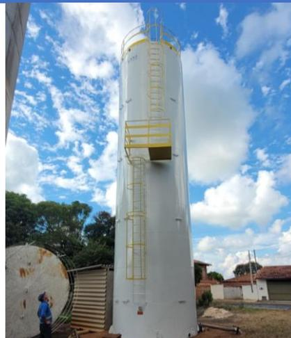
**Foto 2** – Novo Reservatório de 100 m<sup>3</sup> instalado no Distrito Guarapuã (imagens do prestador).
