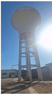
Foto 1 - Visão geral - Reservatório R5 - elevado
