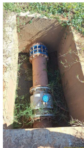
Foto 5 - Macromedidor instalado
