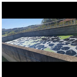
Foto 11 - Segundo módulo de aeração em teste de estanqueidade
