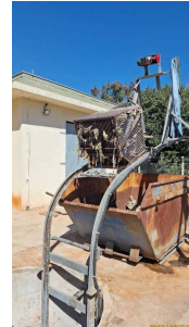
Foto 4 - Limpeza motorizada do cesto
