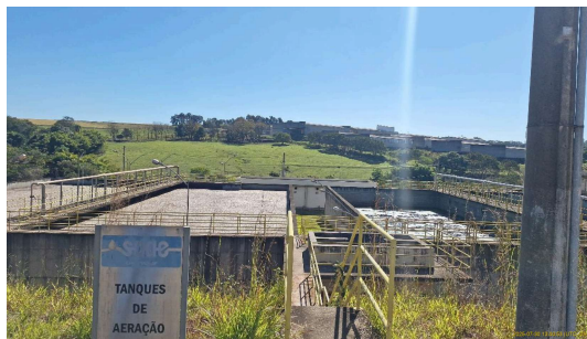
Foto 10 - Tanques de aeração
