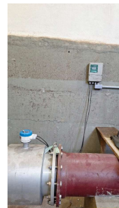
Foto 8 - Macromedidor instalado
