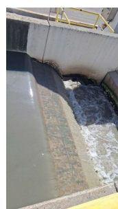
Foto 8 - esgoto pós remoção de areia vertendo para os reatores
