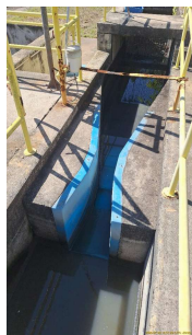
Foto 1 - Macromedidor de entrada em manutenção
