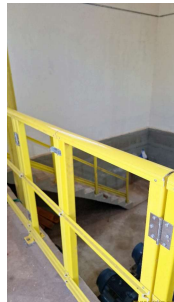
Foto 6 - Guarda corpos para acesso da área dos conjuntos motobomba
