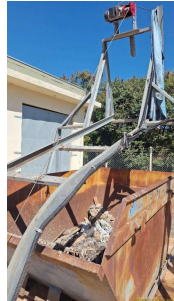
Foto 3 - Caçamba de coleta dos resíduos de gradeamento
