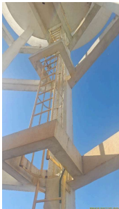
Foto 3 - Escada com guarda corpos
