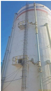
Foto 3 - Escada com guarda corpos
