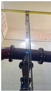
Foto 9 - Traves para içamento dos conjuntos motobomba
