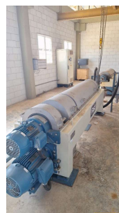
Foto 21 - Centrífugas _ desidratação do lodo
