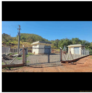
Foto 1 - Visão geral e cercamento de área
