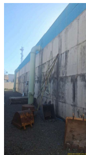
Foto 2 - Lateral - Reservatório R1- 2 câmaras
