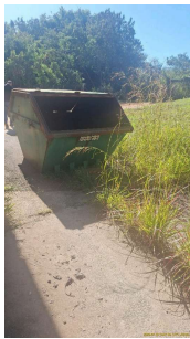
Foto 7 - Caçamba para descarte de material retido no gradeamento
