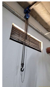
Foto 8 - Guindaste e trave para retirada dos conjuntos motobomba
