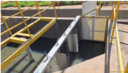
Foto 2 - Conjunto de raspadores para retirada de excesso de lodo
