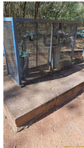
Foto 7 - Laje de proteção - Poço Pessagno
