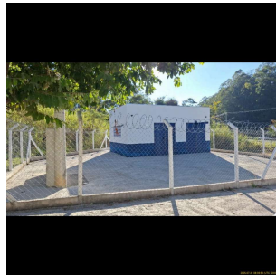
Foto 1 - Estação elevatória de esgoto Parque Portugal - visão geral
