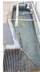
Foto 7 - Dosagem de cal e carvão- pré coagulação
