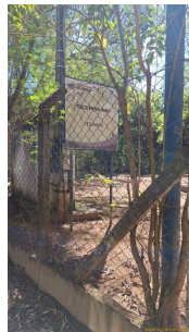
Foto 1 - Visão geral e identificação - Poço Pessagno
