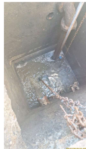
Foto 3 - Gradeamento com cesto - EEE Invernada
