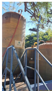
Foto 26 - Armazenamento de PAC
