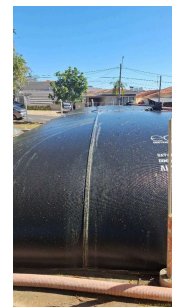
Foto 27 - Lodo em desidratação em Geobag
