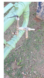
Foto 4 - Tomada para coleta - Poço Santa Thereza
