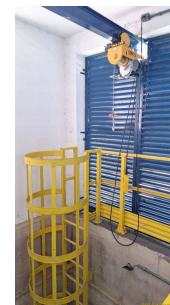
Foto 7 - Trave com guindaste para acesso os conjuntos motobomba
