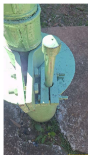
Foto 5 - Tubo de medição de nível - Poço Santa Thereza
