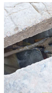
Foto 9 - Dosagem de pac
