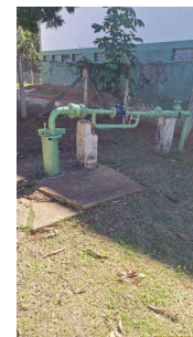
Foto 2 - Laje de proteção - Poço Santa Thereza
