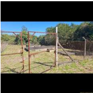
Foto 1 - Entrada da ETE.
