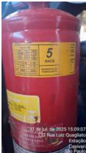
Foto 3 - Validade do extintor do caminhão de apoio.
