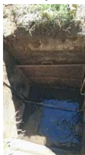
Foto 4 - Entrada do efluente.
