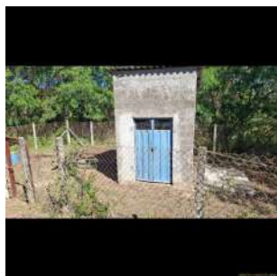
Foto 1 - Vista do cercamento da EEE e do abrigo dos painéis.
