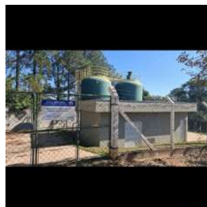
Foto 2 - Entrada da ETE.
