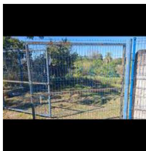
Foto 8 - Portão de entrada.
