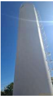
Foto 8 - Lateral do reservatório.
