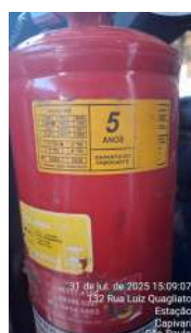
Foto 3 - Validade do extintor do caminhão de apoio.
