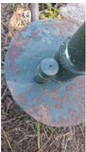
Foto 6 - Tubo de medição de nível.
