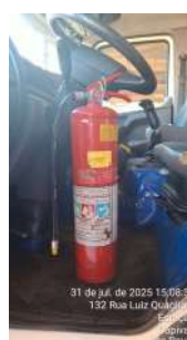
Foto 2 - Extintor do caminhão de apoio.
