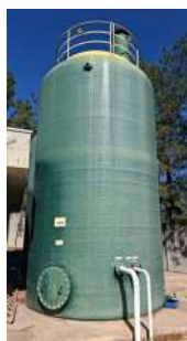
Foto 10 - Reator UASB.
