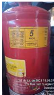
Foto 3 - Validade do extintor do caminhão de apoio.
