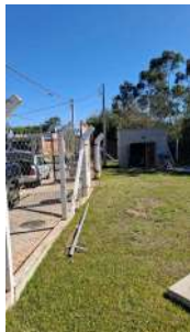
Foto 3 - Vista do cercamento e do abrigo do painel.
