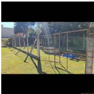
Foto 1 - Vista da entrada da EEE.
