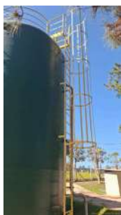
Foto 9 - Escada tipo marinheiro.
