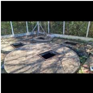
Foto 7 - Poços da elevatória.
