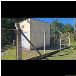
Foto 2 - Cercamento e abrigo dos painéis.
