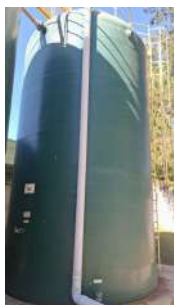
Foto 11 - Filtro anaeróbio submerso (FAS)
