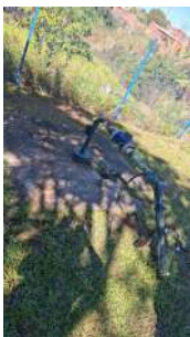
Foto 3 - Vista geral do cavealete.
