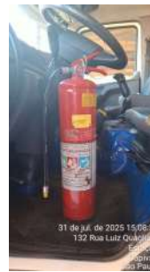
Foto 2 - Extintor do caminhão de apoio.
