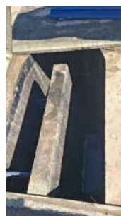
Foto 6 - Canal para retirada de areia.
