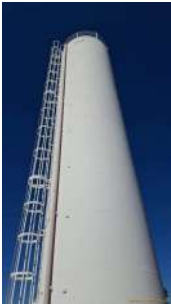
Foto 2 - Vista do reservatório.
