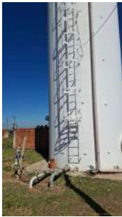
Foto 5 - Base do reservatório.
