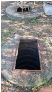
Foto 8 - Poço de passagem.
