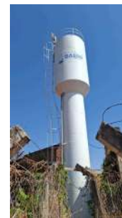
Foto 2 - Vista do Reservatório Mantovani em São José do Rio Pardo
