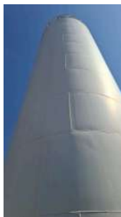
Foto 5 - Vista lateral do Reservatório Vila Pereira 2 em São José do Rio Pardo
