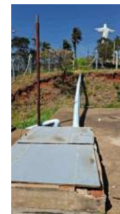
Foto 7 - Tampa de inspeção do Reservatório Vale 2 em São José do Rio Pardo
