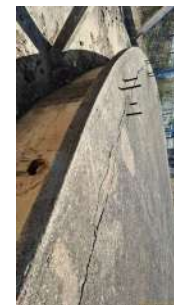
Foto 6 - Vista lateral do Reservatório Santo Antônio em São José do Rio Pardo
