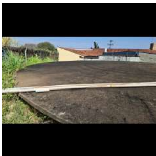
Foto 3 - Tubulação do Reservatório Vila Pereira 1 em São José do Rio Pardo
