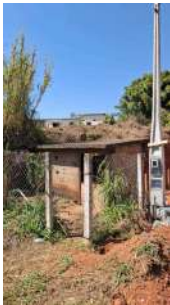
Foto 2 - Entrada da EEA Lupercio Torres em São José do Rio Pardo
