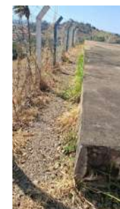
Foto 4 - Vista lateral do Reservatório Vale 2 em São José do Rio Pardo
