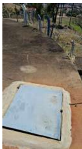
Foto 6 - Tampa de inspeção do Reservatório Vale 1 em São José do Rio Pardo
