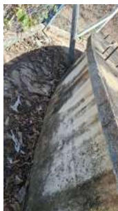
Foto 5 - Vista lateral do Reservatório Santo Antônio em São José do Rio Pardo
