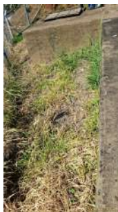
Foto 6 - Vista lateral do Reservatório Vale 2 em São José do Rio Pardo
