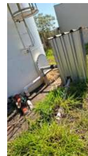
Foto 4 - Entrada de água do Reservatório Vila Formosa 2 em São José do Rio Pardo
