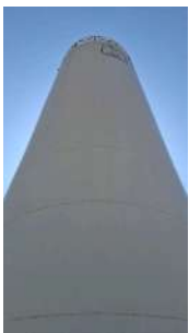
Foto 6 - Vista lateral do Reservatório Vila Pereira 2 em São José do Rio Pardo
