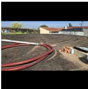
Foto 7 - Vista superior do Reservatório Vila Pereira 1 em São José do Rio Pardo
