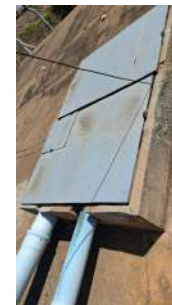
Foto 9 - Tampa de inspeção do Reservatório Vale 2 em São José do Rio Pardo
