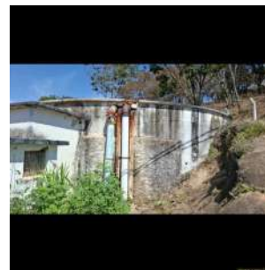
Foto 2 - Vista do Reservatório Santo Antônio em São José do Rio Pardo
