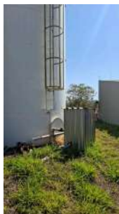
Foto 3 - Vista da EEA Altos do São Domingos em São José do Rio Pardo
