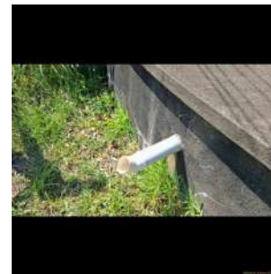
Foto 2 - Extravasador do Reservatório Vale 1 em São José do Rio Pardo
