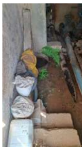
Foto 1 - Materiais de construção e produtos químicos na EEA Santo Antônio em São José do Rio Pardo
