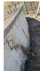
Foto 4 - Vista lateral do Reservatório Santo Antônio em São José do Rio Pardo
