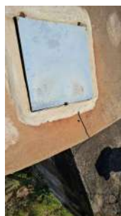
Foto 4 - Tampa de inspeção do Reservatório Vale 1 em São José do Rio Pardo
