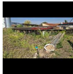
Foto 2 - Vista lateral do Reservatório Vila Pereira 1 em São José do Rio Pardo
