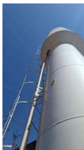
Foto 3 - Guarda-corpo do Reservatório Mantovani em São José do Rio Pardo
