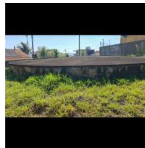
Foto 4 - Vista lateral do Reservatório Vila Pereira 1 em São José do Rio Pardo
