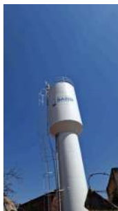
Foto 7 - Vista do Reservatório Mantovani em São José do Rio Pardo
