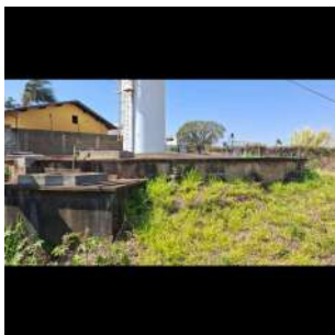
Foto 5 - Vista lateral do Reservatório Vila Pereira 1 em São José do Rio Pardo
