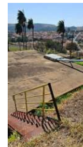
Foto 2 - Vista superior do Reservatório Vale 2 em São José do Rio Pardo
