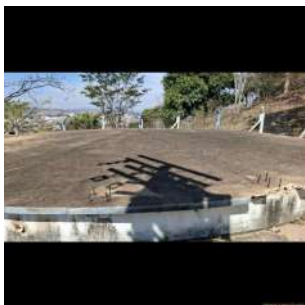
Foto 3 - Vista superior do Reservatório Santo Antônio em São José do Rio Pardo
