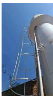
Foto 5 - uarda-corpo do Reservatório Mantovani em São José do Rio Pardo
