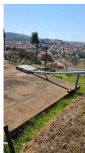
Foto 3 - Vista superior do Reservatório Vale 2 em São José do Rio Pardo
