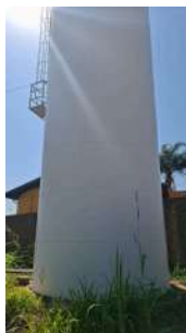
Foto 7 - Vista lateral do Reservatório Vila Pereira 2 em São José do Rio Pardo
