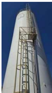
Foto 3 - Guarda-corpo do Reservatório Vila Pereira 2 em São José do Rio Pardo
