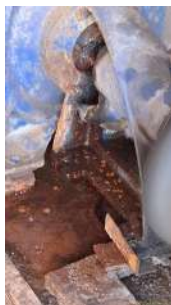
Foto 1 - Drenagem inadequada na EEA Santo Antônio em São José do Rio Pardo
