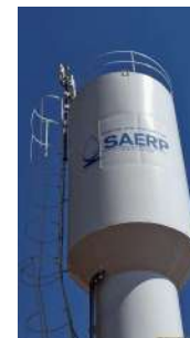
Foto 8 - Vista superior do Reservatório Mantovani em São José do Rio Pardo
