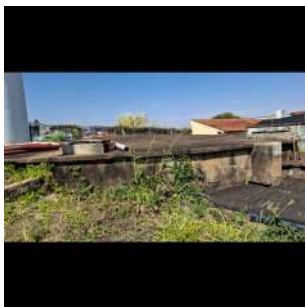
Foto 1 - Vista do Reservatório Vila Pereira 1 em São José do Rio Pardo
