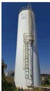
Foto 1 - Guarda-corpo do Reservatório Vila Pereira 2 em São José do Rio Pardo
