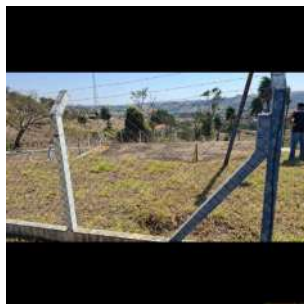
Foto 1 - Cercamento do Reservatório Vale 2 em São José do Rio Pardo
