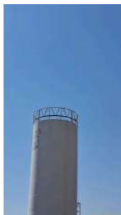
Foto 1 - Ausência do SPDA no Reservatório Vila Formosa 2 em São José do Rio Pardo
