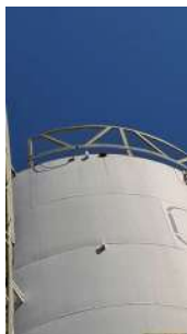
Foto 7 - Vista superior do Reservatório Vila Formosa 2 em São José do Rio Pardo
