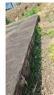
Foto 5 - Vista lateral do Reservatório Vale 2 em São José do Rio Pardo
