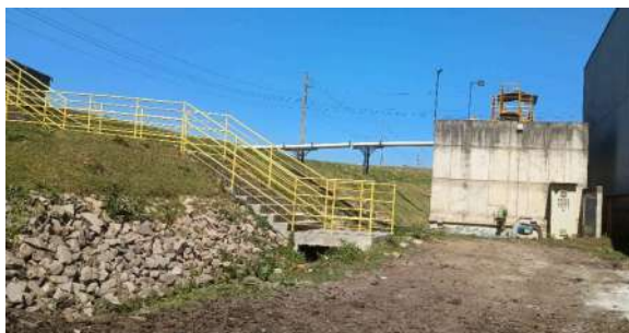
Foto 45 - Tanque de equalização de lodo das lagoas 4 e 5 para recalque novamente para a centrifuga de lodo.
