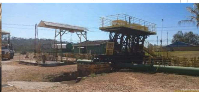
Foto 10 - Vista geral do tratamento preliminar.
