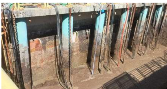
Foto 9 - Poço da estação elevatória de esgoto, pós tratamento preliminar.
