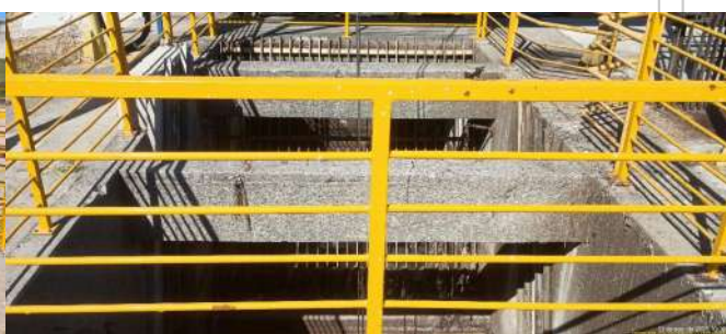
Foto 4 - Tratamento preliminar (gradeamento grosseiro com limpeza manual).
