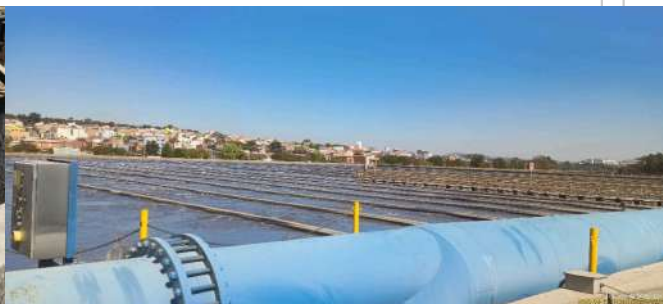
Foto 32 - Vista geral da lagoa de aeração 2.
