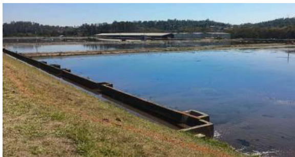
Foto 33 - Chegada do efluente na lagoa de decantação 1.
