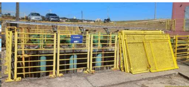
Foto 8 - Poço da estação elevatória de esgoto, pós tratamento preliminar.
