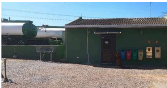
Foto 12 - Sala de operação e CCO, situada ao lado do tratamento preliminar.
