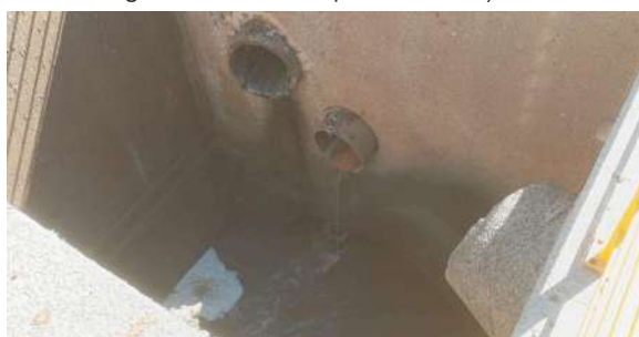
Foto 5 - Chegada do esgoto bruto, antes do tratamento preliminar.
