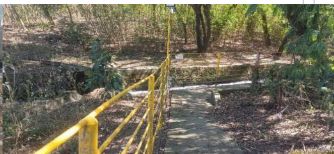
Foto 38 - Saída 2 (Lagoas 3 e 4 de decantação) do efluente tratado.
