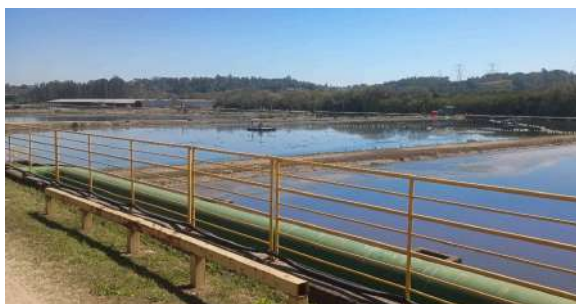
Foto 27 - Vista geral das lagoas de decantação.
