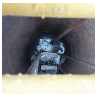
Foto 5 - Cesto de contenção de resíduos no interior da caixa de chegada do esgoto.
