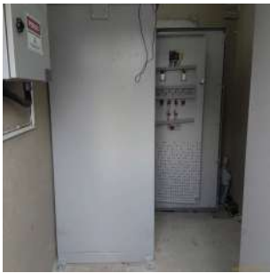
Foto 8 - Interior da edificação.
