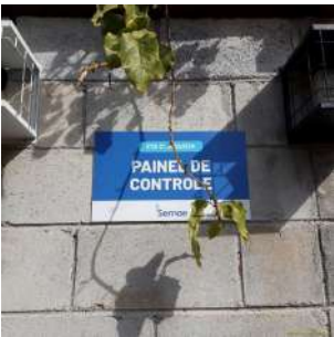
Foto 2 - Placa de Identificação afixada na parede externa da edificação que abriga os painéis
