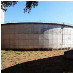
Foto 5 - Vista geral do reservatório II.
