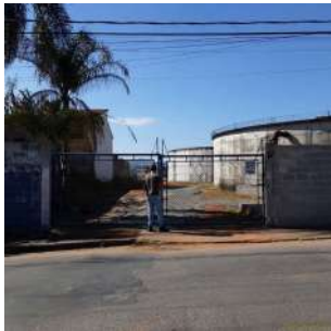
Foto 8 - Portão de acesso à área na Rua Euclides da Cunha.
