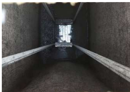
Foto 4 - Cesto de contenção de resíduos no interior da caixa de chegada do esgoto.
