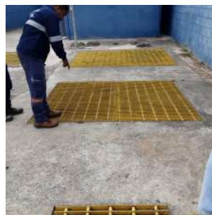
Foto 5 - Poço de bombeamento do esgoto.
