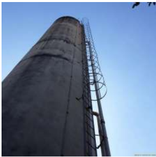
Foto 5 - Escadas de acesso ao topo do reservatório.
