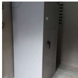
Foto 8 - Interior da edificação.
