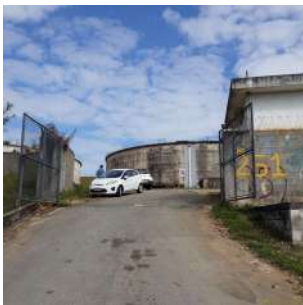
Foto 2 - Portão de acesso ao centro de reservação.
