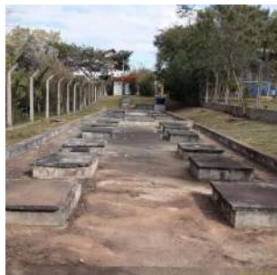
Foto 6 - Vista geral das fossas filtro.
