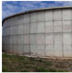
Foto 4 - Vista geral do Reservatório I.
