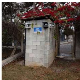
Foto 8 - Edificação que abriga os painéis elétricos.
