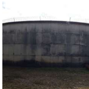
Foto 9 - Vista geral do Reservatório II.
