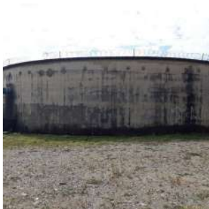
Foto 8 - Vista geral do Reservatório II.
