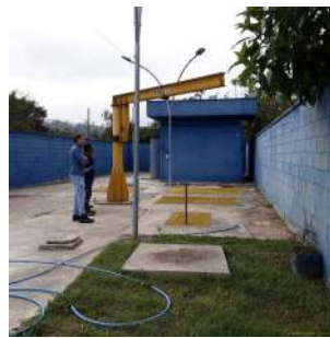
Foto 2 - Vista geral da elevatória.
