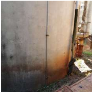
Foto 6 - Aterramento do para-raios.
