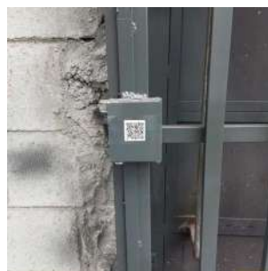
Foto 9 - Item de segurança para abertura da porta da edificação por meio de QRCode.
