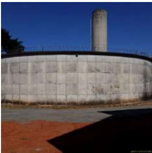
Foto 4 - Vista geral do reservatório II.
