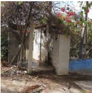
Foto 1 - Vista geral do portão de acesso à ETE. Toda a área está cercada por alambrados.
