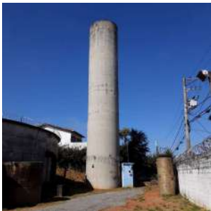
Foto 2 - Vista geral do reservatório.
