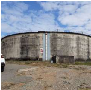
Foto 6 - Vista geral do Reservatório II.
