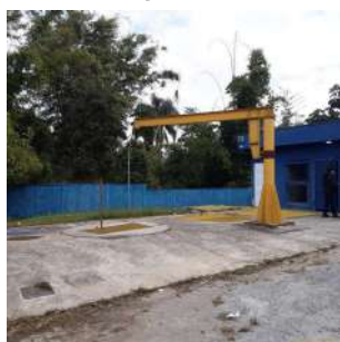
Foto 3 - Vista geral da elevatória.
