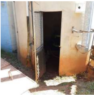
Foto 1 - Portão para acesso à elevatória no interior do Reservatório elevado Vila Suissa I.
