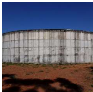
Foto 9 - Vista geral do Reservatório III.
