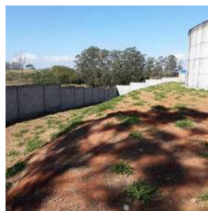
Foto 12 - Vista geral da área e muro de cercamento nos fundos do terreno.
