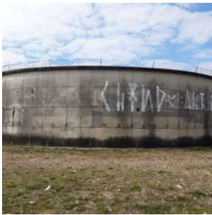
Foto 13 - Vista geral do Reservatório III.
