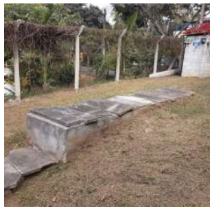
Foto 4 - Ponto de chegada do esgoto na ETE.
