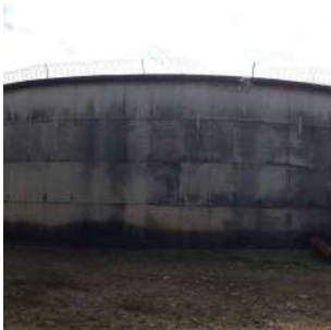
Foto 14 - Vista geral do Reservatório III.
