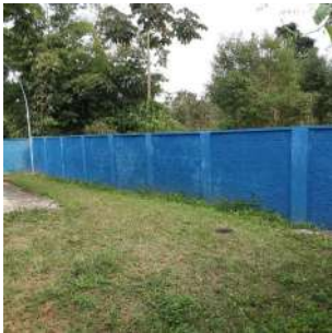
Foto 11 - Vista geral do muro de cercamento atrás da edificação.
