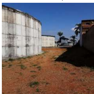
Foto 13 - Vista geral dos reservatórios comunicantes.
