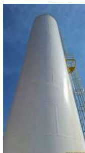
Foto 5 - Vista traseira do reservatório.
