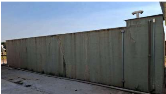
Foto 1 - Vista do reservatório.
