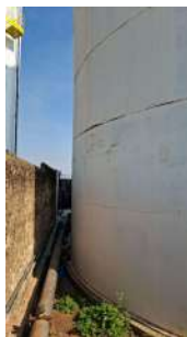
Foto 7 - Vista traseira do reservatório.
