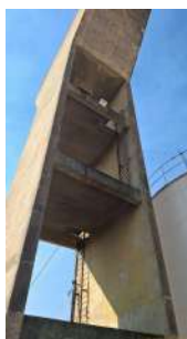
Foto 1 - Detalhe das escadas e patamares.
