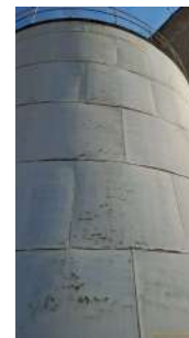
Foto 6 - Vista da estrutura do reservatório.
