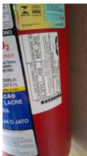
Foto 21 - Validade do extintor.
