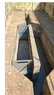
Foto 4 - Canal de remoção de areia.
