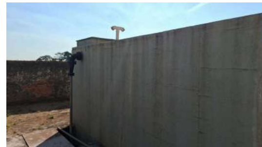
Foto 4 - Tubulação de alimentação do reservatório.
