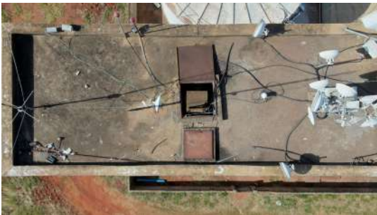
Foto 1 - Tampa de inspeção aberta.
