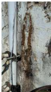
Foto 1 - Vazamento.
