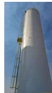
Foto 2 - Vista frontal do reservatório.
