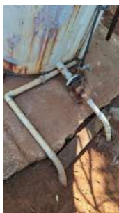
Foto 3 - Tubulação de saída.
