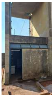
Foto 1 - Vista da EEAT na base do Reservatório Central.
