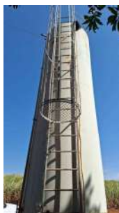
Foto 5 - Tubulação de alimentação e escada marinho.
