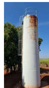
Foto 4 - Vista traseira do reservatório.
