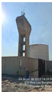
Foto 1 - Área sem o muro.
