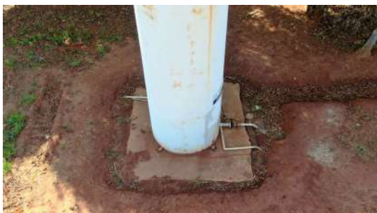
Foto 11 - Base do reservatório.
