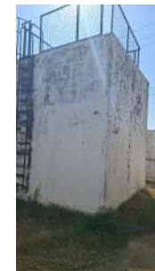
Foto 4 - Vista traseira do reservatório.
