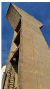
Foto 3 - Vista frontal do reservatório.
