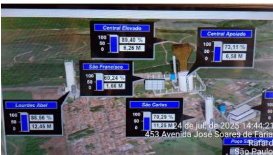
Foto 11 - Detalhe do nível do reservatório no CCO.
