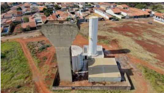
Foto 9 - Vista aérea do reservatório.
