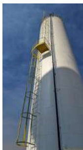
Foto 3 - Escada marinheiro e passarela de descanso.
