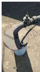
Foto 5 - Tubo de nível do poço.
