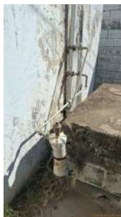
Foto 5 - Sistema de cloração e fluoretação.
