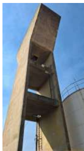
Foto 1 - Vista do reservatório.
