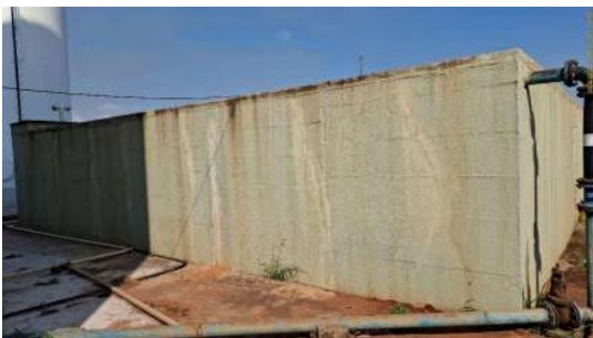
Foto 7 - Outra lateral do reservatório.
