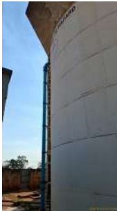
Foto 1 - Frente do reservatório.
