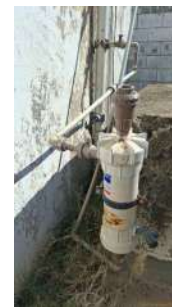
Foto 6 - Detalhe do sistema de cloração e fluoretação.
