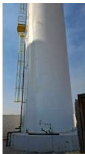
Foto 1 - Base e reservatório.
