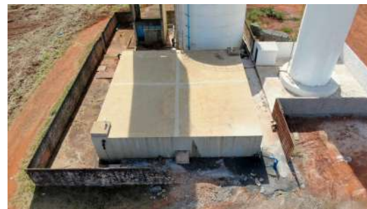
Foto 8 - Vista aérea do reservatório.
