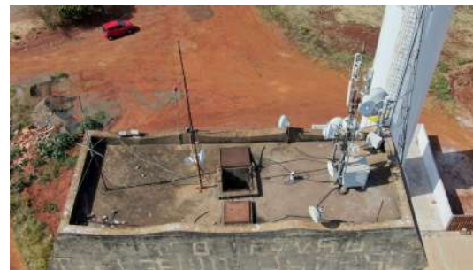
Foto 8 - Vista da cobertura do reservatório.
