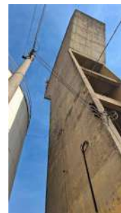
Foto 4 - Vista traseira do reservatório.
