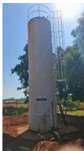
Foto 1 - Vista frontal do reservatório.
