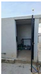
Foto 1 - Entrada da EEAT.
