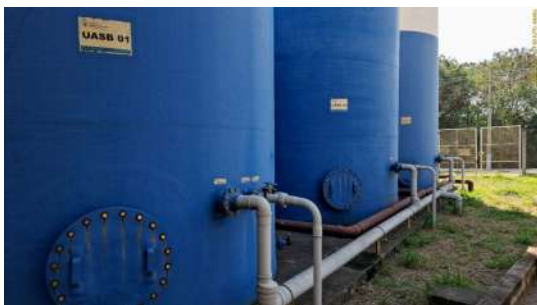
Foto 23 - Reatores UASB.
