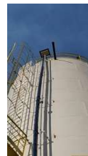
Foto 6 - Tubulação de recalque e extravasor ao lado.
