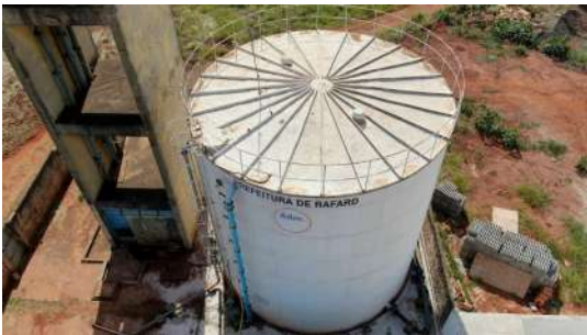
Foto 11 - Vista aérea do reservatório.
