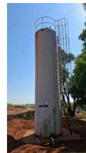
Foto 2 - Vista geral do reservatório.
