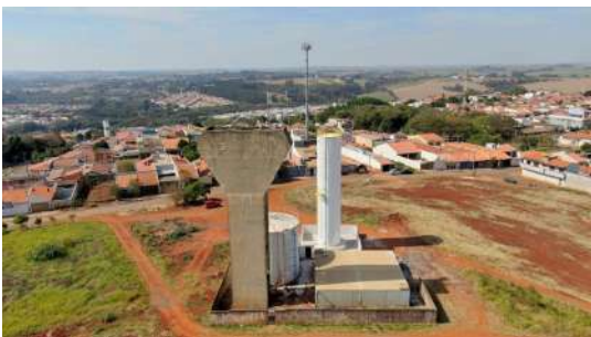
Foto 7 - Vista aérea do conjunto de reservatórios.
