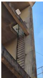
Foto 3 - Escada do segundo patamar.
