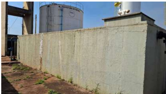
Foto 5 - Lateral do reservatório.
