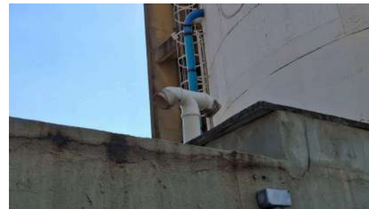
Foto 2 - Tubulação de inspeção.
