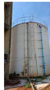
Foto 8 - Vista do reservatório apoiado.
