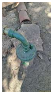
Foto 3 - Tubo de medição de nível.
