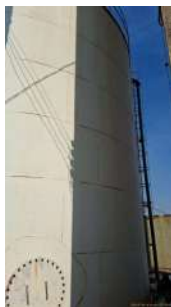
Foto 5 - Lateral do reservatório.
