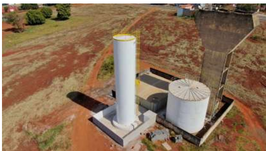
Foto 9 - Vista do sistema de reservação.
