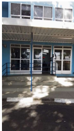
Foto 2 - Fachada Entrada I
