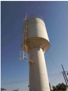
Foto 4 - Escada com guarda-corpo.
