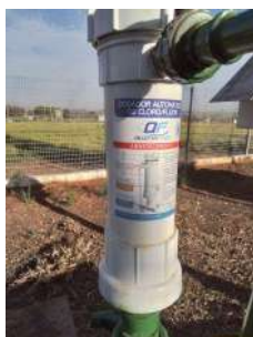
Foto 5 - Aplicação de cloro e flúor.
