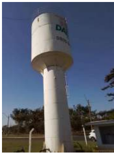
Foto 1 - Vista do reservatório.
