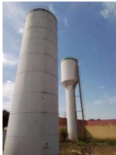
Foto 1 - Vista dos reservatórios.
