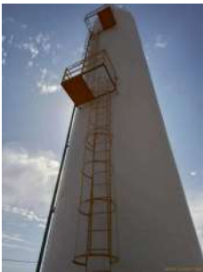
Foto 2 - Escada com guarda-corpos.
