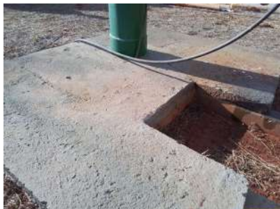
Foto 7 - Laje do poço.
