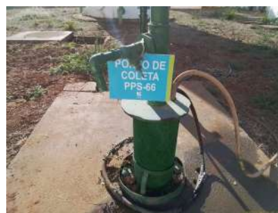
Foto 2 - Ponto para coleta de água bruta.
