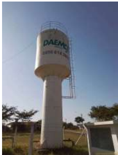
Foto 3 - Vista do reservatório, ainda com pintura do DAEMO.
