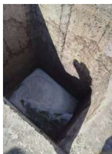
Foto 32 - Neste ponto, os efluentes tratados pelos dois módulos é unido.
