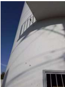
Foto 1 - Suporte para condutor de descida.
