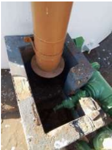
Foto 4 - Saída do extravasor.
