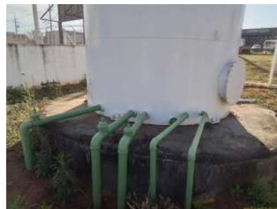
Foto 4 - Saídas do reservatório e extravasor.
