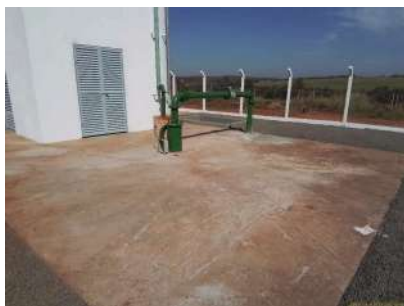
Foto 3 - Laje do poço.
