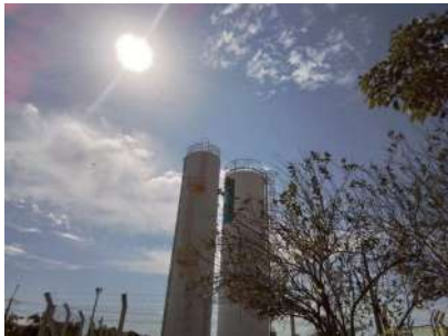
Foto 8 - Topo dos reservatórios.
