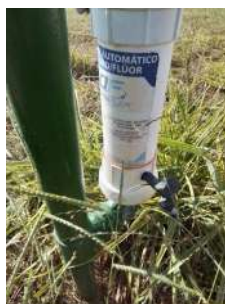
Foto 8 - Aplicação de cloro e flúor.
