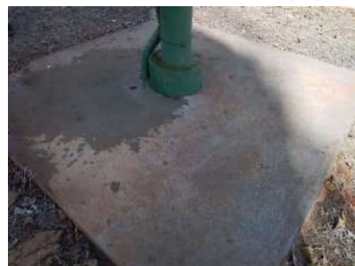
Foto 8 - Detalhe da laje do poço.
