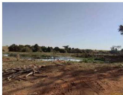
Foto 2 - Vista da ETE.
