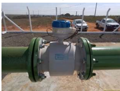
Foto 5 - Macromedidor instalado.
