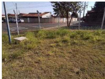
Foto 2 - Vegetação alta na área do reservatório.
