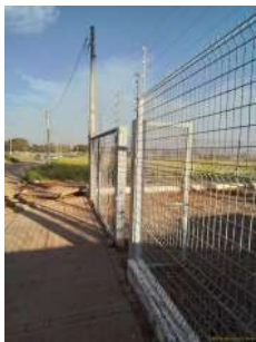
Foto 3 - Cercamento da área.
