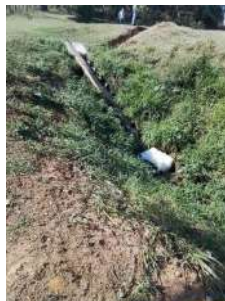
Foto 10 - Saída do efluente tratado.
