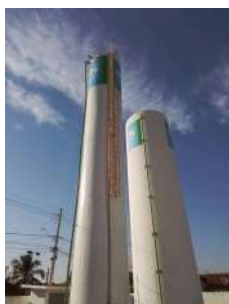
Foto 5 - Detalhe do guarda-corpo.
