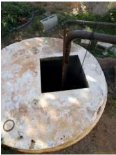
Foto 1 - Detalhe da abertura junto ao poço de sucção.
