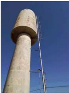
Foto 2 - Escada e guarda-corpo.
