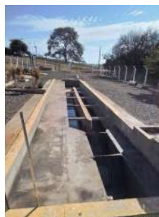
Foto 6 - Vista do gradeamento (perto) e caixa de areia (mais distante).
