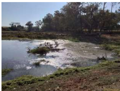
Foto 1 - Acúmulo de vegetação na lagoa anaeróbia.
