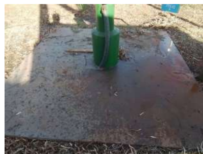
Foto 6 - Detalhe da laje.
