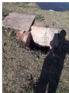
Foto 3 - Caixa de inspeção 2.
