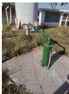
Foto 4 - Vista do poço.
