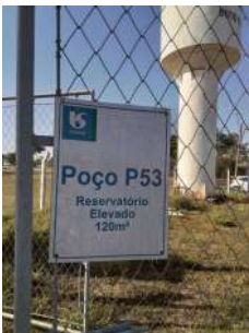
Foto 2 - Identificação do poço e reservatório.
