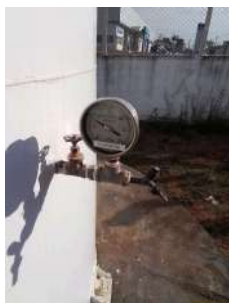
Foto 5 - Manômetro na base. O reservatório também está ligado ao sistema de telemetria.
