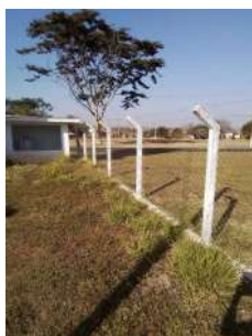
Foto 3 - Cercamento da área.
