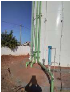
Foto 2 - Poço P-17 à frente e reservatório ao fundo.
