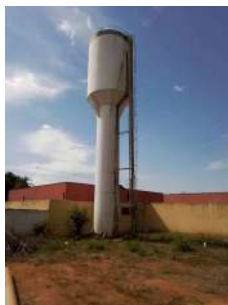
Foto 3 - Reservatório em taça.
