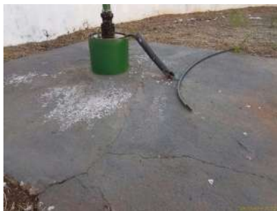
Foto 5 - Detalhe da laje do poço.
