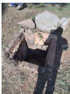
Foto 6 - Caixa de inspeção 3.
