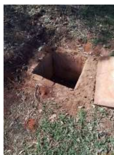
Foto 7 - Caixa de inspeção 4.
