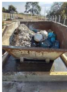
Foto 4 - Caçamba para acúmulo de material grosseiro retido no gradeamento.
