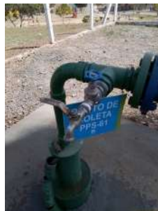
Foto 4 - Torneira para coleta de água bruta.
