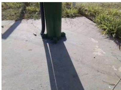
Foto 5 - Detalhe da laje.
