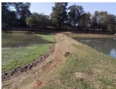
Foto 8 - Separação entre lagoa anaeróbia e facultativa.
