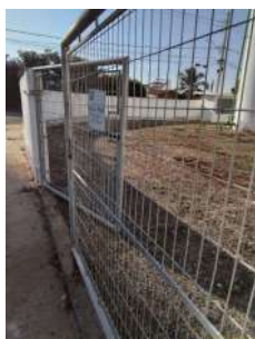
Foto 3 - Cercamento do local.
