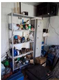
Foto 31 - Almoarifado com material utilizado na ETE.
