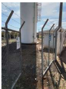
Foto 1 - Entrada e cercamento do local.
