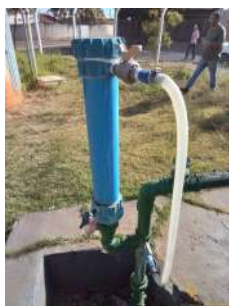
Foto 7 - Aplicação de cloro e flúor.
