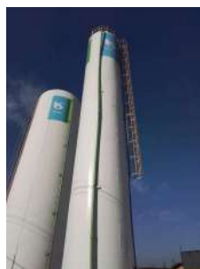
Foto 6 - Extravasor na lateral do reservatório.
