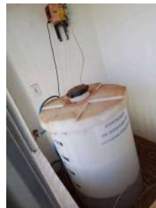
Foto 8 - Tanque de ortopolifosfato.
