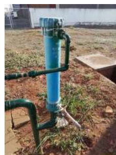
Foto 4 - Aplicação de cloro e flúor.
