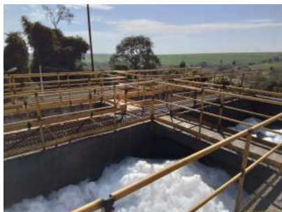
Foto 25 - Tanques de concreto.
