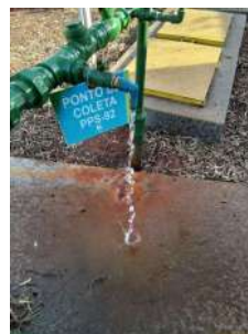
Foto 4 - Ponto para coleta de água bruta.
