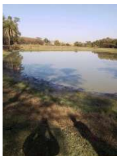
Foto 11 - Vista da ETE a partir da lagoa facultativa próxima à saída do efluente tratado.
