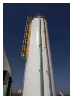
Foto 6 - O reservatório junto do Poço 3 possui apenas a finalidade de regularizar a vazão da elevatória ao lado do Poço 3.
