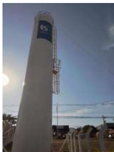
Foto 3 - Guarda-corpo do reservatório.
