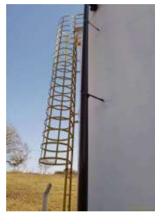
Foto 14 - Guarda-corpo junto ao UASB de fibra.
