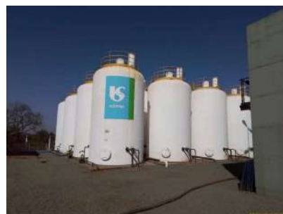
Foto 12 - Reatores UASB (fibra).
