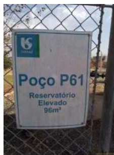
Foto 2 - Identificação do poço e reservatório.
