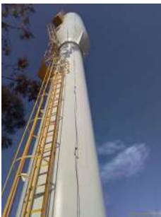
Foto 4 - Detalhe do guarda-corpo.
