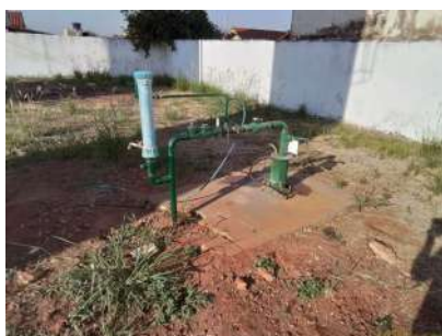
Foto 1 - Vista do poço.
