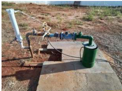
Foto 3 - Vista do poço.
