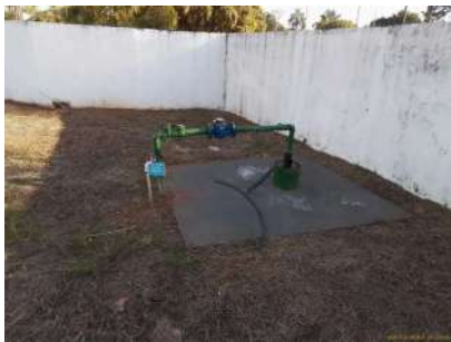
Foto 1 - Vista do poço.
