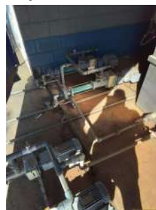
Foto 17 - Bombas utilizadas na aplicação de polímero (pares de 1+1R).
