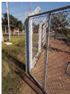
Foto 3 - Cercamento da área.
