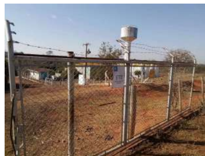
Foto 2 - Cercamento do local.
