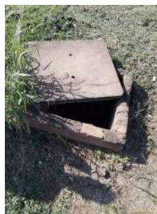
Foto 2 - Caixa de inspeção 1.
