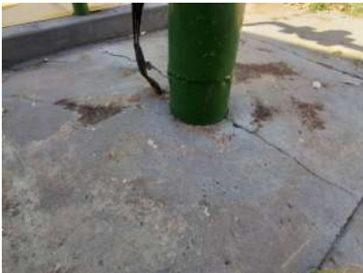
Foto 7 - Detalhe da laje.
