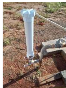
Foto 6 - Aplicação de cloro e flúor.
