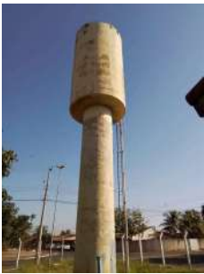
Foto 1 - Vista do reservatório.
