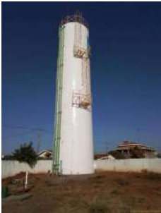
Foto 1 - Vista do reservatório.
