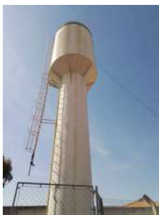
Foto 2 - Vista do reservatório.
