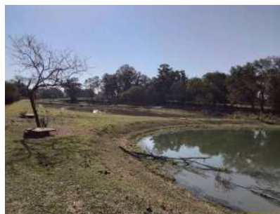
Foto 5 - À frente e à direita a lagoa anaeróbia e, ao fundo, as lagoas facultativas.
