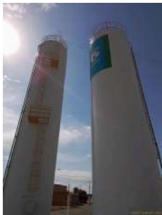
Foto 1 - Vista dos reservatórios. À esquerda, o reservatório operante.
