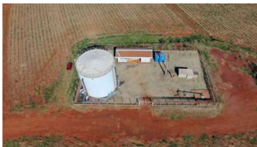
Foto 22 - Vista superior do reservatório.
