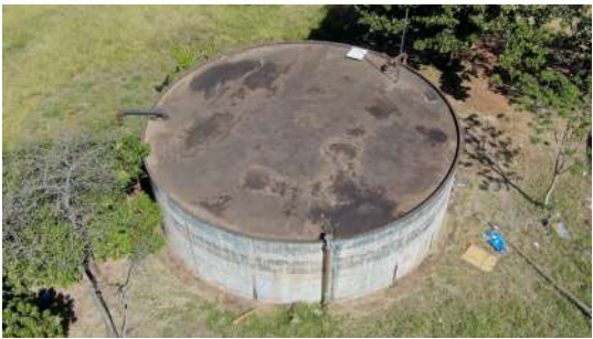
Foto 10 - Vista superior do reservatório.
