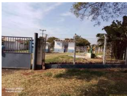
Foto 1 - Vista externa do poço.
