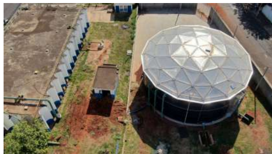
Foto 12 - Vista superior do reservatório.
