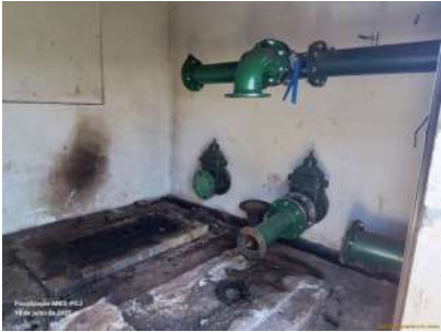
Foto 4 - Interior da EEA desativada.
