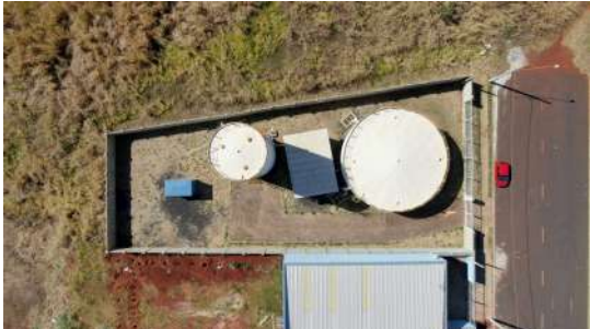
Foto 15 - Vista superior do reservatório.
