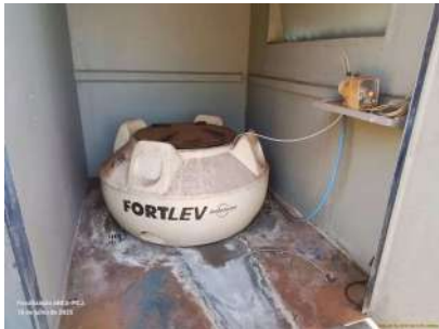
Foto 8 - Dosagem de Ácido fluorsilícico.
