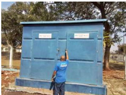
Foto 9 - Casa de química.
