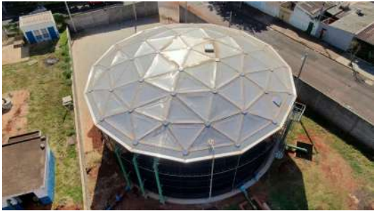
Foto 5 - Vista superior do reservatório.
