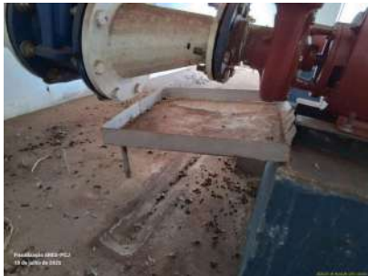
Foto 8 - Sistema de drenagem da gaxeta.
