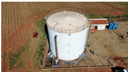
Foto 15 - Vista superior do reservatório.
