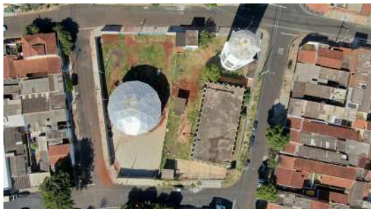
Foto 15 - Vista superior do reservatório.
