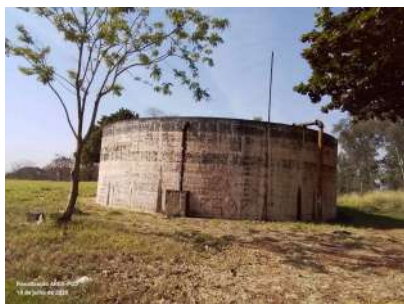
Foto 1 - Vista do reservatório e tubo extravasor.
