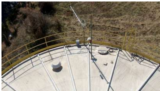
Foto 12 - Vista superior do reservatório.
