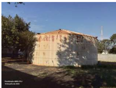
Foto 3 - Vista do reservatório.
