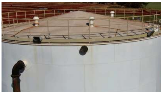
Foto 16 - Vista superior do reservatório.
