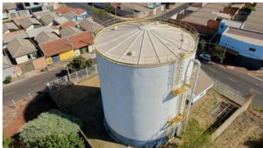
Foto 10 - Vista superior do reservatório.
