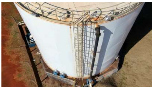
Foto 20 - Vista superior do reservatório.
