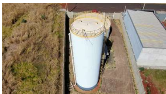
Foto 9 - Vista superior do reservatório.
