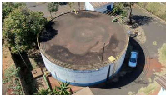
Foto 14 - Vista superior do reservatório.
