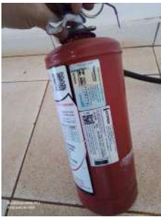
Foto 11 - Validade do extintor.
