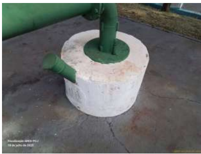
Foto 3 - Tubo de nível e laje.
