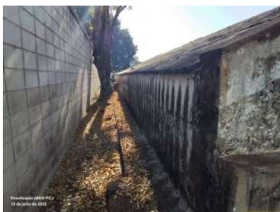
Foto 3 - Vista da lateral externa 1.
