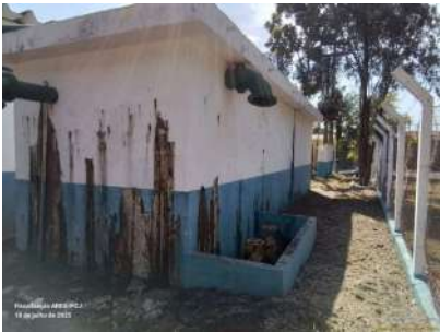
Foto 2 - Vista da caixa de sucção.
