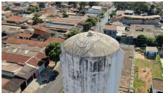
Foto 6 - Vista superior do reservatório.
