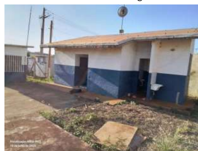
Foto 8 - Casa de química.
