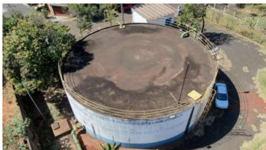
Foto 11 - Vista superior do reservatório.
