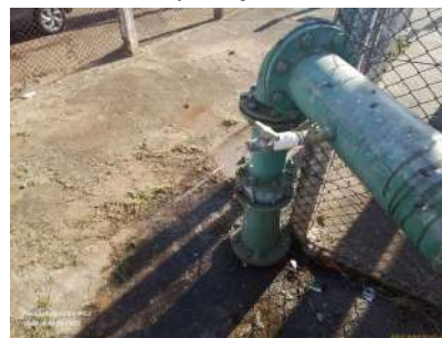
Foto 5 - Torneira de amostragem de água bruta.
