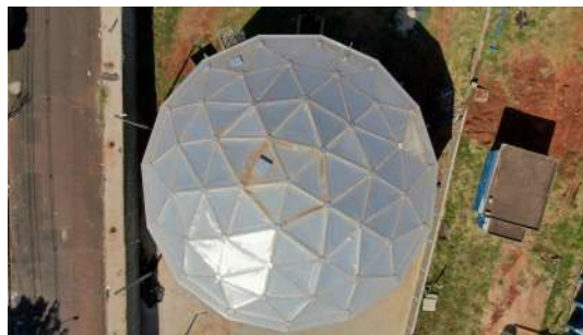
Foto 8 - Vista superior do reservatório.
