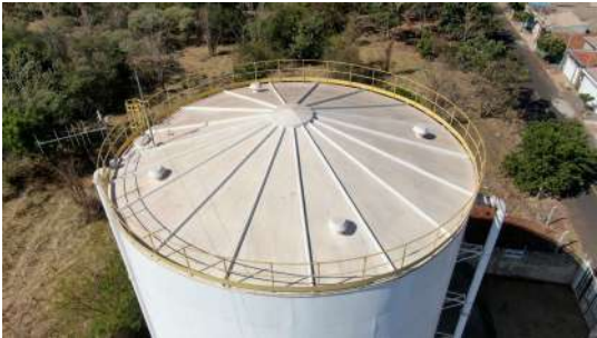
Foto 2 - Tubulações de ventilação.
