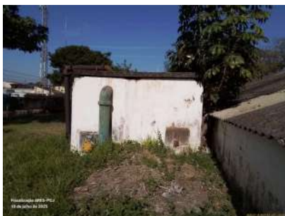
Foto 3 - Vista da lateral 2 da caixa de sucção.
