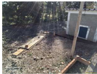
Foto 2 - Vista da caixa de gradeamento e remoção de areia.
