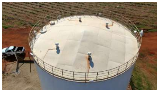
Foto 10 - Vista superior do reservatório.
