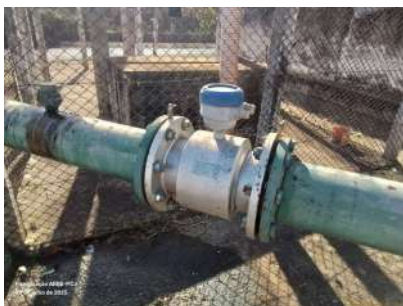
Foto 4 - Macro medidor com fios cortados.
