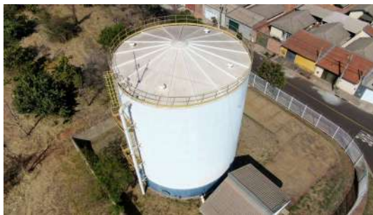
Foto 4 - Vista superior do reservatório.
