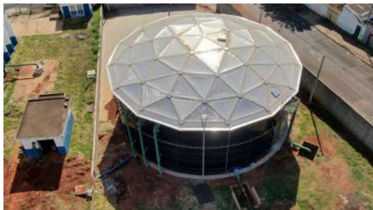
Foto 13 - Vista superior do reservatório.
