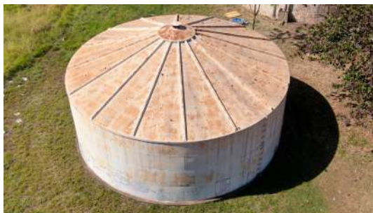
Foto 12 - Vista superior do reservatório.
