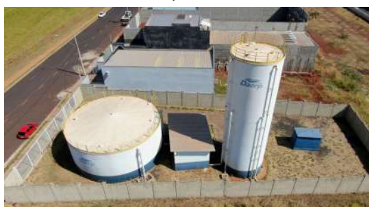
Foto 11 - Vista superior do reservatório.
