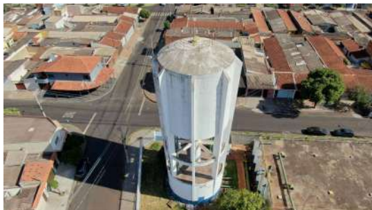
Foto 9 - Vista superior do reservatório.
