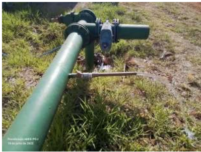
Foto 4 - Torneira de amostragem de água bruta.
