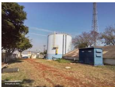
Foto 1 - Vista do reservatório.
