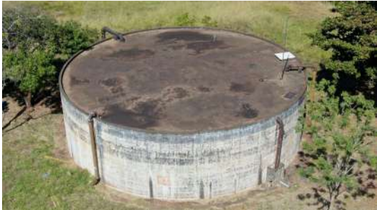
Foto 11 - Vista superior do reservatório.
