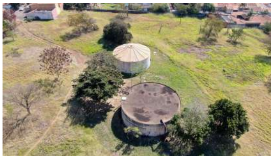
Foto 8 - Vista superior dos dois reservatórios.
