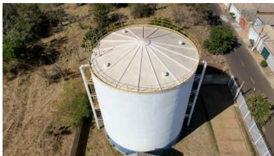
Foto 3 - Tubo extravasor à direita.
