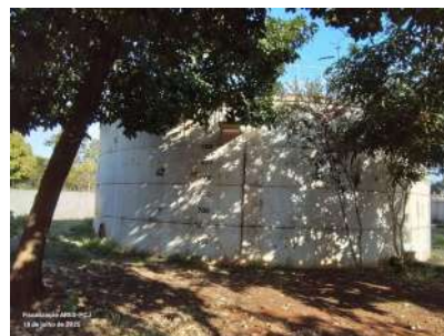
Foto 10 - Medidor de nível.
