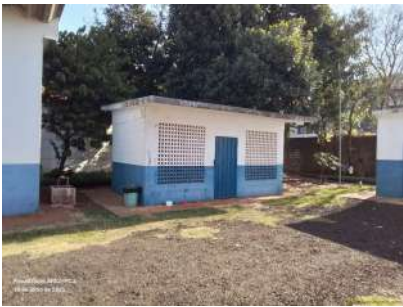
Foto 12 - Casa de química.
