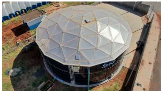
Foto 10 - Vista superior do reservatório.
