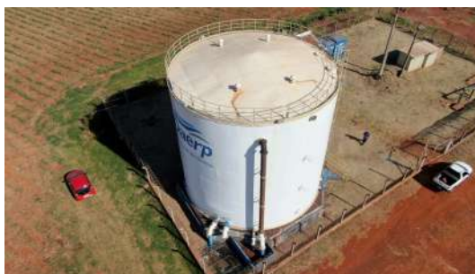
Foto 14 - Vista superior do reservatório.
