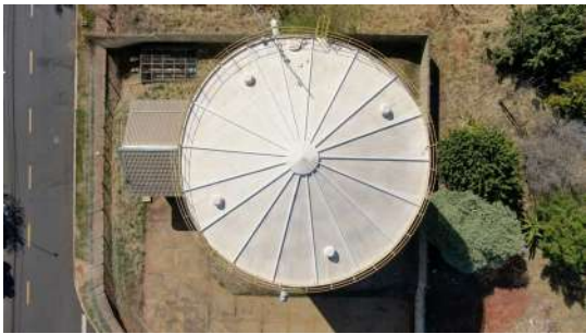
Foto 13 - Vista superior do reservatório.
