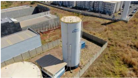
Foto 13 - Vista superior do reservatório.
