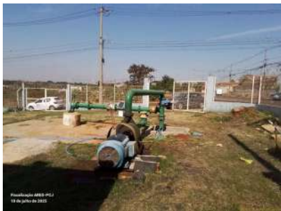
Foto 4 - Vista interna da EEA.
