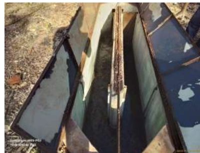
Foto 4 - Caixas de areia.
