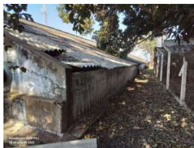
Foto 4 - Vista da lateral externa 1.
