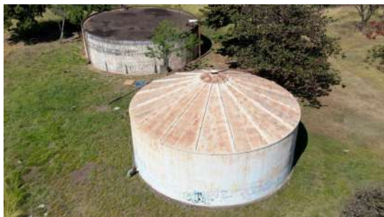
Foto 11 - Vista superior do reservatório.
