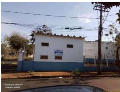
Foto 1 - Vista do acesso e placa de identificação.
