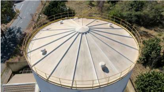
Foto 16 - Vista superior do reservatório.
