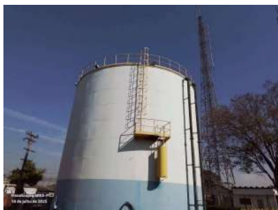
Foto 3 - Vista do guarda-corpo.
