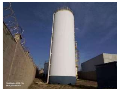
Foto 4 - Vista do reservatório.
