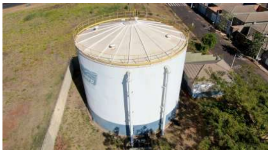
Foto 5 - Extravasor à esquerda.
