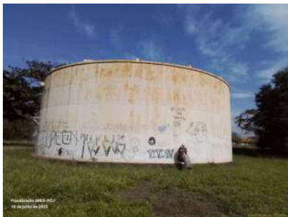
Foto 3 - Vista do reservatório.
