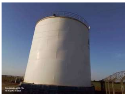
Foto 7 - Vista do reservatório.
