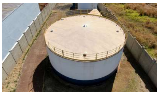
Foto 8 - Vista superior do reservatório.
