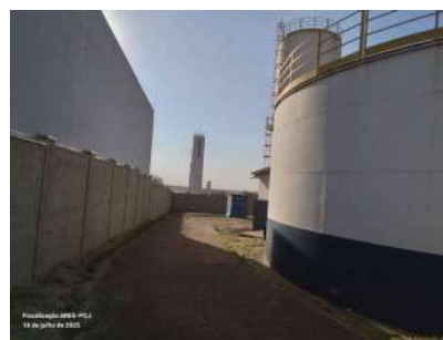
Foto 6 - Vista do acesso ao reservatório.
