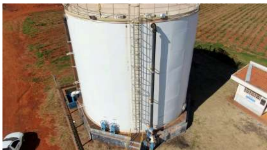
Foto 19 - Vista superior do reservatório.
