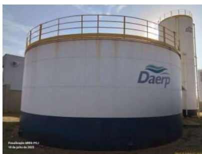
Foto 5 - Vista do reservatório.
