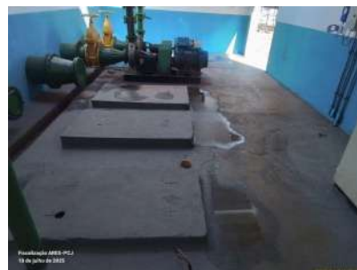
Foto 6 - Vista da EEA.
