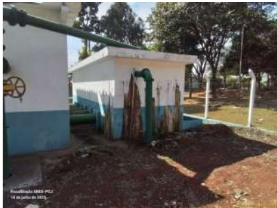
Foto 1 - Vista da caixa de sucção.
