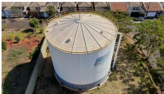
Foto 8 - Vista superior do reservatório.
