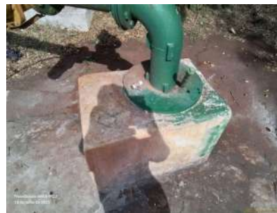
Foto 4 - Vista da tubo de medição de nível.
