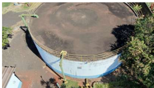
Foto 10 - Vista superior do reservatório.
