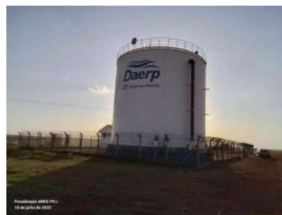
Foto 8 - Vista do reservatório.
