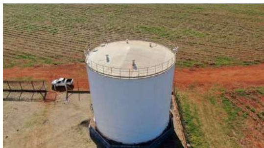
Foto 9 - Vista superior do reservatório.
