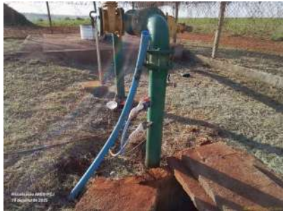
Foto 5 - Cloração e fluoretação.
