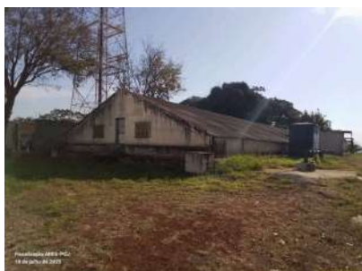
Foto 1 - Vista externa do reservatório.
