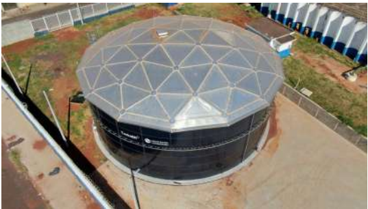
Foto 2 - Vista superior do reservatório.
