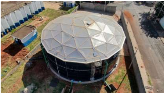
Foto 4 - Vista superior do reservatório.
