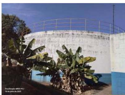
Foto 3 - Vista do reservatório.
