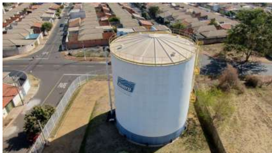
Foto 11 - Vista superior do reservatório.
