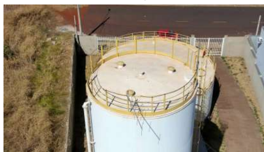
Foto 10 - Vista superior do reservatório.
