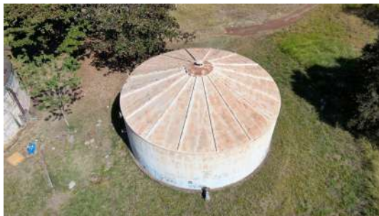
Foto 10 - Vista superior do reservatório.
