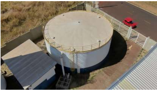
Foto 12 - Vista superior do reservatório.
