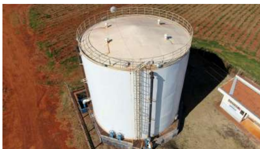
Foto 18 - Vista superior do reservatório.
