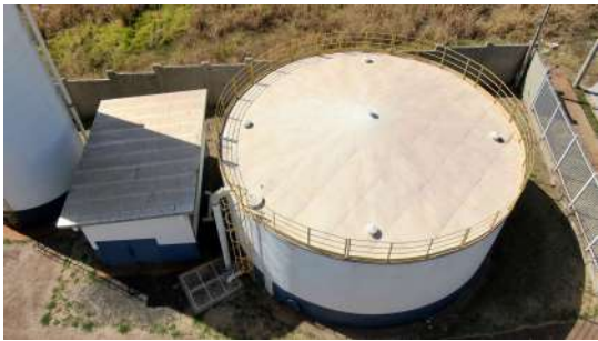
Foto 11 - Vista superior do reservatório.
