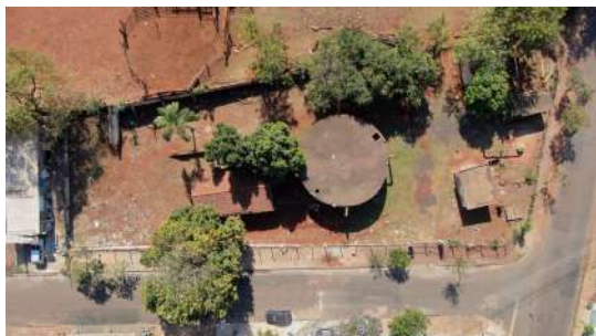
Foto 1 - Vista superior do reservatório.
