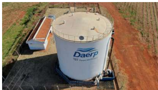
Foto 12 - Vista superior do reservatório.
