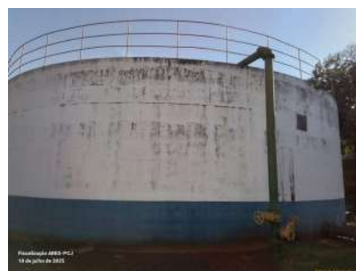
Foto 6 - Vista do reservatório.
