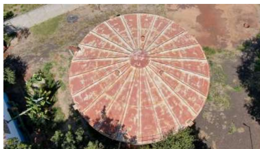
Foto 8 - Vista superior do reservatório.
