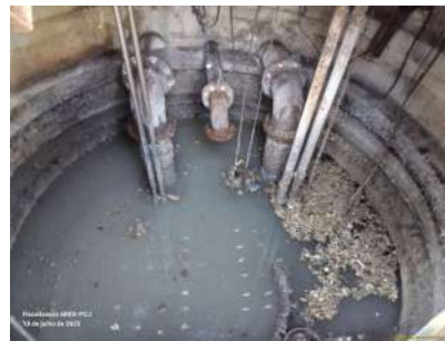
Foto 6 - Poço de sucção.
