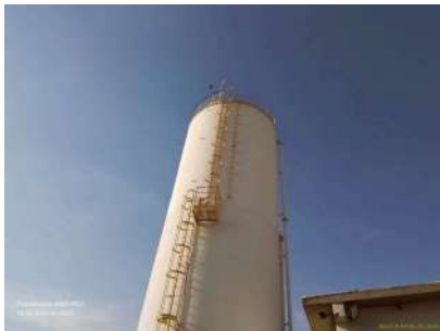
Foto 2 - Guarda-corpo superior e medidor de nível.
