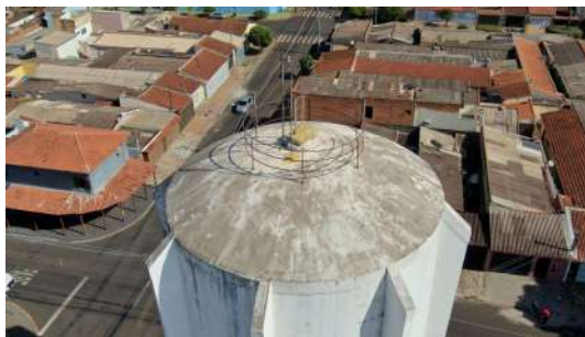
Foto 4 - Guarda-corpo e tampa de inspeção.
