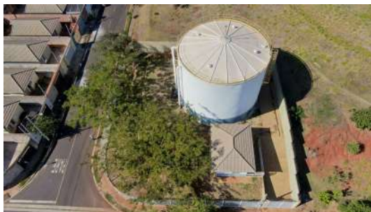
Foto 2 - Vista superior do reservatório.
