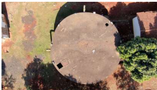
Foto 2 - Vista superior do reservatório.
