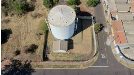
Foto 15 - Vista superior do reservatório.
