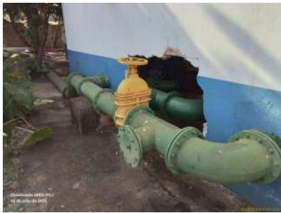
Foto 10 - Tubulação externa de sucção.
