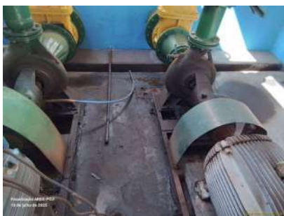
Foto 3 - Bomba esquerda com dreno e direita sem dreno.
