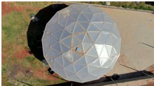
Foto 9 - Vista superior do reservatório.
