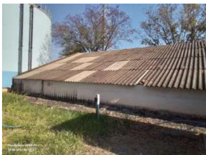
Foto 9 - Vista da lateral externa 3.
