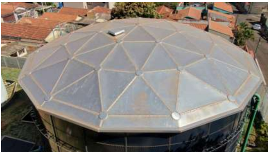
Foto 2 - Vista superior do reservatório.
