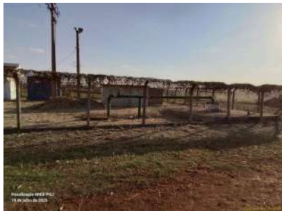
Foto 1 - Vista externo do poço.
