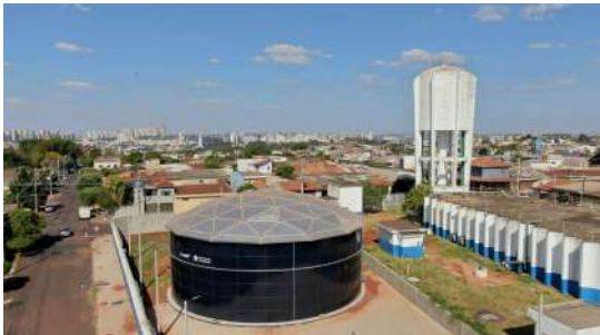
Foto 1 - Vista superior do reservatório ao fundo.
