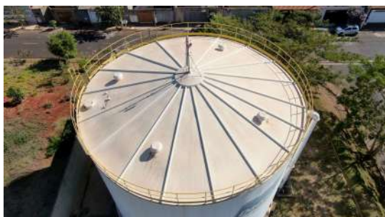
Foto 9 - Vista superior do reservatório.
