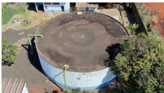
Foto 9 - Vista superior do reservatório.
