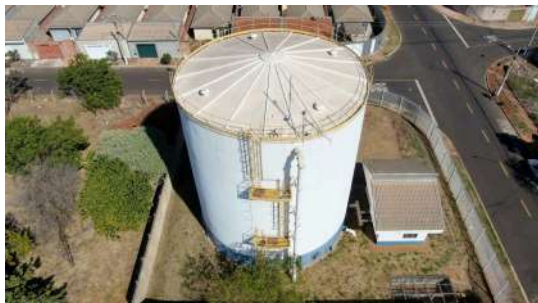
Foto 5 - Vista superior do reservatório.
