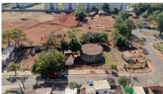
Foto 6 - Vista superior do reservatório.
