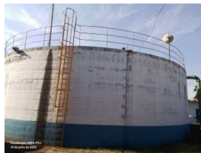
Foto 2 - Guarda-corpo e medidor de nível.
