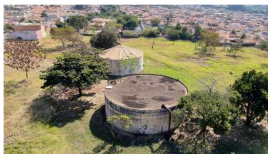
Foto 8 - Vista superior dos dois reservatórios.
