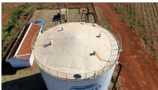
Foto 13 - Vista superior do reservatório.
