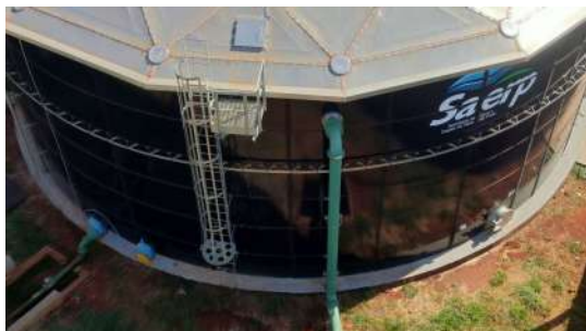
Foto 11 - Guarda-corpo e tampa de inspeção.
