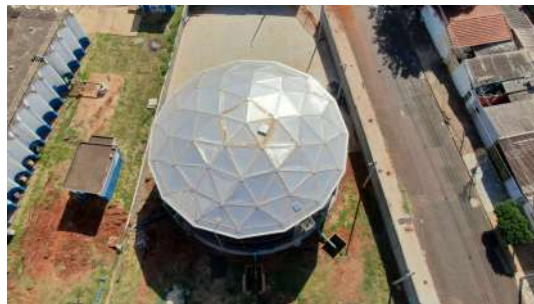
Foto 14 - Vista superior do reservatório.
