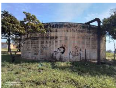
Foto 5 - Vista do reservatório.
