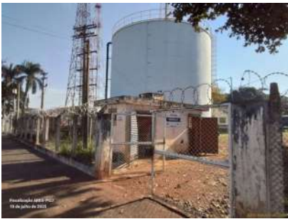
Foto 1 - Vista do acesso.
