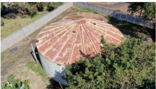
Foto 4 - Vista superior do reservatório.
