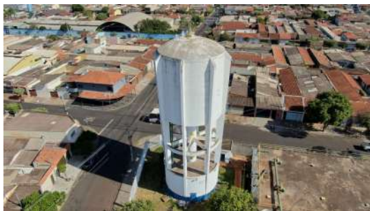
Foto 3 - Vista superior do reservatório.
