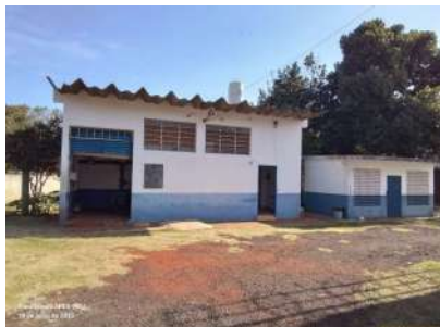
Foto 1 - Vista externa da EEA.
