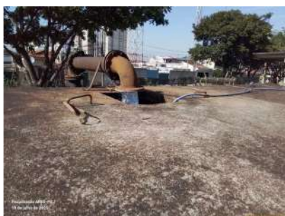
Foto 1 - Acesso à estrutura utilizado como entrada de água de abastecimento.
