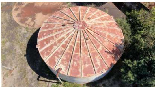
Foto 6 - Vista superior do reservatório.
