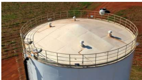
Foto 21 - Vista superior do reservatório.
