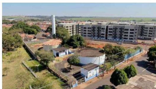
Foto 8 - Vista superior do reservatório.
