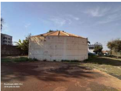
Foto 2 - Vista do reservatório.
