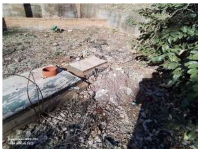
Foto 1 - Resíduo sólido da grade descartado no entorno da EEE.
