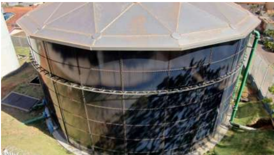
Foto 1 - Vista superior do reservatório.
