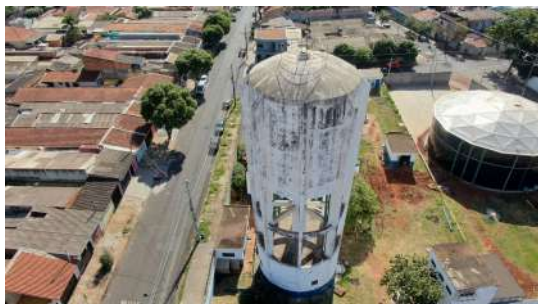
Foto 7 - Vista superior do reservatório.
