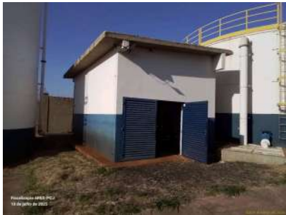
Foto 1 - Vista externa da EEA.
