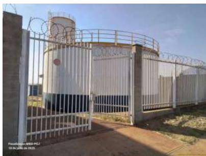
Foto 1 - Acesso ao reservatório.
