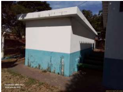
Foto 3 - Vista da caixa de sucção.
