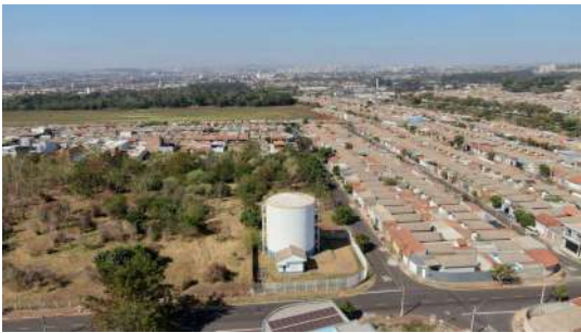
Foto 14 - Vista superior do reservatório.
