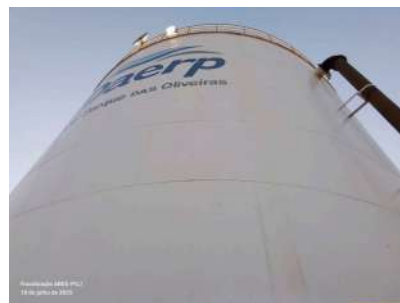
Foto 6 - Vista do reservatório.
