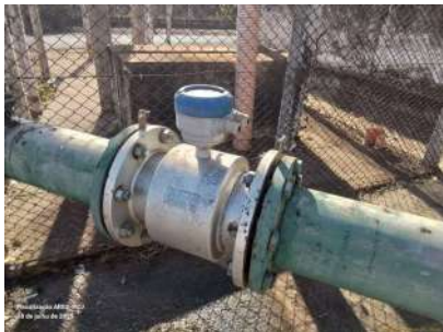
Foto 1 - Macro medidor com fios cortados.
