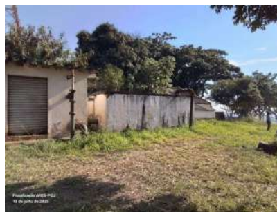
Foto 2 - Vista da lateral 1 da caixa de sucção.
