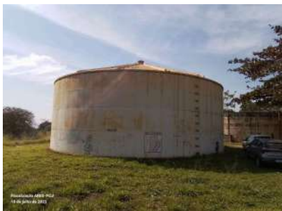
Foto 5 - Vista do reservatório.
