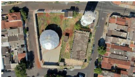
Foto 10 - Vista superior do reservatório.
