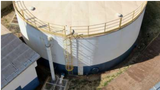
Foto 13 - Tampa de inspeção.
