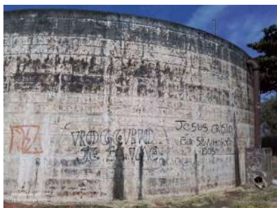
Foto 3 - Vista do reservatório.
