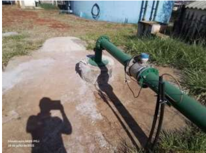
Foto 5 - Laje de proteção.
