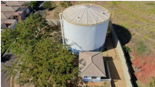
Foto 16 - Vista superior do reservatório.
