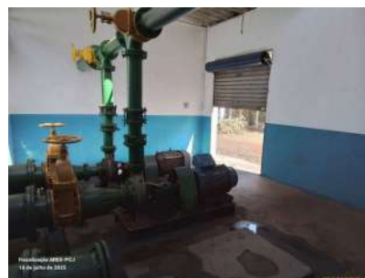
Foto 4 - Vista do acesso.
