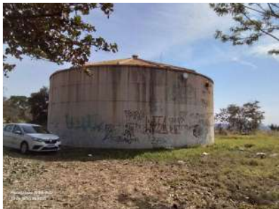
Foto 1 - Vista do reservatório.
