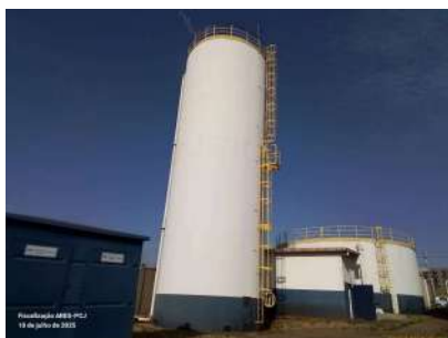
Foto 3 - Vista do reservatório.
