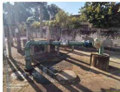
Foto 2 - Vista interna do poço.
