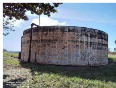
Foto 6 - Vista do reservatório.
