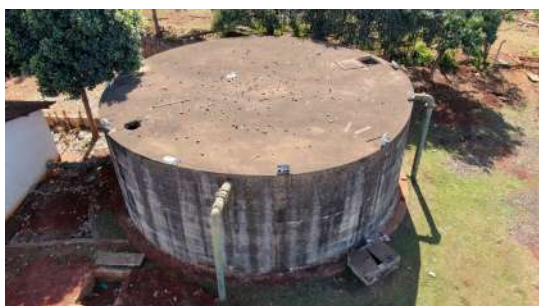
Foto 5 - Vista superior do reservatório.
