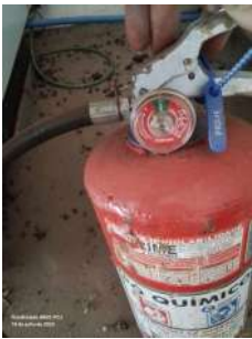
Foto 2 - Extintor despressurizado.
