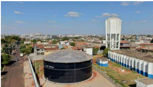
Foto 1 - Vista superior do reservatório.
