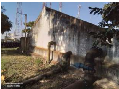
Foto 5 - Vista da lateral externa 2 e extravasor.
