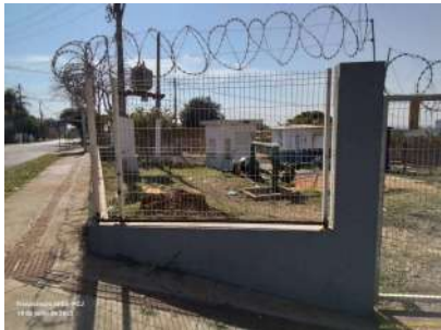
Foto 1 - Vista externa da EEA.
