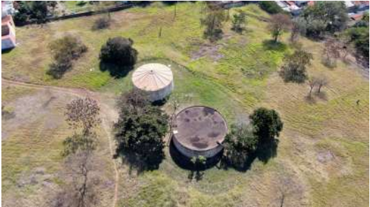
Foto 14 - Vista superior dos dois reservatórios.
