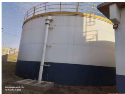
Foto 3 - Vista do reservatório e extravasor.
