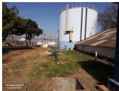
Foto 10 - Vista da lateral externa 3.
