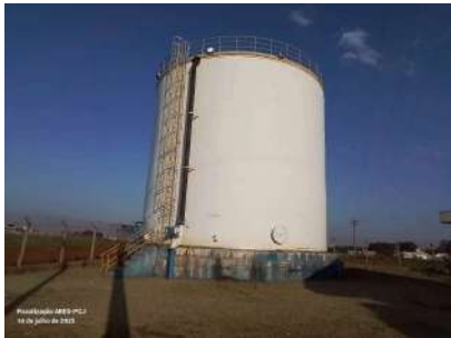
Foto 1 - Vista do reservatório e guarda-corpo.
