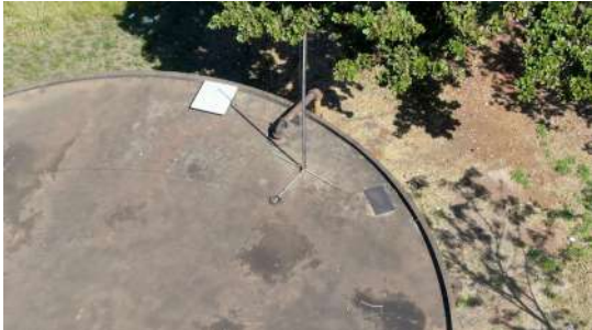
Foto 13 - Vista superior do reservatório.
