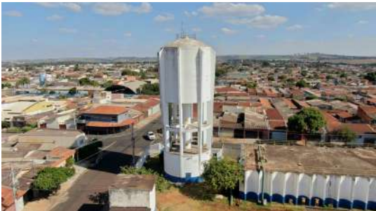
Foto 2 - Vista superior do reservatório.
