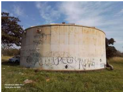
Foto 2 - Vista do reservatório.
