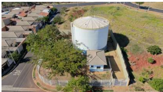
Foto 1 - Vista superior do reservatório.
