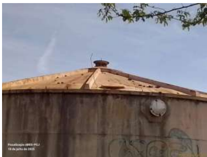
Foto 7 - Vista do reservatório.
