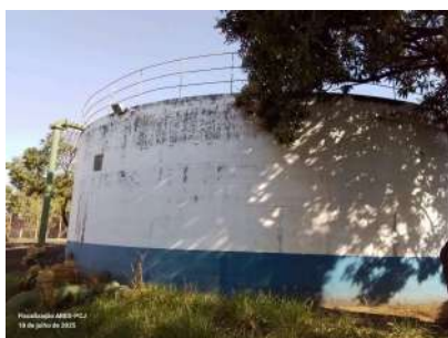
Foto 5 - Vista do reservatório.
