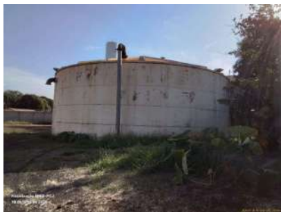
Foto 1 - Vista do reservatório e tubo extravasor.
