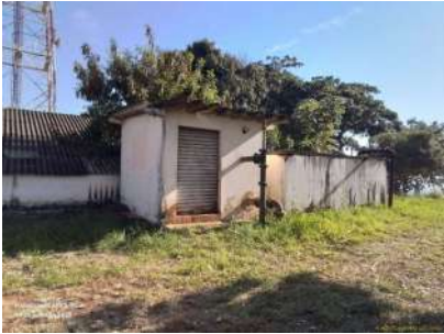
Foto 3 - Antiga EEA desativada.
