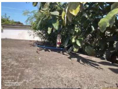
Foto 5 - Tubulação de ventilação.
