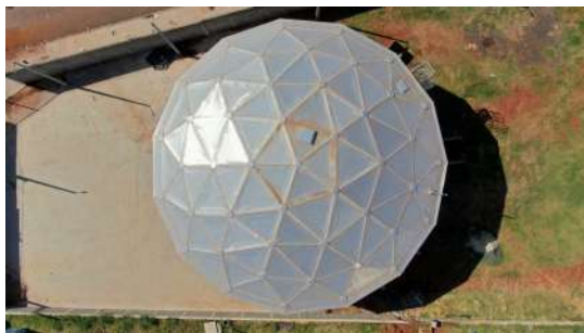
Foto 7 - Vista superior do reservatório.
