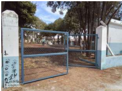
Foto 1 - Vista do acesso ao poço.
