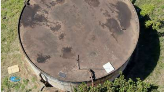
Foto 12 - Vista superior do reservatório.
