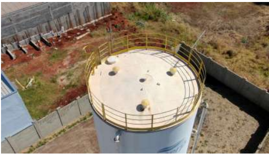
Foto 14 - Vista superior do reservatório.
