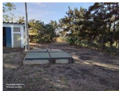
Foto 10 - Vista externa do poço de sucção.
