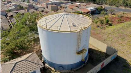
Foto 14 - Vista superior do reservatório.
