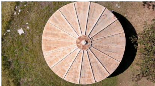
Foto 13 - Vista superior do reservatório.
