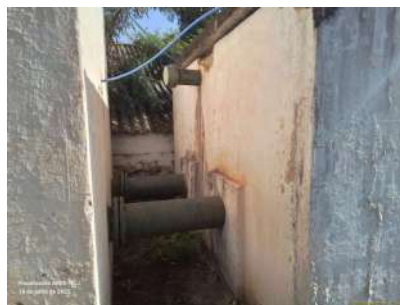
Foto 6 - Vista da lateral 4 da caixa de sucção. Antiga tomada de água da EEA desativada.
