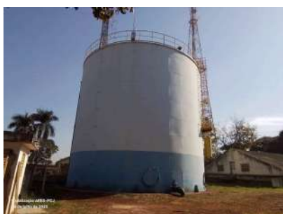
Foto 9 - Vista do reservatório.
