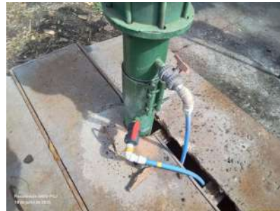
Foto 6 - Cloração e fluoretação.
