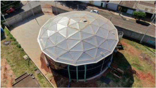
Foto 6 - Vista superior do reservatório.
