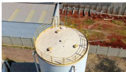
Foto 12 - Vista superior do reservatório.
