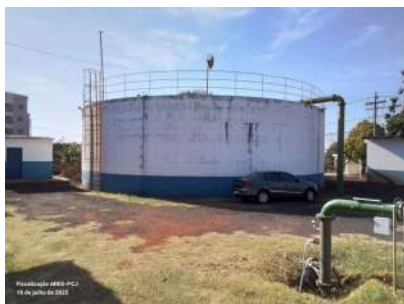
Foto 1 - Vista do reservatório.
