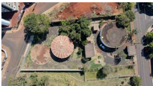
Foto 7 - Vista superior do reservatório.
