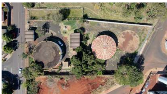
Foto 13 - Vista superior do reservatório.
