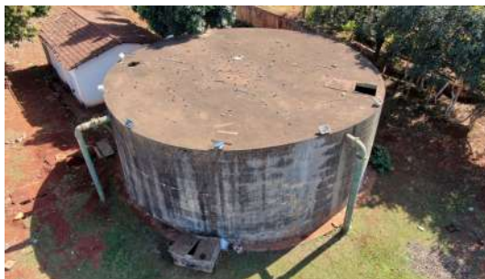
Foto 4 - Vista superior do reservatório.
