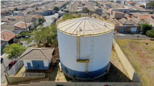
Foto 15 - Vista superior do reservatório.
