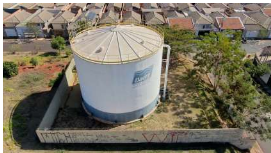
Foto 7 - Vista superior do reservatório.
