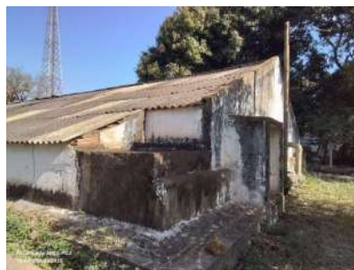
Foto 6 - Vista da lateral externa 2.
