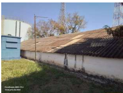
Foto 7 - Vista da lateral externa 3.
