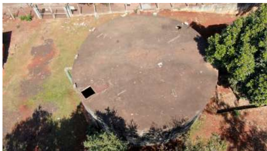
Foto 3 - Vista superior do reservatório.
