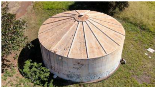
Foto 9 - Vista superior do reservatório.
