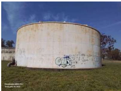
Foto 4 - Vista do reservatório.
