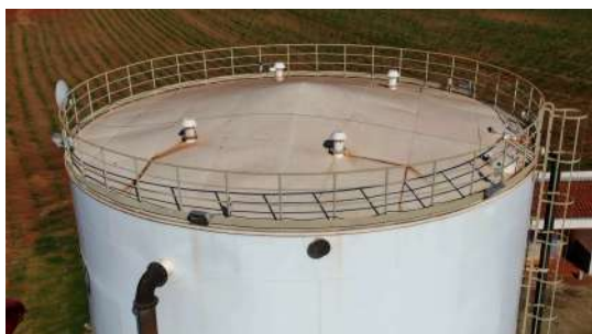
Foto 17 - Vista superior do reservatório.
