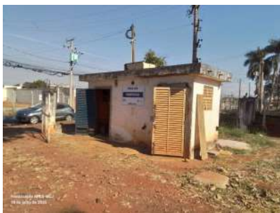
Foto 1 - Vista do acesso e placa de identificação.
