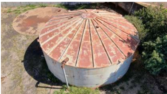
Foto 5 - Vista superior do reservatório.
