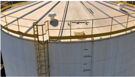
Foto 12 - Tampa de inspeção fechada.
