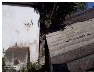
Foto 2 - Árvores crescendo junto à estrutura da caixa de sucção e reservatório semienterrado.
