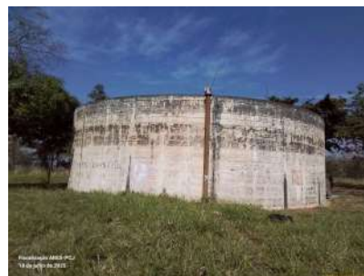
Foto 4 - Vista do reservatório.
