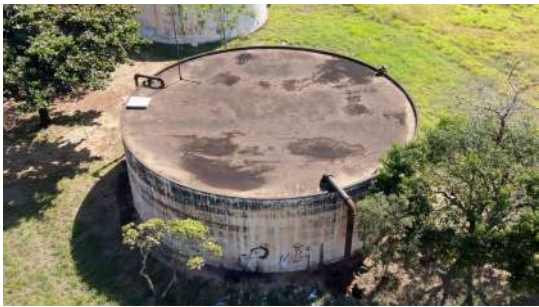
Foto 9 - Vista superior do reservatório.
