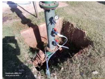
Foto 8 - Cloração e fluoretação.
