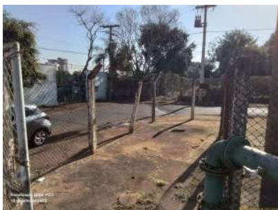
Foto 6 - Vista de cerca de alambrado.
