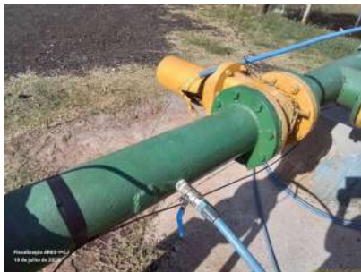
Foto 7 - Tomada de água bruta.
