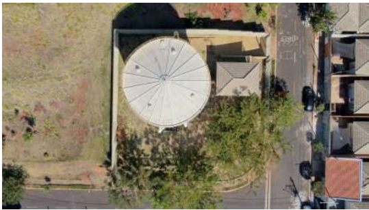
Foto 11 - Vista superior do reservatório.
