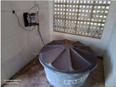
Foto 13 - Ácido fluorsilícico
