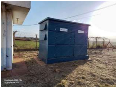
Foto 13 - Nova casa de química.
