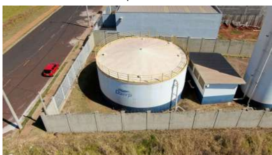
Foto 9 - Vista superior do reservatório.
