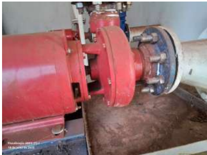
Foto 6 - Sistema de drenagem da gaxeta.
