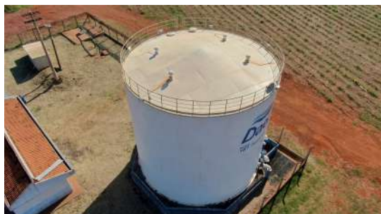
Foto 11 - Vista superior do reservatório.
