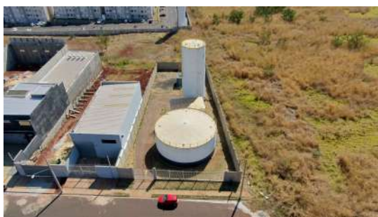
Foto 7 - Vista superior do reservatório.
