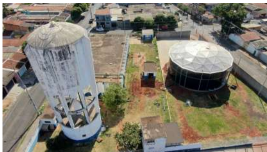
Foto 8 - Vista superior do reservatório.
