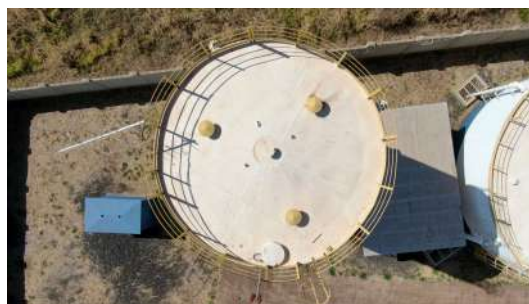
Foto 8 - Tampa de inspeção e tubulação de ventilação.
