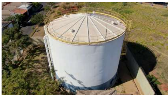
Foto 3 - Vista superior do reservatório.
