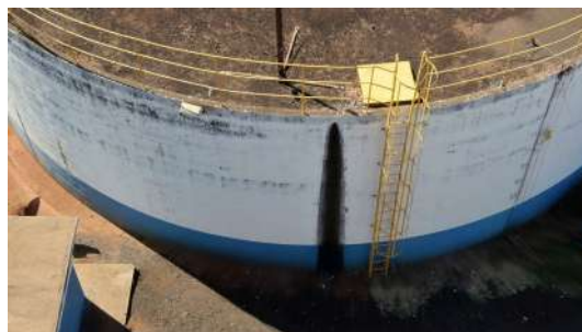
Foto 12 - Tampa de inspeção fechada.
