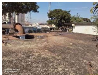
Foto 4 - Vista do topo da caixa de sucção.
