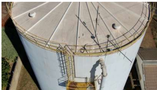
Foto 8 - Tampa de inspeção.
