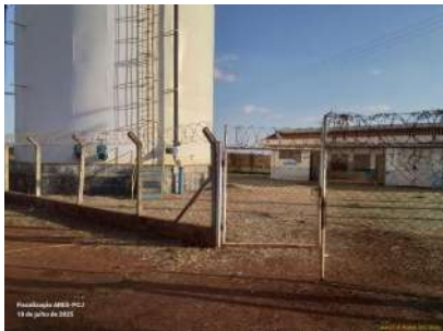
Foto 2 - Acesso ao poço.
