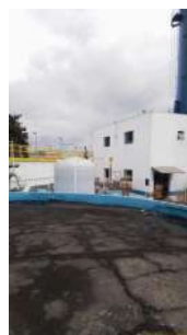
Foto 40 - Vista da ETA.
