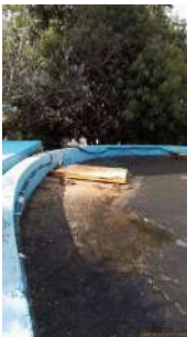
Foto 5 - Tampa de inspeção.
