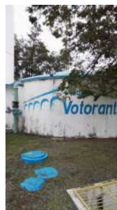
Foto 6 - Visão geral do reservatório apoiado.
