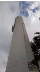
Foto 1 - Reservatório elevado Pq Bela Vista
