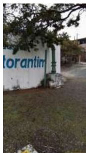
Foto 5 - Abastecimento do reservatório.
