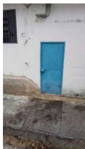
Foto 5 - Acesso à casa de bombas
