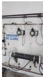
Foto 2 - Sistema de geração de cloro a partir de sal.
