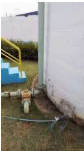
Foto 4 - Alimentação do reservatório.
