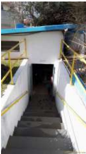
Foto 1 - Acesso à casa de bombas.
