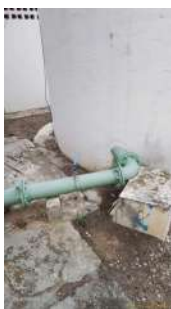
Foto 3 - Saída do reservatório.
