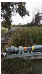
Foto 1 - Mato alto na área das bombas.
