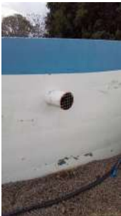
Foto 3 - Extravasor com tela de proteção.
