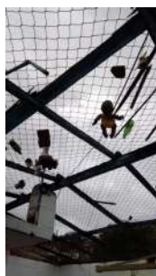
Foto 1 - Foi instalada tela sobre a a área da elevatória para evitar que objetos sejam jogados no local.
