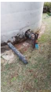
Foto 2 - Saídas do reservatório.
