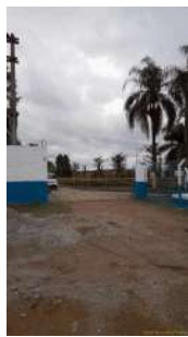
Foto 1 - Entrada da elevatória, antiga ETE.
