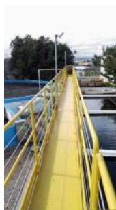
Foto 26 - Guarda-corpo da ETA.
