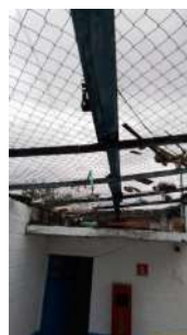
Foto 2 - Tela para evitar que dejetos entrem na elevatória.
