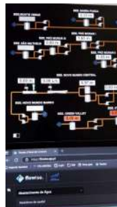
Foto 32 - Visualização das elevatórias central e bairro Novo Mundo no CCO.
