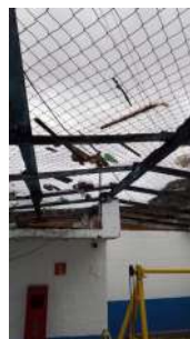
Foto 3 - Tela para evitar que dejetos entrem na elevatória.
