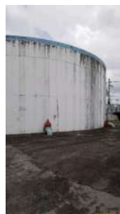
Foto 8 - Visão geral do reservatório.
