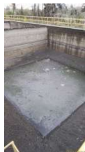
Foto 6 - Um dos tanques da antiga ETE.
