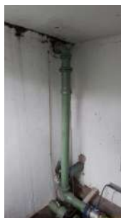
Foto 8 - Alimentação do reservatório.
