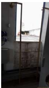
Foto 7 - Acesso à elevatória
