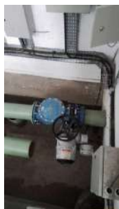
Foto 16 - Entrada do reservatório.
