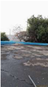
Foto 4 - Cobertura do reservatório.
