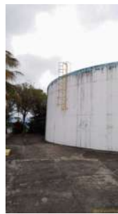
Foto 2 - Reservatório e escada para acessar a cobertura.
