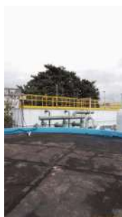
Foto 39 - Vista da ETA a partir do reservatório semi enterrado.
