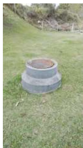
Foto 14 - PV na chegada do efluente à elevatória.
