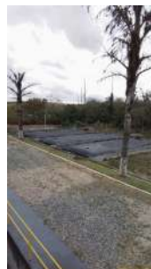
Foto 19 - Visualização de BAGs para secagem de lodo da antiga ETE.
