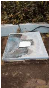
Foto 5 - Tampa para inspeção.
