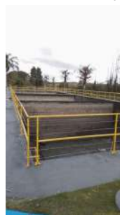
Foto 4 - Tanques da antiga Estação de Tratamento que foi desativada.
