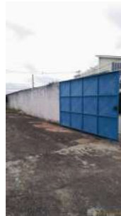
Foto 4 - Portão de acesso.
