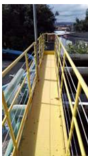
Foto 25 - Guarda-corpo na passarela da ETA compacta.
