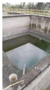
Foto 7 - Um dos tanques da antiga ETE.
