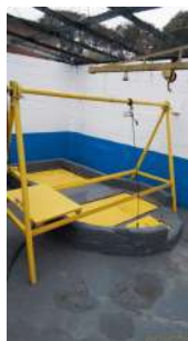
Foto 4 - Poços de sucção.
