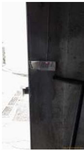
Foto 12 - Alarme situado na câmara inferior do reservatório elevado.
