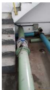
Foto 13 - Saída e extravasor.
