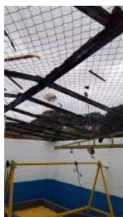
Foto 4 - Tela para evitar que dejetos entrem na elevatória.
