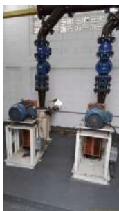
Foto 10 - Bombas centrífugas.
