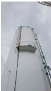
Foto 1 - Reservatório elevado. Visualiza-se escada com proteção para acessar a cobertura, tubulações de alimentação e extravasor.
