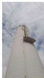
Foto 8 - Escada para acessar a cobertura.
