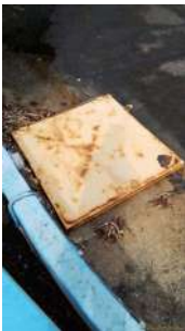
Foto 6 - Tampa de inspeção.
