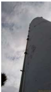
Foto 3 - Alimentação do reservatório a partir do reservatório semi enterrado.
