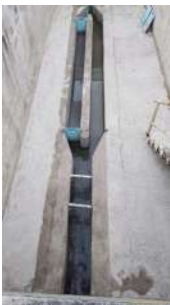
Foto 3 - Gradeamento e caixa de areia.
