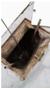
Foto 5 - Cesto peneira para remoção de sólidos.
