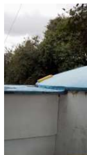
Foto 17 - Tampa de inspeção.
