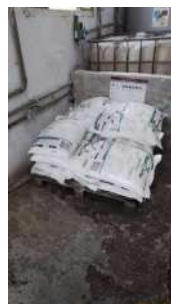
Foto 4 - Sal utilizado na geração de cloro para tratamento.
