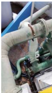
Foto 23 - Tubulação em azul realiza pós cloração.
