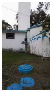
Foto 4 - Abastecimento do reservatório.
