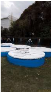
Foto 2 - Sistema de fossas filtro desativado.
