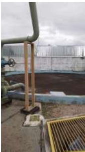
Foto 2 - Reservatório semi enterrado
