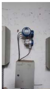
Foto 11 - Macromedidor na entrada do reservatório.
