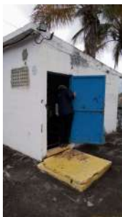
Foto 9 - Portão de acesso à casa de bombas.
