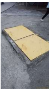
Foto 2 - Poços na entrada do efluente.
