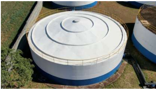
Foto 5 - Vista superior do reservatório Klavin 3
