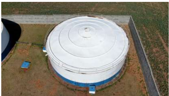
Foto 6 - Vista superior do reservatório Klavin 2
