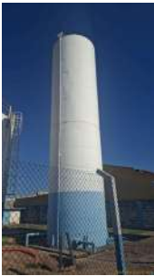
Foto 1 - Cercamento da área e reservatório São Francisco
