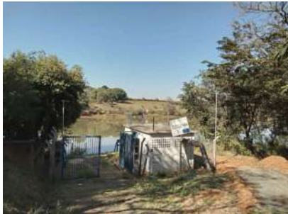
Foto 1 - Vista externa da captação córrego Palmital
