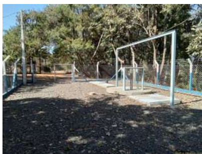
Foto 6 - Cercamento da área
