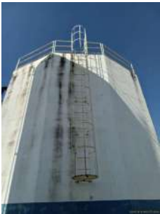
Foto 3 - Escada de acesso e guarda-corpo
