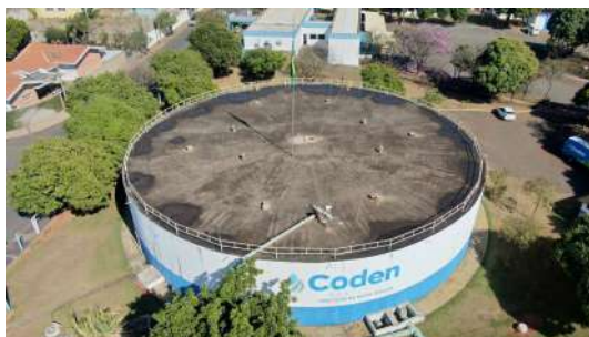
Foto 2 - Vista superior do reservatório
