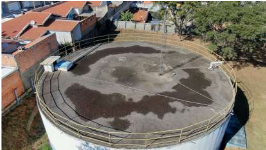
Foto 9 - Vista superior do reservatório Santa Luiza
