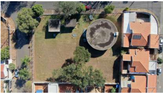
Foto 8 - Vista superior do reservatório Santa Luiza, EEAT São Francisco e EEAT Terra Nova
