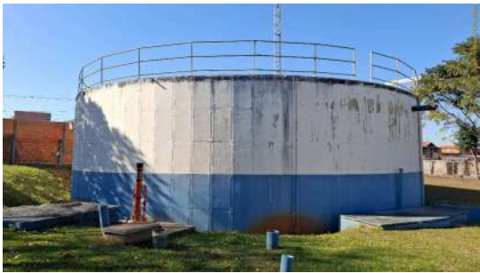
Foto 7 - Vista lateral do reservatório Santa Luiza
