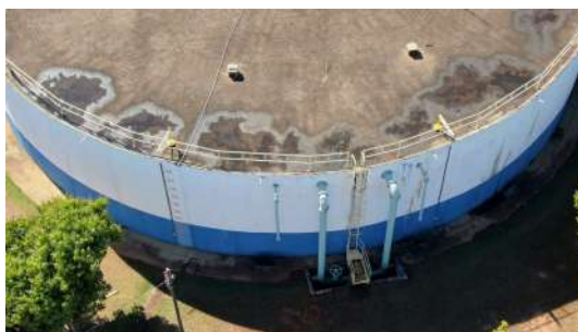
Foto 3 - Escada de acesso e guarda-corpo
