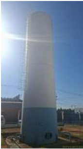
Foto 3 - Vista do interior da área do reservatório São Francisco
