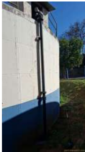
Foto 5 - Entrada de água
