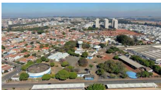
Foto 4 - Vista superior do reservatório 5000, Castelo, ETA e sede da CODEN
