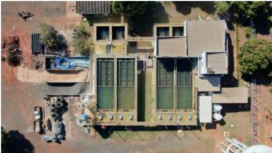
Foto 4 - Vista superior da ETA
