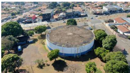
Foto 1 - Vista lateral da área do reservatório Castelo
