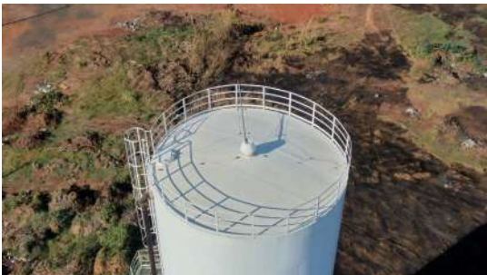
Foto 2 - Vista superior do reservatório Pós Anhanguera
