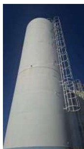
Foto 4 - Escada de acesso e guarda-corpo
