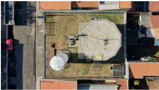
Foto 5 - Vista superior do cercamento da área dos reservatórios
