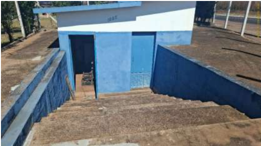
Foto 2 - Vista interna da área do booster Klavin
