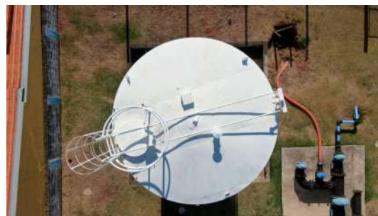
Foto 7 - Vista superior do reservatório elevado São Francisco
