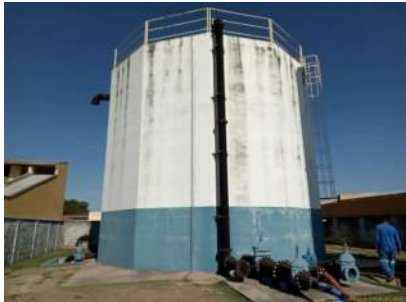
Foto 1 - Reservatório São Francisco apoiado
