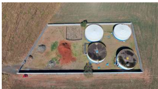
Foto 5 - Vista superior do cercamento da área do Centro de Reservação Klavin
