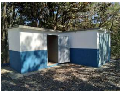
Foto 4 - Casa do gerador e painéis
