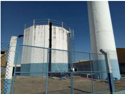
Foto 4 - Vista externa dos reservatórios São Francisco
