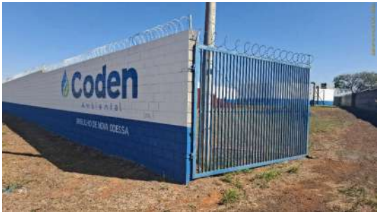
Foto 1 - Portão de acesso
