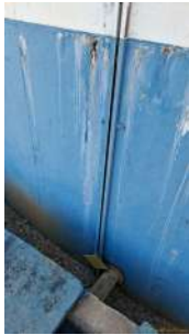
Foto 3 - Medidor de nível
