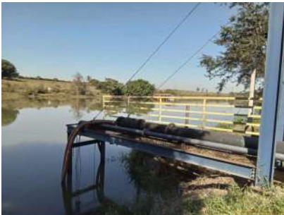
Foto 3 - Tomada de água
