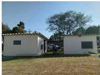
Foto 6 - Casa de bombas São Francisco e Terra Nova
