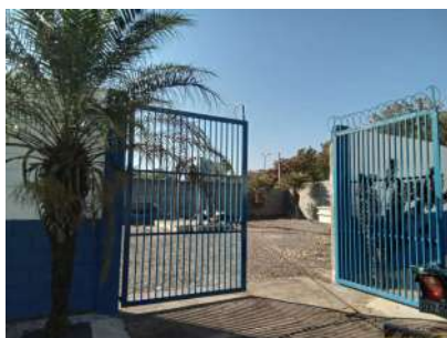
Foto 1 - Portão de acesso
