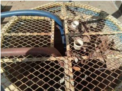
Foto 4 - Poço de sucção
