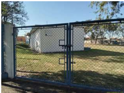
Foto 1 - Portão de acesso a EEAT São Francisco, Terra Nova e reservatório
