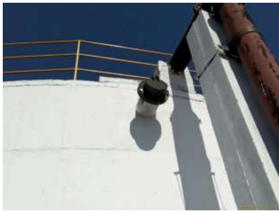
Foto 2 - Saída do tubo extravasor
