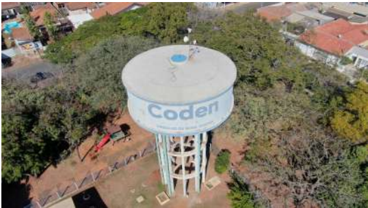
Foto 1 - Vista lateral do reservatório Castelo
