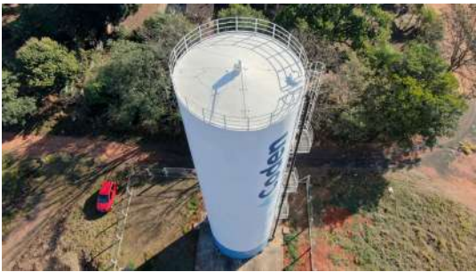
Foto 4 - Guarda-corpos e escada de acesso
