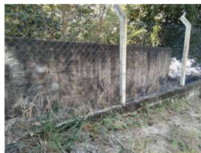
Foto 9 - Cercamento da área
