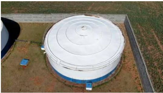
Foto 1 - Tampa de inspeção
