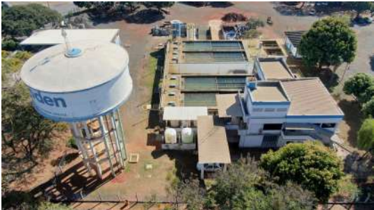
Foto 3 - Vista superior do reservatório Castelo e ETA
