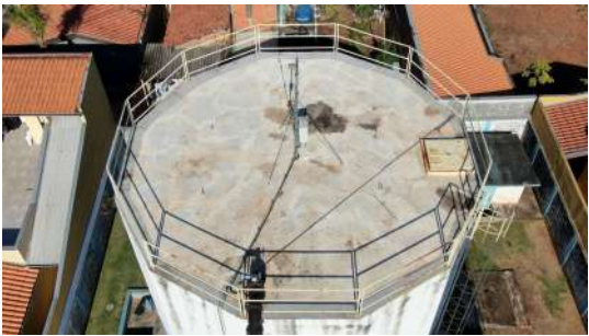
Foto 6 - Vista superior do reservatório apoiado São Francisco
