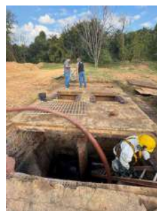
Foto 8 - limpeza do poço
