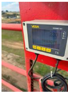
Foto 11 - medidor de vazão na entrada
