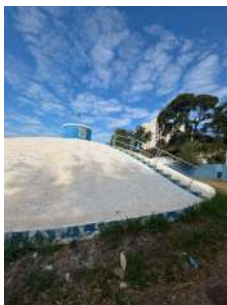
Foto 3 - Vista do reservatório
