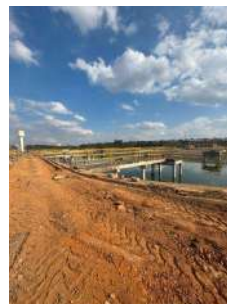
Foto 16 - Lagoa em adequação
