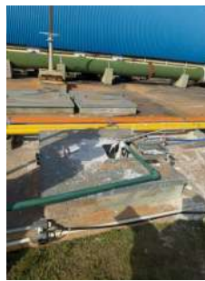
Foto 26 - Dosagem de cal
