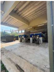
Foto 8 - Centrifugas de lodo
