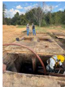
Foto 2 - Serviço de reforma do poço de sucção
