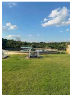
Foto 8 - Vista geral da ETE
