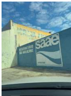
Foto 1 - Vista geral da fachada
