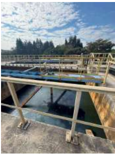
Foto 1 - Desarenador estava paralisado
