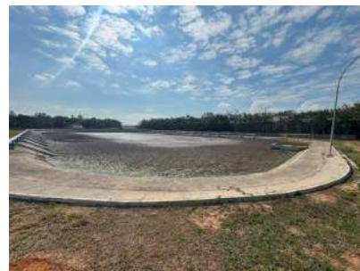
Foto 14 - Lagoa de aeração
