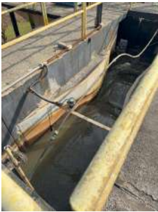
Foto 2 - MEdição de vazão na entrada de esgoto bruto
