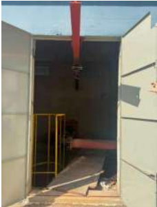
Foto 7 - Vista externa da casa de bombas
