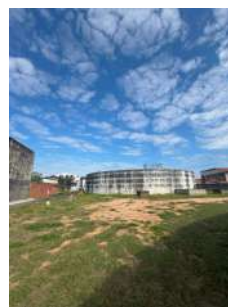
Foto 4 - Vista geral do reservatório
