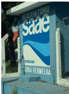
Foto 1 - Vista externa da unidade
