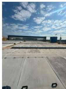
Foto 20 - Vista geral sob decantadores
