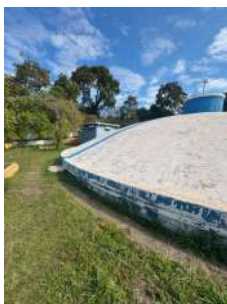
Foto 5 - Vista do reservatório
