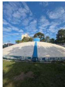
Foto 2 - Vista do reservatório
