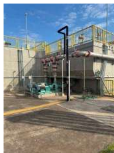
Foto 14 - Injeção de ozônio gasoso na água
