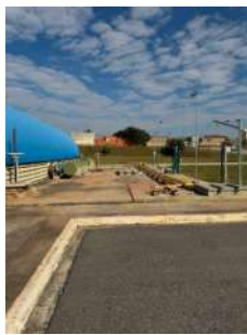
Foto 25 - Dosagem de cal
