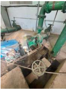
Foto 1 - Drenagem inadequada
