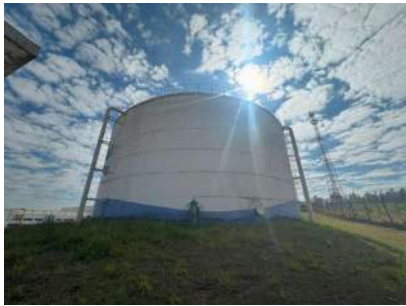
Foto 1 - Vista geral do reservatório
