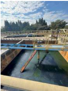
Foto 3 - Desarenador paralisado
