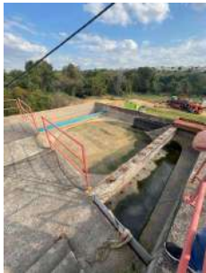
Foto 3 - Desarenador paralisado
