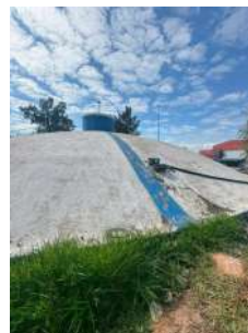
Foto 4 - Vista do reservatório
