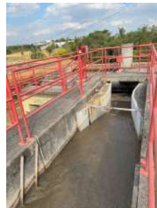
Foto 4 - Entrada de esgoto bruto
