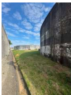
Foto 3 - Lateral do reservatório
