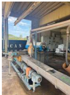
Foto 10 - Desaguamento do lodo
