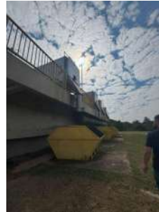
Foto 8 - Caçamba de resíduos
