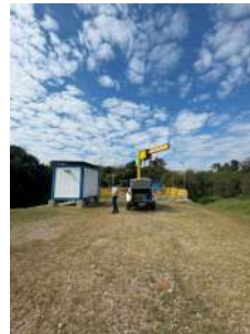
Foto 10 - Vista da Elevatória de baixa
