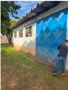
Foto 2 - Casa de bombas
