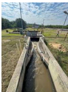
Foto 3 - Entrada de esgoto bruto
