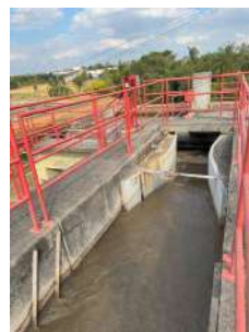
Foto 10 - Canal de entrada
