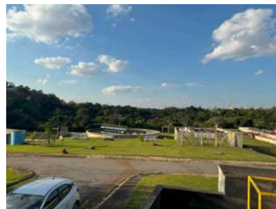
Foto 6 - Vista geral da ETE
