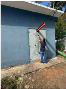
Foto 2 - Cada de bombas
