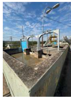
Foto 10 - Entrada de esgoto bruto
