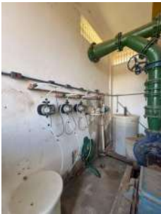
Foto 3 - Bombas dosadora de fluor
