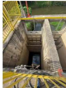
Foto 12 - Poço de sucção
