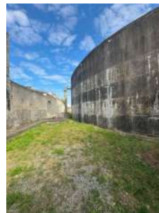
Foto 2 - Vista geral do reservatório
