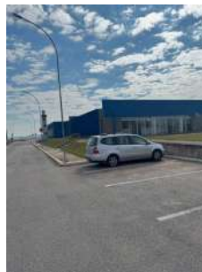
Foto 32 - Vista geral da ETA
