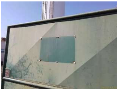
Foto 1 - Local previsto para instalação da placa de identificação.
