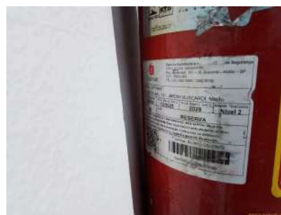
Foto 4 - Validade do extintor.
