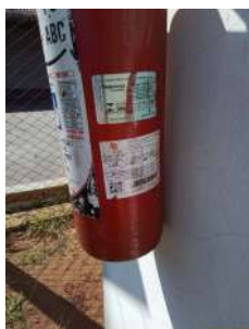
Foto 10 - Validade do extintor.
