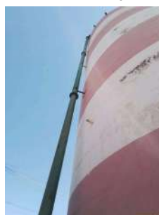
Foto 7 - Extrapasor da câmara superior.
