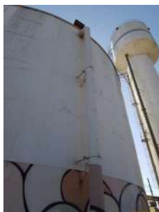
Foto 1 - Extravasor do reservatório.
