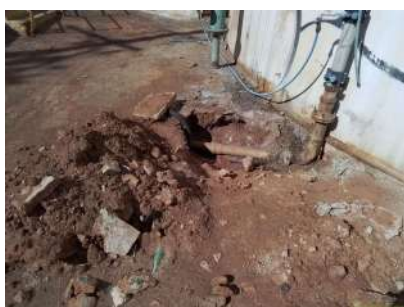
Foto 5 - Recentemente, foi realizada manutenção na interligação do reservatório.
