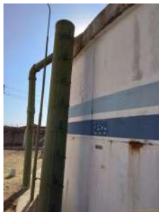
Foto 1 - Detalhe da escada.
