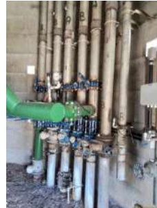
Foto 4 - Registros no interior do reservatório.
