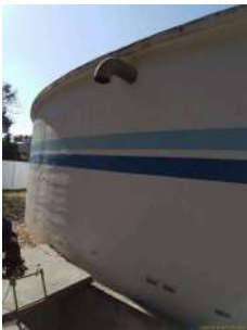
Foto 1 - Extravisor do reservatório.
