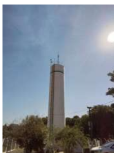
Foto 7 - Vista afastada do reservatório.
