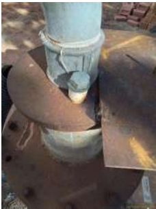
Foto 4 - Tubo de medição de nível.
