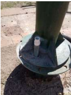
Foto 2 - Tubo de medição de nível.
