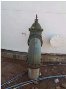
Foto 3 - Saída do reservatório.
