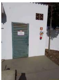
Foto 3 - Extintor no local.
