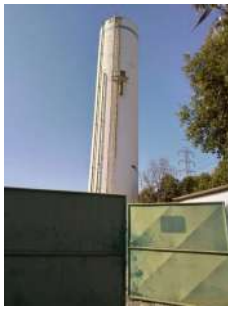
Foto 1 - Vista do reservatório e cercamento.
