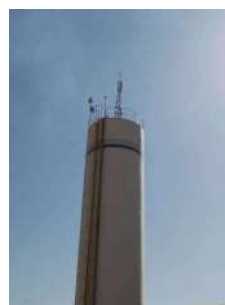
Foto 8 - Detalhe do topo do reservatório.
