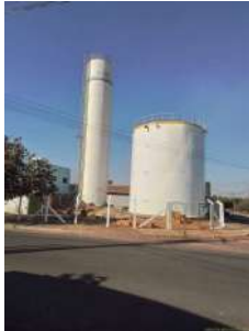
Foto 7 - Vista dos reservatórios no local.
