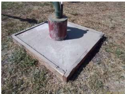
Foto 3 - Laje do poço.
