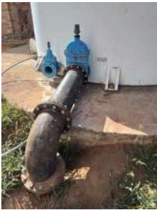
Foto 3 - Saída do reservatório.
