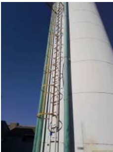
Foto 2 - Detalhe do guarda-corpo.
