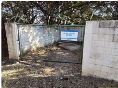
Foto 1 - Cercamento da EEE.
