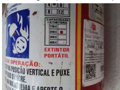
Foto 9 - Validade do extintor.
