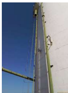
Foto 6 - Detalhe da escada com guarda-corpos.
