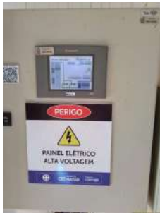
Foto 7 - Conversor 1 do macromedidor.
