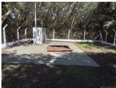
Foto 3 - Vista da EEE.
