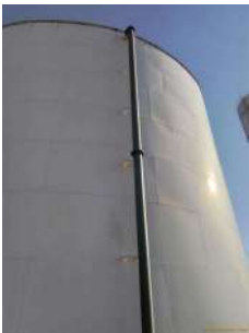
Foto 4 - Extravisor do reservatório.
