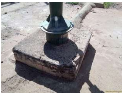
Foto 3 - Detalhe da laje.
