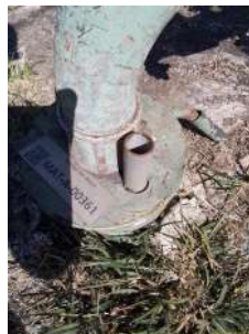
Foto 8 - Tubo de medição de nível.
