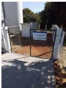
Foto 1 - Cercamento da área.
