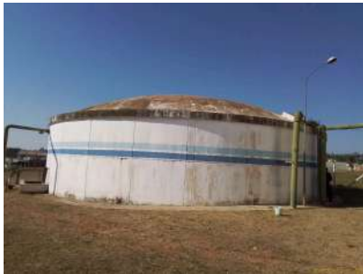
Foto 1 - Vista do reservatório apoiado.
