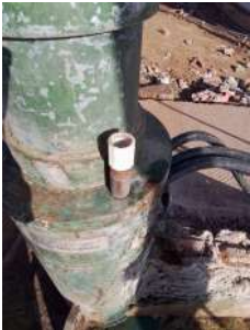
Foto 4 - Tubo de medição de nível.
