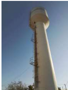
Foto 1 - Vista do reservatório.
