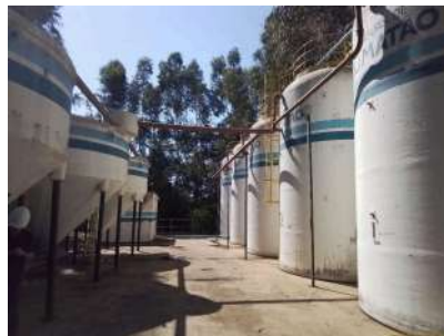
Foto 13 - Vista da ETE.
