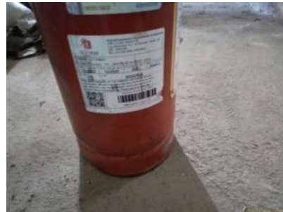
Foto 4 - Validade do extintor.
