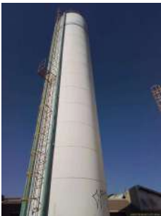
Foto 1 - Vista do reservatório.
