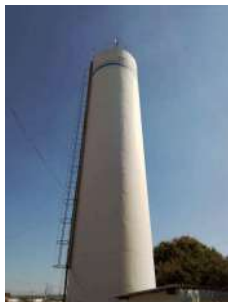
Foto 3 - Reservatório Vila Maria.
