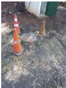
Foto 12 - O lodo armazenado é retirado através deste PV sinalizado pelos cones.
