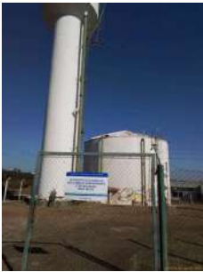
Foto 1 - Vista dos reservatórios.
