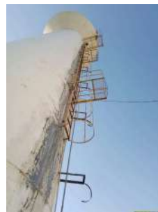
Foto 4 - Detalhe da escada com guarda-corpos.
