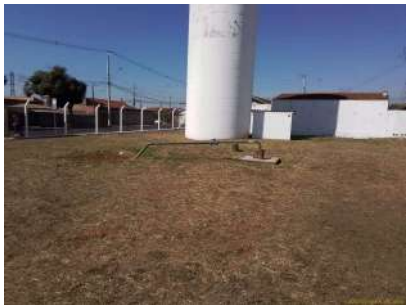
Foto 2 - Vista do poço com o reservatório desativado ao fundo.
