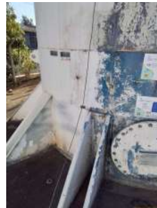
Foto 2 - Condutor de descida do para-raios.
