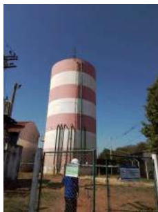
Foto 1 - Vista do reservatório.
