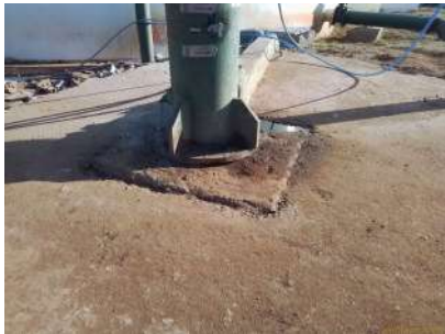
Foto 5 - Detalhe da laje.
