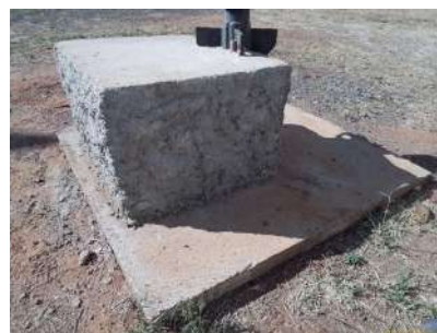
Foto 4 - Laje do poço.
