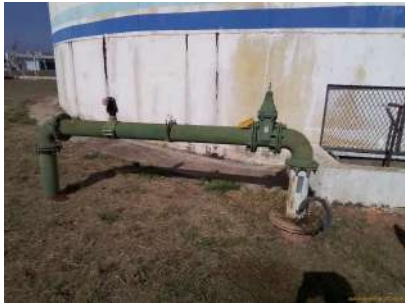
Foto 1 - Tubulação do booster.
