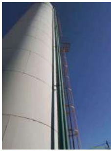
Foto 5 - Extravasor do reservatório.
