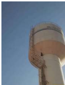
Foto 5 - Captor Franklin no topo do reservatório.
