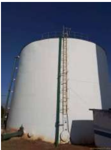
Foto 1 - Vista do reservatório apoiado.
