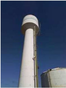
Foto 3 - Saída do reservatório.
