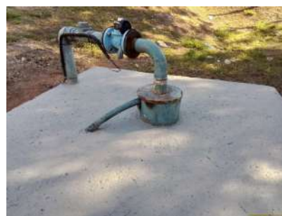
Foto 6 - Laje do poço.
