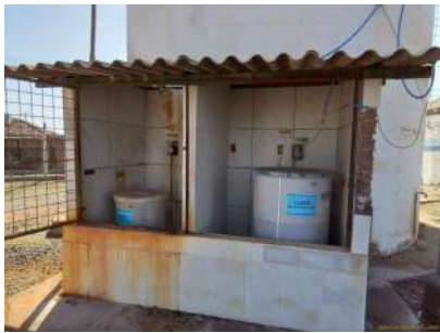
Foto 5 - Cloro e flúor aplicado na água captada pelo poço.
