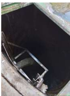
Foto 10 - Tampa de inspeção do poço.
