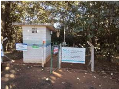
Foto 1 - Vista da EEE.
