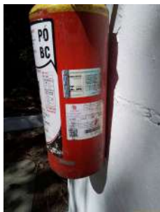
Foto 7 - Validade do extintor.
