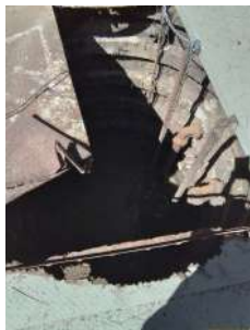
Foto 5 - Poço de sucção.
