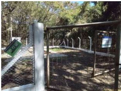
Foto 1 - Cercamento da EEE.
