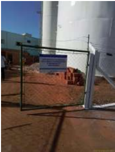
Foto 1 - Cercamento do local.
