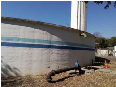
Foto 2 - Vista do reservatório.
