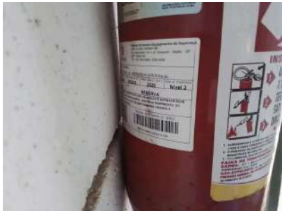
Foto 8 - Validade do extintor.
