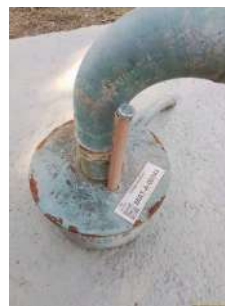
Foto 4 - Tubo de medição de nível.
