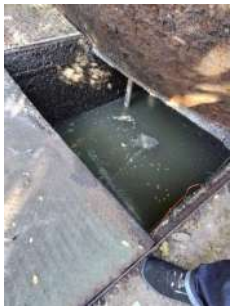
Foto 5 - Poço de sucção.
