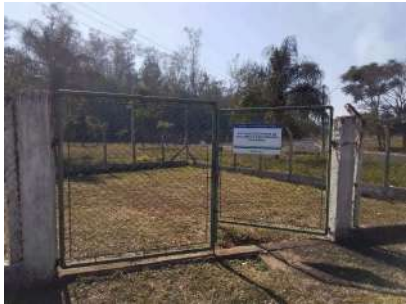
Foto 1 - Cercamento do poço.
