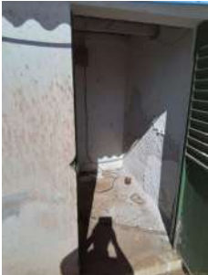
Foto 3 - Abrigo da EEA.
