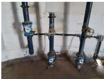
Foto 8 - Registros no interior do reservatório.
