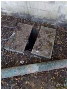
Foto 1 - Detalhe da tampa de inspeção.
