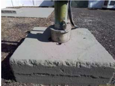
Foto 3 - Detalhe da laje.
