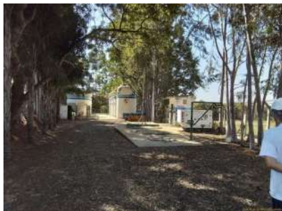
Foto 3 - Vista da ETE.
