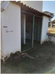
Foto 1 - Abrigo do booster.
