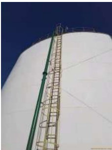
Foto 2 - Detalhe da escada com guarda-corpo.
