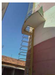
Foto 6 - Escada com guarda-corpo.
