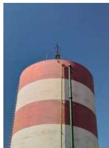
Foto 2 - Detalhe do captor Franklin no topo.
