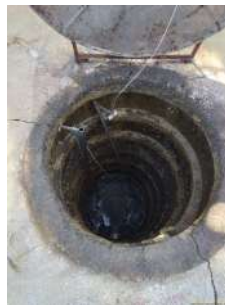
Foto 4 - Chegada do esgoto bruto (tampa aberta).
