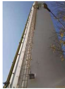
Foto 2 - Detalhe da escada com guarda-corpo.
