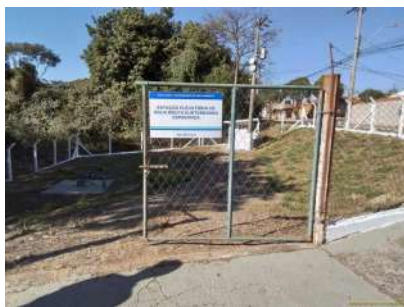
Foto 1 - Cercamento do local.
