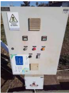
Foto 5 - Especificações da bomba da EEE.
