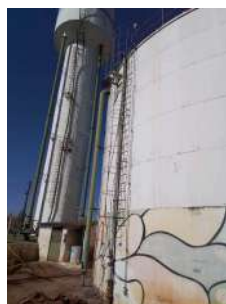
Foto 4 - Escada com guarda-corpo para acesso ao topo do reservatório.
