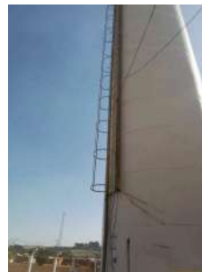
Foto 4 - Detalhe da escada com guarda-corpo.
