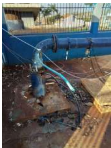
Foto 1 - Torneira e mangueira para coleta de água bruta.
