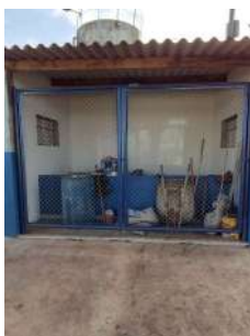
Foto 14 - Novo abrigo de produtos químicos.
