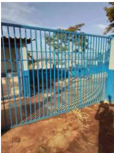
Foto 2 - Portão de acesso.
