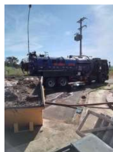
Foto 3 - Caminhão hidrovácuo realizando remoção de efluente
