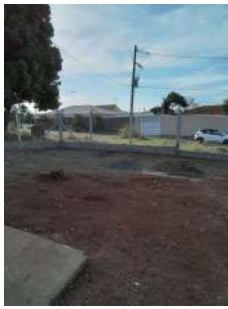
Foto 16 - Cercamento da área.
