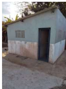
Foto 10 - Novo abrigo de produtos químicos em reforma.
