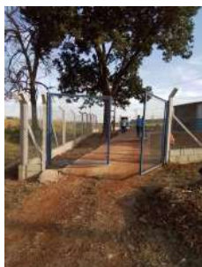
Foto 3 - Portão de acesso.
