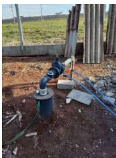
Foto 8 - Cavalete do poço. Será executada laje de proteção.
