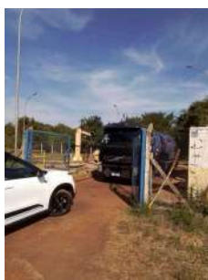
Foto 13 - Entrada da elevatória e caminhão limpa fossa removendo o esgoto acumulado nos poços na estação.
