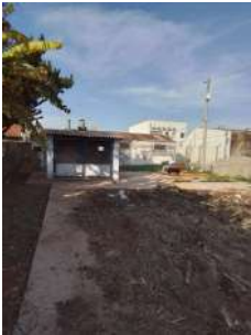
Foto 2 - Vista da área da captação.
