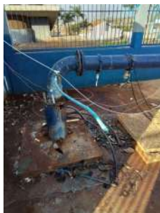
Foto 10 - Torneira e mangueira para coleta de água bruta.
