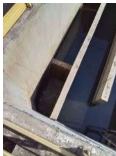
Foto 15 - Saída do efluente das chicanas.
