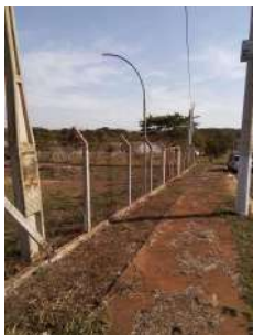
Foto 3 - Cercamento da área
