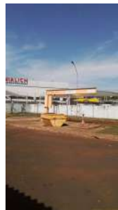
Foto 5 - Visão geral da elevatória.
