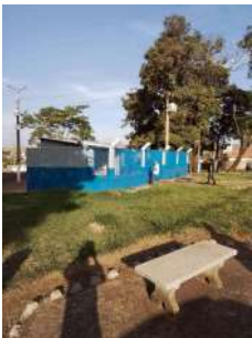
Foto 1 - Visão geral da área do poço.
