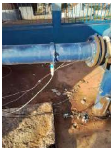
Foto 6 - Aplicação de produtos químicos.
