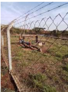
Foto 2 - Visão do sistema de bombeamento. Não foi possível entrar na área.
