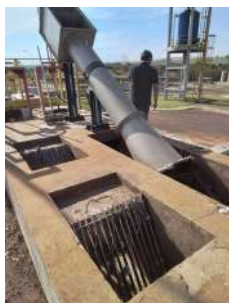
Foto 4 - Gradeamento e peneiramento.
