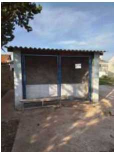
Foto 3 - Novo abrigo de produtos químicos sendo finalizado.
