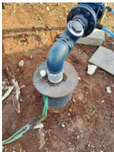
Foto 1 - Tubo para medição de nível.
