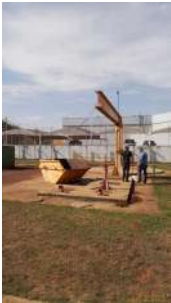
Foto 2 - Braço com talha para manutenção e içamento de equipamentos.
