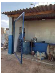
Foto 5 - Interior do novo abrigo de produtos químicos.
