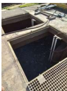
Foto 9 - Poço de sucção da elevatória, sem bombas instaladas no momento da inspeção.
