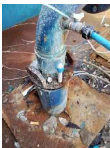
Foto 1 - Tubo para medição de nível.
