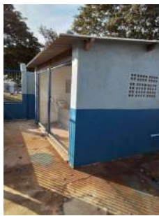
Foto 3 - Novo abrigo de produtos químicos. O antigo foi demolido.
