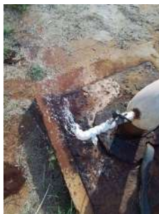
Foto 6 - Torneira para coleta de água no cavalete.
