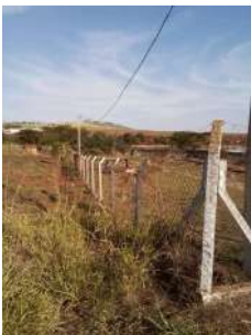
Foto 4 - Cercamento da área
