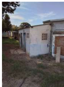
Foto 7 - Antigo abrigo de produtos químicos.
