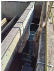
Foto 16 - Calha parshal na saída das chicanas
