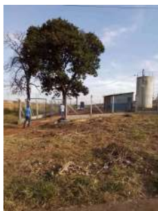
Foto 1 - Visão geral da área do poço Monte Castelo. O reservatório está desativado.
