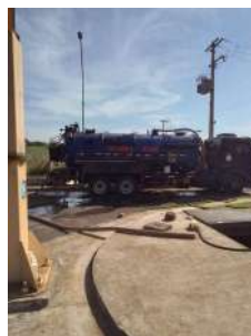
Foto 8 - Caminhão limpa fossa removendo o efluente.
