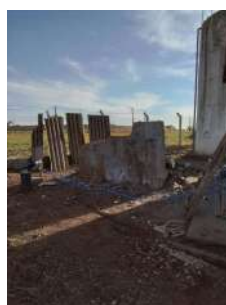
Foto 6 - Abrigo antigo estava sendo demolido.
