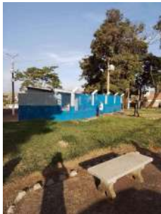
Foto 1 - Muro e cerca no perímetro da área.
