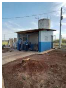
Foto 4 - Novo abrigo de produtos químicos do poço. O local ainda estava em obras.
