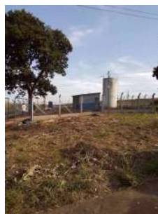
Foto 2 - Visão geral da área. O cercamento foi executado recentemente.
