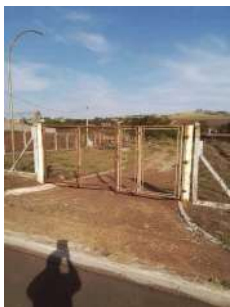
Foto 1 - Portão de acesso à área da elevatória.
