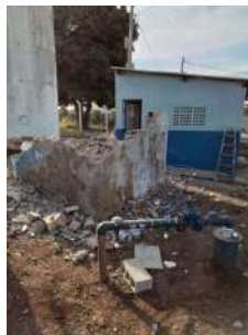
Foto 10 - Abrigo antigo sendo demolido.
