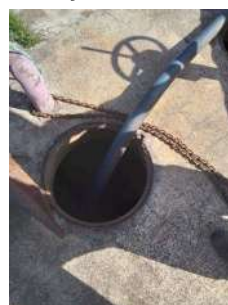
Foto 5 - Mangueira do caminhão hidrovácuo realizando a sucção de efluente.
