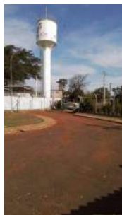
Foto 6 - Portão de acesso, muro e cercamento.
