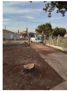
Foto 17 - Cercamento da área.
