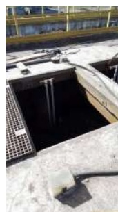
Foto 2 - Poço de sucção sem bombas em operação no momento da Fiscalização.
