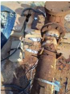
Foto 5 - Aplicação de produtos químicos no cavalete.
