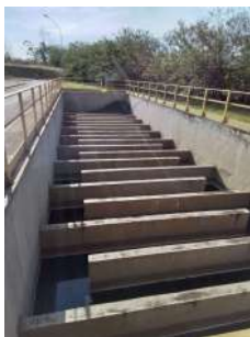
Foto 14 - Chicana antes do lançamento final da ETE.
