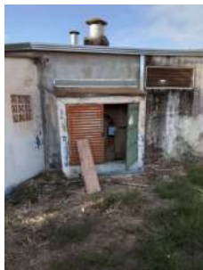
Foto 8 - Abrigo dos painéis de comando. Serão realocados para a nova construção.
