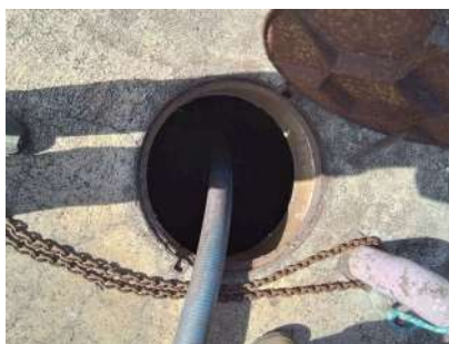
Foto 6 - Mangueira do caminhão hidrovácuo realizando a sucção de efluente.
