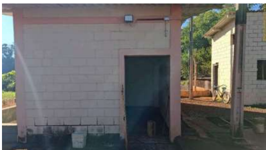
Foto 11 - Abrigo do poço de sucção.
