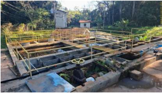
Foto 5 - Vista do tratamento.
