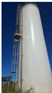
Foto 1 - Vista frontal do reservatório.
