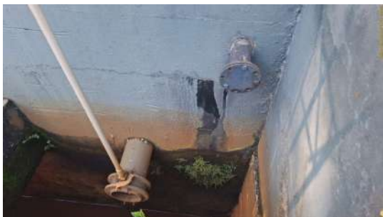
Foto 3 - Vazamento.
