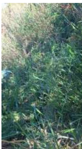
Foto 3 - Calha Parshall, escondida pelo mato alto.
