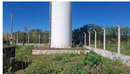
Foto 6 - Base do reservatório.
