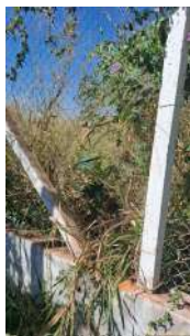
Foto 1 - Abertura no alambrado no fundo do terreno. do terreno.
