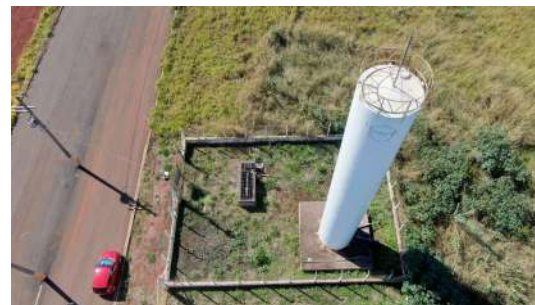
Foto 8 - Vista aérea do reservatório e do poço do Distrito Industrial.
