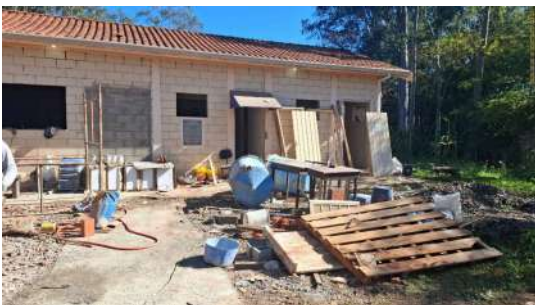
Foto 17 - Reforma da ETA.
