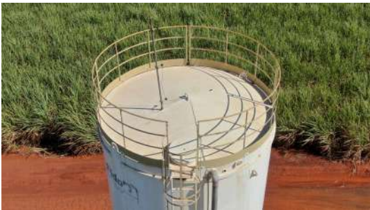
Foto 7 - Vista da cobertura do reservatório.
