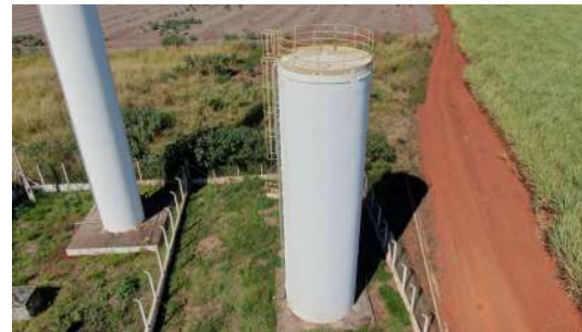
Foto 8 - Vista aérea do reservatório.
