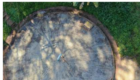
Foto 6 - Detalhe da cobertura do reservatório.
