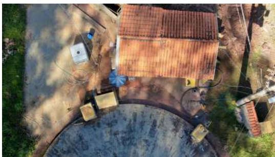
Foto 5 - Vista aérea da EEAT e do reservatório.
