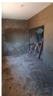
Foto 19 - Reforma sendo executada.
