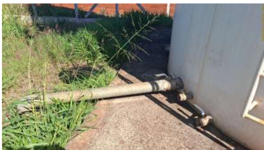
Foto 5 - Tubulação de saída e descarga do reservatório.
