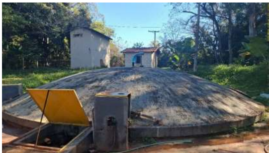
Foto 1 - Vista frontal do reservatório.
