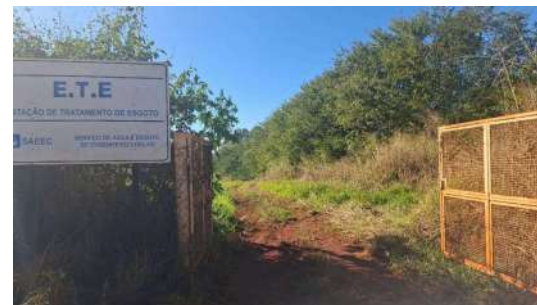
Foto 2 - Entrada da ETE.
