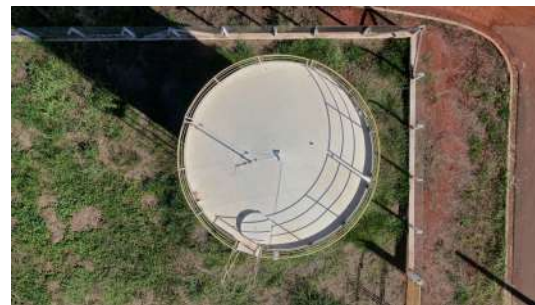
Foto 10 - Vista superior o reservatório.
