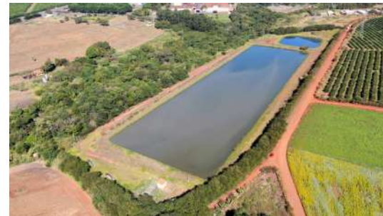
Foto 11 - Vista aérea da ETE.
