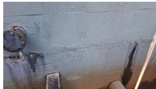
Foto 4 - Vazamentos
