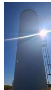
Foto 2 - Vista traseira do reservatório.
