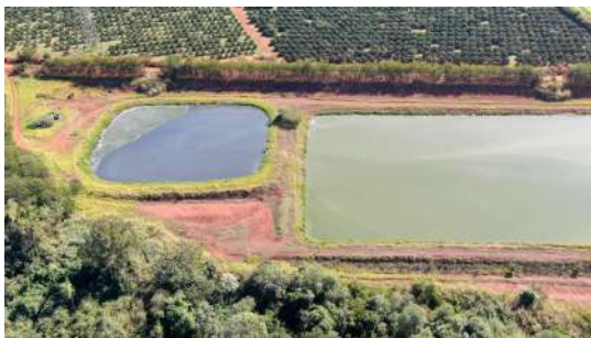
Foto 12 - Vista aérea da lagoa anaeróbia.
