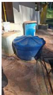
Foto 1 - Flúor sem bacia de contenção.
