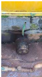
Foto 1 - Extravasor capeado.
