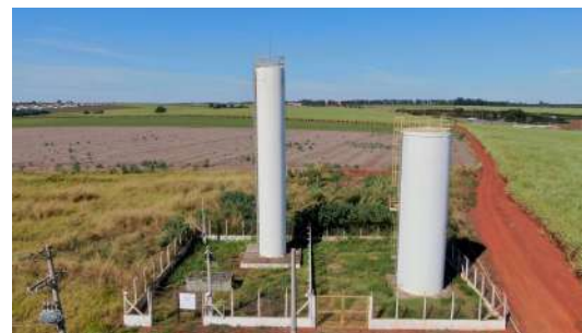
Foto 6 - Vista dos dois reservatórios: à esquerda, o Reservatório do Distrito Industrial; à direita, o Reservatório Parque dos Trabalhadores.
