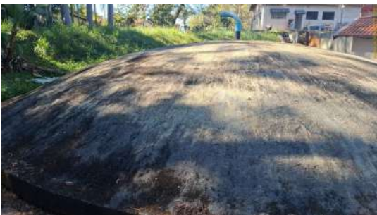
Foto 3 - Cobertura do reservatório.
