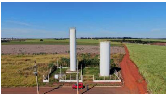
Foto 7 - Vista dos dois reservatórios, a esquerda o Reservatório do Distrito Industrial e a Direita o reservatório Parque dos Trabalhadores
