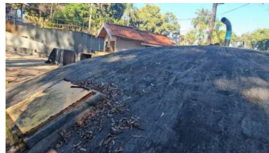
Foto 4 - Vista da cobertura.
