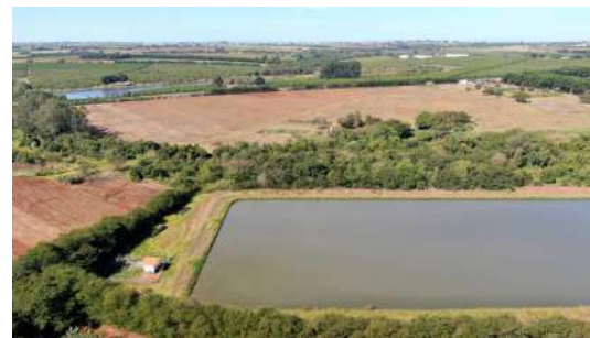
Foto 13 - Vista aérea da lagoa facultativa.
