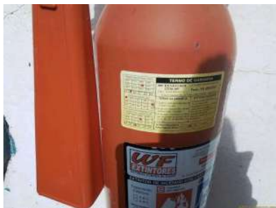
Foto 1 - Validade do extintor
