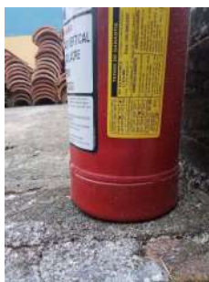
Foto 1 - Validade do extintor de incêndio
