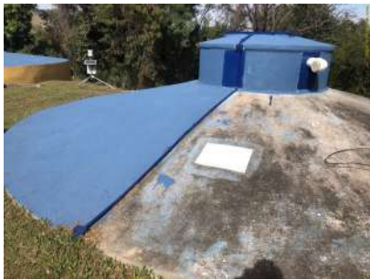
Foto 1 - Reservatório sem vazamentos aparentes
