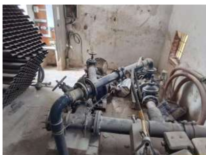
Foto 1 - Acesso para manutenção
