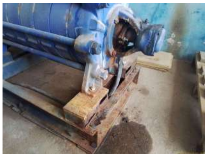
Foto 1 - Drenagem das gaxetas
