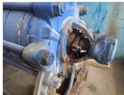
Foto 2 - Drenagem das gaxetas
