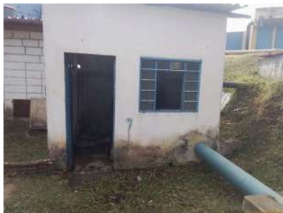
Foto 1 - Vista externa da EEA (local onde está o painel elétrico)
