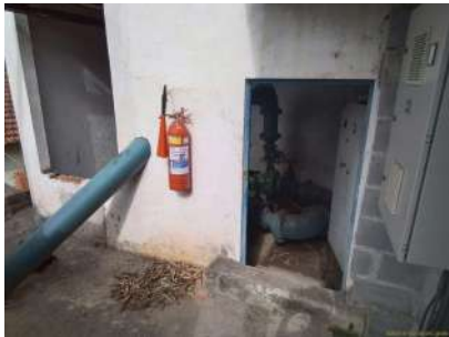
Foto 1 - Vista externa da EEA
