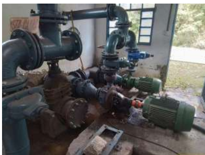
Foto 1 - Acesso para manutenção
