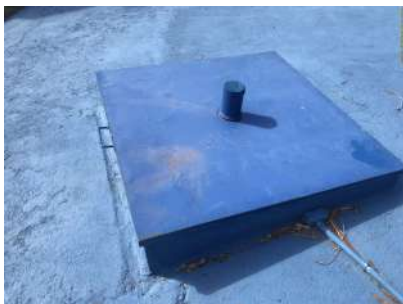
Foto 1 - Tampa de inspeção
