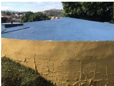
Foto 1 - Reservatório sem vazamentos aparentes
