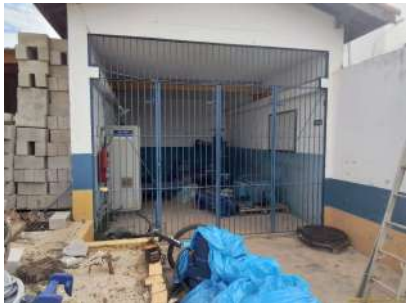
Foto 1 - Vista externa da EEA
