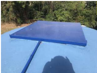
Foto 1 - Tampa de inspeção
