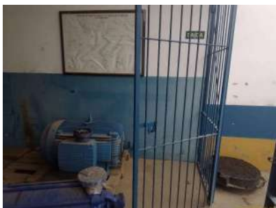
Foto 1 - Acesso para manutenção
