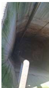
Foto 7 - Poço com cesto.
