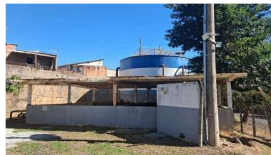
Foto 16 - Vista do leito de secagem de lodo.
