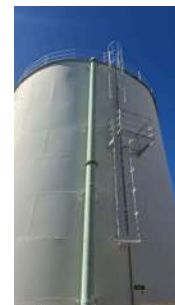
Foto 6 - Tubulação de entrada e escada marinheiro.
