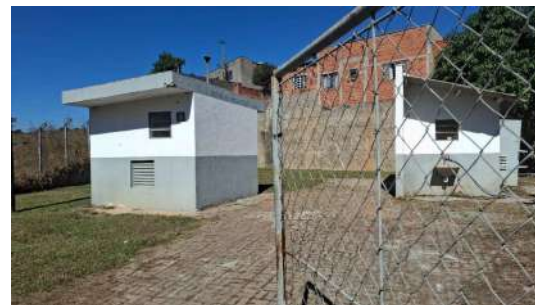
Foto 2 - Entrada da ETE.
