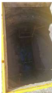
Foto 3 - Poço com o gradeamento.
