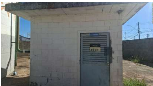
Foto 7 - Vista da EEA.
