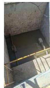
Foto 6 - Caixa de gordura.
