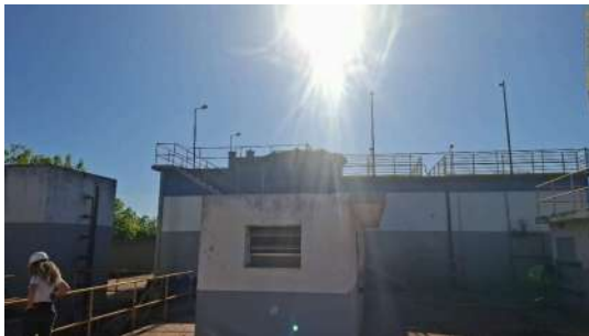
Foto 3 - Vista geral dos reatores.
