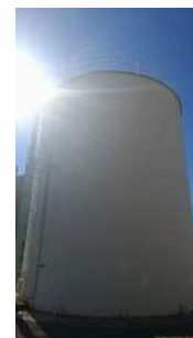
Foto 8 - Vista lateral do reservatório.
