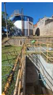
Foto 9 - Vista geral do tratamento primário e secundário.
