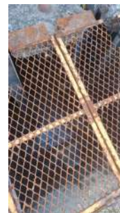
Foto 8 - Poço de sucção.
