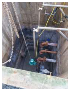
Foto 1 - Instalação da bomba reserva.
