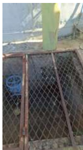
Foto 3 - Saída do extravasor.
