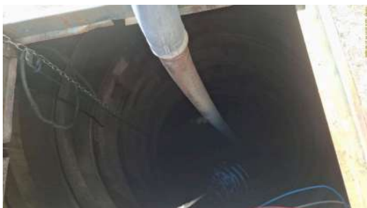
Foto 5 - Poço de sucção.
