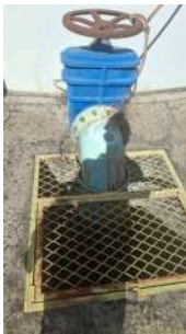
Foto 4 - Descarga do reservatório.
