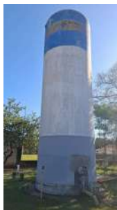
Foto 1 - Vista frontal do reservatório.
