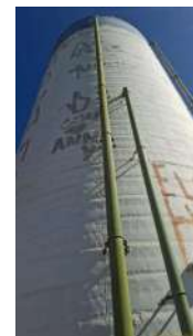
Foto 4 - Tubulação do extravasor da célula superior e tubulação de entrada da célula inferior.
