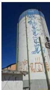
Foto 13 - Vista da lateral do reservatório.
