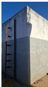
Foto 19 - Tanque de lodo.
