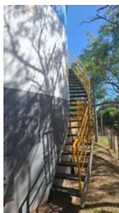
Foto 11 - Escada de entrada do reator.
