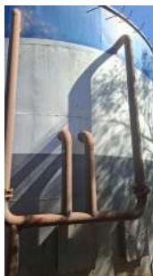
Foto 13 - Tubulações do reator.
