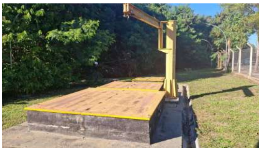
Foto 11 - Poços e guindaste para içamento.
