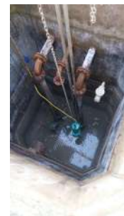
Foto 2 - Bomba reserva sendo instalada.
