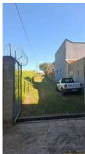
Foto 7 - Vista da entrada da EEE.
