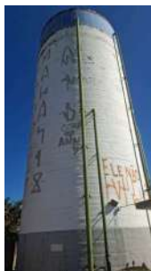
Foto 1 - Vista frontal do reservatório.
