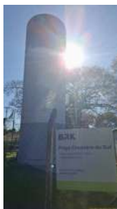
Foto 6 - Vista da placa e do reservatório.
