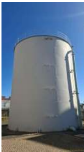
Foto 1 - Vista frontal do reservatório apoiado.
