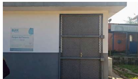
Foto 10 - Abrigo dos painéis de controle.
