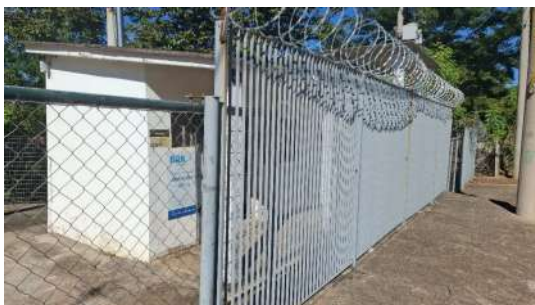
Foto 1 - Entrada da ETE.
