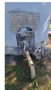
Foto 2 - Vista geral ponto do vazamento.
