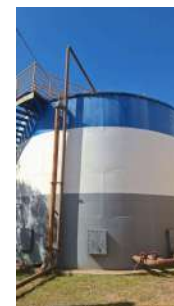
Foto 10 - Reator UASB com tratamento aeróbio.
