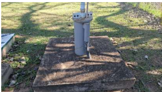
Foto 5 - Laje de proteção.
