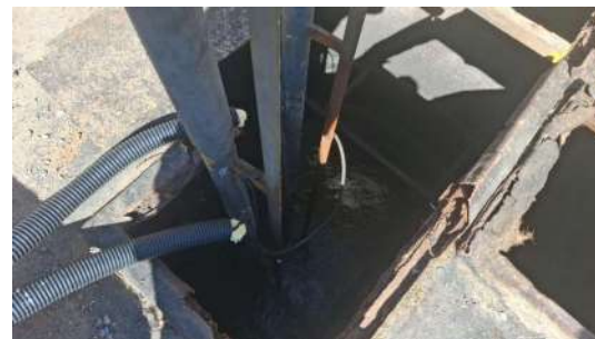
Foto 8 - Poço da elevatória.
