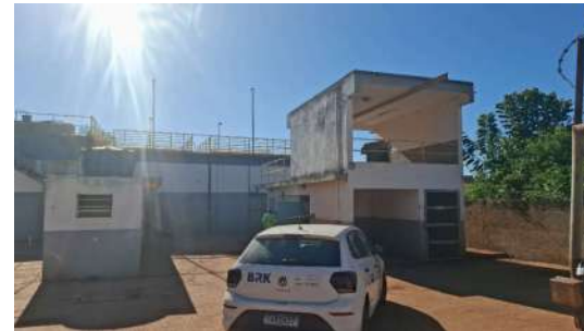
Foto 2 - Vista geral da ETE.
