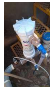
Foto 8 - Dosadora de pastilha de cloro.
