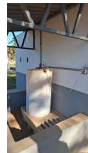
Foto 10 - Sistema de dosagem de flúor.
