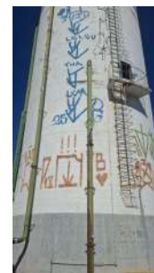
Foto 10 - Tubulação de saída.
