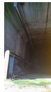
Foto 8 - Poço com cesto.
