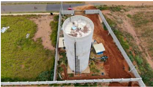
Foto 7 - Vista superior do cercamento da área do poço e reservatório
