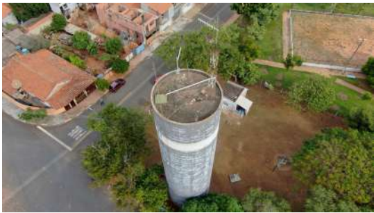
Foto 8 - Vista superior do reservatório e poço Santa Eudóxia
