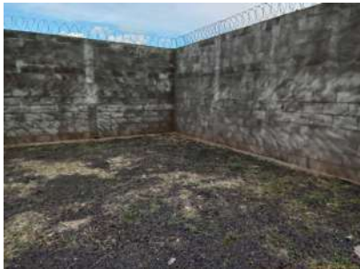
Foto 5 - Cercamento e limpeza da área
