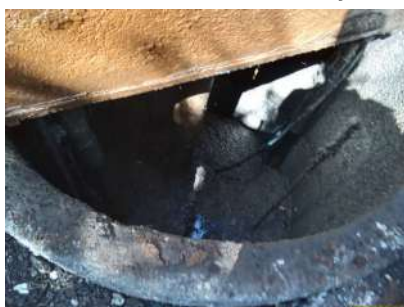
Foto 3 - Poço de sucção
