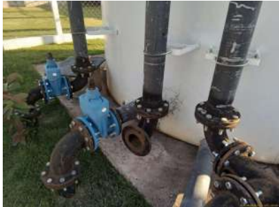
Foto 3 - Saída do tubo extravassor
