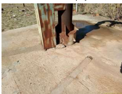
Foto 3 - Laje de proteção
