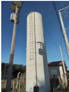
Foto 1 - Reservatório Portal do Vale
