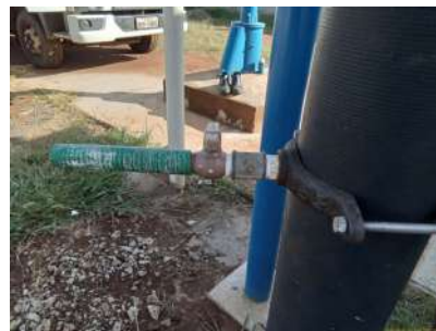
Foto 6 - Tomada para coleta de água bruta
