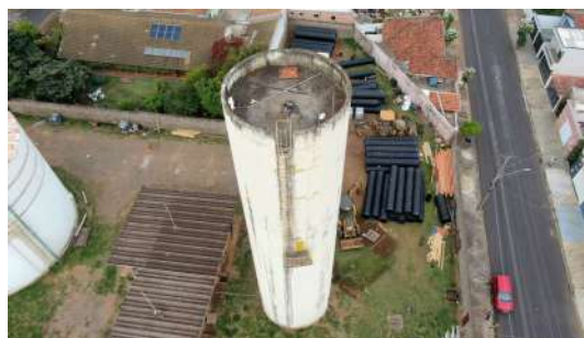
Foto 6 - Vista superior do reservatório
