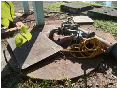
Foto 5 - Poço de sucção
