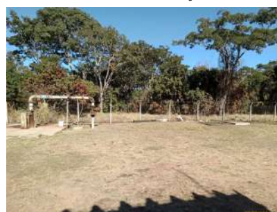
Foto 6 - Limpeza da área e cercamento do poço, reservatório e estação elevatória de água tratada Abdenur
