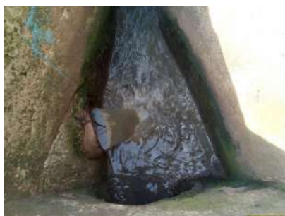
Foto 1 - Chegada do esgoto bruto
