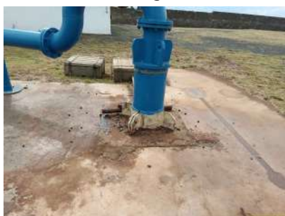
Foto 3 - Laje de proteção
