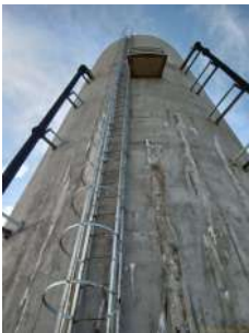
Foto 4 - Escada de acesso e guarda-corpo
