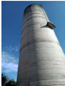
Foto 5 - Escada de acesso e guarda-corpo
