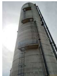
Foto 2 - Escada de acesso e guarda-corpo
