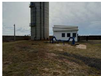
Foto 6 - Vista do poço e reservatório Jardins do Porto
