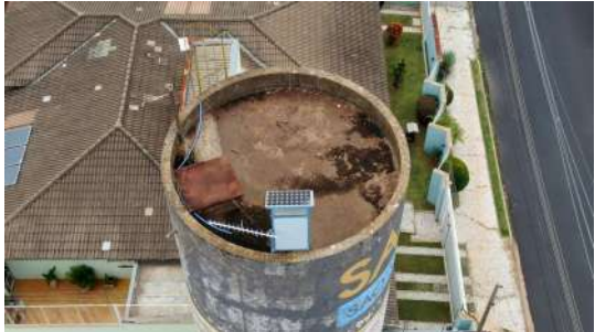
Foto 6 - Vista superior do reservatório
