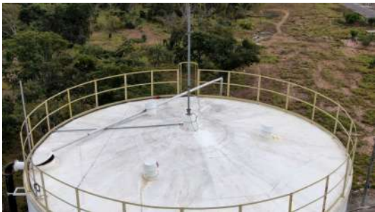
Foto 1 - Tampa de inspeção parcialmente aberta
