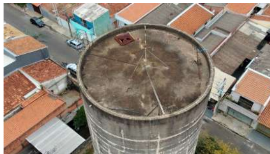
Foto 8 - Vista superior da laje de cobertura
