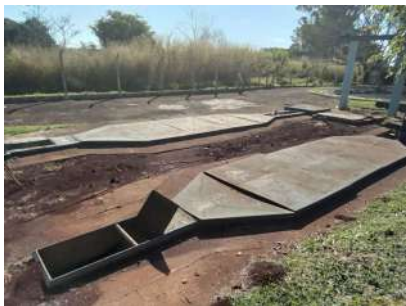
Foto 2 - Vista lateral do tratamento preliminar, composto por grades e caixa de areia
