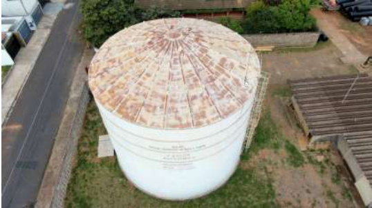
Foto 5 - Vista da cobertura
