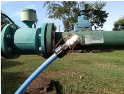
Foto 4 - Tomada para coleta de água bruta
