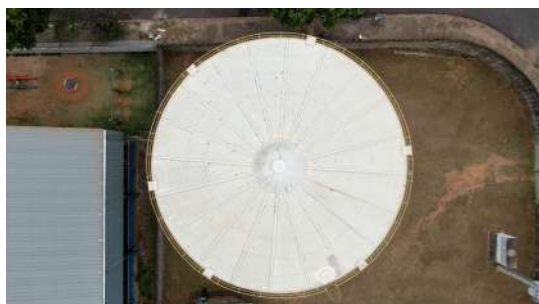
Foto 5 - Vista superior do reservatório Parque Industrial (apoiado)
