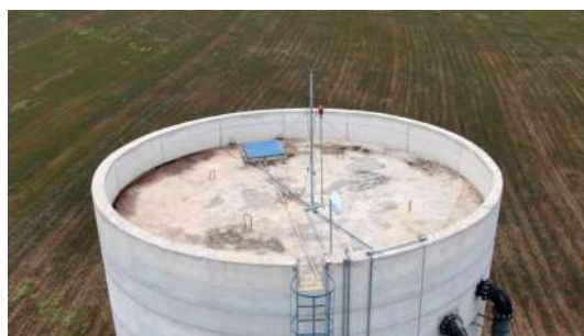
Foto 8 - Tampa de inspeção
