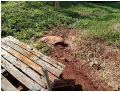
Foto 1 - Tubulação de lançamento de esgoto tratado
