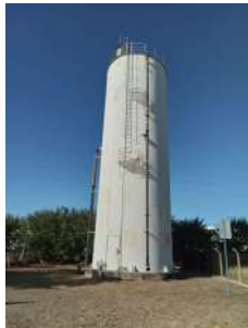
Foto 3 - Reservatório Parque Novo Mundo
