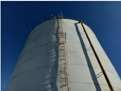
Foto 4 - Escada de acesso e guarda-corpo
