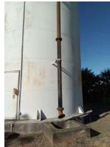
Foto 4 - Saída do tubo extravasor
