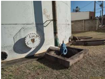
Foto 3 - Saída do tubo extravasor
