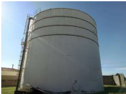
Foto 1 - Reservatório Nova Instância (apoiado)
