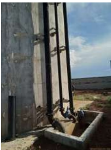
Foto 2 - Saída do tubo extravasor
