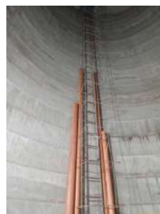
Foto 4 - Guarda-corpos na parte interna do reservatório
