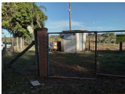
Foto 1 - Portão de acesso
