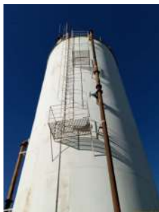
Foto 5 - Escada de acesso e guarda-corpo
