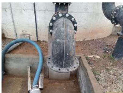
Foto 3 - Saída do tubo extravassor
