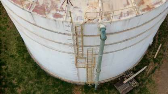
Foto 6 - Tampa de proteção
