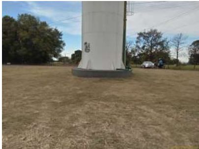
Foto 3 - Limpeza da área
