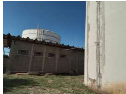
Foto 4 - Limpeza da área
