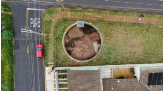
Foto 5 - Cercamento da área
