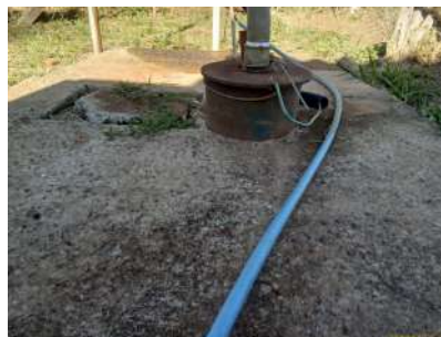
Foto 4 - Laje de proteção
