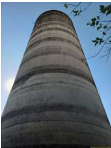
Foto 2 - Reservatório São Carlos VIII
