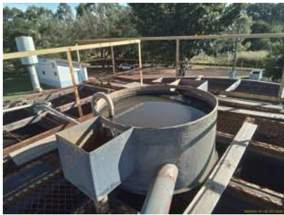
Foto 8 - Vista superior do UASB
