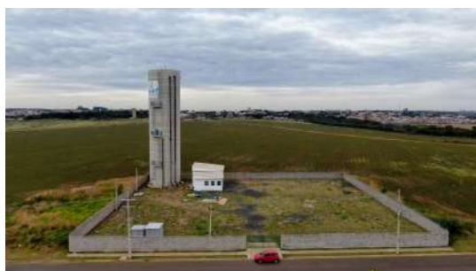
Foto 7 - Cercamento da área do poço e reservatório Jardim do Porto
