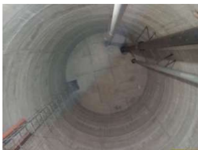
Foto 5 - Vista da laje de fundo
