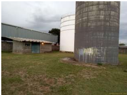
Foto 3 - Limpeza da área
