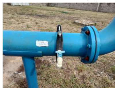
Foto 4 - Tomada para coleta de água bruta
