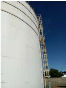
Foto 2 - Escada de acesso e guarda-corpo
