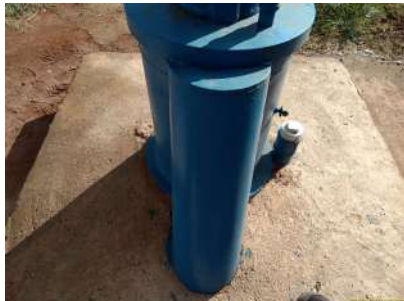
Foto 3 - Laje de proteção
