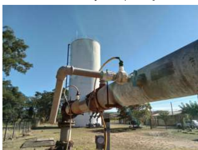
Foto 5 - Tomada para coleta de água bruta
