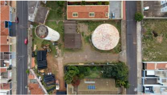
Foto 4 - Vista da área dos reservatórios e poço Nova Instância
