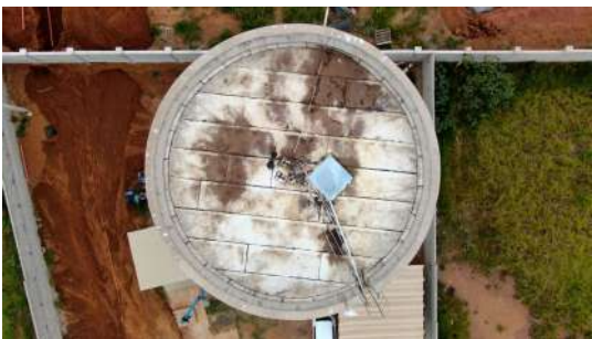
Foto 6 - Vista superior do reservatório
