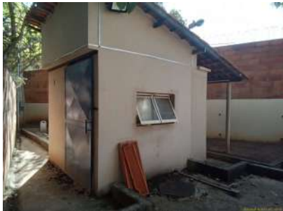
Foto 6 - Vista externa da casa de bombas
