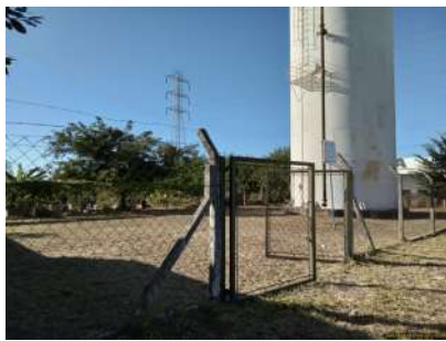
Foto 1 - Portão de acesso
