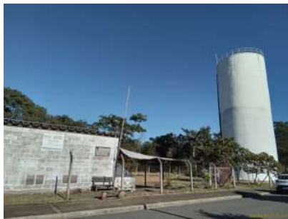
Foto 1 - Vista externa da área do reservatório e poço
