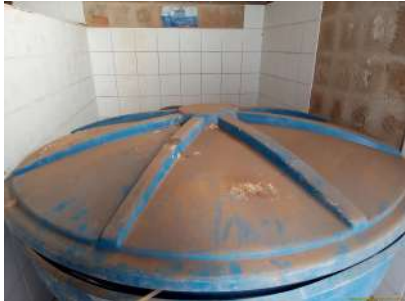
Foto 5 - Armazenamento de cloro
