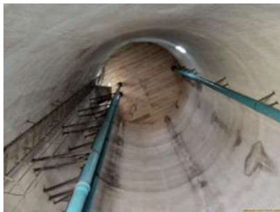
Foto 1 - Vista da laje de fundo
