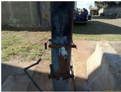
Foto 4 - Tomada para coleta de água bruta
