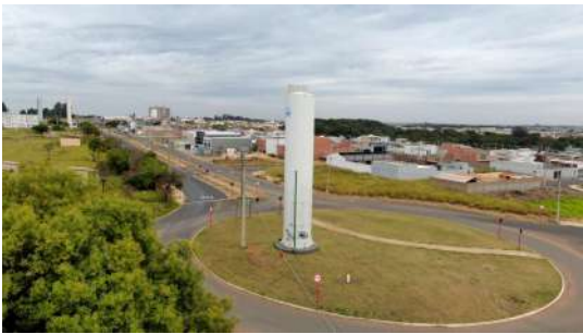
Foto 2 - Ausência de cercamento da área
