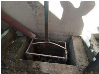
Foto 3 - Cesto para retirada de resíduos
