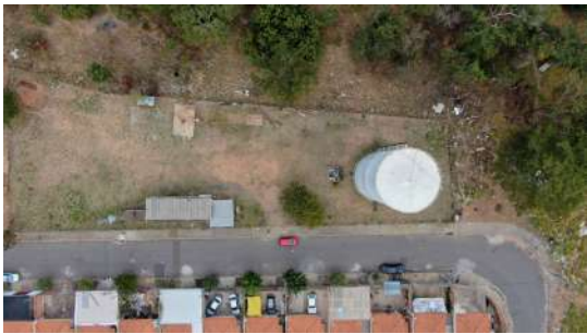
Foto 7 - Vista superior do reservatório, poço e EEAT Eduardo Abdenur
