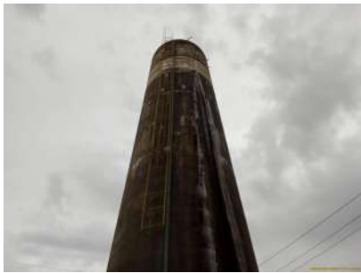
Foto 3 - Reservatório Jardim Alvorada
