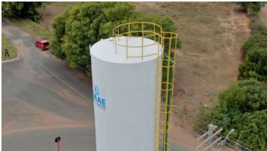
Foto 5 - Tampas de proteção e tubulação de ventilação
