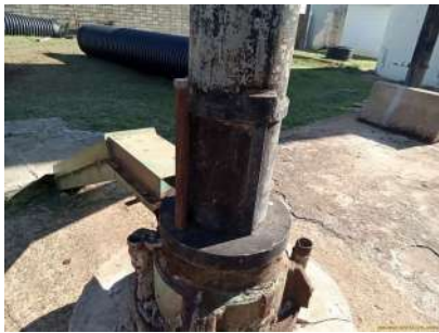
Foto 3 - Tubo de medição de nível
