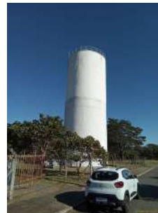
Foto 3 - Reservatório Eduardo Abdenur
