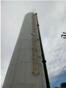
Foto 2 - Escada de acesso e guarda-corpo
