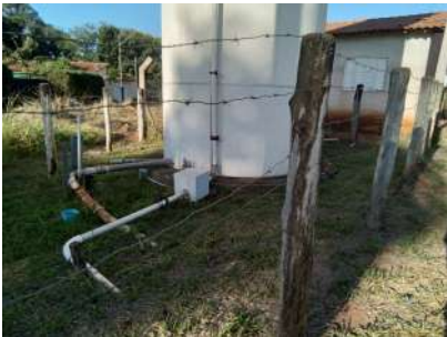
Foto 2 - Vista da área do reservatório
