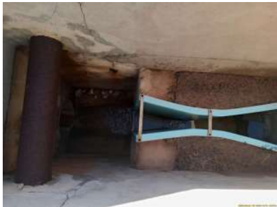
Foto 12 - Medidor de vazão tipo Parshall (saída)
