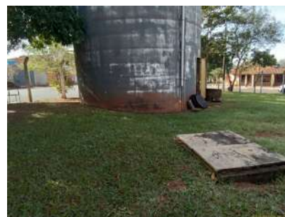
Foto 6 - Vista da área do reservatório
