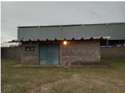
Foto 2 - Vista externa da EEAT Parque Industrial Nova Instância
