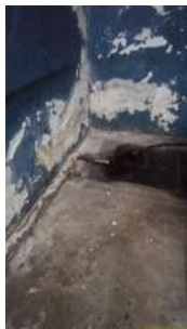
Foto 1 - Tubulação que drena a água de lubrificação das gaxetas das bombas centrífugas.
