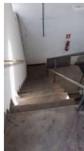
Foto 2 - Acesso à casa de bombas.
