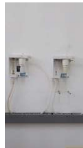
Foto 2 - Dosagem de cloro gás, que pode ser utilizado na pré e pós cloração.
