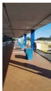
Foto 3 - Controles dos filtros. Mesas serão substituídas por painéis.
