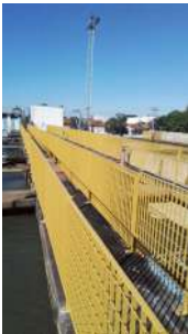
Foto 4 - Guarda-corpo na ETA.
