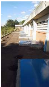
Foto 3 - Poço de sucção das bombas.
