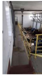
Foto 2 - Acesso casa de bombas velha.
