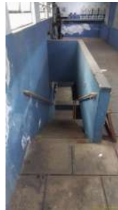
Foto 2 - Acesso à casa de bombas.
