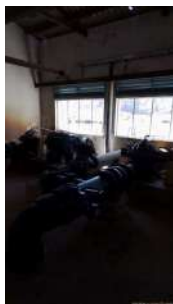
Foto 5 - Casa de bombas
