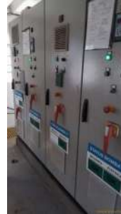
Foto 4 - Casa de bombas velha.
