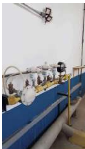
Foto 4 - Tubulação de cloro gás.
