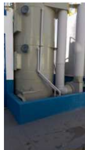
Foto 2 - Muro de contenção do lavador de gás cloro.
