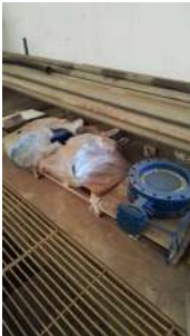
Foto 2 - Registros novos para substituição.
