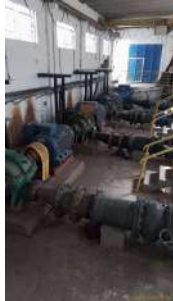
Foto 3 - Casa de bombas nova.
