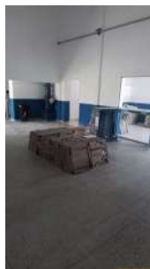
Foto 22 - Materiais para a reforma que estava ocorrendo no prédio. Espaços que antes funcionavam como armazenamento e depósito de materiais e produtos químicos foram convertidos em salas de controle operacional e ambientes administrativos e de apoio para os funcionários.
