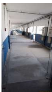
Foto 23 - Área que abriga painéis de controle dos filtros. Espaço estava passando por reforma.
