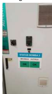
Foto 5 - Bomba grande 3 em operação.
