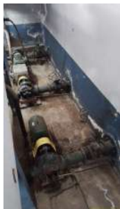
Foto 1 - Bombas centrífugas.
