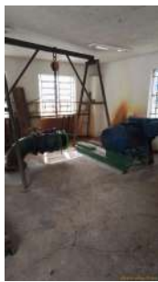
Foto 1 - Bomba em manutenção na casa nova.
