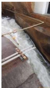
Foto 5 - Aplicação de PAC (coagulante) e dióxido de cloro (pré cloração).
