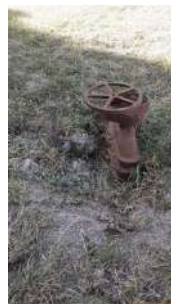
Foto 5 - Vedação da entrada do reservatório.
