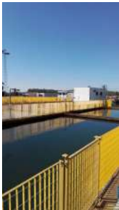
Foto 3 - Guarda-corpo na ETA.
