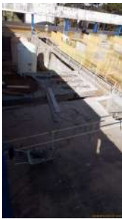
Foto 6 - Visualização das obras para demolição da laje.
