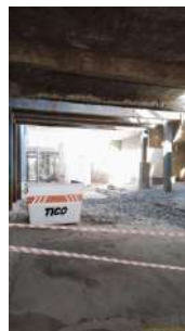
Foto 3 - Área interditada para a obra.
