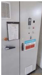
Foto 1 - Bomba em manutenção na casa de bombas nova.
