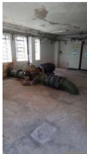
Foto 1 - Amplo acesso para manutenção na casa de bombas nova.
