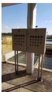
Foto 6 - Um dos novos painéis de comando de filtros da ETA.
