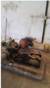
Foto 1 - Bomba pequena 3 em manutenção.
