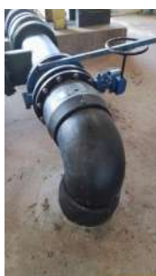
Foto 7 - Tubulação nova em PEAD no recalque de bombas da casa velha.
