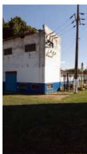
Foto 13 - Casa de bombas velha.
