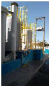
Foto 1 - Muros de contenção nos tanques para armazenamento de PAC.
