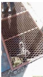
Foto 5 - Gradeamento na tomada d'água.
