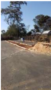
Foto 1 - Futura área para estocagem dos produtos químicos.
