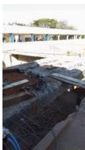
Foto 4 - Demolição da laje.
