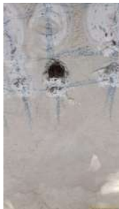
Foto 3 - Abertura para realização de análise da estrutura.
