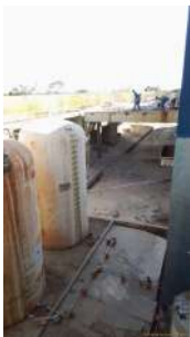
Foto 4 - Nesta foto observa-se tanques para armazenamento de PAC em local provisório. Ao fundo, demolição de laje onde os tanques ficavam
