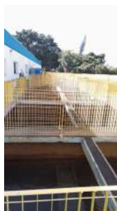
Foto 21 - Filtros da ETA.
