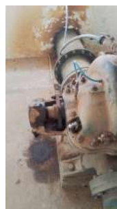
Foto 2 - Drenagem de uma das bombas da casa nova.
