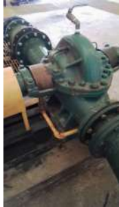
Foto 7 - Drenagem da água de lubrificação das gaxetas de uma das bombas.
