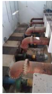
Foto 2 - Casa de bombas da elevatória.
