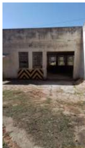
Foto 1 - Casa de bombas
