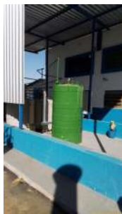
Foto 5 - Muro de contenção da área que armazena dióxido de cloro, utilizado na pré cloração.
