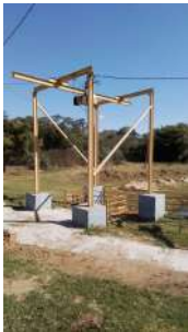
Foto 3 - Tomada de água da casa velha.
