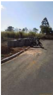
Foto 2 - Blocos para construção de diques de contenção da futura nova área de estocagem dos produtos químicos.
