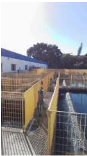
Foto 2 - Guarda-corpo na ETA.
