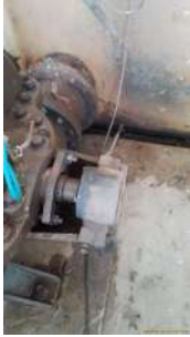
Foto 5 - Drenagem de bomba da casa velha.
