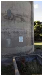
Foto 1 - Identificação do reservatório.
