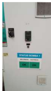
Foto 3 - Bomba grande 1 em operação.
