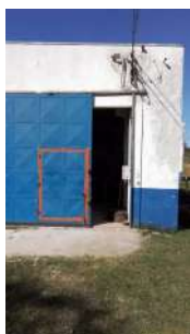
Foto 11 - Casa de bombas nova.
