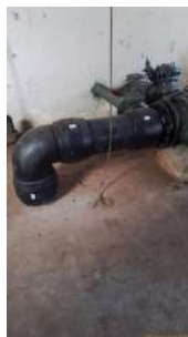
Foto 6 - Nova tubulação em PEAD no recalque das bombas da casa velha.
