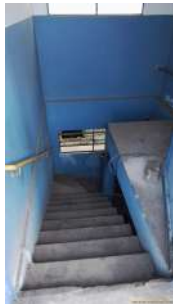
Foto 1 - Acesso à casa de bombas.
