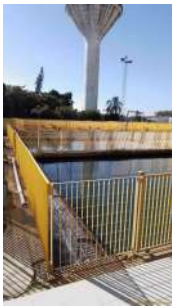
Foto 1 - Guarda-corpo na ETA.
