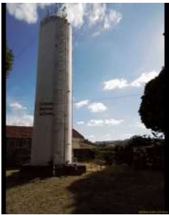
Foto 1 - Visão geral do reservatório.
