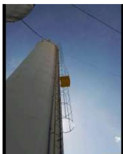
Foto 1 - Escada com proteção.
