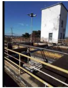
Foto 6 - 06 floculadores mecânicos no início do tratamento.
