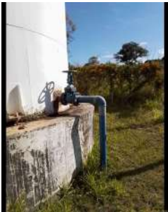
Foto 2 - Saída do reservatório.
