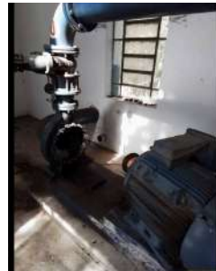
Foto 4 - Bomba em manutenção.
