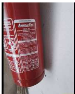
Foto 1 - Validade do extintor.
