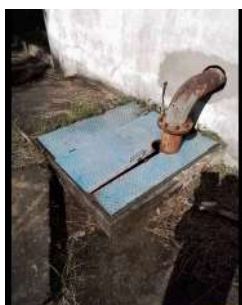
Foto 1 - Tampa de inspeção junto à tubulação de sucção da elevatória.
