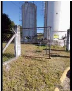
Foto 1 - Portão de acesso à área.
