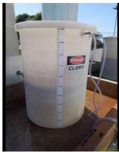
Foto 3 - Tanque para armazenar cloro.
