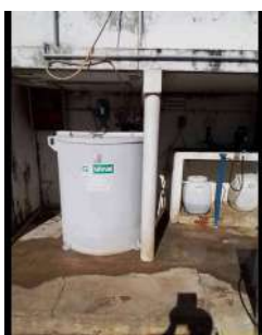
Foto 1 - Armazenamento de barrilha, utilizada para correção do PH
