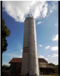
Foto 1 - Escada com proteção.
