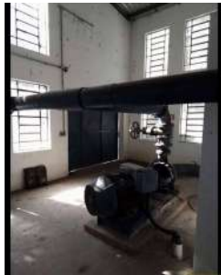
Foto 3 - Bomba em manutenção.
