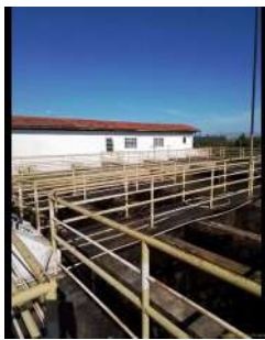
Foto 1 - Guarda-corpo em condições adequadas.
