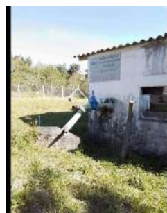
Foto 6 - Tubulação de recalque.
