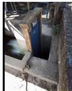
Foto 10 - Tomada de água da captação.
