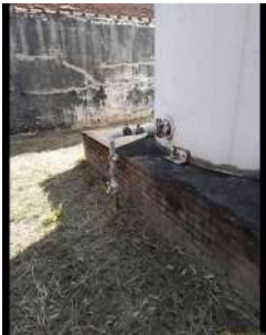
Foto 4 - Saída do reservatório.
