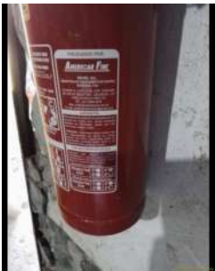
Foto 1 - Validade do extintor.
