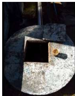
Foto 4 - Abertura pela qual os operadores avaliam a separação das fases líquida e sólida do lodo.
