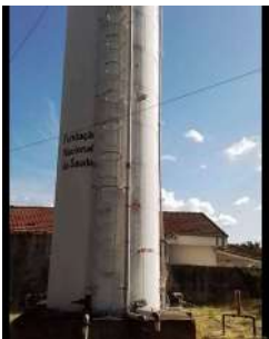
Foto 1 - Medidor de nível por contrapeso.
