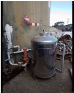
Foto 2 - Filtro dinâmico utilizado para pré-filtração.
