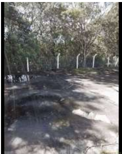
Foto 3 - Cercamento da área.
