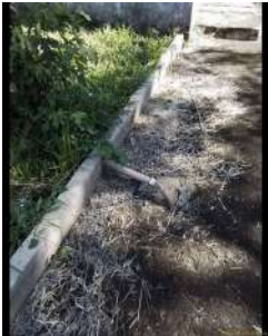
Foto 2 - Alimentação do reservatório a partir do poço.
