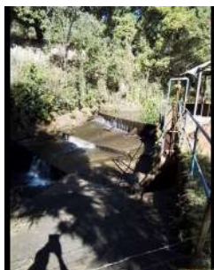
Foto 7 - Barramento da captação
