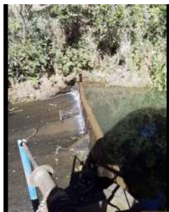
Foto 9 - Barramento da captação
