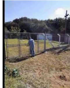
Foto 4 - Cercamento de área.
