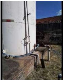
Foto 2 - Abastecimento do reservatório.
