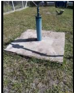
Foto 1 - Laje de concreto.
