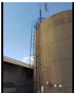
Foto 1 - Escada com proteção.
