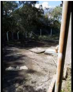
Foto 2 - Cercamento da área.
