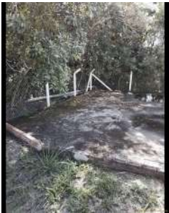
Foto 1 - Cercamento da área.
