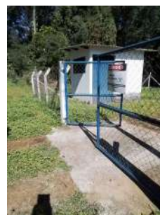
Foto 2 - Cercamento da área.
