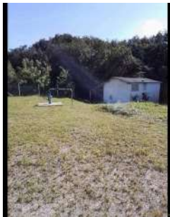
Foto 2 - Poço e elevatória.
