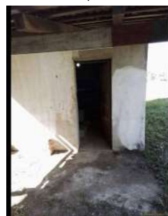
Foto 4 - Entrada da elevatória.
