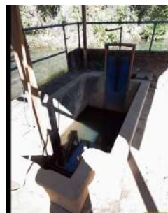
Foto 8 - Tomada de água da captação.
