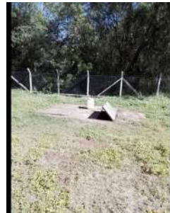
Foto 4 - Poços da elevatória.
