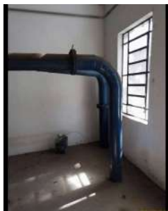
Foto 5 - Tubulação de recalque.
