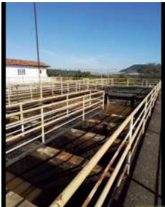
Foto 3 - 2 decantadores da ETA I. No momento da inspeção, um estava passando por limpeza.
