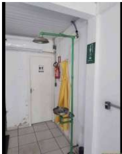
Foto 1 - Chuveiro de emergência no laboratório.
