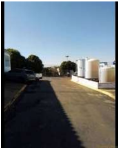
Foto 2 - Cercamento no perímetro da área.
