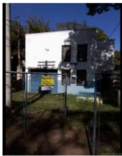
Foto 1 - Visão geral da captação.
