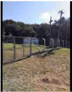
Foto 1 - Cercamento da área.
