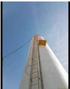
Foto 1 - Descida do extravasor.
