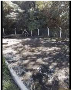
Foto 1 - Visão geral do reservatório.
