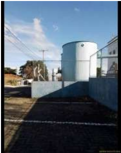
Foto 3 - Cercamento da área.
