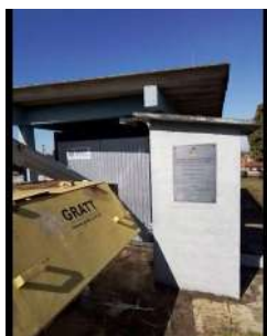
Foto 1 - Unidade de tratamento de lodo da ETA I.
