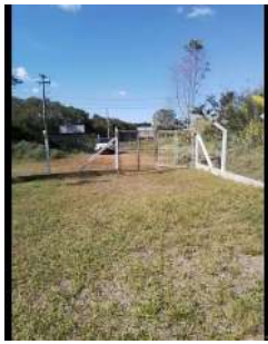
Foto 1 - Cercamento de área.
