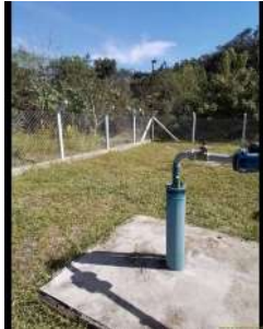
Foto 3 - Cercamento de área.
