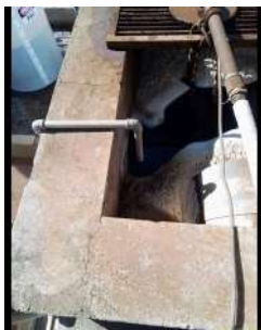
Foto 1 - Aplicação de flúor após a entrada de água bruta.
