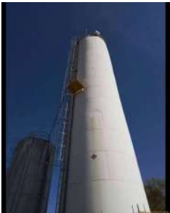
Foto 1 - Visão geral do reservatório.
