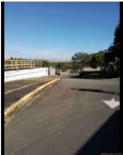
Foto 1 - Um dos portões de acesso.
