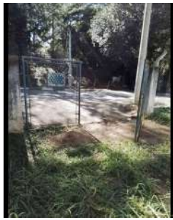
Foto 1 - Portão de acesso.
