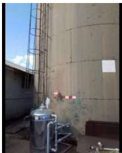
Foto 1 - Medidor de nível por contrapeso.
