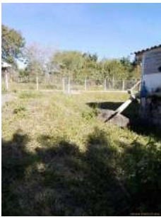
Foto 3 - Poço que alimenta o reservatório.
