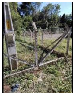
Foto 1 - Cercamento da área.
