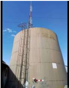
Foto 1 - Visão geral do reservatório.
