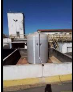
Foto 5 - Armazenamento de ácido fluossilícico (flúor).
