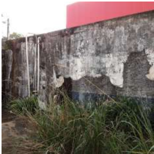
Foto 4 - Vista geral da parede lateral do reservatório.
