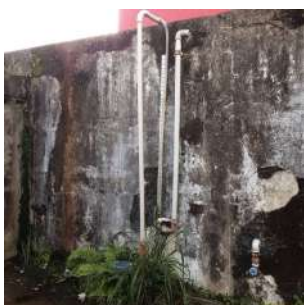
Foto 5 - Medidor de nível.
