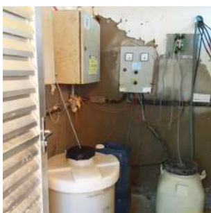
Foto 7 - Interior da edificação.
