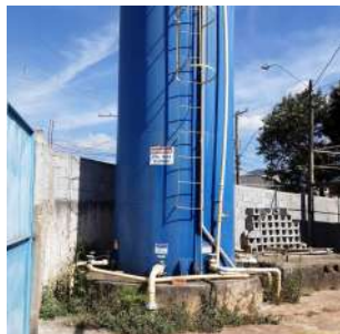
Foto 3 - Vista geral do reservatório. Há uma placa de identificação afixada na parede do reservatório.
