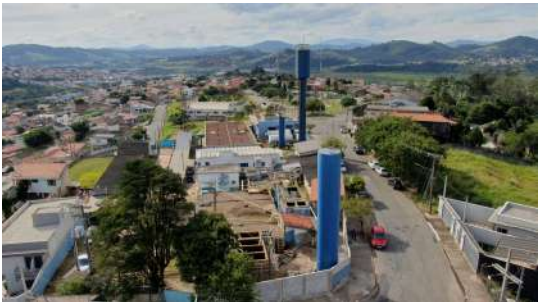
Foto 1 - Vista aérea da ETA Sede.
