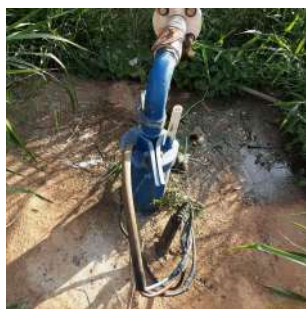
Foto 7 - Tubo de medição de nível.
