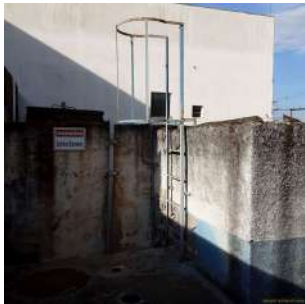
Foto 3 - Escadas de acesso ao topo do reservatório.
