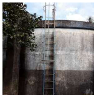
Foto 4 - Escadas de acesso ao topo do reservatório.
