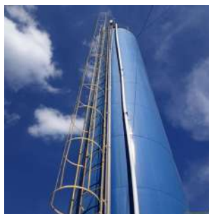
Foto 4 - Escadas de acesso ao topo do reservatório.
