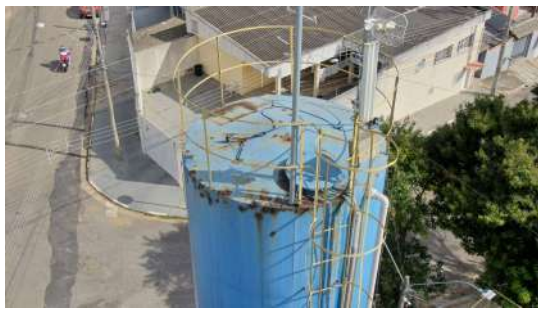
Foto 5 - Guarda-corpos no topo do reservatório.
