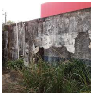
Foto 4 - Vista geral da parede lateral do reservatório.
