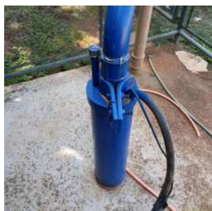
Foto 5 - Tubo de medição de nível.
