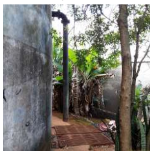
Foto 9 - Tubo extravasador.
