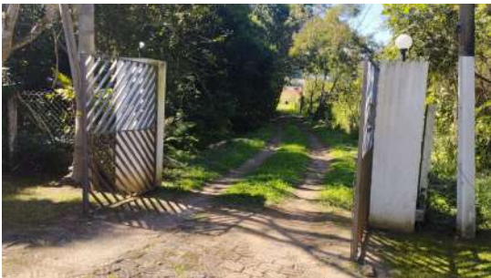
Foto 1 - Portão de acesso à área da captação.
