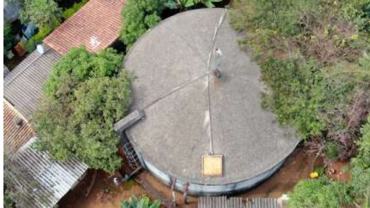
Foto 5 - Tampa de inspeção e tubulação de ventilação no topo do reservatório.
