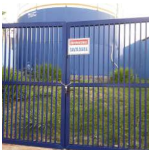
Foto 3 - Placa de identificação do reservatório, afixada em local visível a partir da Rua José Felix da Costa.
