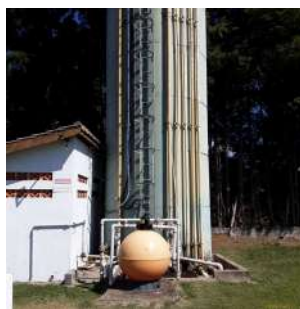
Foto 4 - Vista geral do reservatório.
