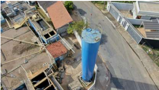
Foto 2 - Vista aérea do reservatório.
