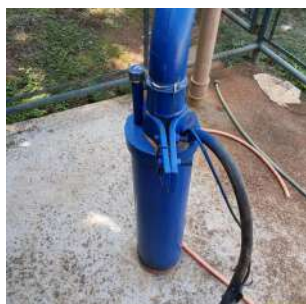
Foto 5 - Tubo de medição de nível.
