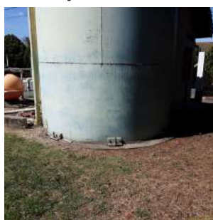
Foto 9 - Vista geral da base do reservatório.
