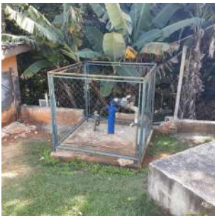
Foto 1 - Vista geral da área e cercamento do poço.
