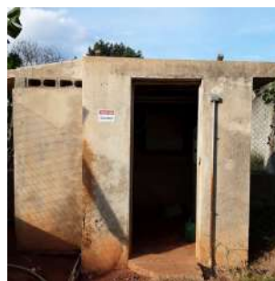
Foto 8 - Vista geral da edificação que abriga os equipamentos de aplicação de cloro e flúor na água bruta.
