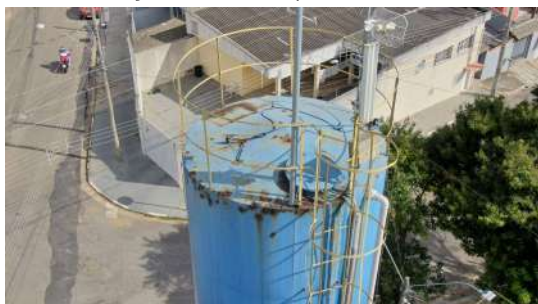
Foto 5 - Guarda-corpos no topo do reservatório.
