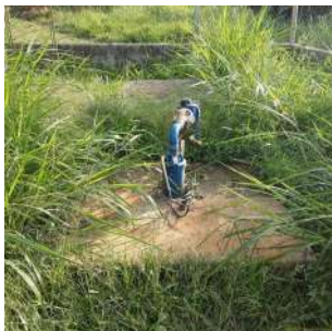
Foto 4 - Vista geral da estrutura do poço e laje de proteção.
