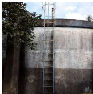
Foto 4 - Escadas de acesso ao topo do reservatório.
