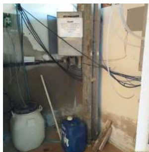
Foto 8 - Interior da edificação.
