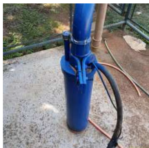
Foto 5 - Tubo de medição de nível.
