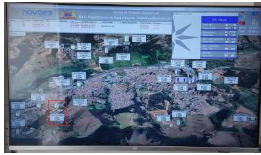
Foto 13 - O prestador já possui infraestrutura de telemetria instalada no local, como pode ser observado na tela do supervisor do sistema, porém, devido à falta de manutenção dos equipamentos, a medição de nível não está funcionando neste reservatório.
