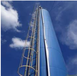
Foto 4 - Escadas de acesso ao topo do reservatório.
