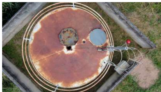
Foto 6 - Detalhe da tampa de inspeção.
