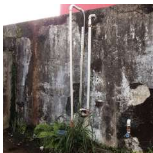
Foto 5 - Medidor de nível.
