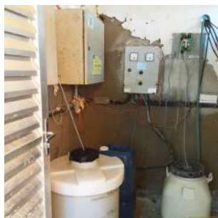
Foto 7 - Interior da edificação.
