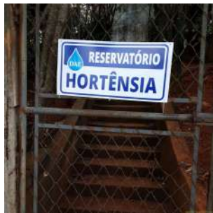
Foto 3 - Placa de identificação do reservatório, afixada em local visível a partir da Rua Colômbia.
