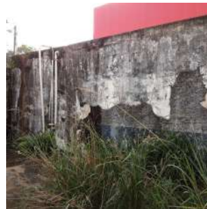
Foto 4 - Vista geral da parede lateral do reservatório.
