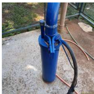
Foto 5 - Tubo de medição de nível.
