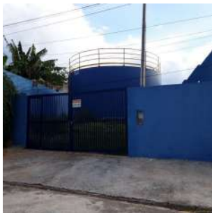
Foto 2 - Vista do cercamento e portão de acesso à área.
