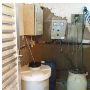
Foto 7 - Interior da edificação.
