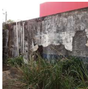
Foto 4 - Vista geral da parede lateral do reservatório.
