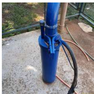
Foto 5 - Tubo de medição de nível.
