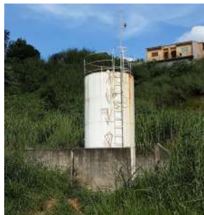
Foto 2 - Vista geral do reservatório, localizado em área cercada por muros.
