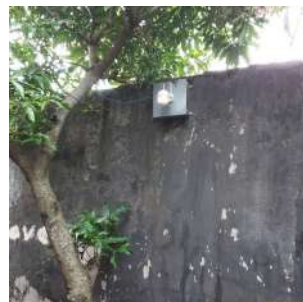
Foto 12 - Câmera apontada para a régua e mangueira de medição de nível, as imagens são acompanhadas por um operador na ETA Sede.
