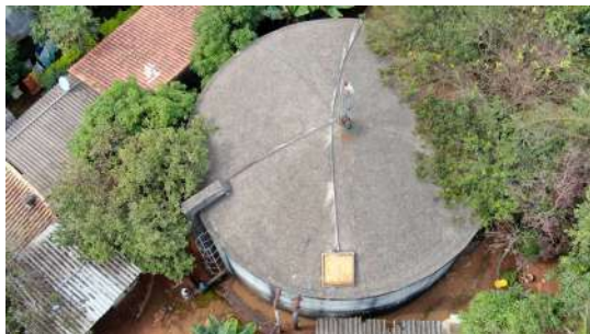
Foto 5 - Tampa de inspeção e tubulação de ventilação no topo do reservatório.
