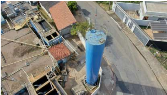
Foto 2 - Vista aérea do reservatório.
