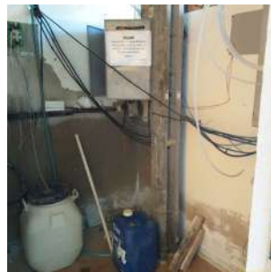
Foto 8 - Interior da edificação.
