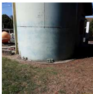
Foto 9 - Vista geral da base do reservatório.
