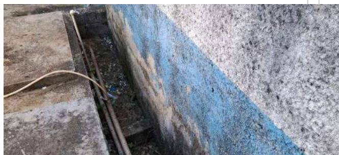
Foto 8 - Detalhe da parede lateral do reservatório após limpeza realizada pelo prestador.
