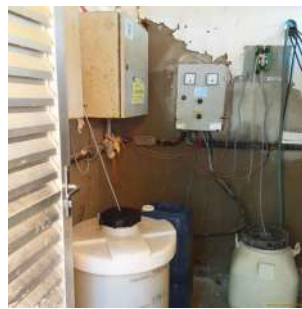
Foto 7 - Interior da edificação.
