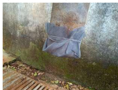
Foto 10 - Tela de proteção instalada pelo prestador após a fiscalização.
