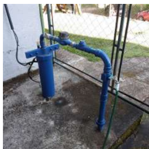
Foto 3 - Vista geral da estrutura do poço e laje de proteção.
