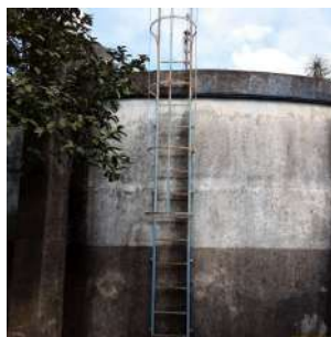
Foto 4 - Escadas de acesso ao topo do reservatório.
