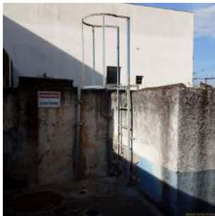
Foto 3 - Escadas de acesso ao topo do reservatório.
