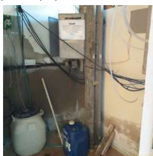
Foto 8 - Interior da edificação.
