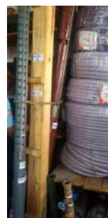
Foto 15 - Bomba reserva do poço armazenada no almoxarifado da sede.
