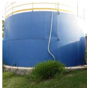
Foto 8 - Mangueira de medição de nível.
