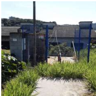
Foto 1 - Vista geral do cercamento do poço.
