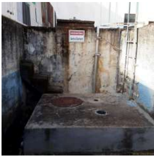
Foto 2 - Vista geral do reservatório, com placa de identificação.
