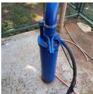
Foto 5 - Tubo de medição de nível.
