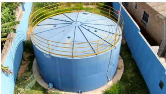
Foto 4 - Vista geral do reservatório.
