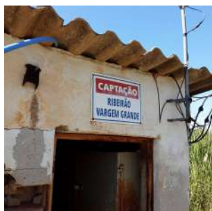
Foto 3 - Detalhe da placa de identificação instalada na fachada da edificação.
