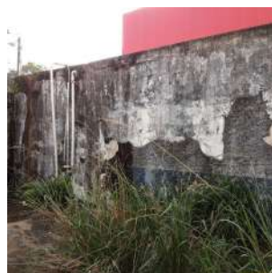
Foto 4 - Vista geral da parede lateral do reservatório.
