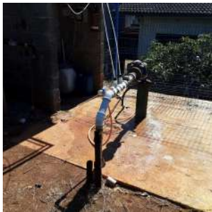
Foto 3 - Vista geral da estrutura do poço e da laje de proteção.
