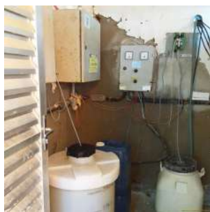
Foto 7 - Interior da edificação.
