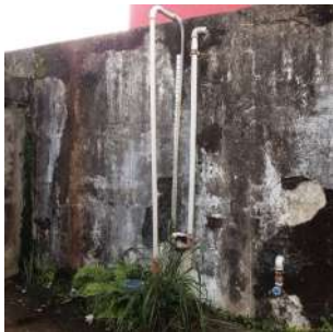
Foto 5 - Medidor de nível.
