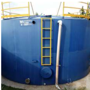
Foto 5 - Escada de acesso ao topo do reservatório. A tubulação branca à direita é o ponto
