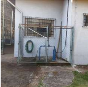
Foto 1 - Vista geral do cercamento do poço.
