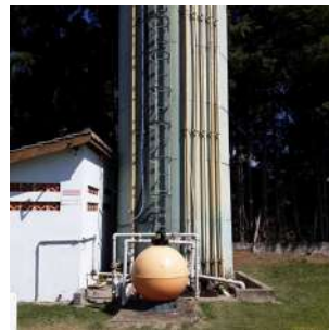
Foto 4 - Vista geral do reservatório.
