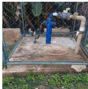
Foto 2 - Vista geral da estrutura do poço e da laje de proteção.
