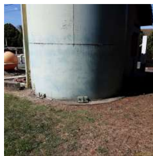
Foto 9 - Vista geral da base do reservatório.
