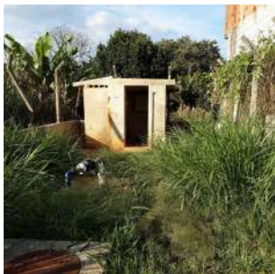
Foto 3 - Vista geral das instalações do poço e edificação de apoio.
