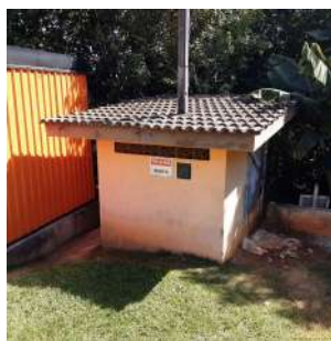
Foto 6 - Vista geral da edificação que abriga os painéis elétricos e equipamentos de aplicação de cloro e flúor na água bruta. Há uma placa de identificação do poço na fachada da edificação.
