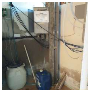
Foto 8 - Interior da edificação.
