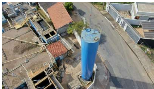
Foto 2 - Vista aérea do reservatório.
