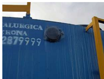
Foto 6 - Tela de proteção instalada no extravasor.
