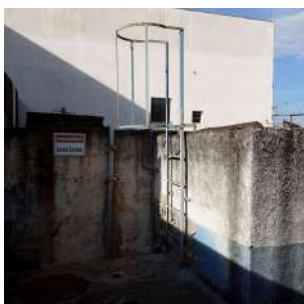
Foto 3 - Escadas de acesso ao topo do reservatório.
