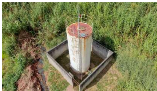
Foto 4 - Detalhe da escada e guarda-corpos no topo do reservatório.
