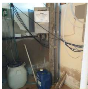
Foto 8 - Interior da edificação.
