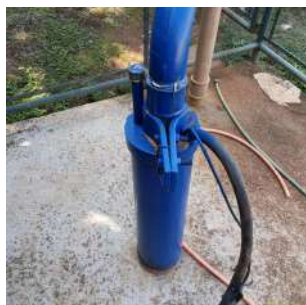
Foto 5 - Tubo de medição de nível.
