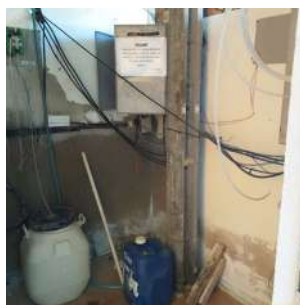
Foto 8 - Interior da edificação.
