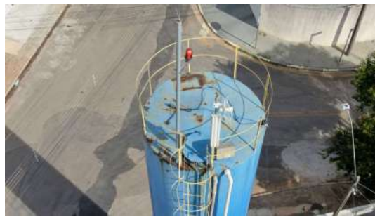
Foto 6 - Detalhe da haste do para-raios e da tampa de inspeção.
