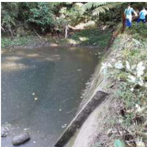
Foto 4 - Detalhe da barragem.
