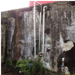
Foto 5 - Medidor de nível.
