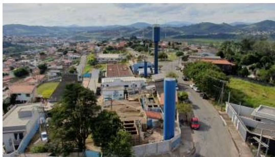
Foto 1 - Vista aérea da ETA Sede.
