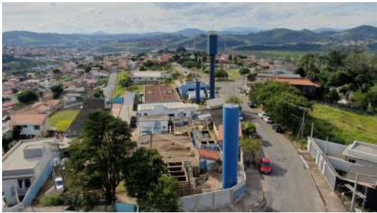
Foto 1 - Vista aérea da ETA Sede.
