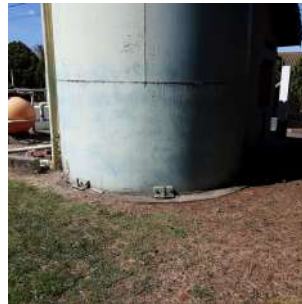
Foto 9 - Vista geral da base do reservatório.
