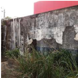
Foto 4 - Vista geral da parede lateral do reservatório.
