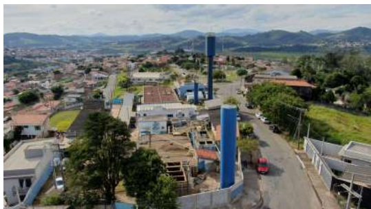
Foto 1 - Vista aérea da ETA Sede.
