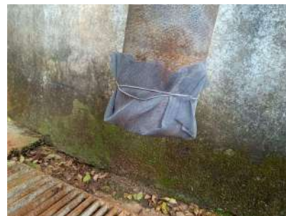
Foto 10 - Tela de proteção instalada pelo prestador após a fiscalização.
