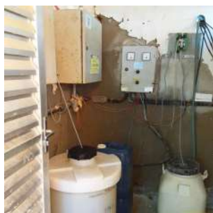
Foto 7 - Interior da edificação.
