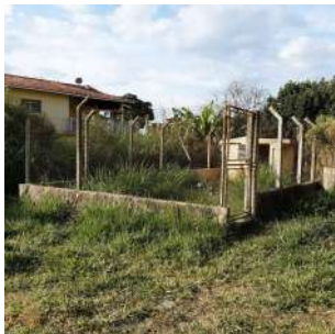
Foto 1 - Vista geral do cercamento da área.
