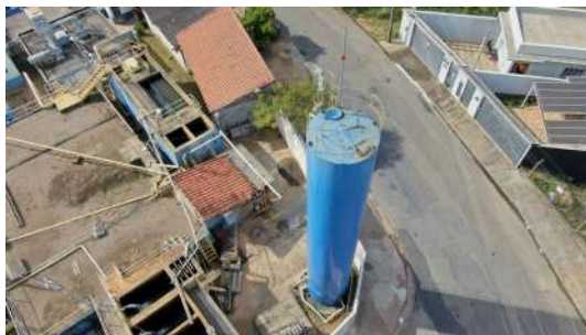
Foto 2 - Vista aérea do reservatório.
