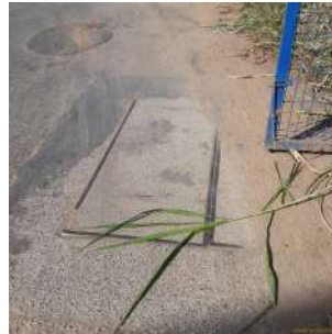
Foto 5 - Tampas de acesso ao interior da elevatória, que está localizada sob a via.
