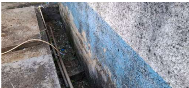
Foto 8 - Detalhe da parede lateral do reservatório após limpeza realizada pelo prestador.
