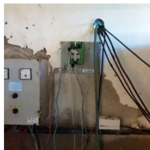
Foto 10 - Detalhe da bomba dosadora de flúor.
