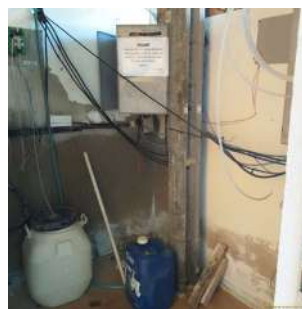
Foto 8 - Interior da edificação.
