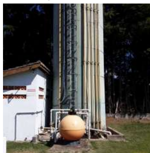
Foto 4 - Vista geral do reservatório.
