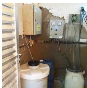
Foto 7 - Interior da edificação.
