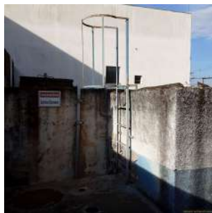
Foto 3 - Escadas de acesso ao topo do reservatório.
