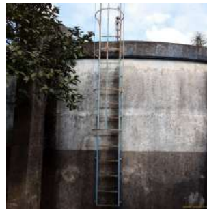
Foto 4 - Escadas de acesso ao topo do reservatório.
