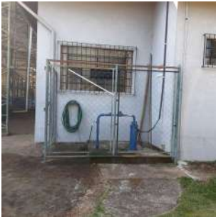
Foto 1 - Vista geral do cercamento do poço.
