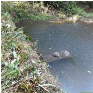
Foto 5 - Detalhe da barragem.
