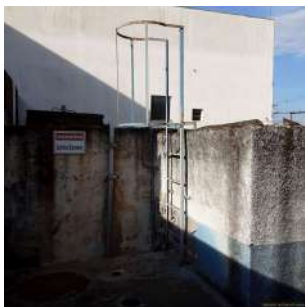
Foto 3 - Escadas de acesso ao topo do reservatório.
