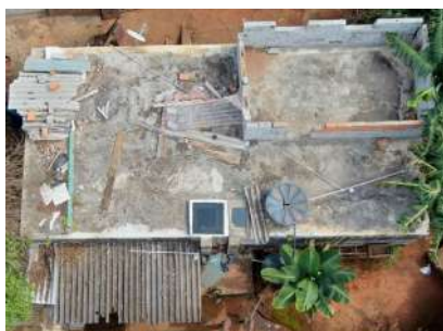
Foto 1 - Vista aérea do reservatório desativado. É possível observar as paredes de um novo cômodo sendo erguidas sobre o reservatório.
