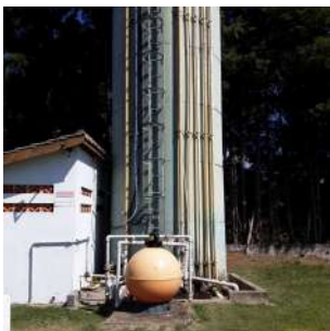
Foto 4 - Vista geral do reservatório.
