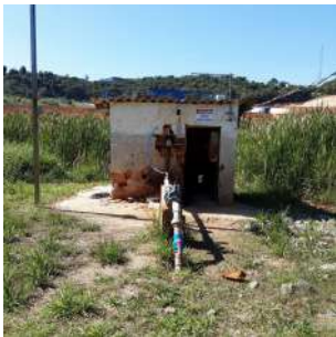
Foto 2 - Edificação que abriga a elevatória da captação.
