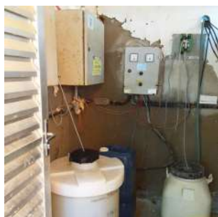
Foto 7 - Interior da edificação.
