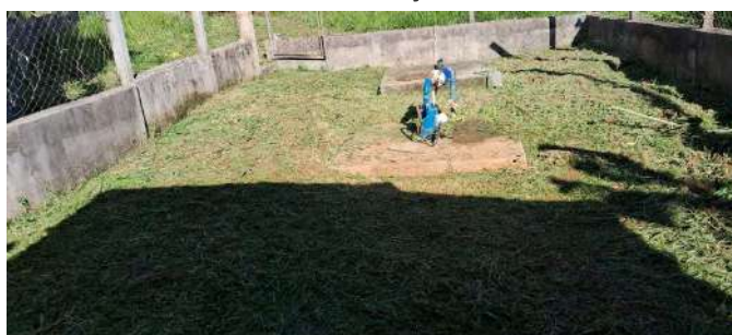
Foto 13 - O prestador providenciou a limpeza da área após a vistoria.
