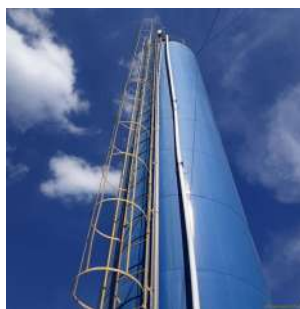
Foto 4 - Escadas de acesso ao topo do reservatório.
