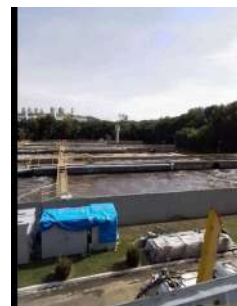
Foto 24 - Vista dos tanques a partir da estrutura do tratamento preliminar.
