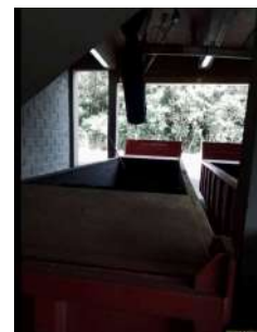
Foto 4 - Caçambas para emoção do lodo ressecado.
