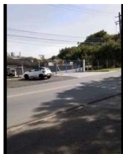
Foto 1 - Cerca e portão de acesso.
