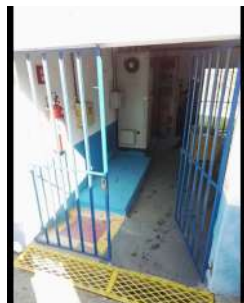
Foto 1 - Acesso à casa de bombas.
