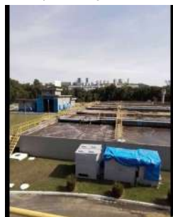
Foto 25 - Vista dos tanques a partir da estrutura do tratamento preliminar.
