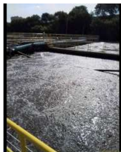
Foto 14 - Aeração em um dos tanques da ETE.
