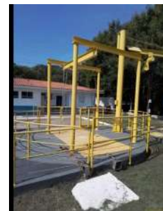
Foto 2 - Elevatória na entrada da ETE.
