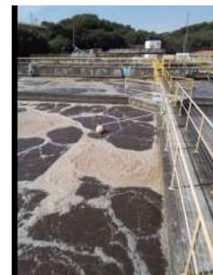
Foto 4 - Vista de um dos tanques da ETE.
