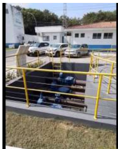
Foto 1 - Elevatória na entrada da ETE.
