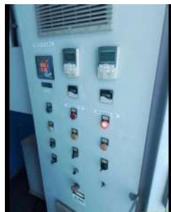
Foto 1 - Duas bombas instaladas.
