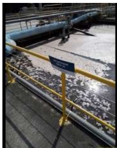
Foto 5 - Identificação de um dos tanques, que podem funcionar como decantadores e como aeradores.
