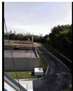
Foto 21 - Vista dos tanques da ETE a partir do tratamento preliminar.
