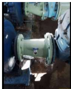
Foto 1 - Detalhes da tubulação para drenagem.
