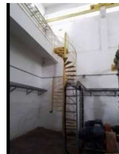
Foto 2 - Escada para acessar a casa de bombas.
