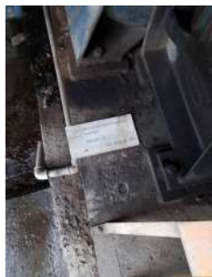
Foto 1 - Identificação da elevatória.
