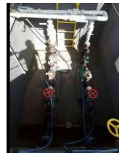
Foto 8 - Bombeamento de lodo.
