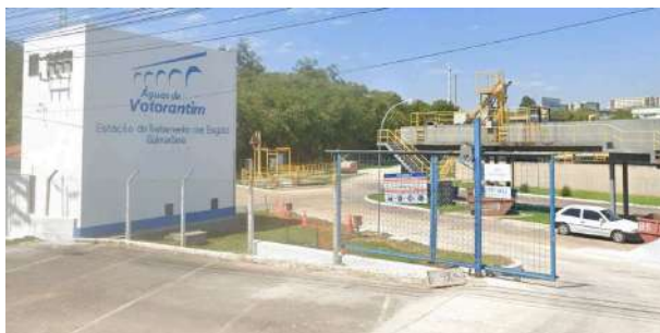
Foto 1 - Identificação da ETE na entrada.
