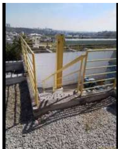
Foto 1 - Acesso para área onde estão as bombas da elevatória Vila Irineu.
