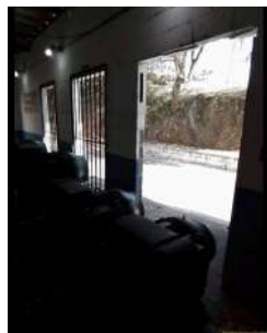
Foto 1 - Acesso à elevatória.
