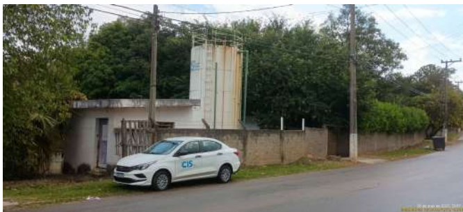
Foto 1 - Vista geral do reservatório e da EEAT.
