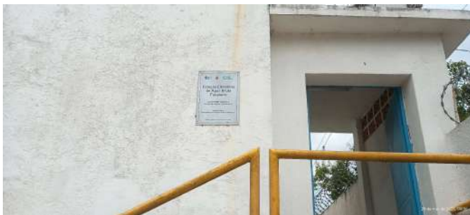
Foto 3 - Placa de identificação, no lado interno da EEAB.
