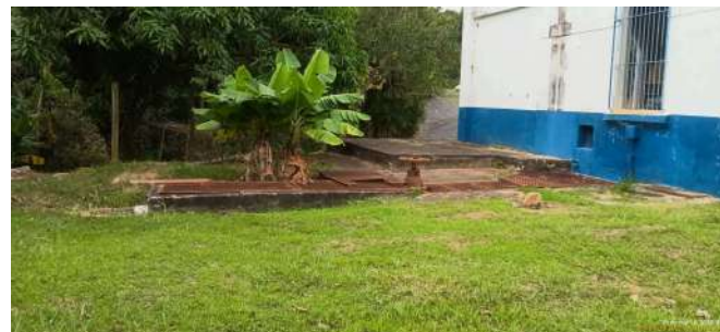
Foto 11 - FUNDOS DA CASA DE BOMBA, COM DETALHA PARA O CANAL ONDE ESTÁ A ADUTORA DE RECALQUE.
