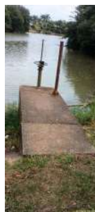
Foto 1 - Passarela de acesso ao volante da comporta.
