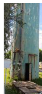
Foto 6 - Vista geral do reservatório e da base.
