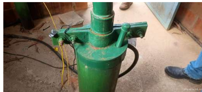
Foto 5 - Vista geral do poço.
