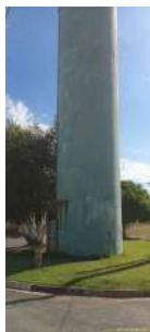
Foto 1 - Vista geral do reservatório.
