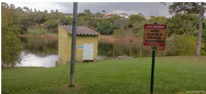
Foto 1 - Vista geral da casa de bombas (EEAB) e, ao fundo, da represa.
