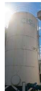
Foto 4 - Vista geral do reservatório.
