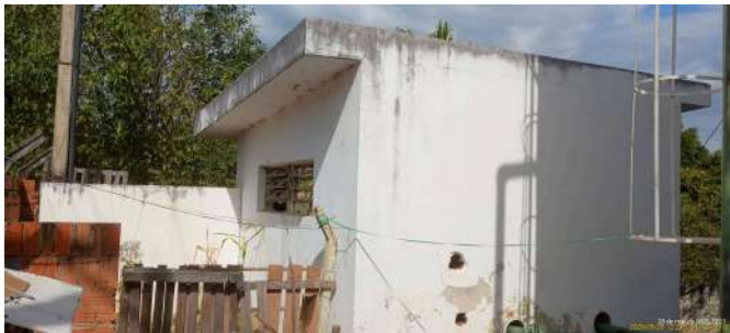
Foto 1 - Situação geral da casa de bombas da EEAT.
