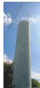
Foto 2 - Vista geral do reservatório.
