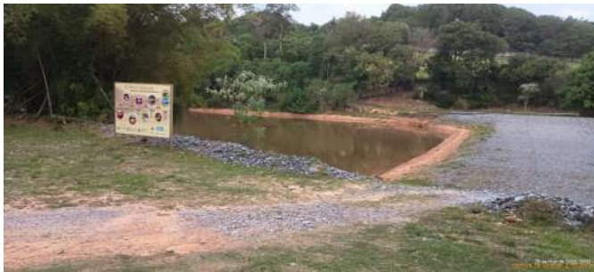
Foto 1 - Vista geral da Represa do Braiaia.
