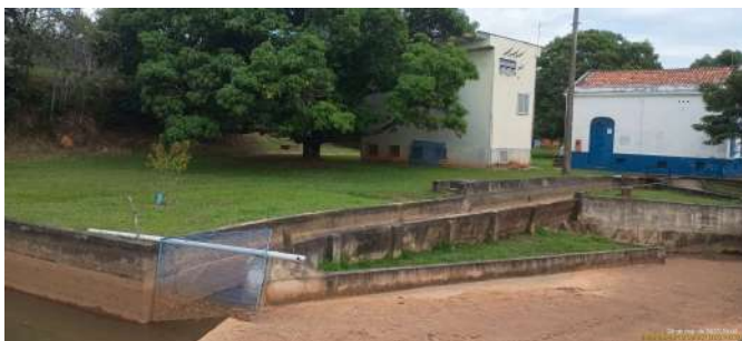
Foto 5 - Canal de derivação da água bruta e, ao fundo, casa de bombas da EEAB.
