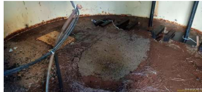
Foto 2 - Situação no piso do reservatório.
