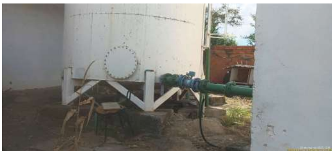
Foto 3 - Base do reservatório.
