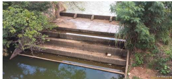
Foto 2 - Vista do barramento da represa Fubaleiro.
