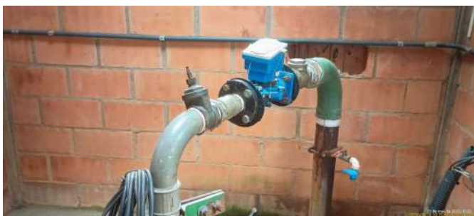
Foto 3 - Vista geral do cavalete do Poço.
