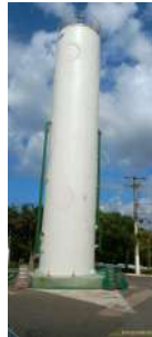
Foto 1 - Vista geral do reservatório.
