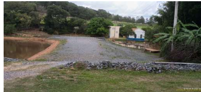
Foto 2 - Vista geral da Represa do Braiaia.
