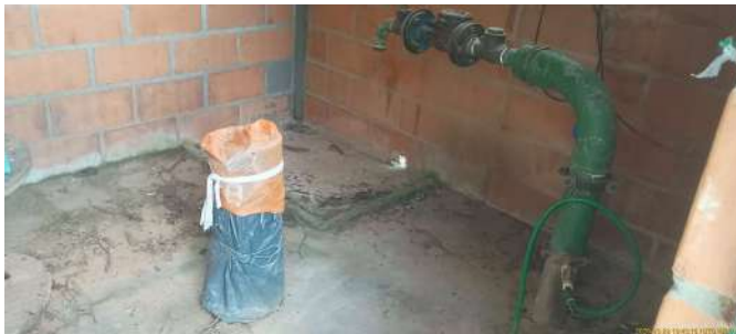
Foto 1 - Situação do Poço 2.
