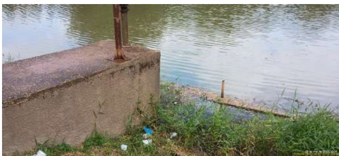
Foto 7 - Ponto de tomada de água bruta e adução por gravidade até a EEAB.
