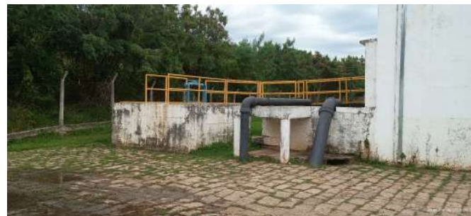
Foto 4 - Chegada da água bruta, por gravidade.
