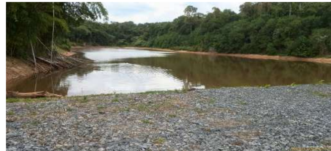
Foto 4 - Vista a montante da Represa
