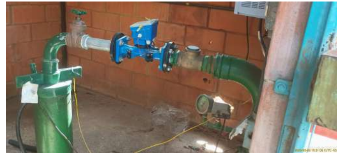
Foto 2 - Vista geral do cavalete do Poço.
