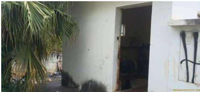
Foto 3 - Vista geral da entrada da casa de bombas da EEAT.
