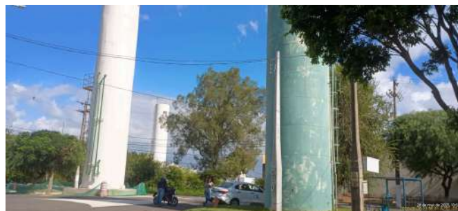
Foto 4 - Vista geral do reservatório atual (verde) e do novo (branco), em fase de conclusão.
