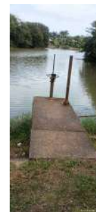
Foto 6 - Ponto de tomada de água bruta e adução por gravidade até a EEAB.
