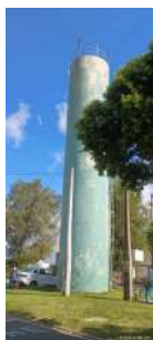
Foto 3 - Vista geral do reservatório.
