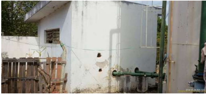
Foto 1 - Vista geral da EEAT.
