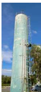
Foto 5 - Vista geral do reservatório.
