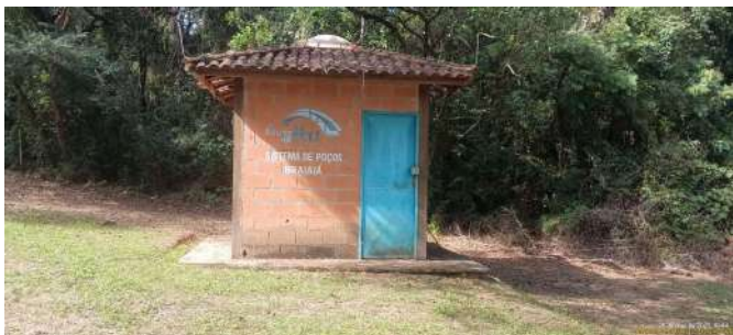
Foto 1 - Vista geral do abrigo do Poço 1, próximo à captação superficial Braialá.
