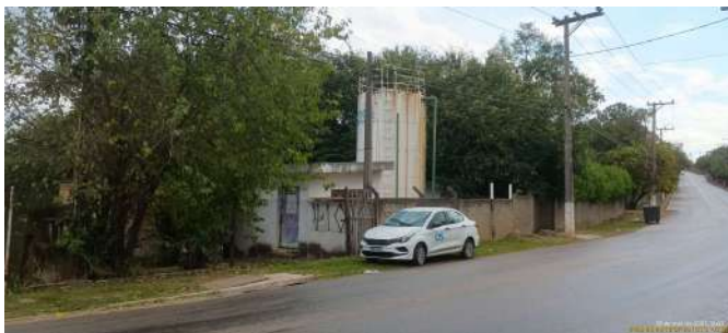
Foto 5 - Reservatório e EEAT situados ao lado da represa.
