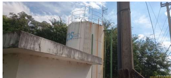
Foto 2 - Vista geral do reservatório.
