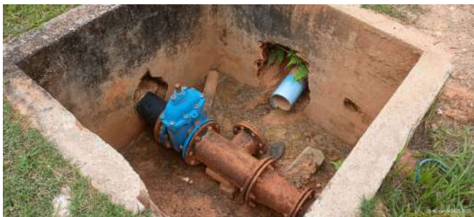
Foto 1 - Caixa (poço) de acesso ao registro da tubulação.
