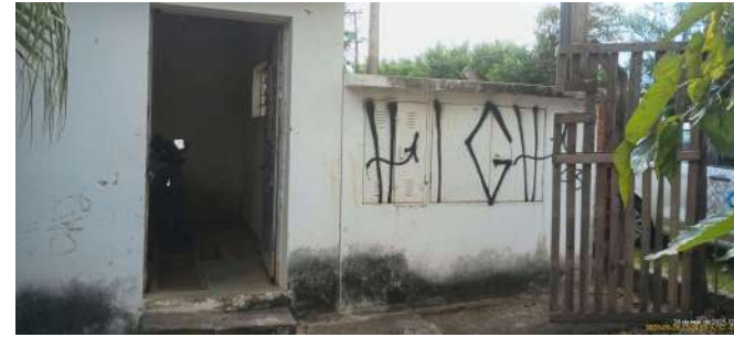
Foto 2 - Vista geral da entrada da casa de bombas da EEAT.
