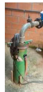
Foto 4 - Vista geral do cavalete do Poço.
