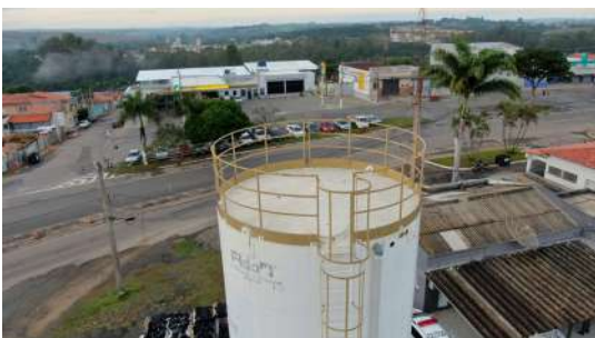
Foto 3 - Vista da cobertura.
