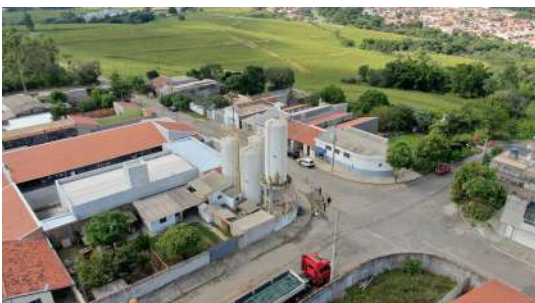
Foto 9 - Vista aérea dos reservatórios.
