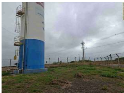
Foto 9 - Vista geral da área onde está implantado o reservatório.
