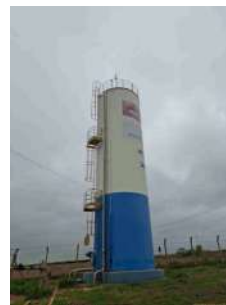
Foto 6 - Vista lateral do reservatório.
