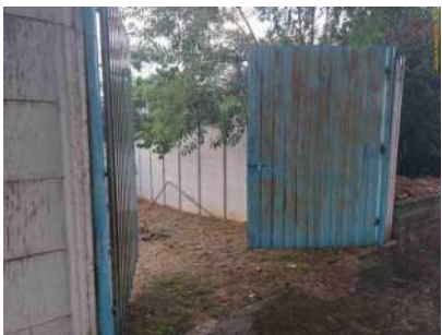
Foto 7 - Portão da EEE.
