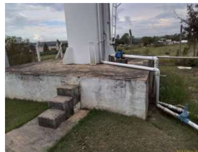
Foto 4 - Base do reservatório.
