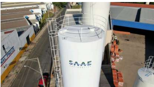
Foto 5 - Vista superior do reservatório menor.
