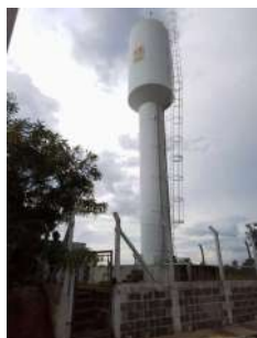
Foto 1 - Vista geral do reservatório.
