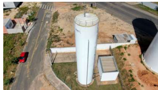
Foto 2 - Vista da lateral direita do reservatório.
