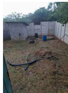
Foto 2 - Vista da área da EEE.
