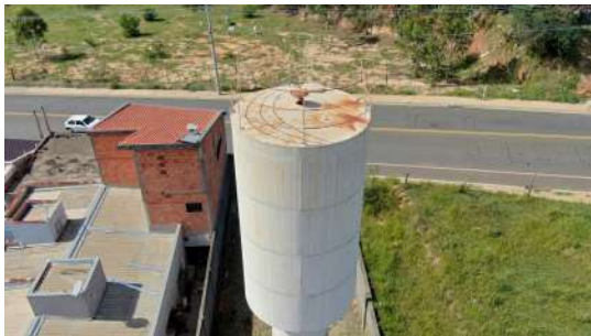
Foto 4 - Vista traseira do reservatório.
