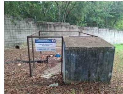
Foto 2 - Vista frontal do poço.
