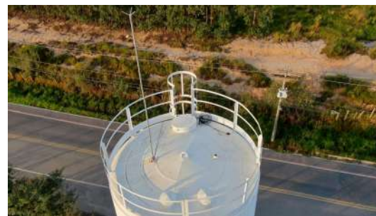
Foto 12 - Vista da cobertura.
