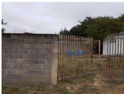
Foto 1 - Muro e portão de entrada da EEE.
