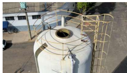
Foto 8 - Detalhe da cobertura do reservatório elevado.
