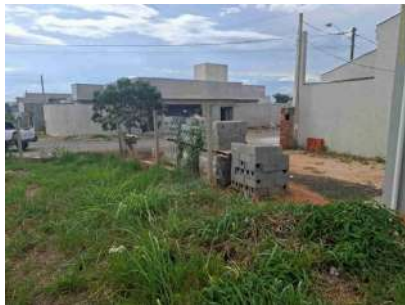
Foto 1 - A área está sem cercamento nas laterais.
