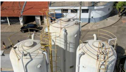
Foto 5 - Cobertura de 3 reservatórios, vista traseira.
