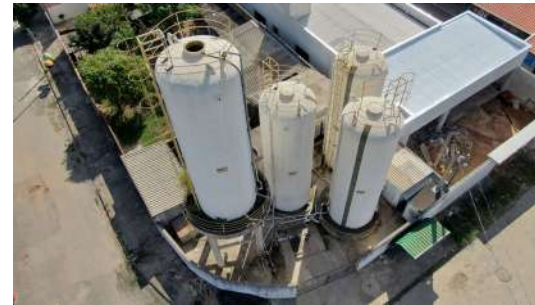
Foto 2 - Vista da cobertura dos reservatórios.
