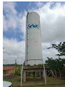
Foto 2 - Vista frontal do reservatório.
