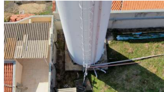
Foto 4 - Base do reservatório.
