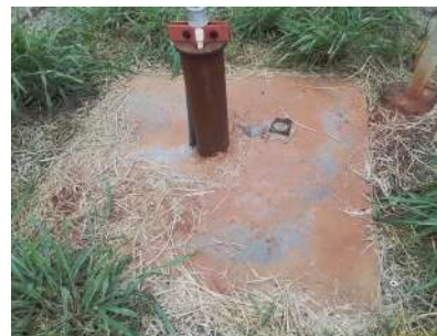
Foto 8 - Laje do poço.
