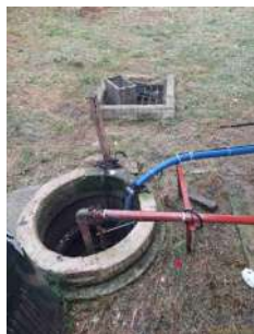
Foto 1 - Poço de sucção.
