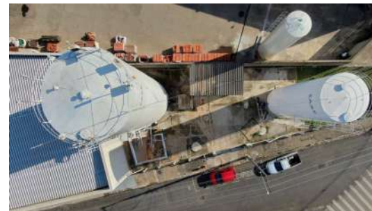
Foto 2 - Vista superior dos dois reservatórios.
