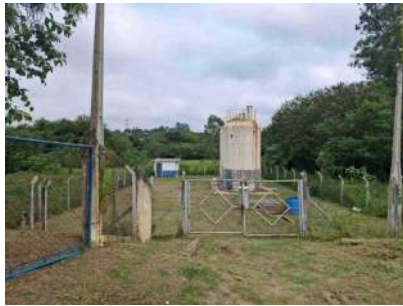
Foto 1 - Entrada da ETE.
