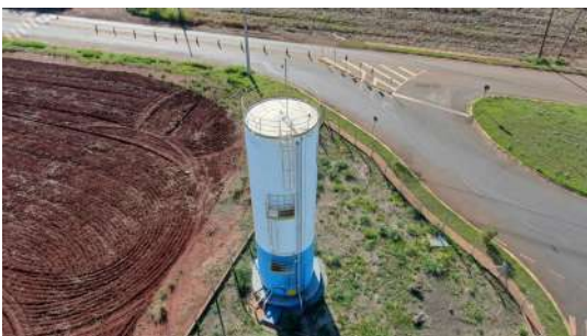
Foto 13 - Vista lateral do reservatório.
