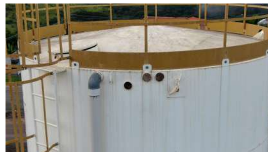
Foto 4 - Detalhe do extravasor e da ventilação.
