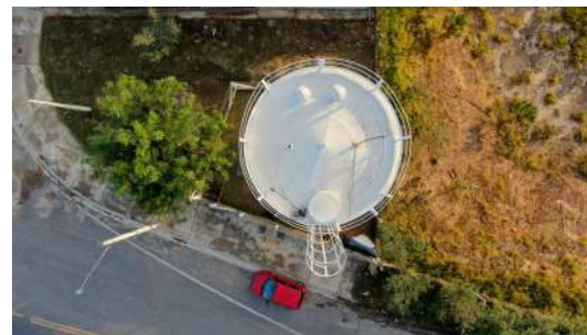
Foto 14 - Vista superior do reservatório.
