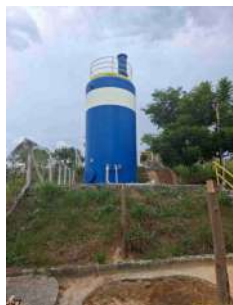
Foto 3 - Reatores UASB, vista do gradeamento.
