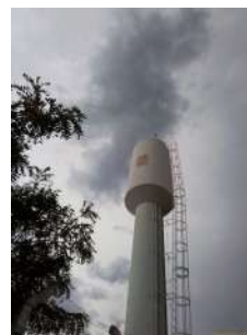
Foto 2 - Identificação do local no topo do reservatório.
