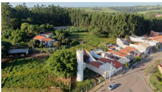
Foto 11 - Vista geral do reservatório.
