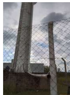
Foto 10 - Saída do tubo extravasor.
