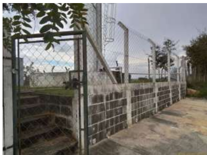
Foto 3 - Cercamento do local.
