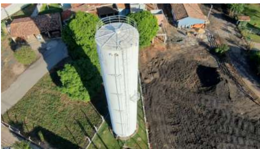
Foto 1 - Vista frontal do reservatório.
