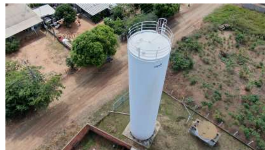
Foto 6 - Vista lateral do reservatório.
