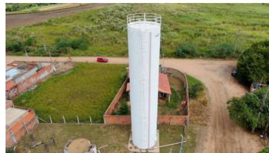
Foto 2 - Escada marinheiro e extravasor.
