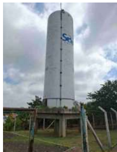
Foto 3 - Entrada da área do reservatório.
