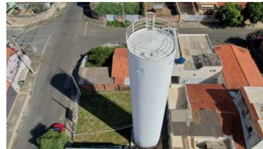
Foto 6 - Lateral direita do reservatório.
