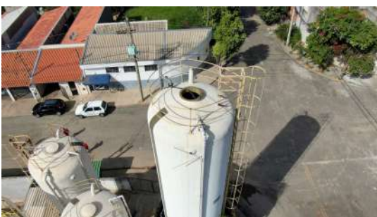
Foto 7 - Vista traseira do reservatório elevado.
