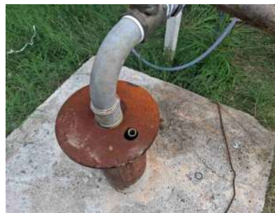
Foto 6 - Tubo de medição do nível.
