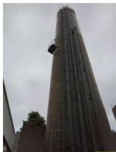
Foto 7 - Guarda-corpo na escada e no topo do reservatório.
