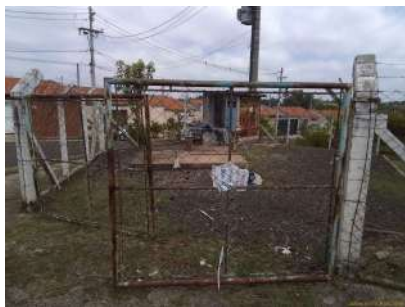
Foto 1 - Cercamento do local.
