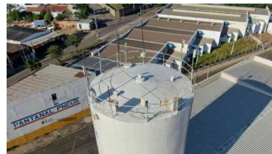
Foto 6 - Cobertura do reservatório maior.
