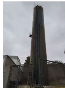
Foto 2 - Vista geral do reservatório.
