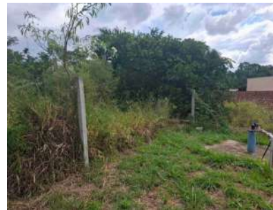
Foto 2 - Lateral sem alambrado.
