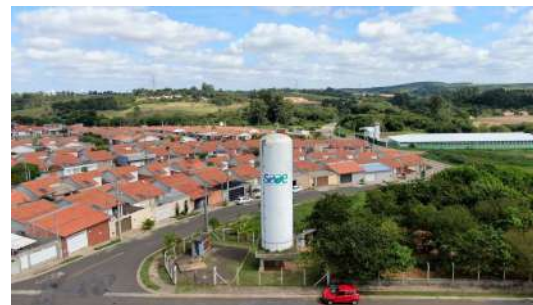
Foto 10 - Vista geral do reservatório.
