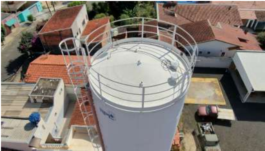
Foto 3 - Vista da cobertura.
