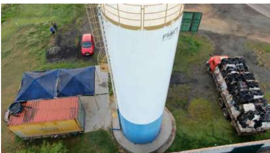
Foto 5 - Vista traseira do reservatório.
