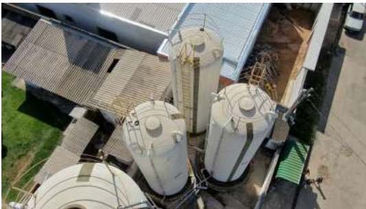
Foto 3 - Detalhe da cobertura de 3 dos 4 reservatórios.
