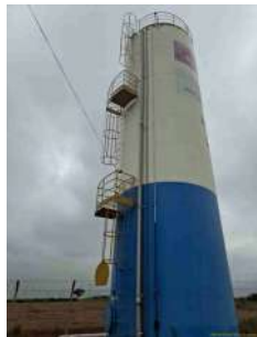
Foto 3 - Escada e guarda-corpo.
