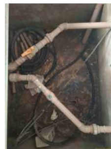
Foto 6 - Tubulação de recalque.
