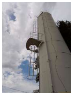
Foto 3 - Guarda-corpo na escada e no topo do reservatório.
