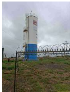
Foto 1 - Fachada do reservatório.
