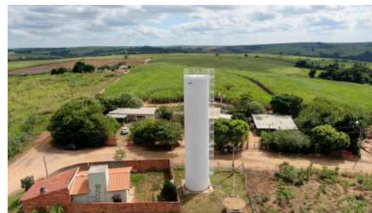
Foto 4 - Vista traseira do reservatório.
