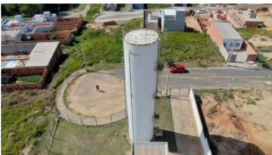
Foto 3 - Vista traseira do reservatório.
