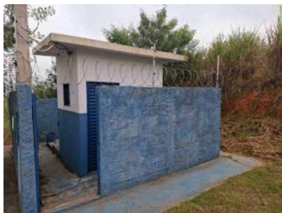
Foto 1 - Fachada da EEE.
