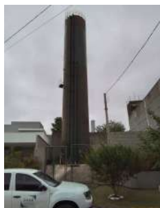
Foto 3 - Vista geral do local onde se situa o reservatório.
