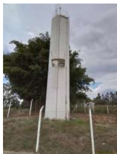
Foto 1 - Vista geral do reservatório.
