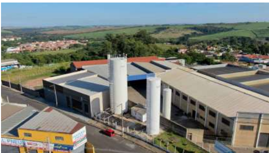
Foto 1 - Vista geral dos reservatórios.
