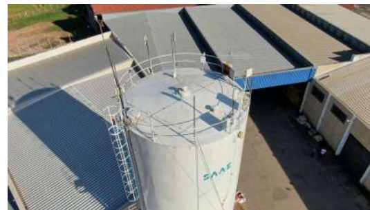
Foto 8 - Vista superior do reservatório maior.
