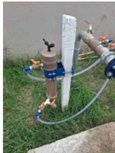
Foto 3 - Dosadora de cloro e flúor em pastilha.
