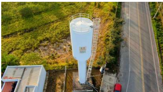
Foto 13 - Vista geral do reservatório.
