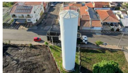
Foto 2 - Vista traseira do reservatório.
