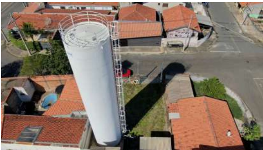
Foto 5 - Vista traseira do reservatório.
