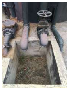
Foto 5 - Caixa de saída do tubo extravasor e descarga.
