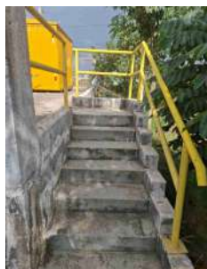
Foto 7 - Escada com guarda-corpo.
