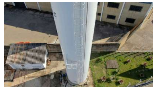
Foto 4 - Base, escada marinheiro e tubulações do reservatório menor.
