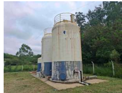
Foto 6 - Reatores UASB, vista frontal.
