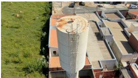
Foto 5 - Vista aérea lateral do reservatório.
