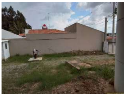
Foto 9 - Vista geral do local onde se situa o reservatório.
