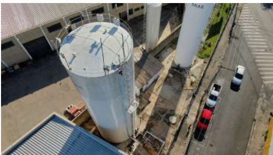
Foto 7 - Base, escada marinheiro e tubulações do reservatório maior.
