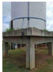
Foto 6 - Base do reservatório.
