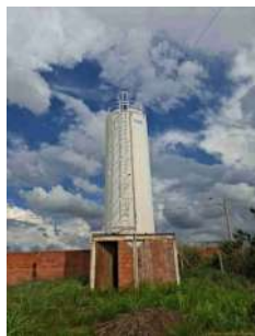
Foto 1 - Vista geral do reservatório.
