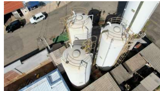
Foto 4 - Vista traseira de 3 dos 4 reservatórios.
