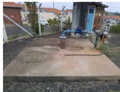
Foto 2 - Laje do poço.
