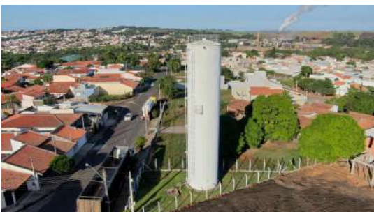
Foto 3 - Vista da lateral direita do reservatório.
