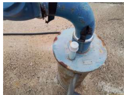
Foto 4 - Tubo de medição de nível.
