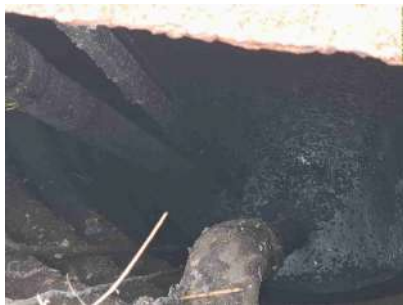
Foto 5 - Poço de sucção.
