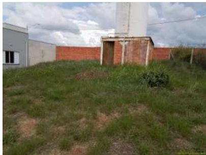
Foto 1 - Mato alto no local onde se encontra o poço e o reservatório.
