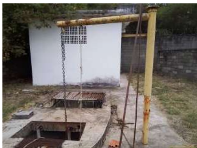
Foto 3 - Pórtico para acesso às bombas.
