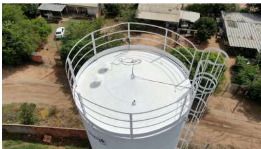
Foto 3 - Vista da cobertura.
