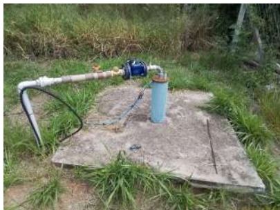
Foto 3 - Laje do poço.
