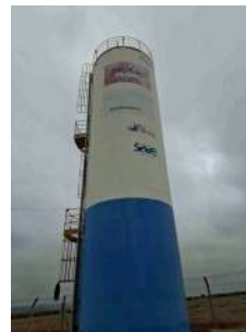
Foto 2 - Vista frontal do reservatório.
