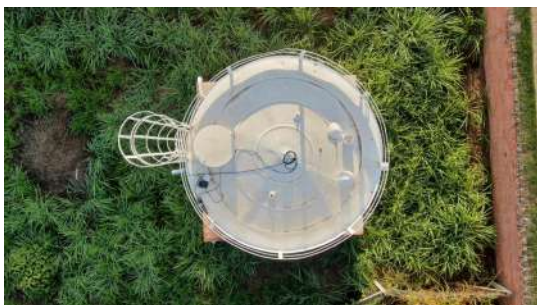
Foto 5 - Vista da cobertura.
