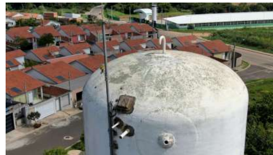
Foto 2 - Tubulações de ventilação e extravasão.
