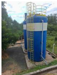
Foto 1 - Reatores UASB.
