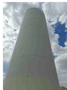
Foto 4 - Vista da estrutura do reservatório.
