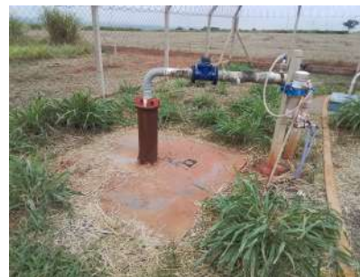
Foto 2 - Vista geral do poço.
