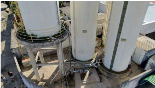
Foto 1 - Bases dos Reservatórios
