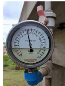
Foto 4 - Manômetro para medição do nível..
