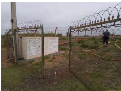
Foto 9 - Cercamento do local.
