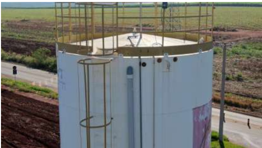
Foto 11 - Vista do extravasor e da ventilação do reservatório.
