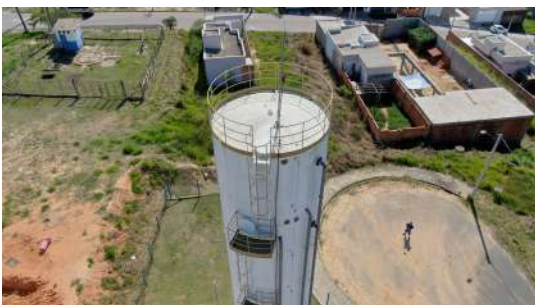
Foto 5 - Detalhe da cobertura do reservatório.
