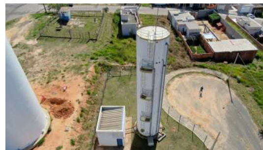
Foto 4 - Tubulações e escada marinheiro.
