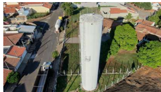
Foto 2 - Saída para tubulação sem tela de proteção.
