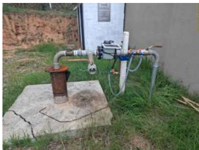
Foto 5 - Vista frontal do poço.
