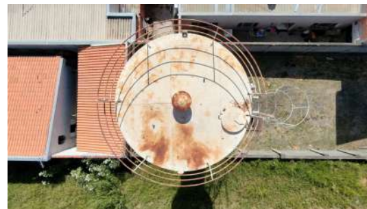
Foto 6 - Vista da cobertura do reservatório.
