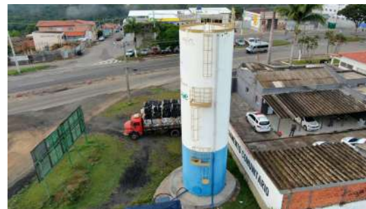
Foto 2 - Tubulação e escada marinheiro.
