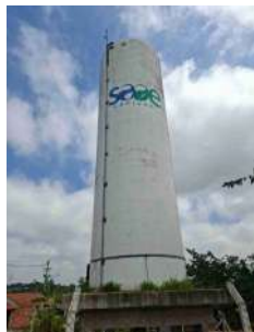
Foto 1 - Vista do reservatório.
