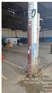
Foto 3 - Conjuntos motobomba reservas.
