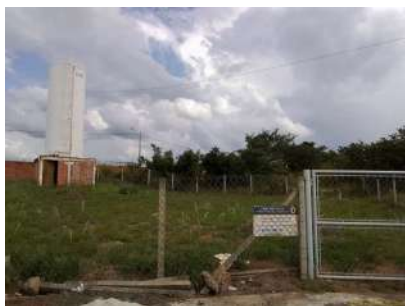
Foto 1 - Cercamento do local.
