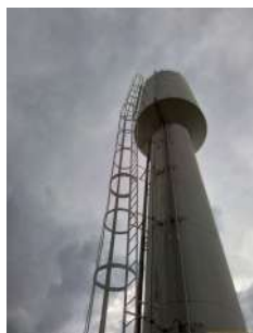
Foto 9 - Guarda-corpo na escada e topo do reservatório.
