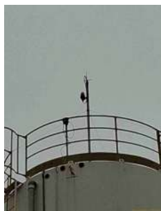
Foto 7 - Guarda-corpo da cobertura e captor do SPDA.
