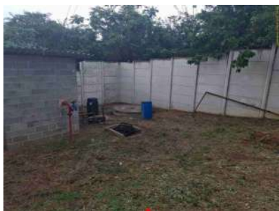
Foto 8 - Vista geral da EEE.
