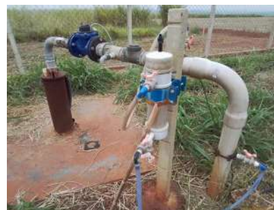
Foto 4 - Dosadora de cloro e flúor em pastilha.
