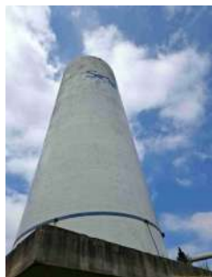
Foto 7 - Vista lateral do reservatório.
