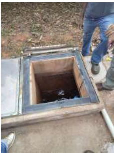
Foto 2 - Tampa de inspeção no reservatório enterrado.
