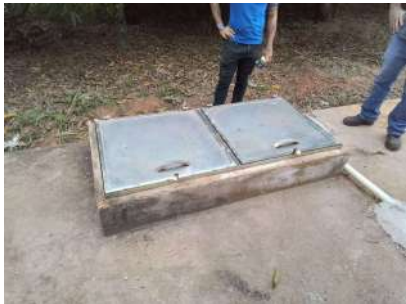
Foto 3 - Tampa de inspeção no reservatório enterrado.
