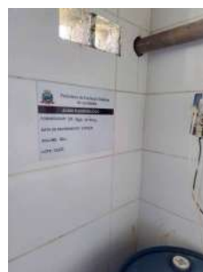
Foto 4 - Armazenamento de flúor.
