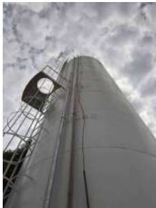
Foto 2 - Escada com guarda-corpo e plataforma de descanso.
