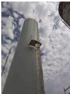
Foto 1 - Guarda-corpo na escada.
