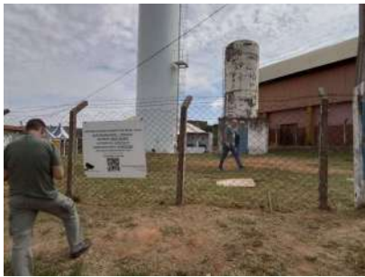
Foto 1 - Cercamento da área.
