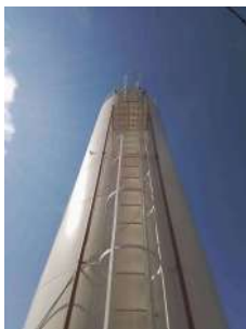
Foto 1 - Escada com guarda-corpo.
