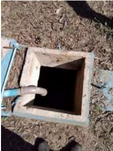
Foto 7 - Tampas do reservatório enterrado.
