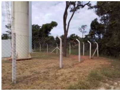
Foto 2 - Cercamento da área.
