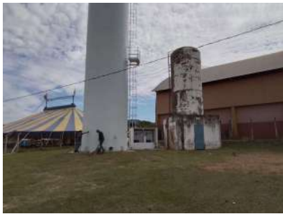
Foto 1 - Visão geral do reservatório e poço 1. O reservatório à direita está desativado e será removido.
