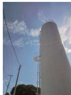
Foto 2 - Escada com guarda-corpo.
