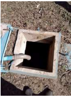
Foto 6 - Tampas do reservatório enterrado.
