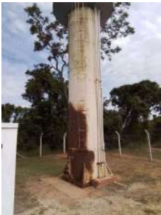
Foto 2 - Reservatório tipo taça, desativado.
