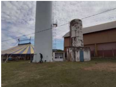
Foto 1 - Visão geral do poço 1 junto ao elevatório metálico elevado em operação. O reservatório à direita foi desativado e será removido.
