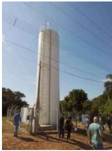
Foto 1 - Reservatório elevado com 100 m³, situado na área onde há o poço 9 e o reservatório caixa do dreno, que foi desativado.
