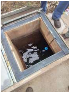
Foto 4 - Tampa de inspeção no reservatório enterrado.
