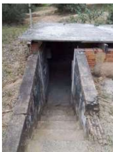
Foto 1 - Escada de acesso à elevatória.
