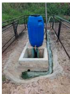
Foto 16 - Retorno do efluente que não cai na calha.
