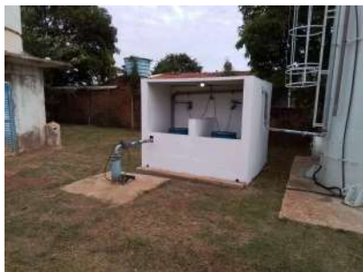
Foto 1 - Visão geral da área do poço.
