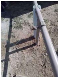
Foto 1 - Torneira para tomada de água bruta.
