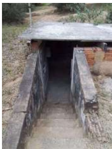
Foto 1 - Acesso à elevatória.
