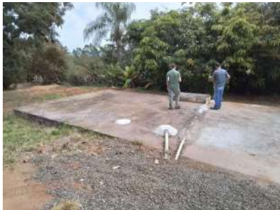
Foto 1 - Reservatório enterrado do poço 7.
