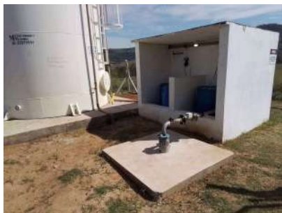
Foto 1 - Laje de concreto.
