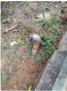
Foto 2 - Tela de proteção no reservatório enterrado.
