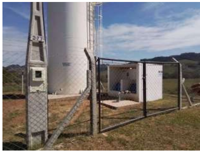
Foto 1 - Cercamento da área.
