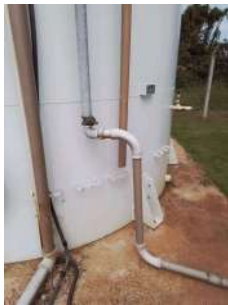
Foto 1 - Descida do extravasor.
