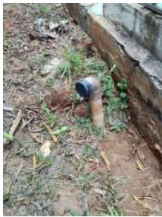
Foto 1 - Tela de proteção no reservatório enterrado.
