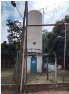
Foto 2 - Vista do reservatório.
