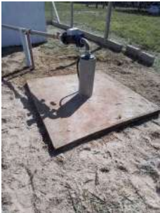
Foto 1 - Laje de concreto.
