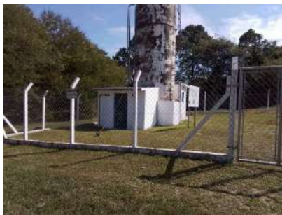
Foto 1 - Cercamento da área.
