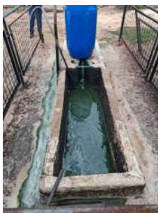
Foto 14 - Saída do tratamento. Este local estava com muitos detritos em fiscalização realizada em 2024.
