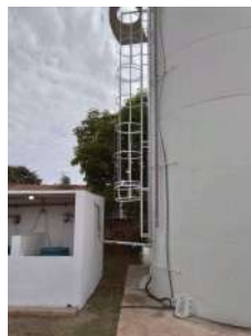
Foto 2 - Abastecimento do reservatório a partir do poço 5.
