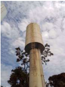
Foto 1 - Este reservatório tipo taça situado na área do poço 6 está desativado e substituirá o reservatório do poço 2.
