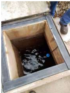
Foto 1 - Tampa de inspeção no reservatório enterrado.
