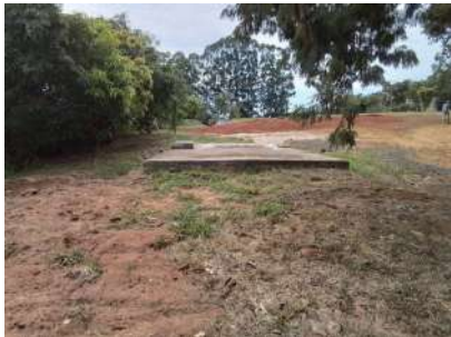
Foto 2 - Reservatório enterrado do poço 7.
