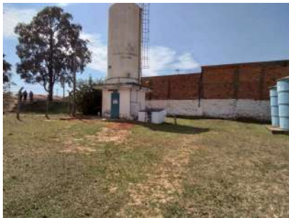
Foto 1 - Visão geral do poço 4 e dos reservatórios que foram desativados (elevado e apoiados à direita).
