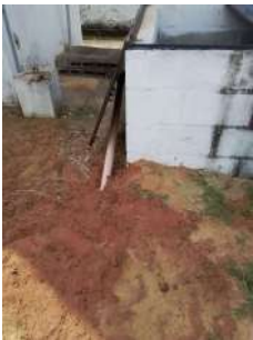
Foto 2 - Detalhe da tubulação que encaminha a água para o reservatório do poço 8 - Rosim.
