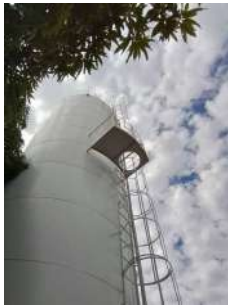
Foto 1 - Escada com guarda-corpo e plataforma de descanso.
