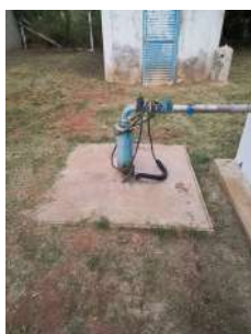
Foto 1 - Laje de concreto.
