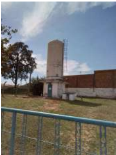
Foto 2 - Reservatório elevado do poço 4.
