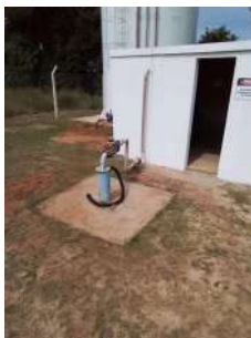
Foto 1 - Laje de proteção.
