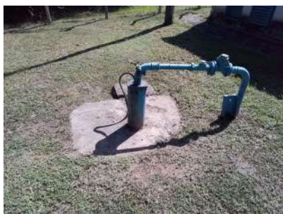
Foto 1 - Laje de concreto do poço.
