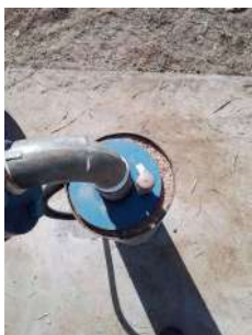
Foto 1 - Tubo de medição de nível.
