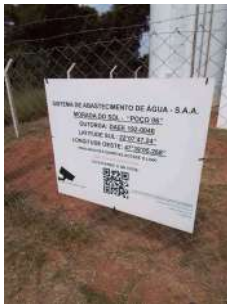
Foto 1 - Placa de identificação do reservatório e poço 6.
