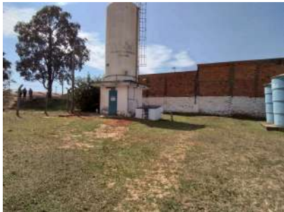
Foto 1 - Reservatório elevado do poço 4.
