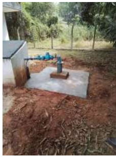
Foto 1 - Laje de proteção recentemente concretada.
