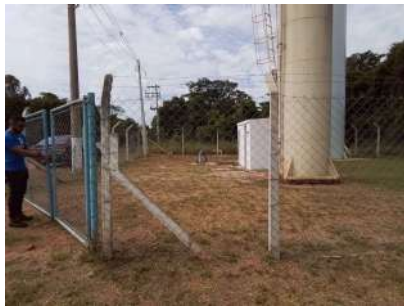
Foto 1 - Cercamento da área.
