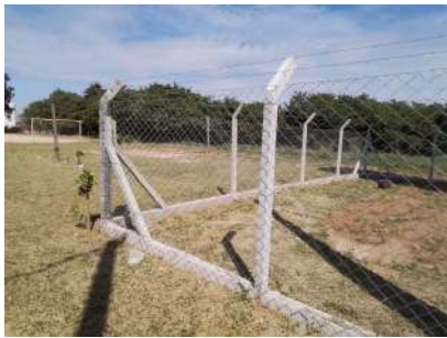
Foto 2 - Cercamento da área.
