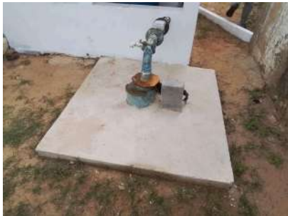
Foto 1 - Laje de concreto.
