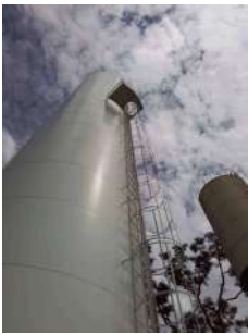
Foto 2 - Escada com guarda-corpo.
