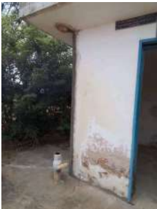
Foto 5 - Desativação do reservatório do poço 4.
