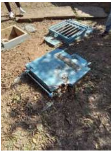
Foto 5 - Tampas do reservatório enterrado.
