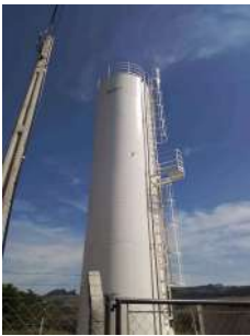
Foto 1 - Escada com guarda-corpo.
