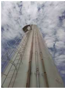
Foto 1 - Escada com guarda-corpo.
