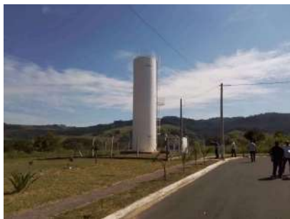
Foto 1 - Visão geral do reservatório.
