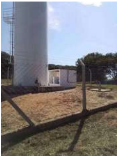
Foto 1 - Visão geral do poço 9 e reservatório, ambos situados próximo ao reservatório caixa do dreno, que foi desativado.
