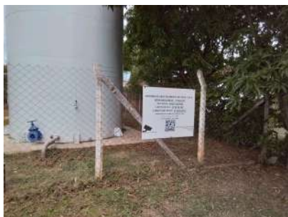
Foto 1 - Cercamento da área.
