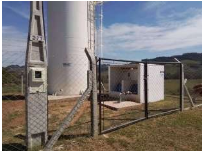
Foto 1 - Vista do poço e reservatório.
