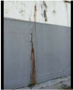
Foto 5 - Vista externa da ETA
