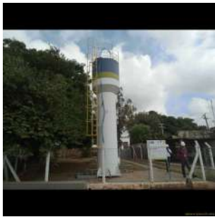
Foto 3 - Vista externa da área do reservatório e poço São João
