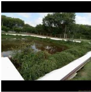
Foto 2 - Vista das lagoas inoperantes
