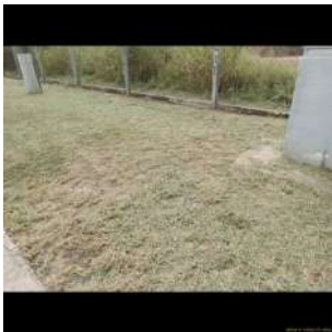
Foto 4 - Cercamento e limpeza da área
