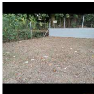
Foto 8 - Cercamento e limpeza da área
