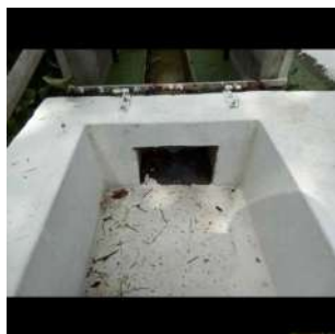
Foto 7 - Saída esgoto tratado
