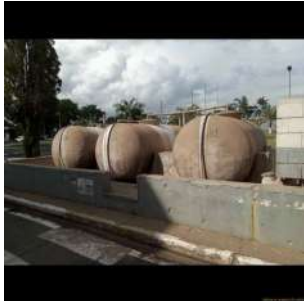
Foto 19 - Armazenamento de Flúor
