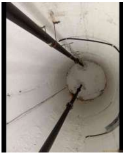
Foto 5 - Laje de fundo do reservatório
