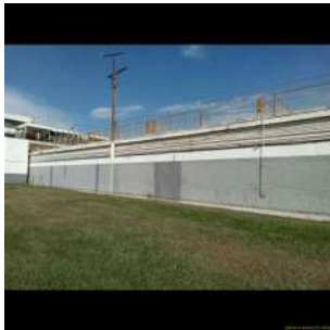
Foto 21 - Vista lateral da ETA
