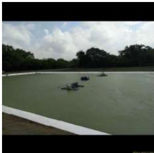
Foto 4 - Vista da lagoa de maturação 1 e aeradores
