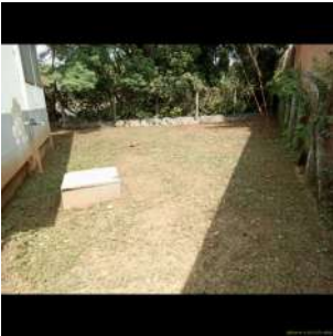
Foto 4 - Cercamento e limpeza da área externa
