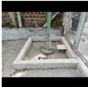
Foto 7 - Laje de proteção
