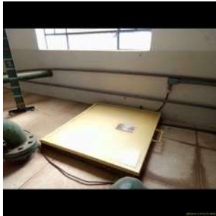
Foto 3 - Tampa de inspeção
