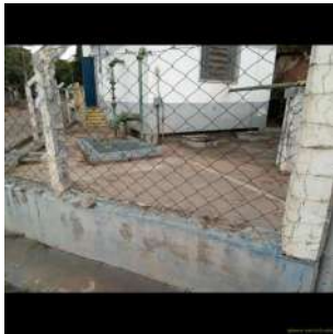
Foto 2 - Cercamento da área
