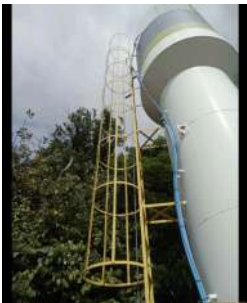
Foto 2 - Escada de acesso e guarda-corpo
