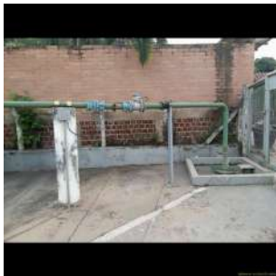
Foto 4 - Cavalete do poço Tatu
