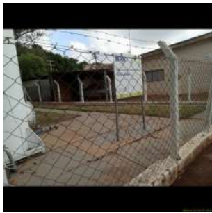
Foto 4 - Cercamento da área
