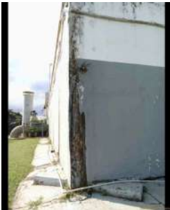
Foto 4 - Vista externa da ETA
