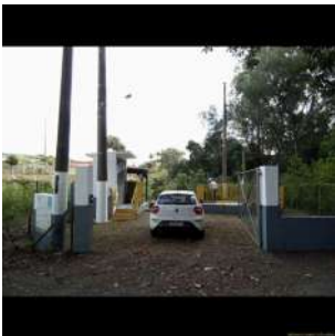
Foto 1 - Vista externa da EEEB Pires
