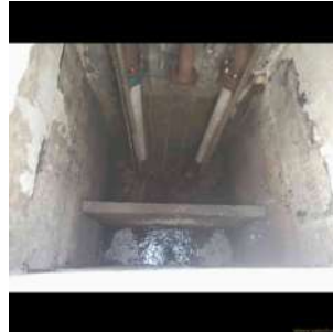
Foto 4 - Vista do interior do poço de sucção
