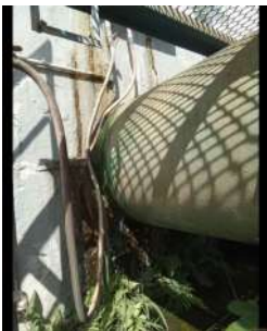
Foto 2 - Vista externa da ETA
