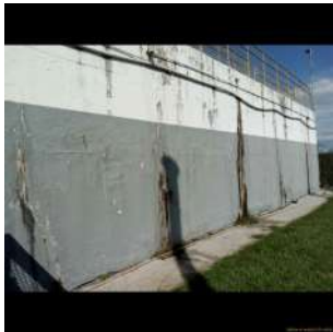
Foto 3 - Vista externa da ETA
