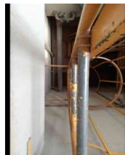
Foto 2 - Vista superior do interior da EEEB Lopes
