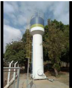
Foto 1 - Reservatório São João
