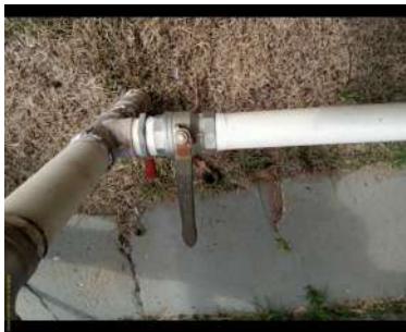
Foto 7 - Tomada para coleta de água bruta
