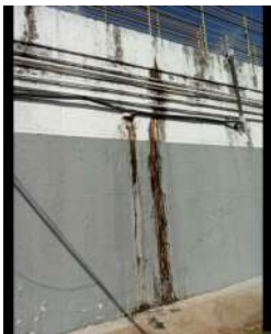
Foto 1 - Vista externa da ETA
