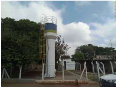
Foto 6 - Vista geral do cercamento área do poço e reservatório São João
