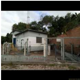
Foto 1 - Vista externa do poço Tatu
