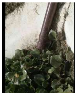
Foto 6 - Chegada do esgoto na lagoa de Maturação 2
