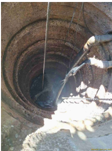
Foto 1 - Entrada do esgoto no poço de sucção
