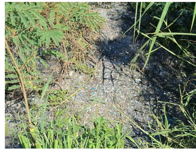
Foto 8 - ETE São Jorge - acúmulo de resíduos na borda da lagoa
