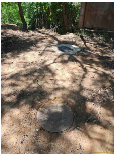
Foto 3 - Poço de sucção localizado na via
