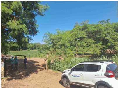
Foto 1 - Portão de entrada - ETE São Jorge
