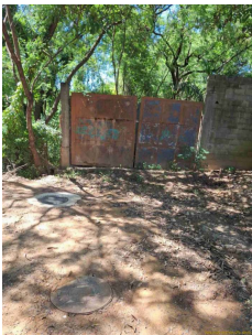
Foto 4 - Poço de sucção em área de entrada
