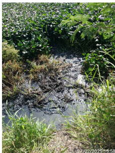
Foto 3 - Evidência de limpeza da ETE São Jorge (2)
