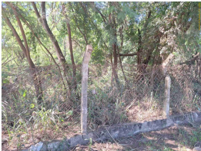
Foto 2 - Cercamento com alambrado - ETE São Jorge
