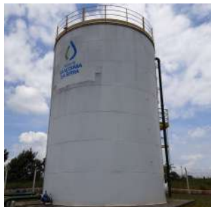
Foto 5 - Vista geral do reservatório.
