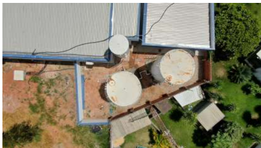
Foto 2 - Vista aérea dos reservatórios e cercamento.
