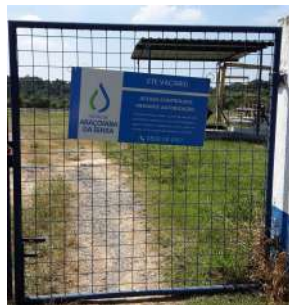
Foto 2 - Placa de identificação afixada no portão de acesso à ETE.
