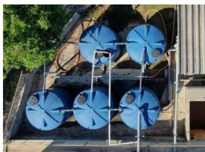
Foto 5 - Vista aérea dos reservatórios.
