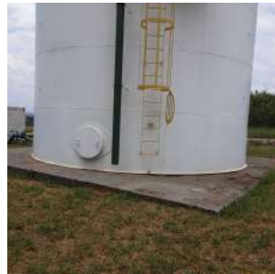
Foto 11 - Vista geral da base do reservatório.
