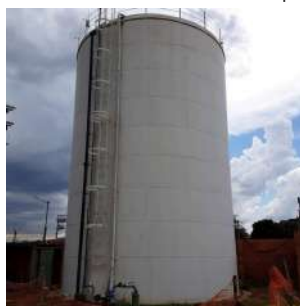
Foto 3 - Vista geral do reservatório.
