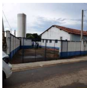
Foto 4 - Cercamento e portão de acesso à área.
