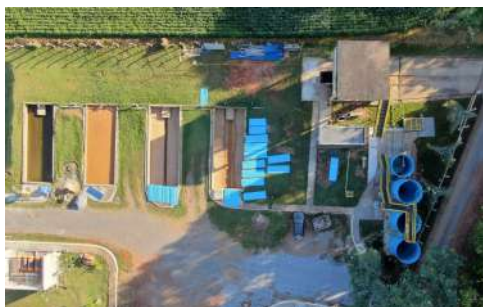
Foto 4 - Vista aérea dos leitos de secagem do sistema atual, à esquerda, e da edificação que abriga as centrífugas e estruturas do novo sistema de tratamento de lodo, à direita.
