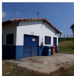
Foto 21 - Vista geral da edificação onde funcionava um laboratório. Segundo o prestador, este laboratório foi desativado, pois todas as análises estão sendo feitas por laboratório externo.
