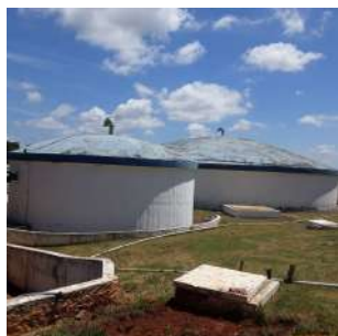
Foto 6 - Vista geral dos reservatórios.
