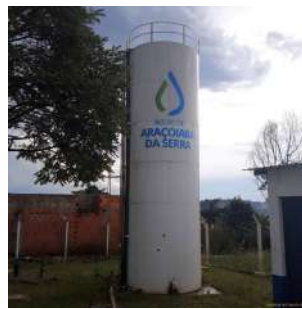
Foto 4 - Vista geral do reservatório. No portão há duas placas de identificação, uma do booster e outra do poço, não há uma placa específica para o reservatório. No entanto, pode ser observada a identificação do prestador de serviços no próprio corpo do reservatório.
