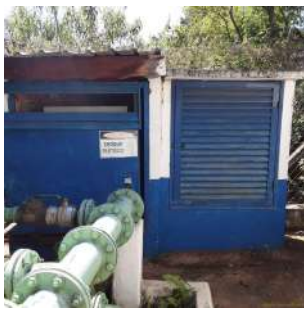
Foto 8 - Abrigo dos painéis elétricos.
