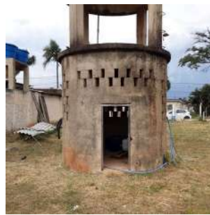
Foto 10 - Estrutura de antigo reservatório desativado que abriga as estruturas acessórias do poço.
