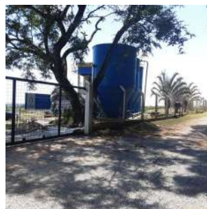
Foto 2 - Cercamento e portão de acesso à área.
