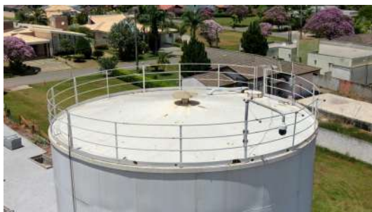
Foto 5 - Guarda corpos no topo do reservatório.
