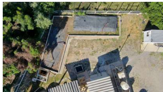
Foto 16 - Vista aérea do sistema de desaguamento de lodo em geobags.
