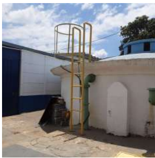
Foto 3 - Escada de acesso ao topo do reservatório
