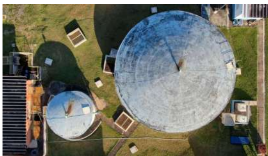
Foto 5 - Vista aérea dos reservatórios. O reservatório menor tem capacidade de 100m 3 e o maior de 1000m 3 .
