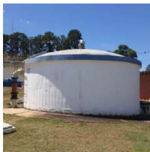
Foto 9 - Vista geral do reservatório com capacidade de 100m 3 .
