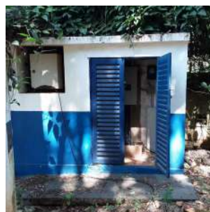
Foto 6 - Vista geral da edificação que abriga os painéis elétricos e o medidor de vazão.
