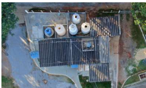
Foto 1 - Vista aérea do pátio de estocagem de produtos químicos.
