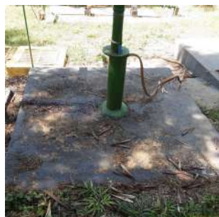
Foto 5 - Detalhe da laje de proteção.
