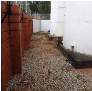
Foto 14 - Bases dos reservatórios 1 e 2.
