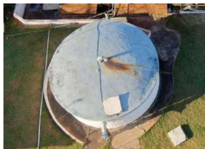
Foto 7 - Vista aérea do reservatório com capacidade de 100m 3 .
