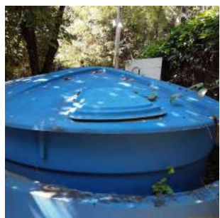
Foto 7 - Detalhe da tampa de inspeção do Reservatório 1.
