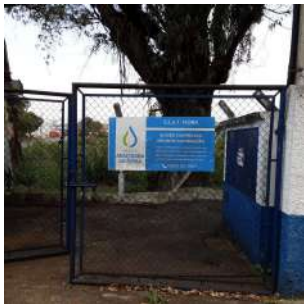
Foto 2 - Placa de identificação da elevatória, afixada em local visível a partir da Rua Osório Rosa.
