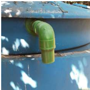
Foto 1 - Detalhe do tubo sem tela de proteção.
