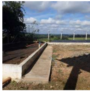
Foto 18 - Vista geral dos geobags.
