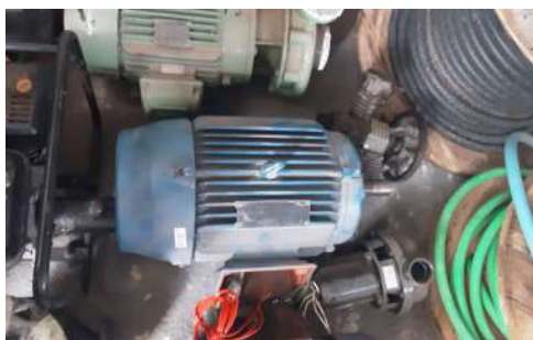
Foto 11 - Motor da bomba reserva armazenado no almoxarifado.
