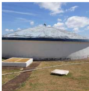
Foto 11 - Vista geral do reservatório com capacidade de 1000m 3 .
