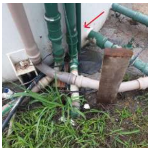
Foto 7 - Detalhe da tubulação. A seta indica o tubo extravasor.
