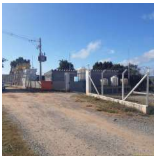
Foto 3 - Cercamento e portão de acesso à área.
