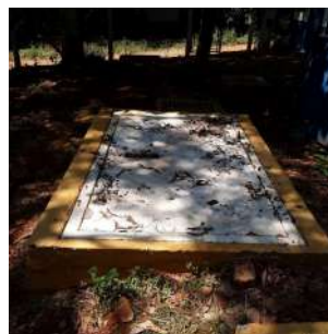
Foto 4 - Caixa onde está instalada a bomba da elevatória. No momento da fiscalização não foi possível abrir a tampa para verificação interna.
