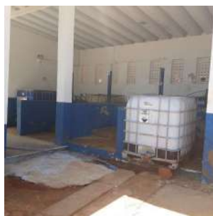
Foto 6 - Área coberta do pátio de estocagem.
