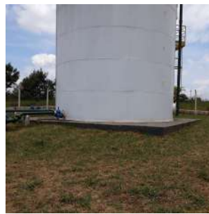
Foto 10 - Vista geral da base do reservatório.
