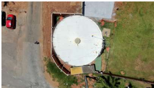
Foto 2 - Vista aérea do local onde estão instalados o reservatório e o poço.
