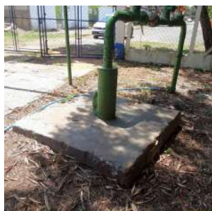
Foto 5 - Detalhe da laje de proteção.
