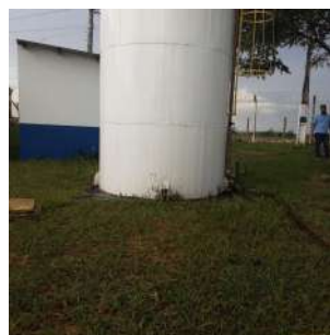
Foto 9 - Detalhe da base do reservatório.
