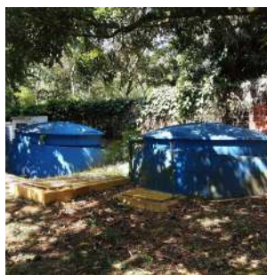
Foto 4 - Vista geral dos reservatórios.
