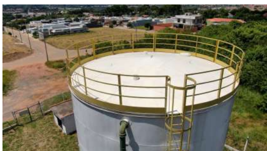
Foto 7 - Guarda corpos no topo do reservatório.
