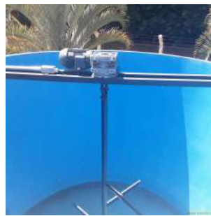
Foto 11 - Motor e pás do tanque de homogeneização do lodo.
