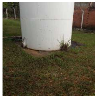
Foto 8 - Detalhe da base do reservatório.
