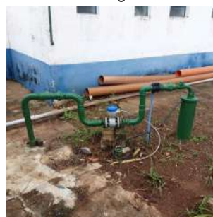
Foto 5 - Vista geral da estrutura do poço.
