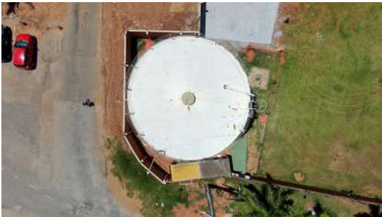
Foto 2 - Vista aérea do local onde estão instalados o reservatório e o poço (à direita do reservatório).
