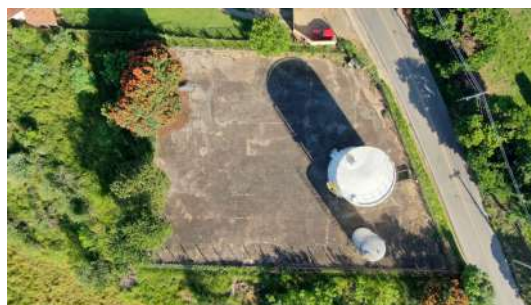
Foto 4 - Vista aérea do local. É possível visualizar dois reservatórios, o menor é um reservatório antigo que está desativado e foi mantido no local, o reservatório maior é o objeto desta fiscalização.
