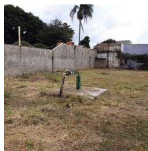
Foto 4 - Vista geral da estrutura do poço.
