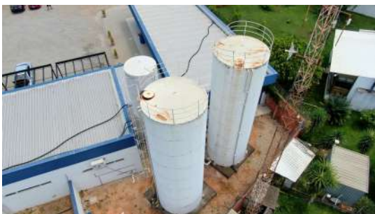
Foto 5 - Vista geral dos reservatórios.
