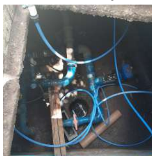
Foto 4 - Vista geral da elevatória.
