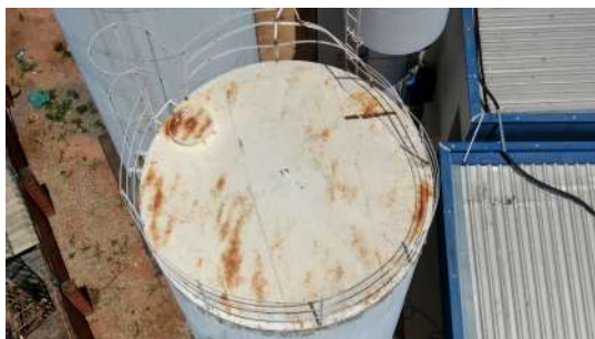
Foto 6 - Vista geral do topo do reservatório 1.
