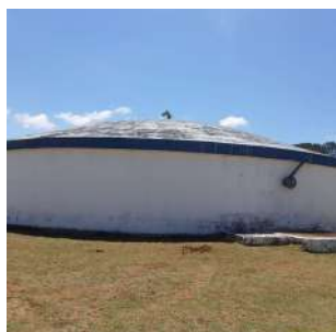
Foto 12 - Vista geral do reservatório com capacidade de 1000m 3 .
