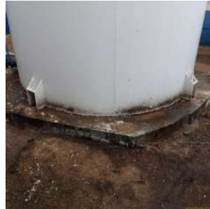
Foto 9 - Detalhe da base do reservatório.
