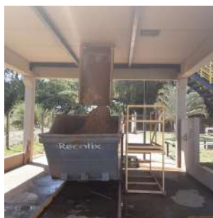
Foto 7 - Caçamba de armazenamento do lodo desidratado. Na reforma dessa edificação houve o reforço das estruturas de sustentação, especialmente a laje do teto.
