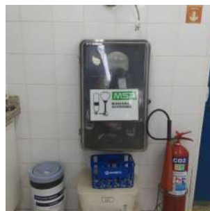
Foto 2 - Máscara autônoma instalada no interior do laboratório.
