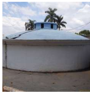
Foto 4 - Vista geral do reservatório. A estrutura no topo abriga a tubulação de ventilação.
