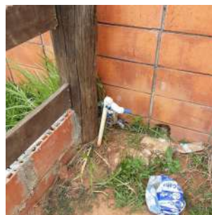
Foto 8 - Torneira para coleta de água bruta localizada próximo ao poço.
