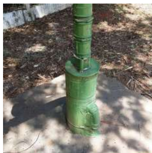
Foto 8 - Tubo de medição de nível.
