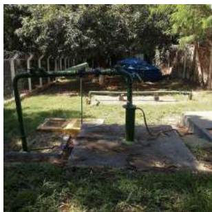
Foto 3 - Vista geral da estrutura do poço.
