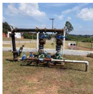
Foto 3 - Vista geral da elevatória.
