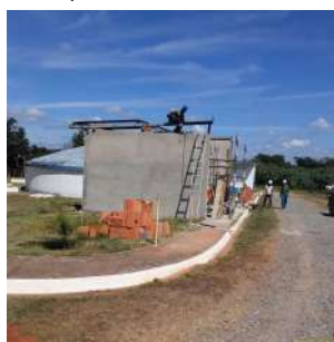
Foto 9 - Vista geral da edificação. Os trabalhadores estavam implantando um teto retrátil na edificação, segundo o prestador, essa estrutura foi concebida para aumentar a segurança das operações de instalação e retirada dos cilindros.
