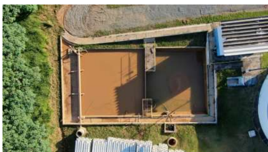
Foto 1 - Vista aérea dos tanques de decantação de lodo proveniente de descarga dos decantadores e lavagem dos filtros.
