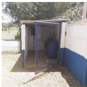
Foto 7 - Vista geral da edificação que abriga os equipamentos de aplicação de cloro e flúor na água bruta.
