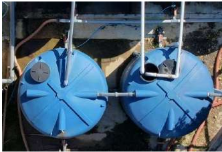
Foto 1 - Reservatório utilizado na distribuição de água com a tampa aberta.
