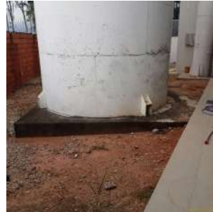
Foto 13 - Base do Reservatório 1.
