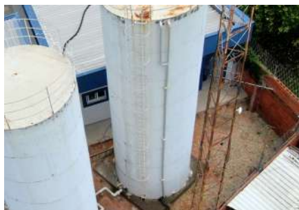
Foto 9 - Tubulação de entrada de água no reservatório 1.
