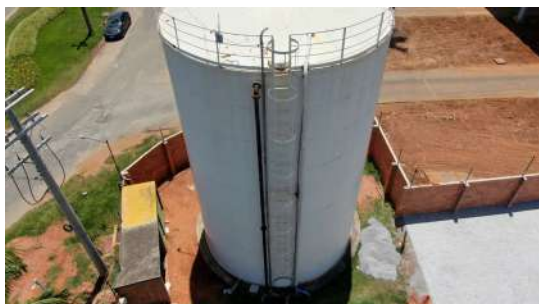
Foto 4 - Escada de acesso ao topo do reservatório.
