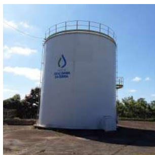
Foto 5 - Vista geral do reservatório.
