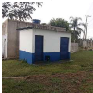
Foto 5 - Vista geral da edificação que abriga a elevatória.
