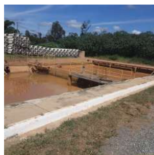
Foto 2 - Vista geral dos tanques de decantação de lodo. Segundo o prestador, após a conclusão das
