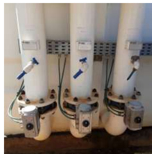
Foto 12 - Torneiras para coleta de amostras da água tratada que sai dos filtros.
