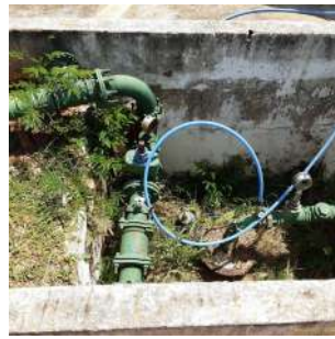
Foto 8 - Detalhe da caixa dos registros de manobras.
