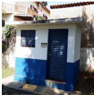
Foto 10 - Vista geral da edificação que abriga os equipamentos de aplicação de cloro e fluor na água bruta.
