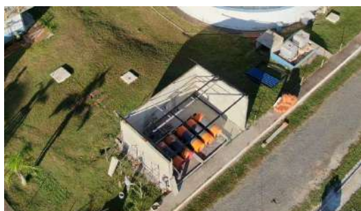
Foto 8 - Vista aérea da edificação que abriga dos cilindros de gás cloro. Essa edificação estava passando por obras de adequação no momento da fiscalização.
