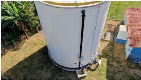
Foto 7 - Vista geral do tubo extravasor.
