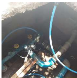
Foto 3 - Vista geral da elevatória.
