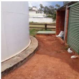
Foto 10 - Vista geral da base do reservatório. À direita está uma pequena edificação que abriga os tanques de produtos químicos e bombas dosadoras do poço. Há também uma elevatória que, segundo o prestador, pertence ao condomínio e é utilizada para pressurizar a água distribuída para as casas.
