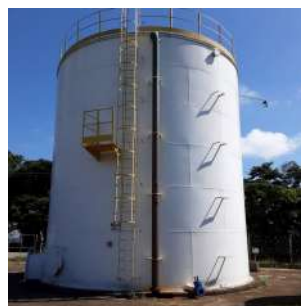
Foto 6 - Escada de acesso ao topo do reservatório e à direita, o tubo extravasor.
