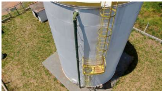
Foto 6 - Escadas de acesso ao topo do reservatório e tubo extravasor à esquerda.
