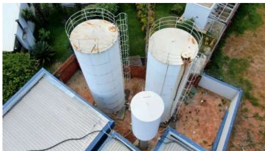
Foto 8 - Vista das escadas e guarda-corpos dos reservatórios.
