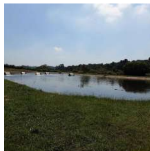
Foto 6 - Vista geral da lagoa de aeração.
