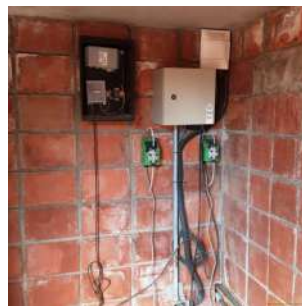
Foto 12 - Bombas dosadoras de cloro e flúor.
