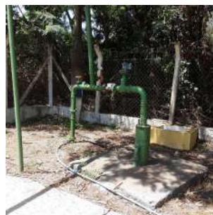
Foto 4 - Vista geral da estrutura do poço.
