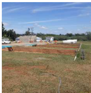
Foto 5 - Vista geral dos leitos de secagem. Segundo o prestador, esses leitos serão mantidos após o início da operação do novo sistema, e poderão ser utilizados para contingência em casos de sobrecarga ou necessidade de manutenção do sistema.
