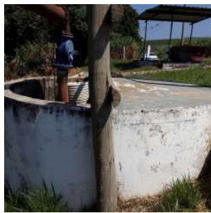
Foto 15 - Poço de bombeamento em uso na elevatória.
