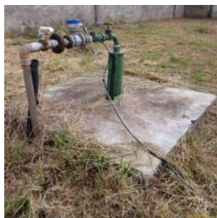
Foto 5 - Detalhe da laje de proteção.
