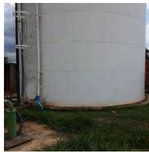
Foto 8 - Vista geral da base do reservatório.
