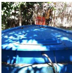
Foto 8 - Detalhe da tampa de inspeção do Reservatório 2.
