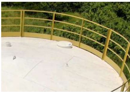
Foto 9 - Tampa de inspeção no topo do reservatório.
