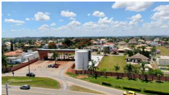
Foto 1 - Vista aérea da entrada do condomínio Village Ipanema I, ao centro a área do reservatório e do poço.
