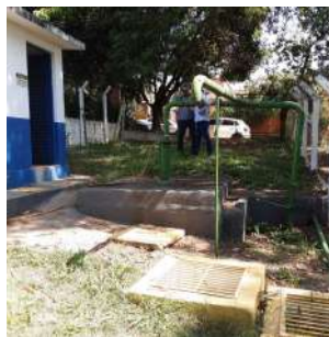
Foto 4 - Vista geral da estrutura do poço.
