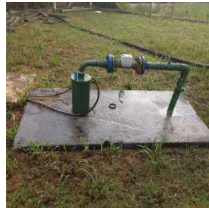
Foto 4 - Vista geral da estrutura do poço.
