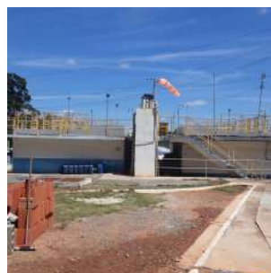
Foto 6 - Vista geral da ETA.
