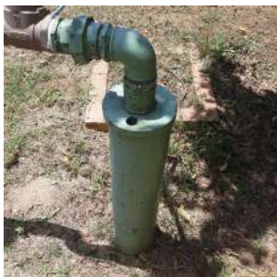
Foto 1 - Detalhe da tubulação do poço sem o tubo de medição de nível.
