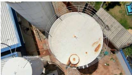
Foto 7 - Vista geral do topo do reservatório 2.
