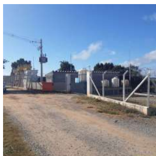
Foto 3 - Cercamento e portão de acesso à área.
