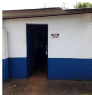
Foto 4 - Vista geral da edificação que abriga os equipamentos da elevatória.
