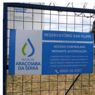
Foto 4 - Não foi localizada placa específica para a elevatória, mas há uma placa de identificação do reservatório afixada em local visível na entrada da área.
