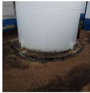
Foto 8 - Detalhe da base do reservatório.
