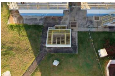
Foto 24 - Esta caixa protegida por grades amarelas é o ponto onde as águas provenientes
