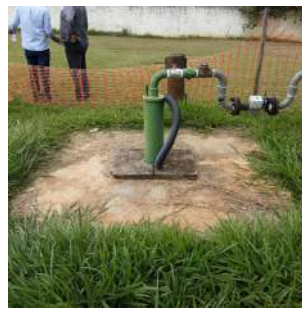
Foto 4 - Detalhe da laje de proteção.
