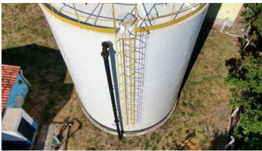
Foto 5 - Escada de acesso ao topo do reservatório. À esquerda, a tubulação de entrada da água no reservatório e no topo a tampa de inspeção.
