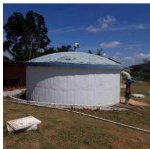
Foto 8 - Vista geral do reservatório com capacidade de 100m 3 .
