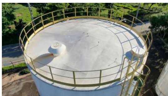
Foto 7 - Guarda-corpos no topo do reservatório. À direita está a tampa de inspeção e à esquerda o tubo de ventilação.
