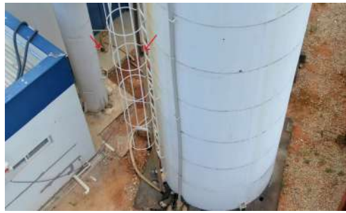
Foto 2 - As setas vermelhas nesta imagem indicam o ponto de conexão com a mangueira de bombeiro e o bocal dela sem conexão com outros equipamentos.
