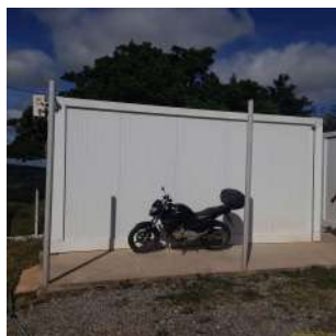
Foto 30 - Container onde funciona o laboratório.
