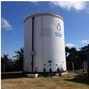
Foto 4 - Vista geral do reservatório.
