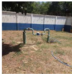
Foto 4 - Vista geral da estrutura do poço.
