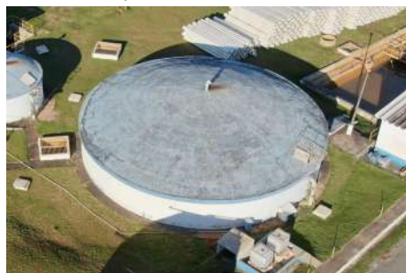
Foto 10 - Vista aérea do reservatório com capacidade de 1000m 3 .
