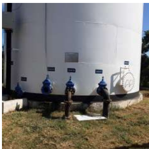
Foto 9 - Registros e tubulações de saída da água do reservatório e tampa de inspeção à direita. Todas as estruturas estão identificadas com pequenas placas.
