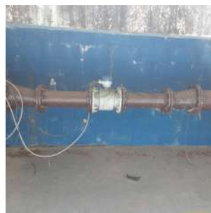
Foto 19 - Detalhe do macromedidor de entrada do efluente bruto.
