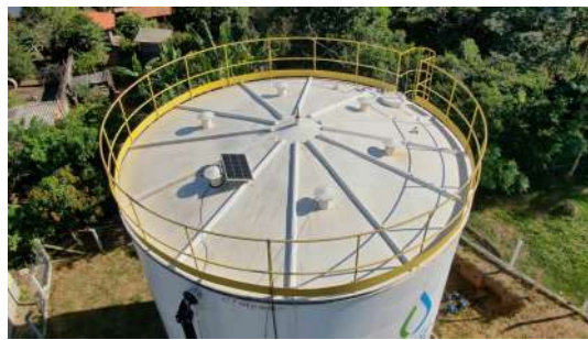
Foto 6 - Guarda-corpos no topo do reservatório. Na imagem também é possível visualizar seis tubos de ventilação e uma pequena placa fotovoltaica.
