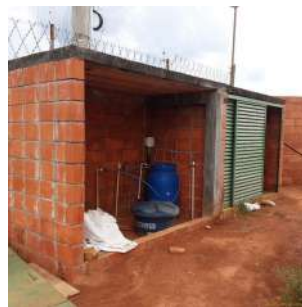
Foto 10 - Vista geral da edificação que abriga os equipamentos de aplicação de cloro e flúor na água bruta.
