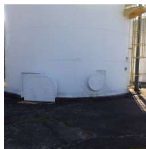
Foto 8 - Tampas de inspeção na base do reservatório.
