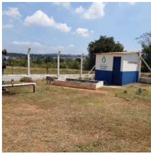
Foto 7 - Vista geral da caixa de manobras e edificação para abrigo dos painéis elétricos.
