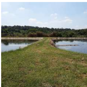
Foto 5 - Ponto de passagem do efluente da primeira para a segunda lagoa.
