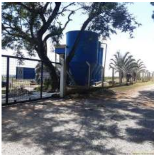
Foto 2 - Cercamento e portão de acesso à área.
