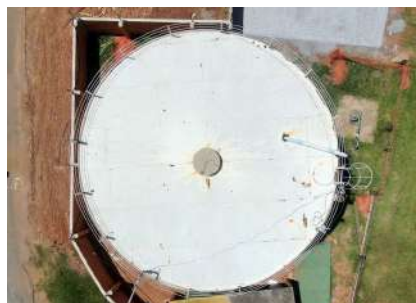
Foto 6 - Vista geral do topo do reservatório, é possível visualizar a tubulação de ventilação no centro e, à direita, a tubulação de entrada da água no reservatório e tampa de inspeção.
