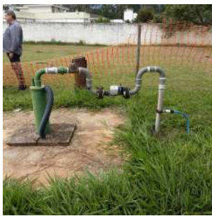
Foto 3 - Vista geral da estrutura do poço.
