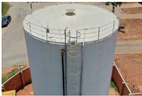
Foto 7 - Vista da porção superior do tubo extravasor, localizado à esquerda da escada.
