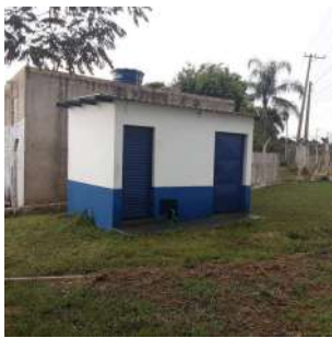
Foto 9 - Vista geral da edificação que abriga os equipamentos de aplicação de cloro e flúor na água bruta.
