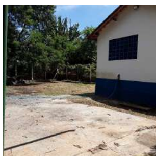
Foto 10 - Ponto de saída da mangueira dosadora de cloro da edificação.
