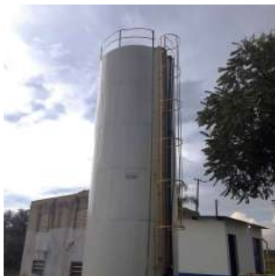
Foto 5 - Escada de acesso e guarda-corpos no topo do reservatório.
