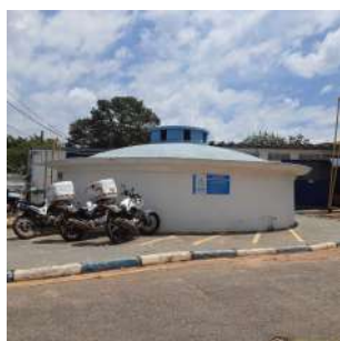
Foto 1 - Vista geral do reservatório.
