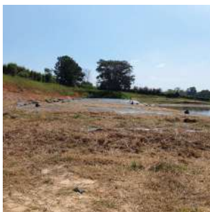
Foto 10 - Vista geral do pátio de desagendamento do lodo retirado das lagoas. Segundo o prestador, a última retirada foi realizada em dezembro de 2023.
