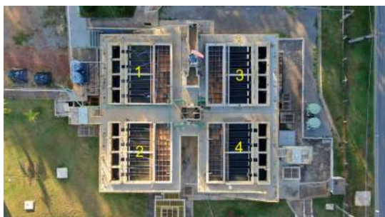
Foto 5 - Vista aérea da ETA. A ETA é composta por quatro módulos, cada módulo tem um floculador hidráulico, dois decantadores e quatro filtros. Na imagem os módulos estão numerados na sequência que aparecem neste relatório.
