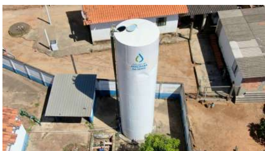
Foto 3 - Vista geral do reservatório.
