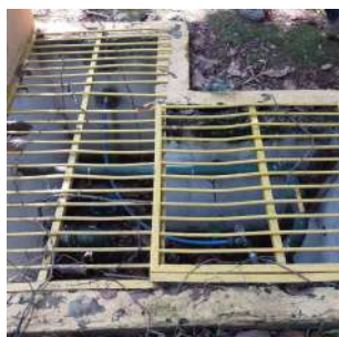
Foto 5 - Caixa de registros da tubulação, protegida por grades.
