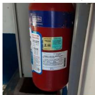
Foto 10 - Detalhe da etiqueta de controle de manutenções do extintor - dentro da validade.
