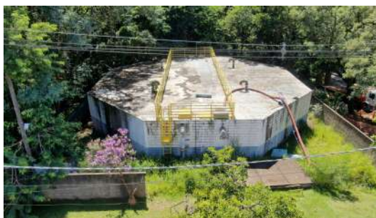
Foto 2 - Vista geral do reservatório.
