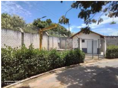
Foto 1 - Vista geral do local onde se situa a EEAT.
