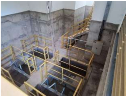
Foto 2 - Vista geral interna da edificação que abriga o gradeamento grosseiro e os tanques de desarenação.
