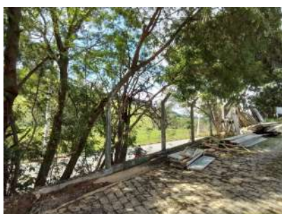
Foto 1 - Cercamento com alambrado da ETA II.
