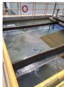
Foto 12 - Tanque de decantação.
