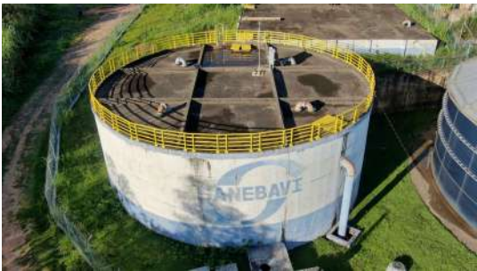
Foto 4 - Vista aérea do reservatório.
