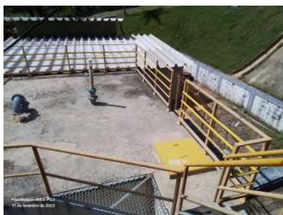
Foto 1 - Guarda-corpo na laje e escada de acesso ao reservatório.
