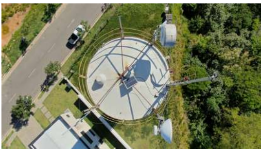
Foto 1 - Tampa de inspeção no topo do reservatório.
