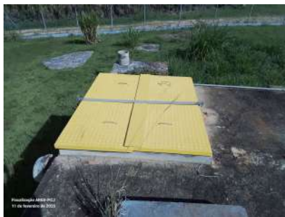
Foto 1 - Tampa do reservatório.
