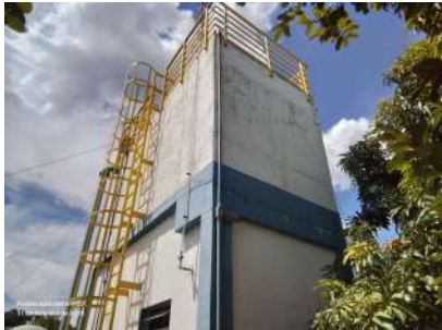
Foto 2 - Aspecto geral do reservatório.
