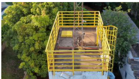
Foto 1 - Tampa de inspeção no topo do reservatório.
