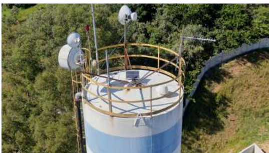
Foto 1 - Tubulação de ventilação, à direita.
