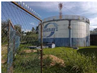
Foto 1 - Cercamento do local com alambrado.
