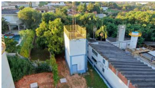
Foto 6 - Vista aérea do reservatório.
