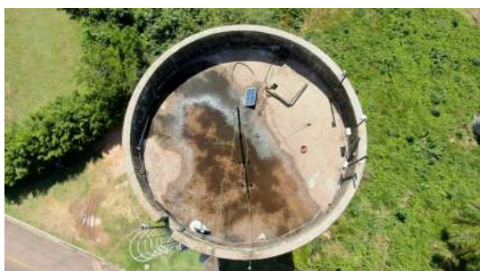
Foto 1 - Tampa de inspeção no topo do reservatório.
