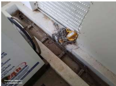
Foto 3 - Talha para içamento das bombas.
