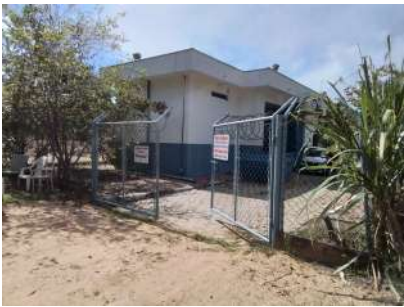
Foto 1 - Vista geral da EEE.
