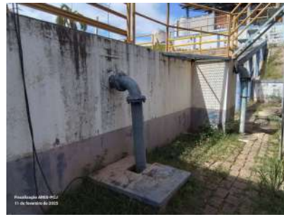
Foto 4 - Vista da lateral do reservatório
