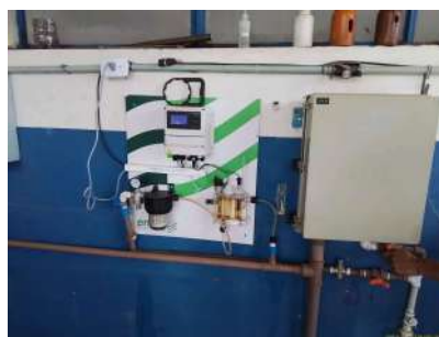
Foto 2 - Analisador de cloro e flúor.
