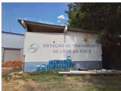
Foto 1 - Identificação do local onde se situa a EEAT.
