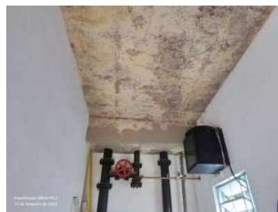
Foto 4 - Detalhe das tubulações do reservatório.
