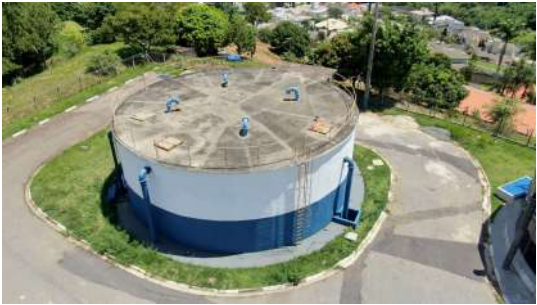
Foto 2 - Vista geral do reservatório.
