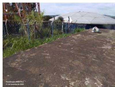
Foto 2 - Cercamento com alambrado do local.
