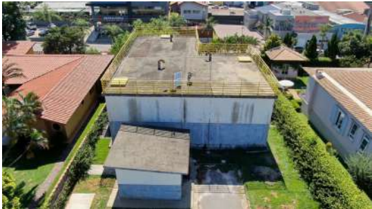
Foto 5 - Vista geral do reservatório.
