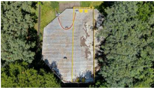
Foto 1 - Tampas de inspeção no topo do reservatório.
