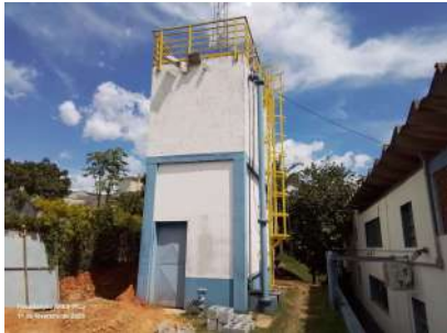
Foto 1 - Vista geral externa do reservatório.
