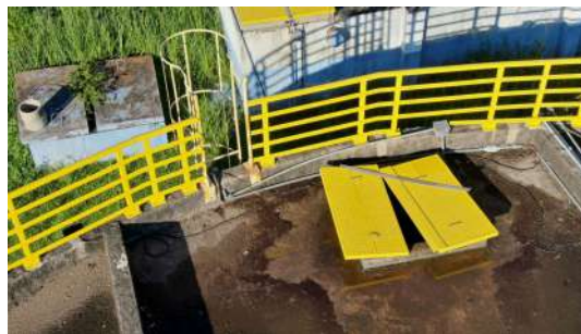
Foto 2 - Tamba aberta no topo do reservatório.
