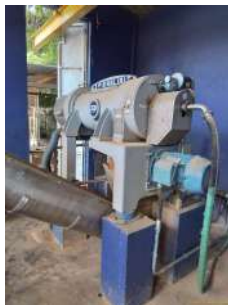
Foto 7 - Centrífuga de lodo.
