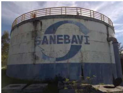
Foto 1 - Identificação do local na estrutura do reservatório.
