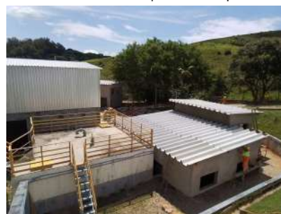
Foto 5 - Obras de ampliação da ETA.
