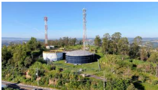
Foto 5 - Vista geral do local onde se encontra o reservatório.
