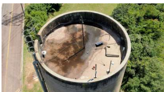
Foto 1 - Tubulação de ventilação próxima à escada.
