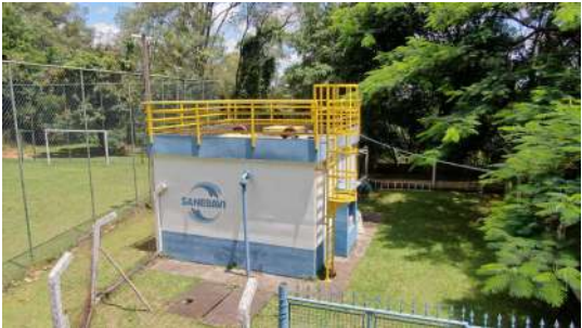
Foto 2 - Vista geral do reservatório.
