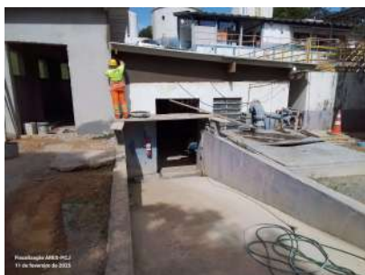
Foto 4 - Vista geral da edificação que a abriga a EEAT.
