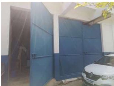
Foto 1 - Porta de acesso ao gradeamento grosseiro e tanques de desarenação.
