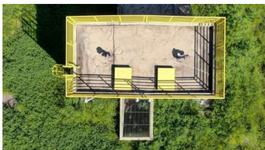
Foto 1 - Tampas de inspeção no topo do reservatório.
