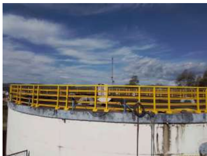
Foto 1 - Para-raio no topo do reservatório.
