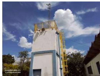
Foto 2 - Guarda-corpo no topo do reservatório.
