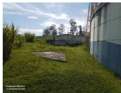
Foto 2 - Vista geral do reservatório.
