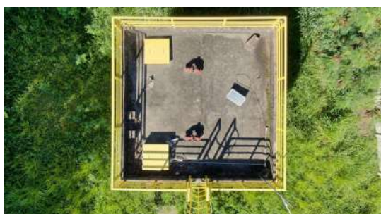
Foto 1 - Tampas de inspeção no topo do reservatório.
