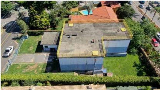
Foto 6 - Vista geral do reservatório.
