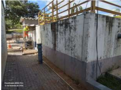
Foto 5 - Vista da lateral do reservatório
