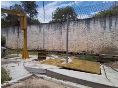
Foto 3 - Vista do local onde encontram-se os poços com as motobombas e gradeamento.
