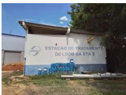
Foto 1 - Identificação do local onde se encontra o reservatório.
