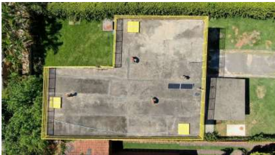
Foto 1 - Tampas de inspeção no topo do reservatório.
