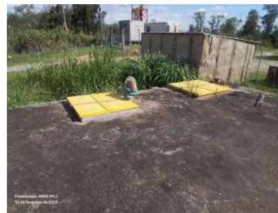
Foto 2 - Tampas do reservatório.
