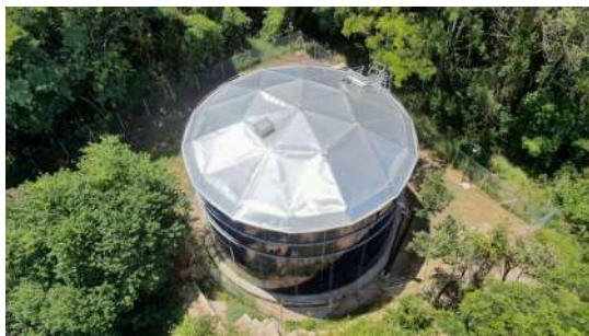
Foto 3 - Vista geral do reservatório.
