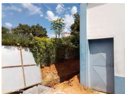
Foto 1 - Cercamento da ETA II com alambrado.
