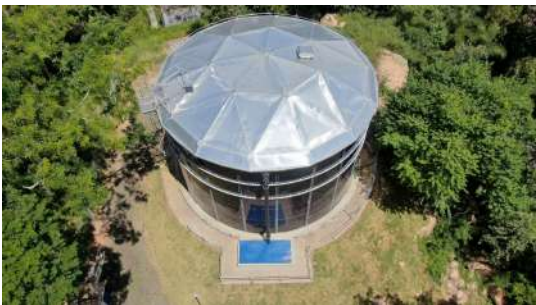
Foto 2 - Vista geral do reservatório.
