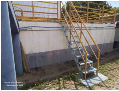
Foto 3 - Vista da lateral do reservatório.
