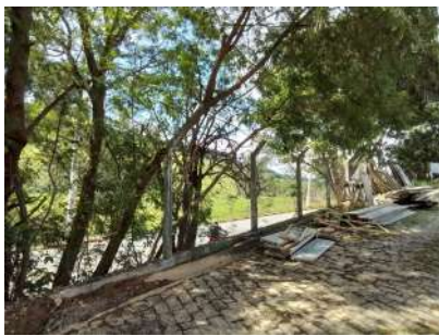
Foto 1 - Cercamento com alambrado da ETA II.
