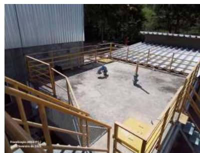
Foto 2 - Guarda-corpo na laje e escada de acesso ao reservatório.
