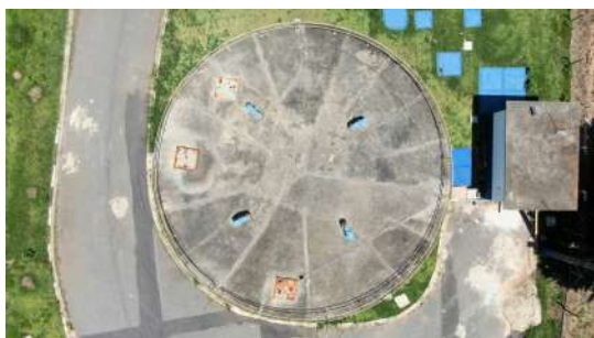
Foto 1 - Tampas de inspeção no topo do reservatório.
