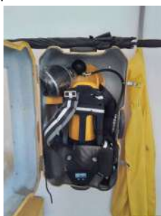
Foto 3 - Kit de uso de emergência do gás cloro, armazenado no prédio que abriga o laboratório.
