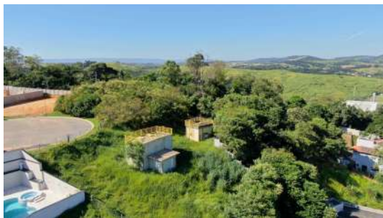
Foto 1 - Vista do local onde se encontra o reservatório (ao fundo).
