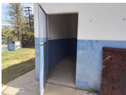
Foto 1 - Porta de acesso à edificação que abriga a EEAT.
