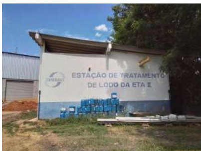
Foto 1 - Identificação do local onde encontra-se o reservatório.
