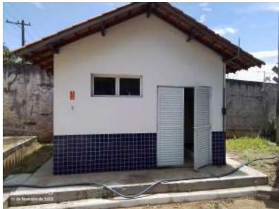
Foto 4 - Vista externa da edificação que abriga os painéis elétricos e o gerador de energia.
