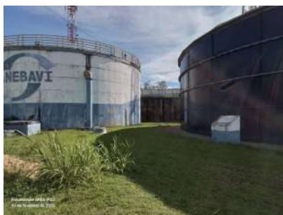
Foto 1 - Vista geral do local onde se situa o reservatório.
