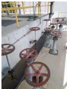
Foto 16 - Válvulas pós-filtração.
