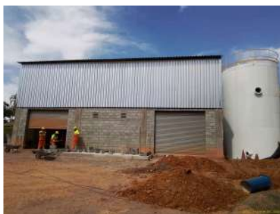
Foto 6 - Obras de ampliação da ETA.
