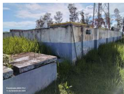
Foto 5 - Vista do reservatório.
