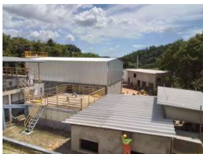
Foto 4 - Obras de ampliação da ETA.
