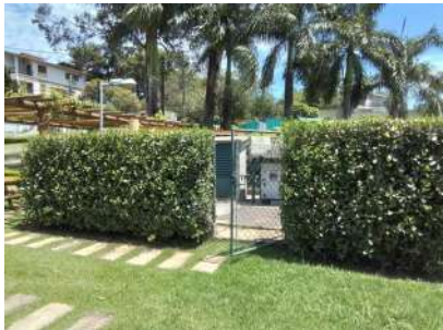
Foto 1 - Vista externa da EEE.
