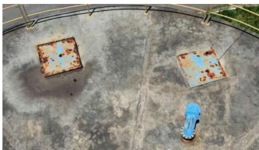
Foto 2 - Detalhe das tampas de inspeção.
