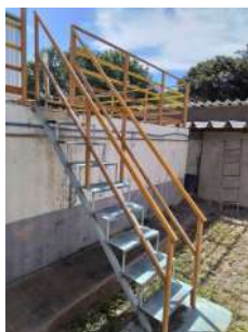
Foto 18 - Reservatório de concreto da ETA.
