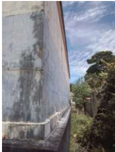
Foto 3 - Vista lateral do reservatório.
