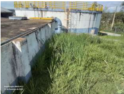
Foto 2 - Mato alto ao redor do reservatório.
