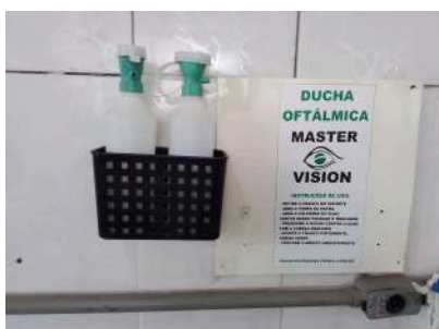
Foto 1 - Ducha oftálmica do laboratório.
