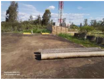
Foto 3 - Cercamento com alambrado do local.
