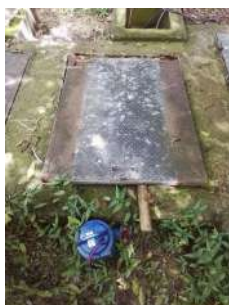
Foto 1 - Bomba em operação da EEE.
