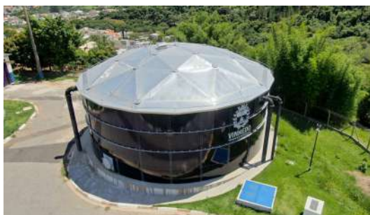
Foto 2 - Vista geral do reservatório.
