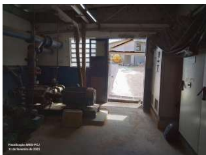
Foto 1 - Porta de acesso à EEAT.
