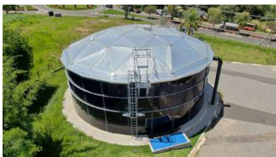
Foto 1 - Guarda-corpo na escada e ao redor da tampa de inspeção no topo do reservatório.
