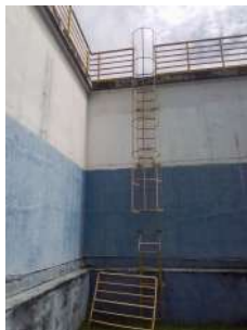
Foto 1 - Escada e topo do reservatório com guarda-corpo.
