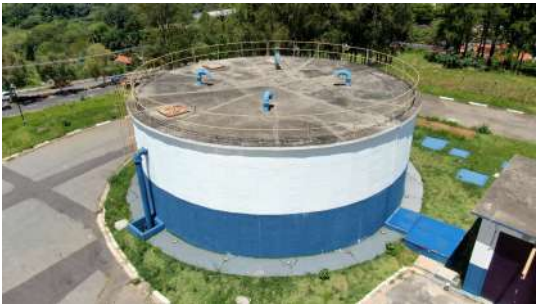
Foto 3 - Vista geral do reservatório.
