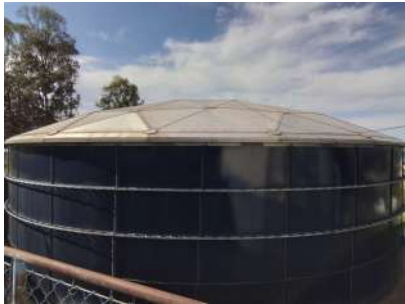
Foto 1 - Vista geral do reservatório.
