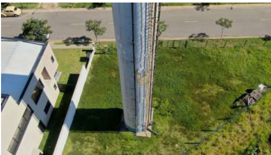
Foto 2 - Guarda-corpo na escada do reservatório.
