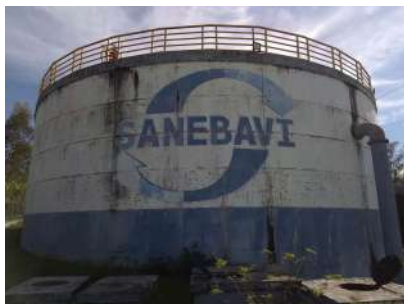
Foto 1 - Identificação do local no Reservatório de Concreto ao lado.
