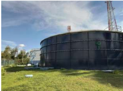
Foto 3 - Vista geral do reservatório.
