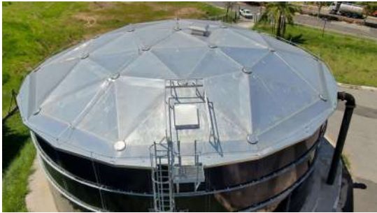
Foto 1 - Tubulação de ventilação no topo do reservatório.
