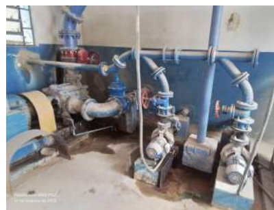
Foto 2 - Vista do interior da edificação que abriga a EEAT.
