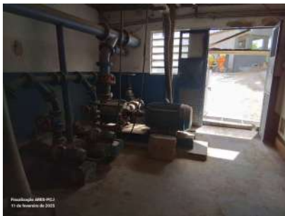
Foto 1 - Porta de acesso ao interior da EEAT.
