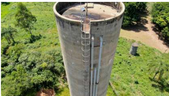
Foto 1 - Guarda-corpo na escada e proteção de alvenaria no topo do reservatório.
