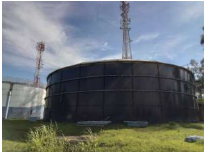
Foto 4 - Vista geral do reservatório.
