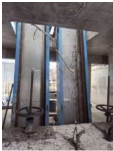
Foto 2 - Esteiras da grade mecanizada.
