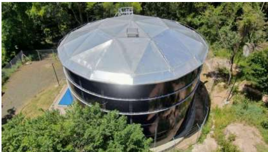
Foto 1 - Tubulação de ventilação no topo do reservatório.
