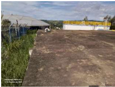
Foto 1 - Tubulação de ventilação do reservatório.
