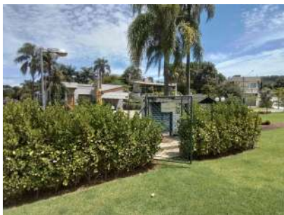
Foto 1 - Vista geral do local onde se situa a EEE.
