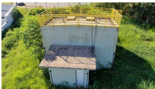
Foto 4 - Vista geral do reservatório.
