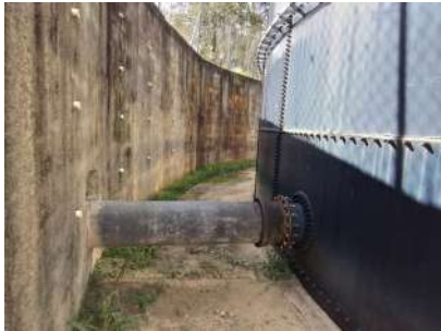
Foto 2 - Tubulação do reservatório.
