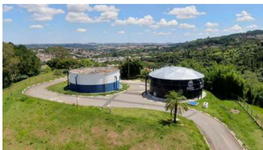
Foto 1 - Vista do local onde se situa o reservatório.
