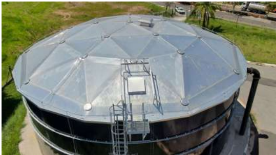
Foto 1 - Tampa de inspeção no topo do reservatório.
