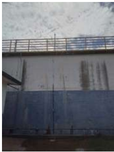
Foto 1 - Para-raio no topo do reservatório.
