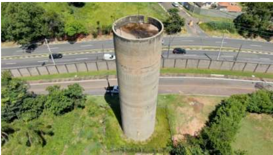
Foto 2 - Vista geral do reservatório.
