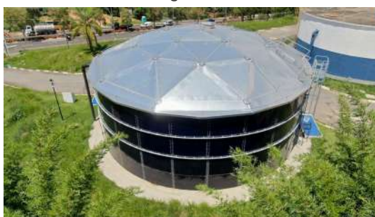
Foto 3 - Vista geral do reservatório.
