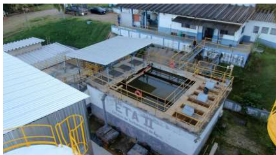
Foto 20 - Vista aérea do módulo de tratamento da ETA II.
