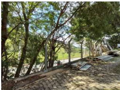
Foto 1 - Cercamento com alambrado da ETA II.
