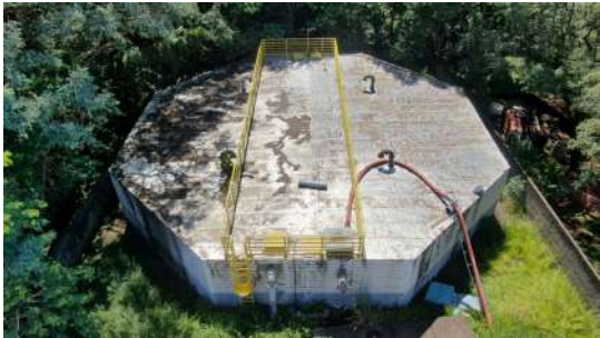
Foto 1 - Tubulação de ventilação no topo do reservatório.
