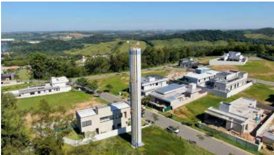
Foto 3 - Vista geral do reservatório.
