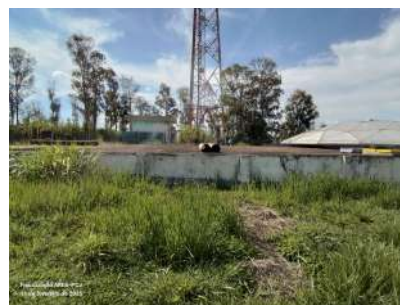
Foto 3 - Vista geral do reservatório.
