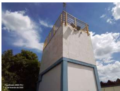
Foto 3 - Aspecto geral do reservatório.
