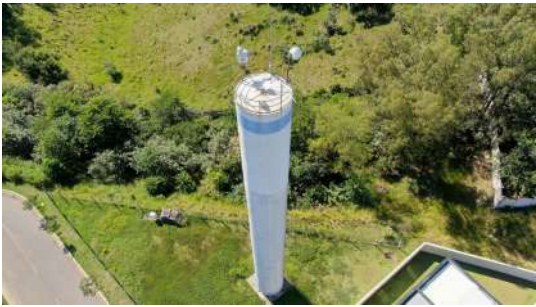
Foto 2 - Vista geral do reservatório.
