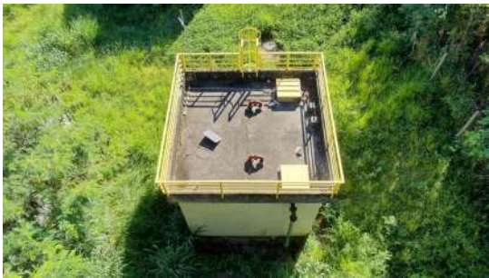
Foto 1 - Tubulação de ventilação no topo do reservatório.
