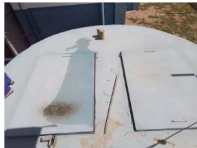
Foto 4 - Laje do poço do conjunto motobomba.
