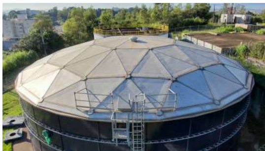
Foto 1 - Tampa de inspeção no topo do reservatório.
