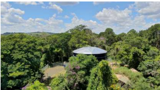
Foto 1 - Vista geral do local onde se encontra o reservatório.
