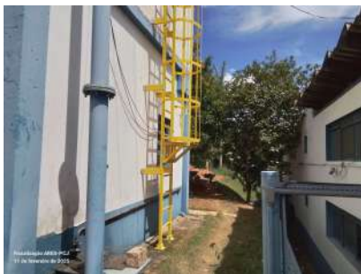
Foto 1 - Escada com guarda-corpo.
