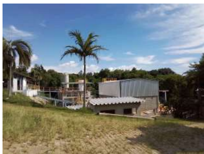
Foto 1 - Vista geral da ETA II: à esquerda, prédio do laboratório e de armazenamento produtos químicos; no centro, módulo de tratamento da água; à direita, obras de ampliação.
