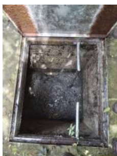
Foto 1 - Gradeamento grosseiro submerso.
