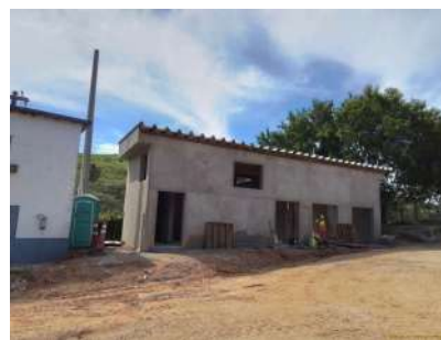
Foto 7 - Obras de ampliação da ETA.
