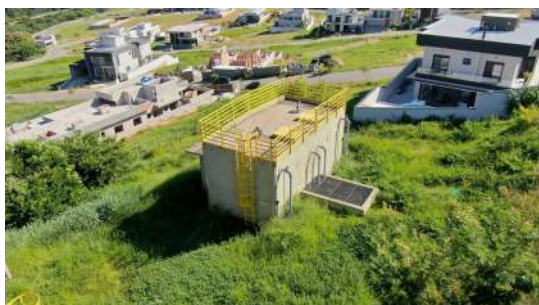
Foto 3 - Vista geral do reservatório.
