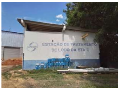
Foto 1 - Identificação do local onde encontra-se a EEAT.
