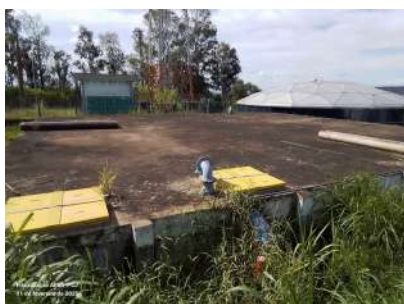
Foto 4 - Vista da laje do reservatório.
