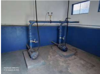
Foto 3 - Vista interna da edificação da EEA.
