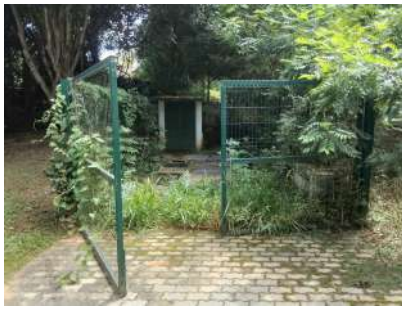
Foto 1 - Vista geral do local da EEE.
