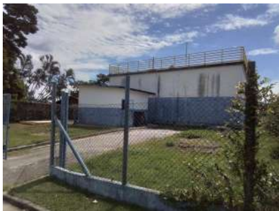
Foto 1 - Vista geral do reservatório.
