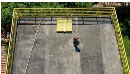
Foto 1 - Tubulação de ventilação no topo do reservatório.
