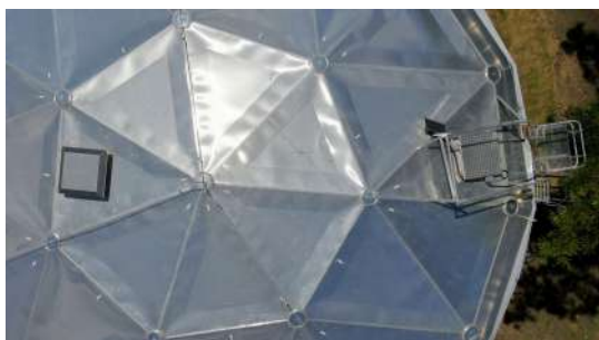
Foto 1 - Tampa de inspeção no topo do reservatório.
