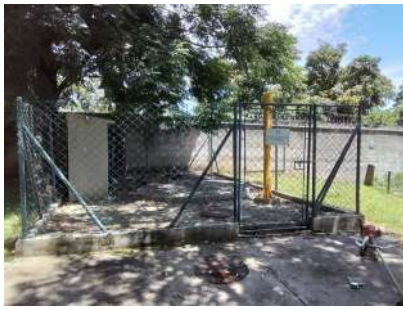
Foto 1 - Vista geral do local da EEE.
