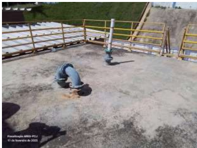
Foto 1 - Vista da laje do reservatório.
