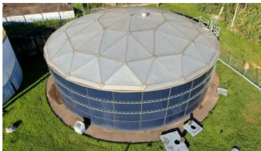
Foto 6 - Vista aérea do reservatório.
