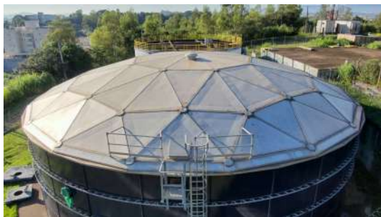
Foto 1 - Tubulação de ventilação no topo do reservatório.
