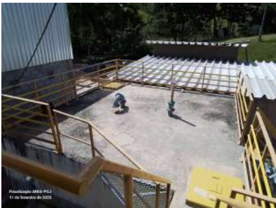
Foto 2 - Vista geral do reservatório.
