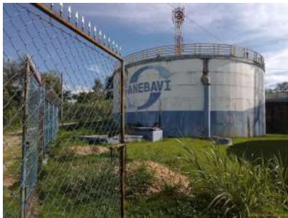
Foto 1 - Vista geral do reservatório.
