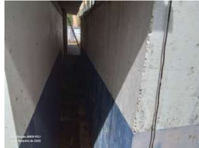
Foto 6 - Vista da lateral do reservatório
