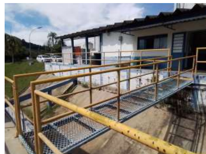
Foto 3 - Prédio do laboratório e de armazenamento de produtos químicos.
