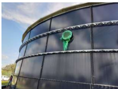
Foto 1 - Tela de proteção na saída do tubo extravasor.
