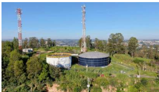
Foto 2 - Para-raios nas torres de telecomunicação no terreno ao lado.
