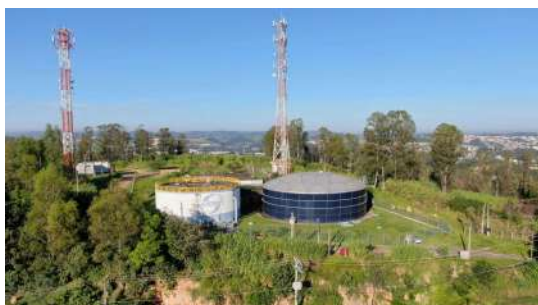
Foto 3 - Para-raios nas torres de telecomunicação no terreno ao lado.
