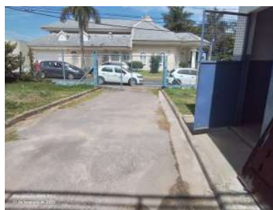
Foto 2 - Portas de acesso ao local e à edificação da EEAT.
