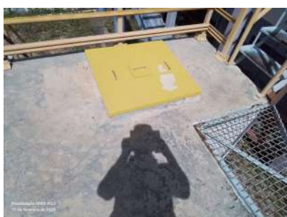
Foto 1 - Tampa do reservatório.
