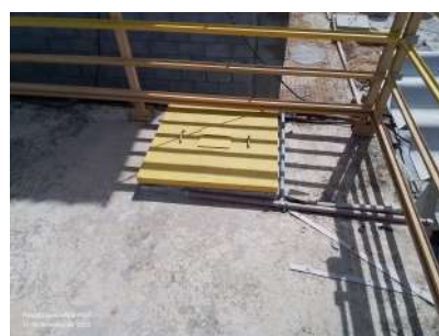
Foto 2 - Tampa do reservatório.
