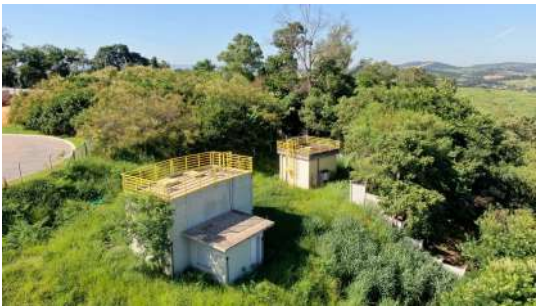
Foto 2 - Vista do local onde se situa o reservatório.
