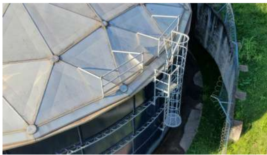
Foto 2 - Guarda-corpo na escada e topo do reservatório.
