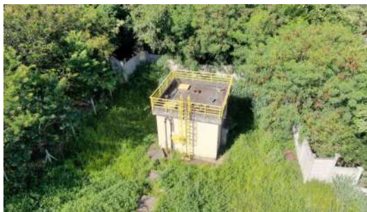
Foto 2 - Vista geral do reservatório.
