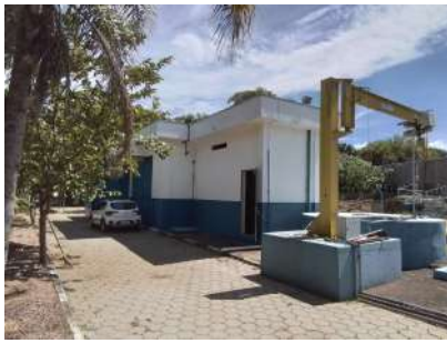
Foto 12 - Vista geral da EEB: em primeiro plano, poços das bombas e, em segundo plano, edificação com o gradeamento grosseiro e tanques de desarenação.
