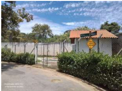
Foto 2 - Vista geral do local onde se situa a EEAT.
