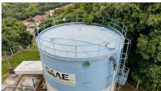
Foto 1 - Vista aérea do reservatório
