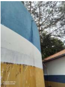
Foto 1 - Dreno da laje 1
