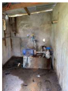
Foto 2 - Vista interna da EEA
