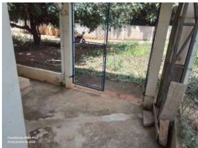
Foto 1 - Acesso para manutenção na Estação Elevatória
