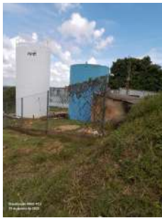
Foto 1 - Cercamento incompleto da área
