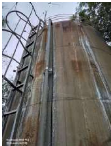
Foto 1 - Escada e guarda-corpo
