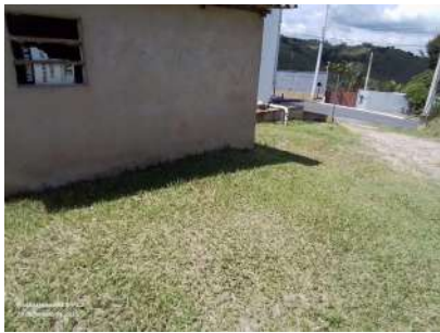
Foto 1 - Área no entorno do reservatório
