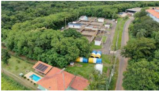
Foto 2 - Vista aérea do local
