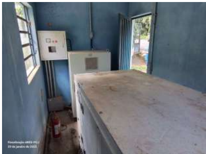
Foto 5 - Acesso para manutenção do gerador
