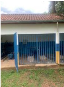
Foto 2 - Vista externa da EEA
