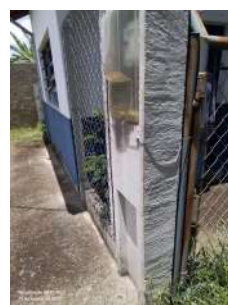
Foto 2 - Alambrado cercando a EEE
