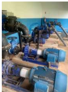
Foto 4 - Vista interna da EEA
