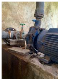
Foto 2 - Vazamento
