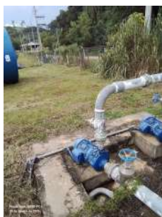
Foto 1 - Acesso para manutenção na Estação Elevatória
