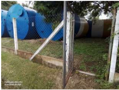
Foto 1 - Entrada da área do reservatório
