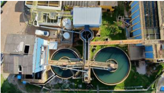
Foto 2 - Vista aérea da ETA
