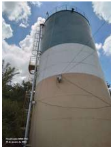
Foto 1 - Medidor de nível
