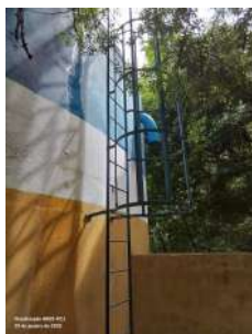
Foto 1 - Escada com guarda-corpo
