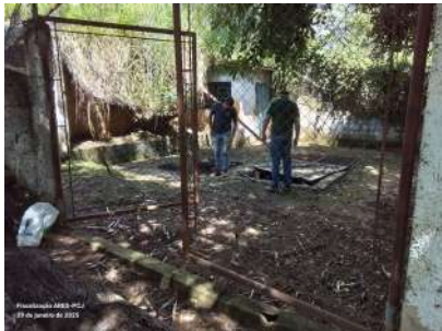
Foto 1 - Entrada da EEE
