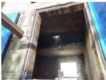
Foto 1 - Entrada do esgoto
