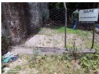
Foto 1 - Cerca improvisada para impedir o acesso de terceiros
