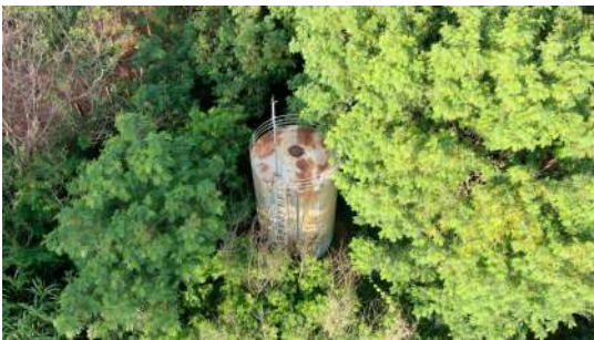
Foto 2 - Vista aérea do reservatório
