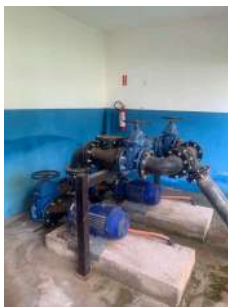
Foto 3 - Vista interna da EEA
