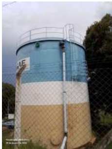
Foto 1 - Guarda-corpo e escada
