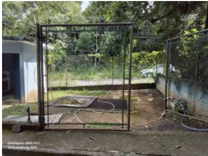
Foto 1 - Entrada da EEE
