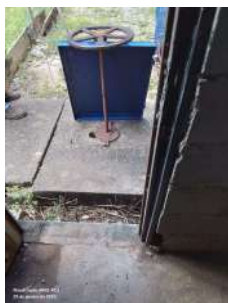
Foto 1 - Acesso para manutenção na Estação Elevatória
