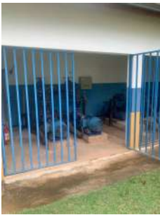
Foto 1 - Acesso para manutenção na Estação Elevatória
