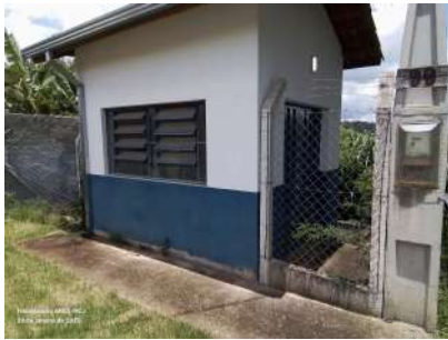
Foto 1 - Vista externa da EEE
