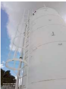
Foto 2 - Escada com guarda-corpo
