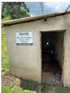
Foto 1 - Placa de identificação da área
