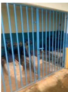
Foto 1 - Acesso para manutenção na Estação Elevatória
