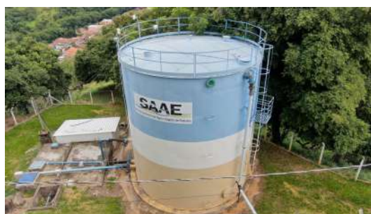
Foto 2 - Vista aérea do reservatório
