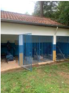
Foto 1 - Vista externa da EEA
