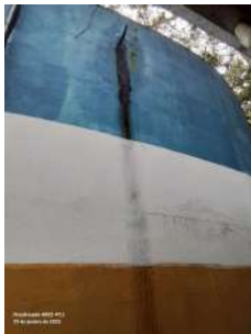
Foto 2 - Dreno da laje 2
