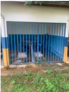
Foto 2 - Vista externa da EEA
