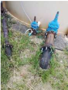
Foto 2 - Medidor de nível
