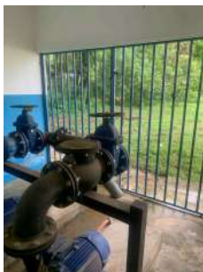
Foto 1 - Acesso para manutenção na Estação Elevatória
