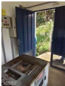
Foto 1 - Acesso para manutenção do gerador
