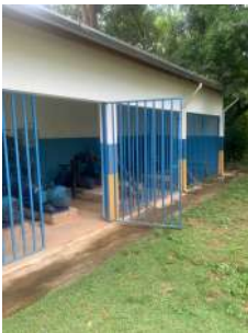
Foto 1 - Vista externa da EEA
