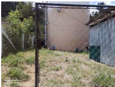
Foto 1 - Ausência de identificação da área
