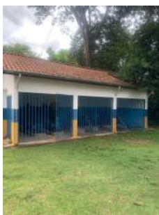
Foto 1 - Vista externa da EEA
