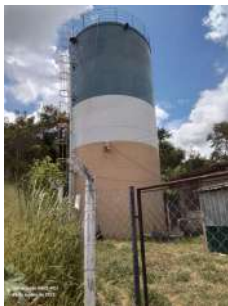
Foto 1 - Entrada da área do reservatório
