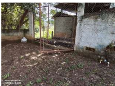
Foto 1 - Acesso para manutenção na Estação Elevatória
