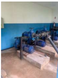
Foto 3 - Vista interna da EEA
