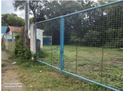
Foto 1 - Entrada da área do reservatório
