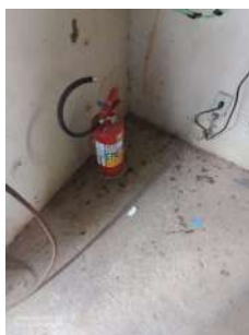
Foto 1 - Extintor de incêndio
