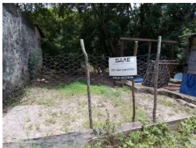
Foto 1 - Entrada da EEE
