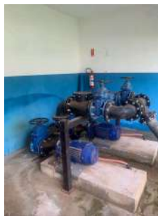
Foto 4 - Vista interna da EEA
