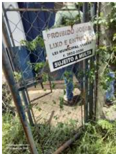
Foto 1 - Portão de entrada da EEE
