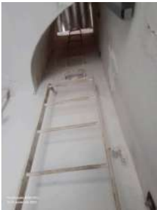
Foto 1 - Acesso para área do reservatório
