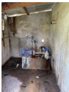
Foto 3 - Vista interna da EEA
