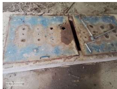
Foto 2 - Tampa da caixa de entrada de esgoto
