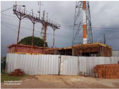
Foto 1 - Obra no local
