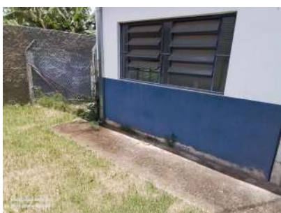
Foto 1 - Alambrado cercando a EEE
