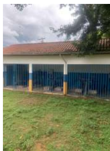
Foto 2 - Vista externa da EEA
