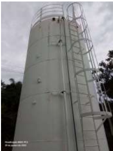
Foto 1 - Guarda-corpo e escada
