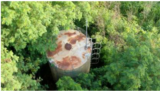
Foto 1 - Vista aérea do reservatório
