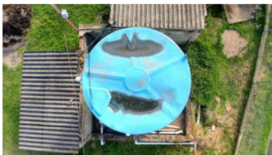
Foto 1 - Vista aérea do reservatório
