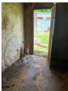
Foto 1 - Acesso para manutenção na Estação Elevatória
