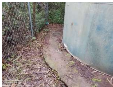
Foto 2 - Área no entorno do reservatório - Foto 1
