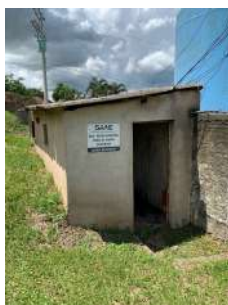
Foto 1 - Vista externa da EEA
