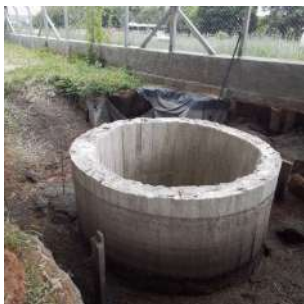
Foto 9 - Estação elevatória de esgoto de Nova Ipeúna em obras em Ipeúna
