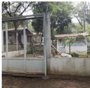
Foto 1 - Entrada da Captação subterrânea 4 em Ipeúna
