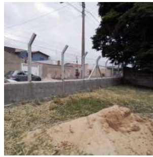
Foto 2 - Vista da Estação elevatória de esgoto de Nova Ipeúna em Ipeúna
