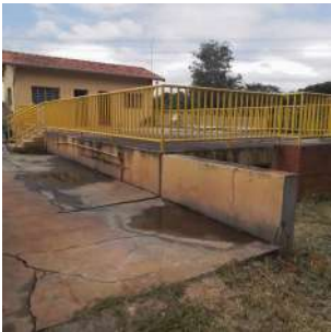
Foto 1 - Reservatório semi-enterrado da ETA em Ipeúna
