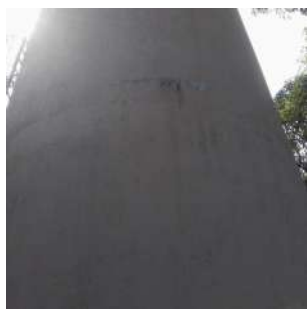
Foto 7 - Vista do Reservatório elevado 4 em Ipeúna
