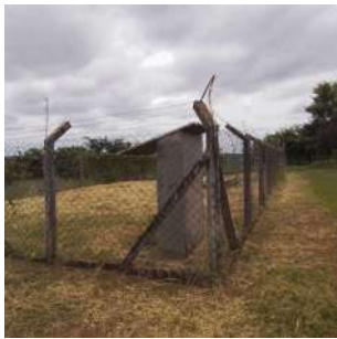
Foto 1 - Cercamento da Elevatória de esgoto Jardim dos Ipês em Ipeúna
