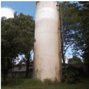
Foto 2 - Vista do Reservatório elevado 4 em Ipeúna
