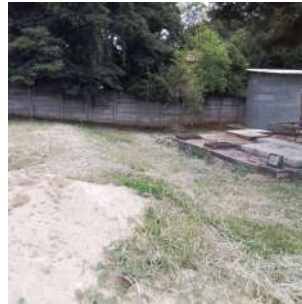
Foto 4 - Estação elevatória de esgoto de Nova Ipeúna em obras em Ipeúna
