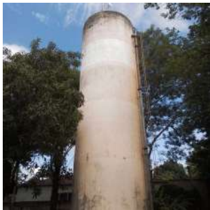
Foto 1 - Vista do Reservatório elevado 4 em Ipeúna
