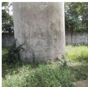
Foto 9 - Vista do Reservatório elevado 4 em Ipeúna
