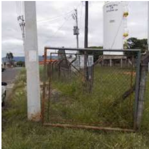
Foto 2 - Entrada do Reservatório 3 em Ipeúna
