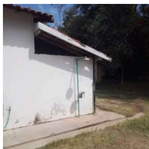
Foto 4 - Chuveiro de emergência da ETA em Ipeúna
