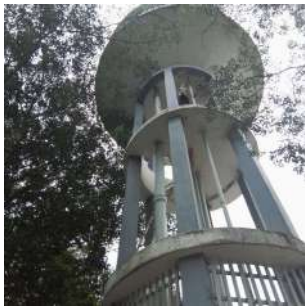
Foto 5 - Tubulações de entrada e saída no Reservatório 2 - Castelo em Ipeúna
