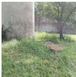
Foto 10 - Vista do Reservatório elevado 4 em Ipeúna
