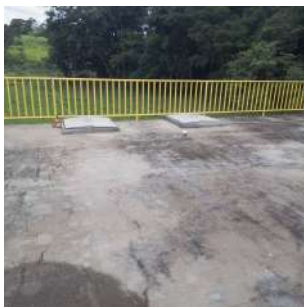
Foto 3 - Tampas de inspeção do Reservatório semi-enterrado da ETA em Ipeúna
