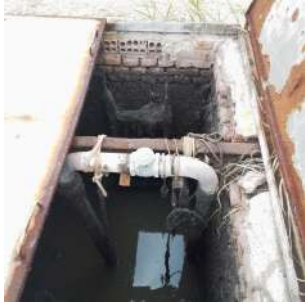
Foto 5 - Elevatória de esgoto Jardim dos Ipês em Ipeúna
