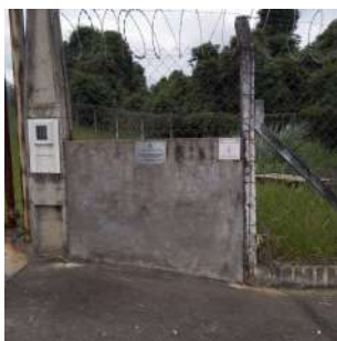
Foto 1 - Entrada da Elevatória de Esgoto Alto de Ipeúna em Ipeúna
