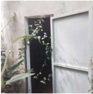
Foto 6 - Vista do interior do Reservatório elevado 4 em Ipeúna
