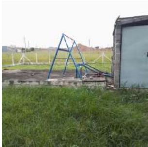
Foto 4 - Acesso para manutenção da Elevatória de Esgoto RESIDENCIAL ZILDA SCAGLIA DORTA em Ipeúna
