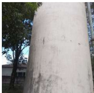
Foto 11 - Vista do Reservatório elevado 4 em Ipeúna
