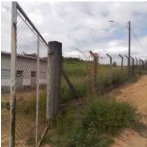
Foto 1 - Cercamento da ETE em Ipeúna
