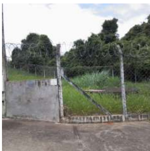
Foto 3 - Vista da Elevatória de Esgoto Alto de Ipeúna em Ipeúna
