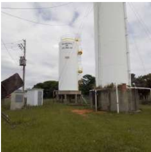
Foto 3 - Reservatório 3 em Ipeúna
