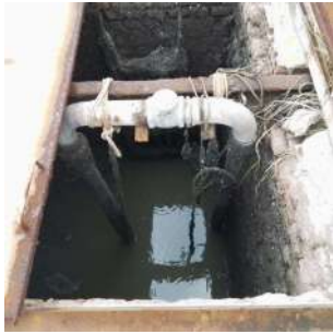
Foto 4 - Elevatória de esgoto Jardim dos Ipês em Ipeúna
