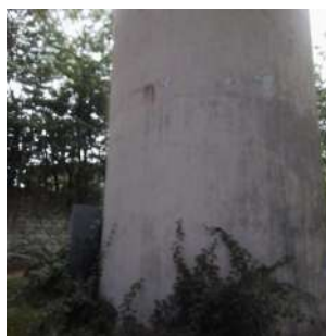
Foto 8 - Vista do Reservatório elevado 4 em Ipeúna
