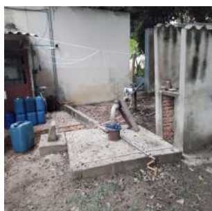
Foto 7 - Laje de proteção da Captação subterrânea Poço 1 em Ipeúna
