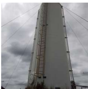
Foto 10 - Guarda-corpo do Reservatório 3 em Ipeúna
