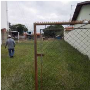
Foto 1 - Entrada do Reservatório 3 em Ipeúna
