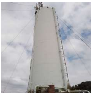
Foto 5 - Vista do Reservatório 3 em Ipeúna
