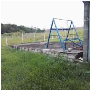
Foto 3 - Acesso para manutenção da Elevatória de Esgoto RESIDENCIAL ZILDA SCAGLIA DORTA em Ipeúna
