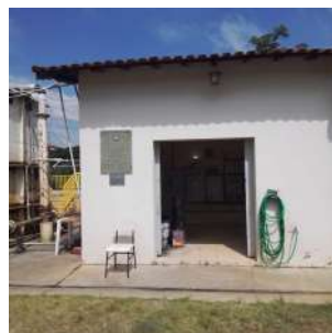
Foto 2 - Entrada do laboratório da ETA em Ipeúna
