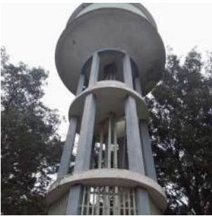
Foto 2 - Reservatório 2 - Castelo em Ipeúna
