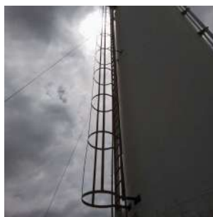
Foto 9 - Guarda-corpo do Reservatório 3 em Ipeúna
