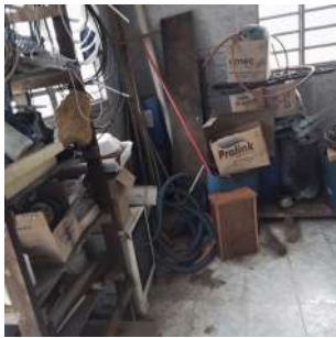
Foto 2 - Ausência de limpeza do Reservatório semi-enterrado da ETA em Ipeúna
