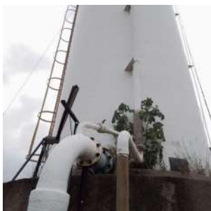
Foto 7 - Tubulação de entrada do Reservatório 3 em Ipeúna
