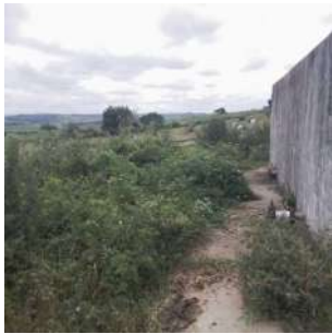
Foto 1 - Vista do exterior da Estação elevatória de esgoto Centro em Ipeúna
