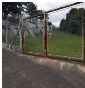
Foto 2 - Cercamento da Elevatória de Esgoto Alto de Ipeúna em Ipeúna
