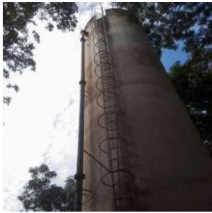
Foto 3 - Guarda-corpo do Reservatório elevado 4 em Ipeúna
