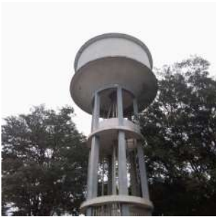
Foto 3 - Reservatório 2 - Castelo em Ipeúna
