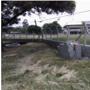
Foto 3 - Estação elevatória de esgoto de Nova Ipeúna em obras em Ipeúna
