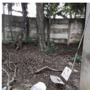
Foto 1 - Ausência de limpeza da Captação subterrânea Poço 1 em Ipeúna
