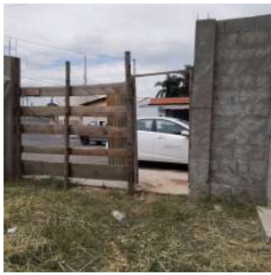
Foto 1 - Entrada da Estação elevatória de esgoto de Nova Ipeúna em Ipeúna
