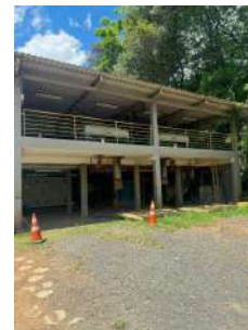
Foto 2 - Tratamento de lodo ETA
