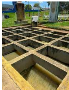
Foto 3 - Tanque desinfecção
