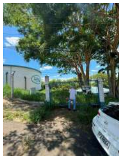
Foto 1 - Vista externa da unidade
