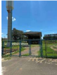
Foto 1 - Sistema de lodo da ETE
