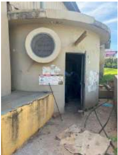
Foto 1 - Casa de bombas
