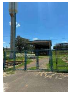
Foto 2 - Unidade Tratamento de lodo
