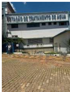
Foto 1 - Fachada do prédio da ETA
