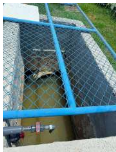
Foto 5 - Aplicação de hipoclorito
