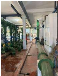
Foto 1 - Vista geral da EEAT
