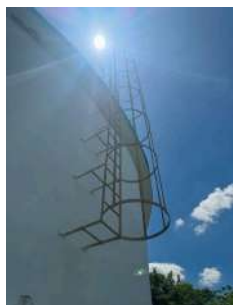
Foto 5 - Escada de acesso
