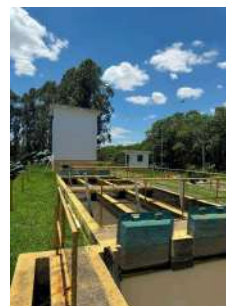
Foto 10 - Canal de entrada
