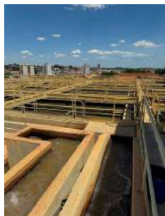
Foto 7 - Vista geral das unidades
