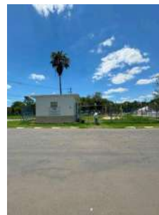
Foto 2 - Vista externa da unidade
