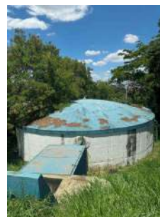
Foto 4 - Visto do reservatório semi-enterrado
