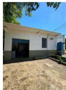
Foto 4 - Casa de bombas
