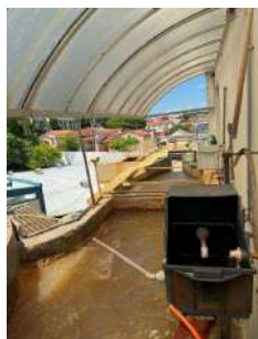
Foto 3 - Canal de entrada
