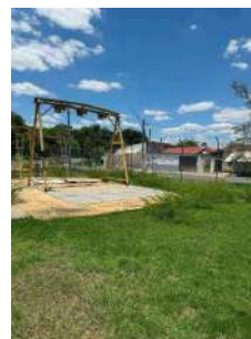
Foto 4 - Vista da elevatória
