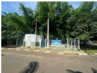
Foto 1 - Vista externa da unidade
