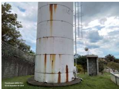
Foto 1 - Vazamentos aparentes.
