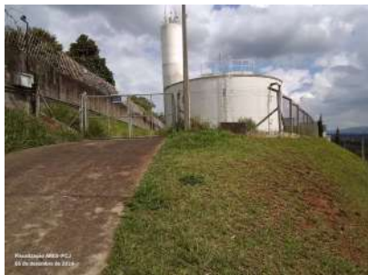
Foto 1 - Alambrado cercando o entorno do reservatório.
