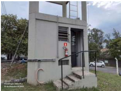
Foto 1 - Vista geral da EEAT.
