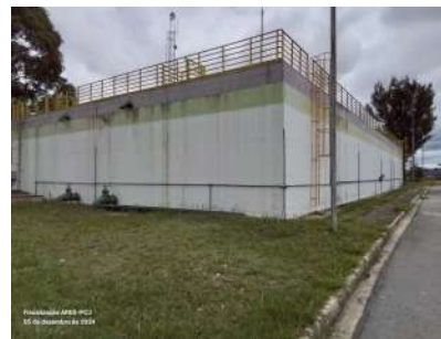
Foto 2 - Vista geral do reservatório.
