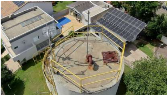
Foto 1 - Tubulação de ventilação.
