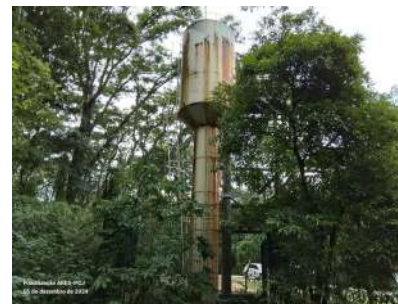
Foto 2 - Vista geral do reservatório.
