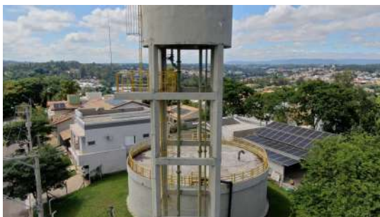
Foto 3 - Vista aérea do reservatório elevado.
