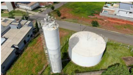
Foto 3 - Vista aérea do local.
