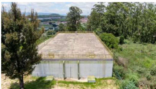
Foto 9 - Vista geral do reservatório.
