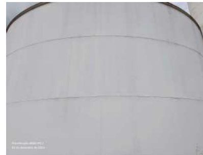
Foto 2 - Sem vazamentos aparentes.
