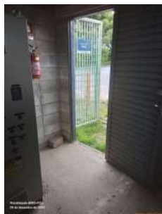
Foto 1 - Acesso para manutenção na Estação Elevatória.
