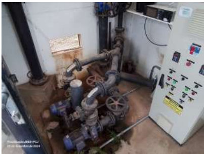
Foto 2 - Vista interna da EEAT.
