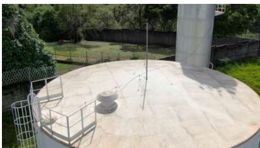
Foto 1 - Tampa de inspeção do reservatório.
