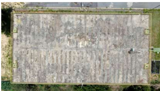
Foto 11 - Vista geral do reservatório.
