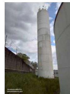
Foto 2 - Guarda-corpo sobre o reservatório.
