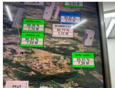
Foto 2 - Monitoramento do reservatório.
