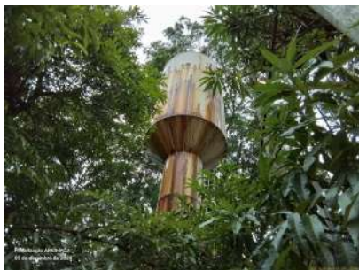
Foto 1 - Vazamentos aparentes.
