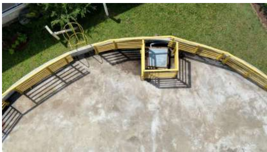
Foto 1 - Tampa de inspeção do reservatório.
