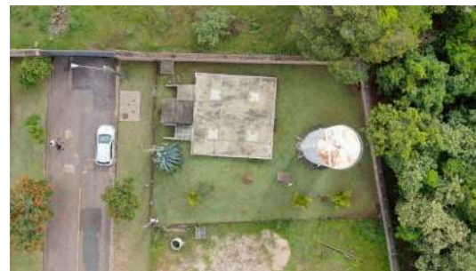
Foto 2 - Vista geral do reservatório.
