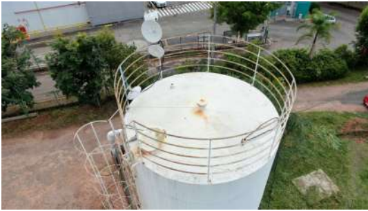
Foto 1 - Tubo de ventilação do reservatório.
