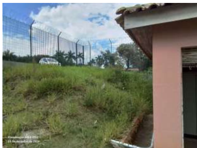
Foto 1 - Gradil cercando a área.
