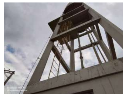
Foto 2 - Guarda-corpo na escada.
