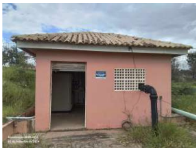
Foto 1 - Vista externa da estação elevatória.
