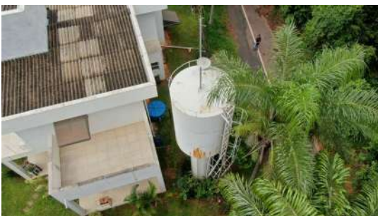
Foto 5 - Vista geral do reservatório.
