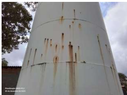
Foto 1 - Vazamentos aparentes.
