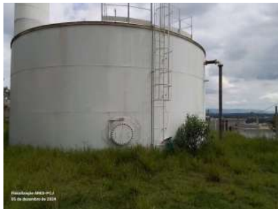
Foto 1 - Sem vazamentos aparentes.
