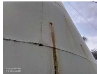
Foto 2 - Vazamentos aparentes.
