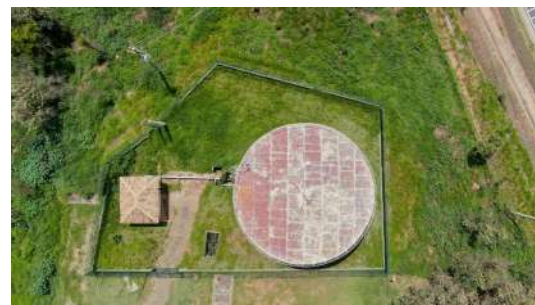
Foto 2 - Gradil cercando o reservatório.
