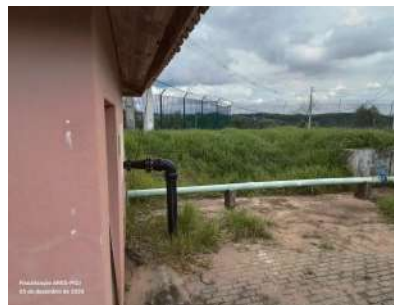
Foto 2 - Gradil cercando a área.
