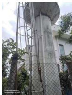
Foto 1 - Cabo condutor de descarga.
