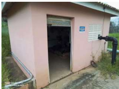
Foto 1 - Acesso para manutenção na estação elevatória.
