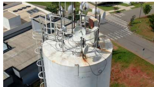
Foto 2 - Tampa de inspeção do reservatório.
