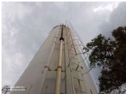
Foto 1 - Escada com guarda-corpo, mas sem bloqueio de acesso.
