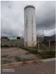
Foto 1 - Vista geral do reservatório.
