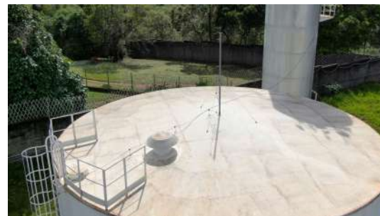
Foto 2 - Guarda-corpo do reservatório.
