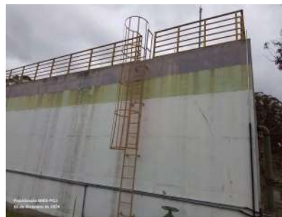
Foto 2 - Guarda-corpo e escada.
