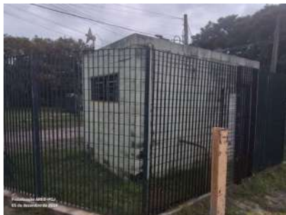
Foto 1 - Gradil cercando a estação elevatória.
