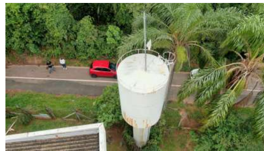
Foto 4 - Vista geral do reservatório.
