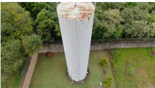
Foto 1 - Tampa de inspeção.
