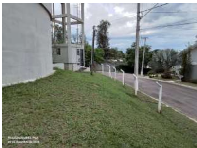
Foto 1 - Local cercado com alambrado.
