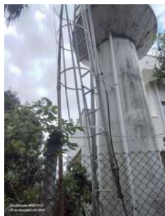
Foto 1 - Escada com guarda corpo.
