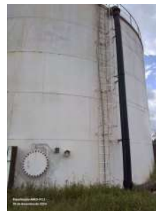
Foto 2 - Reservatório sem vazamentos aparentes.
