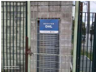
Foto 3 - Portão de entrada da estação elevatória.
