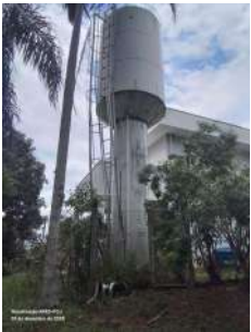
Foto 1 - Vista geral do reservatório.
