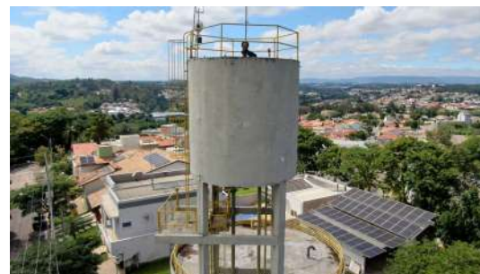
Foto 4 - Vista aérea do reservatório elevado.
