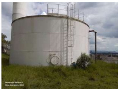
Foto 1 - Guarda-corpo sobre o reservatório e escada com guarda-corpo.
