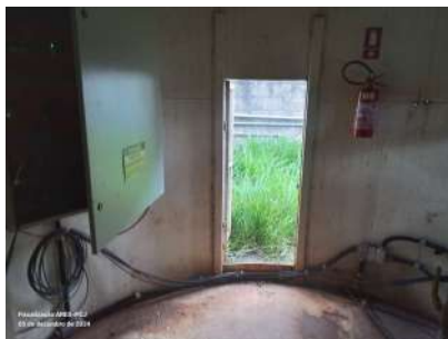
Foto 1 - Acesso para manutenção na Estação Elevatória
