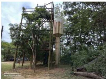
Foto 1 - Vista geral do reservatório.
