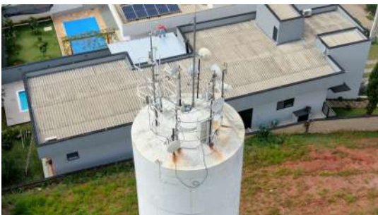
Foto 3 - Tampa de inspeção do reservatório.
