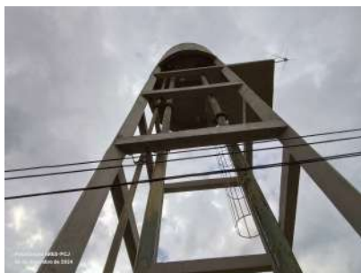
Foto 1 - Tubo extravasor à direita.
