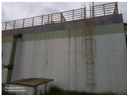
Foto 1 - Guarda-corpo e escada.
