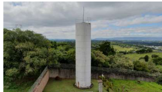
Foto 2 - Vista aérea do reservatório.
