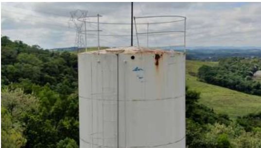
Foto 1 - Inexistência de telas de proteção contra entrada de insetos e pequenos animais no extravasor.
