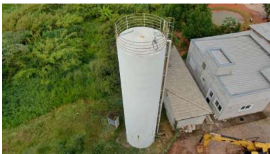
Foto 5 - Vista aérea do reservatório.
