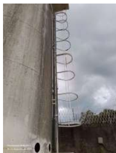
Foto 1 - Escada com guarda-corpo.
