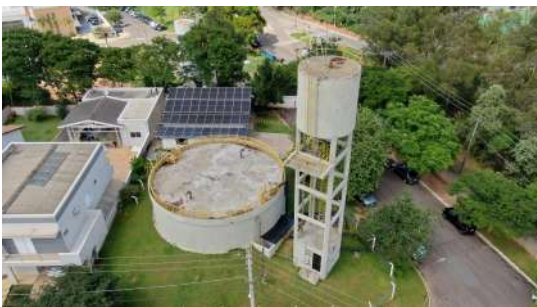
Foto 5 - Guarda-corpo do reservatório.
