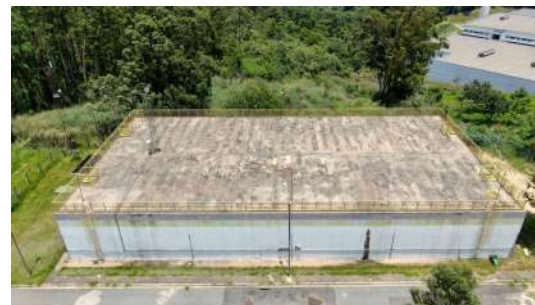
Foto 8 - Vista geral do reservatório.
