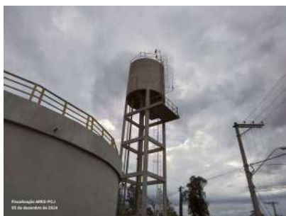
Foto 1 - Guarda-corpo na escada, na laje intermediária e superior do reservatório.
