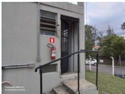
Foto 1 - Acesso para manutenção na Estação Elevatória.
