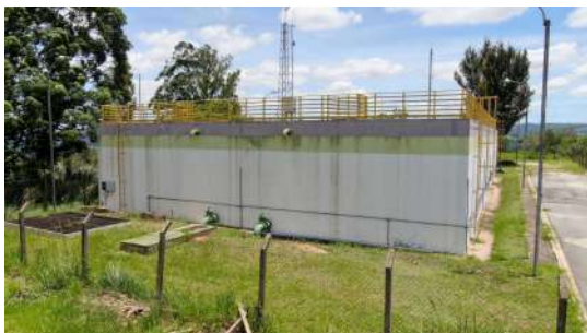
Foto 7 - Vista geral do reservatório.
