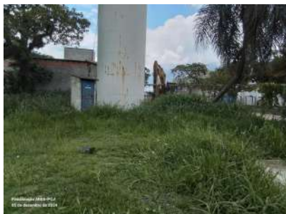
Foto 1 - Ausência de cerca no local.
