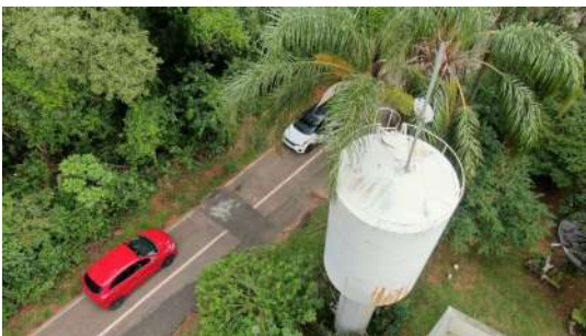
Foto 3 - Vista geral do reservatório.
