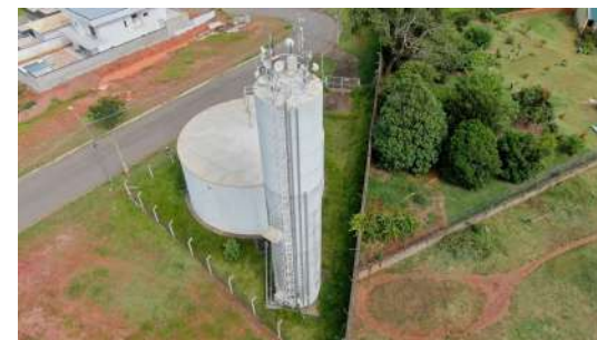
Foto 4 - Escada com guarda-corpo.
