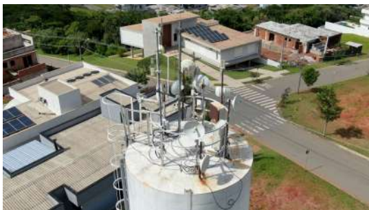
Foto 1 - Tubulação de ventilação à direita da tampa de inspeção do reservatório.
