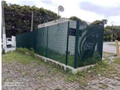
Foto 1 - Vista externa da estação elevatória.
