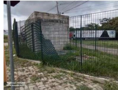
Foto 2 - Vista externa da estação elevatória.
