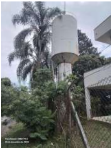
Foto 2 - Vista geral do reservatório.
