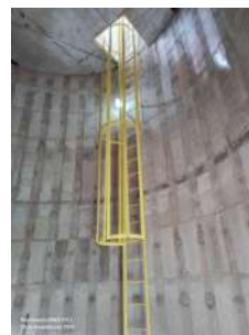
Foto 2 - Escada com guarda-corpo na parte interna.
