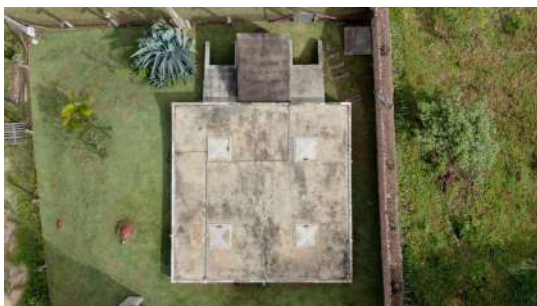
Foto 3 - Vista geral do reservatório.
