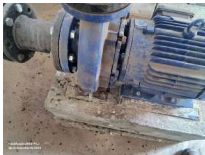
Foto 1 - Conjunto motobomba com selo mecânico.
