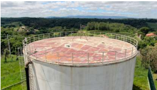
Foto 1 - Tubos de ventilação.
