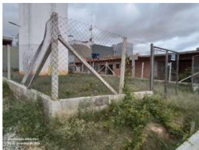
Foto 1 - Cercamento do reservatório.
