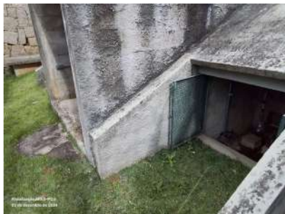
Foto 1 - Acesso para manutenção na Estação Elevatória.
