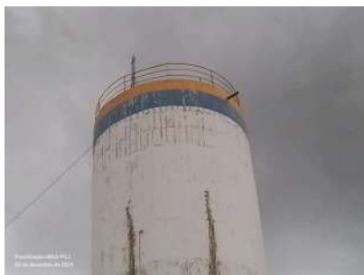
Foto 1 - Guarda-corpo do topo.
