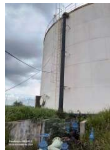
Foto 2 - Escada com guarda-corpo.
