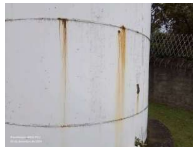
Foto 2 - Vazamentos aparentes.
