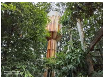
Foto 3 - Vista geral do reservatório.
