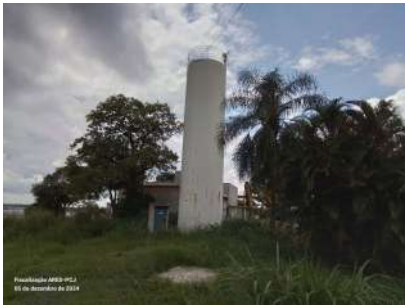
Foto 1 - Vista geral do reservatório.
