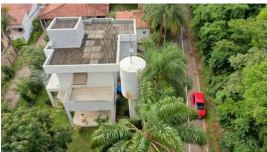
Foto 7 - Vista geral do reservatório.
