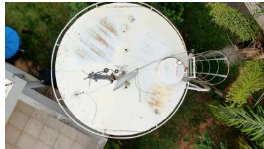
Foto 2 - Tapa adaptada com corte para instalação de tubulação.
