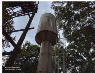
Foto 2 - Vazamentos aparentes.
