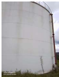
Foto 1 - Reservatório sem vazamentos aparentes.
