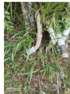
Foto 2 - À esquerda saída do tubo extravasor.
