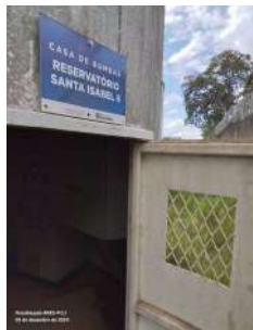
Foto 1 - Entrada da estação elevatória na base do reservatório elevado.
