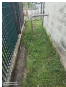
Foto 5 - Mato no entorno da estação elevatória. Faz-se necessária a roçagem do mato no local.
