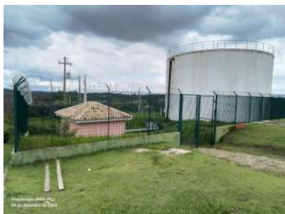
Foto 1 - Gradil cercando o reservatório.
