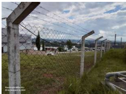
Foto 1 - Alambrado cercando a estação elevatória.
