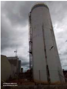
Foto 2 - Vista geral do reservatório.
