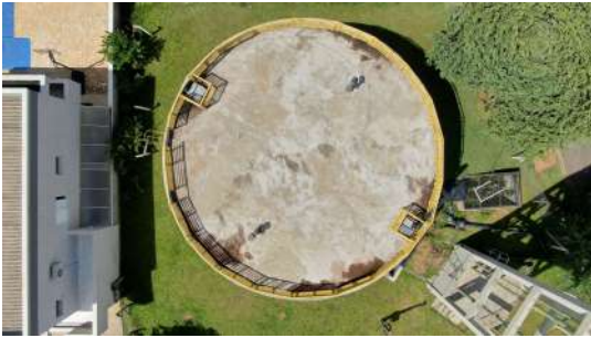
Foto 1 - Tubulação de ventilação.
