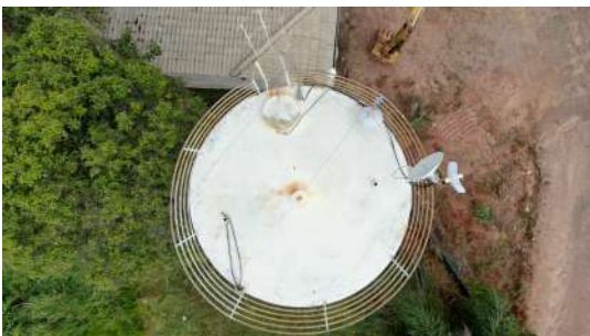
Foto 1 - Tampa de inspeção.
