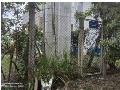
Foto 1 - Cercamento do reservatório.
