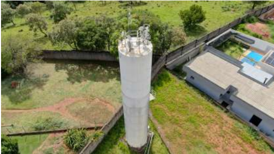
Foto 2 - Vista aérea do reservatório.
