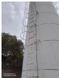
Foto 1 - Escada com guarda-corpo.
