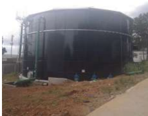
Foto 1 - Vista frontal do reservatório
