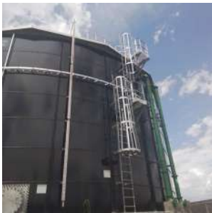
Foto 2 - Escada de acesso e guarda-corpo
