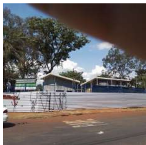
Foto 1 - Vista externa da área
