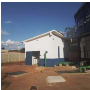
Foto 1 - Vista externa da EEAT Clubinho
