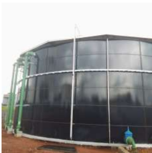
Foto 2 - Vista lateral do reservatório Parque Ribeirão
