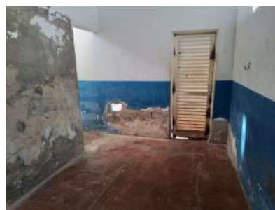
Foto 2 - Interior da EEAT Quintino
