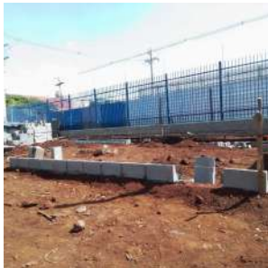
Foto 9 - Construção da caixa de sucção
