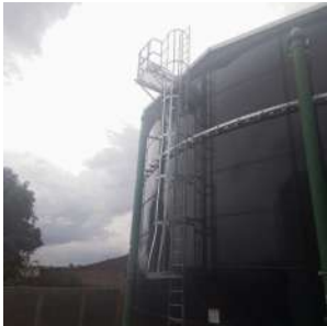
Foto 2 - Escada de acesso e guarda-corpo
