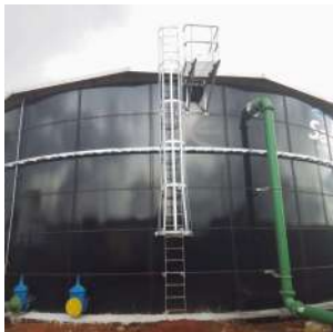
Foto 3 - Escada de acesso e guarda-corpo
