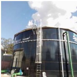
Foto 3 - Escada de acesso e guarda-corpo
