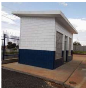
Foto 8 - Casa de dosagem de cloro e flúor
