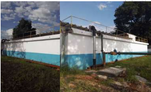
Foto 1 - Vista lateral da Caixa de Sucção do bairro Quintino. Foto 2 - Vista frontal da Caixa de Sucção do bairro Quintino.
