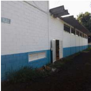
Foto 1 - Vista externa da EEAT Quintino
