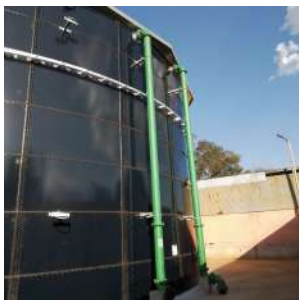
Foto 5 - Vista lateral do reservatório Clubinho
