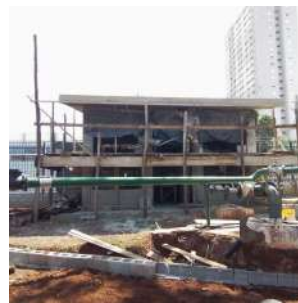
Foto 8 - Construção do armazenamento de produto químico
