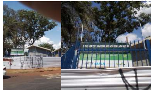
Foto 1 - Vista externa da área
