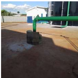
Foto 3 - Laje de proteção
