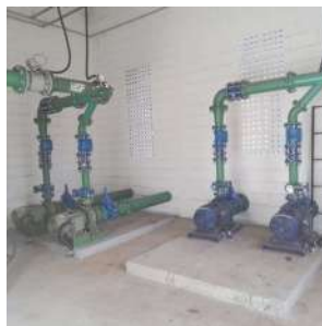
Foto 2 - Vista interna da EEAT Clubinho
