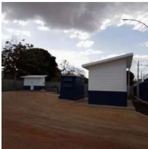
Foto 1 - Vista da área do poço 256 Paiva II
