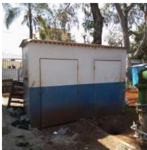
Foto 7 - Armazenamento de cloro e flúor
