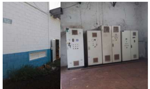
Foto 1 - Vista externa da EEAT Quintino
