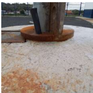
Foto 5 - Laje de proteção
