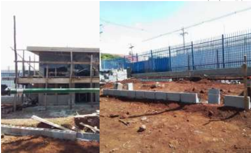
Foto 8 - Construção do armazenamento de produto químico
