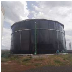
Foto 1 - Vista frontal do reservatório Jd Primavera $
