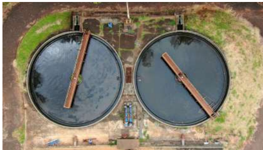
Foto 39 - Vista aérea dos dois decantadores.
