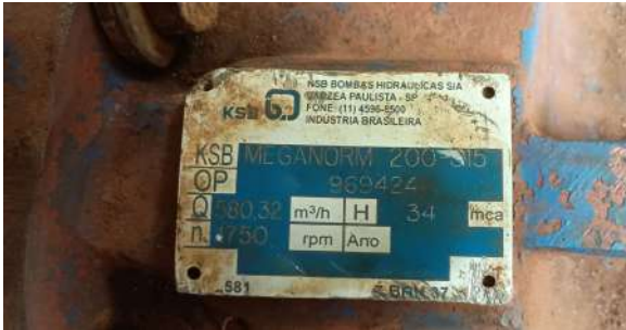
Foto 9 - Placa de especificações técnicas da bomba do conjunto 2.
