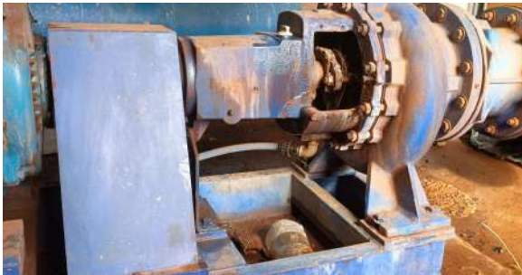
Foto 1 - Mangueira de coleta da água de lubrificação.
