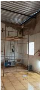
Foto 17 - A elevatória encontrava-se em reforma no momento da visita.
