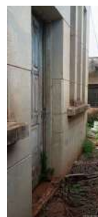
Foto 7 - Entrada da EEAT.
