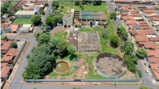
Foto 34 - Vista aérea da área total da ETA, com reservatórios e casa de bombas da EEAT.
