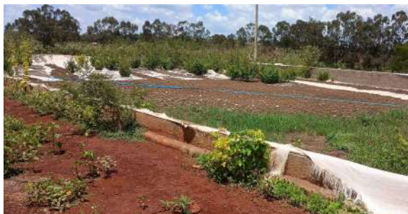
Foto 42 - Área ao lado do prédio da terceira estação elevatória (não está em uso, pois não há linha 3 de lagoas).
