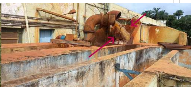
Foto 10 - Situação do canal de chegada de água bruta e indicação da placa de proteção.
