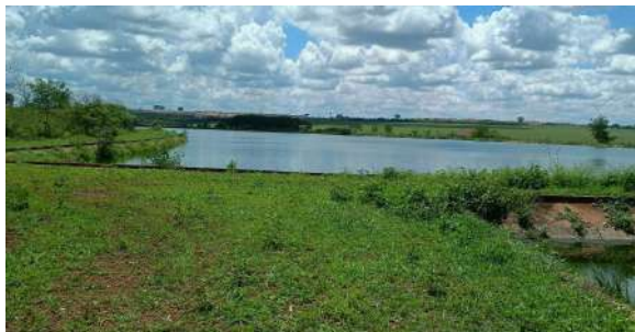
Foto 45 - Vista da transição entre as lagoas anaeróbia e facultativa da linha 2.
