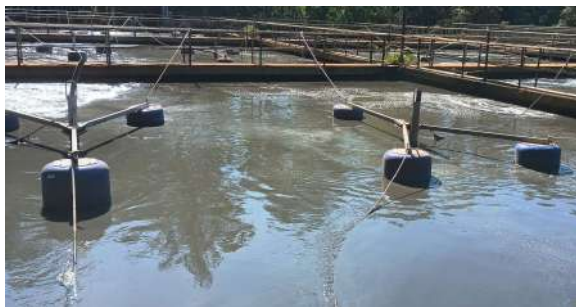
Foto 7 - Aeradores parados, impactando o tratamento.
