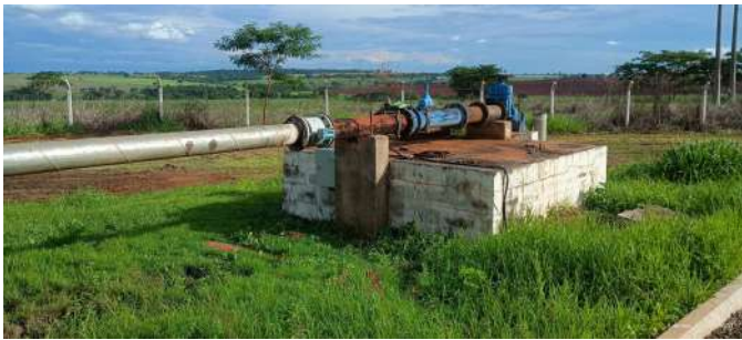
Foto 3 - Tubulação (adutora) do poço.
