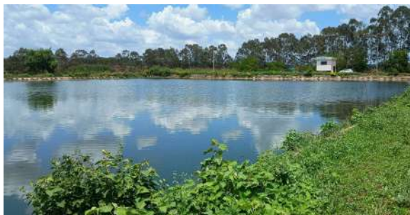
Foto 47 - Vista geral da lagoa anaeróbia da linha 2 e, ao fundo, o prédio da terceira estação elevatória.
