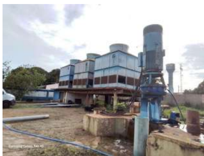
Foto 3 - Vista geral do entorno do poço.
