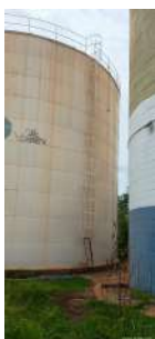
Foto 3 - Vista lateral do reservatório apoiado metálico.
