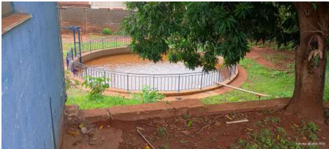
Foto 35 - Tanque de reaproveitamento do lodo dos filtros.
