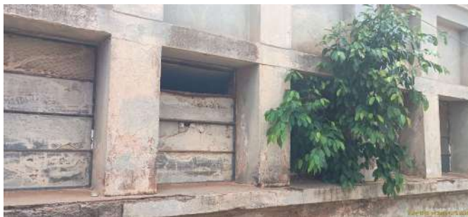
Foto 2 - Vão do antigo vitrô aberto.
