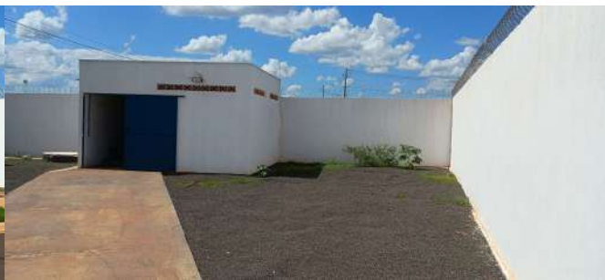
Foto 2 - Vista interna da EEE.
