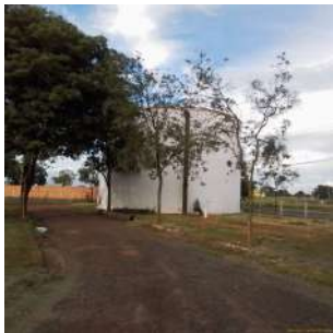
Foto 1 - Vista geral do reservatório.
