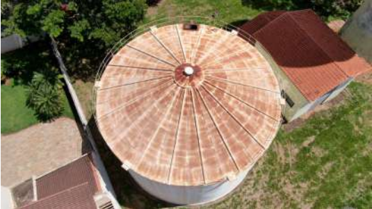
Foto 11 - Vista aérea do reservatório apoiado.
