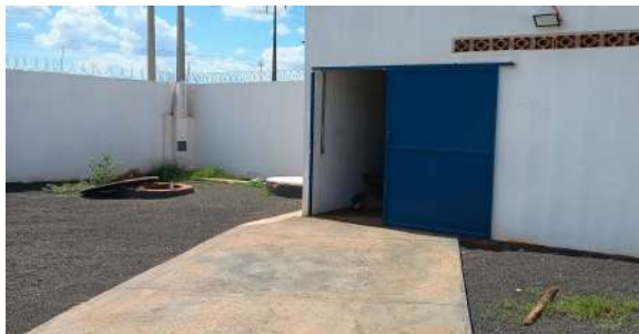
Foto 3 - Vista interna da EEE.
