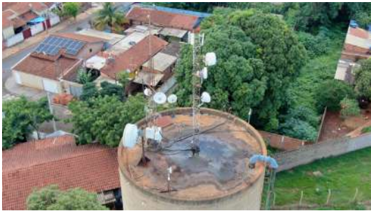
Foto 1 - Vista aérea da laje do reservatório.
