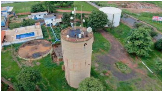
Foto 7 - Vista aérea do reservatório elevado I.
