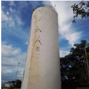
Foto 5 - Vista geral do reservatório elevado.
