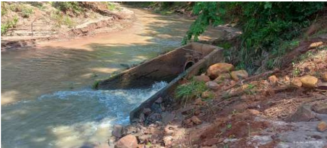
Foto 3 - Ponto de lançamento de esgoto, após abertura de registro.
