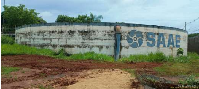
Foto 5 - Lateral do reservatório e logo do SAAEB.
