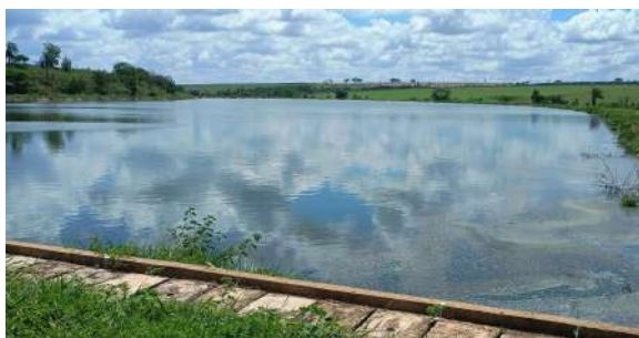
Foto 40 - Vista geral da lagoa facultativa da linha 1.
