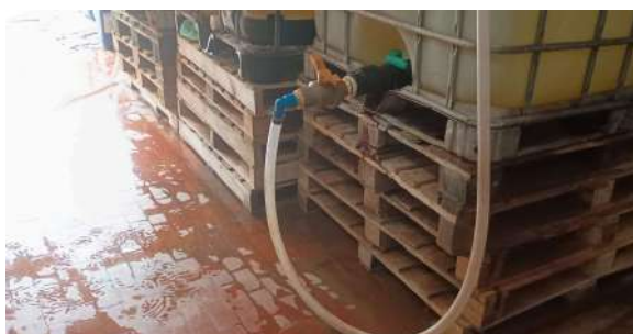
Foto 4 - Base dos tanques de armazenamento.
