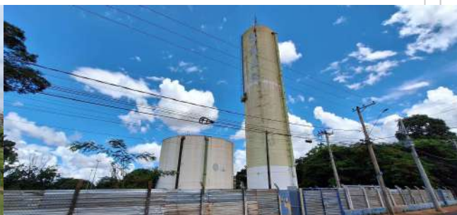
Foto 6 - Vista geral dos reservatórios.
