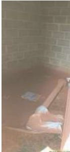
Foto 6 - Vista interna do abrigo de bombas.
