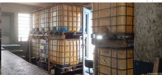
Foto 17 - Tanques antigos de armazenamento de produtos químicos (não são mais utilizados).
