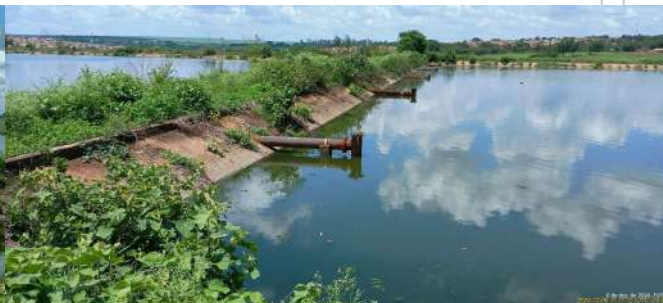
Foto 46 - Vista da transição entre as lagoas anaeróbia e facultativa da linha 2.
