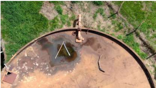
Foto 2 - Vista aérea da laje do reservatório.
