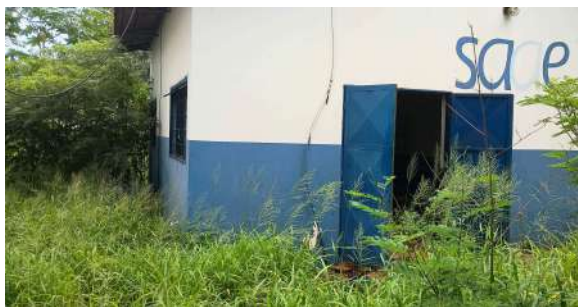
Foto 1 - Casa de bombas da EEAT.
