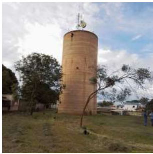
Foto 1 - Vista geral do reservatório elevado.
