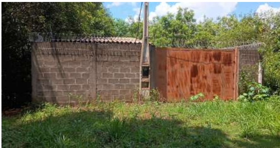
Foto 1 - Vista da entrada da EEE.
