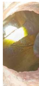
Foto 51 - Vista interna de um dos PVs do emissário.
