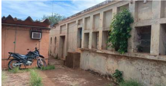
Foto 5 - Vista lateral do reservatório.
