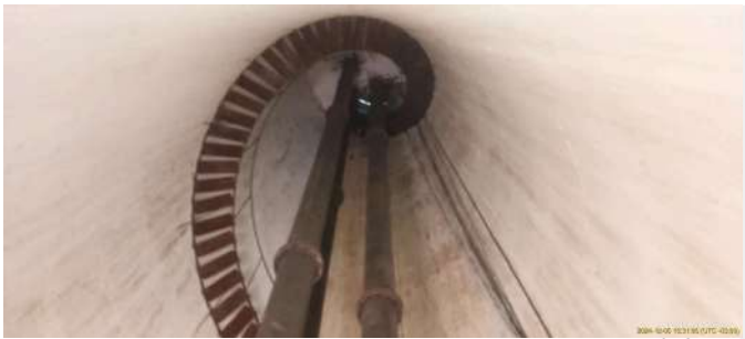
Foto 6 - Vista interna do reservatório elevado.
