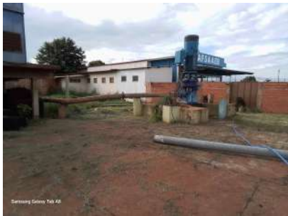
Foto 1 - Vista geral do entorno do poço.
