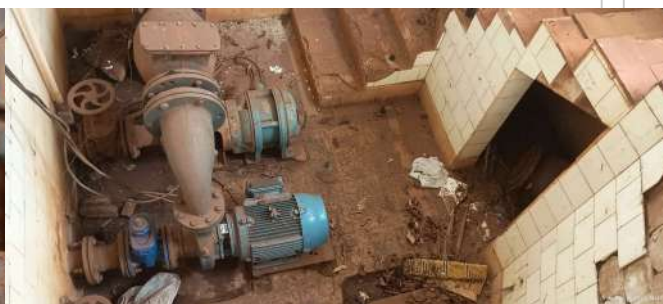
Foto 6 - Vista interna da EEAT.
