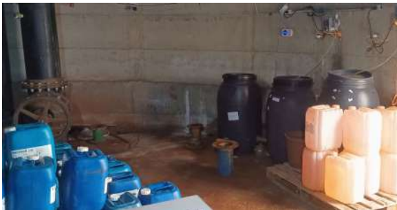
Foto 1 - Situação geral do armazenamento dos produtos químicos.
