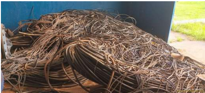
Foto 7 - Cabos elétricos no piso da EEAT.
