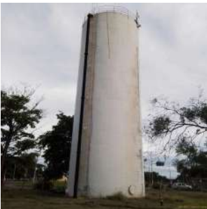
Foto 2 - Vista geral do reservatório elevado.
