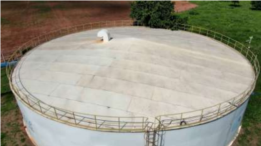
Foto 10 - Vista aérea da cobertura do reservatório.
