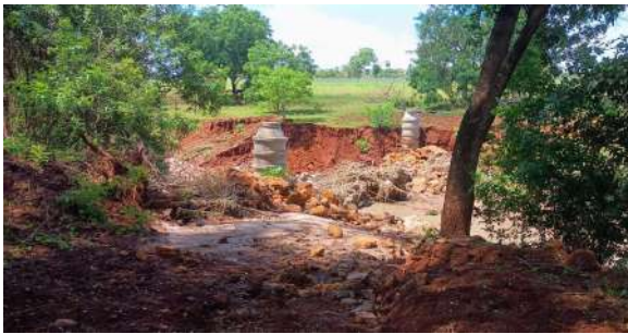
Foto 1 - Vista geral do entorno do emissário, próximo à ETE III Buracão.
