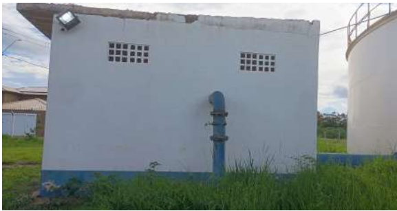
Foto 5 - EEAT e reservatório.
