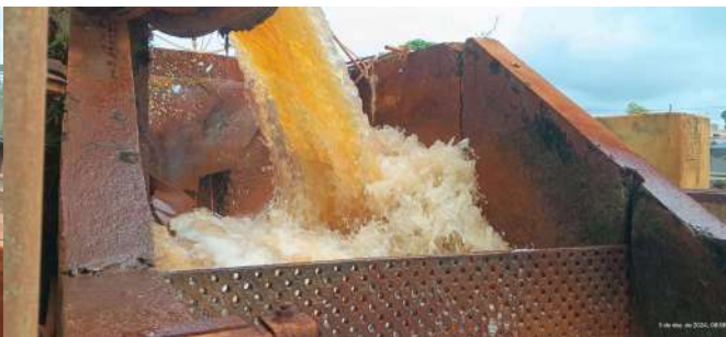
Foto 4 - Detalhe da chegada da água bruta.
