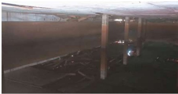
Foto 3 - Vista interna do reservatório.
