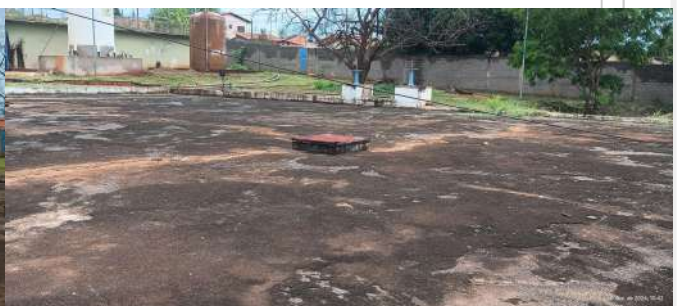
Foto 4 - Laje do reservatório e tampa de inspeção.
