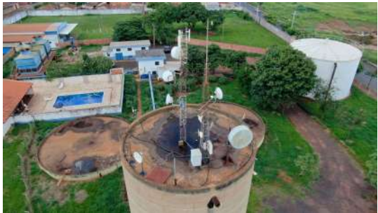
Foto 8 - Vista aérea do reservatório elevado I.
