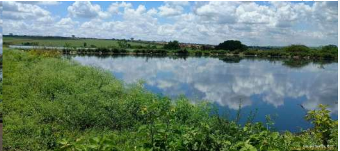
Foto 37 - Vista geral da lagoa anaeróbia da linha 1.
