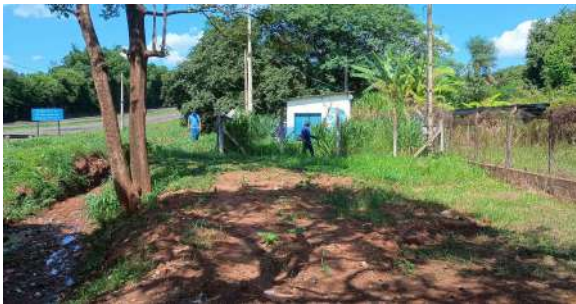
Foto 1 - Vista externa da EEE.
