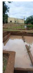
Foto 8 - Caixas desarenadoras.
