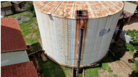
Foto 1 - Vista aérea da laje do reservatório.
