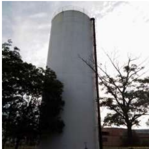
Foto 6 - Vista geral do reservatório elevado.
