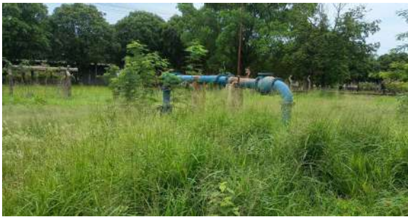
Foto 1 - Vista geral da área do poço.
