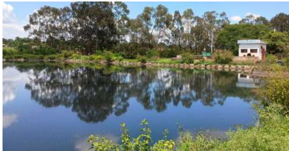
Foto 38 - Vista geral da lagoa anaeróbia da linha 1 e, ao fundo, segunda estação elevatória.
