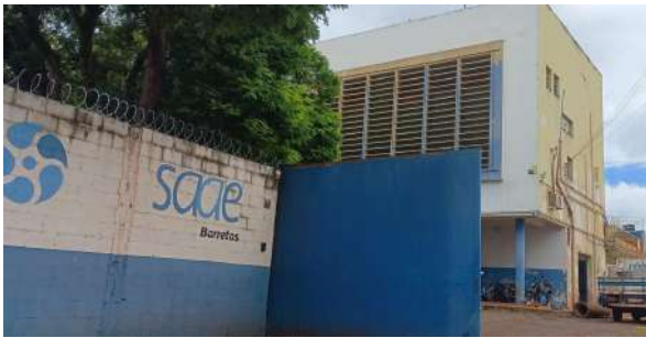
Foto 31 - Vista da entrada da ETA Pereira.
