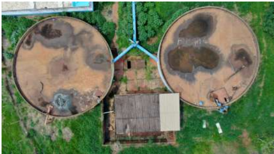
Foto 9 - Vista aérea dos dois reservatórios semienterrados: I (à esquerda) e II (à direita).
