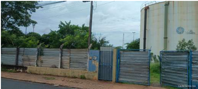
Foto 3 - Vista geral do CR FEB.
