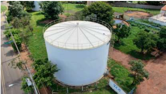
Foto 9 - Vista aérea do reservatório.
