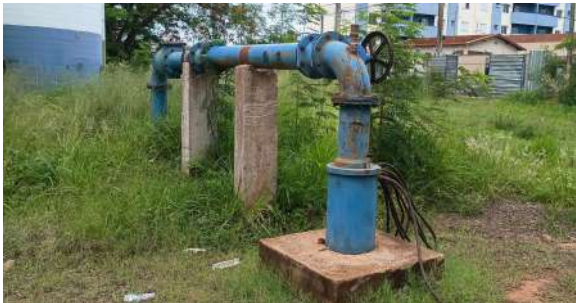
Foto 3 - Vista geral do cavalete do poço.
