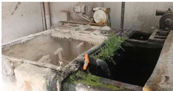
Foto 14 - Tanques de cal e carvão.
