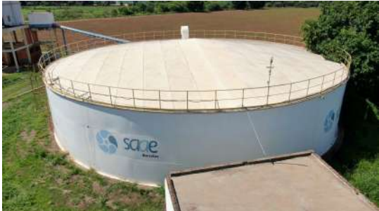
Foto 9 - Vista aérea do reservatório.
