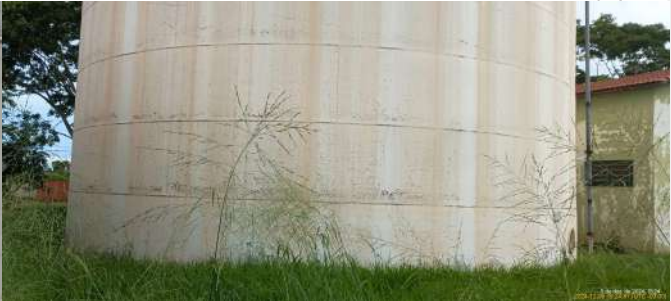
Foto 8 - Vista geral da lateral do reservatório.
