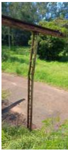
Foto 18 - Estrutura metálica integrante da sustentação da cobertura dos leitos de secagem de lodo.
