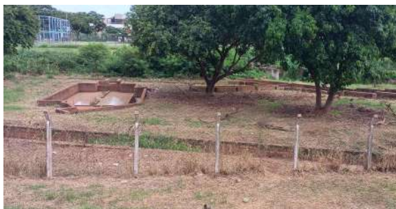
Foto 3 - Canais de tomada de água após o barramento do Córrego Aleixo.
