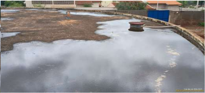
Foto 4 - Laje do reservatório e tampa de inspeção.
