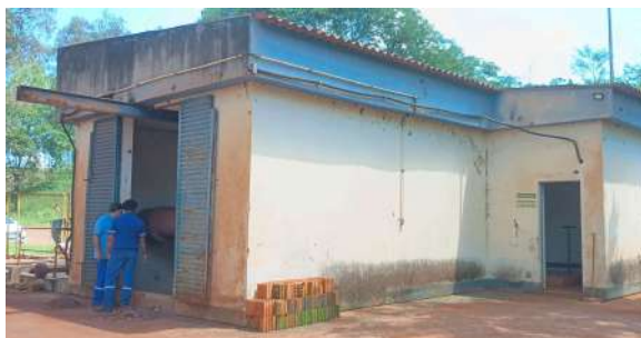
Foto 15 - Vista geral externa da casa de bomba da elevatória.
