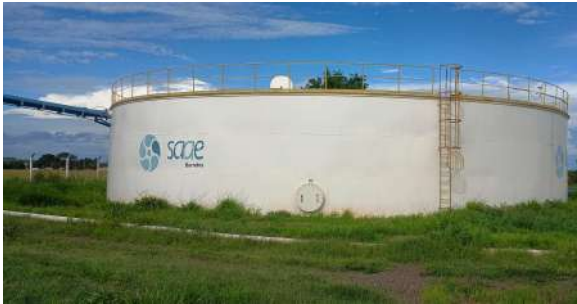
Foto 1 - Vista geral do reservatório.
