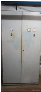
Foto 10 - Paineleletrico e de comando (partida manual) do conjunto 2.
