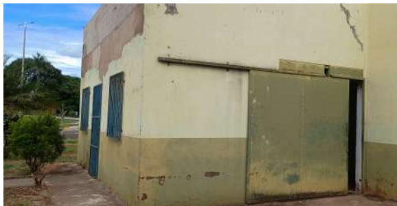
Foto 9 - Entrada da casa de bombas.
