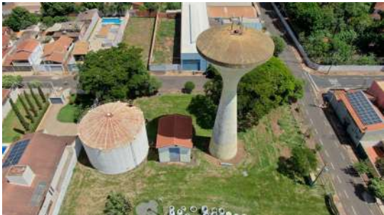
Foto 7 - Vista aérea do CR Sorvetão.
