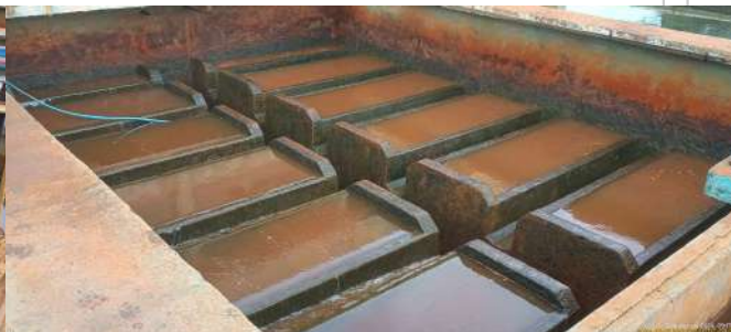
Foto 18 - Momento de limpeza de um dos filtros.
