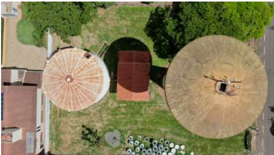
Foto 8 - Vista aérea da laje dos reservatórios.
