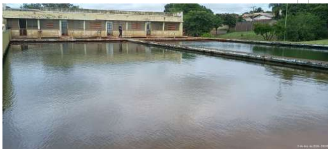
Foto 14 - Vista geral dos decantadores.
