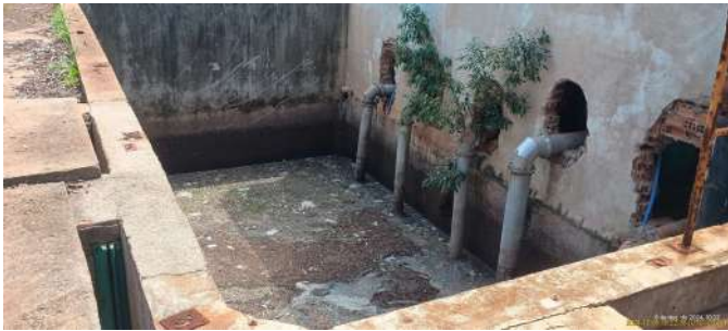
Foto 9 - Tanque de sucção da primeira estação elevatória, sem remoção de areia e outros materiais que passam pelo gradeamento.
