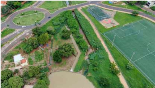
Foto 20 - Vista aérea da captação e, à esquerda, da elevatória de água bruta.
