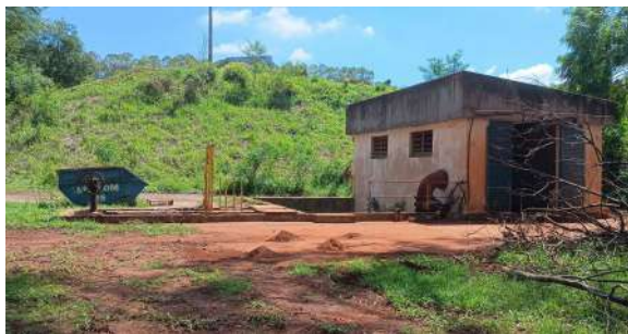
Foto 1 - Chegada de esgoto e casa de bombas da primeira estação elevatória.
