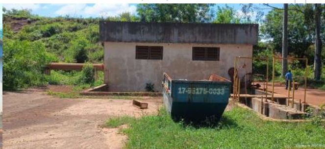
Foto 16 - Vista geral externa da casa de bomba da elevatória.
