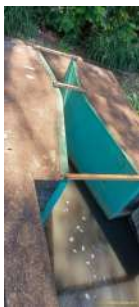
Foto 1 - Calha Parshall do decantador 1.
