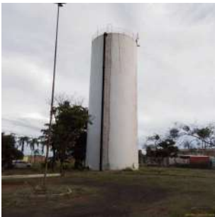
Foto 1 - Vista geral do reservatório elevado.
