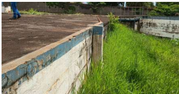
Foto 1 - Vista da laje e lateral do reservatório.
