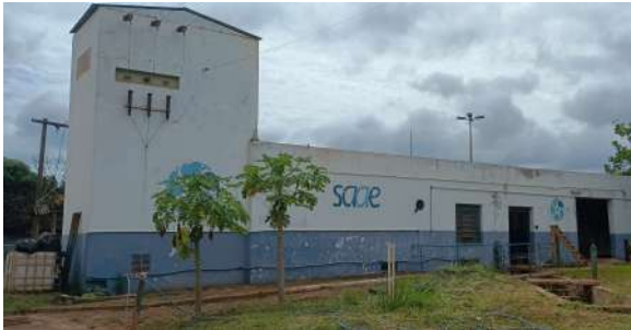
Foto 1 - Vista externa da EEAT.
