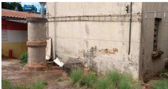
Foto 1 - Vista externa da casa de bombas.
