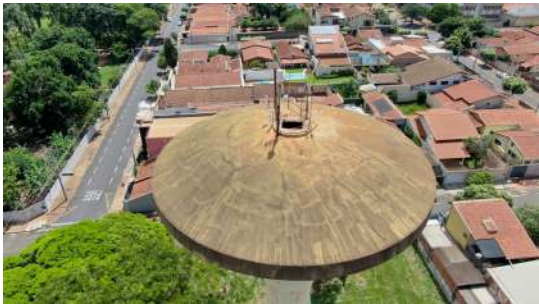
Foto 1 - Vista aérea da laje do reservatório elevado.
