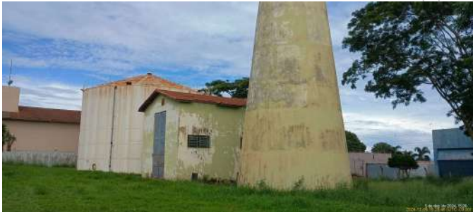
Foto 4 - Base do reservatório elevado, EEAT e reservatório apoiado Sorvetão.
