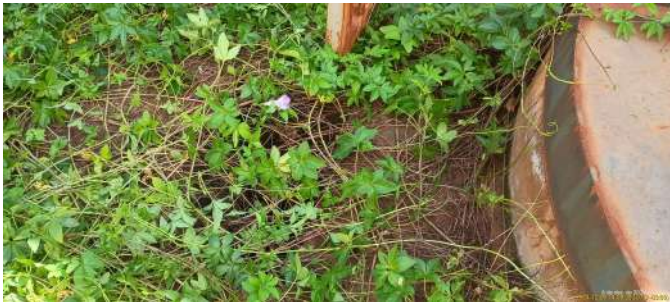
Foto 1 - Buraco no terreno da estação.
