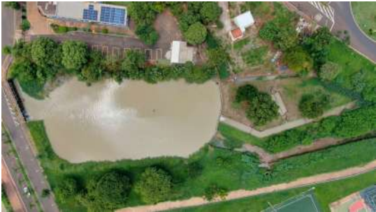
Foto 19 - Vista aérea da captação.
