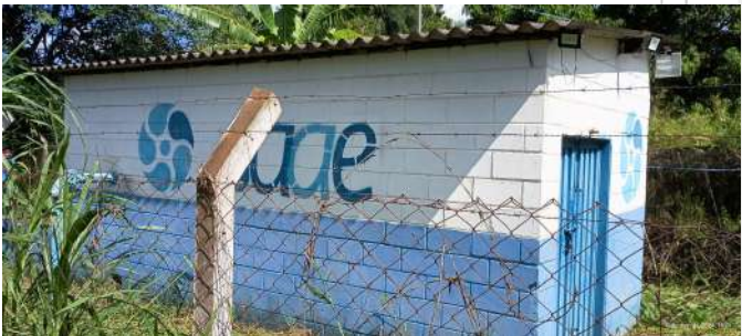
Foto 14 - Vista externa da EEE.
