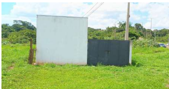
Foto 1 - Vista externa da elevatória.
