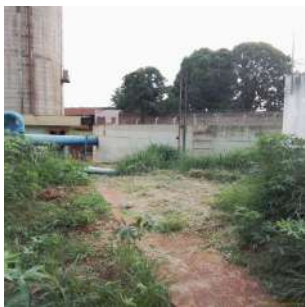
Foto 1 - Vista geral do reservatório semienterrado I.
