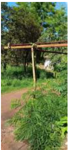
Foto 19 - Estrutura metálica integrante da sustentação da cobertura dos leitos de secagem de lodo.
