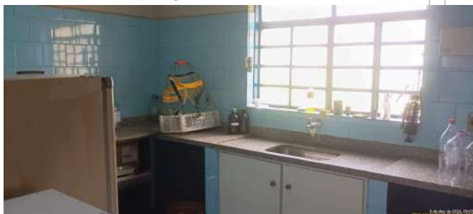
Foto 33 - Situação geral do laboratório da ETE.
