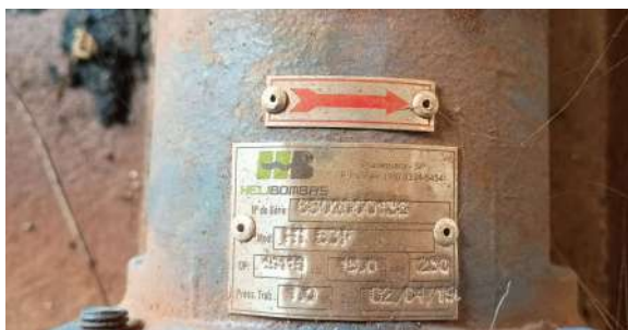
Foto 8 - Placa de especificações técnicas da bomba do conjunto motobomba instalado.
