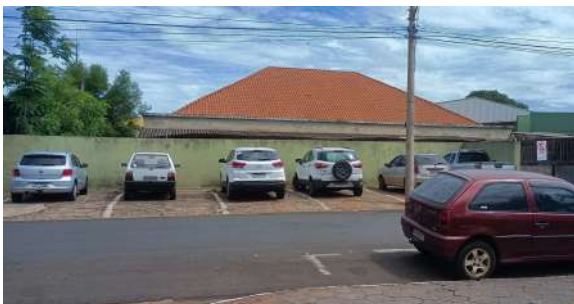
Foto 1 - Vista externa da entrada do reservatório (telhado em destaque é do reservatório).
