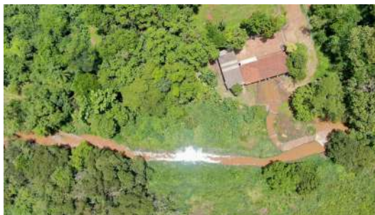
Foto 18 - Vista aérea da Captação do Ribeirão Pitangueiras.
