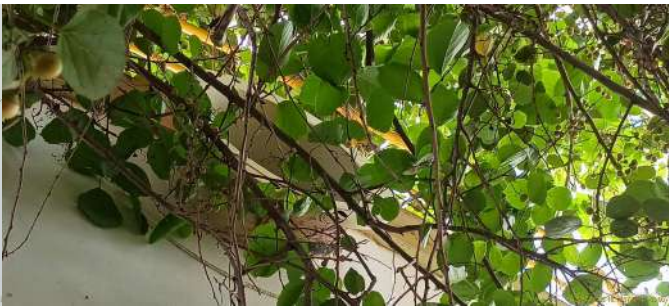
Foto 2 - Ausência de tela de proteção.
