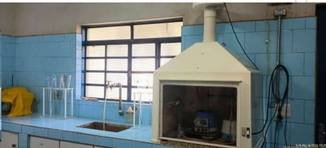
Foto 30 - Situação geral do laboratório da ETE.
