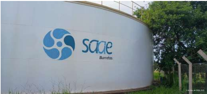
Foto 4 - Lateral do reservatório.
