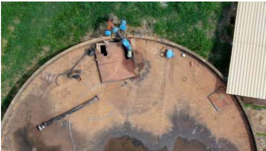
Foto 2 - Vista aérea da laje do reservatório.
