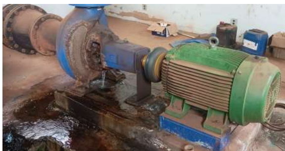
Foto 1 - Drenagem inadequada da água de lubrificação de gaxetas, escoando pelo piso.
