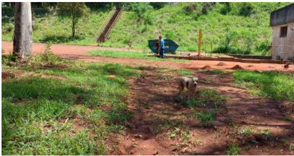
Foto 1 - Momento de abertura de registro para passagem do esgoto para lançamento no curso d'água.
