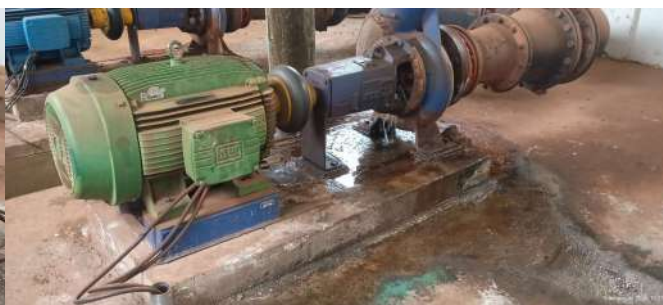
Foto 2 - Drenagem inadequada da água de lubrificação de gaxetas, escoando pelo piso.
