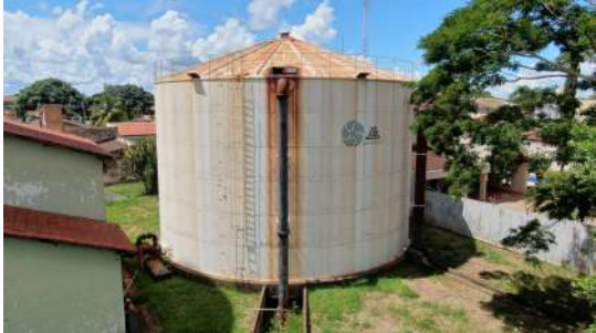
Foto 10 - Vista aérea do reservatório apoiado.
