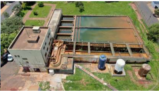
Foto 32 - Vista aérea da ETA.
