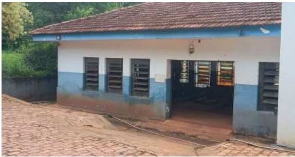
Foto 3 - Vista da casa de bombas.
