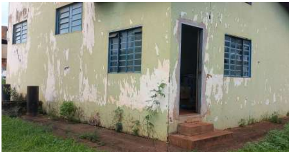
Foto 1 - Casa de bombas da EEAT.
