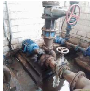
Foto 2 - Ausência da tampa da caixa de ligação elétrica do motor do conjunto 2.
