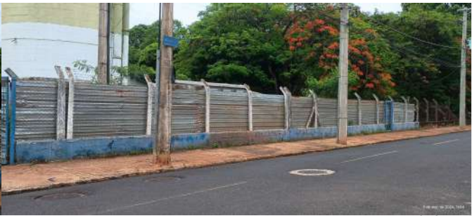
Foto 2 - Vista geral do CR FEB.
