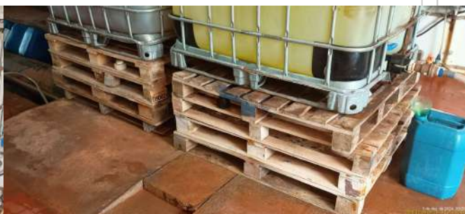
Foto 2 - Base dos tanques de armazenamento.
