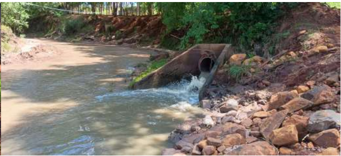
Foto 2 - Lançamento de esgoto in natura no Córrego Aleixo.
