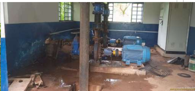
Foto 2 - Vista interna da EEAT.
