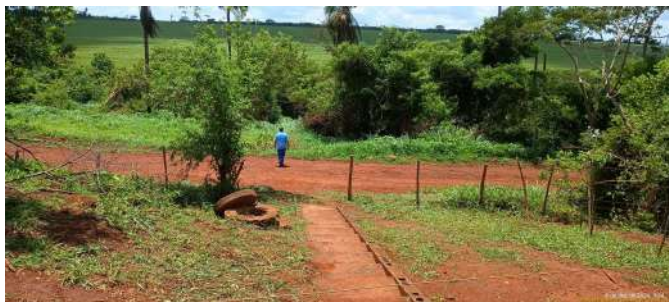
Foto 50 - Sentido do emissário de esgoto tratado, em direção ao Ribeirão Pitangueiras.
