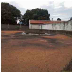
Foto 3 - Laje do reservatório.
