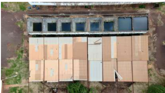
Foto 40 - Vista aérea dos tanques de adensamento de lodo e do telhado dos leitos de secagem de lodo.
