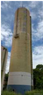
Foto 6 - Vista do reservatório elevado.
