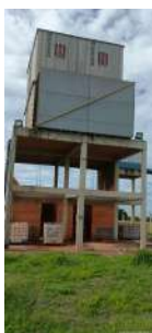
Foto 8 - Sistema de resfriamento da água subterrânea.
