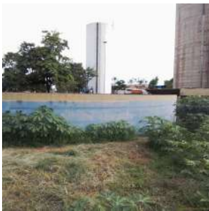
Foto 3 - Vista geral do reservatório semienterrado.
