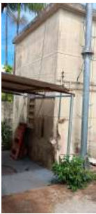
Foto 8 - Vista externa da casa de bombas.
