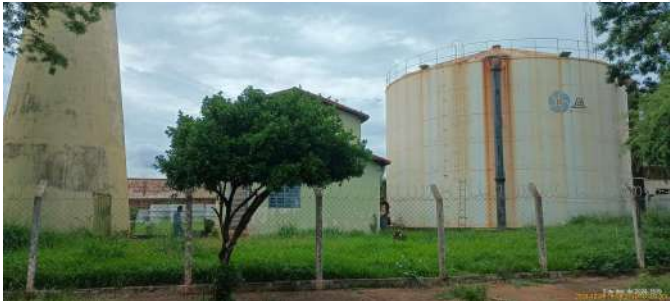
Foto 2 - Reservatórios e EEAT (centro) do CR Sorvetão.
