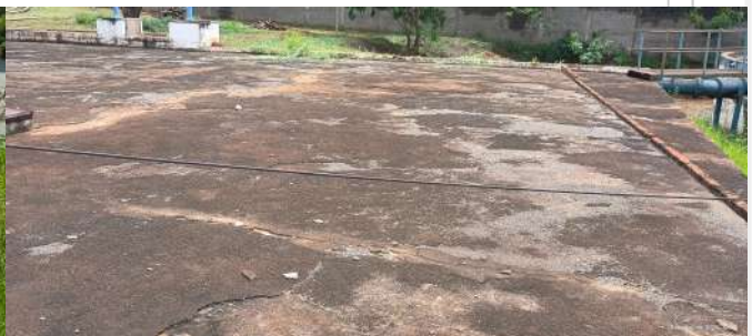
Foto 2 - Laje do reservatório.
