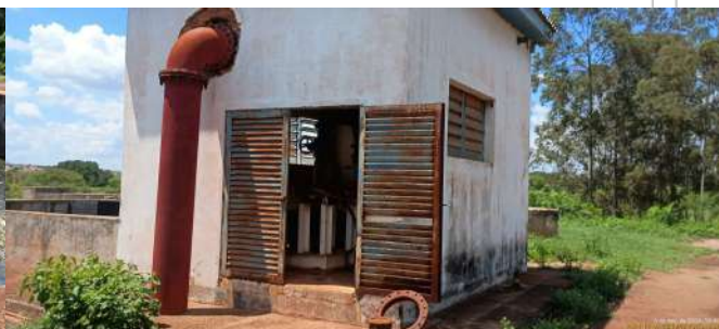
Foto 29 - Vista geral da casa de bombas da segunda estação elevatória.
