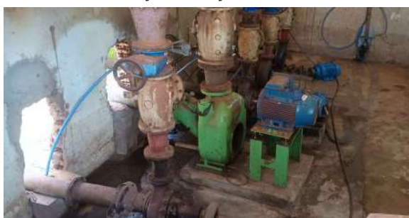
Foto 7 - Vista interna da primeira estação elevatória.
