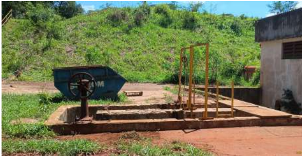
Foto 1 - Chegada do esgoto bruto e local do bypass (desvio do tanque de sucção do esgoto para lançamento no Córrego Aleixo).
