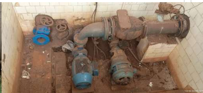
Foto 2 - Vista interna da EEAT.
