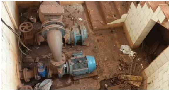
Foto 1 - Vista interna da EEAT.
