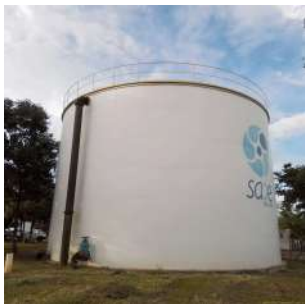
Foto 3 - Vista geral do reservatório.
