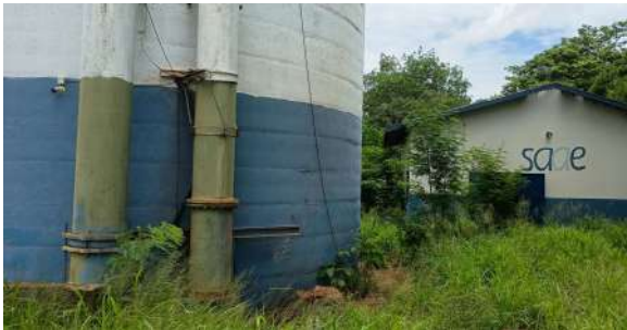
Foto 7 - Base do reservatório elevado e, ao fundo, EEAT.
