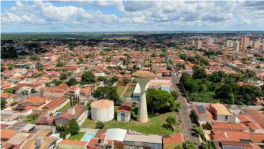
Foto 9 - Vista geral do CR Sorvetão.
