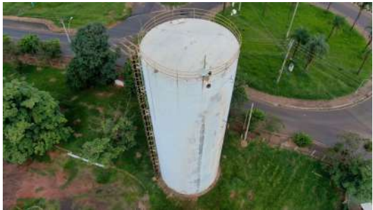
Foto 8 - Vista aérea do reservatório.
