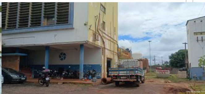
Foto 30 - Vista geral da ETA.
