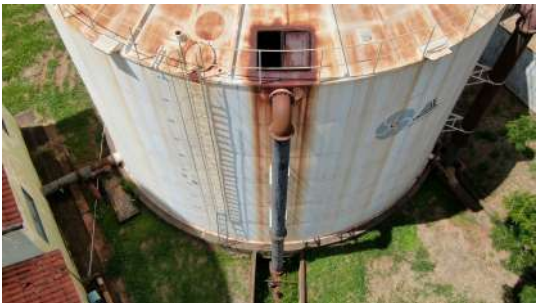
Foto 2 - Vista aérea da laje do reservatório, com detalhe para a tampa de inspeção.
