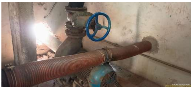
Foto 43 - Mangote de recalque de esgoto que, antigamente, levava parte do esgoto para a ETE III Buracão. Desativado atualmente.
