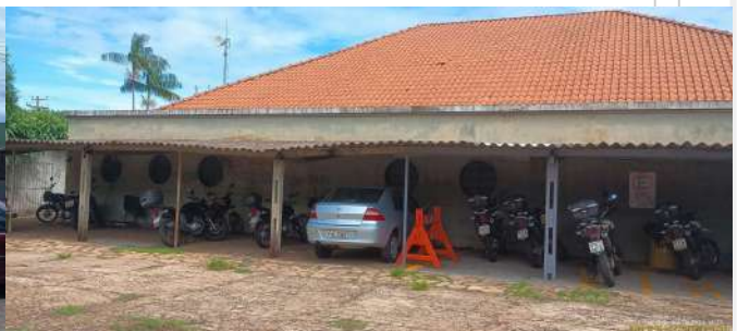
Foto 2 - Vista externa do reservatório.
