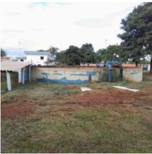
Foto 7 - Vista geral do reservatório semienterrado.
