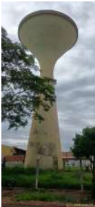
Foto 1 - Vista do reservatório elevado.
