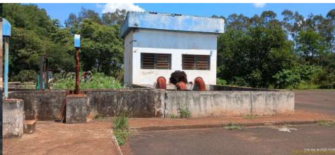
Foto 26 - Vista geral da segunda estação elevatória de esgoto.
