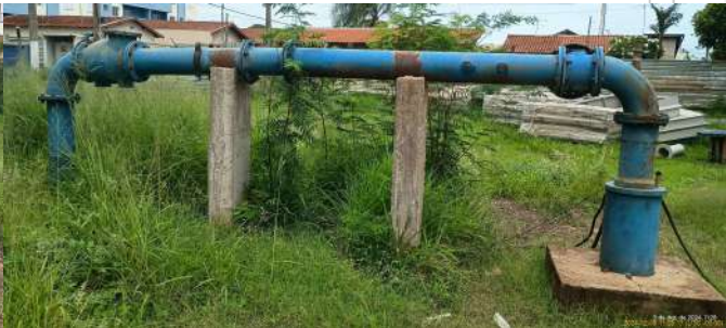
Foto 4 - Vista geral do cavalete do poço.
