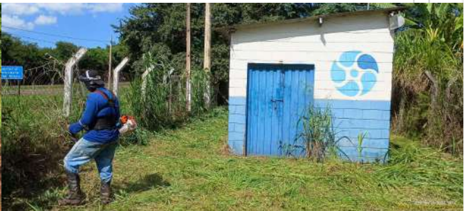
Foto 13 - Vista externa da EEE.
