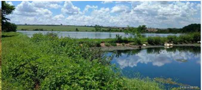
Foto 39 - Vista da transição entre as lagoas anaeróbia e facultativa da linha 1.
