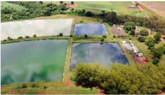
Foto 53 - Vista aérea das estações elevatórias de esgoto (direita) e das lagoas lagoas anaeróbias das duas linhas de lagoas.
