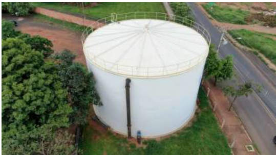
Foto 10 - Vista aérea do reservatório.
