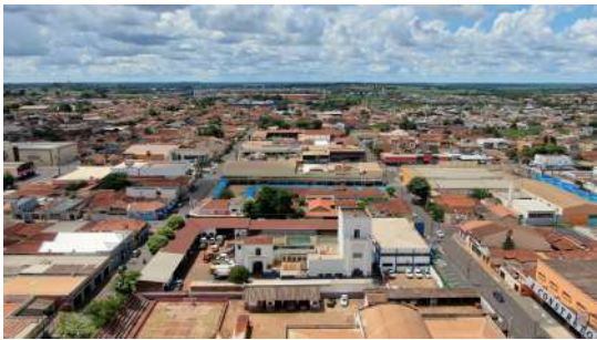
Foto 20 - Vista aérea geral da área: ETA Baroni, Sede do SAAEB e outras estruturas da autarquia no mesmo quarteirão.
