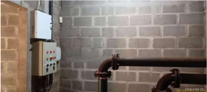
Foto 7 - Painéis elétricos e de comando da EEE.
