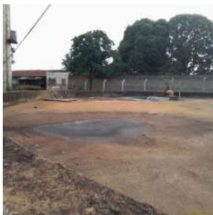
Foto 2 - Laje do reservatório. Ao fundo, tubulação vinda do CR Sorvetão, que também contribuiu para o local, como reservatório pulmão.
