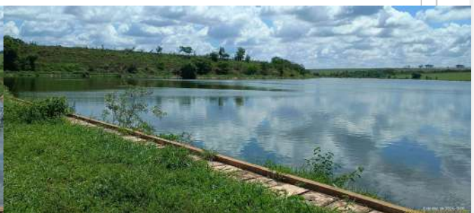
Foto 41 - Vista geral da lagoa facultativa da linha 1.
