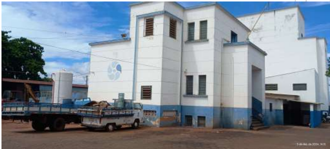
Foto 22 - Prédio da ETA Baroni.
