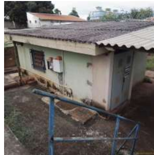
Foto 2 - Vista geral da casa de bombas.
