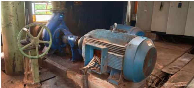
Foto 1 - Ausência da tampa da caixa de ligação elétrica do motor do conjunto 3 (à direita).
