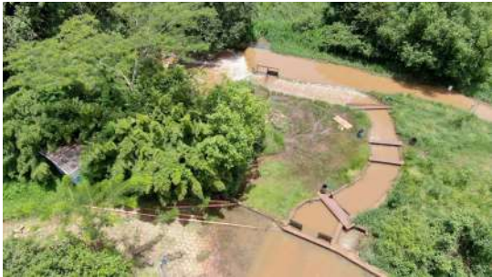
Foto 1 - Vista aérea da Captação Pitangueiras.
