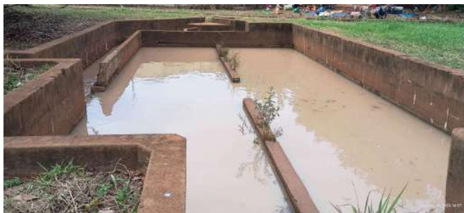
Foto 7 - Caixas desarenadoras.
