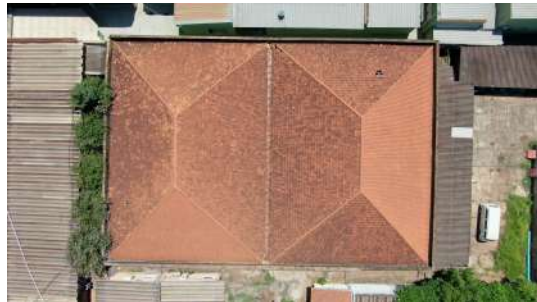
Foto 8 - Vista aérea do telhado do reservatório.
