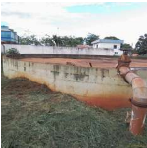
Foto 6 - Vista lateral do reservatório.
