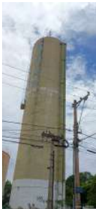
Foto 4 - Vista do reservatório elevado.
