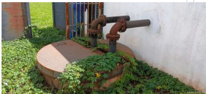
Foto 4 - Poço de sucção de esgoto.
