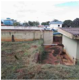
Foto 5 - Vista lateral do reservatório e da da EEAT (direita)
