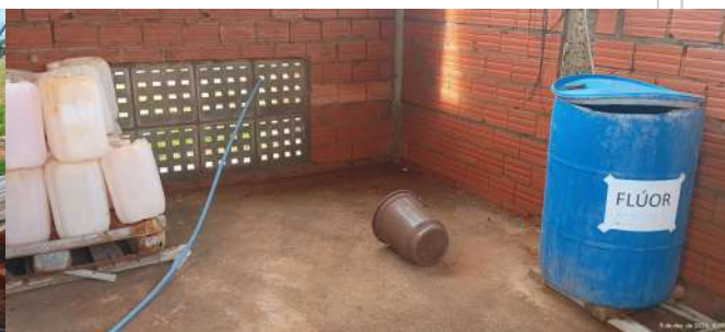
Foto 5 - Bombonas de armazenamento de flúor.
