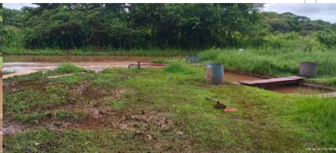
Foto 15 - Vista geral da área de captação, com desvio da água do Ribeirão Pitangueiras até o poço de sucção.
