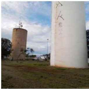
Foto 4 - Vista dos reservatórios metálico (frente) e de concreto (fundo).
