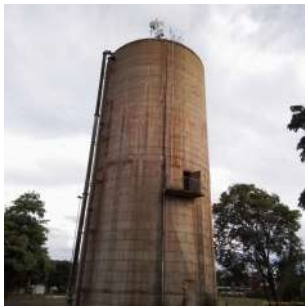
Foto 2 - Vista geral do reservatório elevado.
