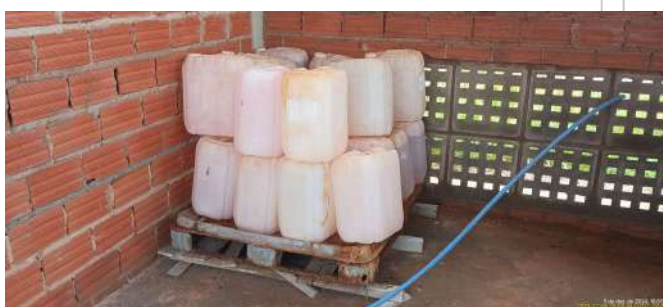
Foto 7 - Bombonas de armazenamento de flúor.
