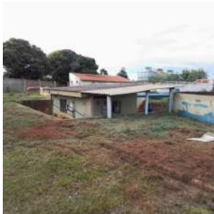
Foto 1 - Vista geral da casa de bombas.
