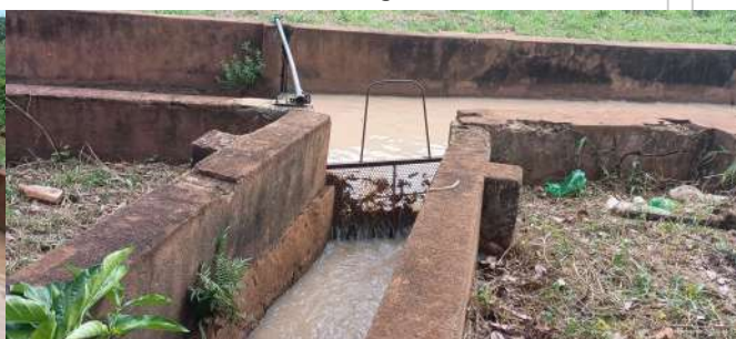
Foto 6 - Gradeamento grosseiro na entrada do canal para as caixas desarenadoras.
