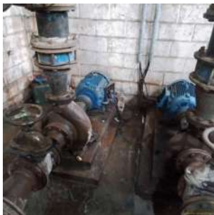
Foto 1 - Ausência da tampa da caixa de ligação elétrica dos conjuntos.
