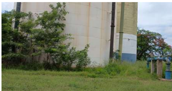
Foto 5 - Reservatório apoiado (esquerda), poço FEB (direita) e reservatório elevado (ao fundo).
