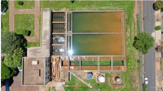
Foto 33 - Vista aérea da ETA.
