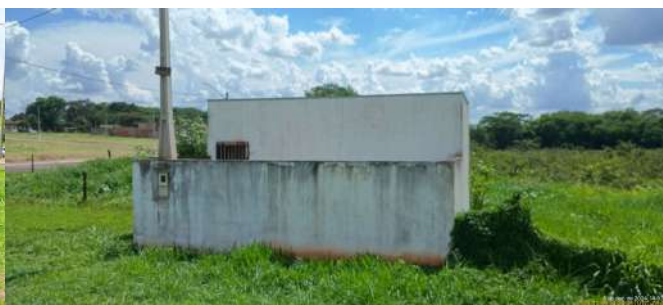
Foto 2 - Vista externa da elevatória.
