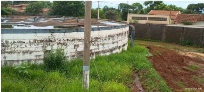
Foto 1 - Tubo extravasor na lateral do reservatório.
