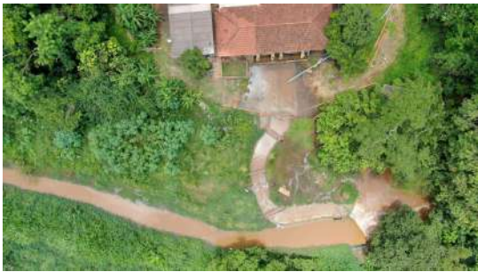
Foto 19 - Vista aérea da Captação do Ribeirão Pitangueiras.
