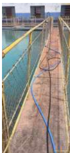
Foto 3 - Passarela entre dois tanques de decantação.
