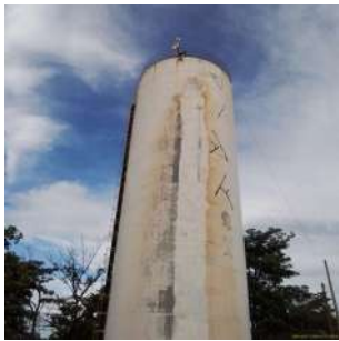
Foto 3 - Vista geral do reservatório elevado.
