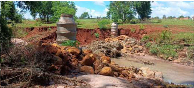
Foto 2 - Vista geral do entorno do emissário, próximo à ETE III Buracão.
