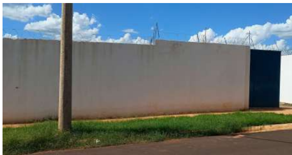
Foto 1 - Vista externa da EEE.
