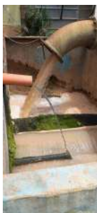
Foto 3 - Pontos de dosagem conjunta de carvão e cal.
