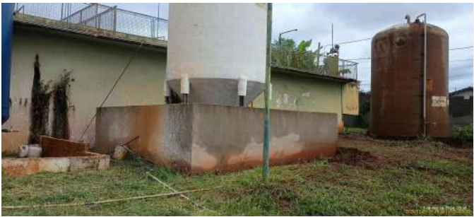
Foto 6 - Ausência de identificação do reservatório branco.
