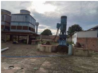
Foto 2 - Vista geral do entorno do poço.
