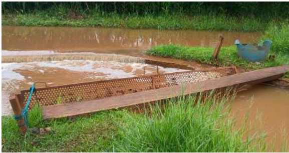
Foto 3 - Vista geral da Captação, sem guarda-corpos.
