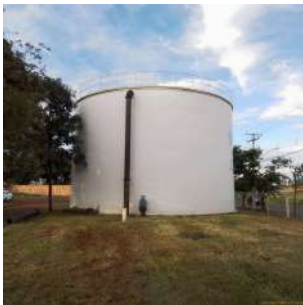
Foto 2 - Vista geral do reservatório.
