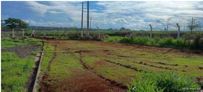
Foto 1 - Trecho com ausência de cerca adequada.
