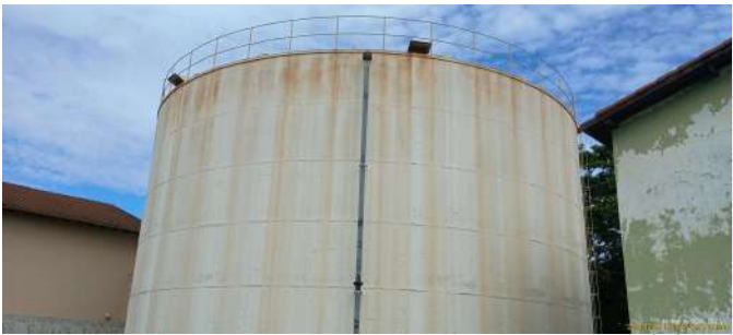
Foto 6 - Vista geral da lateral do reservatório.
