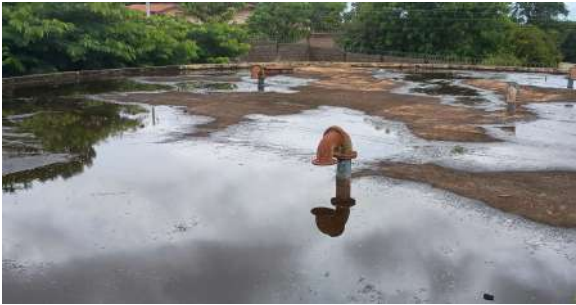
Foto 3 - Laje do reservatório e tubos de ventilação (respiro).
