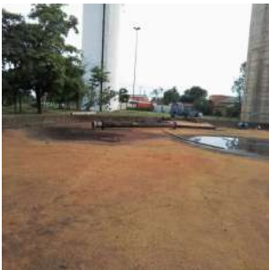
Foto 4 - Laje do reservatório semienterrado II.
