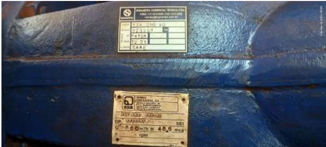
Foto 8 - Placa de especificações técnicas da bomba do conjunto 01.
