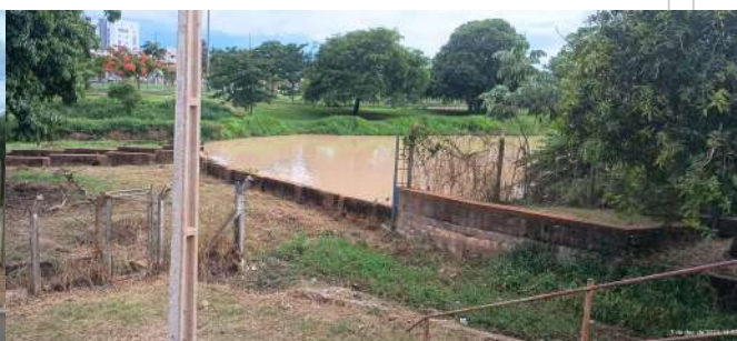
Foto 2 - Barragem e lago no Córrego Aleixo (montante da captação).
