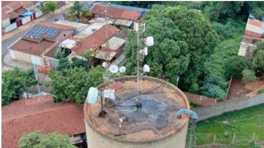
Foto 1 - Vista aérea da laje do reservatório.
