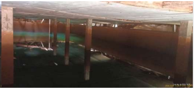
Foto 4 - Vista interna do reservatório.
