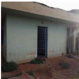
Foto 3 - Entrada da casa de bombas.
