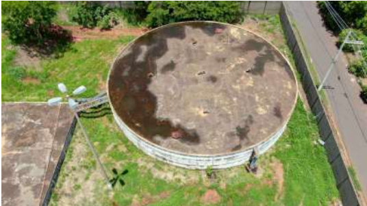
Foto 7 - Vista aérea geral do reservatório circular.
