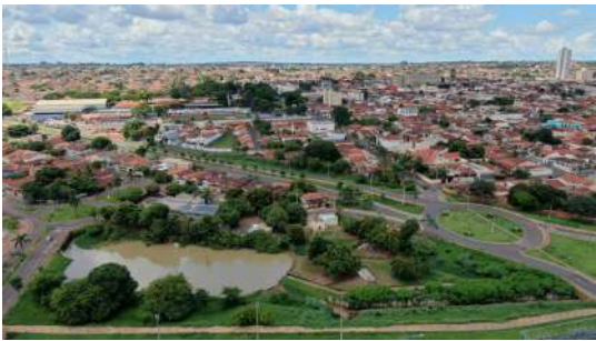
Foto 18 - Vista aérea do lago no Córrego Aleixo e da barragem a montante da captação.
