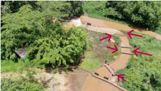
Foto 2 - Indicações de alguns dos locais sem guarda-corpo.
