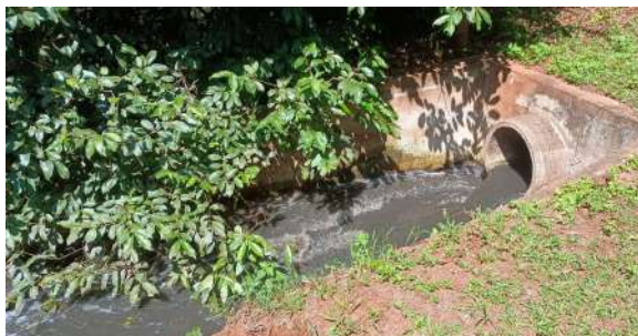
Foto 1 - Lançamento do esgoto pós-tratamento no curso d'água.
