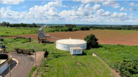
Foto 8 - Vista aérea do local.
