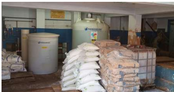
Foto 18 - Armazenamento de produtos químicos.
