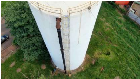
Foto 9 - Vista aérea do reservatório.
