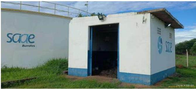
Foto 1 - EEAT e reservatório apoiado.
