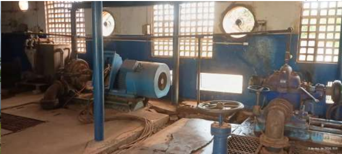
Foto 2 - Vista interna da EEAT.
