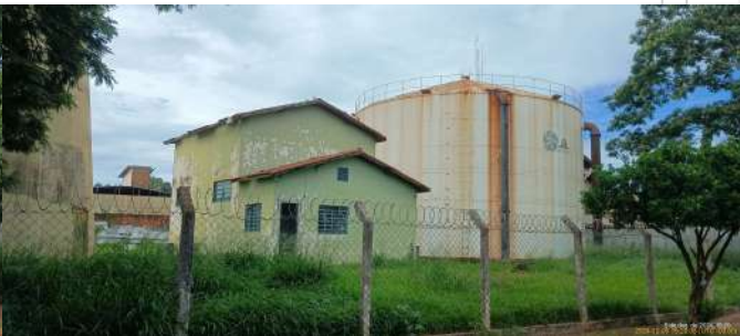
Foto 2 - Reservatório metálico (direita) e EEAT (centro).
