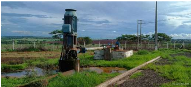
Foto 1 - Vista geral do entorno do poço.
