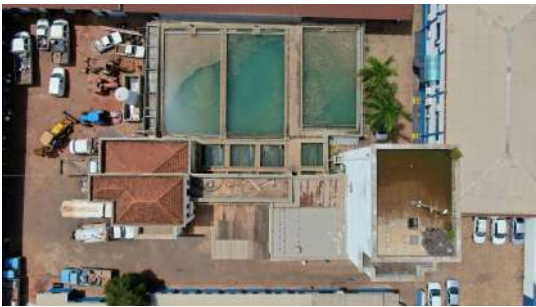
Foto 21 - Vista aérea da ETA Baroni.
