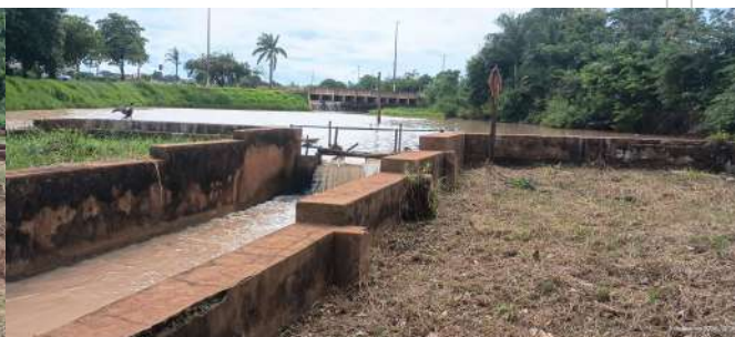
Foto 4 - Canais de tomada de água após o barramento do Córrego Aleixo.
