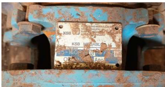
Foto 5 - Placa de especificações técnicas da bomba do único conjunto motobomba em operação.
