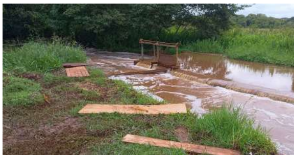
Foto 16 - Vista geral da área de captação, com desvio da água do Ribeirão Pitangueiras até o poço de sucção.
