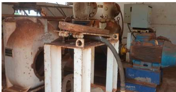
Foto 30 - Vista interna da estação elevatória.
