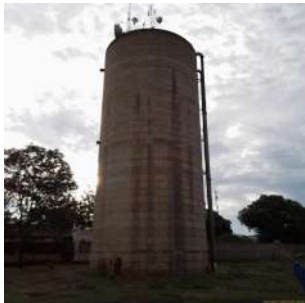
Foto 4 - Vista lateral do reservatório elevado.
