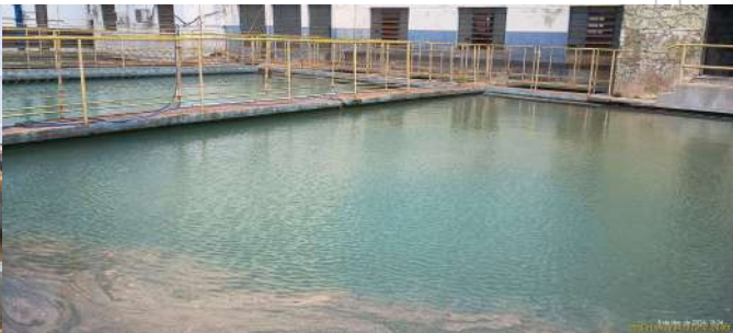
Foto 2 - Vista geral dos decantadores e guarda-corpos no entorno.
