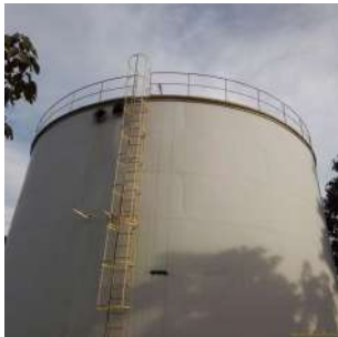
Foto 1 - Tubo extravasor sem tela de proteção.
