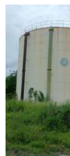
Foto 2 - Vista lateral do reservatório apoiado metálico.
