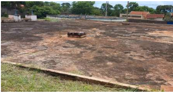
Foto 5 - Laje do reservatório semienterrado I.
