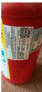
Foto 1 - Validade do extintor dentro do prazo regular.
