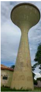
Foto 5 - Reservatório elevado Sorvetão.
