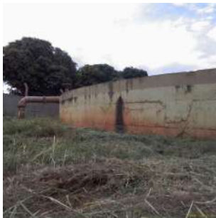
Foto 4 - Vista lateral do reservatório.
