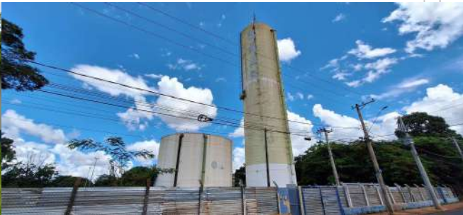
Foto 8 - Vista dos reservatórios.
