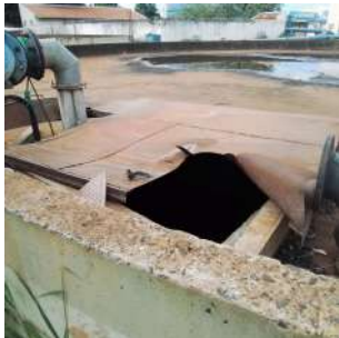
Foto 1 - Situação da tampa de inspeção do reservatório.
