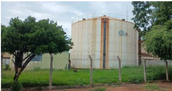
Foto 1 - Vista do reservatório metálico.
