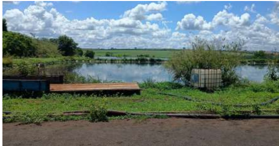
Foto 36 - Vista geral da lagoa anaeróbia da linha 1.
