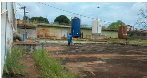
Foto 3 - Laje do reservatório e, à esquerda, tubulações de sucção da EEAT.
