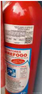
Foto 1 - Validade do extintor de incêndio.
