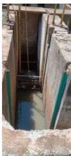
Foto 3 - Canal de gradeamento do lado esquerdo.
