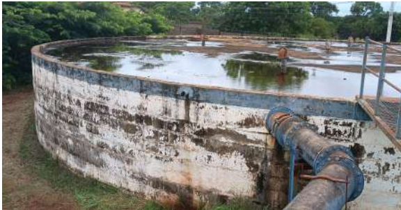
Foto 1 - Vista lateral e da laje do reservatório.
