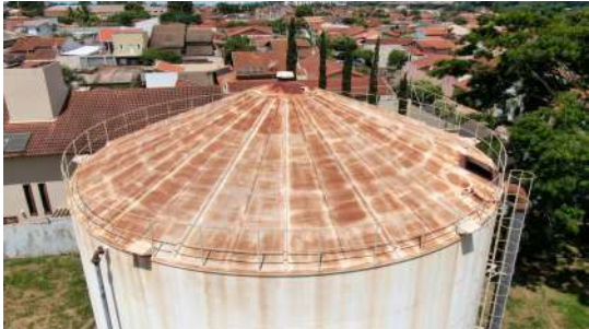
Foto 12 - Vista aérea do reservatório apoiado.
