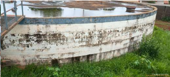
Foto 2 - Vista lateral e da laje do reservatório.
