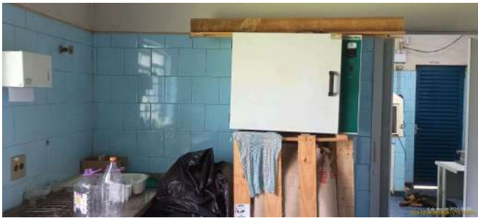
Foto 1 - Exemplo de equipamento na caixa, não utilizado.
