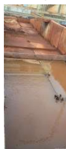
Foto 9 - Situação geral da estruturação de floculação.
