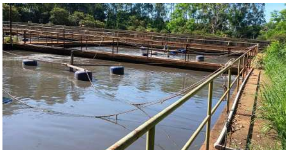
Foto 12 - Tanques de aeração.
