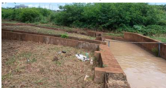
Foto 5 - Canais de tomada de água após o barramento do Córrego Aleixo.
