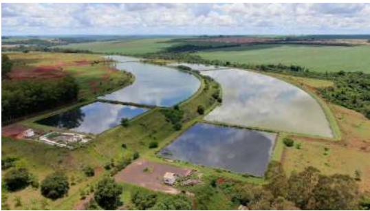
Foto 52 - Vista aérea das lagoas de tratamento da ETE III.
