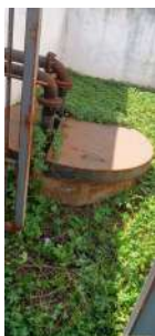
Foto 3 - Poço de sucção de esgoto.
