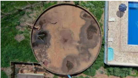
Foto 9 - Vista aérea da laje do reservatório.
