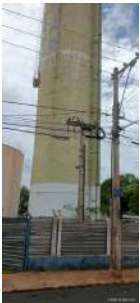
Foto 5 - Vista do reservatório elevado.
