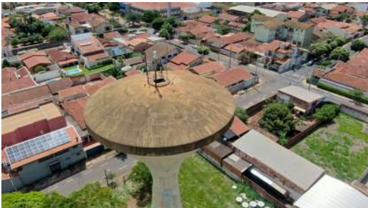
Foto 10 - Vista aérea do reservatório elevado.
