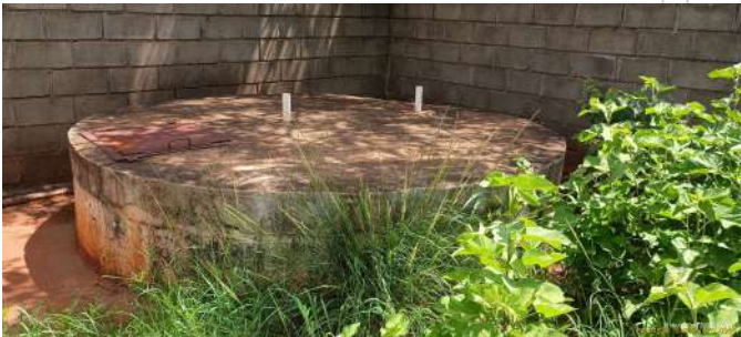
Foto 7 - Tanque de acúmulo de esgoto.
