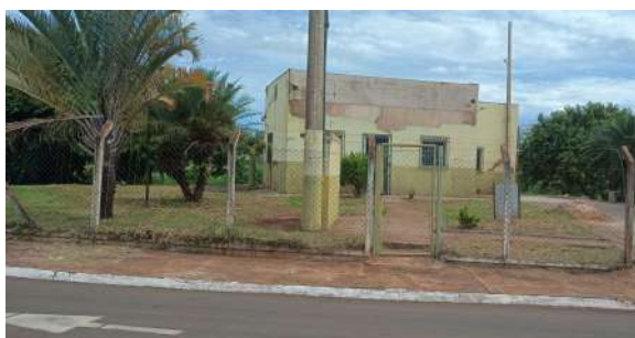
Foto 1 - Vista da entrada da casa de bombas da Captação Aleixo.
