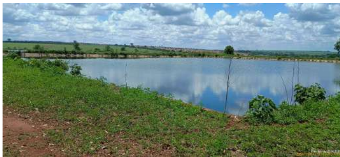
Foto 44 - Vista geral da lagoa anaeróbia da linha 2.
