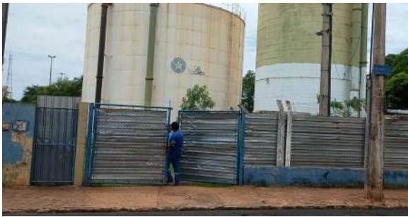
Foto 1 - Vista geral do CR FEB.
