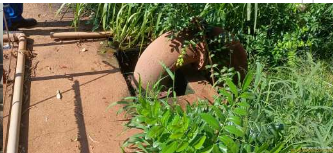
Foto 11 - Tubulação de chegada do esgoto a elevatória nos tanques de aeração.
