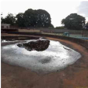
Foto 5 - Laje do reservatório semienterrado II.
