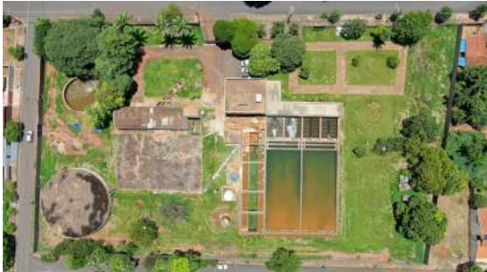
Foto 7 - Vista aérea da ETA Pereira.
