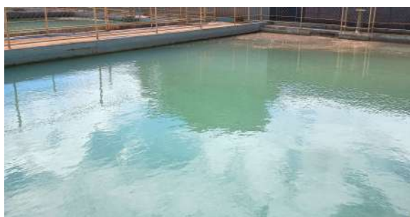
Foto 8 - Módulo de decantação.
