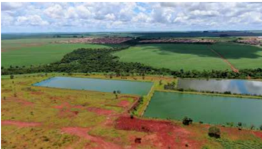
Foto 54 - Vista aérea da lagoa de maturação (esquerda) da linha de lagoas 2.
