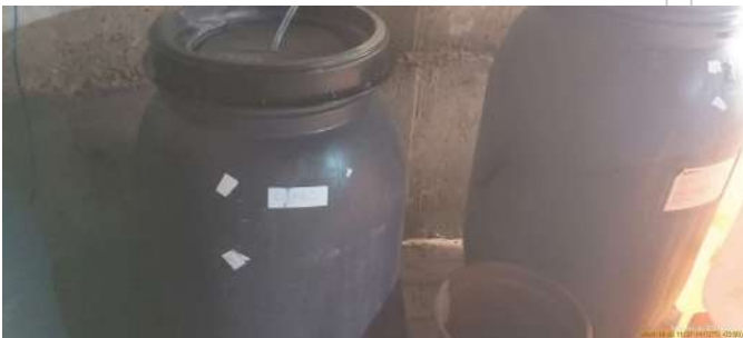
Foto 5 - Ausência de identificação adequada do hipoclorito de sódio.
