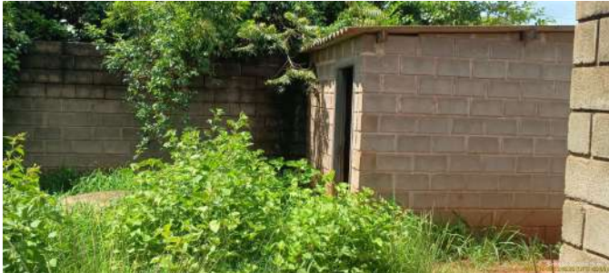
Foto 5 - Local originalmente construído para ser abrigo de bombas.
