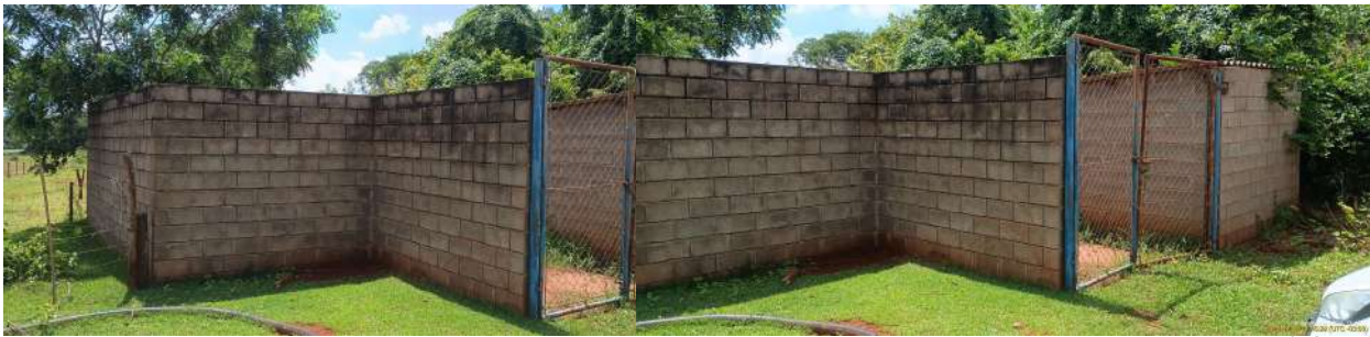
Foto 1 - Vista externa da EEE.
