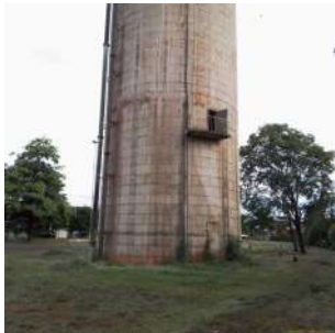
Foto 3 - Vista geral do reservatório elevado.
