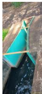
Foto 2 - Calha Parshall do decantador 2.
