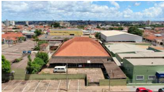
Foto 7 - Vista aérea geral do reservatório.
