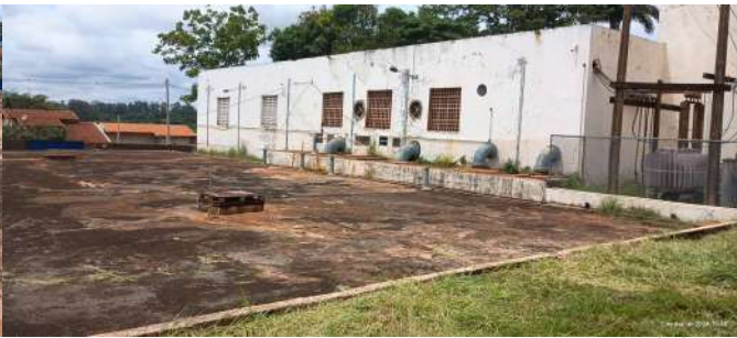
Foto 6 - Laje do reservatório e, ao fundo, EEAT.
