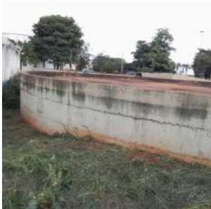
Foto 7 - Vista lateral do reservatório.
