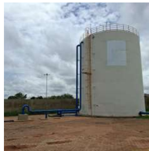
Foto 5 - Vista do Reservatório São Rafael em Araraquara
