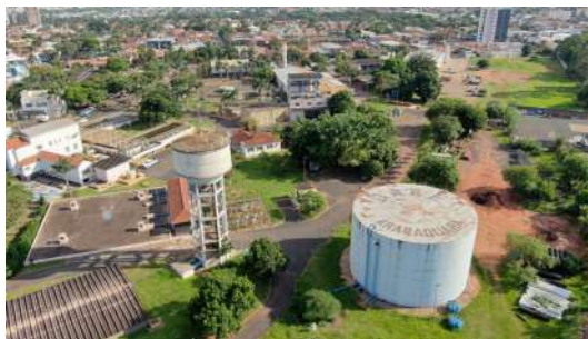
Foto 2 - Reservatório R23 ao lado direito em Araraquara
