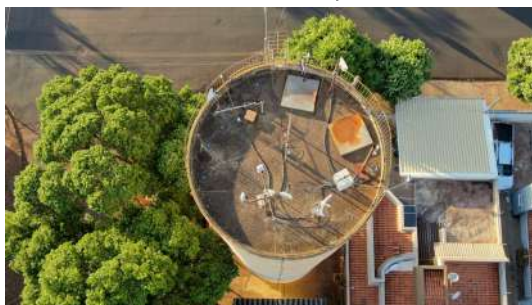
Foto 4 - Tampas de inspeção do Reservatório Jardim das Flores em Araraquara
