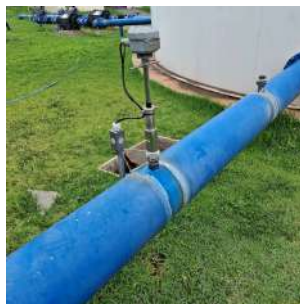
Foto 9 - Medidor de vazão do Poço São Rafael em Araraquara
