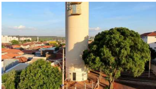
Foto 2 - Área cercada do Reservatório Jardim das Flores em Araraquara
