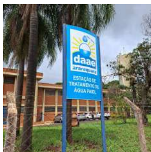
Foto 1 - Entrada da ETA Paiol em Araraquara
