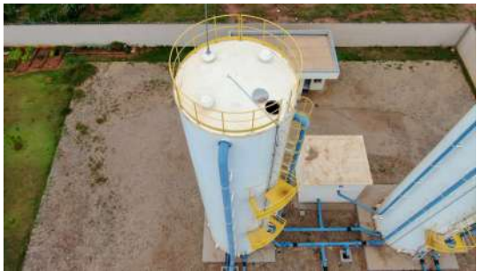
Foto 2 - Guarda-corpo no Reservatório 51 Ipanema ZB em Araraquara
