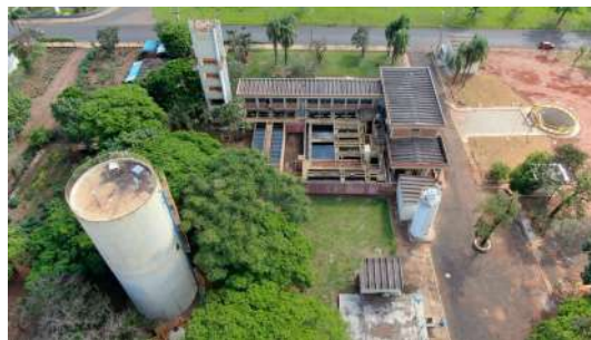
Foto 26 - Vista por drone da ETA Paiol em Araraquara
