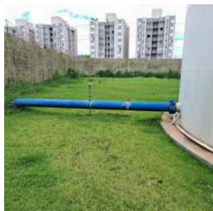
Foto 8 - Saída do do Poço São Rafael e entrada no Reservatório em Araraquara
