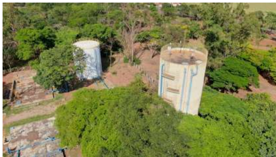
Foto 1 - Tubulações de entrada, extravasamento e ventilação no Reservatório R5 em Araraquara
