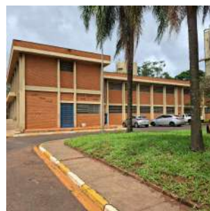
Foto 2 - Entrada da ETA Paiol em Araraquara
