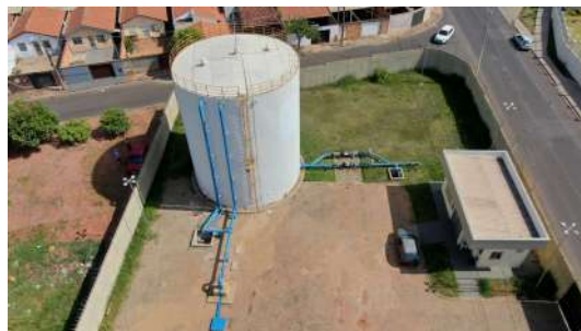
Foto 7 - Vista por drone do Reservatório São Rafael em Araraquara
