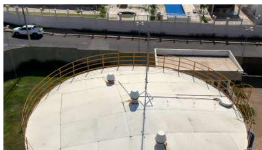
Foto 10 - Para-raios do Reservatório São Rafael em Araraquara
