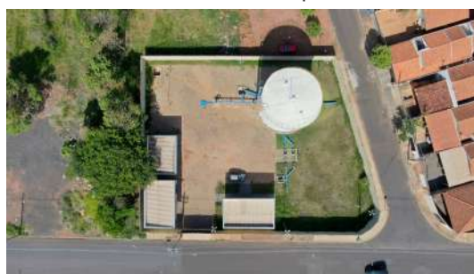
Foto 8 - Vista por drone do Reservatório São Rafael em Araraquara
