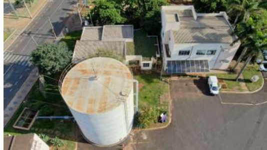
Foto 2 - Tampa de inspeção do Reservatório R39 em Araraquara
