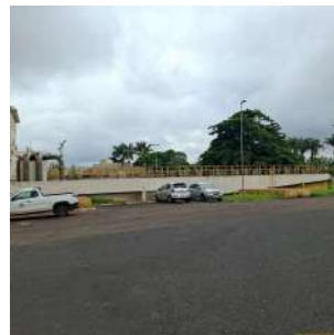
Foto 12 - ETA Fonte em Araraquara
