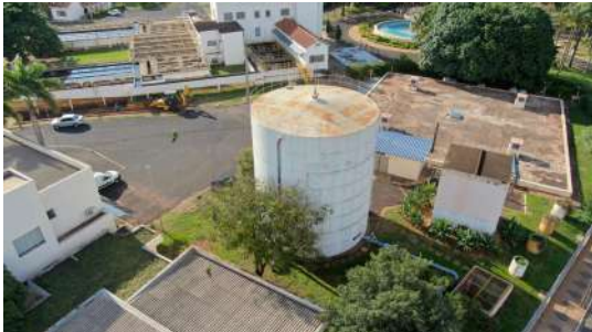
Foto 3 - Reservatório R39 em Araraquara
