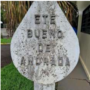
Foto 1 - Entrada da ETE Bueno de Andrade em Araraquara
