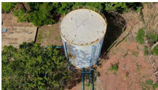
Foto 6 - Reservatório R46 em Araraquara
