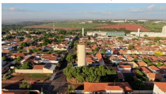
Foto 5 - Vista por drone do Reservatório Jardim das Flores em Araraquara
