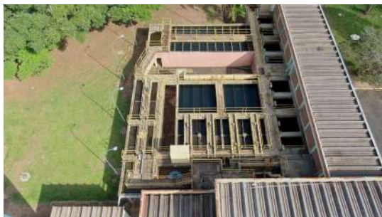
Foto 25 - Vista por drone da ETA Paiol em Araraquara
