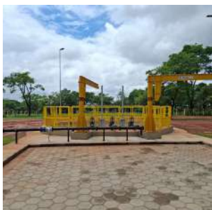
Foto 1 - Tanque de lodo da ETA Paiol em Araraquara
