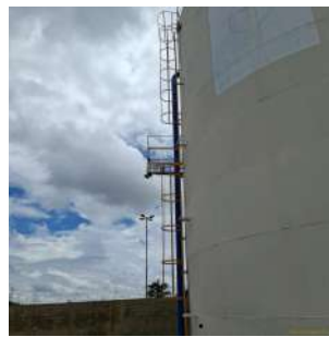
Foto 4 - Guarda-corpo do Reservatório São Rafael em Araraquara
