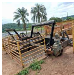
Foto 4 - Entrada do efluente da ETE Araraquara
