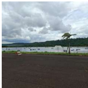
Foto 1 - Vista da ETE Araraquara
