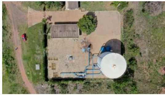
Foto 5 - Vista por drone no Reservatório Flora em Araraquara
