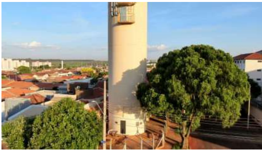
Foto 9 - Vista por drone do Reservatório Jardim das Flores em Araraquara
