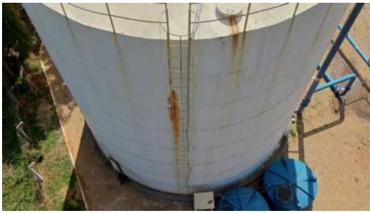
Foto 4 - Guarda-corpo do Reservatório Flora em Araraquara
