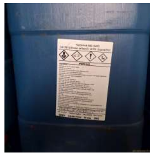
Foto 9 - Produtos químicos utilizados na ETA Fonte em Araraquara
