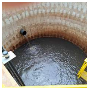
Foto 2 - Tanque de lodo da ETA Paiol em Araraquara
