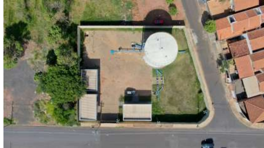
Foto 2 - Vista por drone dos boosters do São Rafael em Araraquara
