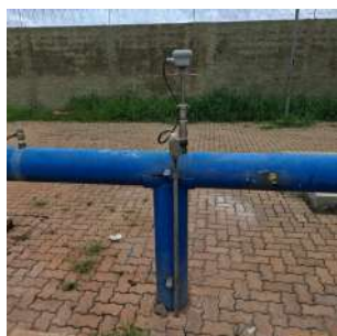
Foto 5 - Medidor de vazão do Poço São Rafael em Araraquara
