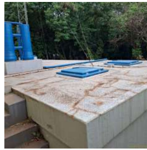
Foto 7 - Tampas de inspeção no Poço Santa Lucia em Araraquara
