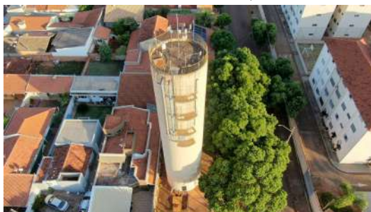
Foto 8 - Vista das tubulações de entrada, extravasamento e ventilação do Reservatório Jardim das Flores em Araraquara
