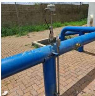
Foto 1 - Medidor de vazão do Poço São Rafael em Araraquara
