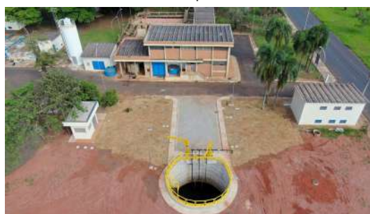
Foto 28 - Vista por drone da ETA Paiol em Araraquara
