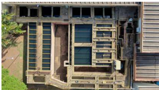
Foto 29 - Vista por drone da ETA Paiol em Araraquara
