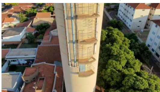
Foto 6 - Vista por drone do Reservatório Jardim das Flores em Araraquara
