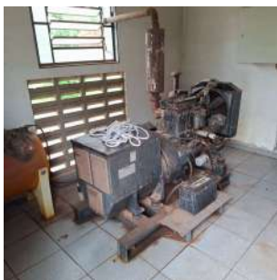
Foto 5 - Sala de centrifugas da ETE Bueno de Andrade em Araraquara
