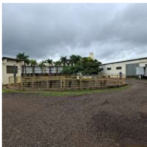
Foto 1 - Tanque de lodo na ETA Fonte em Araraquara
