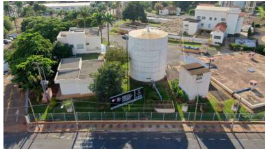
Foto 4 - Reservatório R39 em Araraquara
