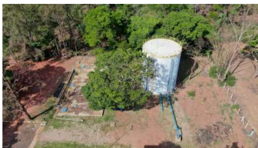
Foto 5 - Reservatório R46 em Araraquara
