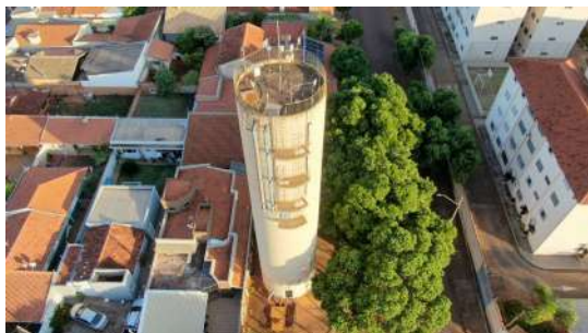
Foto 1 - Vista por drone do Reservatório Jardim das Flores em Araraquara
