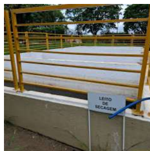
Foto 8 - Leito de secagem do lodo da ETE Bueno de Andrade em Araraquara
