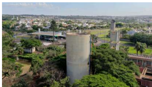
Foto 3 - Reservatório R5 em Araraquara
