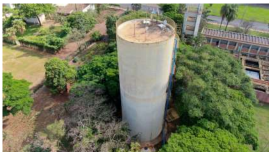
Foto 4 - Reservatório R5 em Araraquara
