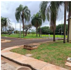
Foto 1 - ETA Paiol em Araraquara
