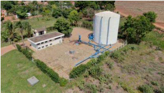
Foto 2 - Vista por drone no Reservatório Flora em Araraquara
