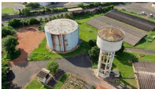
Foto 3 - Reservatório R23 ao lado esquerdo em Araraquara
