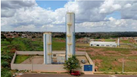
Foto 4 - Reservatório 51 Ipanema ZB em Araraquara
