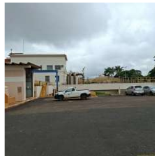
Foto 11 - ETA Fonte em Araraquara
