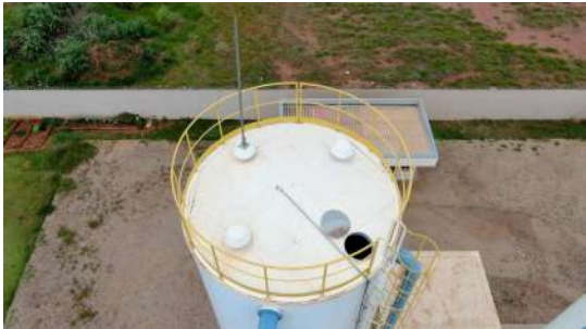
Foto 1 - Tampa de inspeção aberta no Reservatório 51 Ipanema ZB em Araraquara
