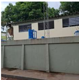
Foto 1 - Área cercada no Poço Santa Lucia em Araraquara
