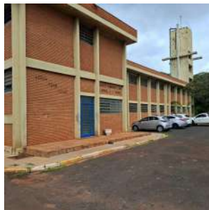
Foto 2 - ETA Paiol em Araraquara
