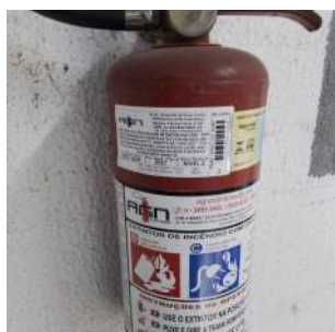
Foto 1 - Manutenção do extintor.
