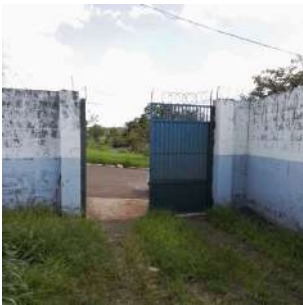
Foto 1 - Portão e muro no perímetro da área.
