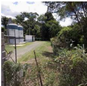
Foto 3 - Cerca no perímetro da área.
