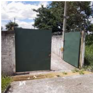
Foto 1 - Portão de acesso.
