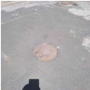
Foto 2 - PV que recebe o efluente na entrada da estação elevatória.
