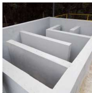
Foto 19 - Tabique de contato em fase final de execução.
