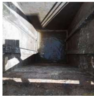
Foto 6 - Poco no qual o efluente entra na elevatória.
