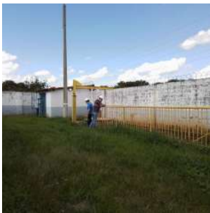
Foto 2 - Visão geral da elevatória.
