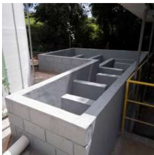
Foto 15 - Tanque de contato em fase final de execução. Quando estiver em operação, o cloro será aplicado na entrada do tanque.
