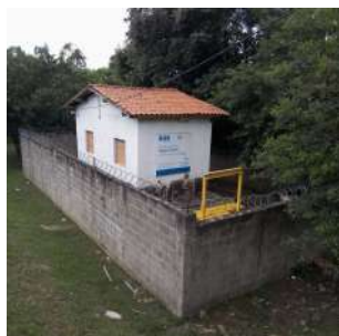
Foto 1 - Placa de identificação da elevatória.
