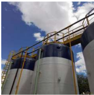
Foto 3 - Guarda-corpo na plataforma que conecta os filtros.
