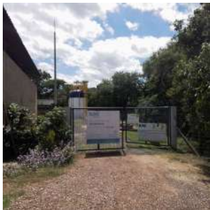
Foto 1 - Vista externa da estação.
