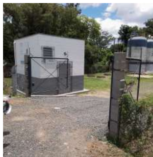
Foto 2 - Portão de acesso.
