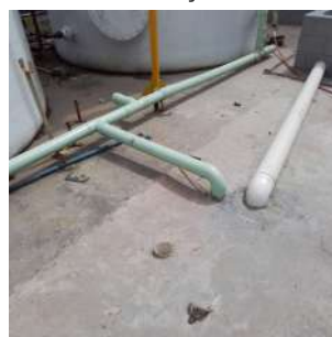
Foto 14 - Aplicação de cloro na entrada do decantador. Posteriormente a aplicação será realizada no tanque de contato.
