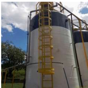
Foto 1 - Escada com proteção em um dos filtros.
