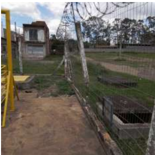
Foto 1 - Recomenda-se realizar manutenção da cerca para evitar que a área sofra vandalismo.
