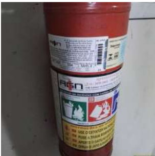
Foto 1 - Manutenção do extintor.
