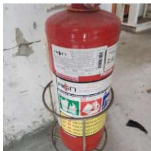
Foto 1 - Manutenção do extintor.
