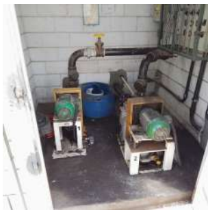
Foto 1 - Bombas centrífugas.
