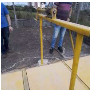
Foto 1 - Estrutura para içar o cesto peneira e realizar a limpeza.
