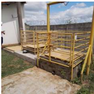
Foto 7 - Poços e estrutura da estação elevatória.
