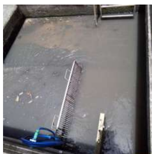
Foto 2 - Gradeamento em boas condições.
