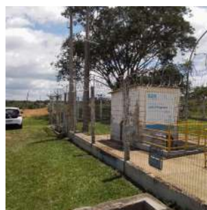
Foto 2 - Cerca e portão.
