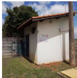
Foto 8 - Edificação que abriga o gerador e o painel de comando.
