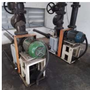
Foto 1 - Bombas centrífugas.
