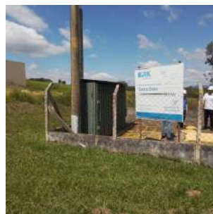
Foto 2 - Cerca no perímetro da área.
