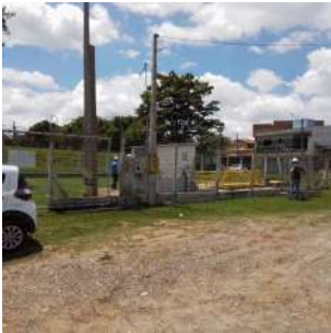
Foto 1 - Visão geral da elevatória.
