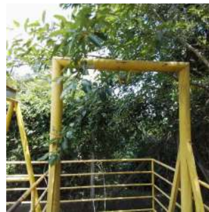
Foto 2 - Estrutura para içamento do cesto peneira.
