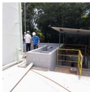
Foto 12 - Tanque de contato em fase final de execução.
