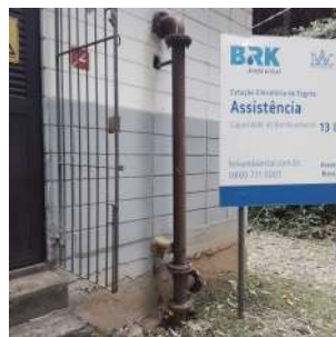
Foto 6 - Recalque elevatória.
