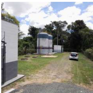
Foto 1 - Visão geral da estação de tratamento de esgoto Batovi.
