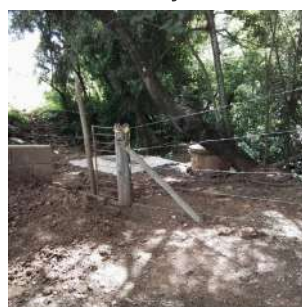
Foto 21 - Lançamento final do efluente.
