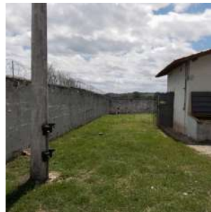
Foto 2 - Muro com concertina.
