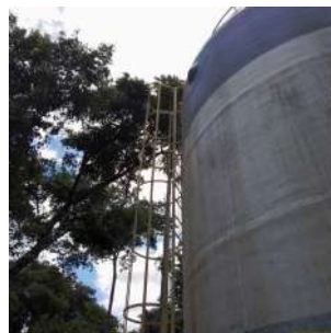
Foto 2 - Escada com proteção.
