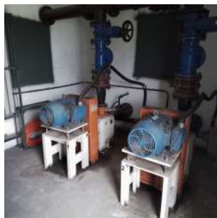
Foto 3 - Bombas centrífugas.
