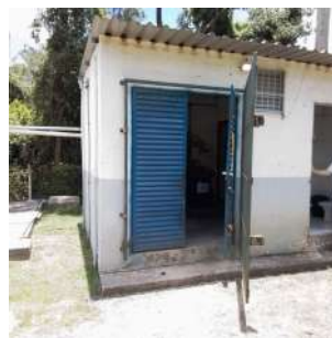
Foto 12 - Edificação que abriga sopradores, painel de comando das bombas e armazenamento do hipoclorito de sódio, além de banheiro.
