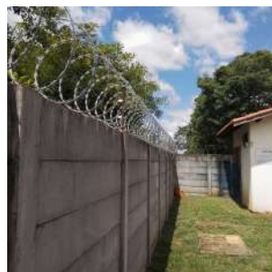
Foto 2 - Muro e concertina no perímetro da área.
