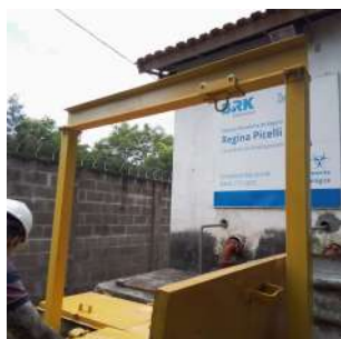
Foto 1 - Estrutura para içar o cesto peneira.
