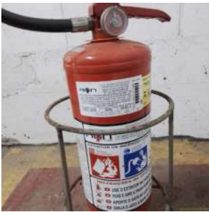
Foto 1 - Manutenção do extintor.
