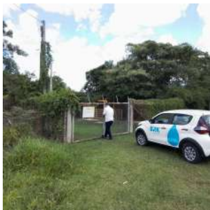
Foto 1 - Visão geral da elevatória.
