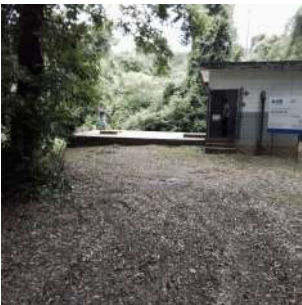
Foto 2 - Visão geral da elevatória.
