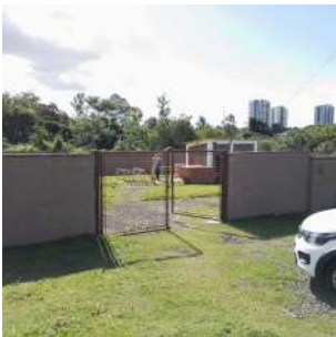
Foto 1 - Visão geral da elevatória.
