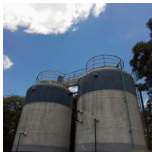
Foto 1 - Guarda-corpo na plataforma que conecta o reator UASB e o filtro aerado.
