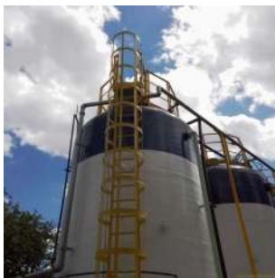
Foto 2 - Escada em um dos filtros.
