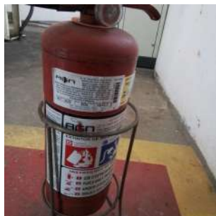
Foto 1 - Manutenção do extintor.
