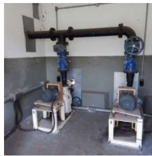
Foto 2 - Bombas centrífugas.
