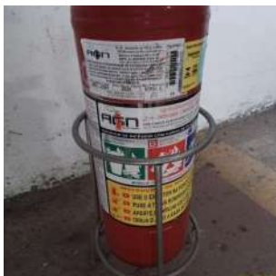
Foto 1 - Manutenção do extintor.
