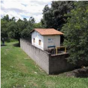
Foto 1 - Visão geral da elevatória.
