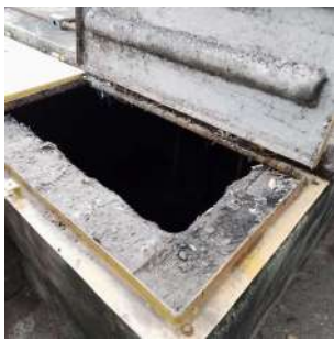
Foto 3 - Poço úmido da elevatória.
