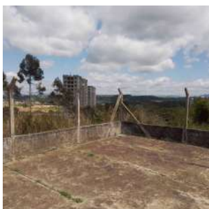
Foto 3 - Cerca no perímetro da área.
