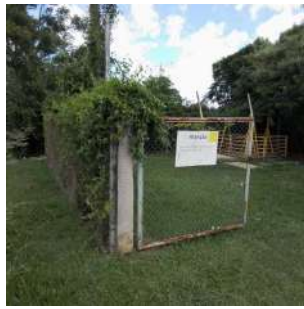
Foto 1 - Cerca e portão de acesso.
