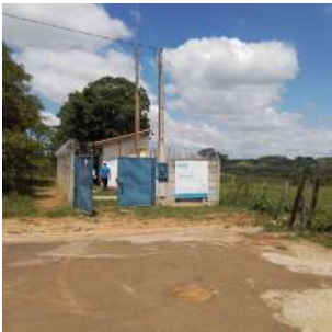
Foto 1 - Visão geral da elevatória.
