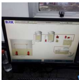
Foto 15 - Monitoramento da ETE Batovi e de sua elevatória interna.
