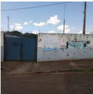
Foto 1 - Vista externa da elevatória.
