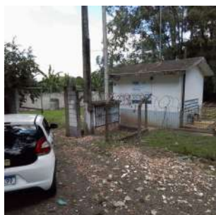
Foto 1 - Cerca e portão de acesso.
