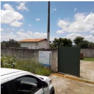
Foto 1 - Visão geral da elevatória.
