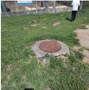
Foto 2 - PV que recebe o efluente na entrada da elevatória.
