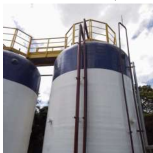
Foto 9 - Tubulação de entrada e de recirculação de um dos filtros.
