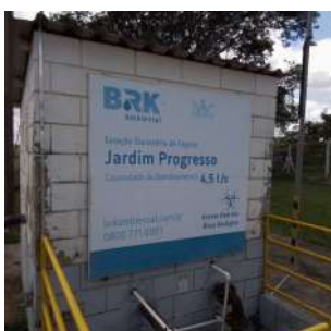
Foto 1 - Placa de identificação da elevatória Progresso I.
