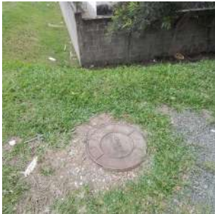
Foto 2 - PV antes da entrada do efluente na estação elevatória.
