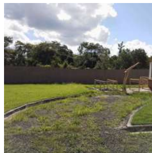
Foto 2 - Muro no perímetro da área.
