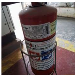
Foto 1 - Manutenção do extintor.
