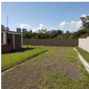
Foto 1 - Muro no perímetro da área.
