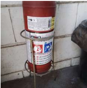
Foto 1 - Manutenção do extintor.
