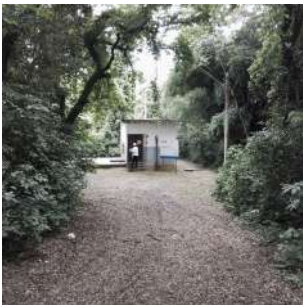
Foto 1 - Visão geral da elevatória.
