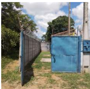
Foto 1 - Portão de entrada.
