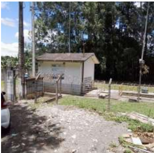
Foto 1 - Visão geral da elevatória.
