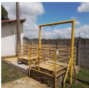
Foto 1 - Estrutura para içamento do cesto peneira.
