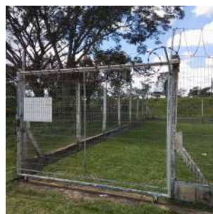
Foto 3 - Portão de acesso.
