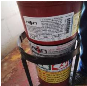
Foto 1 - Manutenção do extintor.
