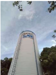
Foto 1 - Pintura de identificação na estrutura do reservatório localizado no mesmo local.
