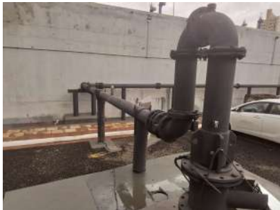
Foto 2 - Vista detalhada do poço.
