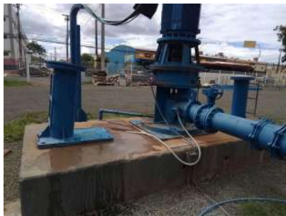
Foto 1 - Laje do poço.
