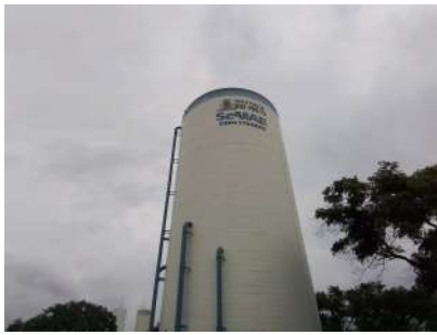
Foto 1 - Pintura de identificação na estrutura do reservatório.
