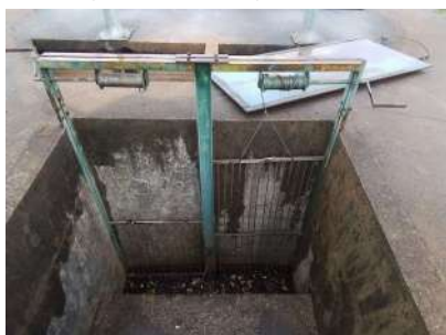
Foto 3 - Detalhe do gradeamento antigo.
