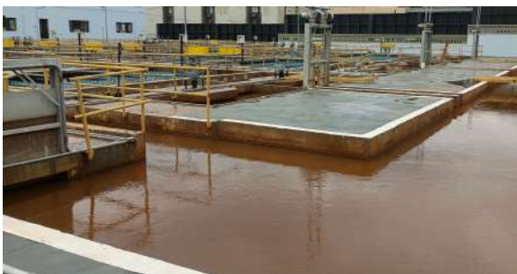
Foto 26 - Canal anterior aos tanques de floculação
