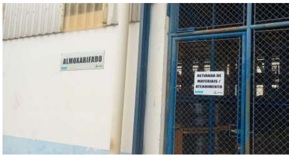
Foto 1 - Entrada do almoxarifado do SeMAE, situado ao lado da ETE Rio Preto.
