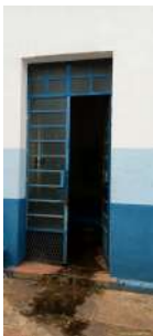
Foto 6 - Acesso à parte interna da EEAT.
