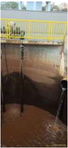
Foto 3 - Vista geral do tanque de equalização do lodo gerado na ETA.
