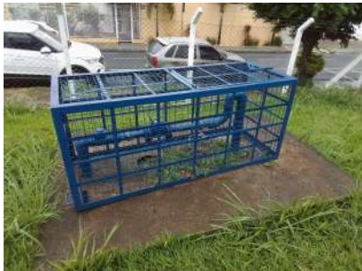
Foto 1 - Laje de proteção do poço.
