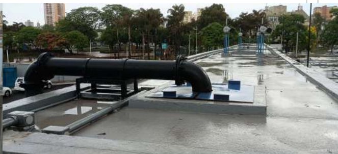
Foto 6 - Tubulação de chegada da água do Poço PTG1.
