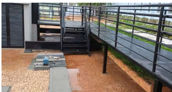
Foto 46 - Local de aplicação do ortopolifosfato
