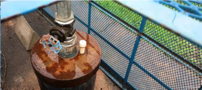
Foto 4 - Vista interna da grade de proteção do poço.
