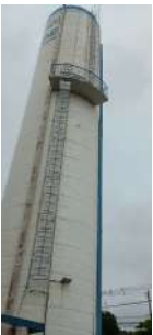
Foto 7 - Reservatório elevado Acácia.
