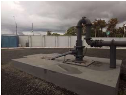
Foto 1 - Local cercado com muro de alvenaria.
