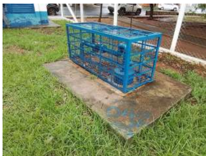
Foto 1 - Laje de proteção do poço.
