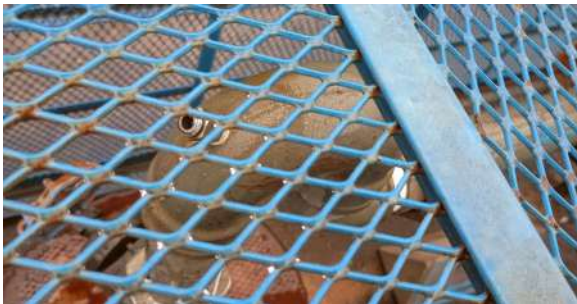
Foto 7 - Ponto de tomada de água bruta.
