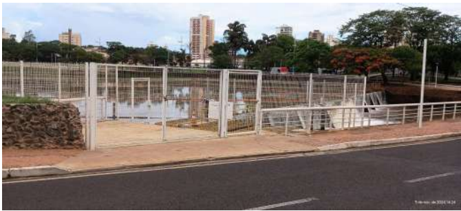
Foto 7 - Vista geral da captação de água bruta na Represa 1 (situada ao lado da ETA Palácio das Águas).
