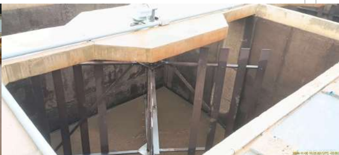
Foto 27 - Um dos tanques de floculação seco, com as pás de agitação.
