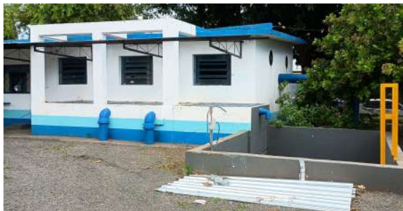
Foto 1 - Prédio da EEAT.
