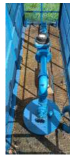
Foto 4 - Vista interna do poço.
