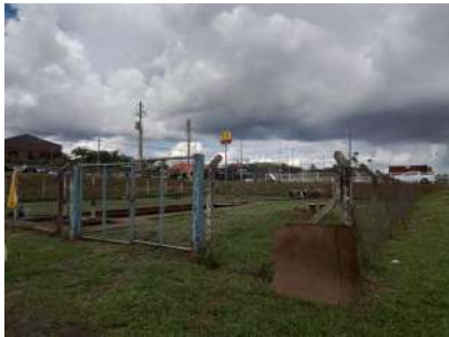
Foto 2 - Local onde ficam os tanques de gradeamento cercado com alambrado.
