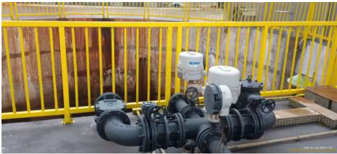
Foto 1 - Vista geral do tanque de equalização do lodo gerado na ETA.
