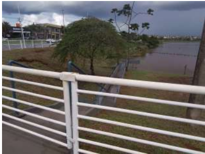
Foto 11 - Passarela sobre a Represa 3, acima da tubulação de tomada de água bruta por gravidade.
