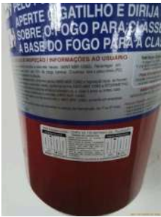
Foto 3 - Validade de um dos extintores de incêndio da EEAT.
