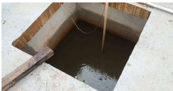
Foto 18 - Chegada de água bruta.
