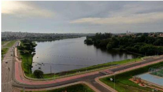
Foto 14 - Vista aérea da Represa 3 (Captação 2)
