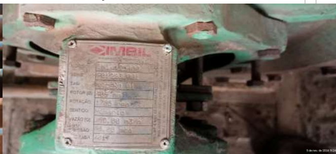
Foto 10 - Placa de especificações técnicas da bomba do conjunto motobomba 1 Maceno.
