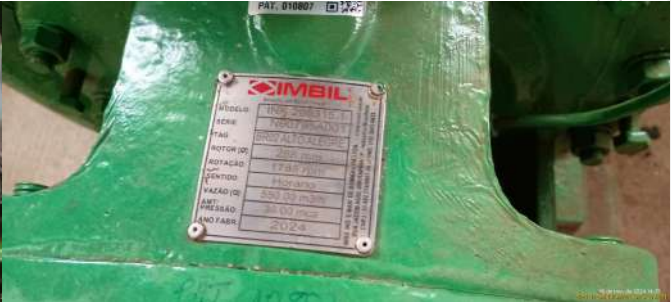
Foto 10 - Placa de especificações técnicas da bomba do conjunto motobomba intermediário da EEAT.
