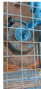
Foto 8 - Vista geral do poço.
