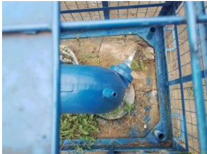
Foto 1 - Estrutura para tomada de água.
