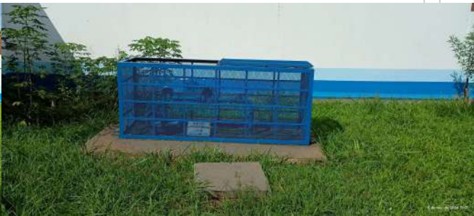
Foto 2 - Grade de proteção do poço.
