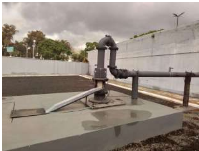
Foto 1 - Laje do poço.
