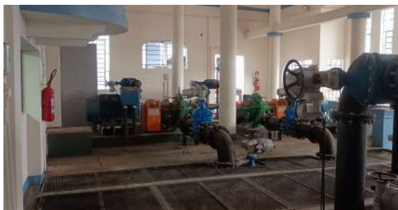
Foto 26 - Vista geral do Prédio 1 da EEAT.
