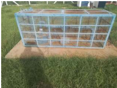
Foto 1 - Vista geral do poço.
