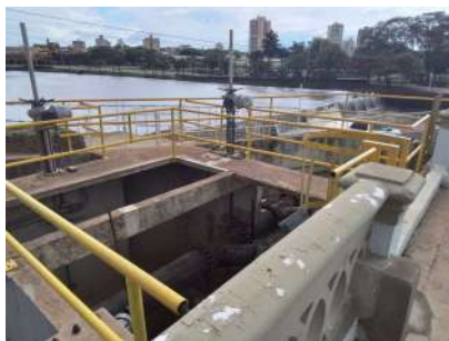
Foto 1 - Vista geral da cobertura da elevatória.
