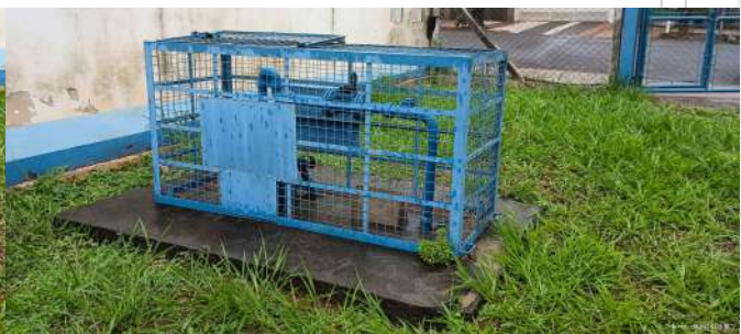
Foto 6 - Vista geral do poço.
