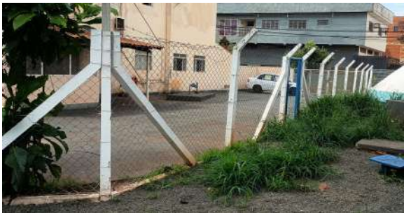
Foto 1 - Vista geral da área do Poço PTB 087.
