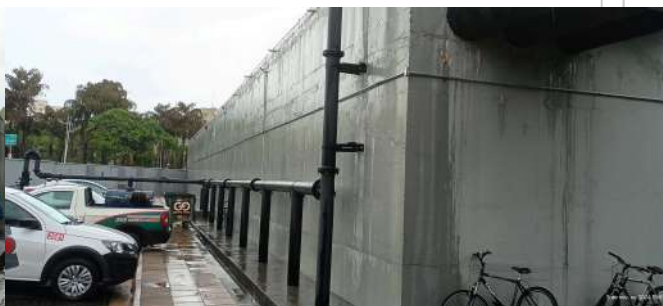
Foto 4 - Tubulação do Poço PTG 1 ao lado do reservatório.
