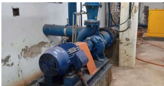
Foto 39 - Sistema de sopradores de lavagem dos filtros.
