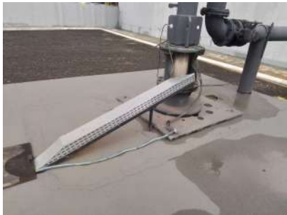
Foto 1 - Vista detalhada do poço.
