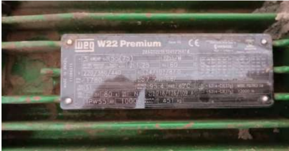
Foto 7 - Placa de especificações técnicas do motor do último conjunto motobomba da EEAT.
