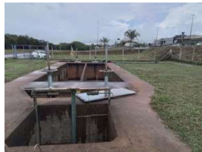
Foto 2 - Vista geral dos tanques, com o gradeamento antigo em primeiro plano.
