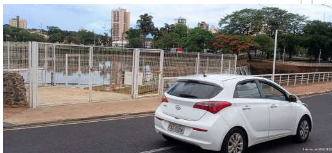
Foto 6 - Vista geral da captação de água bruta na Represa 1 (situada ao lado da ETA Palácio das Águas).
