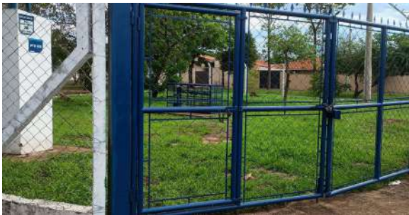
Foto 1 - Vista geral da entrada do local.
