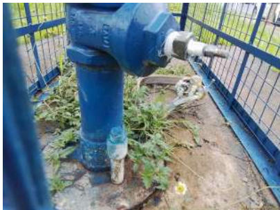
Foto 1 - Tubo para medição de nível.
