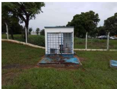
Foto 1 - Vista geral do abrigo dos tanques de produtos químicos e bombas dosadoras.
