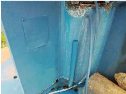
Foto 1 - Tubo para medição de nível.
