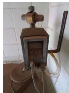
Foto 4 - Dosadora desligada.
