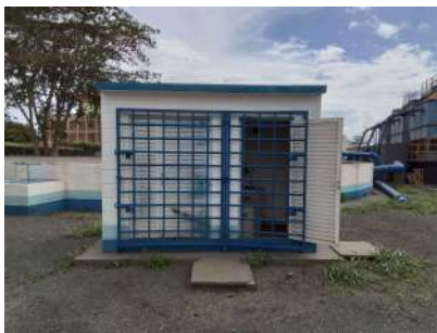
Foto 1 - Casa de química.
