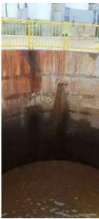
Foto 2 - Vista geral do tanque de equalização do lodo gerado na ETA.
