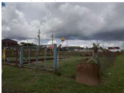
Foto 7 - Vista geral do local onde se situam os tanques de gradeamento e caixas de areia.
