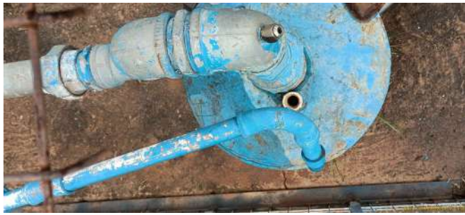
Foto 1 - Tubo de medição de nível sem cap.
