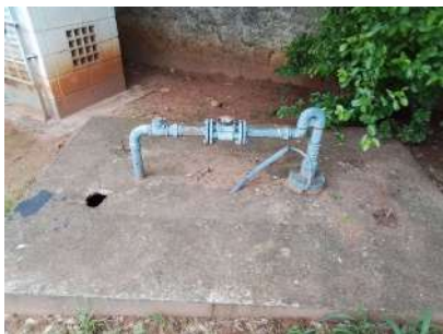
Foto 1 - Laje de proteção do poço.
