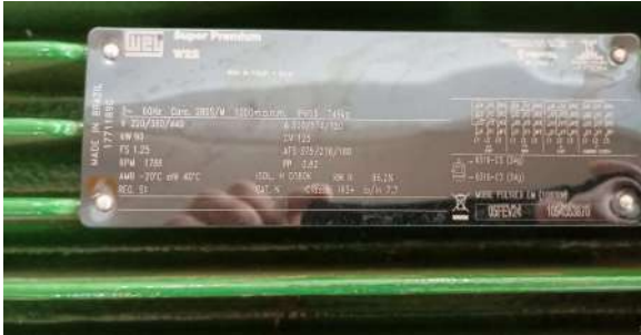
Foto 9 - Placa de especificações técnicas do motor do conjunto motobomba intermediário da EEAT.
