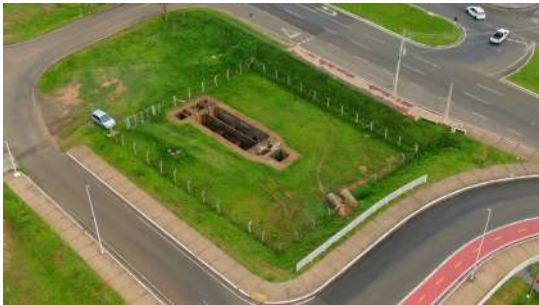
Foto 15 - Vista aérea do local de gradeamento e desarenadores da Captação 2.
