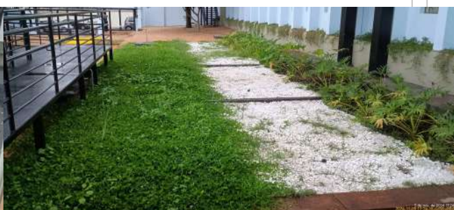
Foto 45 - Vista da área acima dos tanques de contato, pós aplicação de hipoclorito.
