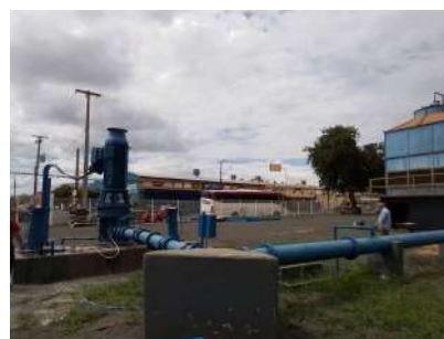
Foto 2 - Vista geral do poço.
