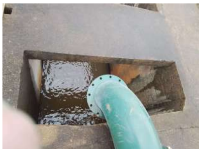
Foto 5 - Tubulação provisória de chegada de água da captação por bombeamento
