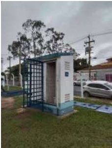
Foto 3 - Vista geral da casa de química.
