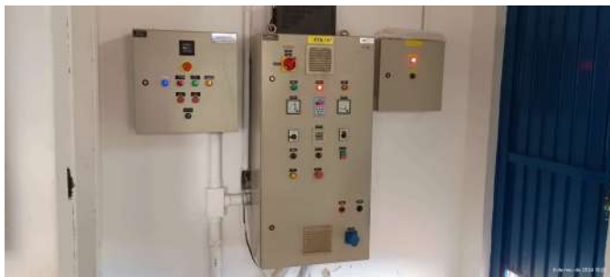
Foto 7 - Painéis elétricos e de comando do poço, situados dentro da EEAT João Paulo II.
