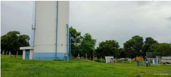
Foto 2 - Vista geral do local onde se situa o poço.
