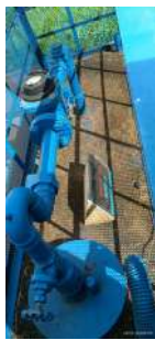
Foto 3 - Vista interna do poço.
