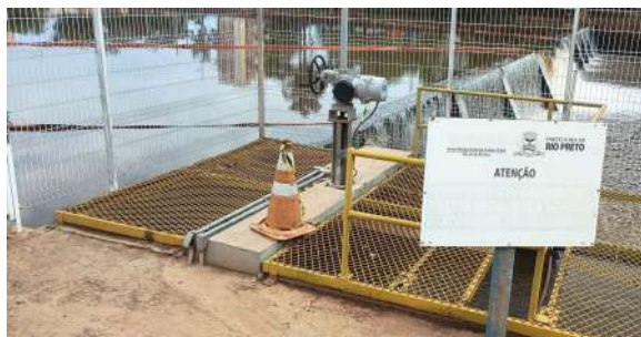
Foto 1 - Vista geral da captação ao lado da barragem da Represa 1.
