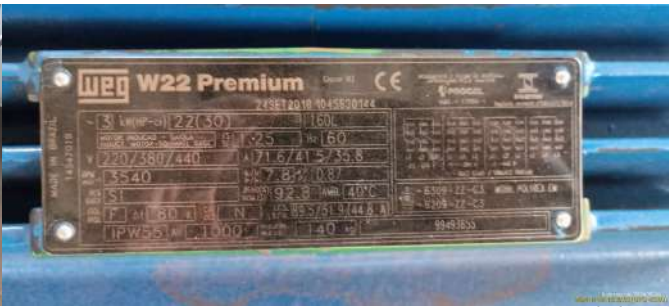
Foto 6 - Placa de especificações técnicas do motor do segundo conjunto motobomba.
