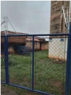
Foto 2 - Vista geral do local onde se situa o poço.
