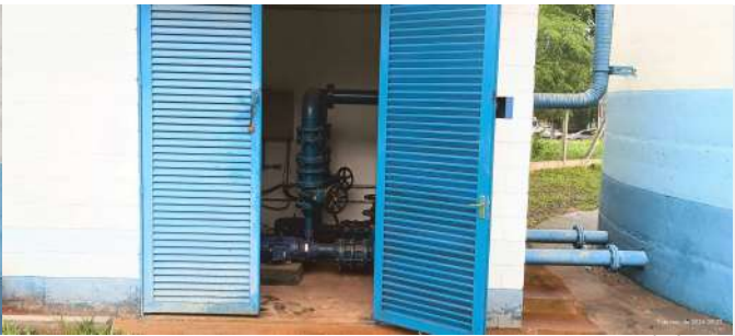
Foto 2 - Entrada da EEAT.
