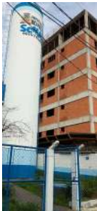
Foto 3 - Reservatório elevado ao lado.
