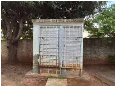
Foto 1 - Vista geral da casa de química.
