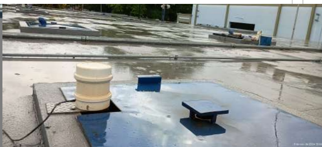
Foto 8 - Medidor de nível do reservatório, em uma das tampas de inspeção.
