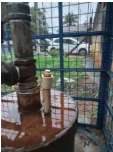
Foto 1 - Tubo para medição de nível.
