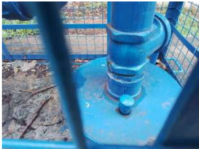
Foto 1 - Tubo para medição de nível.
