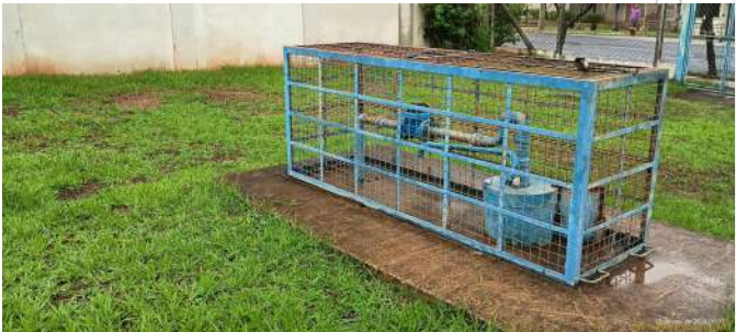
Foto 4 - Vista geral do poço.
