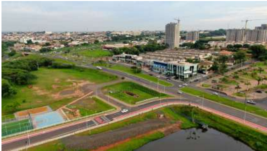
Foto 13 - Vista aérea da Captação 2.
