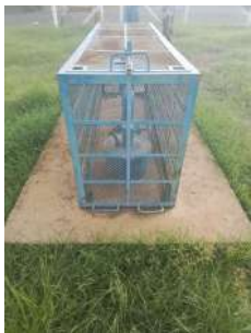
Foto 1 - Laje de proteção do poço.
