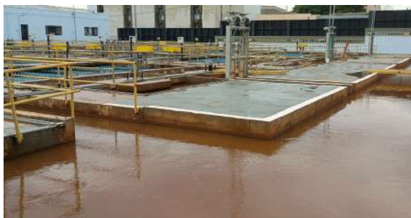
Foto 1 - Situação geral dos locais sem guarda-corpos ou com guarda-corpos inadequados.
