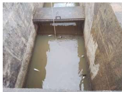
Foto 4 - Gradeamento novo.
