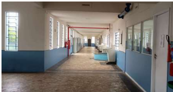
Foto 16 - Vista geral interna da ETA.
