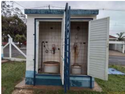
Foto 1 - Casa de química.
