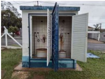
Foto 1 - Casa de química.
