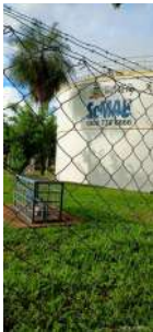
Foto 7 - Vista do poço e, ao fundo, novo reservatório apoiado, que ainda não está em operação.
