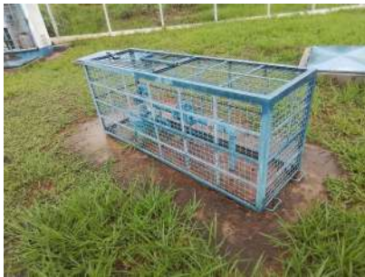
Foto 1 - Laje de proteção do poço.
