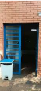
Foto 1 - Entrada da casa de bombas da elevatória.
