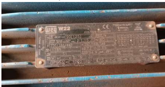
Foto 9 - Placa de especificações técnicas do motor do conjunto motobomba 1 Maceno.
