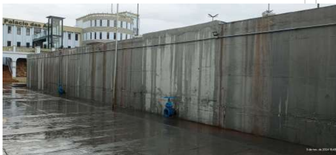
Foto 2 - Vista lateral do reservatório.
