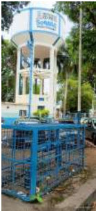
Foto 2 - Vista geral do poço e, ao fundo, do reservatório elevado Maceno.
