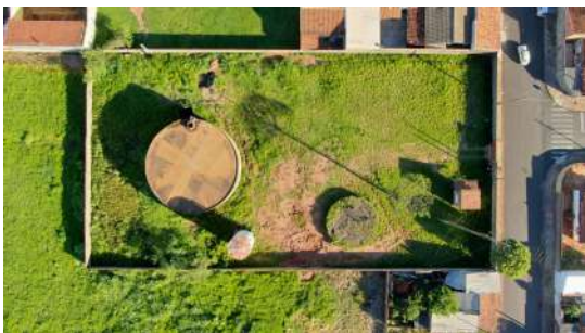
Foto 1 - Vista aérea do cercamento da área por muros.
