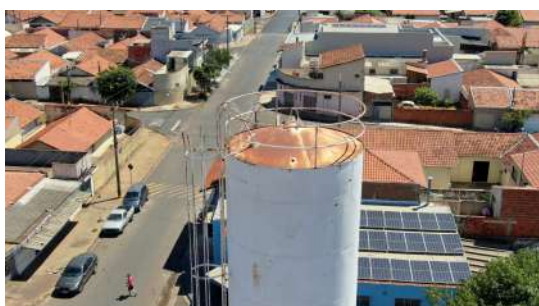
Foto 1 - Detalhe do guarda-corpos no topo do reservatório.
