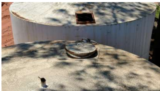
Foto 1 - Detalhe da tampa de inspeção no topo do reservatório.
