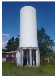
Foto 2 - Vista geral do reservatório.
