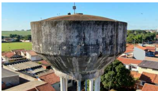
Foto 4 - Detalhe da estrutura de reservação.
