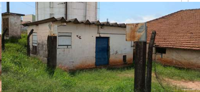
Foto 2 - Vista geral da EEAT.
