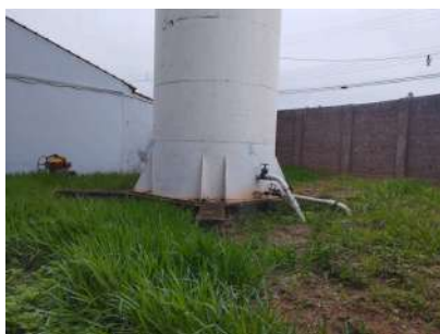
Foto 3 - Vista geral da base do reservatório.
