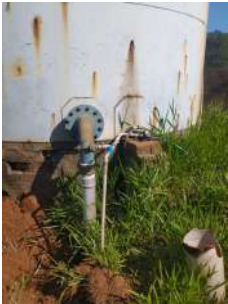
Foto 3 - Detalhe da tubulação de saída do reservatório.
