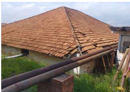
Foto 1 - Vista geral do telhado.
