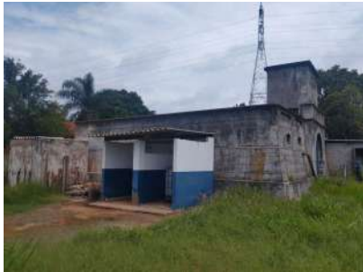
Foto 6 - Abrigo dos tanques e bombas dosadoras de cloro e flúor do subsistema "Captação Superficial do Campinho".
