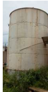
Foto 3 - Vista lateral do reservatório.
