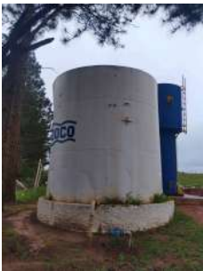
Foto 2 - Vista geral do Reservatório Ginásio de Esportes II (Metálico).
