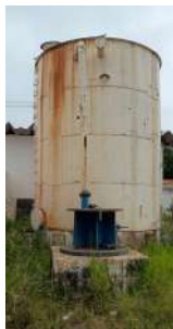
Foto 4 - Vista lateral do reservatório.
