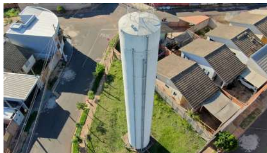
Foto 2 - Vista geral do reservatório.
