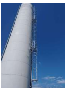
Foto 3 - Detalhe das escadas com guarda-corpos e plataformas com proteção.
