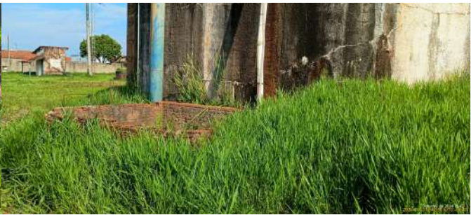
Foto 2 - Caixa de alvenaria ao lado do reservatório.
