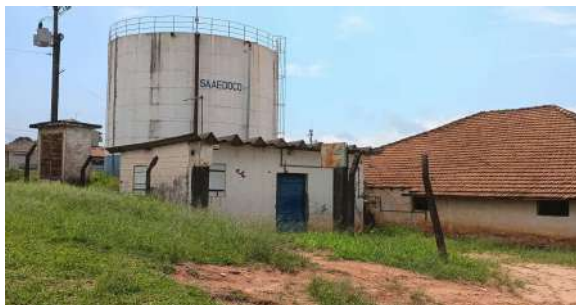
Foto 1 - Vista geral da área, com os reservatórios Filipão enterrado e apoiado (ao fundo) e EEAT (à frente)
