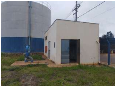
Foto 1 - Vista geral das estruturas do poço e edificação de apoio.
