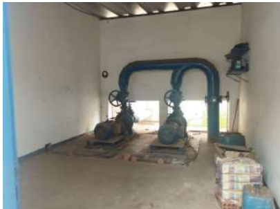
Foto 3 - Vista geral do interior da edificação.
