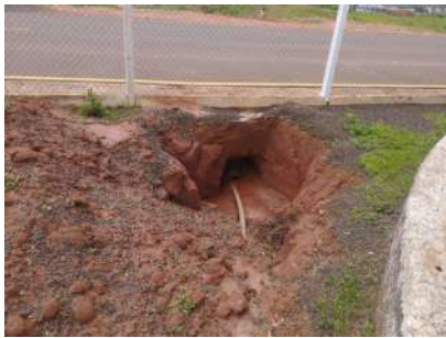
Foto 2 - Detalhe da vala.
