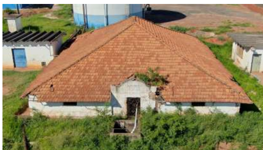
Foto 2 - Vista aérea do Reservatório.
