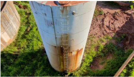
Foto 2 - Detalhe das escadas na parede do reservatório.
