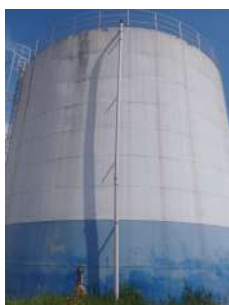
Foto 1 - Detalhe do tubo extravasor.
