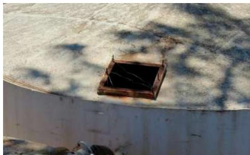
Foto 2 - Detalhe da abertura sem tampa.
