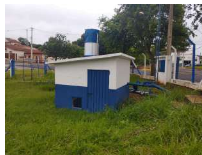
Foto 2 - Vista geral da edificação que abriga a estação elevatória
