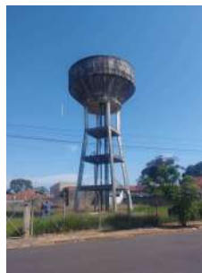
Foto 2 - Vista geral do reservatório a partir da Rua São Carlos.
