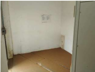
Foto 2 - Vista geral do interior da edificação.
