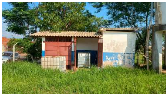
Foto 4 - Abrigo dos tanques e bombas dosadoras de cloro e flúor.
