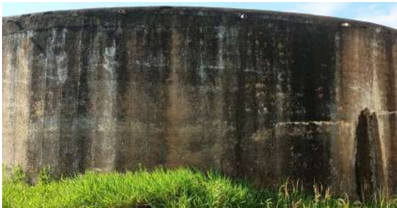
Foto 5 - Vista lateral do reservatório.
