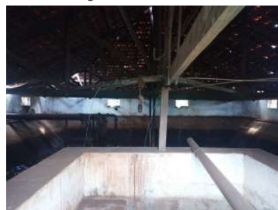
Foto 6 - Vista geral do interior do reservatório.
