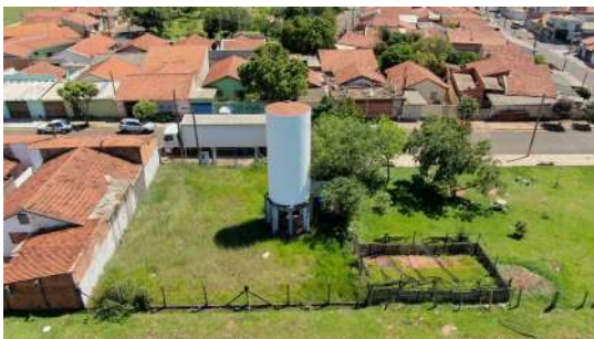
Foto 1 - Vista aérea do reservatório e entorno.
