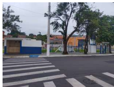
Foto 2 - Vista geral do cercamento da área a partir da Rua José Alves de Assis.
