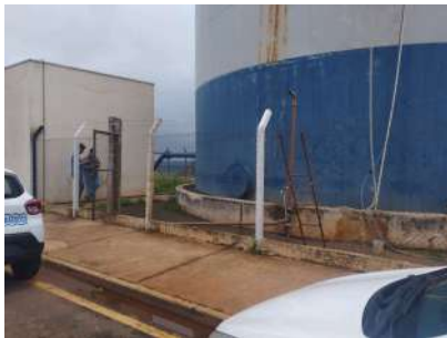
Foto 1 - Detalhe do cercamento e portão de acesso.
