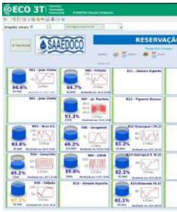
Foto 2 - Imagem do sistema de monitoramento dos níveis dos reservatórios. Este reservatório está identificado neste sistema como "R08 - Sangaletti".
