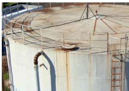
Foto 1 - Detalhe da tampa de inspeção no topo do reservatório.
