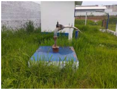
Foto 2 - Vista geral das estruturas do Poço CDHU.
