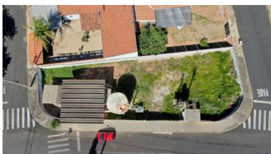
Foto 1 - Vista aérea mostrando o cercamento da área por muros.
