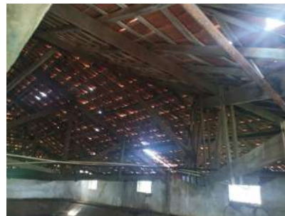
Foto 4 - Vista interna da estrutura do telhado.
