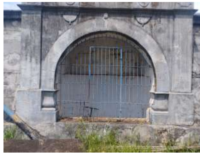
Foto 5 - Portão de acesso à antiga área de manobras de registros do reservatório.
