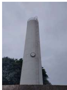
Foto 2 - Vista geral do reservatório a partir da Rua Eugênio Francisco Filho.
