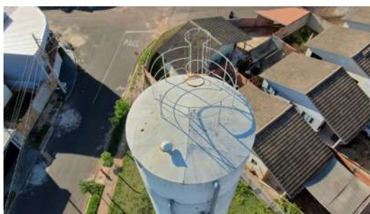
Foto 2 - Detalhe do guarda-corpos no topo do reservatório.
