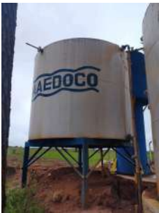
Foto 2 - Vista geral do Reservatório Balança.
