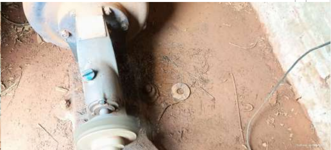
Foto 2 - Piso molhado devido à drenagem inadequada.
