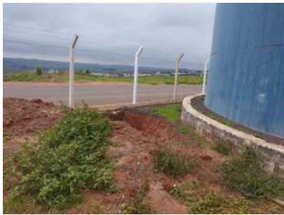
Foto 1 - Vala aberta entre a área do poço e do reservatório.
