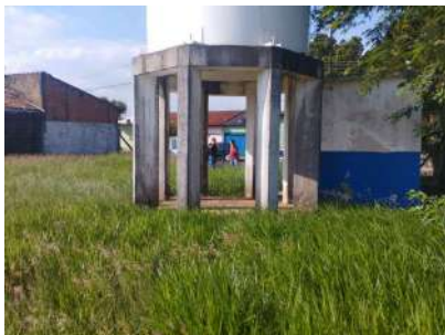
Foto 3 - Vista geral da base do reservatório.
