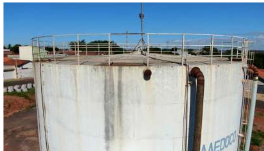
Foto 2 - Detalhe do guarda-corpos no topo do reservatório.
