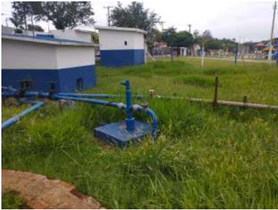
Foto 2 - Vista geral da estrutura do poço.
