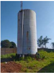
Foto 2 - Vista geral do reservatório apoiado metálico.
