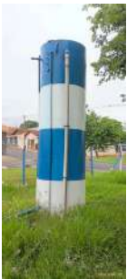
Foto 3 - Reservatório pulmão desativado.
