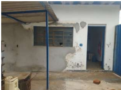
Foto 2 - Vista geral da edificação da elevatória.
