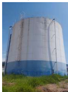
Foto 4 - Vista geral do reservatório.
