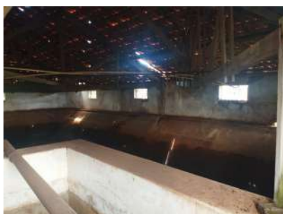
Foto 3 - Aberturas de ventilação vistas do interior do reservatório.
