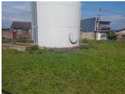
Foto 3 - Base do reservatório com tampa de inspeção.
