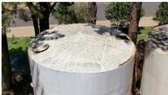
Foto 1 - Vista geral das duas aberturas no topo do reservatório.
