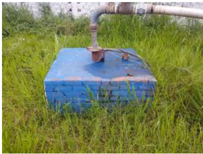
Foto 1 - Detalhe da laje de proteção.
