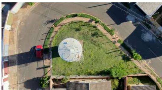
Foto 1 - Vista aérea do cercamento do terreno.
