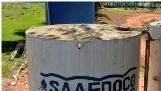
Foto 1 - Detalhe do tubo extravasor.
