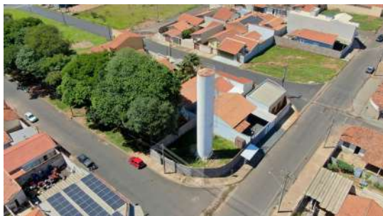
Foto 1 - Vista aérea do reservatório e entorno.
