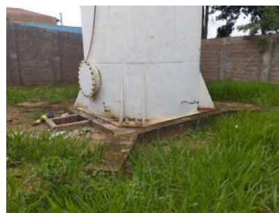
Foto 4 - Vista geral da base do reservatório.
