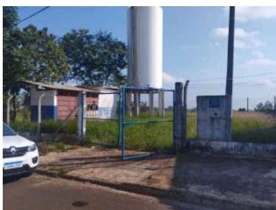
Foto 1 - Detalhe do cercamento e portão de acesso.
