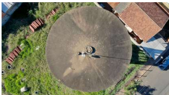
Foto 5 - Vista geral do topo do reservatório.
