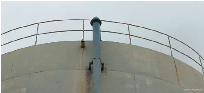
Foto 1 - Detalhe do tubo extravasor.
