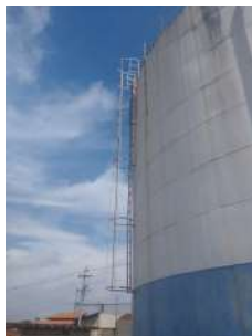
Foto 1 - Detalhe das escadas e guarda-corpos.
