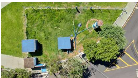
Foto 1 - Vista aérea mostrando o cercamento da área com alambrados.
