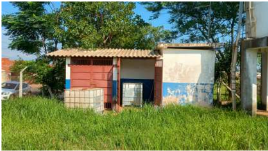
Foto 1 - Estrutura para abrigo dos taques e bombas dosadoras de cloro e flúor.
