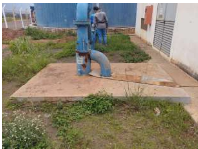
Foto 1 - Detalhe da laje de proteção do poço.
