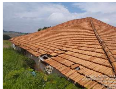
Foto 2 - Vista geral do telhado
