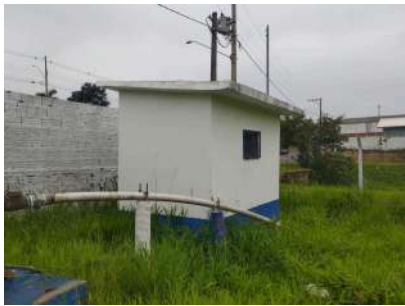
Foto 3 - Edificação de apoio ao lado do poço.
