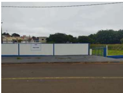
Foto 1 - Vista geral do cercamento da área.
