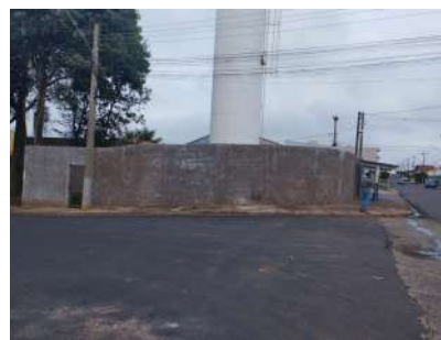
Foto 2 - Vista do cercamento da área a partir da Rua Eugênio Francisco Filho.
