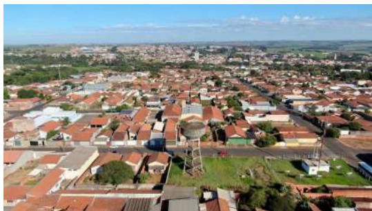
Foto 1 - Vista aérea do reservatório e entorno.
