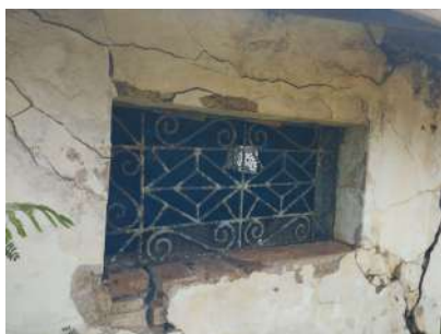
Foto 1 - Detalhe de uma das aberturas de ventilação do reservatório.
