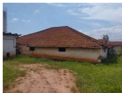
Foto 4 - Vista geral da lateral do reservatório.
