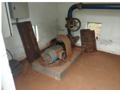
Foto 3 - Vista geral do interior da edificação.
