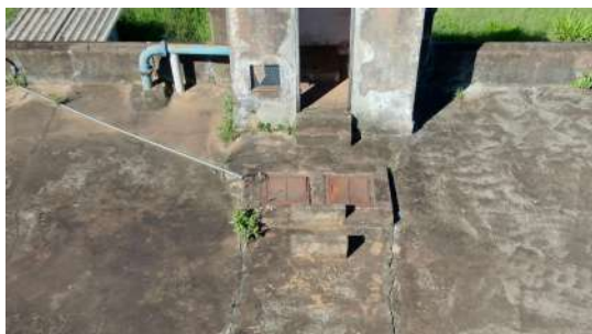
Foto 1 - Detalhe das tampas de inspeção no topo do reservatório.
