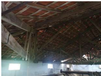
Foto 3 - Vista interna da estrutura do telhado.
