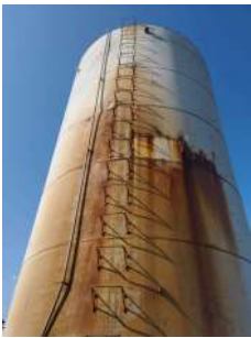
Foto 1 - Detalhe das escadas na parede do reservatório.
