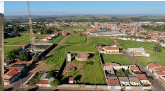
Foto 6 - Vista aérea dos subsistemas e entorno.
