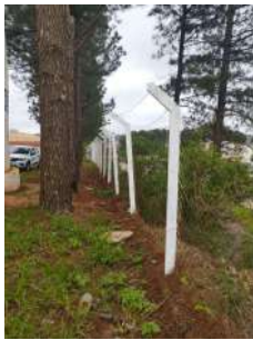
Foto 1 - Detalhe do cercamento da área por alambrados.
