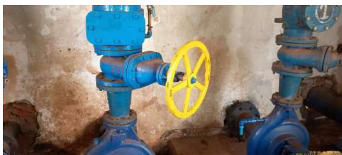
Foto 1 - Registro da tubulação de recalque da bomba 3 (contando da entrada).
