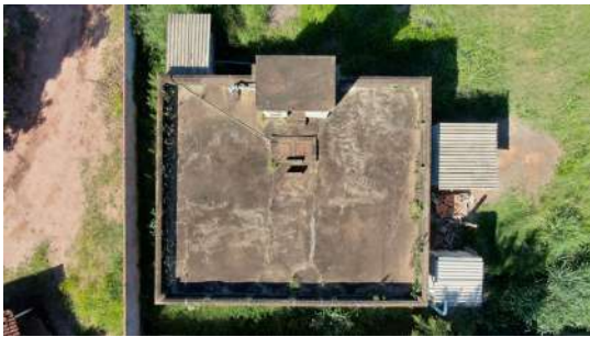
Foto 4 - Vista aérea do topo do reservatório.
