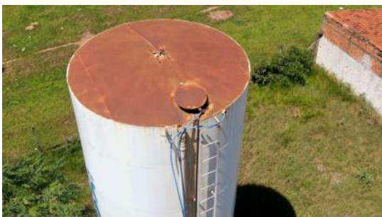
Foto 5 - Mangueiras para aplicação de cloro e flúor no interior do reservatório.
