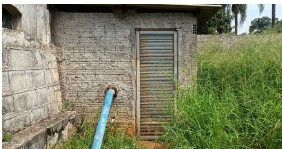
Foto 3 - Detalhe da edificação que abriga a elevatória.
