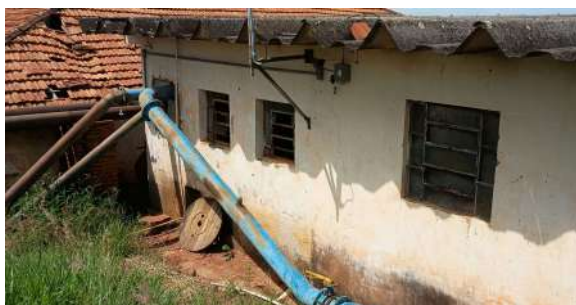
Foto 4 - Vista dos fundos da EEAT, com detalhe para as tubulações de recalque.
