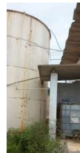
Foto 5 - Vista lateral do reservatório.
