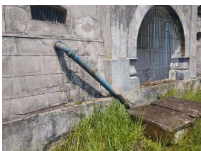
Foto 1 - Detalhe do tubo extravasor.
