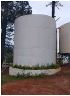
Foto 3 - Vista geral do Reservatório Ginásio de Esportes II (Metálico).
