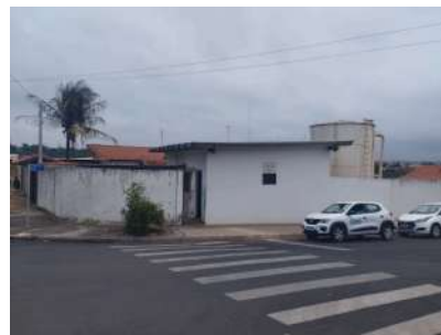
Foto 2 - Vista do cercamento da área a partir da Rua Mineiros do Tietê.
