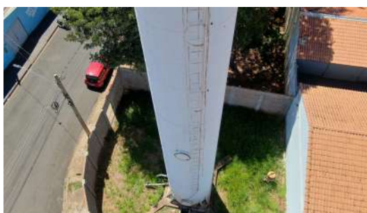
Foto 2 - Detalhe da escada e guarda-corpos para acesso ao topo do reservatório.
