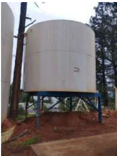
Foto 3 - Vista geral do Reservatório Balança.
