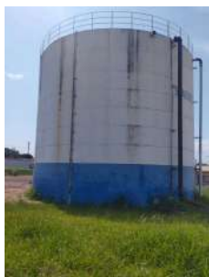
Foto 3 - Vista geral do reservatório.
