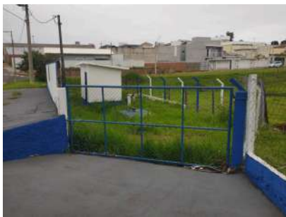
Foto 2 - Portão de acesso à área.
