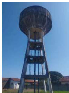
Foto 3 - Vista geral do reservatório.
