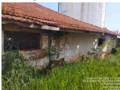
Foto 5 - Vista geral da lateral do reservatório.
