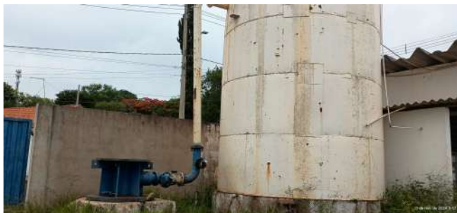
Foto 6 - Vista do reservatório e do poço.
