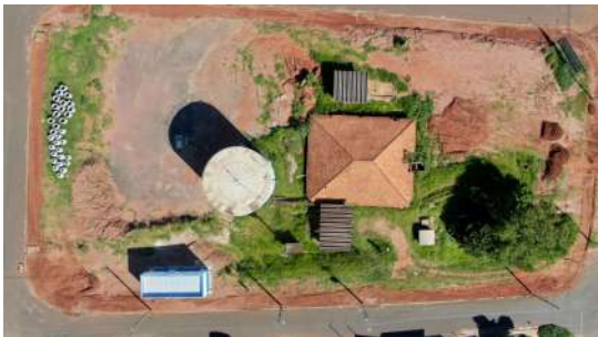
Foto 1 - Vista área do local - terreno sem cercamento.
