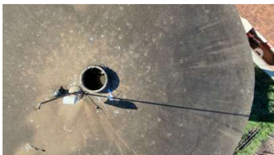
Foto 3 - Detalhe da escada de acesso ao topo do reservatório. O acesso ao topo se dá por meio de abertura localizada no centro da estrutura reservação.
