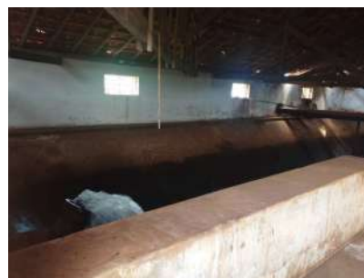
Foto 2 - Aberturas de ventilação vistas do interior do reservatório.
