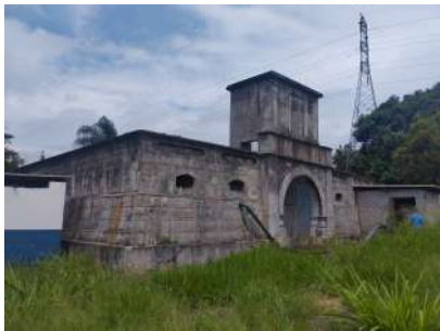
Foto 3 - Vista geral do reservatório.
