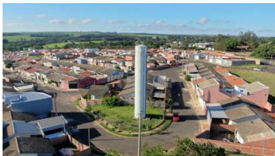
Foto 1 - Vista aérea do reservatório e entorno.
