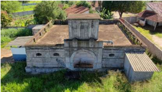
Foto 2 - Vista geral do reservatório.
