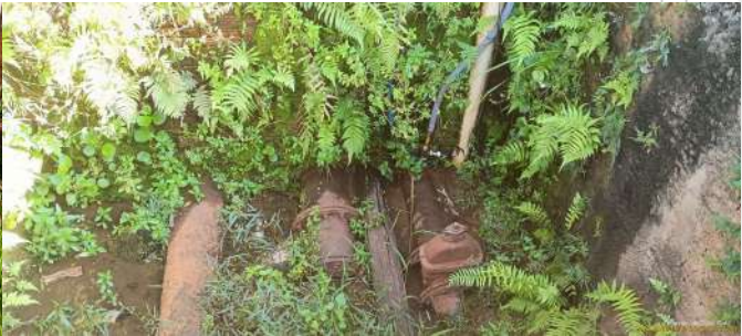
Foto 4 - Vista interna da caixa de alvenaria.
