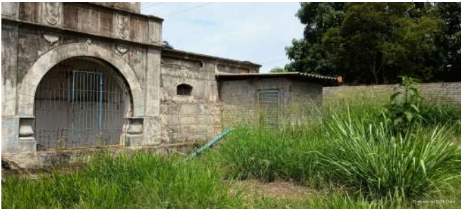
Foto 2 - Vista geral da edificação que abriga a elevatória, localizada junto ao reservatório.
