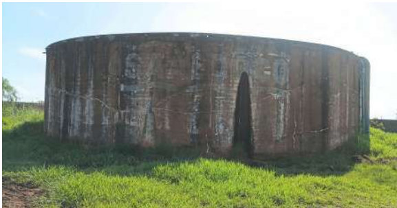
Foto 3 - Vista lateral do reservatório.
