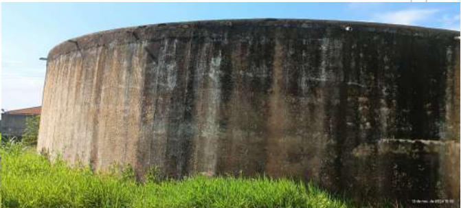
Foto 4 - Vista lateral do reservatório.
