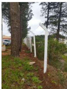
Foto 1 - Detalhe do cercamento da área por alambrados.
