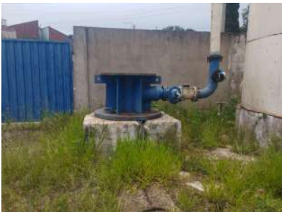
Foto 2 - Vista geral das estruturas do poço.
