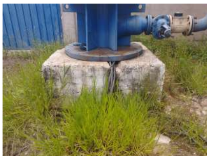
Foto 1 - Detalhe da laje de proteção.
