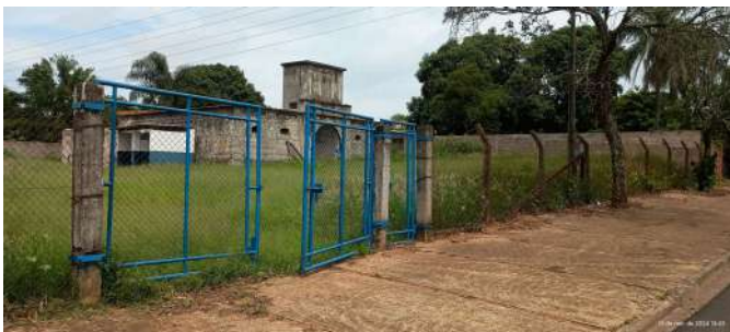
Foto 1 - Vista geral do cercamento da área a partir da Av. Leo Guaraldo.
