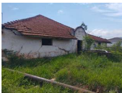
Foto 3 - Vista geral da fachada do reservatório.
