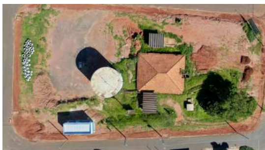
Foto 1 - Vista área do local - terreno sem cercamento.
