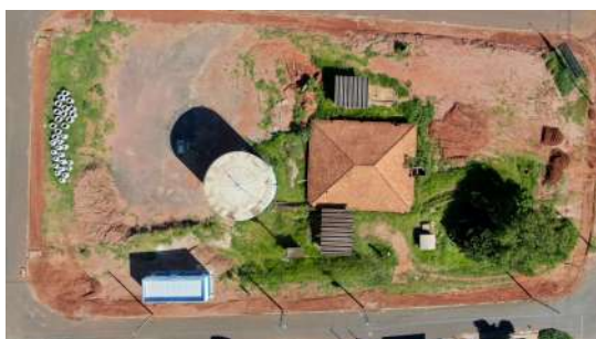
Foto 1 - Vista aérea do local - terreno sem cercamento.
