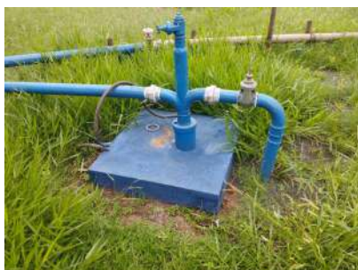
Foto 1 - Detalhe da laje de proteção do poço.
