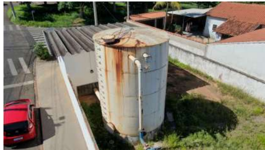
Foto 2 - Vista geral do reservatório.
