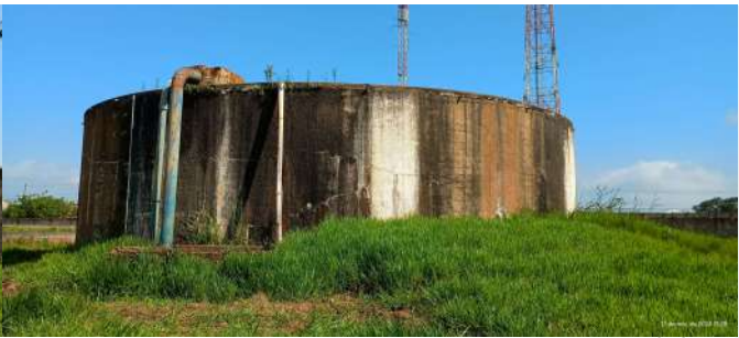
Foto 2 - Vista lateral do reservatório.
