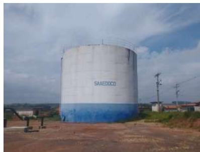
Foto 2 - Vista geral do reservatório.
