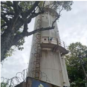
Foto 1 - Visão geral - Reservatório elevado Vila Georgina Cohab
