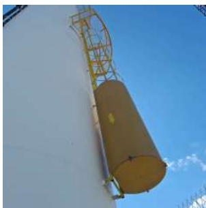
Foto 1 - Escada com guarda-corpos e área de descanso - Reservatório Artesano Elevado.
