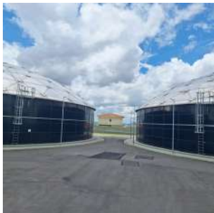
Foto 1 - CRD Campo Grande - Reservatórios semienterrado B e C
