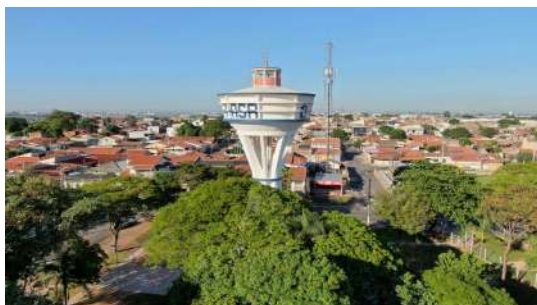
Foto 1 - Presença de para-raios - Res Nova Aparecida Elevado
