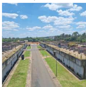
Foto 14 - Visão geral - reatores UASB - lado direito com aplicação de neutralizadores de odor
