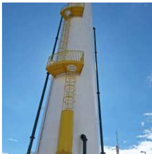
Foto 1 - Escada com guarda-corpos e áreas de descanso - Reservatório Elevado Vista Campinas.
