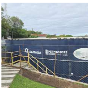
Foto 1 - Visão geral - Reservatório Apoiado B -
