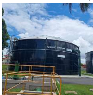
Foto 4 - Reservatório Apoiado B - Norte Sul - Visão Geral
