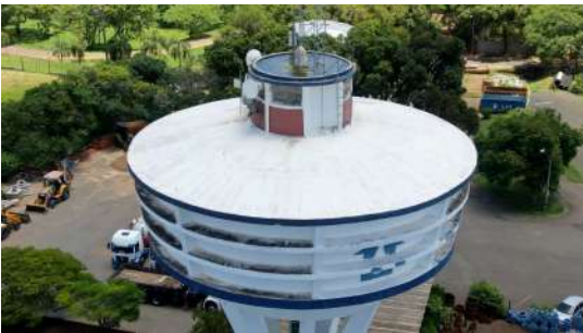
Foto 2 - Cobertura - Res Paranapanema Elevado
