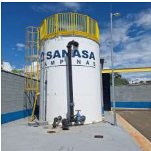
Foto 1 - Reservatório Apoiado Artesano - visão geral
