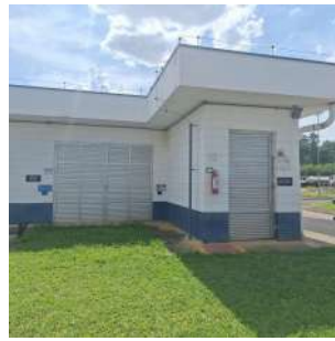
Foto 9 - Subestação da ETE Samambaia
