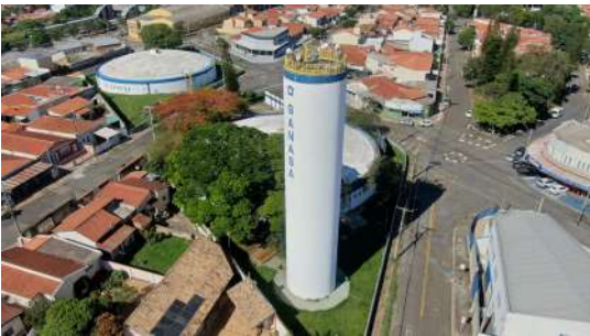
Foto 1 - Visão geral - Res Eulina Elevado
