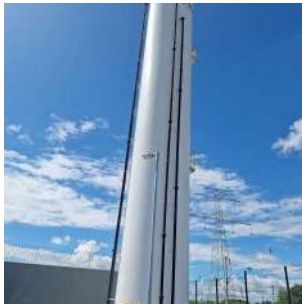
Foto 1 - Visão geral - Reservatório Artesano Elevado
