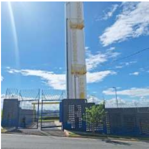
Foto 1 - Visão geral - Reservatório Elevado Vista Campinas
