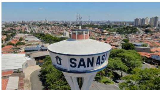
Foto 1 - Para-raios - Res Vila Georgina Elevado
