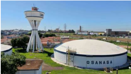
Foto 1 - Visão geral - Res São Bernardo Elevado
