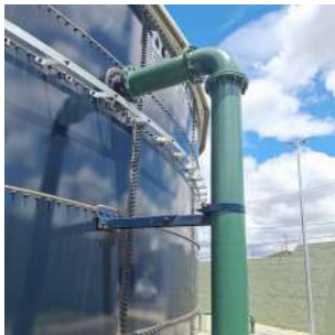
Foto 1 - Tubo extravasor - Reservatório Semienterrado C - DIC V
