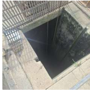
Foto 2 - Poço de sucção da elevatória de esgoto da ETE
