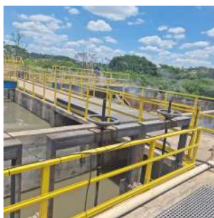
Foto 7 - Névoas - Inibidor de odor aplicado ao longo da ETE Anhumas
