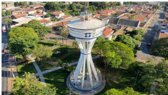
Foto 1 - Visão geral - Res Nova Aparecida Elevado
