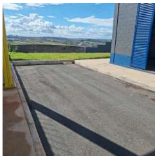
Foto 1 - Cercamento por muro e contenção por arame farpado
