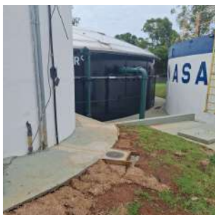
Foto 1 - Tubo extravasor - Reservatório semienterrado B
