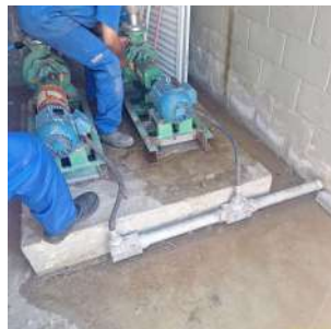
Foto 2 - Reparo do vazamento - gaxetas
