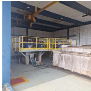
Foto 13 - Centrifugas - desidratação do lodo
