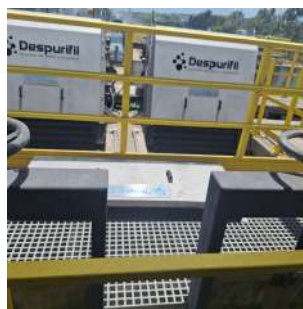
Foto 8 - Peneiras gradeamento fino - 3 mm
