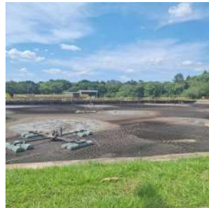
Foto 11 - Sistema de lodos ativados - tanque de aeração
