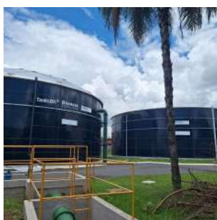
Foto 3 - CRD NORTE SUL -Reservatório Apoiado B à esquerda
