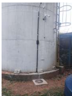
Foto 3 - Instalação do cabo de para-raios concluída. Fonte: SANASA.
