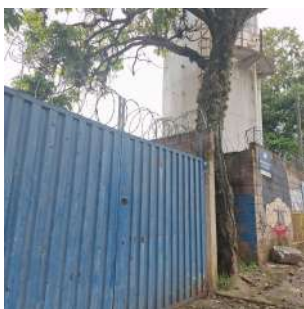
Foto 1 - Portão e muro sem identificação
