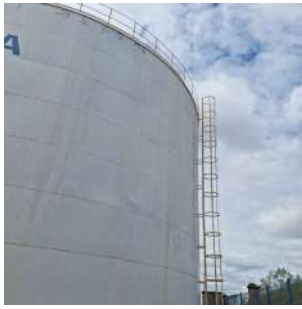
Foto 1 - Escada com guarda-corpos - Reservatório Swiss Park Apoiado
