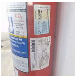
Foto 2 - Validade regular do extintor.
