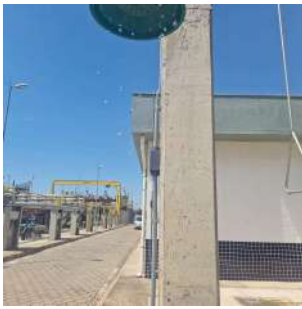
Foto 3 - Chuveiro de emergência funcionando
