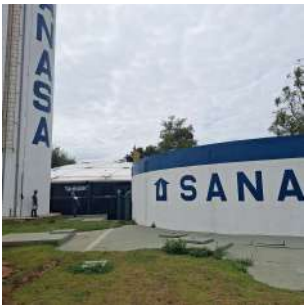
Foto 1 - Visão geral - CRD Jambeiro - Reservatório semienterrado B ao centro
