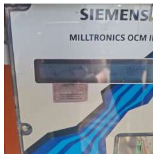
Foto 2 - Leitor do macromedidor de saída.
