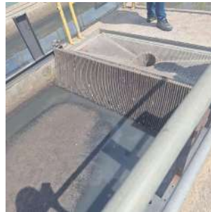
Foto 4 - Gradeamento - tratamento preliminar
