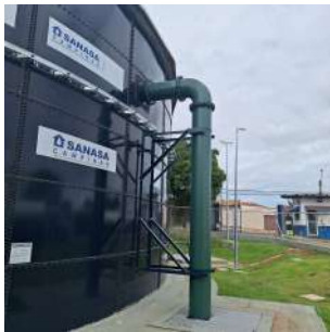
Foto 1 - Tubo extravasor - Reservatório apoiado B - Nova Europa
