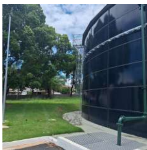
Foto 1 - Escada com gurada-corpos à lateral do Reservatório Apoiado B - Norte Sul
