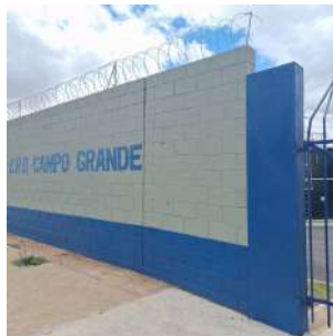
Foto 2 - CRD Campo Grande - Fachada - Reservatórios B e C - Campo Grande
