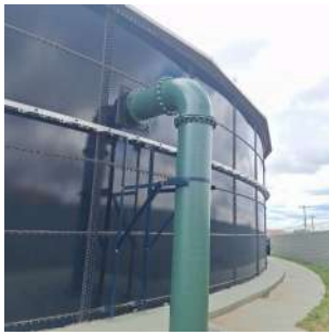
Foto 1 - Extravasor - Reservatório Campo Grande Semienterrado C
