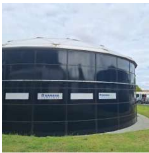
Foto 1 - Visão Geral - Reservatório apoiado B - Nova Europa
