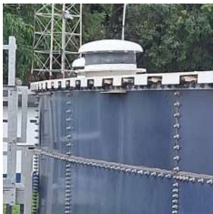
Foto 1 - Ventilação do Reservatório Apoiado B - São Vicente
