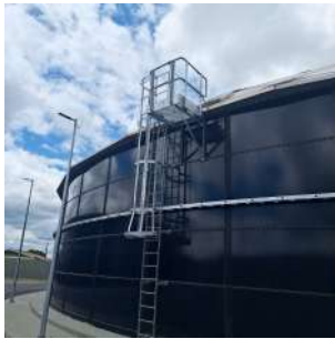
Foto 1 - Escada com guarda-corpos - Reservatório Campo Grande Semienterrado C
