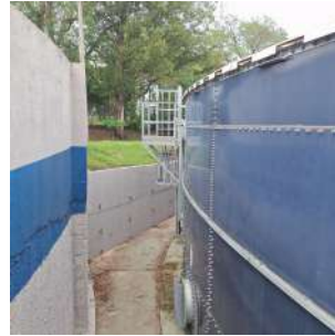
Foto 2 - Escada com guarda-corpos - Reservatório Apoiado B - São Vicente
