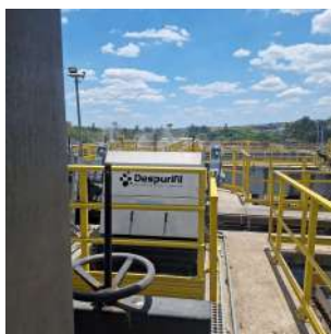
Foto 10 - Peneiras gradeamento fino - 3 mm
