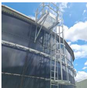
Foto 1 - Escada com guarda-corpos - Reservatório Semienterrado C - DIC V
