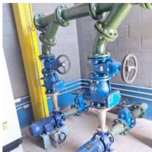
Foto 1 - Dois conjuntos motobomba instalados.
