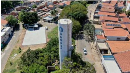
Foto 3 - Visão geral aérea - Reservatório elevado Vila Georgina Cohab
