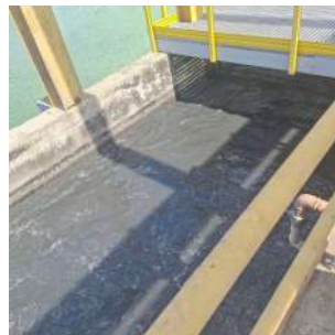
Foto 5 - Caixa de areia - tratamento preliminar
