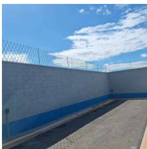
Foto 1 - Cercamento - Reservatório Artesano Elevado
