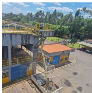
Foto 11 - Remoção de areia do tratamento preliminar
