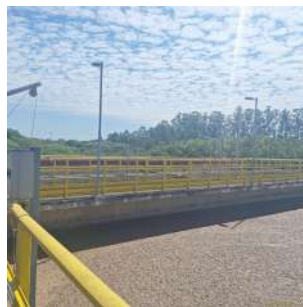
Foto 2 - Guarda-corpos sobre reator biológico
