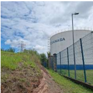
Foto 1 - Visão geral - Reservatório Swiss Park Apoiado
