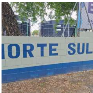
Foto 1 - CRD NORTE SUL - fachada
