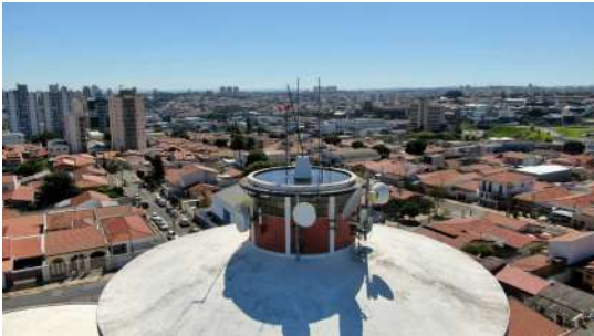
Foto 2 - Cobertura - Res São Bernardo Elevado
