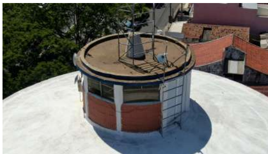
Foto 2 - Cobertura - Res Vila Georgina Elevado
