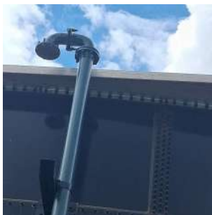
Foto 1 - Tela de proteção na tubulação de ventilação e sob a junção da cobertura do reservatório
