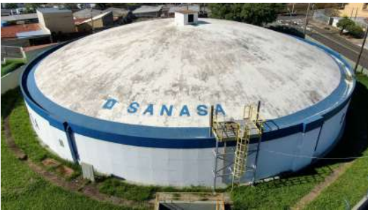
Foto 1 - Visão geral - Res Eulina Semienterrado Circular B
