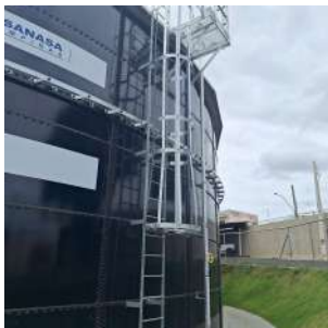
Foto 1 - Escada com guarda-corpos - Reservatório apoiado B - Nova Europa
