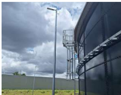
Foto 1 - Escada com guarda-corpos - Reservatório semienterrado B
