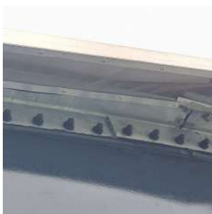
Foto 1 - Tela de proteção sob a cobertura do Reservatório semienterrado B
