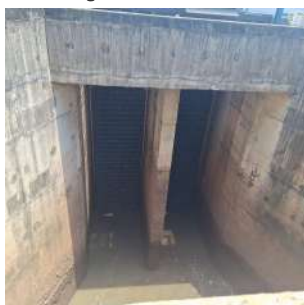
Foto 5 - Gradeamento - Elevatória
