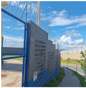
Foto 1 - Área devidamente cercada por muro e arame farpado
