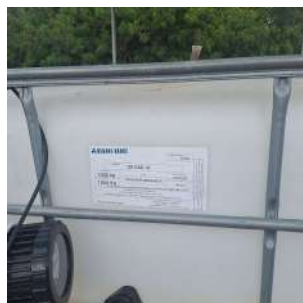
Foto 20 - Tanque com antiespumante
