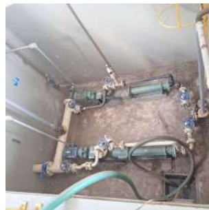
Foto 15 - Bomba de lodo_ envio para a centrífuga
