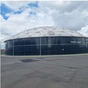
Foto 1 - Visão geral - Reservatório Campo Grande Semienterrado C
