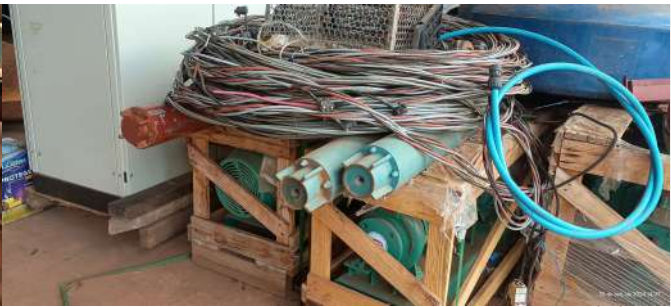
Foto 2 - Bombas em estoque.
