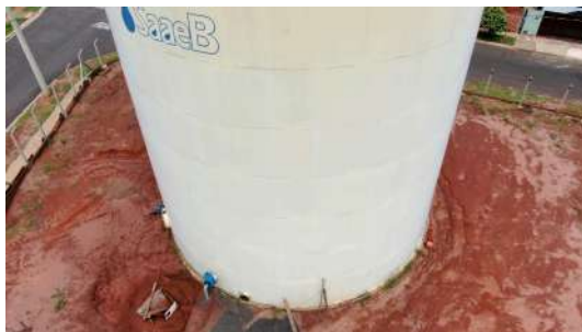
Foto 5 - Vista lateral do reservatório apoiado.
