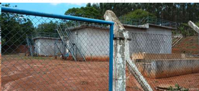
Foto 4 - Portão e cercamento da ETE.
