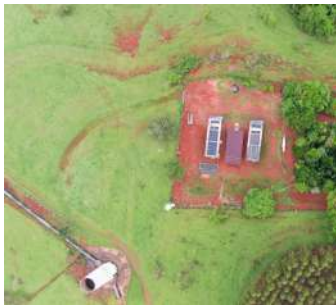
Foto 28 - Vista aérea da área da ETE Patrimônio.
