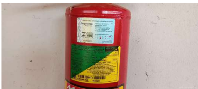
Foto 1 - Validade do extintor de incêndio.
