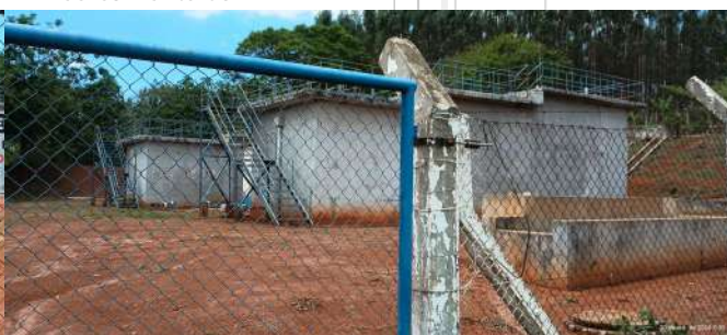
Foto 4 - Portão e cercamento da ETE.
