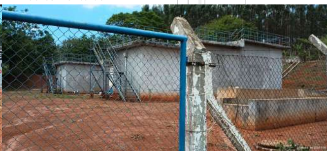
Foto 4 - Portão e cercamento da ETE.
