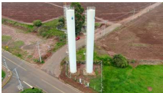
Foto 8 - Vista aérea dos dois reservatórios elevados, sendo o desta ficha o reservatório da direita.
