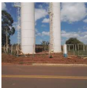
Foto 1 - Vista frontal do conjunto de reservatórios metálicos. O reservatório desta ficha é o da esquerda.
