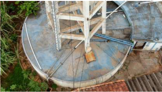
Foto 5 - Vista aérea da cobertura de um dos reservatórios semienterrados.
