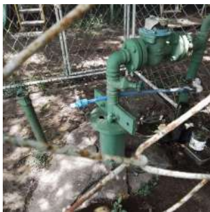
Foto 1 - Tubo de medição de nível do poço.
