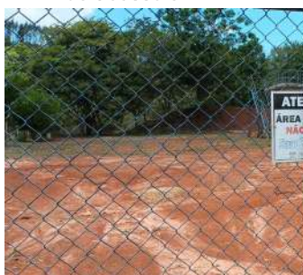
Foto 3 - Portão e cercamento da ETE.
