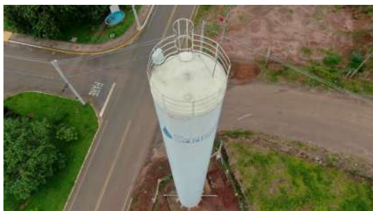
Foto 8 - Vista aérea da cobertura do reservatório.
