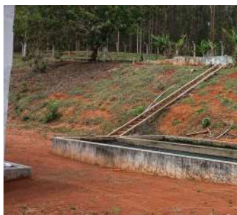
Foto 5 - Talude interno na ETE, sendo a chegada do esgoto bruto na parte superior.
