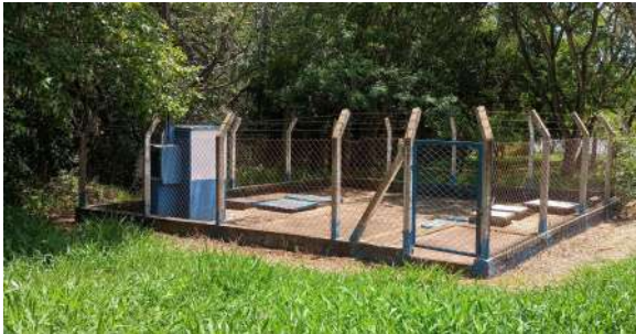
Foto 1 - Vista geral externa da EEE.
