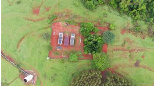
Foto 28 - Vista aérea da área da ETE Patrimônio.
