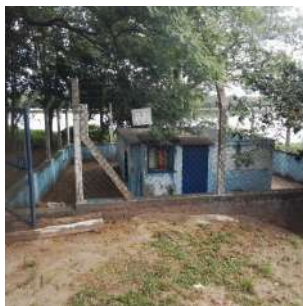
Foto 2 - Vista externa da EEEB.
