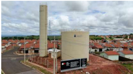
Foto 1 - Vista geral aérea do reservatório elevado e do apoiado Jd. Santa Maria.
