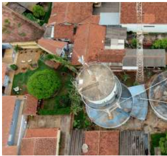
Foto 1 - Vista aérea das coberturas dos reservatórios elevado e semienterrados Polícia Militar.
