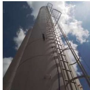
Foto 2 - Descida do cabeamento do SPDA na lateral da escada..
