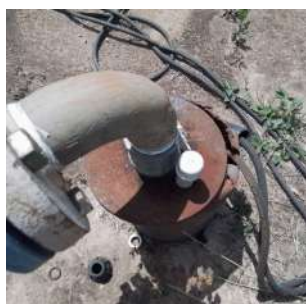
Foto 1 - Tubo de medição de nível
