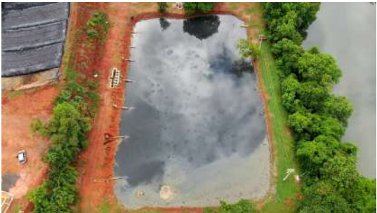
Foto 6 - Vista aérea da lagoa central dentre as 3 lagoas iniciais de tratamento.
