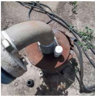
Foto 1 - Tubo de medição de nível
