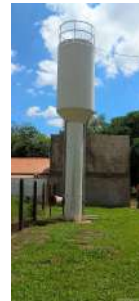
Foto 2 - Reservatório de transição (entre poços e EEAT).
