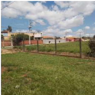
Foto 1 - Cercamento do entorno.
