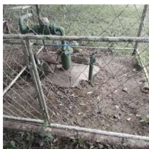
Foto 1 - Situação da laje de proteção.
