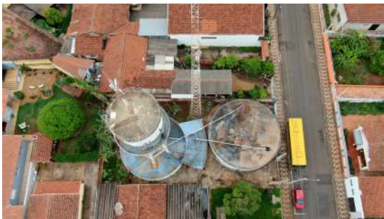
Foto 1 - Vista aérea das coberturas dos reservatórios elevado e semienterrados Polícia Militar.
