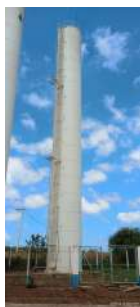
Foto 2 - Reservatório elevado II.
