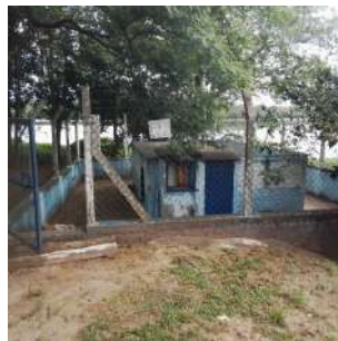
Foto 2 - Vista externa da EEEB.
