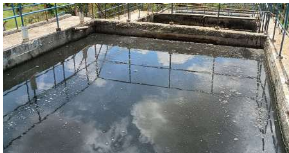
Foto 20 - Vista da parte superior de um dos módulos de tratamento.
