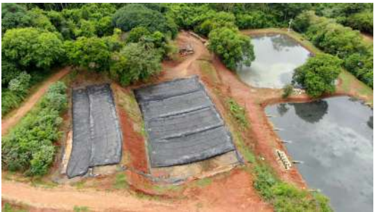
Foto 4 - Geobags ao lado das lagoas de tratamento, utilizados para adensamento do lodo removido das lagoas.
