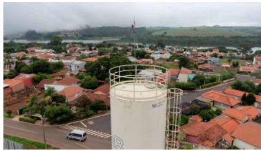
Foto 2 - Guarda corpo na cobertura do reservatório.
