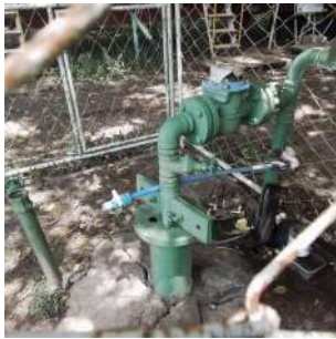
Foto 1 - Torneira para para coleta de água bruta.
