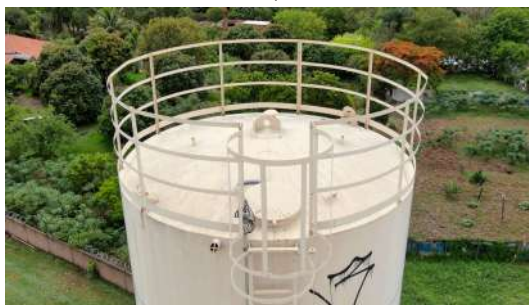
Foto 3 - Vista aérea da cobertura do reservatório novo (amarelo).
