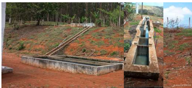
Foto 5 - Talude interno na ETE, sendo a chegada do esgoto bruto na parte superior.
