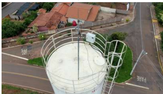
Foto 9 - Vista aérea da cobertura do reservatório.
