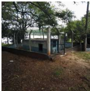
Foto 1 - Vista externa da EEEB.
