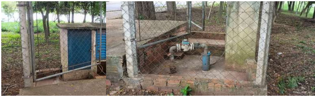
Foto 1 - Vista geral externa do poço. Foto 2 - Vista geral externa do poço.
