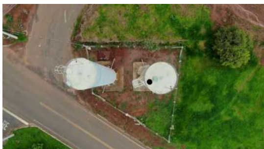
Foto 9 - Vista aérea dos dois reservatórios, sendo o da direita o reservatório desta ficha.
