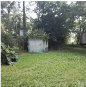
Foto 1 - Vista do abrigo dos painéis.
