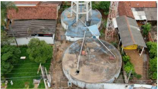
Foto 3 - Vista dos reservatórios semienterrados.
