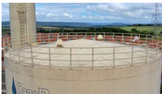
Foto 3 - Vista aérea da cobertura do reservatório apoiado.
