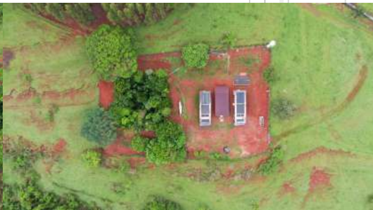
Foto 29 - Vista aérea da área da ETE Patrimônio.
