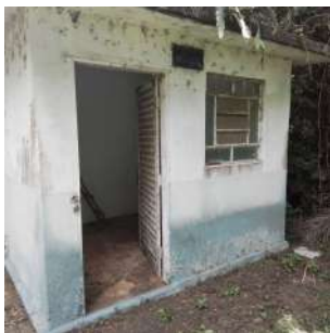
Foto 4 - Fachada do abrigo.
