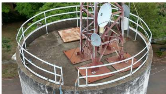
Foto 3 - Vista aérea da cobertura do reservatório elevado.
