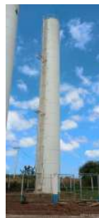
Foto 2 - Reservatório elevado II.
