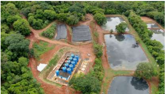
Foto 2 - Vista aérea geral da ETE Cidade.
