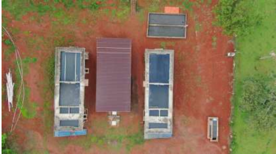
Foto 30 - Vista aérea da área da ETE Patrimônio.
