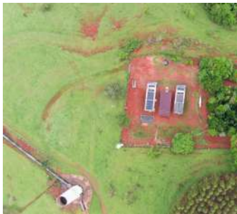
Foto 28 - Vista aérea da área da ETE Patrimônio.
