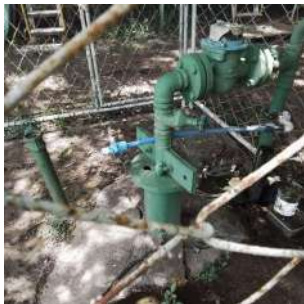
Foto 1 - Tubo de medição de nível do poço.
