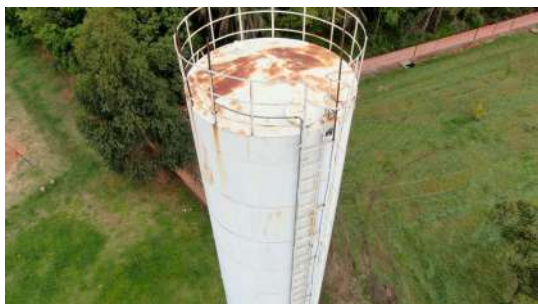
Foto 6 - Vista aérea da lateral do reservatório antigo (branco).
