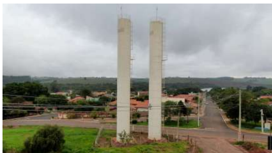
Foto 7 - Vista aérea dos dois reservatórios elevados, sendo o reservatório desta ficha o da esquerda.
