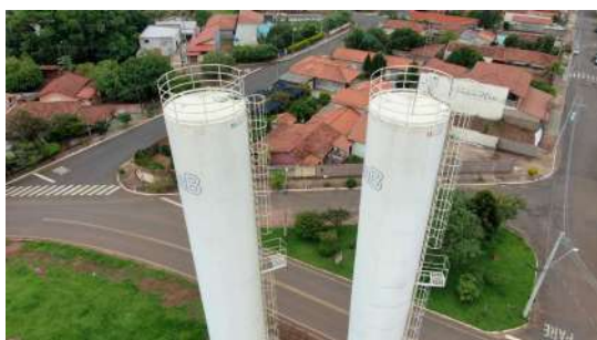
Foto 1 - Vista aérea dos reservatórios.
