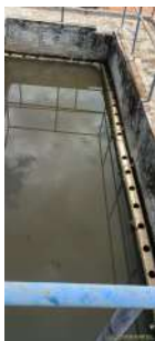
Foto 3 - Calhas e tubos desalinhados.
