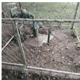
Foto 1 - Situação da laje de proteção.
