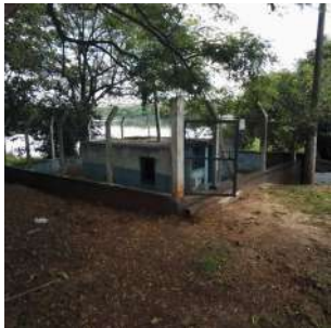
Foto 1 - Vista externa da EEEB.
