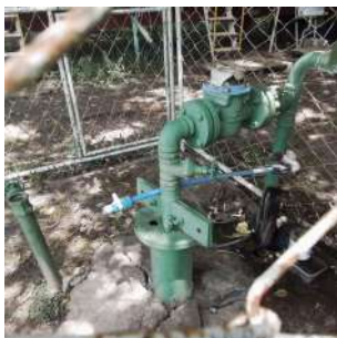
Foto 1 - Torneira para para coleta de água bruta.
