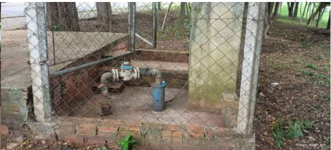
Foto 2 - Vista geral externa do poço.
