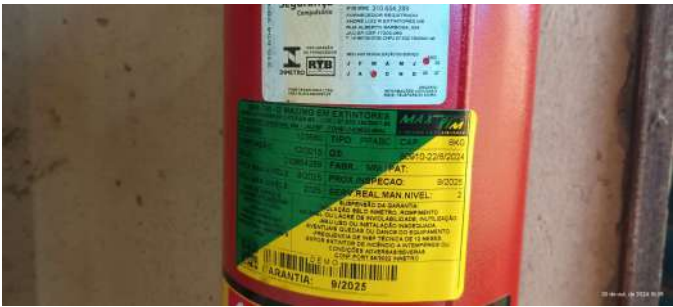
Foto 1 - Validade do extintor.
