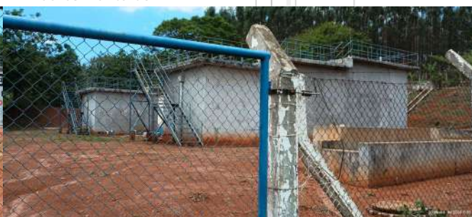
Foto 4 - Portão e cercamento da ETE.
