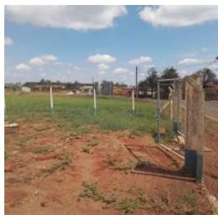
Foto 1 - Cercamento no perímetro.
