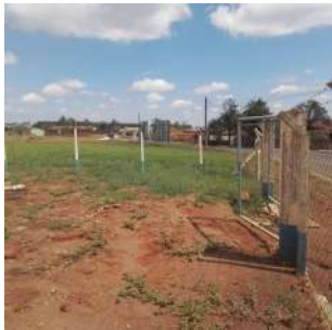
Foto 1 - Cercamento no perímetro.
