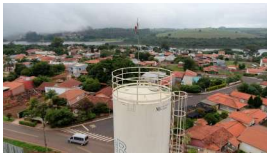
Foto 2 - Guarda corpo na cobertura do reservatório.
