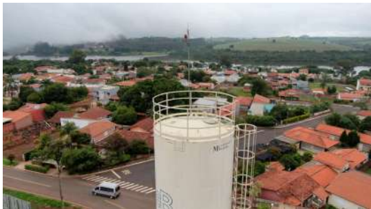
Foto 3 - Haste de captação do SPDA.
