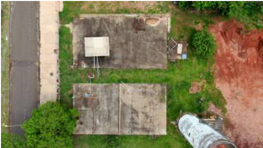
Foto 2 - Vista aérea do reservatório elevado e da laje dos reservatórios enterrados.
