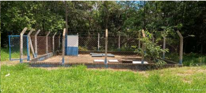
Foto 2 - Vista geral externa da EEE.
