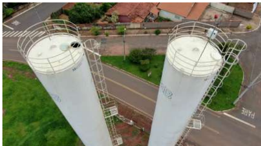
Foto 3 - Haste de captação do SPDA (reservatório da direita).
