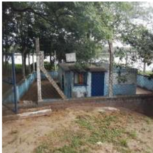
Foto 2 - Vista externa da EEEB.
