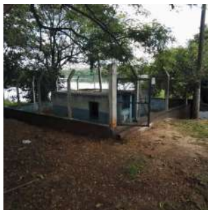
Foto 1 - Vista externa da EEEB.
