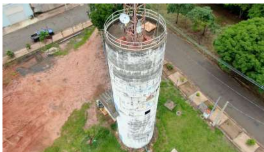
Foto 6 - Vista aérea lateral do reservatório elevado.
