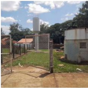
Foto 1 - Entrada do recinto em que se encontra o poço.
