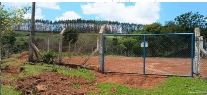
Foto 2 - Portão e cercamento da ETE.
