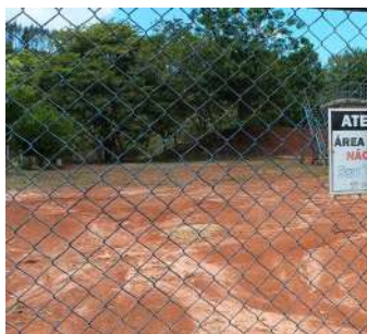
Foto 3 - Portão e cercamento da ETE.
