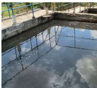
Foto 20 - Vista da parte superior de um dos módulos de tratamento.
