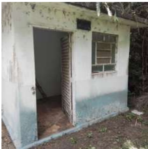
Foto 4 - Fachada do abrigo.
