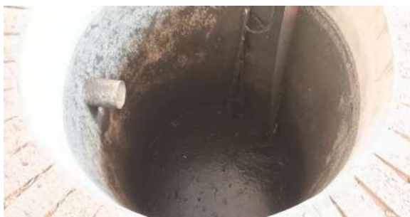
Foto 11 - Um dos poços de acúmulo de lodo para posterior recirculação.
