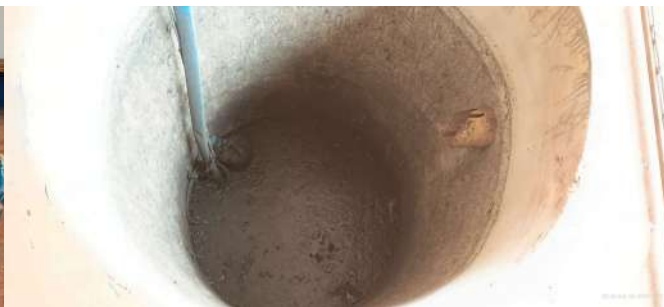
Foto 10 - Um dos poços de acúmulo de lodo para posterior recirculação.
