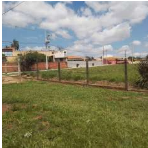
Foto 1 - Cercamento do entorno.
