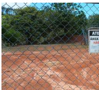
Foto 3 - Portão e cercamento da ETE.
