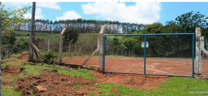
Foto 2 - Portão e cercamento da ETE.
