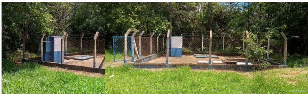
Foto 1 - Vista geral externa da EEE.
