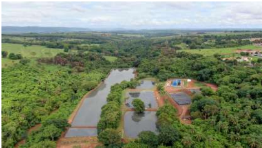
Foto 1 - Vista aérea geral da ETE Cidade.
