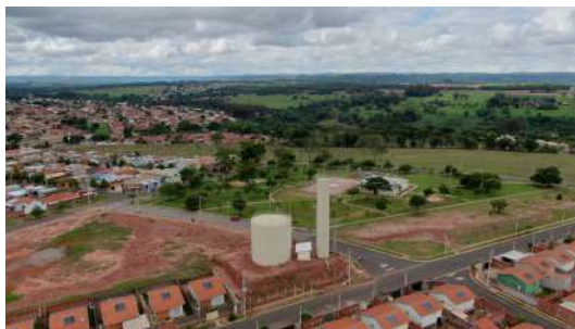
Foto 3 - Vista geral aérea do reservatório elevado e do apoiado Jd. Santa Maria.
