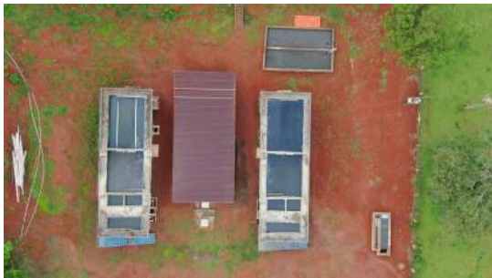
Foto 30 - Vista aérea da área da ETE Patrimônio.
