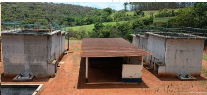
Foto 8 - Vista dos dois módulos de tratamento da ETE.
