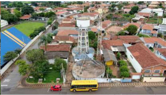
Foto 2 - Vista aérea dos reservatórios elevado e semienterrados.
