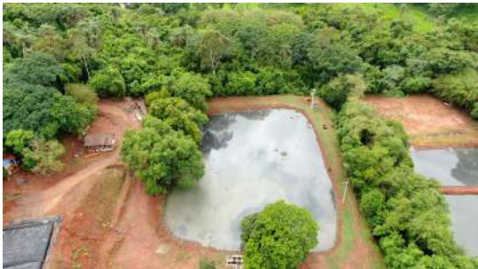
Foto 5 - Vista aérea da primeira entre as 3 lagoas iniciais de tratamento.
