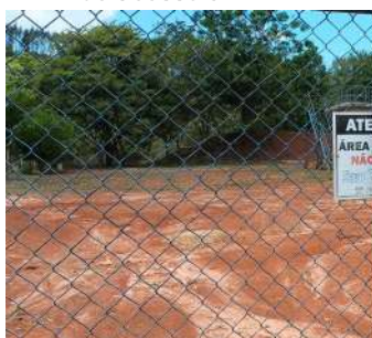
Foto 3 - Portão e cercamento da ETE.
