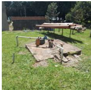
Foto 1 - Situação da laje de proteção.
