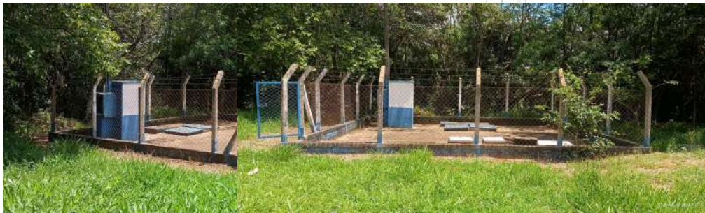
Foto 1 - Vista geral externa da EEE. Foto 2 - Vista geral externa da EEE.
