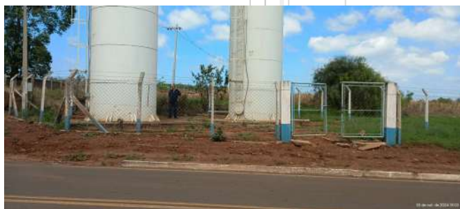
Foto 3 - Vista da área dos reservatórios.
