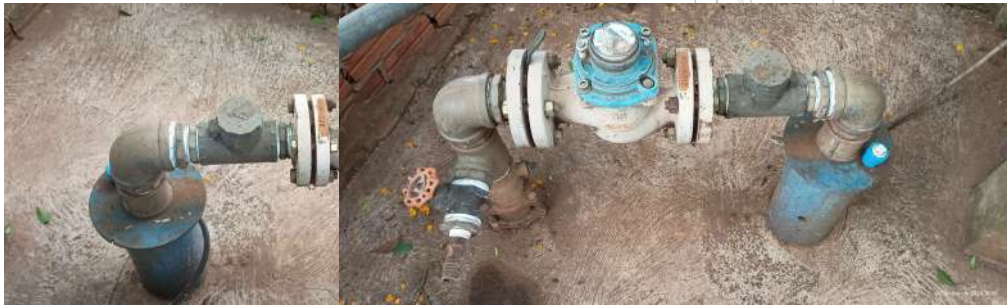
Foto 3 - Vista geral do cavalete do poço. Foto 4 - Vista geral do cavalete do poço.
