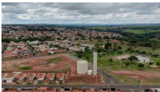
Foto 6 - Vista aérea dos dois reservatórios do Jd. Santa Maria.
