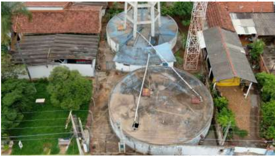
Foto 3 - Vista dos reservatórios semienterrados.
