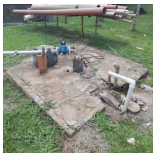
Foto 1 - Situação da laje de proteção.
