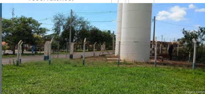
Foto 5 - Vista da área dos reservatórios.
