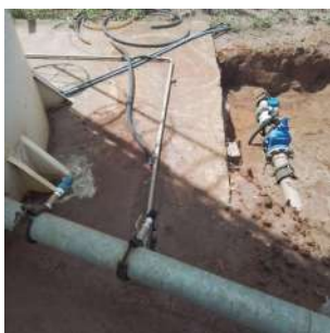
Foto 1 - Transmissor de nível para telemetria.
