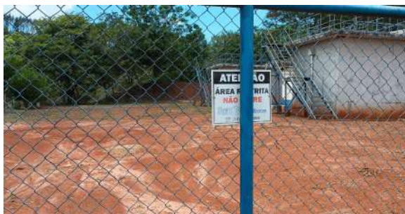
Foto 3 - Portão e cercamento da ETE.
