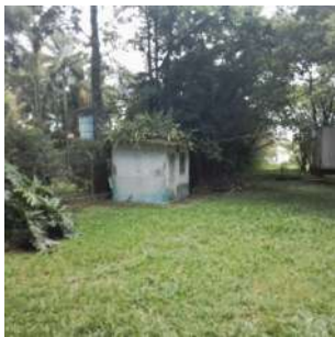
Foto 1 - Vista do abrigo dos painéis.
