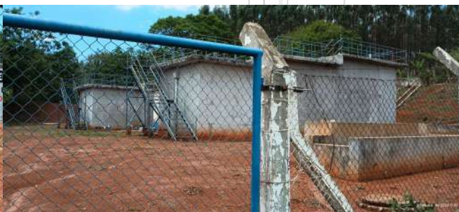
Foto 4 - Portão e cercamento da ETE.
