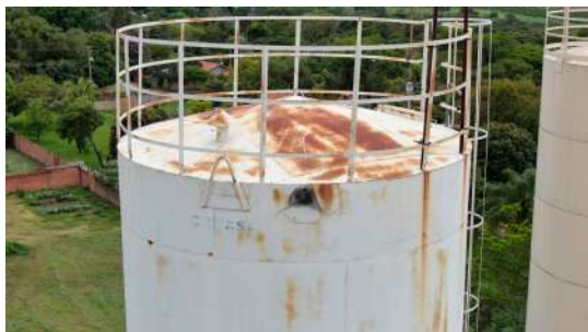
Foto 1 - Tela de proteção em tubo extravasador do reservatório na cor branca.
