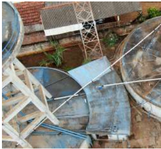
Foto 4 - Vista aérea da cobertura de um dos reservatórios semienterrados.
