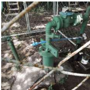
Foto 1 - Tubo de medição de nível do poço.
