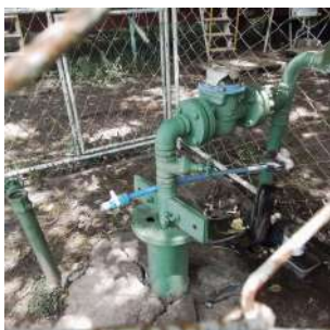
Foto 1 - Torneira para para coleta de água bruta.
