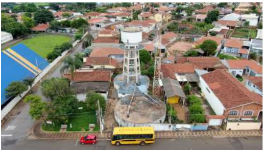
Foto 2 - Vista aérea dos reservatórios elevado e semienterrados.
