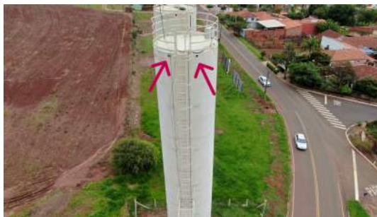
Foto 2 - Indicação dos locais sem tela de proteção.
