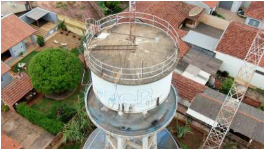
Foto 2 - Vista aérea da cobertura do reservatório elevado.
