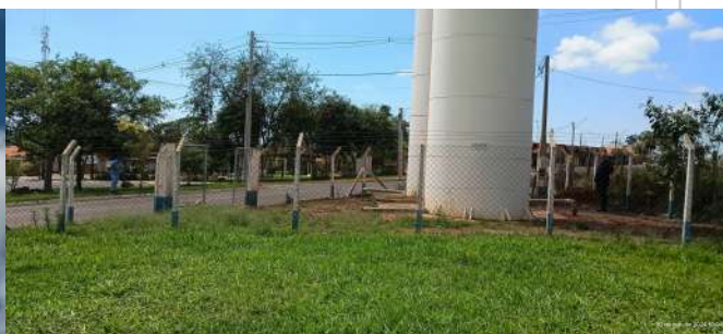
Foto 5 - Vista da área dos reservatórios.
