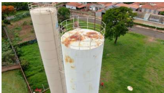
Foto 4 - Vista aérea da cobertura dos reservatórios.
