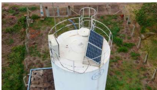
Foto 4 - Vista aérea da cobertura do reservatório elevado.
