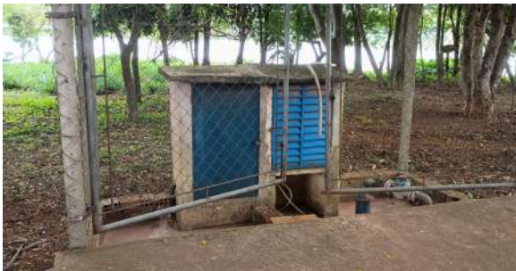
Foto 1 - Vista geral externa do poço.
