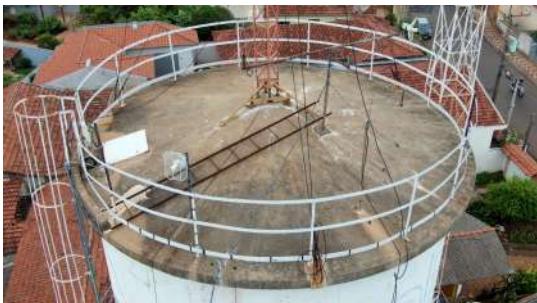
Foto 5 - Vista aérea da cobertura do reservatório elevado.
