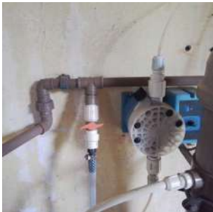
Foto 4 - Bomba de dosagem de cloro
