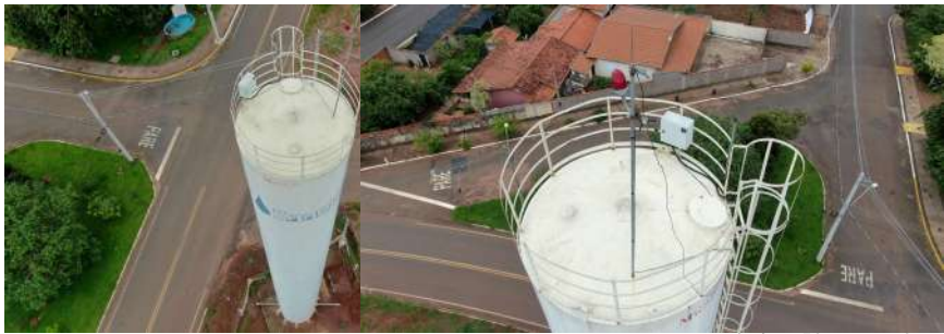
Foto 8 - Vista aérea da cobertura do reservatório.
