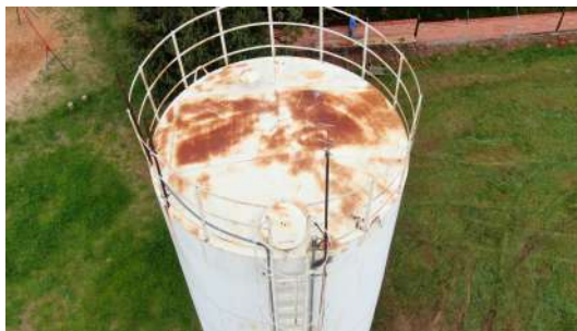
Foto 2 - Tela de proteção em tubo extravasador do reservatório na cor branca.
