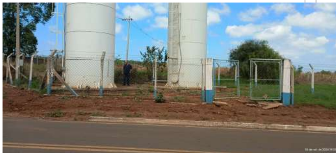
Foto 3 - Vista da área dos reservatórios.
