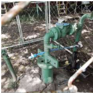
Foto 1 - Torneira para para coleta de água bruta.
