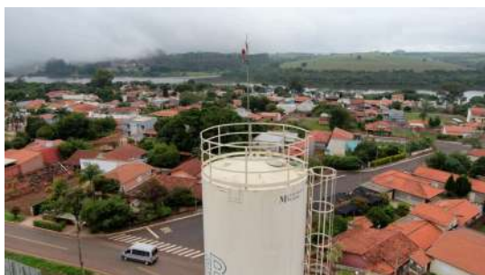
Foto 3 - Haste de captação do SPDA.
