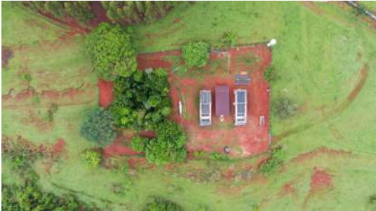
Foto 29 - Vista aérea da área da ETE Patrimônio.
