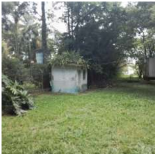
Foto 1 - Vista do abrigo dos painéis.
