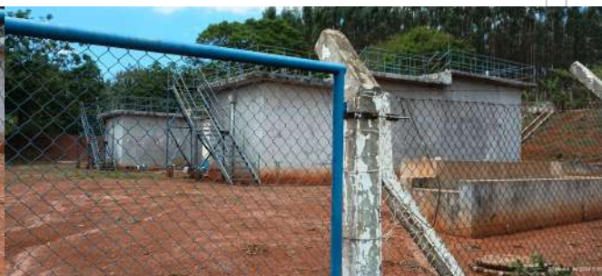
Foto 4 - Portão e cercamento da ETE.
