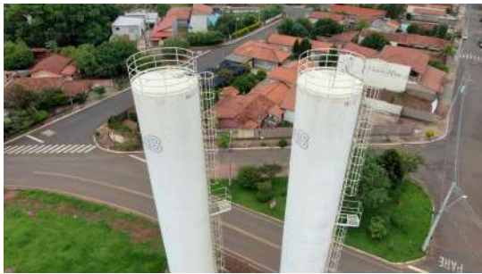
Foto 1 - Vista aérea dos reservatórios.
