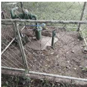
Foto 1 - Situação da laje de proteção.
