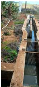
Foto 1 - Disposição de material ao lado do canal de chegada do esgoto bruto.
