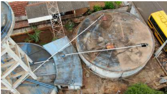
Foto 4 - Vista aérea da cobertura de um dos reservatórios semienterrados.
