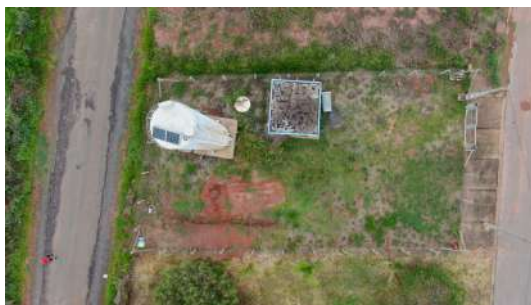
Foto 6 - Vista aérea da cobertura do reservatório elevado.
