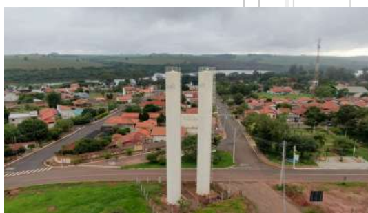
Foto 5 - Vista aérea dos dois reservatórios elevados. O reservatório desta ficha é o da direita.
