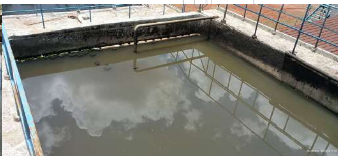
Foto 21 - Vista da parte superior de um dos módulos de tratamento.
