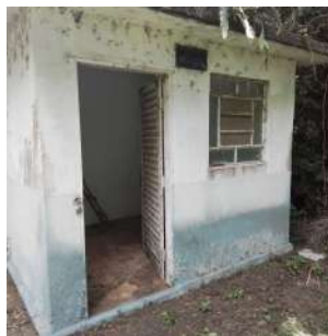
Foto 4 - Fachada do abrigo.
