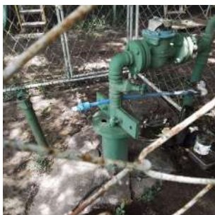
Foto 1 - Tubo de medição de nível do poço.
