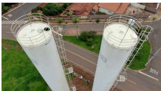
Foto 3 - Haste de captação do SPDA (reservatório da direita).
