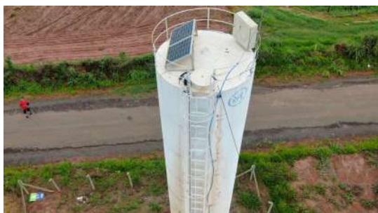
Foto 1 - Local sem telas de proteção.
