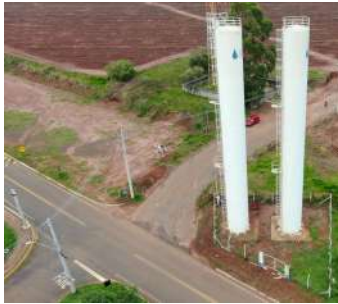
Foto 8 - Vista aérea dos dois reservatórios elevados, sendo o desta ficha o reservatório da direita.
