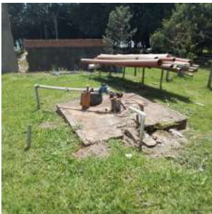
Foto 1 - Situação da laje de proteção.
