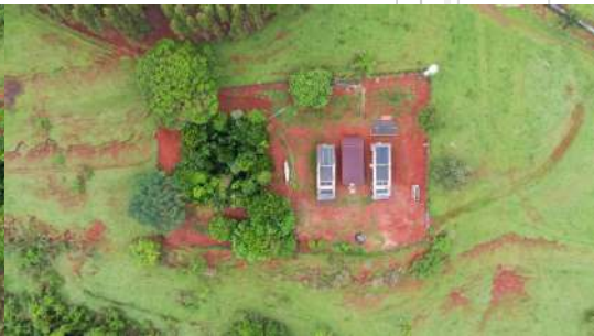
Foto 29 - Vista aérea da área da ETE Patrimônio.
