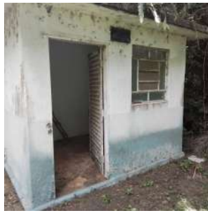
Foto 4 - Fachada do abrigo.
