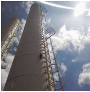
Foto 1 - Escada marinheiro e patamar de descanso do Reservatório.
