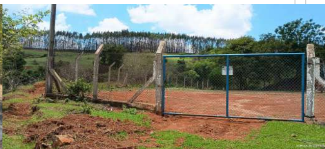
Foto 2 - Portão e cercamento da ETE.
