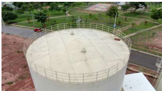
Foto 4 - Vista aérea da cobertura do reservatório apoiado.
