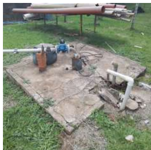
Foto 1 - Situação da laje de proteção.
