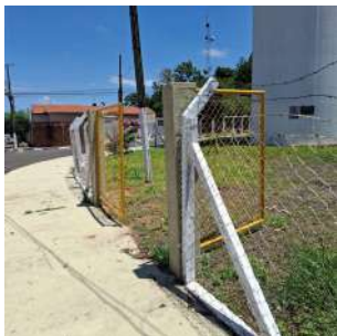
Foto 1 - Cerca no perímetro da área.
