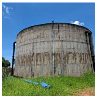
Foto 3 - Visão geral do reservatório.
