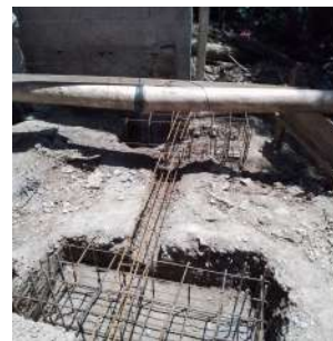
Foto 7 - Armação para fundação.
