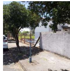
Foto 2 - Muro e cerca no perímetro.
