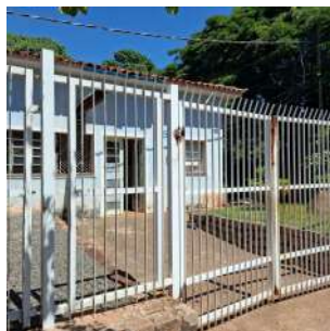
Foto 1 - Vista externa da área que abriga a elevatória e reservatório do Bosquinho.
