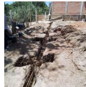
Foto 5 - Armação para fundação.
