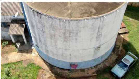
Foto 5 - Descida do aterramento no reservatório.
