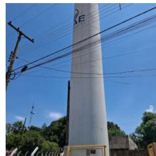
Foto 2 - Visão geral do reservatório.
