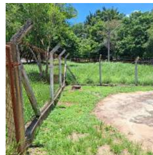
Foto 2 - Cerca no perímetro da área.
