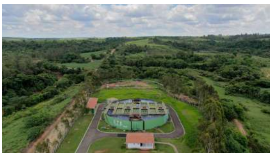
Foto 5 - À frente, edificação do laboratório e instalações; à esquerda do reator, edificação que abriga sopradores e unidades de desinfecção.
