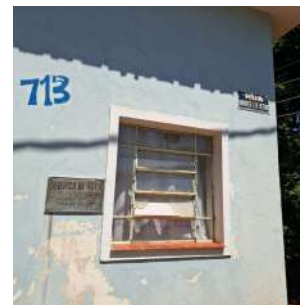
Foto 2 - Edificação da elevatória.
