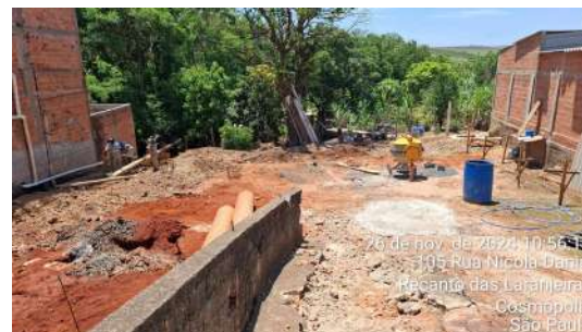
Foto 10 - Vista do canteiro de obras.
