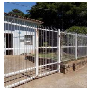
Foto 2 - Cerca na testada do terreno.
