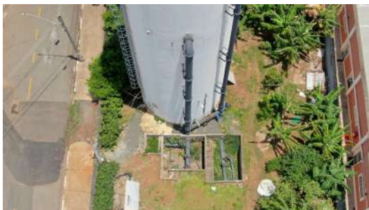
Foto 5 - Imagem aérea exibindo as caixas dos registros: mato alto deve ser removido para melhor acesso.
