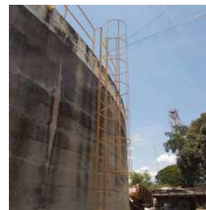
Foto 2 - Escada com guarda-corpo.
