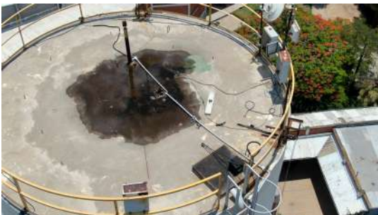
Foto 1 - Tampa de inspeção em aparentes boas condições.
