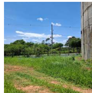
Foto 2 - Cerca no perímetro da área.
