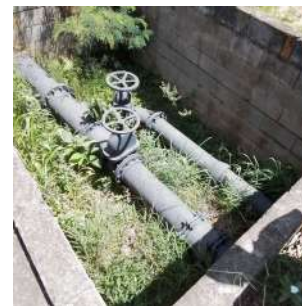
Foto 2 - Alimentação do reservatório vinda da EEAT Bosquinho.
