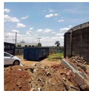
Foto 2 - Muro no perímetro do terreno.
