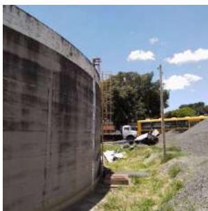
Foto 1 - Escada com guarda-corpo.
