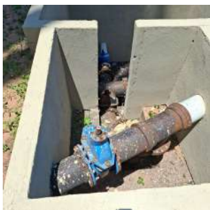
Foto 5 - Tubulação de alimentação do reservatório.
