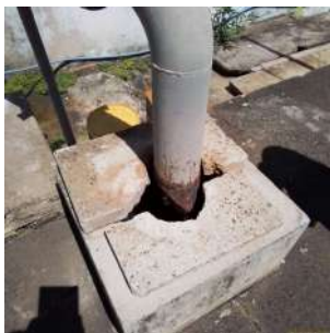
Foto 1 - As aberturas para alimentação do reservatório necessitam ser protegidas com manta que vede a entrada de água de chuva, animais, objetos etc.
