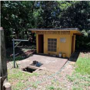
Foto 3 - Visão geral da elevatória.
