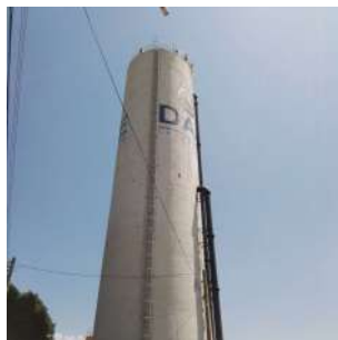
Foto 1 - Visão geral do reservatório.
