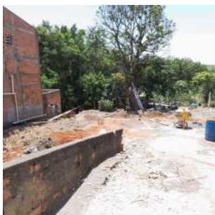
Foto 9 - Visão geral do local da obra.
