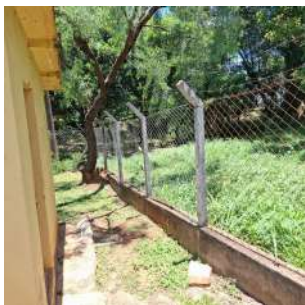
Foto 1 - Cerca no perímetro da área.
