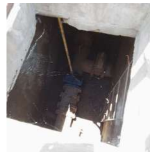
Foto 4 - Saída para reservatório Bosquinho.
