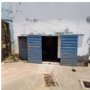
Foto 3 - Portão de acesso para manutenção.
