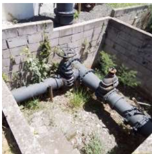
Foto 1 - Mato existente nas caixas com registros deve ser removido com frequência.
