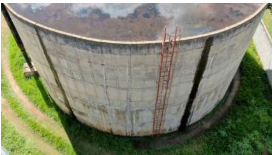
Foto 3 - Escada com guarda-corpo.
