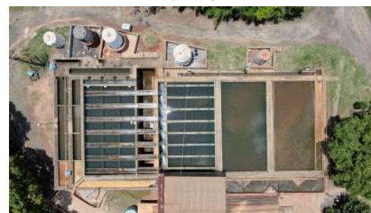
Foto 5 - Etapas de tratamento da ETA.
