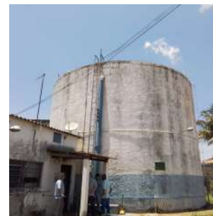
Foto 2 - Vista do reservatório Santo Rizzo I.
