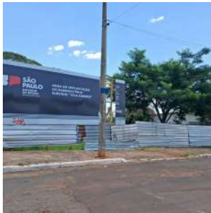
Foto 2 - Placa de identificação da obras no local onde o reservatório será instalado.
