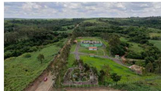
Foto 4 - Visão geral da ETE.
