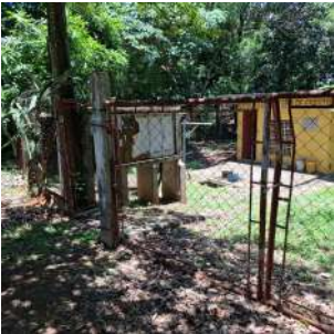
Foto 1 - Vista externa da elevatória de esgoto.
