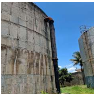
Foto 1 - Extravasor do reservatório.
