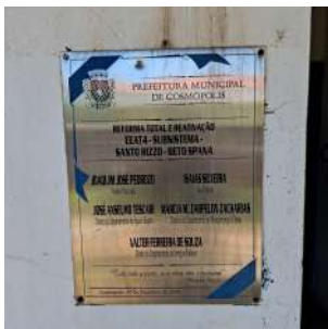
Foto 1 - Placa de identificação da elevatória existente junto aos reservatórios I e II.
