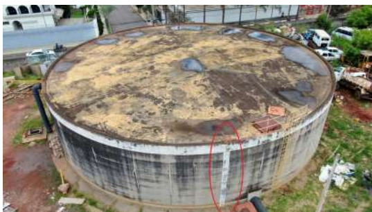
Foto 3 - Medidor de nível do reservatório.
