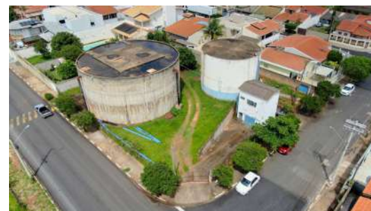
Foto 4 - Imagem aérea, obtida com drone, dos Reservatórios e Elevatória Santo Rizzo. O reservatório I está no centro.
