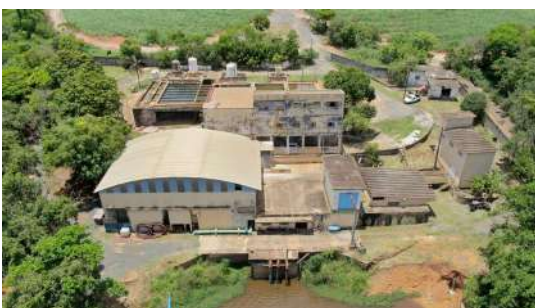
Foto 4 - Nesta imagem observa-se as tubulações de sucção das bombas da captação.
