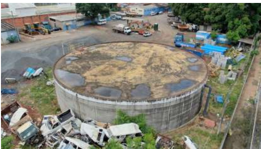
Foto 3 - Área na qual o reservatório está situado funciona como um depósito, estacionamento e almoxarifado da Prefeitura Municipal.
