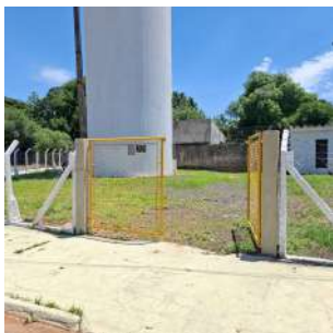
Foto 1 - Visão geral do reservatório.
