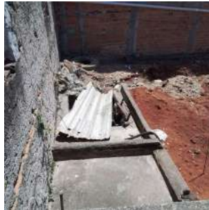
Foto 1 - Local onde havia a elevatória antiga, que foi desativada após ocorrência de furtos e problemas no funcionamento.
