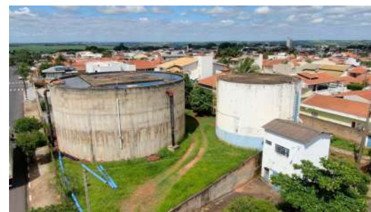
Foto 4 - Imagem aérea, obtida com drone, dos Reservatórios e Elevatória Santo Rizzo. O reservatório II está à esquerda.
