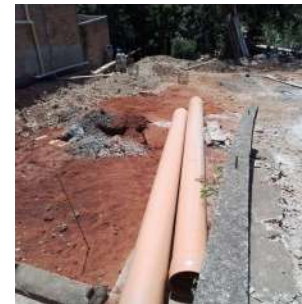
Foto 3 - Tubulação no canteiro de obras.
