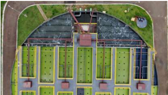
Foto 8 - Detalhe das tubulações de entrada do efluente reator, após tratamento preliminar.
