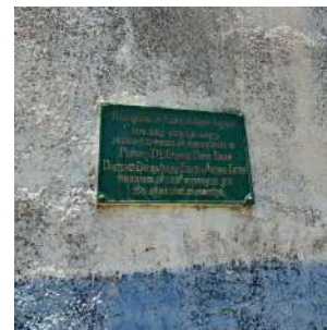
Foto 2 - Placa de identificação do reservatório Santo Rizzo I.
