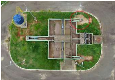
Foto 1 - Em destaque na imagem, evidência que demonstra que está sendo realizada a remoção do material acumulado.
