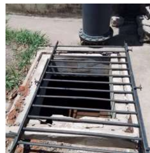
Foto 2 - Caixa que coleta água do extravasor.
