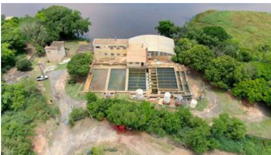
Foto 1 - Visão geral da ETA, situada à margem da represa Pirapitingui, da qual capta água, além do Rio Jaguari.
