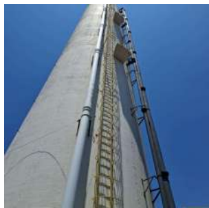
Foto 3 - Escada com guarda-corpo e plataformas de descanso.
