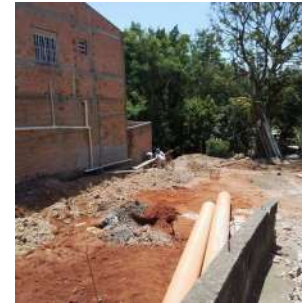
Foto 2 - Visão da obra em andamento.
