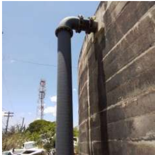
Foto 2 - Tubulação de alimentação do reservatório.
