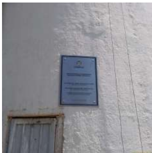
Foto 1 - Placa de identificação na área.
