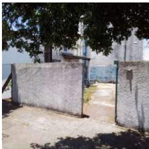
Foto 1 - Portão de acesso à área, o qual permanece trancado.
