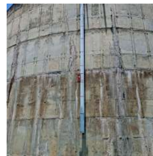
Foto 2 - Medidor de nível por contrapeso.
