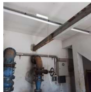
Foto 4 - Estrutura para içamento das bombas.
