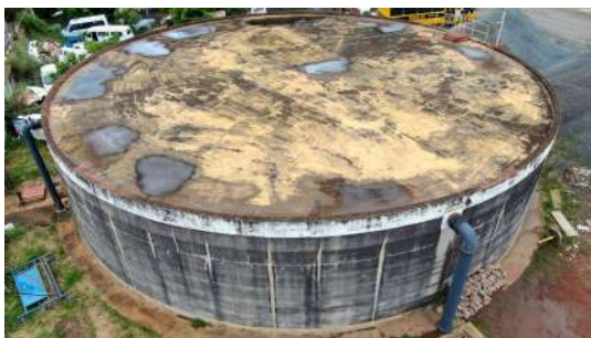
Foto 5 - Imagem aérea do reservatório. Tubulação preta à esquerda é a alimentação do reservatório; tubulação abaixo é o extravasor.
