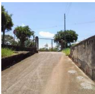
Foto 5 - Rampa para acessar a elevatória.
