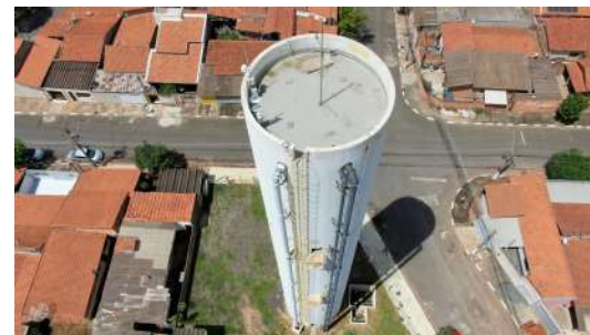
Foto 4 - Escada e guarda-corpo do reservatório.
