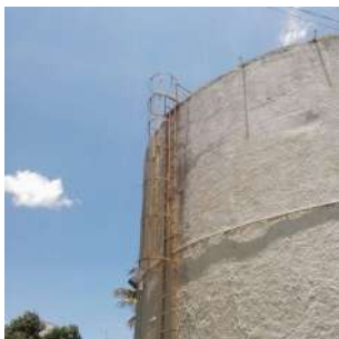
Foto 1 - Escada com proteção para acessar a cobertura,
