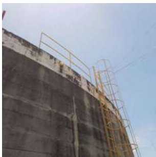
Foto 3 - Escada com guarda-corpo.
