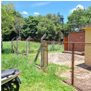
Foto 2 - Vista externa da elevatória,
