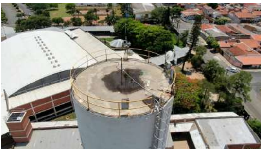
Foto 3 - Escada e guarda-corpo na cobertura do reservatório.
