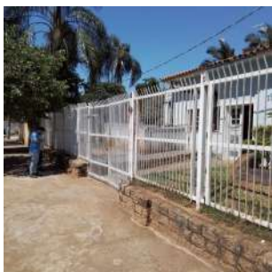
Foto 1 - Cerca na testada do terreno.
