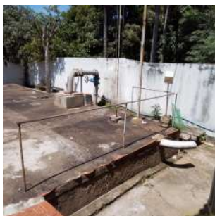
Foto 1 - Guarda-corpo próximo ao medidor de nível.
