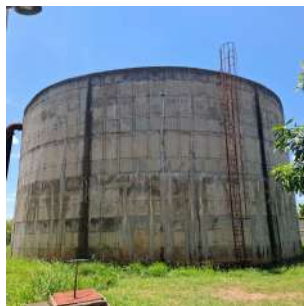
Foto 1 - Visão geral do reservatório.
