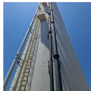
Foto 4 - Escada e tubulações do reservatório.
