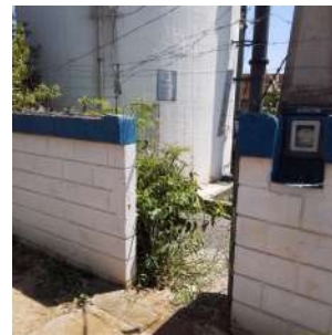
Foto 4 - Portão de acesso à área.
