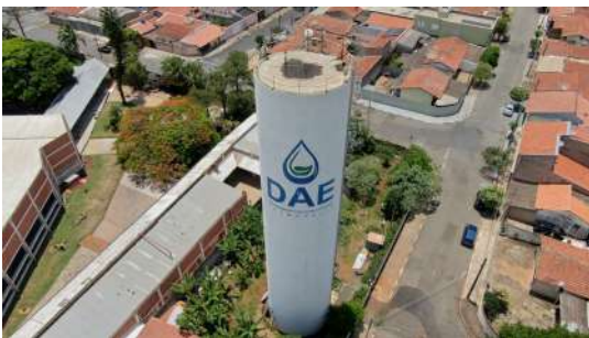
Foto 7 - Imagem aérea do reservatório elevado.
