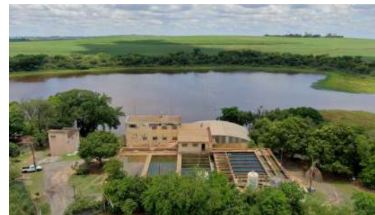
Foto 2 - Visão geral da ETA junto à represa.
