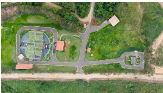
Foto 1 - Visão geral da ETE: à esquerda, Unidade Compacta de Tratamento Primário e Secundário, edificação que abriga sopradores e equipamentos para desinfecção e edificação que abriga laboratório e instalações para os operadores. À direita, tratamento preliminar.
