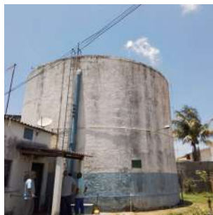
Foto 1 - Vista do reservatório Santo Rizzo I.
