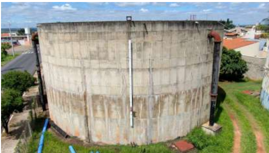
Foto 3 - Medidor de nível por contrapeso.
