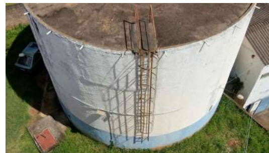
Foto 2 - Escada com proteção para acessar a cobertura,
