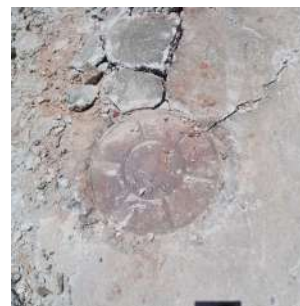
Foto 8 - PV de chegada do esgoto na elevatória.
