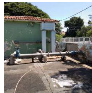
Foto 5 - Entrada de água proveniente do reservatório Monte Castelo.
