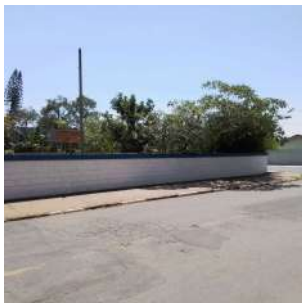
Foto 3 - Muro no perímetro do terreno.
