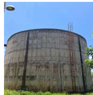
Foto 2 - Visão geral do reservatório.
