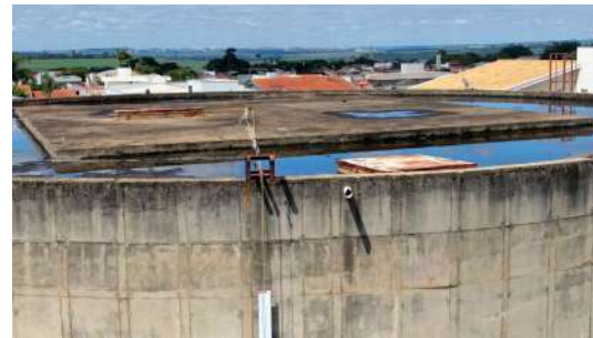
Foto 4 - Medidor de nível por contrapeso.
