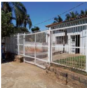
Foto 1 - Vista externa da área que abriga o reservatório e elevatória de água.
