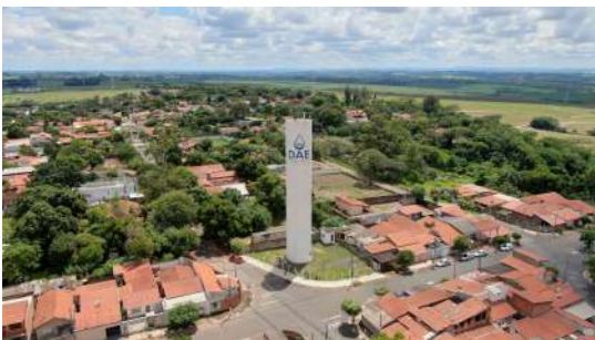
Foto 7 - Imagem aérea do reservatório elevado.
