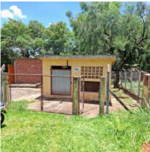
Foto 1 - Visão geral da elevatória. À frente, a construção em amarelo é a antiga elevatória, que foi desativada. Atrás, edificação que abriga a elevatória em funcionamento, construída mais recentemente. De acordo com funcionários do DAE, a alteração ocorreu por questões técnicas, envolvendo cota.
