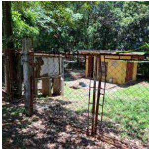
Foto 2 - Vista externa da elevatória de esgoto.
