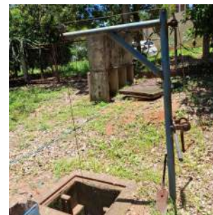
Foto 2 - Estrutura para içamento do cesto peneira, possibilitando a limpeza.
