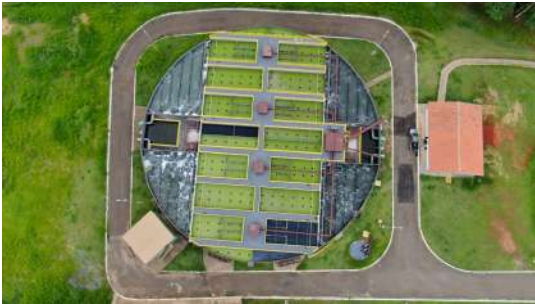
Foto 7 - Reator da ETE.
