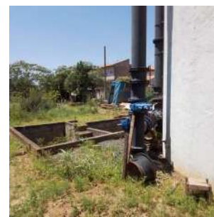
Foto 6 - Tubulação de alimentação do reservatório.
