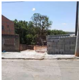
Foto 4 - Vista da área da elevatória.
