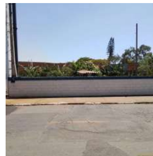
Foto 2 - Muro no perímetro do terreno.
