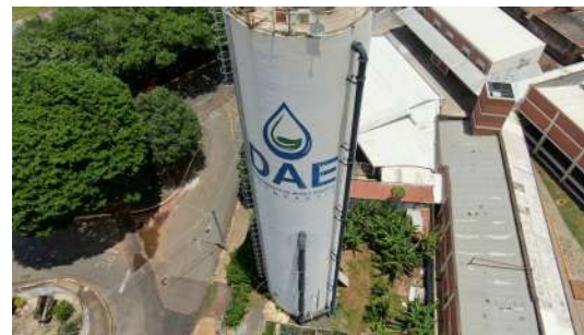
Foto 8 - Tubulações de alimentação e saída do reservatório.
