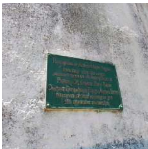
Foto 1 - Placa de identificação do reservatório.
