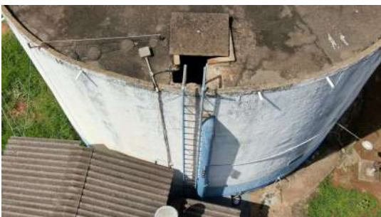
Foto 1 - Abertura existente na cobertura do reservatório, junto à tampa.
