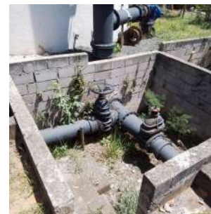
Foto 2 - Mato existente nas caixas com registros deve ser removido com frequência.
