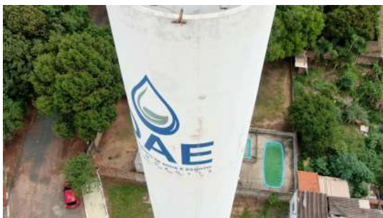
Foto 1 - Suporte para contrapeso estava sem o medidor.
