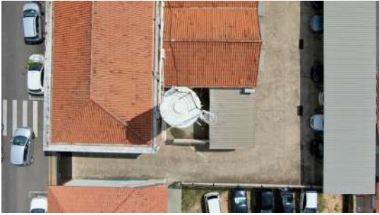
Foto 1 - Tampa de inspeção - Reservatório Elevado 05 - Prefeitura
