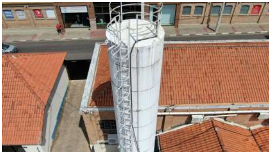
Foto 1 - Ventilação - Reservatório Elevado 05 - Prefeitura
