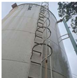
Foto 1 - Escada com guarda-corpos - Reservatório de lavagem de filtro da ETA
