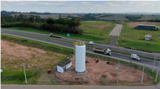
Foto 1 - Visão geral - Reservatório Elevado 35 -Soamin
