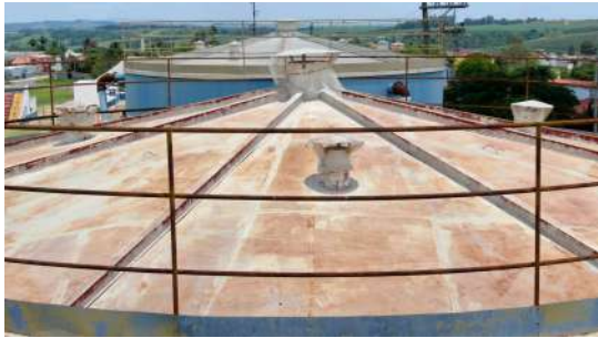
Foto 1 - Presença de tela de proteção - Reservatório Apoiado 28 - CR Jd. Vante
