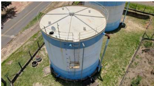
Foto 1 - Presença de extravasor - Reservatório Apoiado 27 - CR Jd. Vante
