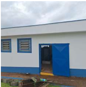
Foto 3 - Portão da casa de bombas - EEA 3 e 4
