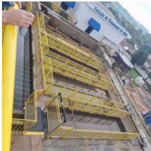
Foto 8 - Visão geral das unidades da ETA
