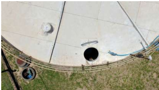
Foto 1 - Tampa de inspeção aberta - Reservatório Apoiado 27 - CR Jd. Vante
