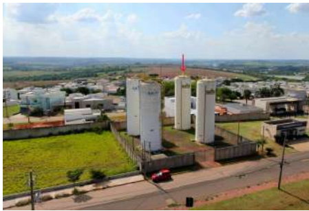
Foto 1 - Visão geral e localização do Reservatório Elevado 33 - Flamboyant
