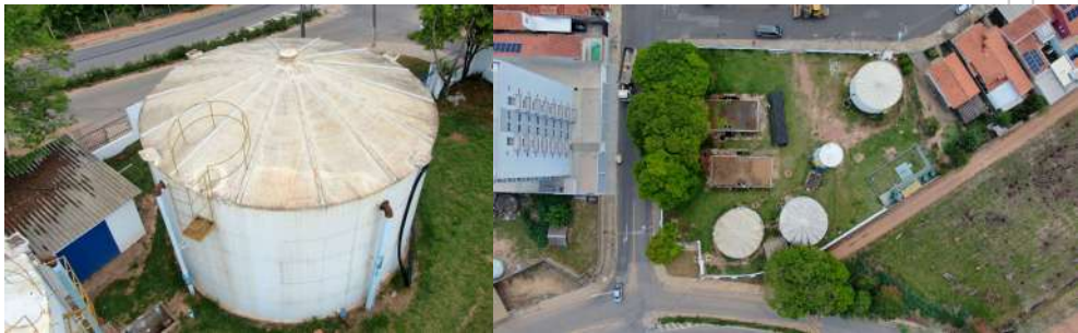
Foto 1 - Visão geral - Reservatório Apoiado 15 - CR Popular
