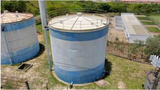
Foto 1 - Visão geral - Reservatório Apoiado 27 - CR Jd. Vante
