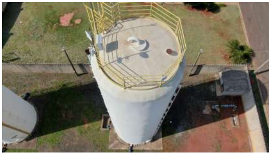
Foto 1 - Presença de ventilação - Reservatório Elevado 32 - Flamboyant
