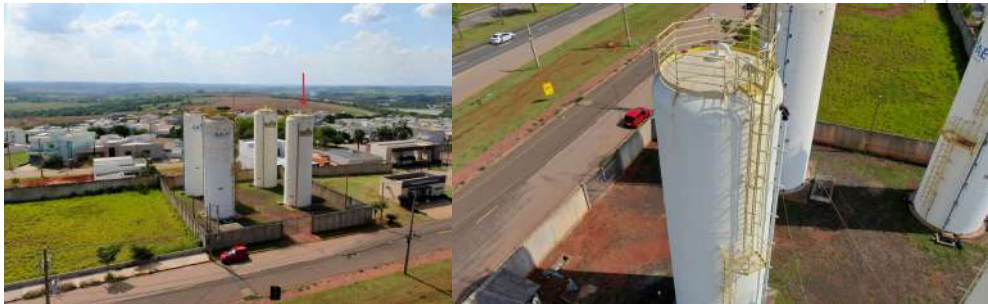
Foto 1 - Visão geral CR Flamboyant e localização do Reservatório Elevado 32
