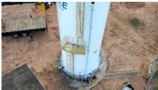
Foto 1 - Extravasor - Reservatório Elevado 35 -Soamin
