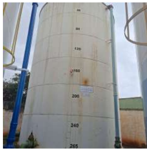
Foto 1 - Visão geral - Reservatório de lavagem de filtro da ETA
