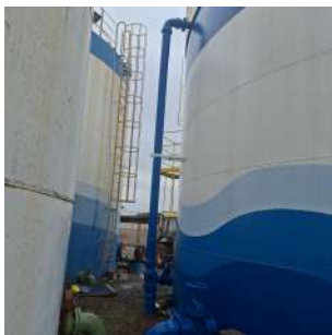
Foto 1 - Extravasor - Reservatório 1 - Vila Progresso ETA
