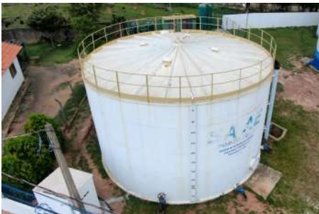
Foto 1 - Visão geral - Reservatório Apoiado 18 - CR Popular
