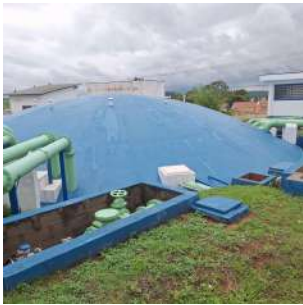
Foto 1 - Visão geral - Reservatório enterrado circular - ETA
