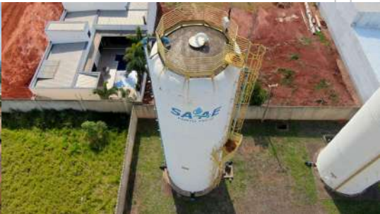
Foto 2 - Visão geral - Reservatório Elevado 34 - Flamboyant
