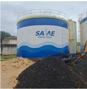
Foto 1 - Visão geral - Reservatório 1 - Vila Progresso ETA
