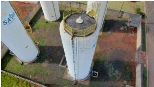
Foto 1 - Presença de ventilação - Reservatório Elevado 31 - Flamboyant
