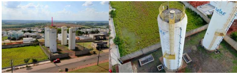
Foto 1 - Visão geral CR Flamboyant - localização do Reservatório Elevado 31
