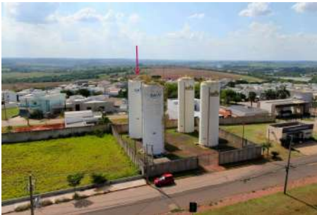
Foto 1 - Visão geral e localização - Reservatório Elevado 34 - Flamboyant
