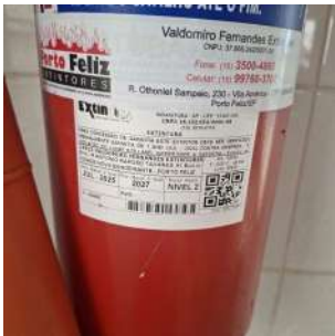
Foto 1 - Validade regular - EEA 2 Justapostas - ETA (Progresso)
