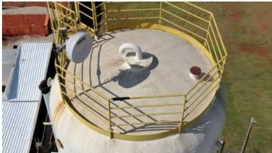
Foto 1 - Presença de tampa de inspeção - Reservatório Elevado 33 - Flamboyant
