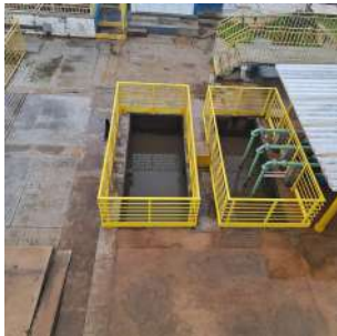
Foto 7 - Lodo de fundo, a ser recalcado para centrífugas
