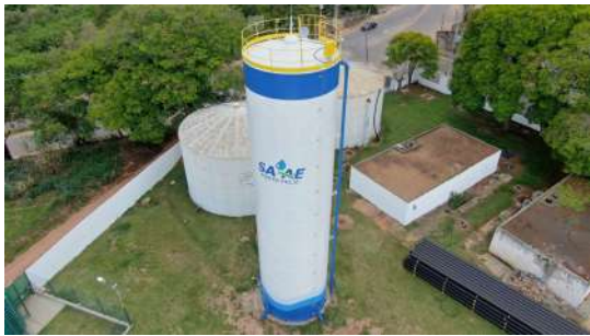
Foto 1 - Visão geral - Reservatório Elevado 16 - CR Popular
