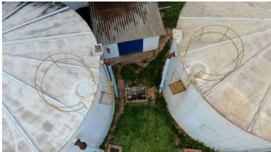
Foto 1 - Tampa de inspeção - Reservatório Apoiado 15 - CR Popular (direita)
