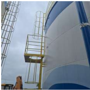
Foto 1 - Escada com guarda-corpos - Reservatório 1 - Vila Progresso ETA
