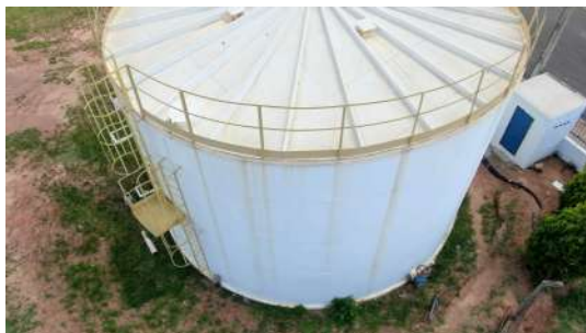
Foto 1 - Tampa de inspeção - Reservatório Apoiado 18 - CR Popular
