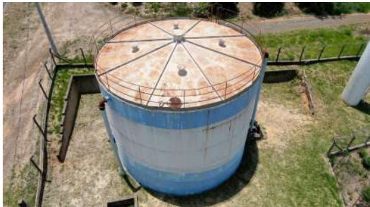
Foto 1 - Visão geral - Reservatório Apoiado 28 - CR Jd. Vante
