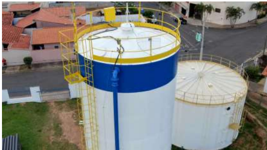
Foto 1 - Tampa de inspeção em boas condições - Reservatório Elevado 16 - CR Popular
