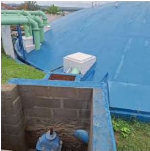
Foto 1 - Tampa de inspeção - Reservatório enterrado circular - ETA
