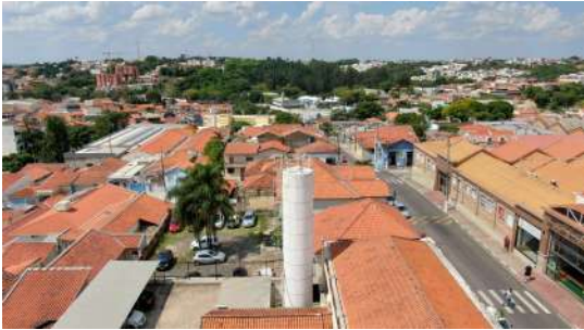
Foto 1 - Visão geral - Reservatório Elevado 05 - Prefeitura
