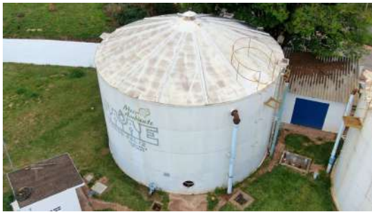
Foto 1 - Visão geral - Reservatório Apoiado 17 - CR Popular
