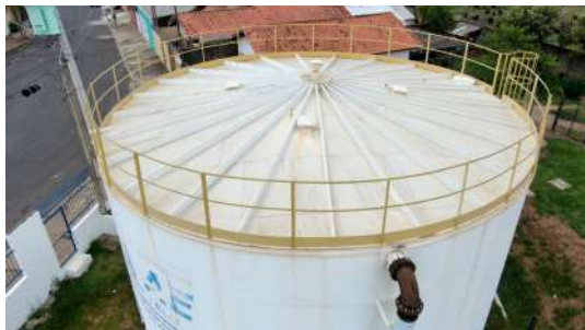
Foto 1 - Ventilação - Reservatório Apoiado 18 - CR Popular
