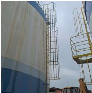
Foto 1 - Escada com guarda-corpos RA 02 Jardim Vante
