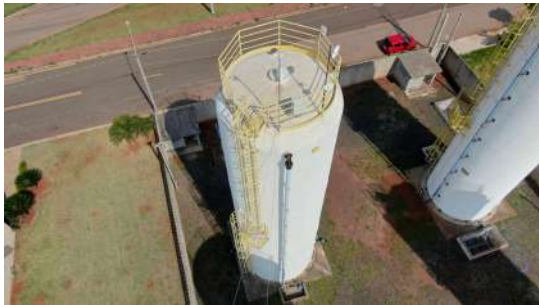
Foto 1 - Presença de extravasor - Reservatório Elevado 32 - Flamboyant
