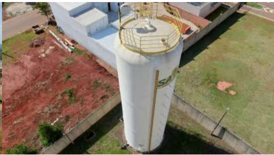
Foto 2 - Visão geral - Reservatório Elevado 33 - Flamboyant
