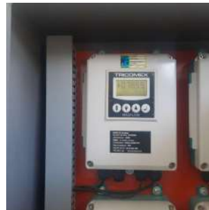
Foto 2 - Display do macromedidor na saída.
