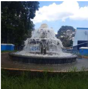
Foto 2 - Chafariz de água bruta
