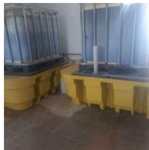
Foto 2 - Produtos químicos com bacia de contenção.
