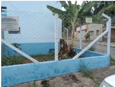
Foto 1 - Cercamento da área
