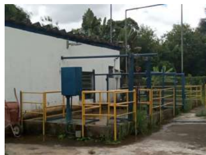
Foto 9 - Poço de acúmulo de água bruta.
