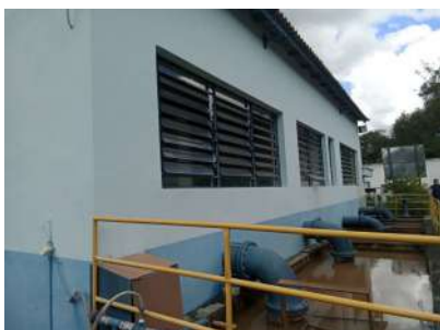
Foto 8 - Poço de sucção.
