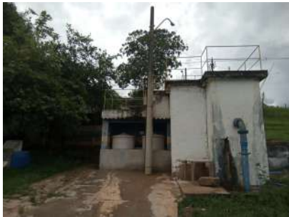
Foto 2 - Vista lateral da ETA 4.
