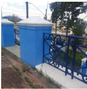
Foto 3 - Reservatório ETA I - (Quadrado)
