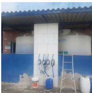
Foto 1 - Ponto de aplicação cloro.
