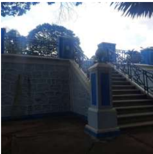
Foto 1 - Reservatório ETA I - (Quadrado)
