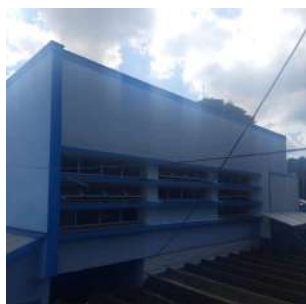
Foto 5 - Vista do prédio ETA I.
