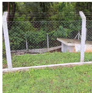
Foto 2 - Cercamento por alambrado e tela - EEEB CDHU
