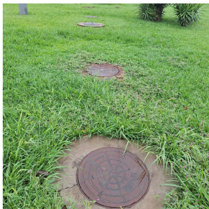
Foto 1 - Sistema de fossa filtro precedendo a elevatória
