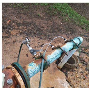
Foto 4 - Injeção de produtos químicos - Poço Baggio
