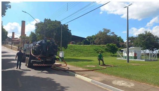
Foto 2 - Limpeza do sistema fossa filtro por empresa contratada. Fonte da imagem: Prefeitura de Jumirim
