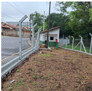
Foto 1 - Visão geral - EEEB Morada do Sol
