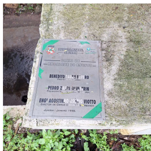
Foto 3 - Placa de inauguração da estação elevatória (caixa de recalque)
