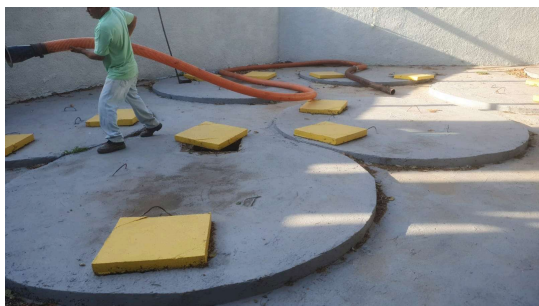
Foto 1 - Limpeza do sistema fossa filtro por empresa contratada. Fonte: Prefeitura de Jumirim.
