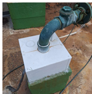
Foto 2 - Proteção sobre a laje - Poço Baggio
