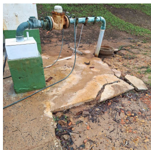
Foto 11 - Laje de Proteção - Poço Baggio
