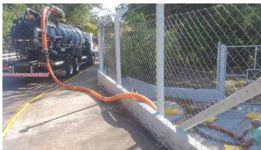
Foto 2 - Limpeza do sistema fossa filtro por empresa contratada (2). Fonte: Prefeitura de Jumirim.
