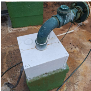
Foto 1 - Nova caixa de proteção sobre a laje - Poço Baggio
