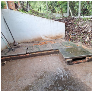
Foto 1 - Tampas sobre local de passagem do esgoto bruto e gradeamento.
