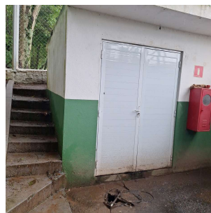
Foto 4 - Posicionamento do extintor e casa de bomba
