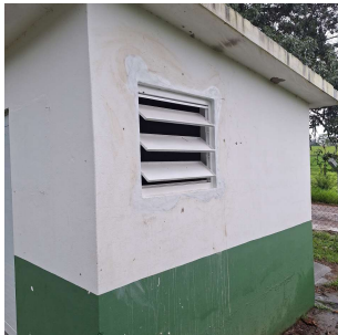
Foto 1 - Janela basculante instalada - EEEB Baggio
