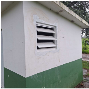
Foto 3 - Janelas basculantes instaladas - EEEB Baggio
