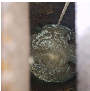
Foto 6 - Chegada de esgoto no poço de sucção - EEEB Baggio
