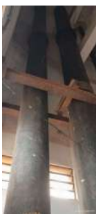
Foto 1 - Tubo extravasador do reservatório.
