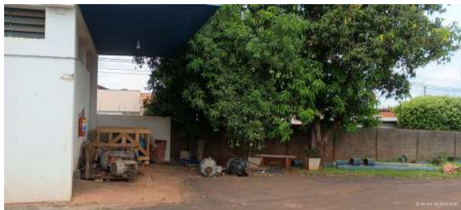
Foto 1 - Local cercado com muro de alvenaria.
