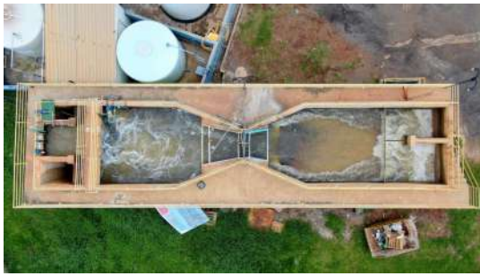
Foto 60 - Vista aérea da chegada comum de água bruta.
