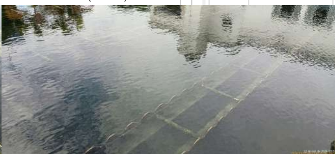
Foto 18 - Decantadores do módulo II (ETA II).
