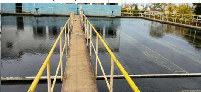
Foto 16 - Decantadores do módulo II (ETA II).
