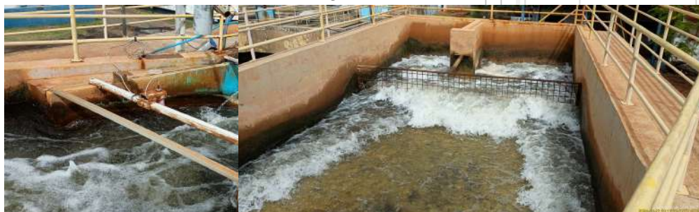
Foto 7 - Aplicação de PAC (policloreto de alumínio) na água bruta.
