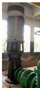
Foto 6 - Primeiro conjunto motobomba.
