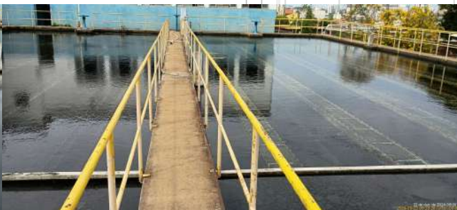
Foto 16 - Decantadores do módulo II (ETA II).
