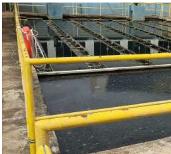
Foto 27 - Decantadores do módulo I (ETA I).
