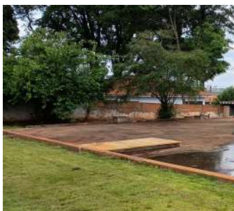
Foto 1 - Vista geral do reservatório.
