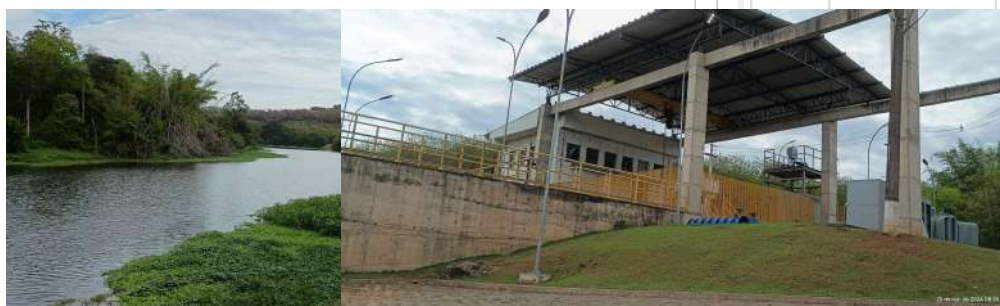
Foto 1 - Vista de jusante para montante do Rio Piracicaba (captação à direita).
