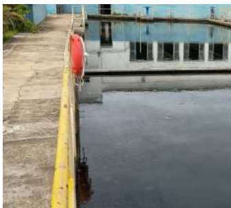
Foto 15 - Decantadores do módulo II (ETA II).
