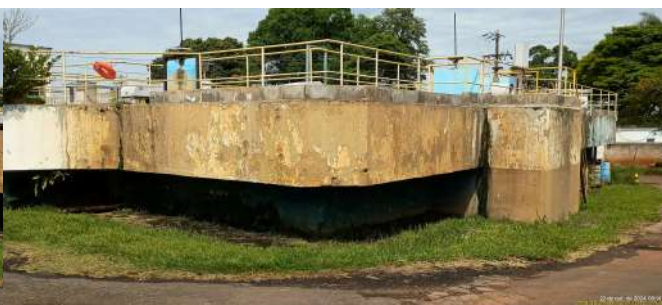
Foto 10 - Visto externa do módulo II (ETA II).
