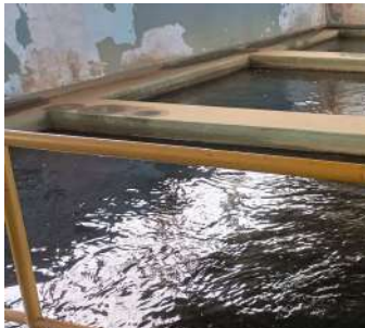
Foto 23 - Filtros do módulo II (ETA II).
