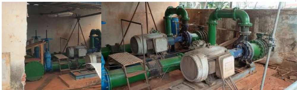
Foto 1 - Vista geral da EEAT.
