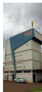
Foto 2 - Vista geral do reservatório.
