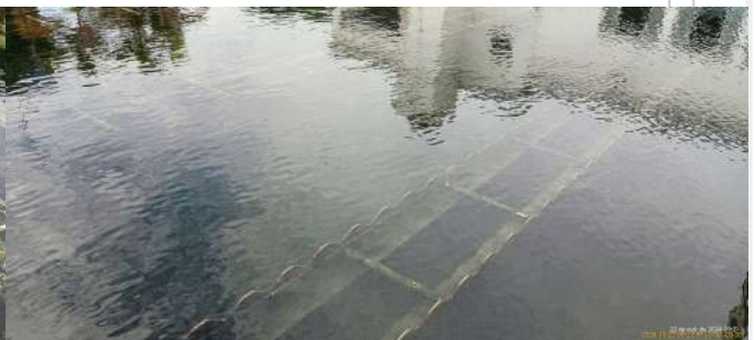
Foto 18 - Decantadores do módulo II (ETA II).
