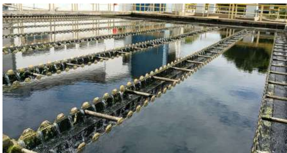
Foto 29 - Decantadores do módulo I (ETA I).
