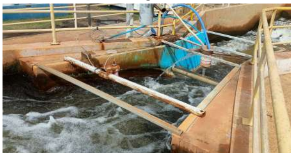
Foto 7 - Aplicação de PAC (polidloreto de alumínio) na água bruta.
