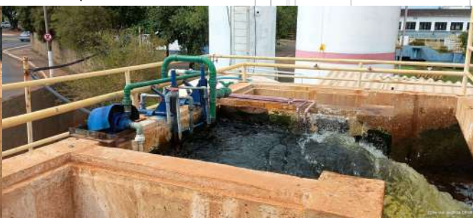
Foto 4 - Aplicação de dióxido de cloro e flúor no início do processo.
