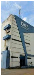
Foto 1 - Vista geral do reservatório.
