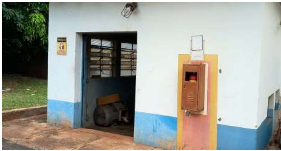
Foto 1 - Casa de bomba do booster.
