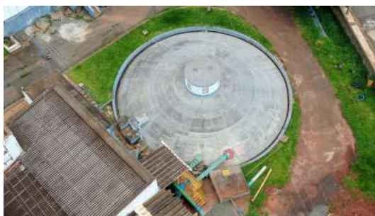
Foto 6 - Vista aérea do reservatório semienterrado da ETA I.
