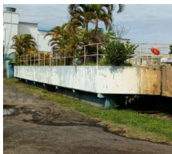
Foto 9 - Visto externa do módulo II (ETA II).
