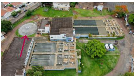
Foto 5 - Vista aérea da ETA com indicação do reservatório semienterrado da ETA I.
