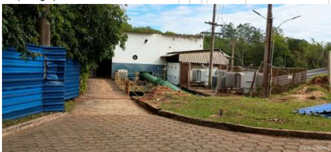
Foto 3 - Vista geral do prédio da antiga captação.
