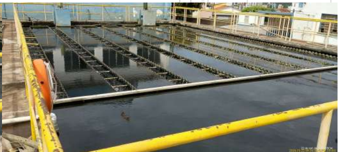
Foto 28 - Decantadores do módulo I (ETA I).
