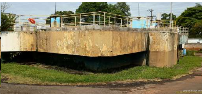
Foto 10 - Visto externa do módulo II (ETA II).
