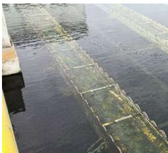
Foto 17 - Decantadores do módulo II (ETA II).
