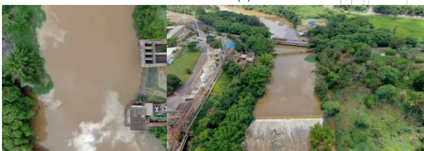
Foto 23 - Vista aérea das Captações superficiais. Na parte superior a nova captação (3) e na parte inferior a antiga captação (2).
