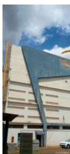
Foto 1 - Vista geral do reservatório.
