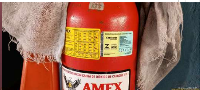
Foto 2 - Extintor de incêndio com prazo vencido.
