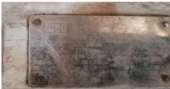
Foto 15 - Placa de especificações técnicas do motor de um dos conjuntos motobomba que recalcam para o CR Santa Maria.
