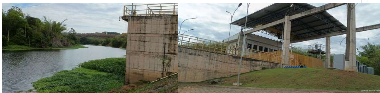
Foto 1 - Vista de jusante para montante do Rio Piracicaba (captação à direita).
