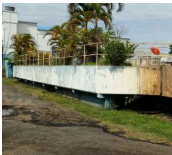
Foto 9 - Visto externa do módulo II (ETA II).
