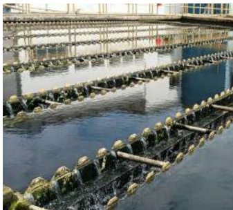
Foto 29 - Decantadores do módulo I (ETA I).
