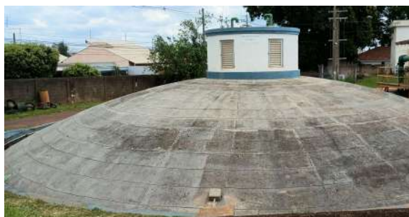
Foto 1 - Vista geral do reservatório.
