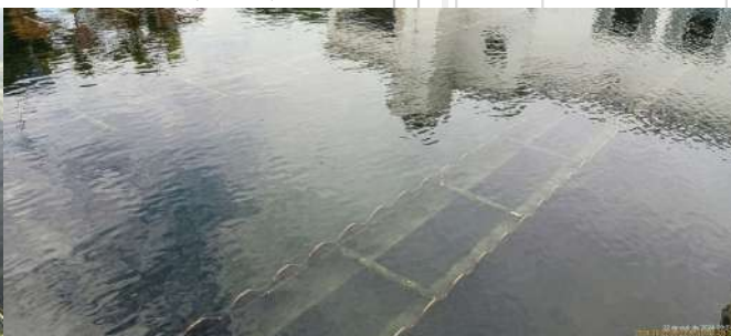
Foto 18 - Decantadores do módulo II (ETA II).
