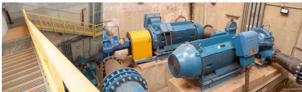
Foto 14 - Escada de acesso aos conjuntos motobomba.
