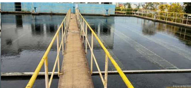
Foto 16 - Decantadores do módulo II (ETA II).
