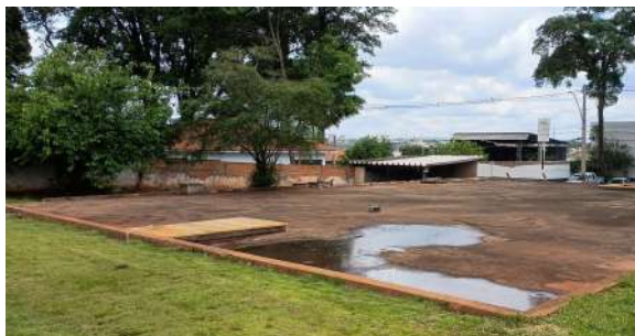
Foto 1 - Vista geral do reservatório.
