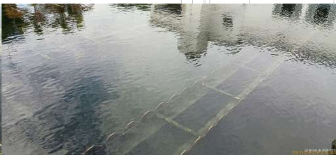
Foto 18 - Decantadores do módulo II (ETA II).
