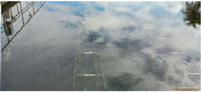
Foto 20 - Decantadores do módulo II (ETA II).
