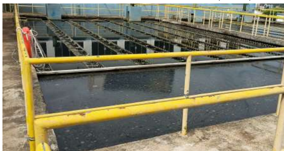
Foto 27 - Decantadores do módulo I (ETA I).
