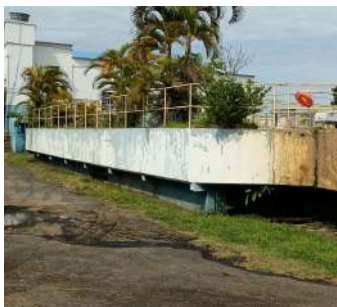
Foto 9 - Visto externa do módulo II (ETA II).
