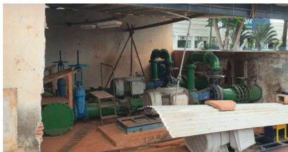
Foto 1 - Vista geral da EEAT.
