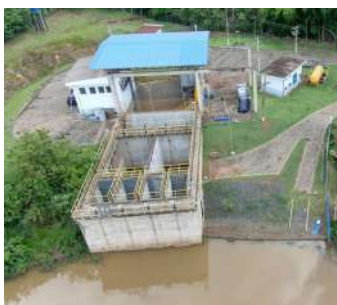
Foto 14 - Vista aérea das Captações Superficiais. À esquerda a nova captação (3) e à direita a antiga captação (2).
