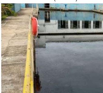
Foto 15 - Decantadores do módulo II (ETA II).
