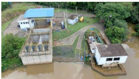
Foto 14 - Vista aérea das Captações Superficiais. À esquerda a nova captação (3) e à direita a antiga captação (2).
