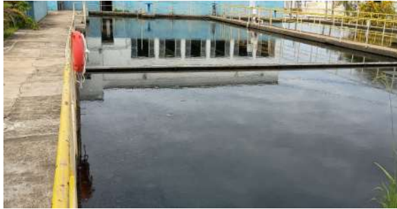
Foto 15 - Decantadores do módulo II (ETA II).
