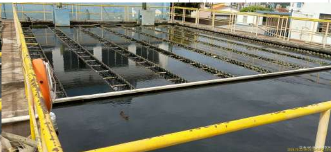
Foto 28 - Decantadores do módulo I (ETA I).
