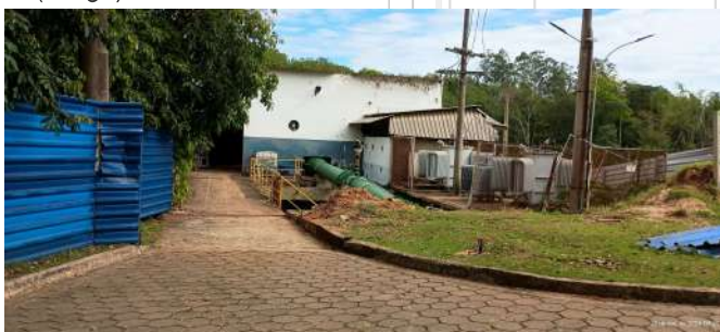
Foto 3 - Vista geral do prédio da antiga captação.
