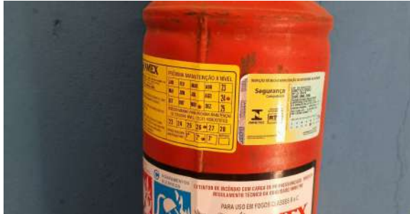
Foto 5 - Extintor de incêndio com prazo vencido.
