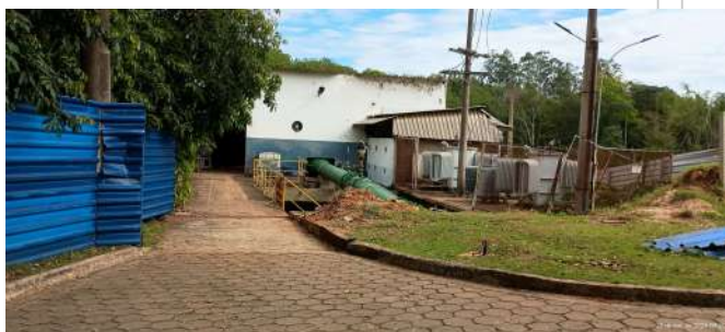
Foto 3 - Vista geral do prédio da antiga captação.
