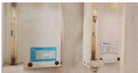
Foto 40 - Dosagem de cloro gás.
