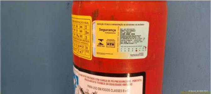
Foto 6 - Extintor de incêndio com prazo vencido.
