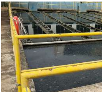
Foto 27 - Decantadores do módulo I (ETA I).
