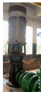
Foto 6 - Primeiro conjunto motobomba.
