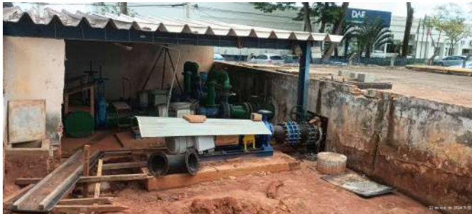
Foto 6 - Vista geral da área e do terceiro conjunto motobomba da EEAT (à frente e em processo de instalação).
