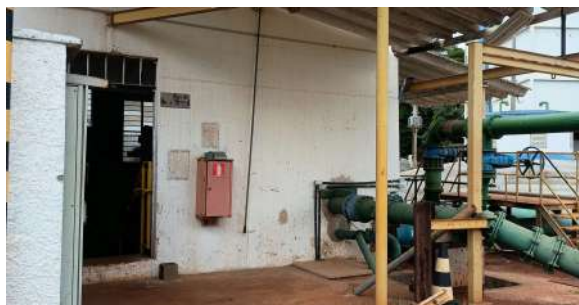
Foto 1 - Vista geral externa da EEAT.
