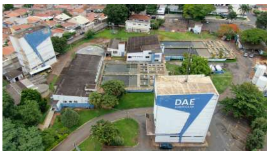
Foto 56 - Vista aérea geral da ETA, suas unidades e reservatórios.
