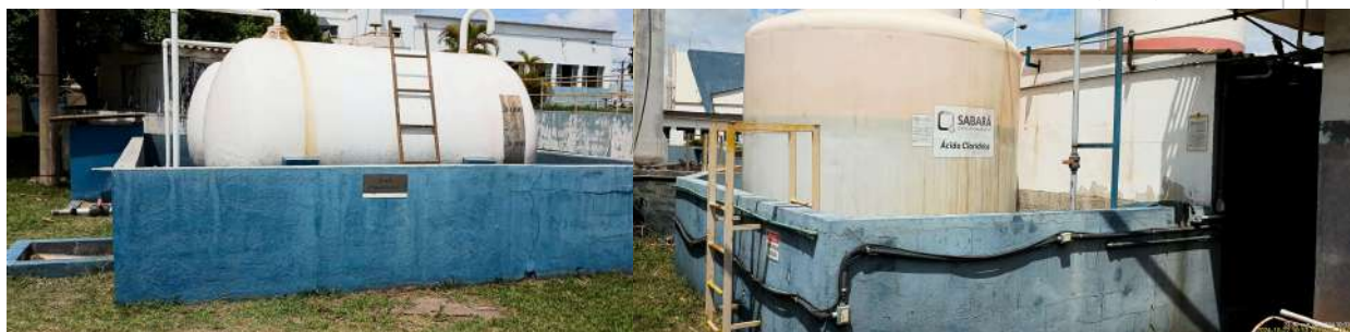
Foto 3 - Bacia de contenção e identificação do ácido fluossilícico.
