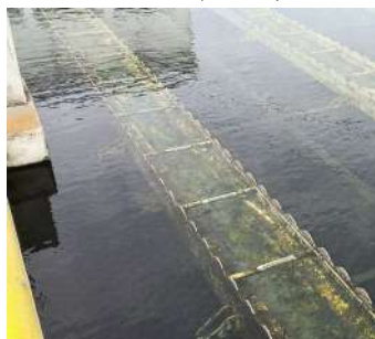
Foto 17 - Decantadores do módulo II (ETA II).
