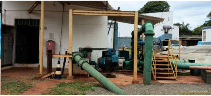
Foto 18 - Um dos conjuntos motobomba que recalcam para o CR Jd. Brasil. Foto 19 - Vista geral externa da EEAT.
