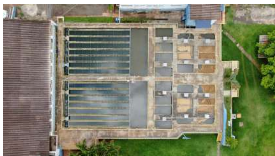
Foto 58 - Vista aérea da ETA I.
