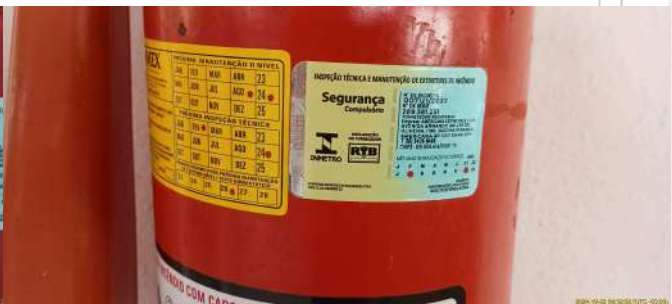
Foto 6 - Extintor de incêndio com prazo vencido.
