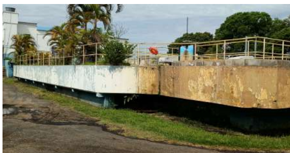
Foto 9 - Visto externa do módulo II (ETA II).
