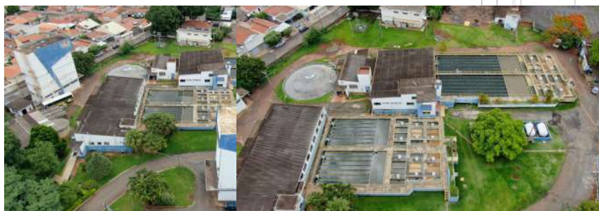
Foto 56 - Vista aérea geral da ETA, suas unidades e reservatórios.
