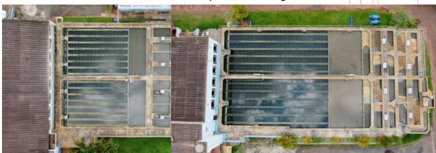
Foto 58 - Vista aérea da ETA I.
