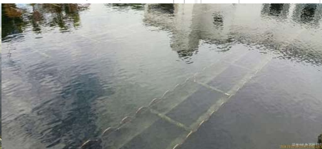
Foto 18 - Decantadores do módulo II (ETA II).
