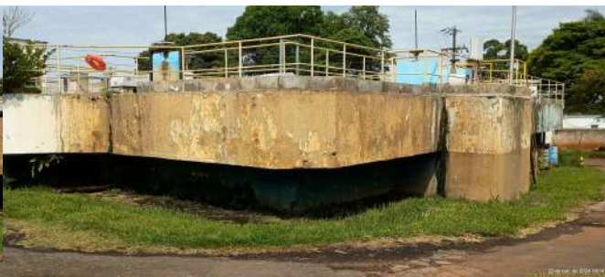
Foto 10 - Visto externa do módulo II (ETA II).
