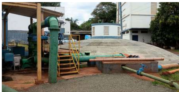
Foto 3 - Vista geral do reservatório.
