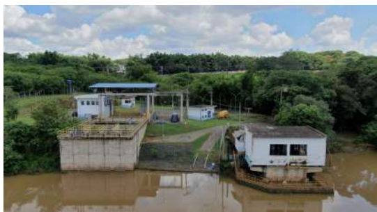
Foto 22 - Vista aérea das Captações Superficiais. À esquerda a nova captação (3) e à direita a antiga captação (2).
