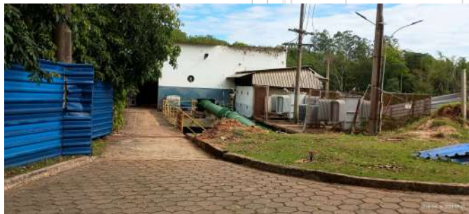
Foto 3 - Vista geral do prédio da antiga captação.
