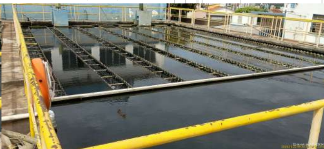
Foto 28 - Decantadores do módulo I (ETA I).
