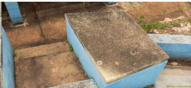
Foto 2 - Tampa do reservatório em boa condição.
