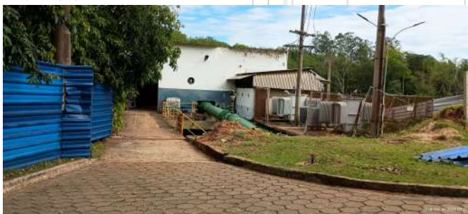
Foto 3 - Vista geral do prédio da antiga captação.
