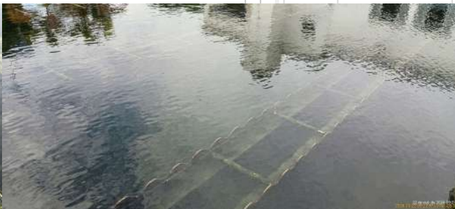
Foto 18 - Decantadores do módulo II (ETA II).
