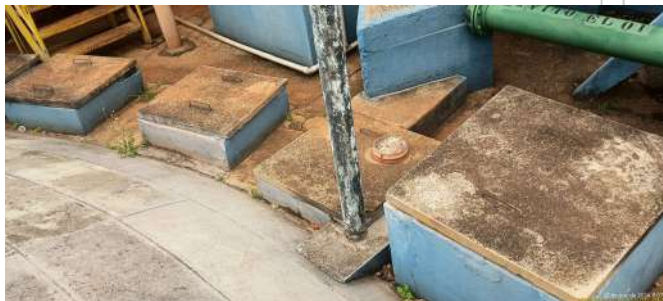
Foto 3 - Tampas do reservatório em boas condições.
