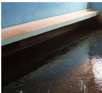
Foto 33 - Filtros do módulo I (ETA I).
