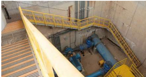
Foto 14 - Escada de acesso aos conjuntos motobomba.
