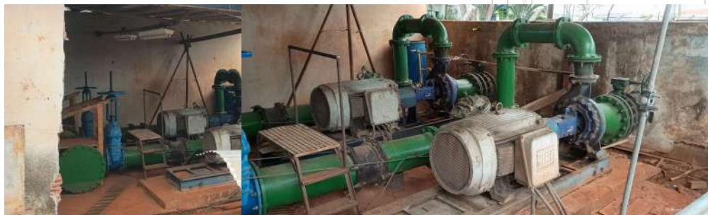
Foto 1 - Vista geral da EEAT.
