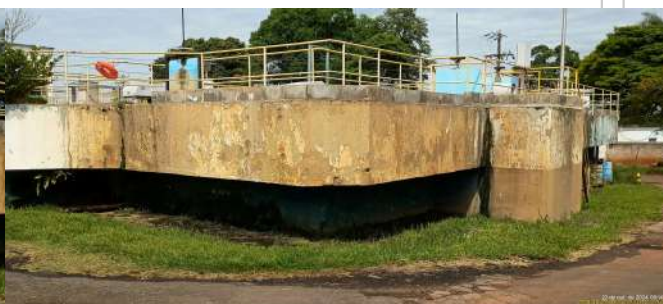
Foto 10 - Visto externa do módulo II (ETA II).
