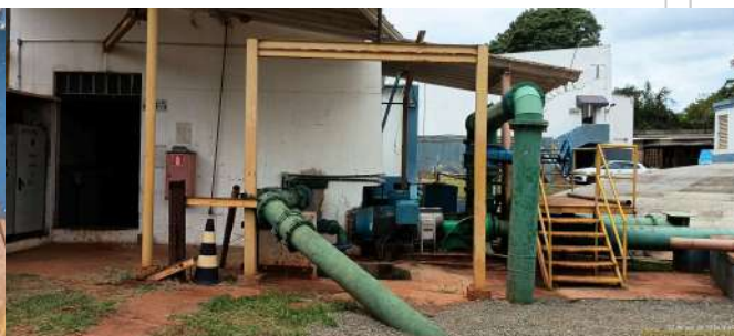
Foto 19 - Vista geral externa da EEAT.
