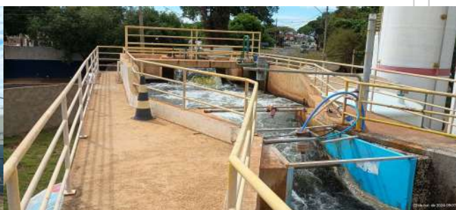
Foto 2 - Chegada de água bruta e aplicação de produtos químicos no início do processo.
