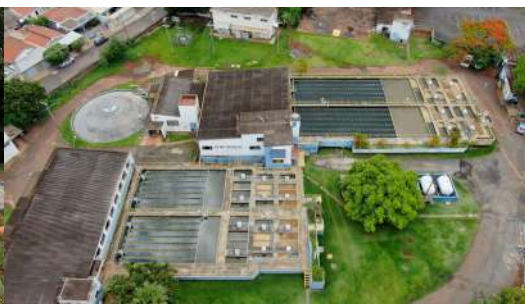
Foto 4 - Vista aérea da ETA.
