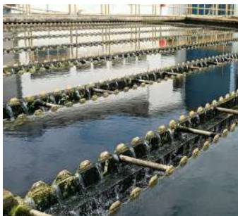
Foto 29 - Decantadores do módulo I (ETA I).
