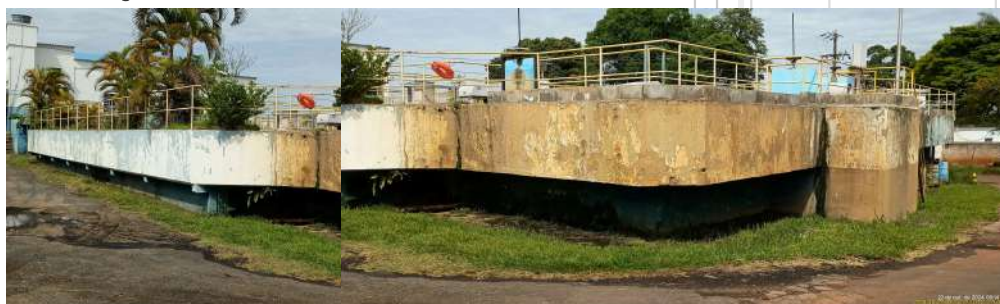
Foto 9 - Visto externa do módulo II (ETA II).
