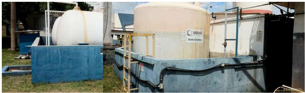
Foto 3 - Bacia de contenção e identificação do ácido fluossilícico.
