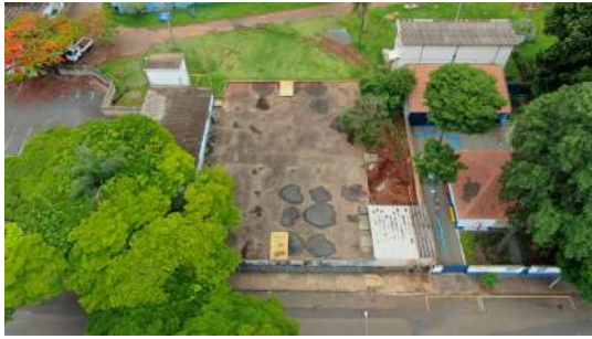
Foto 4 - Vista aérea do reservatório semienterrado da ETA II.
