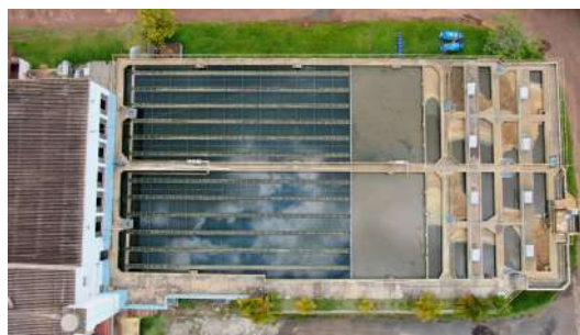
Foto 59 - Vista aérea da ETA II.
