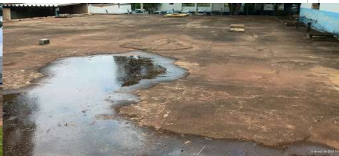
Foto 2 - Laje do reservatório.
