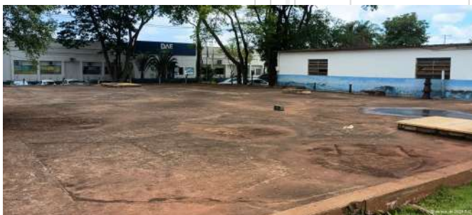
Foto 3 - Vista geral do reservatório.
