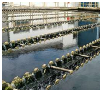
Foto 29 - Decantadores do módulo I (ETA I).
