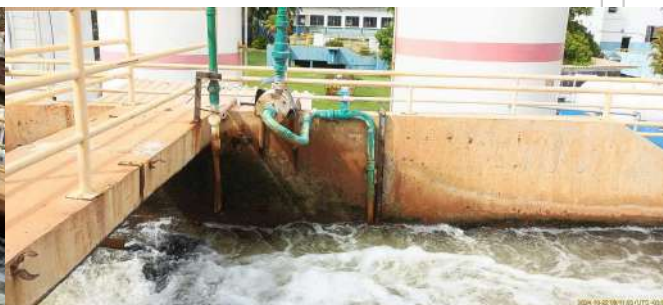
Foto 6 - Aplicação de carvão na água bruta.
