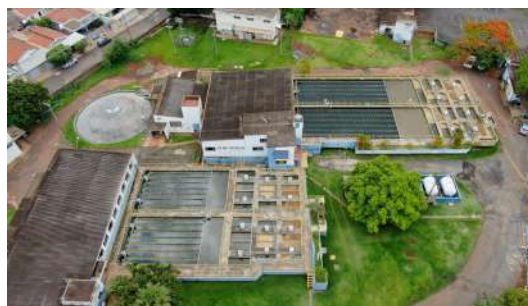
Foto 57 - Vista aérea dos módulos I e II (ETAs I e II). ETA I (antiga e menor volume tratado) situada na parte inferior e ETA II (mais nova e com maior capacidade de volume tratado) na parte superior da imagem.
