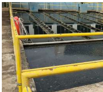
Foto 27 - Decantadores do módulo I (ETA I).
