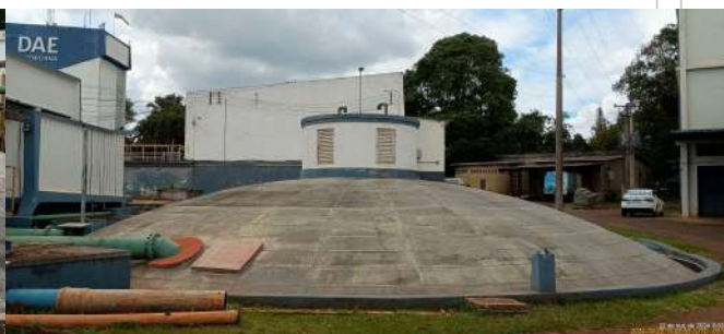
Foto 2 - Vista geral do reservatório.
