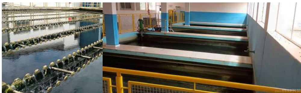
Foto 29 - Decantadores do módulo I (ETA I).
