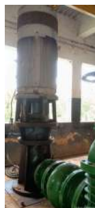
Foto 6 - Primeiro conjunto motobomba.
