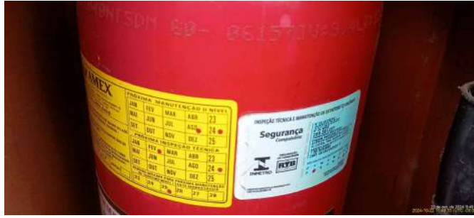
Foto 1 - Extintor de incêndio com validade expirada.
