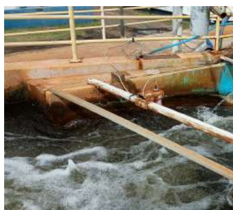
Foto 7 - Aplicação de PAC (policloreto de alumínio) na água bruta.
