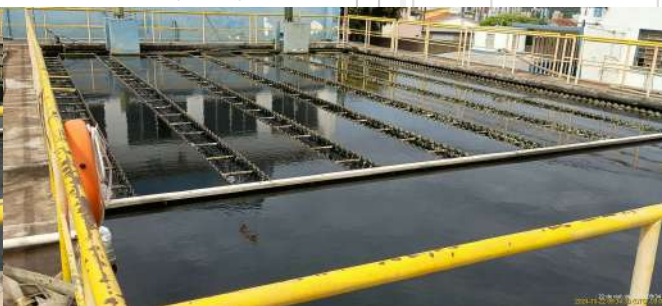
Foto 28 - Decantadores do módulo I (ETA I).
