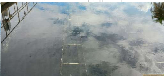
Foto 20 - Decantadores do módulo II (ETA II).
