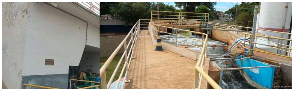
Foto 1 - Vista externa da caixa de chegada de água bruta (vinda das captações do Rio Piracicaba).
