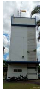
Foto 2 - Vista geral do reservatório.
