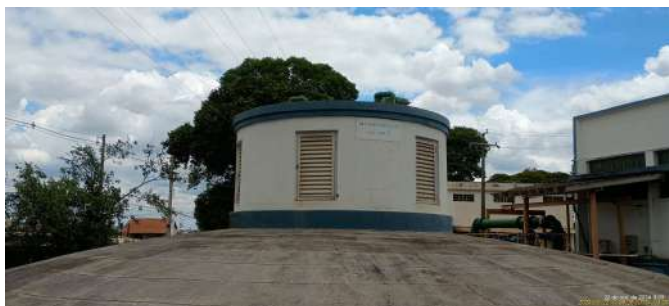
Foto 4 - Tampas do reservatório em boas condições.
