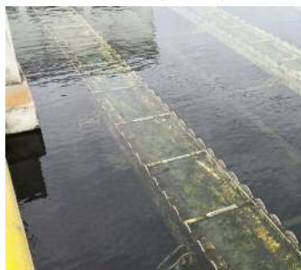
Foto 17 - Decantadores do módulo II (ETA II).
