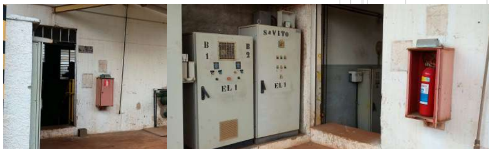
Foto 1 - Vista geral externa da EEAT.
