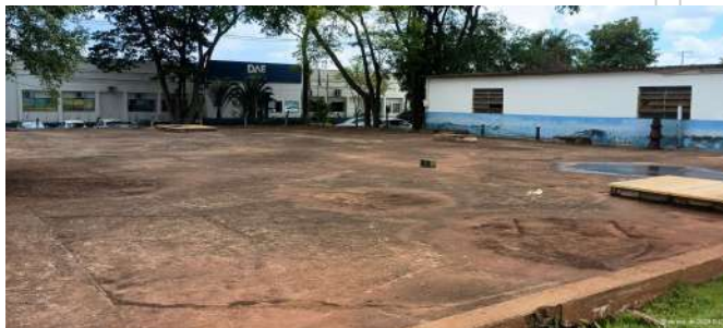
Foto 10 - Reservatório ao lado da EEAT.
