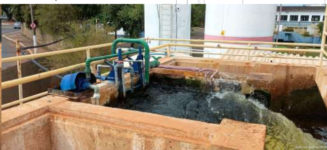
Foto 4 - Aplicação de dióxido de cloro e flúor no início do processo.
