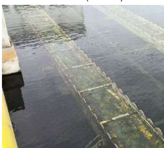
Foto 17 - Decantadores do módulo II (ETA II).
