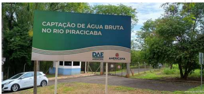
Foto 13 - Placa de identificação da Captação Superficial.
