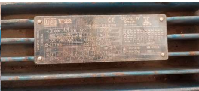
Foto 12 - Placa de especificações técnicas do motor de um dos conjuntos motobomba que recalcam para o CR São Luiz.
