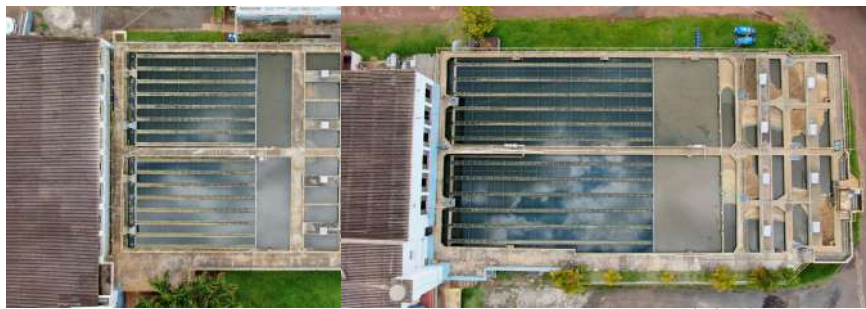
Foto 58 - Vista aérea da ETA Foto 59 - Vista aérea da ETA
