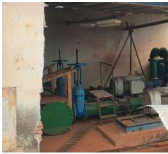
Foto 1 - Vista geral da EEAT.
