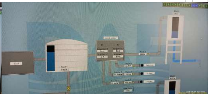
Foto 4 - Sistema de telemetria das vazões da ETA e dos reservatórios.
