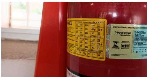
Foto 5 - Extintor de incêndio com prazo vencido.
