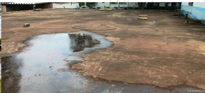
Foto 2 - Laje do reservatório.
