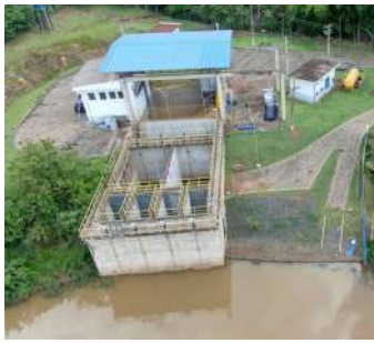
Foto 14 - Vista aérea das Captações Superficiais. À esquerda a nova captação (3) e à direita a antiga captação (2).
