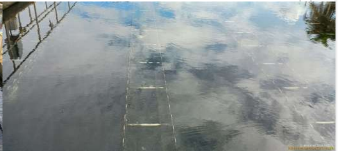
Foto 20 - Decantadores do módulo II (ETA II).
