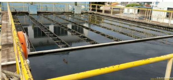
Foto 28 - Decantadores do módulo I (ETA I).
