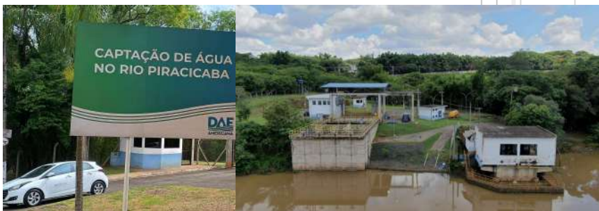
Foto 21 - Placa de identificação na entrada da Captação.
