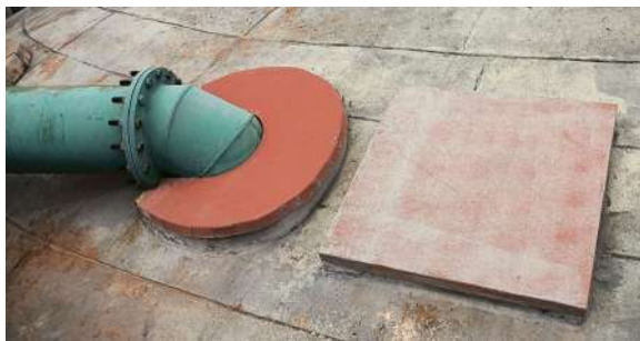
Foto 1 - Tampas do reservatório em boas condições.
