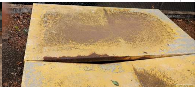
Foto 2 - Detalhe da tampa metálica.
