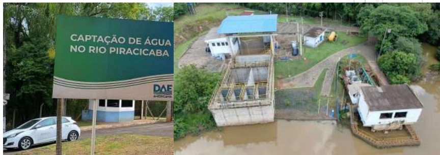
Foto 13 - Placa de identificação da Captação Superficial.
