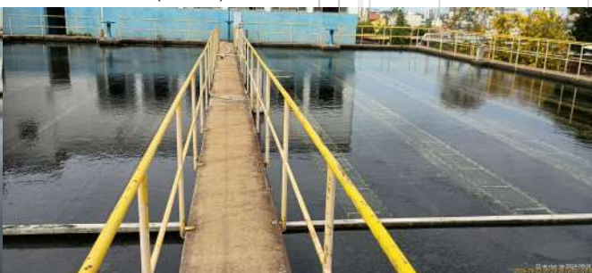
Foto 16 - Decantadores do módulo II (ETA II).
