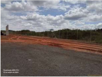
Foto 3 - Cercamento com alambrado.
