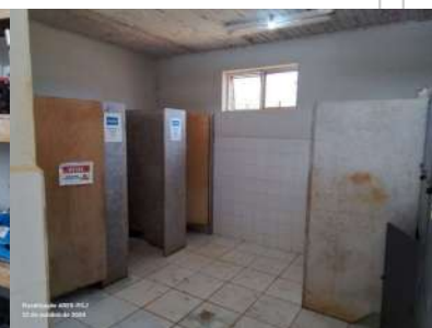
Foto 9 - Vista do vestiário de funcionários.
