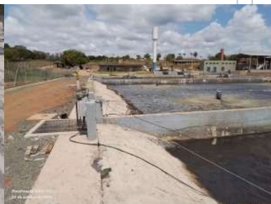
Foto 33 - Concreto utilizado para segurar as lonas de revestimento nos três tanques da unidade A.
