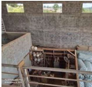
Foto 67 - Futura área de depósito.
