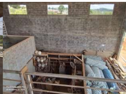
Foto 67 - Futura área de depósito.
