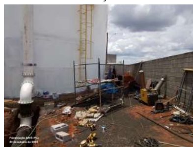
Foto 4 - Vista geral do reservatório.
