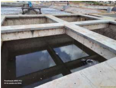
Foto 42 - Tanque de aeração final da unidade A com agitador em manutenção (etapa 1).
