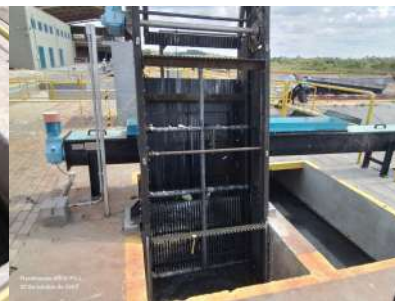
Foto 13 - Gradeamento fino de entrada mecanizado.
