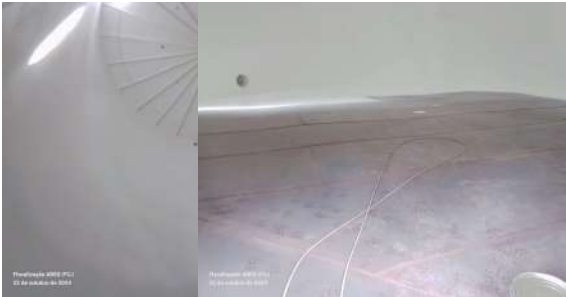
Foto 8 - Teto do interior em acabamento final. Foto 9 - Fundo do interior em acabamento final.
