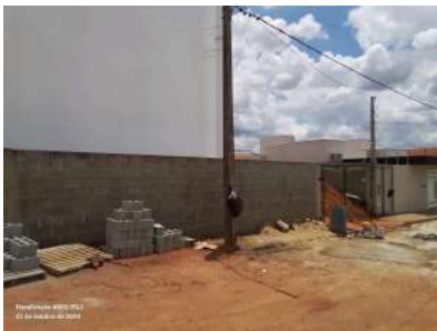
Foto 1 - Muro de alvenaria.
