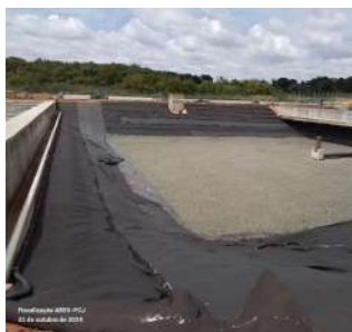
Foto 47 - Tanque de aeração 1B em construção (etapa 2).
