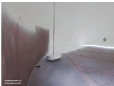
Foto 7 - Parede do interior em acabamento final.
