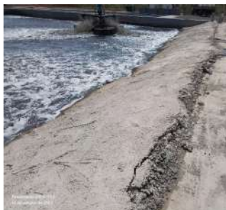
Foto 32 - Concreto utilizado para segurar as lonas de revestimento nos três tanques da unidade A.
