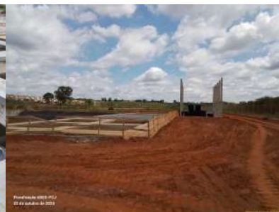
Foto 43 - Vista do tanque de contato em construção da unidade B (etapa 2).
