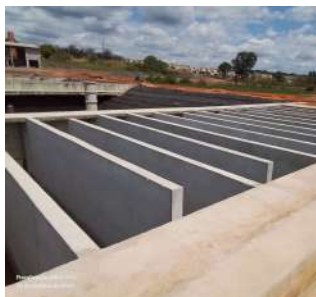
Foto 45 - Vista do tanque de contato em construção da unidade B (etapa 2).
