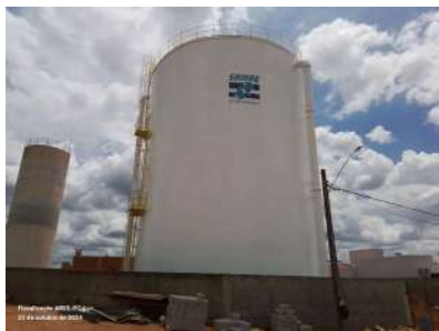
Foto 1 - Vista geral do reservatório.
