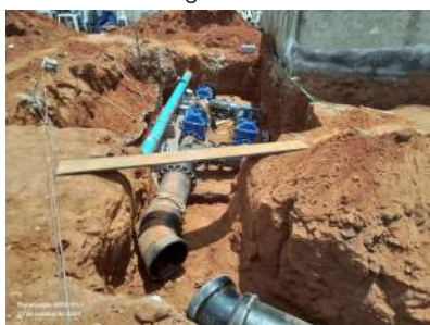
Foto 3 - Instalação da adutora.
