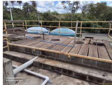
Foto 10 - Sequência de 3 tanques anaeróbios (conjunto 1).
