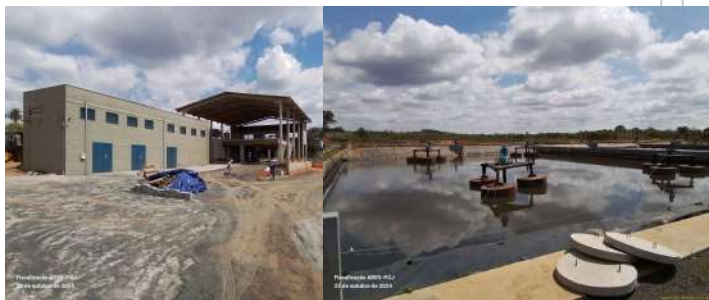
Foto 24 - Vista da casa de força e painéis elétricos de operação e galpão de tratamento de lodo ao fundo.
