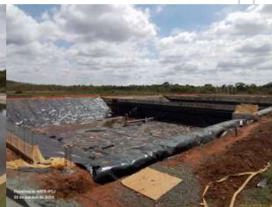
Foto 23 - Vista da unidade de tratamento 2 em construção (etapa 2).
