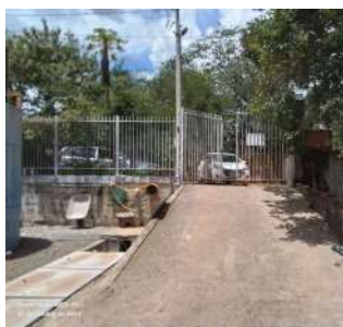
Foto 20 - Entrada da ETE.
