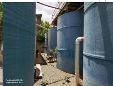
Foto 19 - Vista da parte inferior do conjunto 1.
