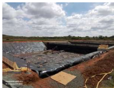
Foto 23 - Vista da unidade de tratamento 2 em construção (etapa 2).
