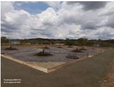
Foto 13 - Vista do tanque 2.
