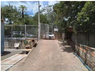
Foto 20 - Entrada da ETE.
