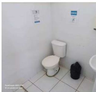
Foto 6 - WC do prédio administrativo.
