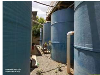
Foto 19 - Vista da parte inferior do conjunto 1.
