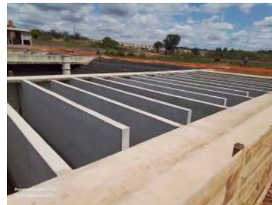
Foto 45 - Vista do tanque de contato em construção da unidade B (etapa 2).
