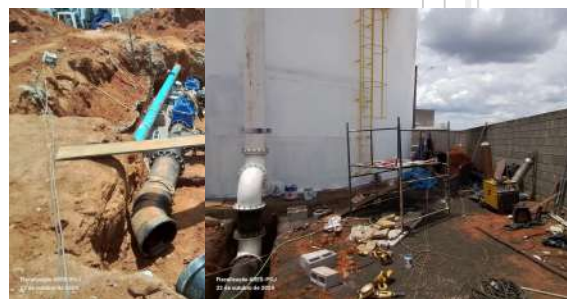
Foto 3 - Instalação da adutora.
