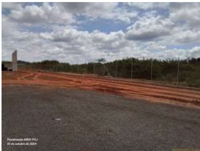
Foto 3 - Cercamento com alambrado.
