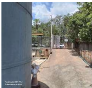
Foto 18 - Entrada da ETE.
