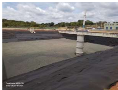
Foto 51 - Tanque de aeração 2B em construção (etapa 2).
