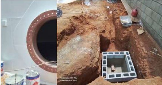
Foto 10 - Escotilha de acesso inferior. Foto 11 - Caixas de passagem.
