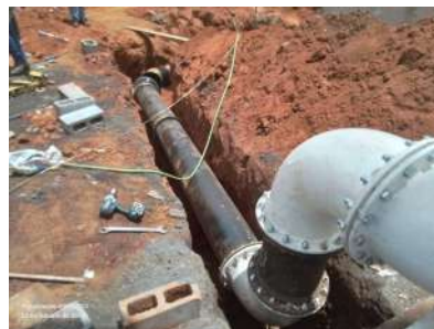
Foto 2 - Instalação da adutora.
