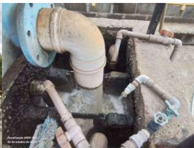
Foto 9 - Pós peneira onde se aplicam os bacilos.
