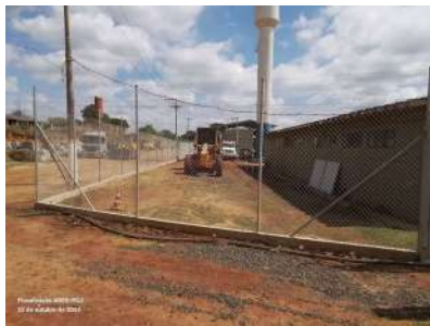
Foto 2 - Cercamento com alambrado.
