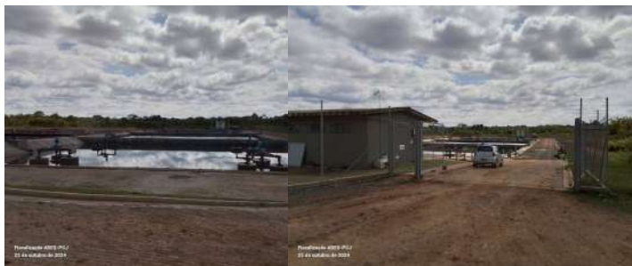
Foto 1 - Vista dos tanques A da etapa 1.
