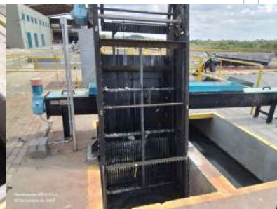
Foto 13 - Gradeamento fino de entrada mecanizado.
