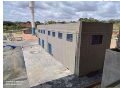
Foto 68 - Vista da casa de força e painéis elétricos de operação.
