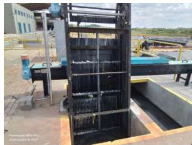
Foto 13 - Gradeamento fino de entrada mecanizado.
