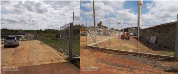
Foto 1 - Portão de acesso. Foto 2 - Cercamento com alambrado.
