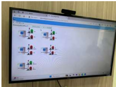
Foto 11 - Aba: Elevatórias de esgoto.
