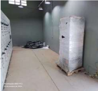
Foto 75 - Local instalação dos painéis de controle da unidade B (etapa 2).
