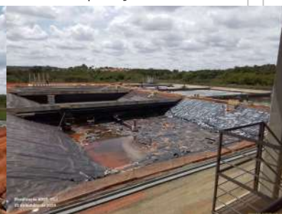
Foto 70 - Vista da unidade B de tratamento em construção (etapa 2).
