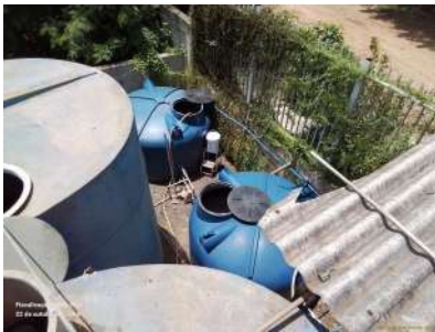
Foto 17 - Vista dos tanques de organismos aplicados no sistema.
