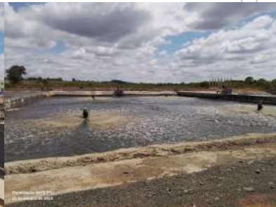
Foto 29 - Vista do tanque de aeração 2A com 4 aeradores. Recebe todo o efluente de entrada e funciona com aeração contínua.
