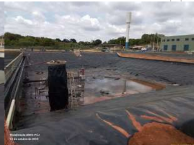
Foto 52 - Tanque de aeração 3B em construção (etapa 2).
