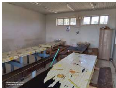
Foto 4 - Vista da área do refeitório.
