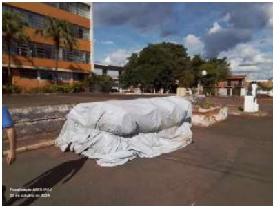
Foto 1 - Conjuntos esticados na ETA para instalação.
