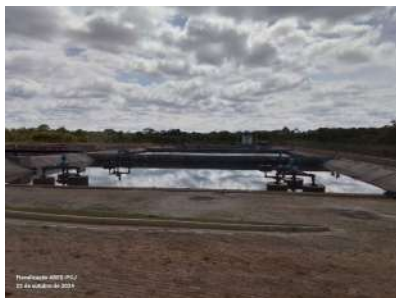
Foto 1 - Vista dos tanques A da etapa 1.
