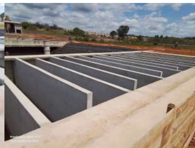
Foto 45 - Vista do tanque de contato em construção da unidade B (etapa 2).
