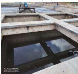
Foto 42 - Tanque de aeração final da unidade A com agitador em manutenção (etapa 1).
