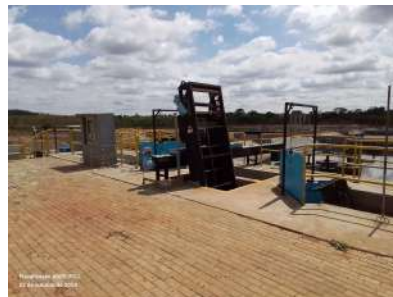
Foto 11 - Vista do tratamento preliminar reformado.
