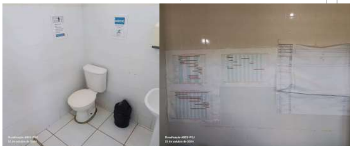
Foto 6 - WC do prédio administrativo.
