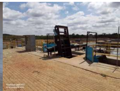
Foto 11 - Vista do tratamento preliminar reformado.
