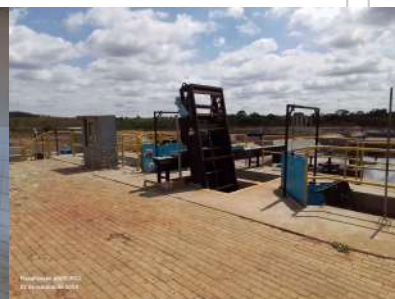
Foto 11 - Vista do tratamento preliminar reformado.
