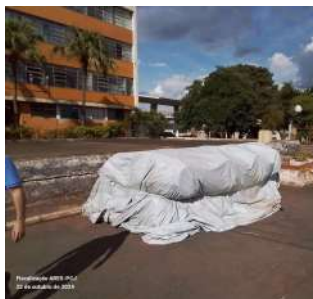
Foto 1 - Conjuntos esticados na ETA para instalação.
