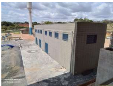
Foto 68 - Vista da casa de força e painéis elétricos de operação.
