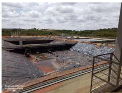
Foto 70 - Vista da unidade B de tratamento em construção (etapa 2).
