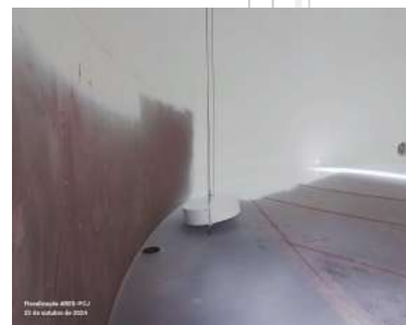
Foto 7 - Parede do interior em acabamento final.
