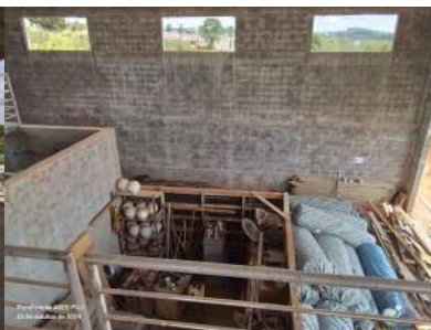
Foto 67 - Futura área de depósito.
