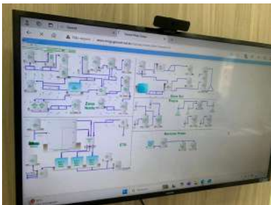
Foto 1 - Vista geral do sistema cadastrado.
