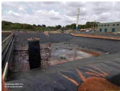
Foto 52 - Tanque de aeração 3B em construção (etapa 2).
