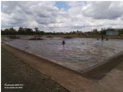
Foto 1 - Vista do aerador parado no tanque 2.
