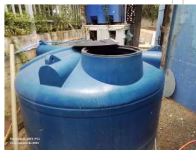
Foto 5 - Tanque de organismos autóctones que consomem o lodo produzido. São aplicados no tanque de mistura.
