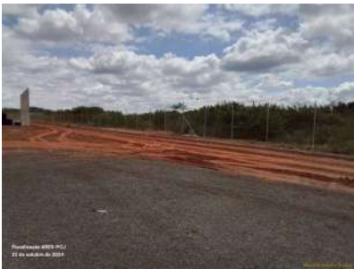
Foto 3 - Cercamento com alambrado.
