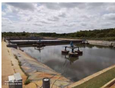
Foto 22 - Vista da unidade de tratamento A (etapa 1).
