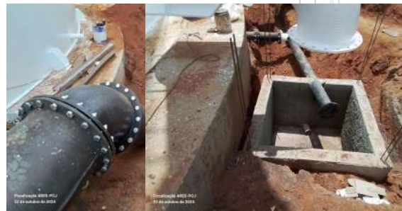
Foto 5 - Instalação da adutora.
