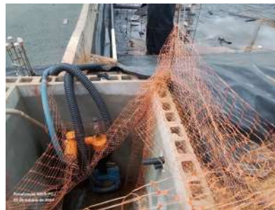
Foto 53 - Primeira válvula automática de saída do tanque 3B (etapa 2).
