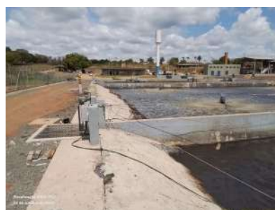
Foto 33 - Concreto utilizado para segurar as lonas de revestimento nos três tanques da unidade A.
