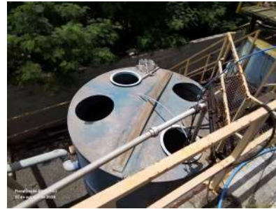
Foto 12 - Tanque mistura que onde se aplica os organismos autóctones e manda pros dois tanques novos anaeróbios.
