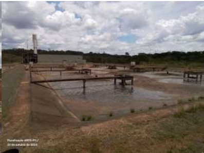
Foto 12 - Vista do tanque 1.
