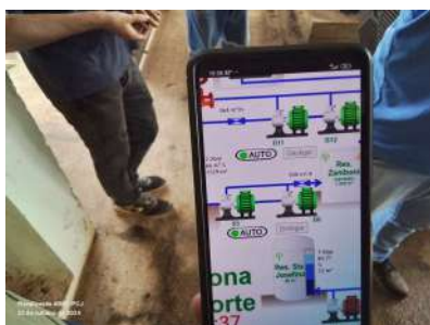
Foto 10 - CCO demonstrando a operação da EEA Zaniboni.
