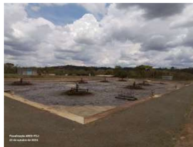
Foto 13 - Vista do tanque 2.
