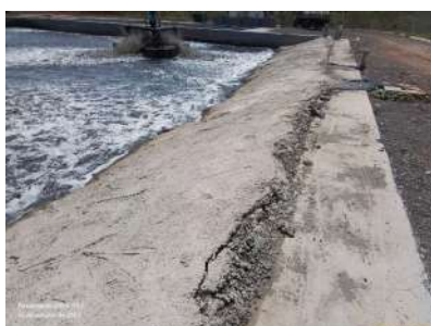
Foto 32 - Concreto utilizado para segurar as lonas de revestimento nos três tanques da unidade A.
