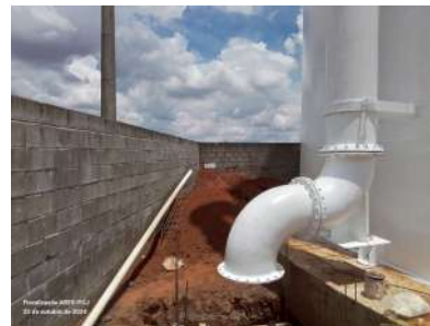
Foto 2 - Muro de alvenaria.
