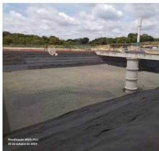
Foto 51 - Tanque de aeração 2B em construção (etapa 2).
