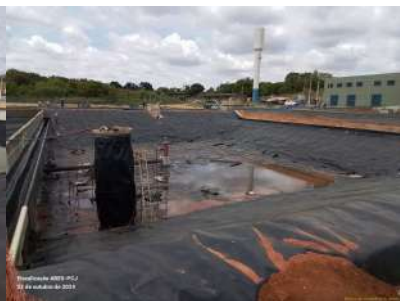
Foto 52 - Tanque de aeração 3B em construção (etapa 2).
