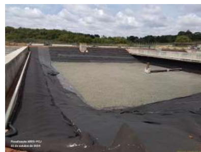
Foto 47 - Tanque de aeração 1B em construção (etapa 2).
