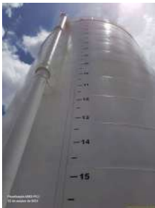
Foto 1 - Medidor de nível.
