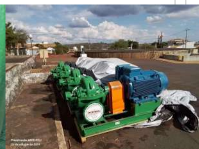
Foto 7 - Bombas estocadas na ETA.
