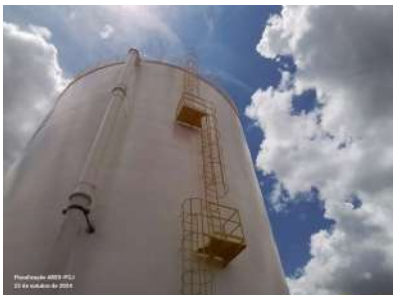
Foto 1 - Guarda corpo do reservatório.
