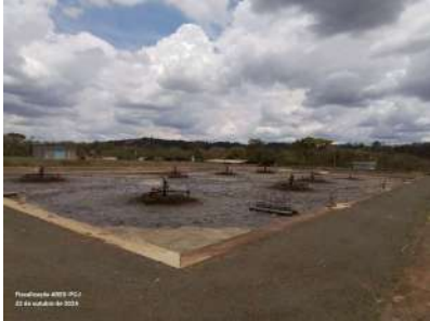
Foto 13 - Vista do tanque 2.
