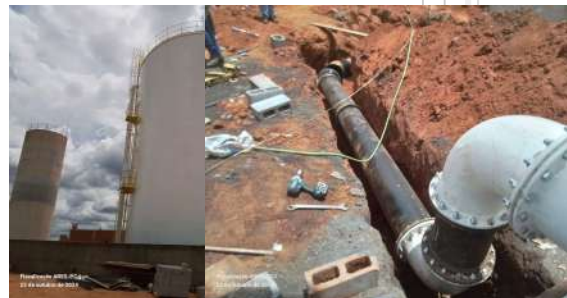
Foto 1 - Vista geral do reservatório.
