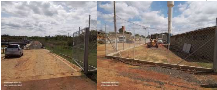
Foto 1 - Portão de acesso.
