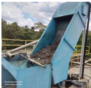
Foto 8 - Peneira para remoção dos sólidos de entrada.
