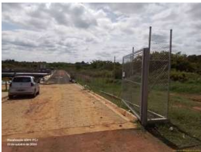
Foto 1 - Portão de acesso.
