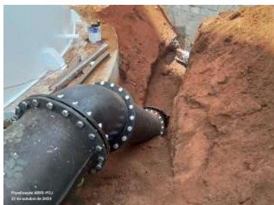
Foto 5 - Instalação da adutora.
