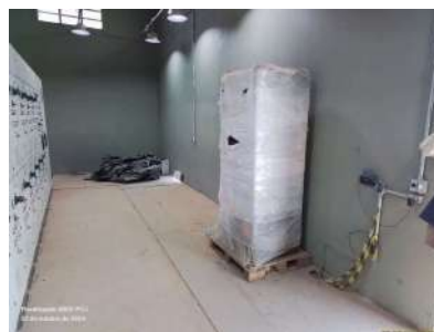
Foto 75 - Local instalação dos painéis de controle da unidade B (etapa 2).
