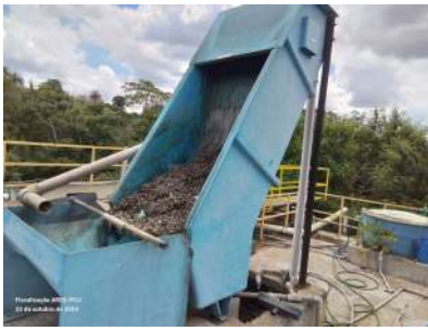
Foto 8 - Peneira para remoção dos sólidos de entrada.
