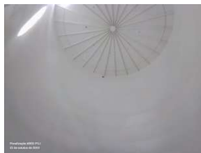
Foto 8 - Teto do interior em acabamento final.
