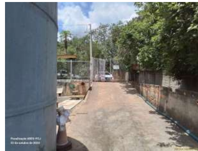
Foto 18 - Entrada da ETE.
