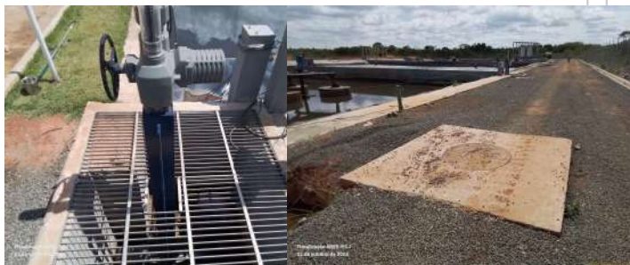
Foto 26 - Primeira válvula automática de saída do tanque 3A.
