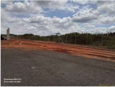
Foto 3 - Cercamento com alambrado.
