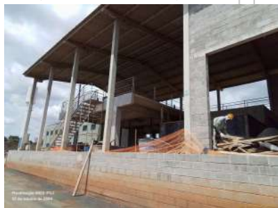
Foto 57 - Vista do sistema de tratamento de lodo (etapa 2).
