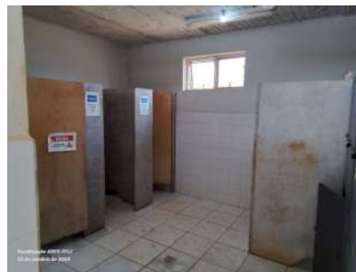
Foto 9 - Vista do vestiário de funcionários.
