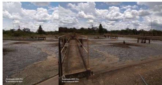
Foto 5 - Vista de um aerador no tanque 1.
