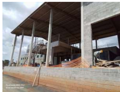
Foto 57 - Vista do sistema de tratamento de lodo (etapa 2).
