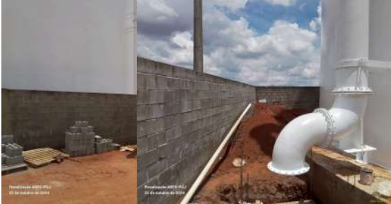
Foto 1 - Muro de alvenaria. Foto 2 - Muro de alvenaria.
