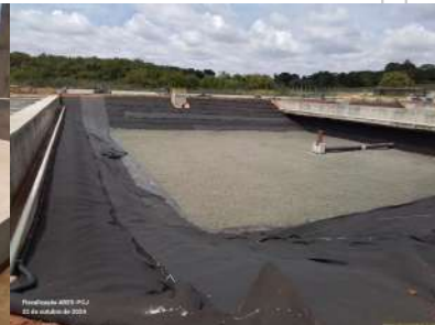
Foto 47 - Tanque de aeração 1B em construção (etapa 2).
