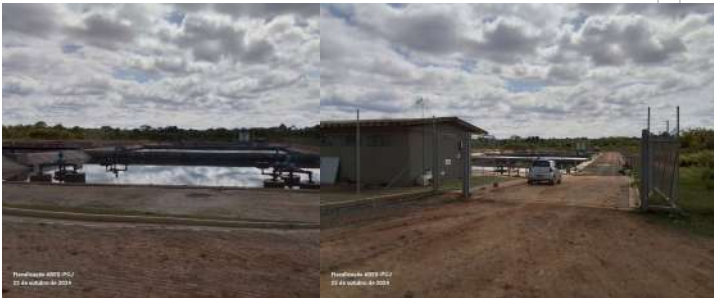
Foto 1 - Vista dos tanques A da etapa 1. Foto 2 - Vista de entrada da ETE.
