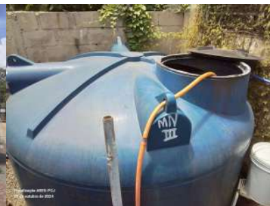
Foto 2 - Tanque de bacilos que são aplicados na entrada do tratamento. Corrige o pH e alimenta as colônias de bactérias.
