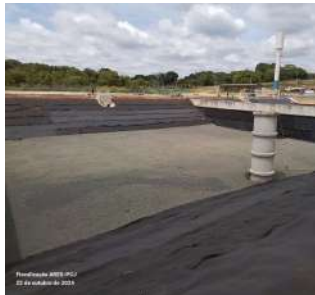
Foto 51 - Tanque de aeração 2B em construção (etapa 2).
