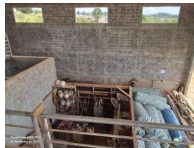
Foto 67 - Futura área de depósito.
