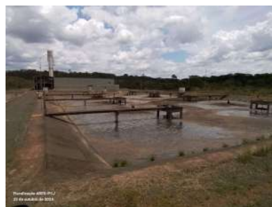
Foto 12 - Vista do tanque 1.
