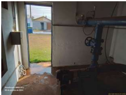
Foto 1 - Porta de acesso à EEA.
