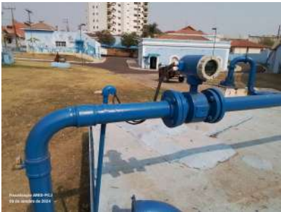
Foto 2 - Macro do poço UC01-P2, que junta com o cavalete do poço UC01-P1.
