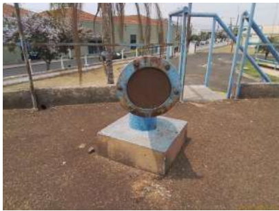
Foto 2 - Tubulação de ventilação do reservatório R1.
