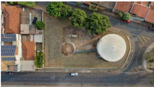
Foto 5 - Vista aérea do local onde se situa o reservatório.
