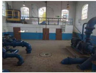
Foto 2 - Ao fundo, porta de acesso à elevatória.
