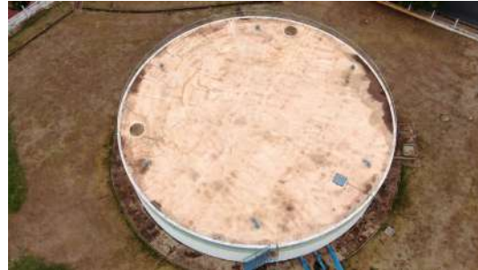
Foto 9 - Vista aérea do reservatório R2.
