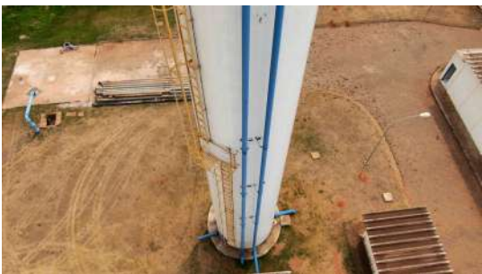
Foto 2 - Guarda-corpo do reservatório.
