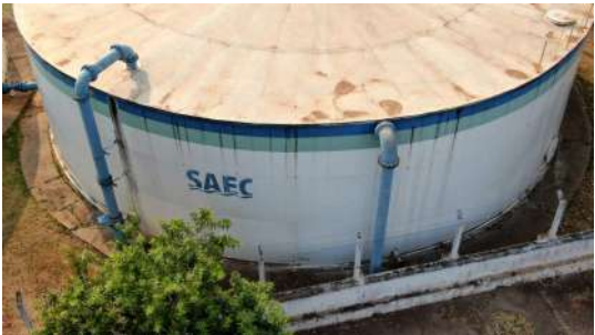
Foto 3 - Vista geral do reservatório apoiado.
