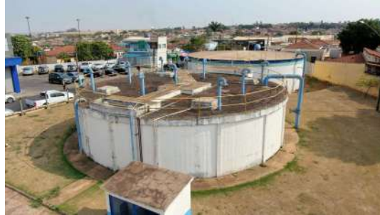
Foto 3 - Vista geral do reservatório apoiado de concreto.
