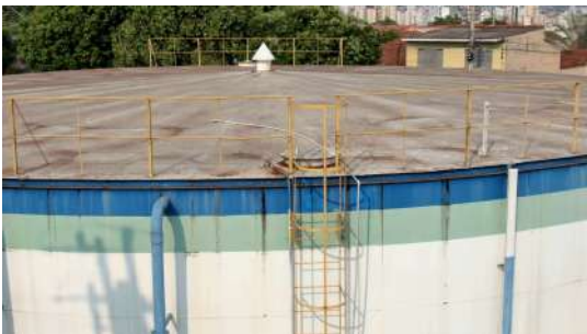
Foto 2 - Tampa de inspeção.
