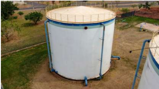
Foto 1 - Guarda-corpo do reservatório.
