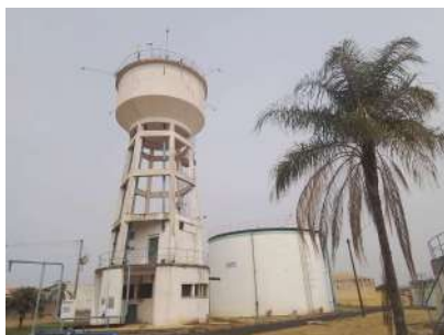
Foto 3 - Vista geral do reservatório (primeiro plano).
