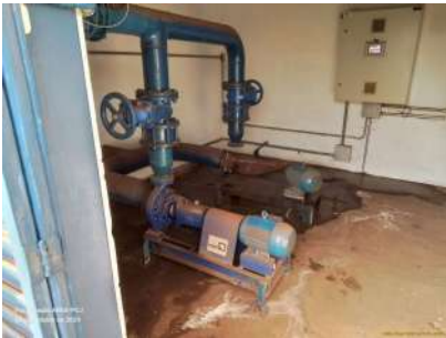
Foto 2 - Vista do interior da edificação da EEA.
