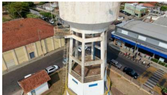
Foto 9 - Vista geral do reservatório.
