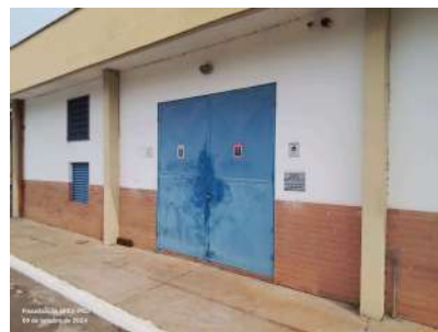
Foto 13 - Vista externa da edificação que abriga os painéis elétricos da EEE.
