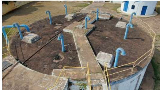
Foto 5 - Vista geral do reservatório apoiado de concreto.
