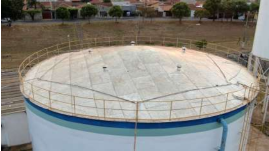
Foto 3 - Guarda-corpo no topo do reservatório.
