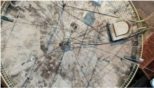
Foto 2 - Tapa de inspeção.
