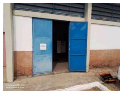
Foto 17 - Edificação que abriga os geradores da EEE.
