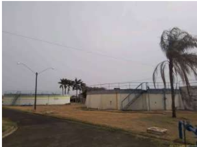
Foto 2 - Vista geral dos reservatórios vasos comunicantes. (R1 à direita e R2 à esquerda).
