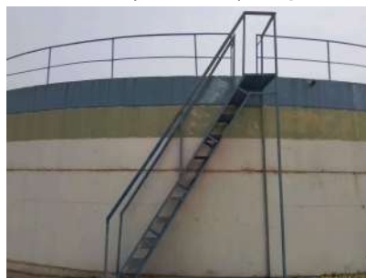
Foto 4 - Vista geral dos guarda-corpos do reservatório R2.
