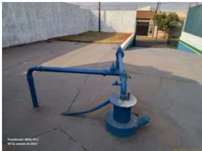
Foto 3 - Vista geral do poço.
