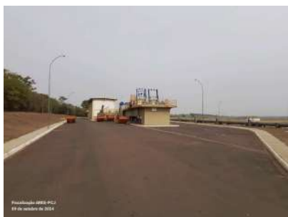
Foto 12 - Vista geral do tratamento preliminar.
