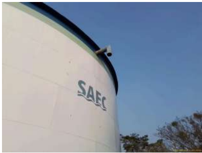
Foto 1 - Tubo extravasor do reservatório.
