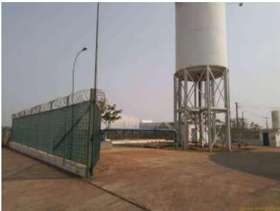
Foto 2 - Vista geral do local onde se situa o poço.
