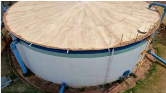
Foto 3 - Guarda-corpo do reservatório.
