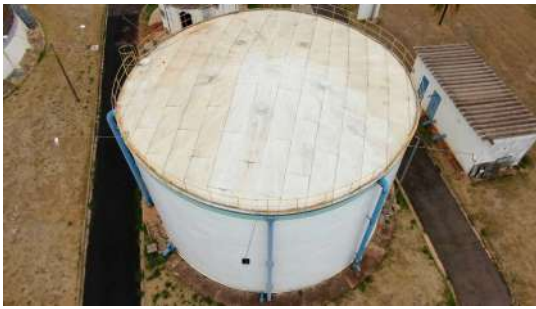
Foto 1 - Tampa de inspeção à esquerda.
