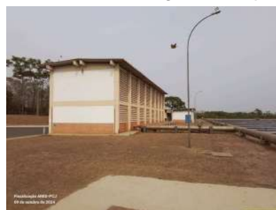
Foto 27 - Casa dos sopradores.
