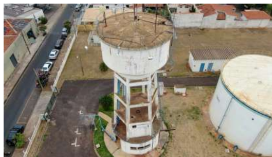
Foto 6 - Vista aérea do reservatório.
