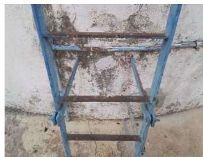
Foto 4 - Detalhe do guarda-corpo da escada do reservatório.
