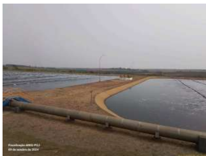
Foto 23 - Vista geral das lagoas de aeração com a caixa de distribuição das lagoas ao centro.
