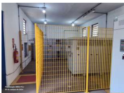
Foto 16 - Vista geral da casa de força.
