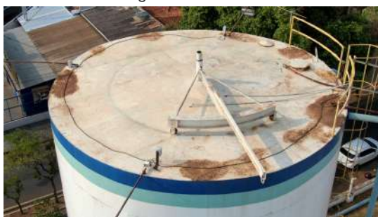
Foto 6 - Vista geral do reservatório elevado.
