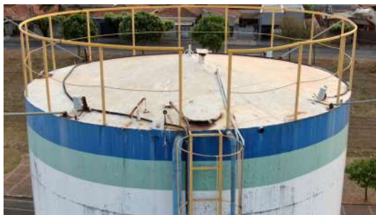
Foto 3 - Guarda-corpos no topo do reservatório.
