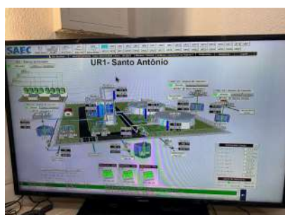
Foto 1 - Interface de monitoramento da unidade no CCO.
