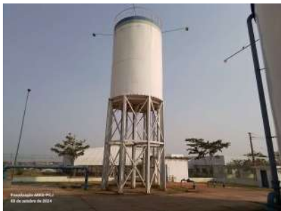
Foto 1 - Vista geral do reservatório.
