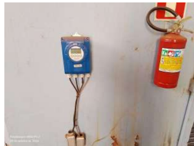
Foto 4 - Visor do macromedidor de vazão.
