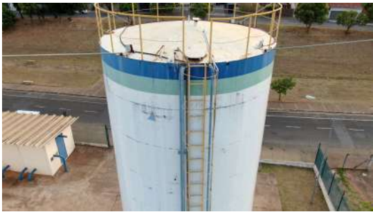
Foto 4 - Guarda-corpo da escada.
