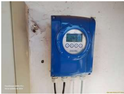
Foto 4 - Visor do macromedidor de vazão.
