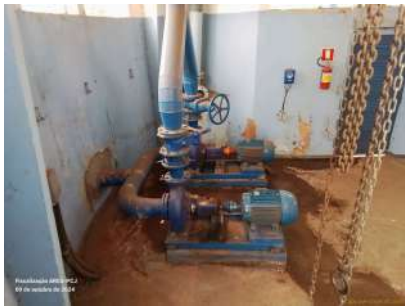
Foto 2 - Vista do interior da edificação da EEA.
