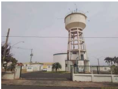
Foto 1 - Vista geral do local onde se situa o reservatório.
