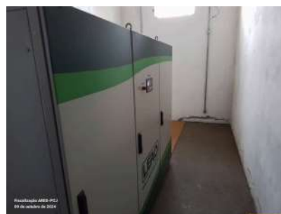
Foto 19 - Painel de controle do gerador da EEE.
