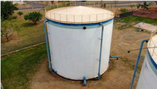
Foto 4 - Vista geral do reservatório apoiado 2.
