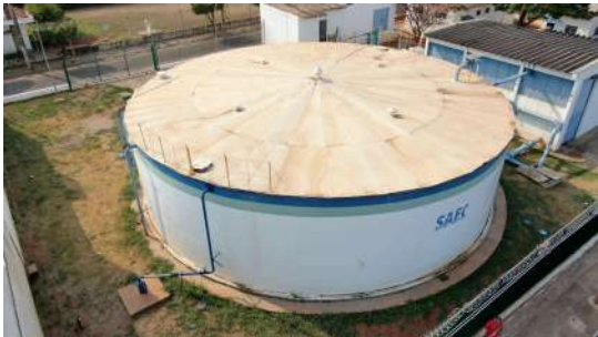
Foto 5 - Vista geral do reservatório.
