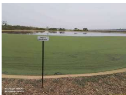
Foto 43 - Vista da lagoa de decantação.
