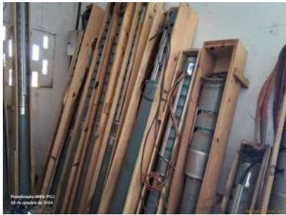
Foto 3 - Bombas reservas de poços.
