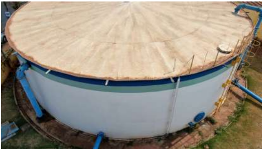
Foto 2 - Vista geral do reservatório apoiado metálico.
