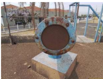
Foto 1 - Tela de proteção do reservatório R1.
