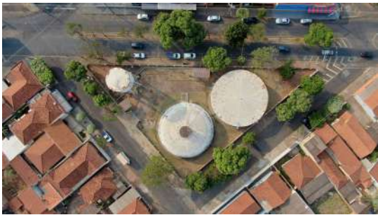
Foto 1 - Vista geral dos reservatórios. Apoiado metálico à direita, semienterrado de concreto ao centro e elevado metálico à esquerda.
