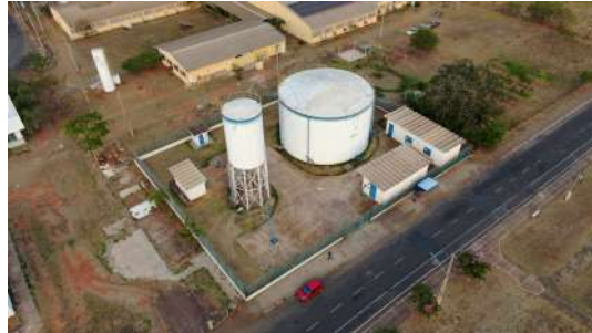
Foto 4 - Vista aérea do local onde se situa o reservatório.
