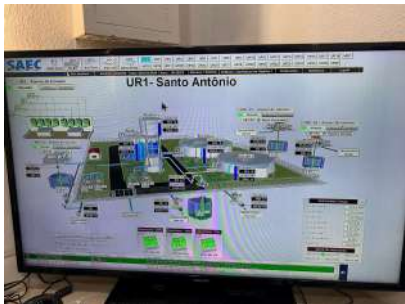
Foto 1 - Interface de monitoramento da unidade no CCO.
