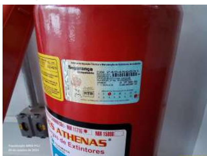
Foto 3 - Inspeção de segurança realizada em abril de 2024.
