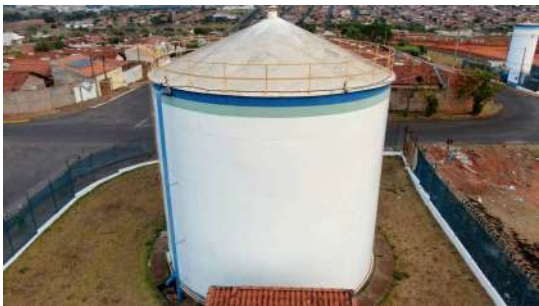
Foto 4 - Vista aérea do reservatório.
