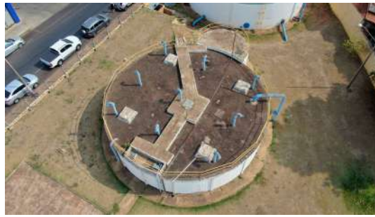
Foto 2 - Vista geral do reservatório apoiado de concreto.
