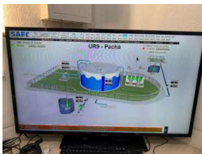
Foto 5 - Interface de monitoramento da unidade no CCO.
