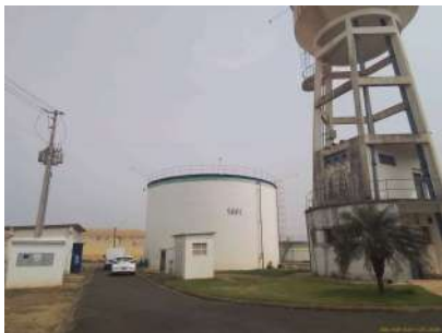
Foto 2 - Vista geral do reservatório (ao fundo).
