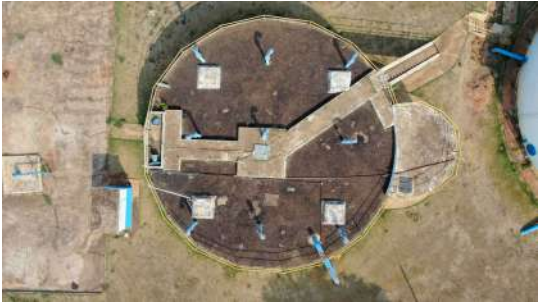
Foto 1 - Tampa de inspeção no centro.
