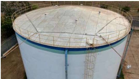
Foto 1 - Tampa de inspeção do reservatório.
