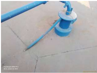
Foto 1 - Laje de proteção do poço.
