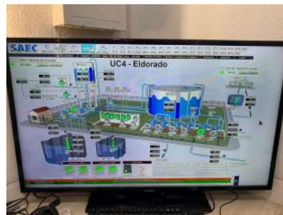
Foto 4 - Interface de monitoramento da unidade no CCO.
