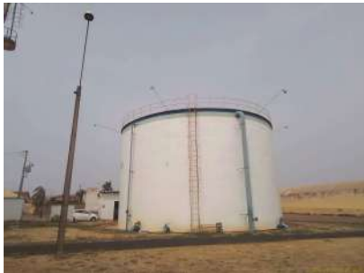
Foto 4 - Vista geral do reservatório.
