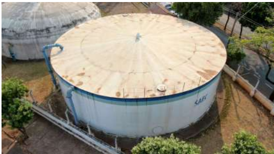
Foto 1 - Guarda-corpo do reservatório.
