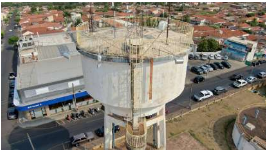
Foto 4 - Vista geral do reservatório.
