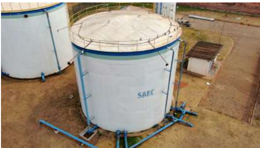
Foto 5 - Vista geral do reservatório apoiado 1.
