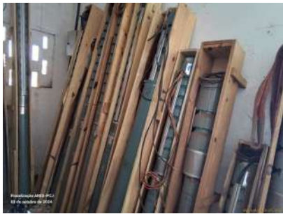
Foto 3 - Depósito de bombas reservas de poços.
