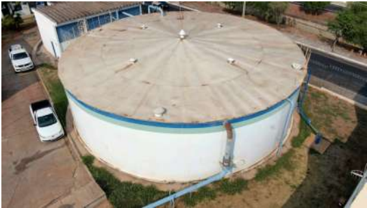
Foto 4 - Vista geral do reservatório.
