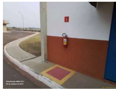
Foto 6 - Extintor de incêndio localizado no exterior do prédio da oficina e do almoxarifado.
