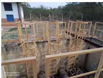
Foto 11 - Escadas de acesso às tubulações das bombas.
