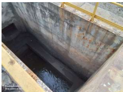
Foto 3 - Poço de chegada de esgoto.
