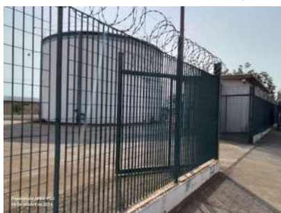
Foto 5 - Vista externa da EEAT.
