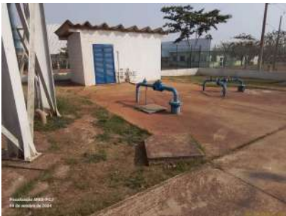
Foto 2 - Vista geral do "poço falso".
