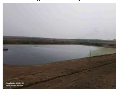
Foto 42 - Vista geral da lagoa de decantação 2.
