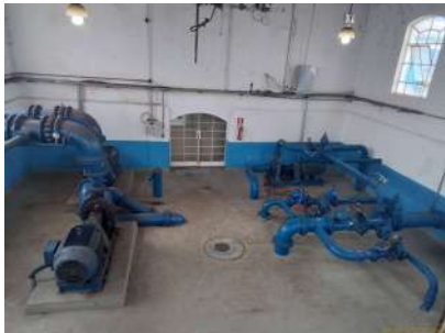
Foto 2 - Vista superior das duas elevatórias de água presentes no local.
