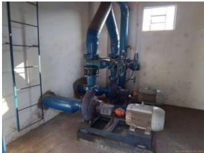
Foto 3 - Vista geral do interior da edificação da EEA.
