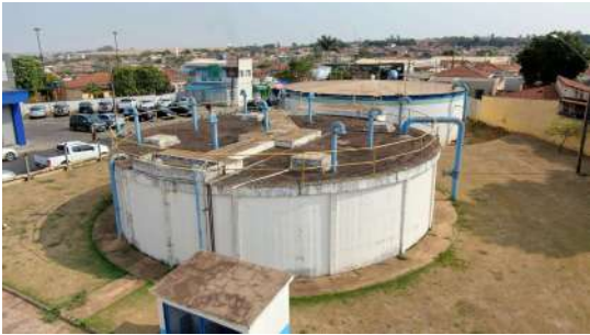
Foto 1 - Guarda-corpo do reservatório.
