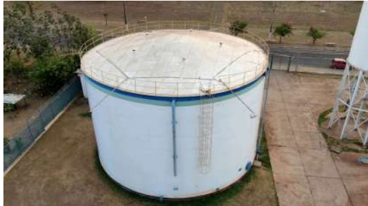
Foto 3 - Vista aérea do reservatório.
