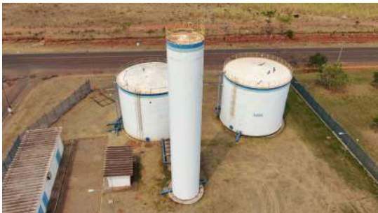
Foto 1 - Vista geral dos reservatórios.
