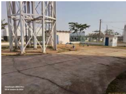
Foto 1 - Vista geral do "poço falso".
