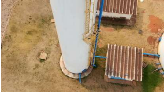
Foto 6 - Guarda-corpo do reservatório.
