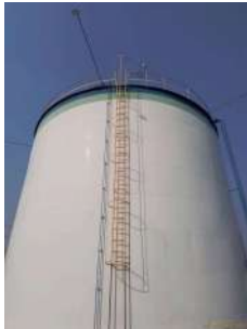
Foto 1 - Guarda-corpos na escada e no topo do reservatório.
