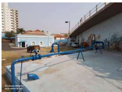
Foto 3 - Poço UC01-P1 ao fundo e macromedidor do poço UC01-P2 a frente (tubulação).
