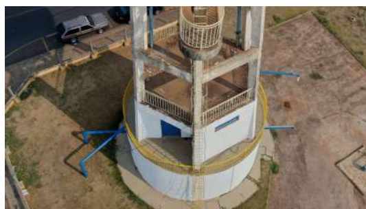
Foto 4 - Guarda-corpo do reservatório.
