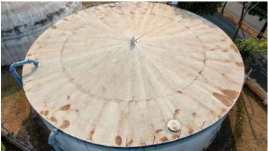
Foto 5 - Vista geral do reservatório apoiado.
