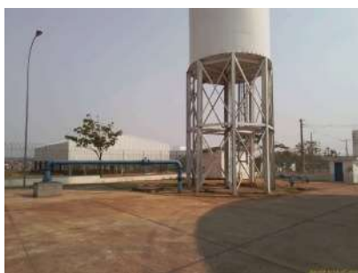
Foto 1 - Vista geral do poço UC04-P1.
