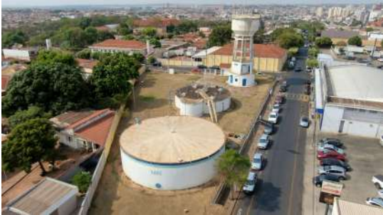
Foto 5 - Vista geral do reservatório apoiado metálico.
