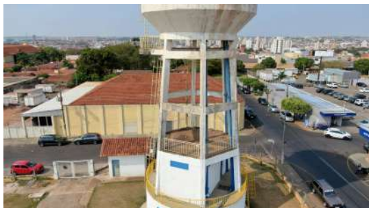
Foto 10 - Vista geral do reservatório.
