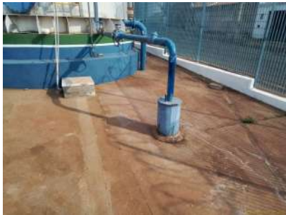
Foto 1 - Laje de proteção do poço.
