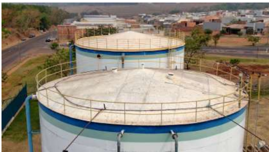
Foto 1 - Tampa de inspeção do reservatório.
