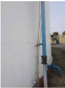
Foto 5 - Mangueiras de aplicação dos produtos químicos no reservatório.
