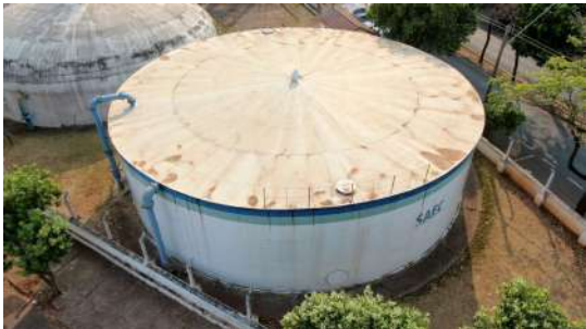
Foto 4 - Vista geral do reservatório apoiado.
