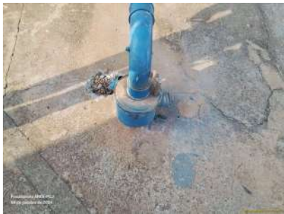
Foto 1 - Laje de proteção do poço.
