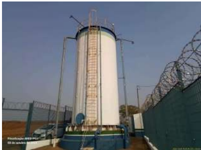
Foto 2 - Vista geral do reservatório.
