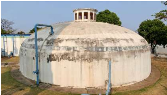
Foto 3 - Vista geral do reservatório semienterrado.
