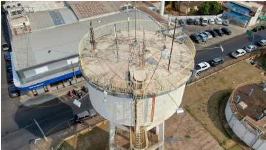
Foto 1 - Tapa de inspeção.
