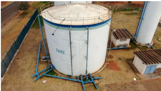
Foto 6 - Vista geral do reservatório apoiado 1.
