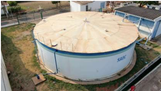
Foto 1 - Guarda-corpo do reservatório.
