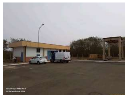
Foto 2 - Vista geral da EEE.
