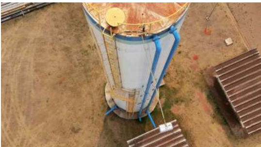
Foto 3 - Tampa de inspeção do reservatório.
