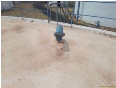
Foto 1 - Tubulação de ventilação do reservatório R2.
