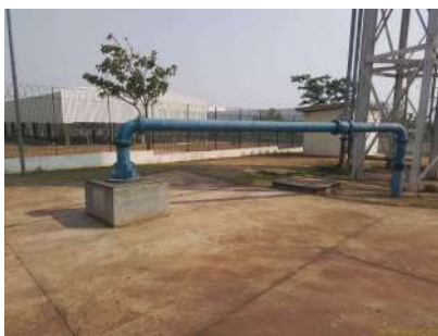
Foto 3 - Vista geral do poço UC04-P1.
