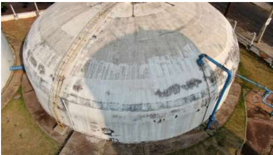
Foto 2 - Vista geral do reservatório semienterrado.
