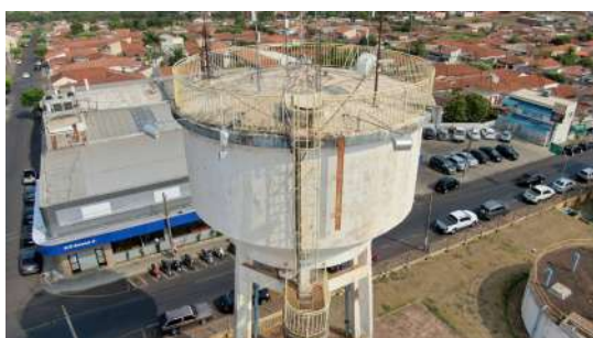
Foto 1 - Guarda-corpo do reservatório.
