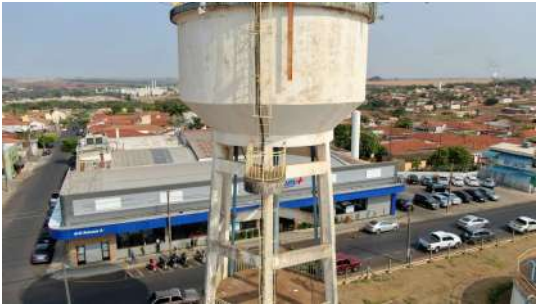
Foto 3 - Vista geral do reservatório.
