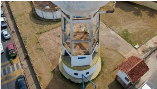
Foto 2 - Condutor de descarga descendo pelo reservatório.
