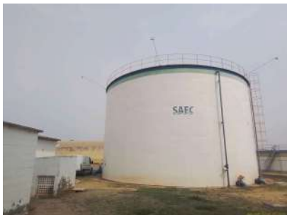
Foto 3 - Vista geral do reservatório.
