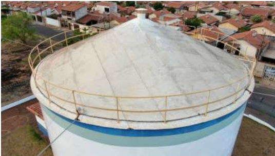
Foto 2 - Guarda-corpos no topo do reservatório.
