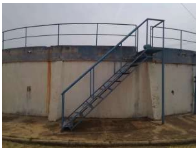
Foto 1 - Vista geral dos guarda-corpos do reservatório R1.
