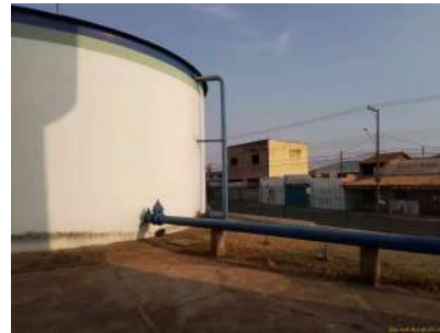
Foto 4 - Vista geral do reservatório.
