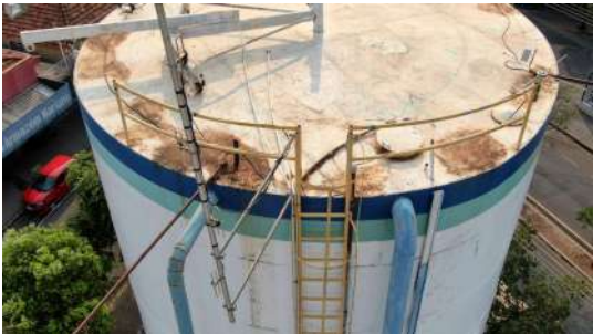
Foto 2 - Tampa de inspeção.
