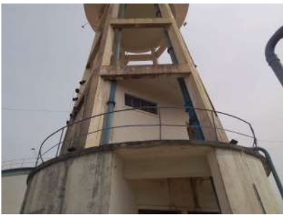
Foto 2 - Detalhe do guarda-corpo do primeiro nível do reservatório.
