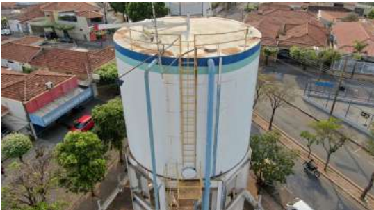
Foto 1 - Tampa de inspeção.
