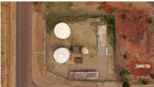
Foto 4 - Vista geral dos reservatórios.
