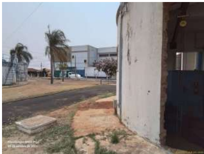
Foto 1 - Elevatória encontra-se no interior de edificação de alvenaria em local cercado com alambrado.
