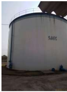
Foto 1 - Vista do reservatório.
