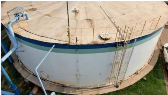
Foto 2 - Guarda-corpo do reservatório.
