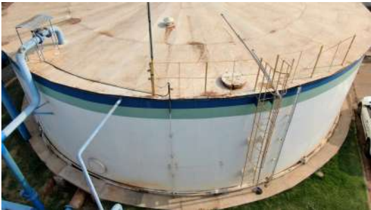
Foto 2 - Vista geral do reservatório.
