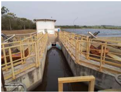
Foto 1 - Guarda-corpos no tratamento preliminar.
