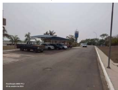
Foto 11 - Vista geral do prédio da administração.
