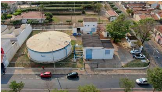
Foto 6 - Vista geral do reservatório.
