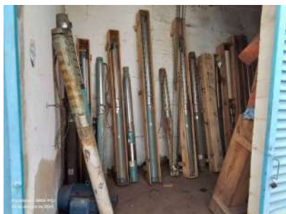
Foto 1 - Depósito de bombas reservas de poços.
