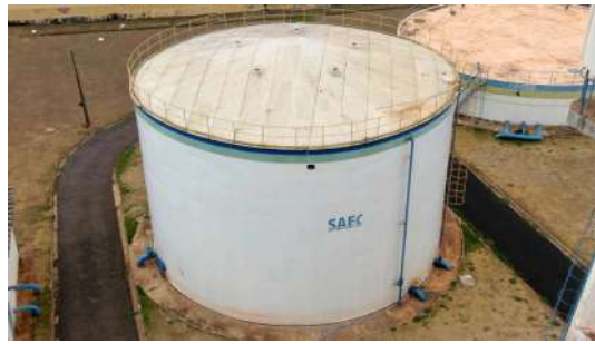
Foto 7 - Vista aérea do reservatório.
