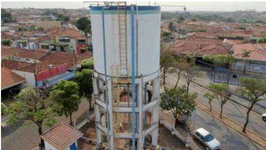
Foto 1 - Tubo extravasor do reservatório.
