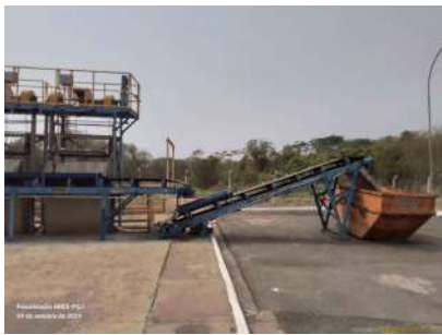
Foto 1 - Vista geral do gradeamento grossoiro.
