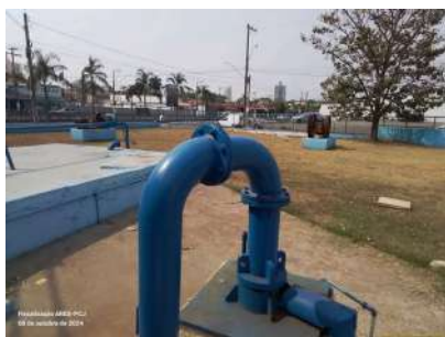
Foto 1 - Local cercado com alambrado e muro.
