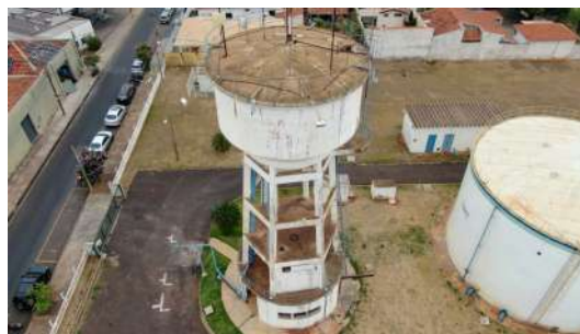
Foto 6 - Guarda-corpo no topo do reservatório.
