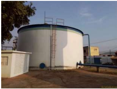
Foto 1 - Vista geral do reservatório.
