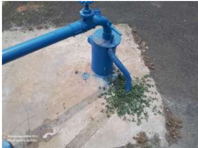
Foto 1 - Laje de proteção do poço.
