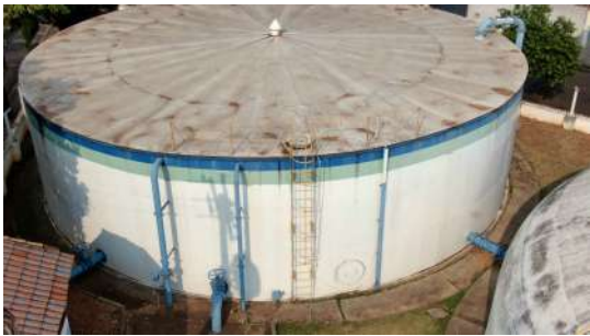
Foto 1 - Tubulações de ventilação.
