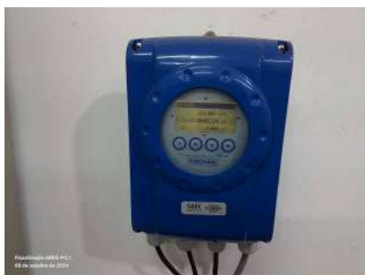
Foto 13 - Macro medidor do poço UC4 P2.
