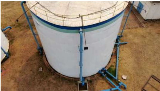
Foto 4 - Vista geral do reservatório apoiado 1.
