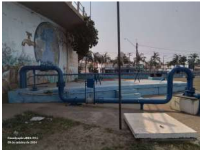
Foto 1 - Vista geral do poço UC01-P1.
