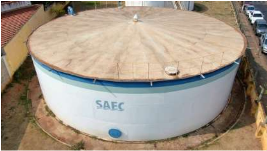
Foto 3 - Vista geral do reservatório apoiado metálico.
