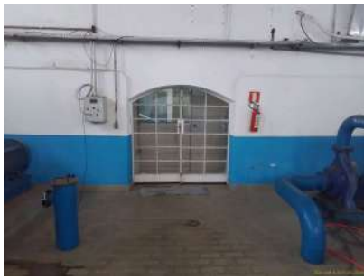
Foto 1 - Porta de acesso à elevatória.
