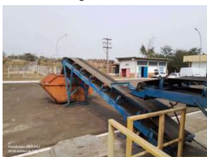
Foto 7 - Esteira de retirada de resíduos do gradeamento grosso.
