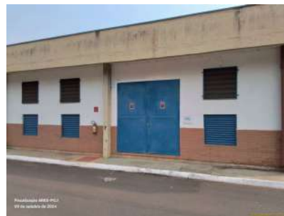
Foto 36 - Prédio da cabine de força.
