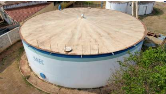
Foto 2 - Guarda-corpo do reservatório.
