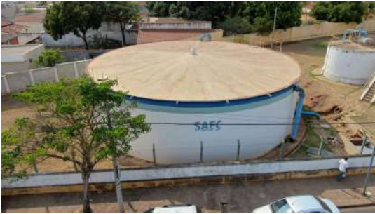
Foto 4 - Vista geral do reservatório apoiado metálico.
