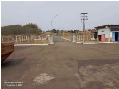
Foto 1 - Portão de acesso à EEE.
