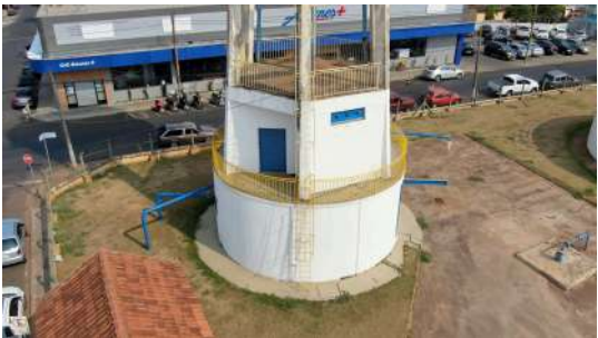
Foto 2 - Vista geral do reservatório.
