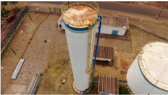
Foto 3 - Guarda-corpo do reservatório.
