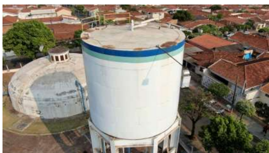
Foto 4 - Vista geral do reservatório elevado.
