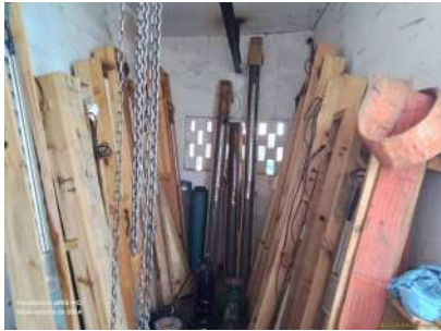
Foto 2 - Bombas reservas de poços.
