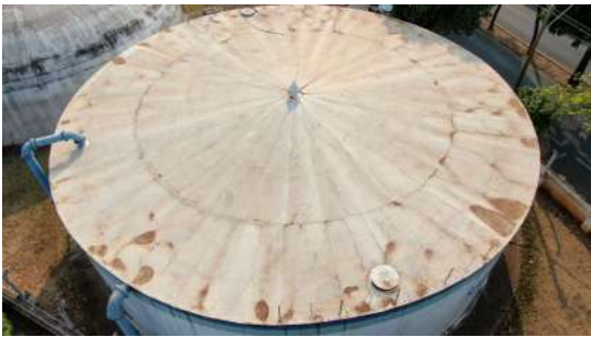
Foto 3 - Tampa de inspeção.
