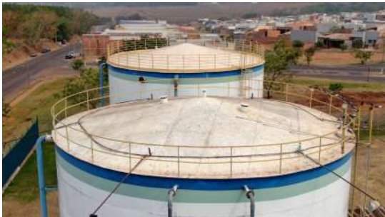
Foto 1 - Guarda-corpo do reservatório.
