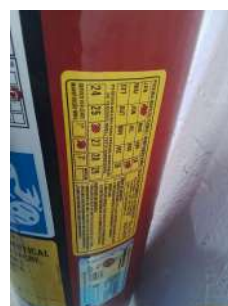
Foto 2 - Manutenção de 2º nível prevista para 2025 e manutenção de 3º nível prevista para 2026.
