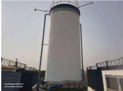
Foto 3 - Vista geral do reservatório.
