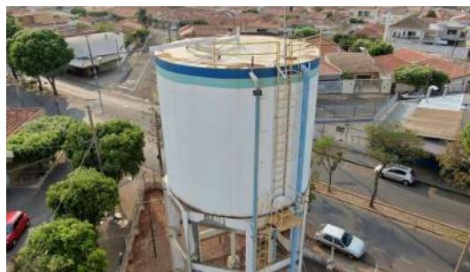
Foto 2 - Vista geral do reservatório elevado.
