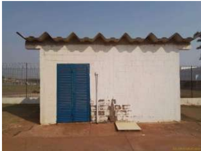
Foto 5 - Vista geral da casa de química.
