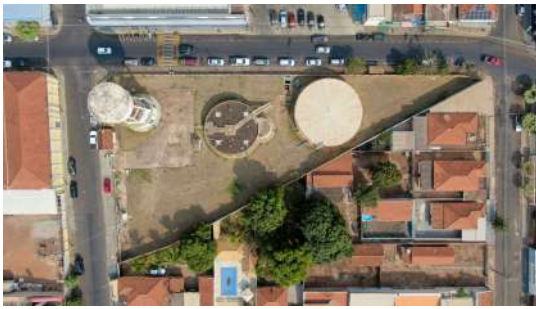
Foto 1 - Vista geral dos reservatórios. Apoiado metálico à direita, apoiado de concreto ao centro e elevado de concreto à esquerda.
