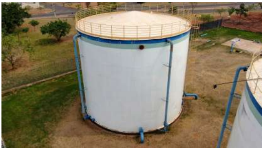
Foto 1 - Tubulações de respiro.
