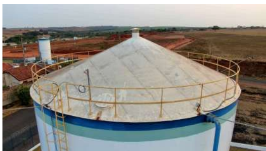
Foto 1 - Tampa de inspeção do reservatório.
