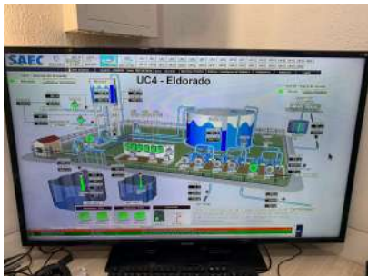
Foto 1 - Interface de monitoramento da unidade no CCO.
