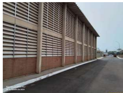
Foto 34 - Exterior do prédio que abriga a casa dos sopradores.
