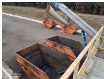
Foto 15 - Caçambas de areia.
