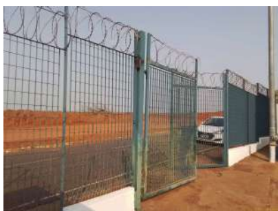
Foto 1 - Local cercado com grades.
