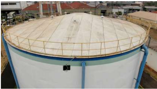
Foto 1 - Tubulação de ventilação no topo do reservatório.
