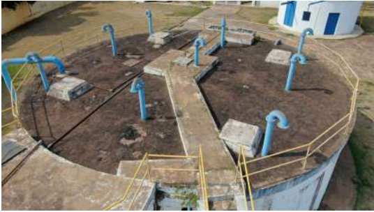
Foto 2 - Tampa de inspeção no centro.
