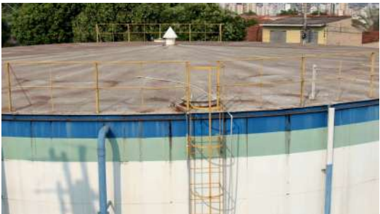
Foto 2 - Guarda-corpo do reservatório.
