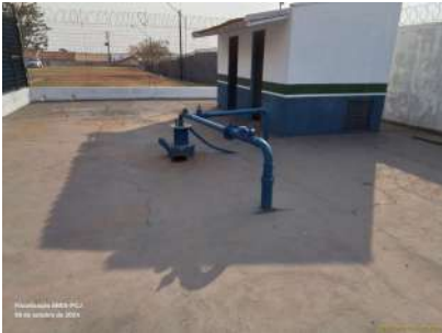
Foto 2 - Vista geral do poço.
