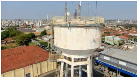
Foto 8 - Vista geral do reservatório.
