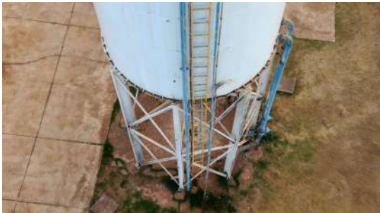
Foto 6 - Guarda-corpo da escada.
