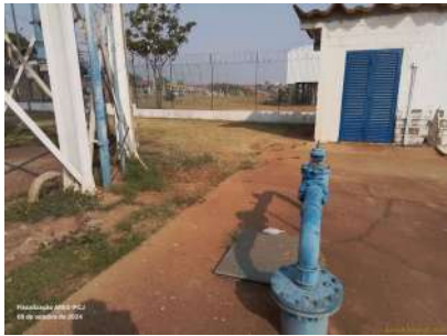
Foto 1 - Local cercado com grades.
