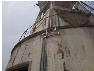
Foto 2 - Fita metálica para aterramento.
