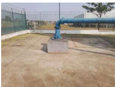
Foto 1 - Laje de proteção do poço.
