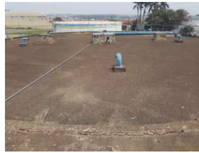
Foto 7 - Vista geral do topo do reservatório R1.
