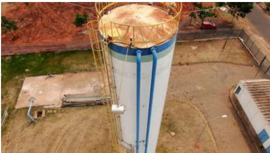
Foto 2 - Tampa de inspeção do reservatório.
