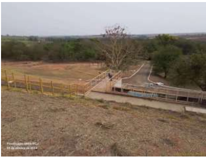
Foto 2 - Guarda-corpos na saída do esgoto da ETE.
