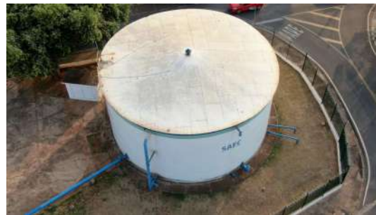
Foto 6 - Vista aérea do reservatório.
