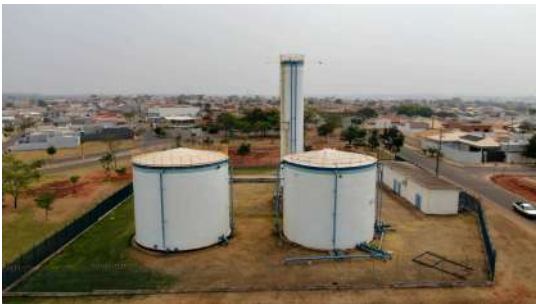
Foto 7 - Vista geral dos reservatórios.
