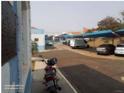
Foto 1 - Prédio que abriga o reservatório em local cercado com alambrado.
