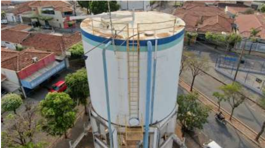
Foto 4 - Guarda-corpo do reservatório.
