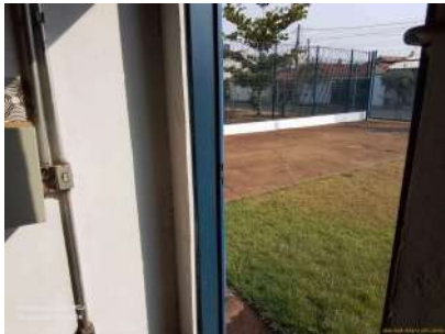
Foto 1 - Elevatória se encontra no interior de prédio em alvenaria em local cercado por grade.
