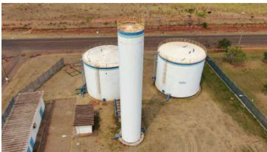
Foto 1 - Vista geral dos reservatórios.
