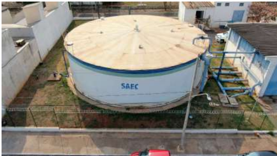
Foto 1 - Vista geral do reservatório.
