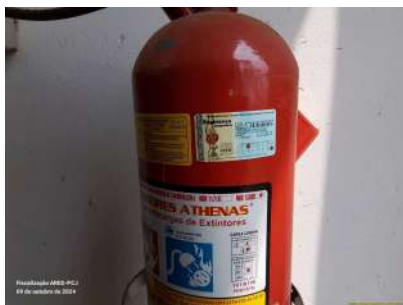
Foto 3 - Última manutenção realizada em março de 2024.
