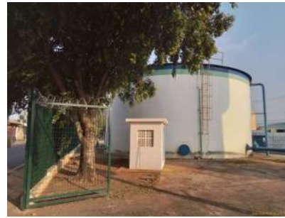
Foto 2 - Vista geral do reservatório.
