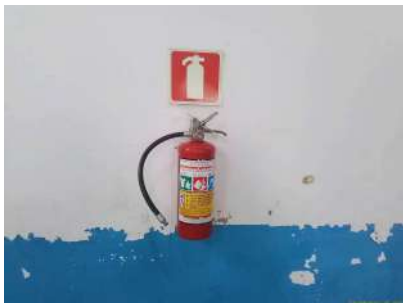
Foto 1 - Presença de extintor de incêndio na sala que abriga os painéis elétricos.
