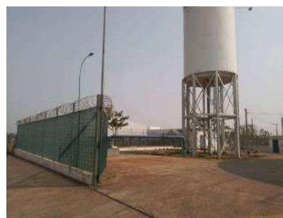
Foto 2 - Vista geral do local onde se situa o poço.
