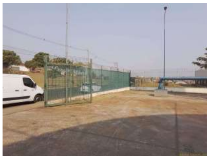
Foto 1 - Local cercado com grades.
