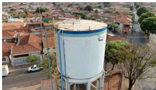
Foto 3 - Vista geral do reservatório elevado.
