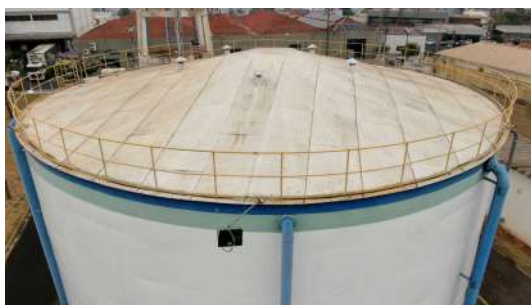
Foto 2 - Guarda-corpo no topo do reservatório.
