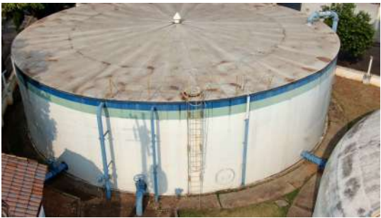
Foto 2 - Vista geral do reservatório apoiado.
