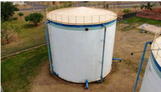
Foto 2 - Tampa de inspeção.
