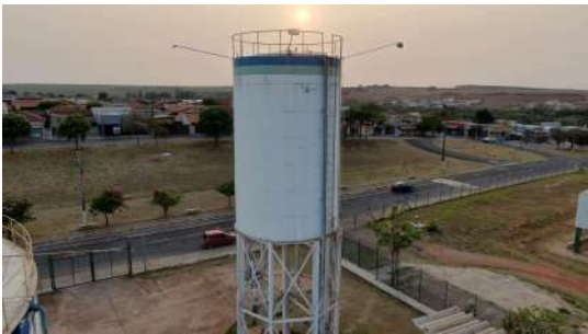
Foto 4 - Vista aérea do reservatório.
