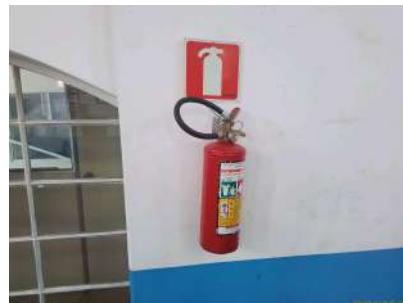
Foto 2 - Presença de extintor de incêndio no local que abriga as elevatórias.
