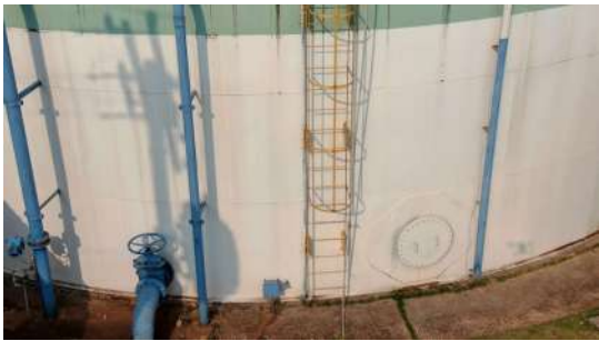
Foto 3 - Guarda-corpo do reservatório.
