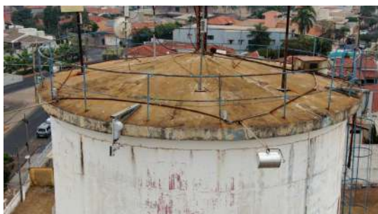
Foto 1 - Estrutura para ventilação no topo do reservatório junto à tampa de inspeção.
