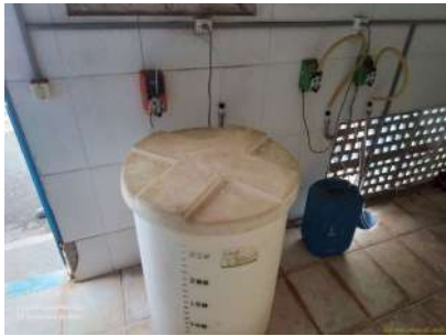
Foto 5 - Dosadora de ortopolifosfato.
