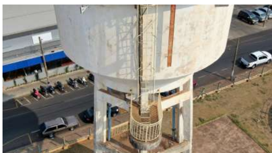
Foto 3 - Guarda-corpo do reservatório.
