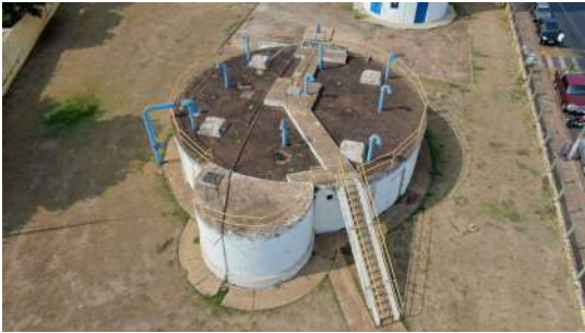
Foto 2 - Guarda-corpo do reservatório.
