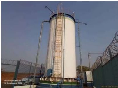
Foto 1 - Guarda-corpos na escada e em todo perímetro do topo do reservatório.
