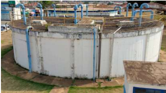
Foto 4 - Vista geral do reservatório apoiado de concreto.
