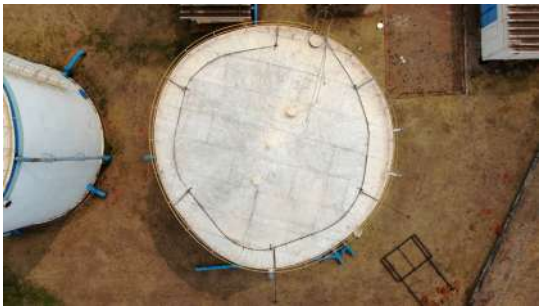
Foto 3 - Tampa de inspeção do reservatório.
