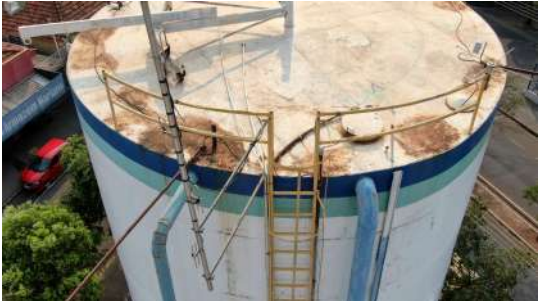
Foto 5 - Guarda-corpo do reservatório.
