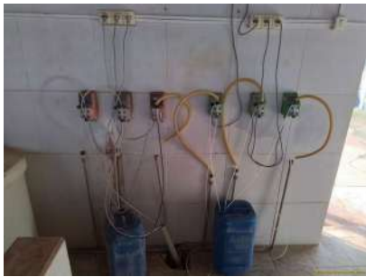
Foto 3 - Dosagem de Hipoclorito de Sódio e Ácido Fluossilícico.
