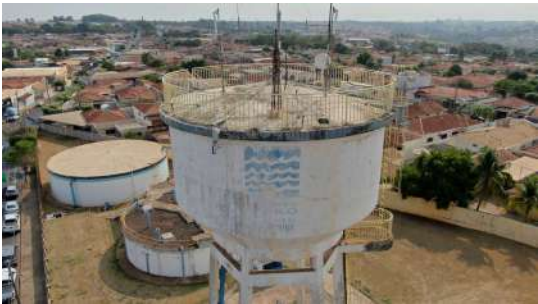
Foto 3 - Condutor de descarga descendo pelo reservatório.
