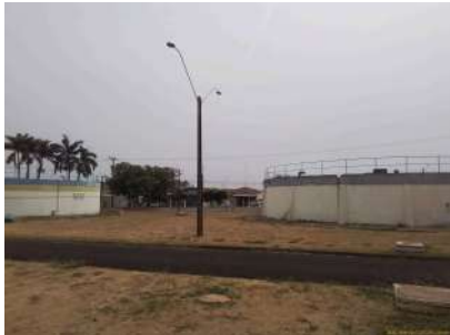
Foto 1 - Vista geral dos reservatórios vasos comunicantes. (R1 à direita e R2 à esquerda).
