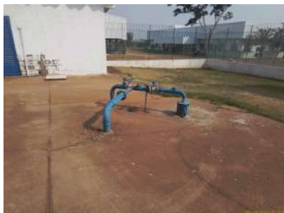
Foto 3 - Vista geral do poço UC04-P2.
