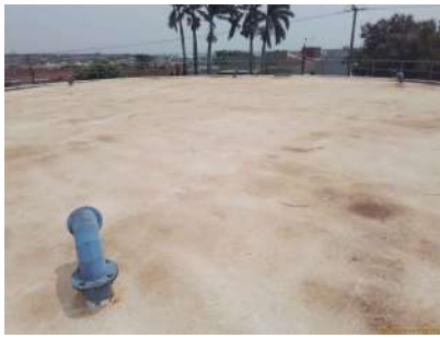
Foto 6 - Vista geral do topo do reservatório R2.
