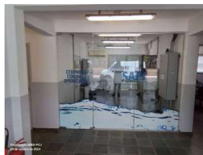
Foto 4 - Centro de Controle Operacional no prédio administrativo.
