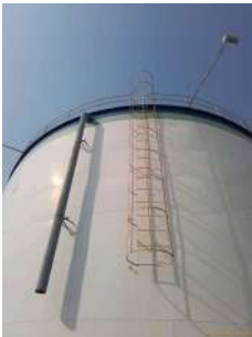
Foto 1 - Guarda-corpo na escada e topo do reservatório.
