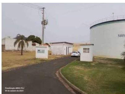
Foto 5 - Vista externa da EEA.
