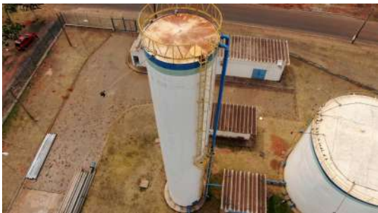
Foto 3 - Vista geral do topo reservatório elevado.
