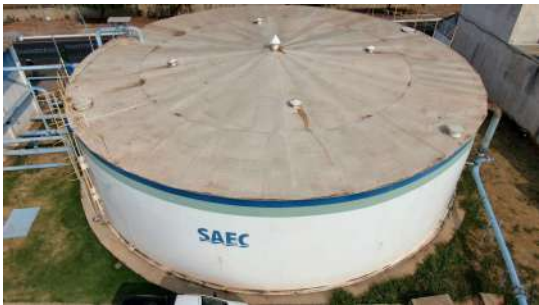
Foto 1 - Tubulações de respiro.
