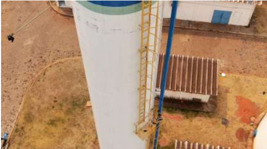
Foto 5 - Guarda-corpo do reservatório.
