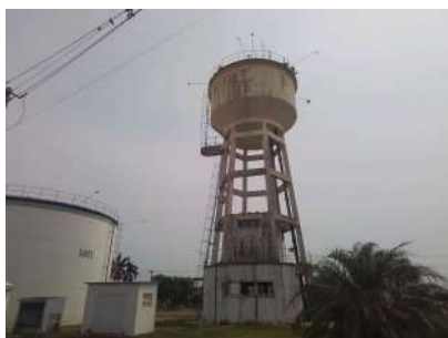
Foto 1 - Vista geral do reservatório (centro).
