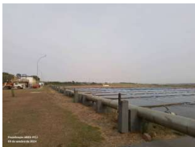
Foto 1 - Vista geral da ETE com o tratamento primário à esquerda e lagoas de aeração à direita.
