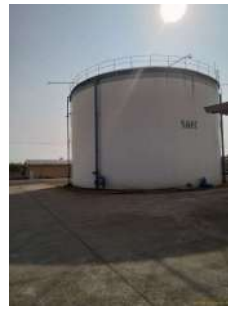
Foto 2 - Vista geral do reservatório.
