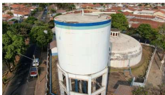
Foto 5 - Vista geral do reservatório elevado.
