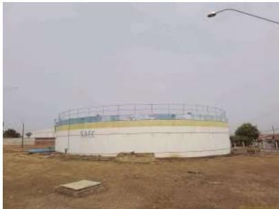
Foto 5 - Vista geral do reservatório R2.
