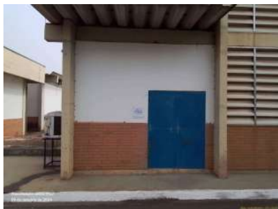
Foto 35 - Prédio que abriga a sala de controle e automação.
