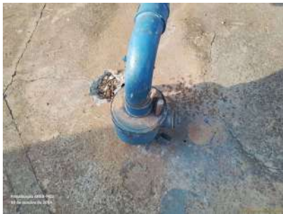
Foto 1 - Tubo de medição de nível.
