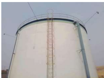
Foto 1 - Guarda-corpo na escada e no topo do reservatório.
