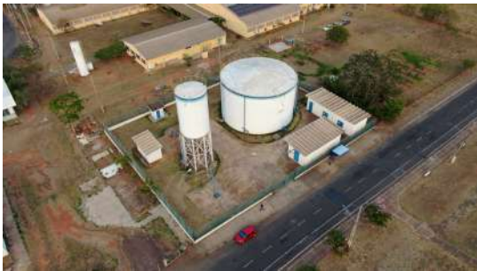
Foto 3 - Vista aérea do local onde se situa o reservatório.
