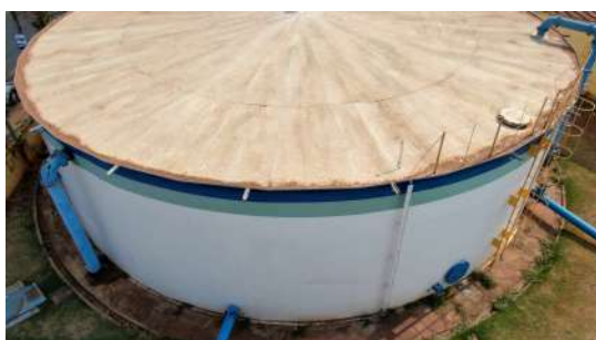
Foto 1 - Tampa de inspeção do reservatório.
