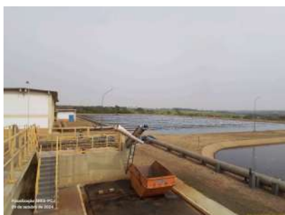
Foto 26 - Vista geral das lagoas de aeração (à direita) e do tratamento preliminar (à esquerda).
