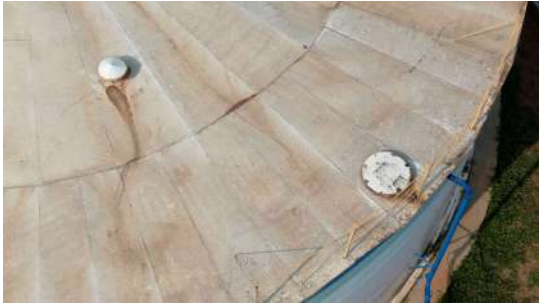
Foto 1 - Tampa de inspeção 1.
