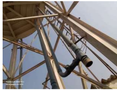
Foto 2 - Saída do tubo extravasor do reservatório.
