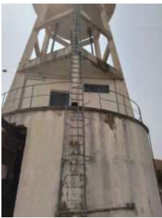
Foto 1 - Guarda-corpo no primeiro nível do reservatório.
