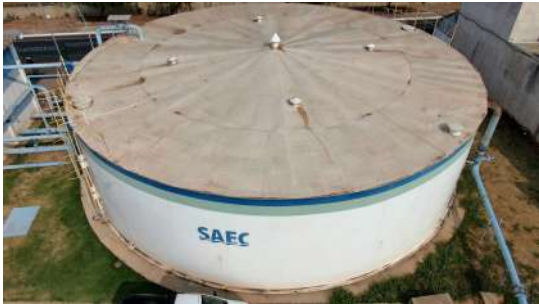
Foto 3 - Vista geral do reservatório.
