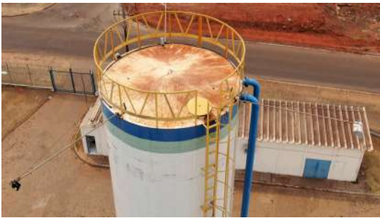
Foto 4 - Guarda-corpo do reservatório.
