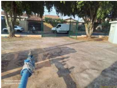
Foto 1 - Local cercado com grades.
