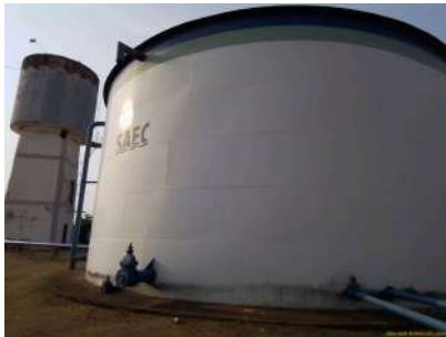
Foto 3 - Vista geral do reservatório.
