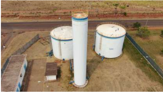
Foto 1 - Vista geral dos reservatórios.
