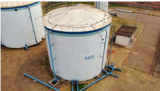
Foto 2 - Tampa de inspeção do reservatório.
