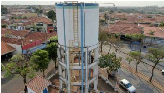
Foto 1 - Guarda-corpo do reservatório.
