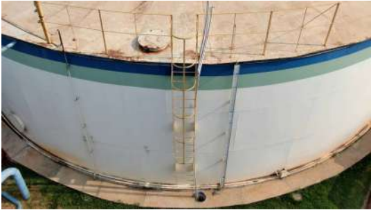
Foto 2 - Tampa de inspeção 2.
