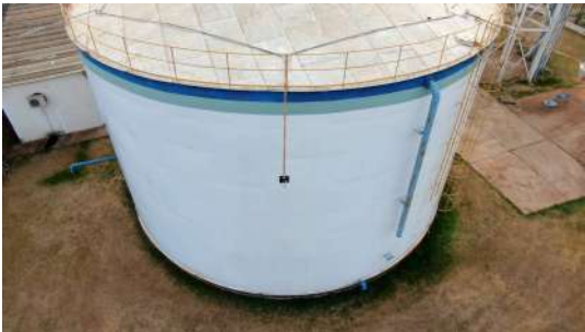
Foto 2 - Guarda-corpo na escada e topo do reservatório.
