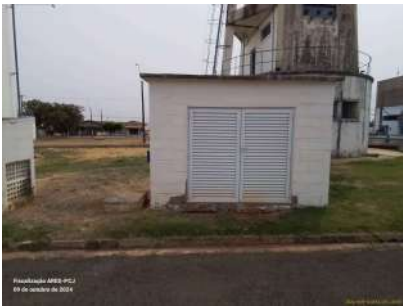
Foto 2 - Vista geral da casa de química.
