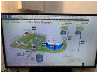
Foto 5 - Interface de monitoramento da unidade no CCO.
