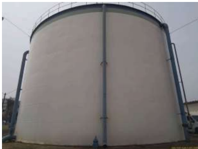
Foto 1 - Tubo extravasor do reservatório.
