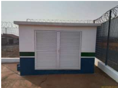
Foto 1 - Vista geral da casa de química.
