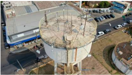
Foto 5 - Guarda-corpo do reservatório.
