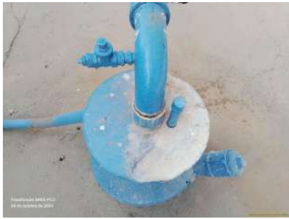
Foto 1 - Tubo para medição de nível.
