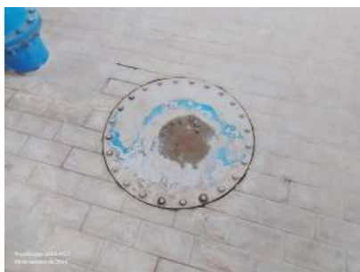
Foto 1 - Tampa de acesso ao reservatório.
