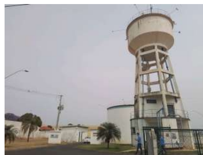
Foto 2 - Vista geral do local onde se situa o reservatório.
