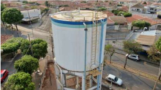
Foto 3 - Guarda-corpo do reservatório.
