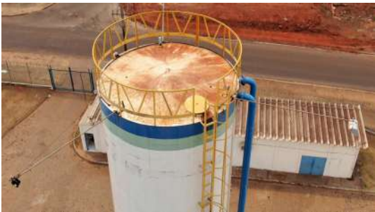
Foto 1 - Tampa de inspeção do reservatório.
