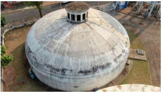
Foto 4 - Vista geral do reservatório semienterrado.
