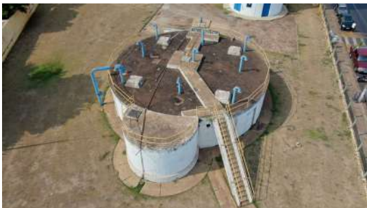
Foto 6 - Vista geral do reservatório apoiado de concreto.
