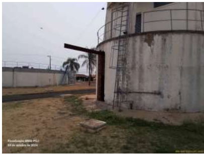
Foto 1 - Vista geral da edificação da EEA (base do reservatório elevado).
