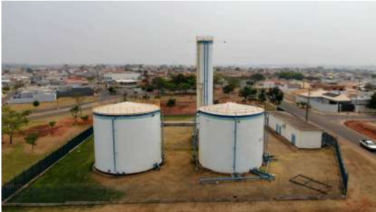
Foto 5 - Vista geral dos reservatórios.
