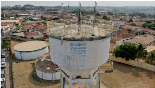
Foto 5 - Vista geral do reservatório.
