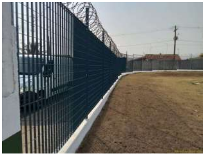
Foto 1 - Local cercado com grades.
