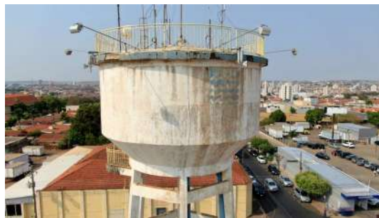
Foto 7 - Vista geral do reservatório.
