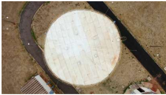
Foto 6 - vista aérea do topo do reservatório.
