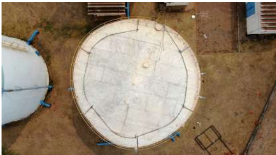
Foto 3 - Vista geral do topo reservatório apoiado 1.
