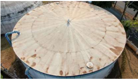
Foto 2 - Tubulações de ventilação.
