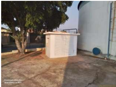
Foto 1 - Casa de química.
