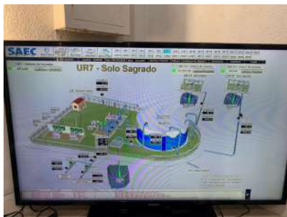
Foto 1 - Interface de monitoramento da unidade no CCO.
