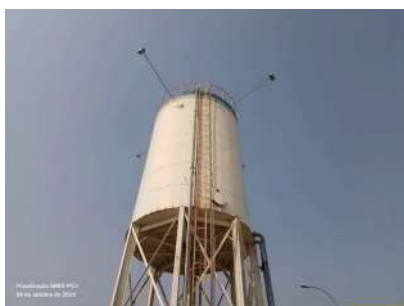
Foto 1 - Guarda-corpos na escada e no topo do reservatório.
