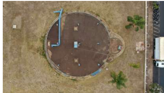
Foto 10 - Vista aérea do reservatório R1.
