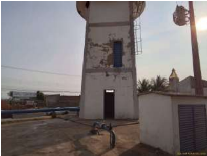
Foto 2 - Vista geral da edificação da EEA, a qual se encontra na base do reservatório elevado.
