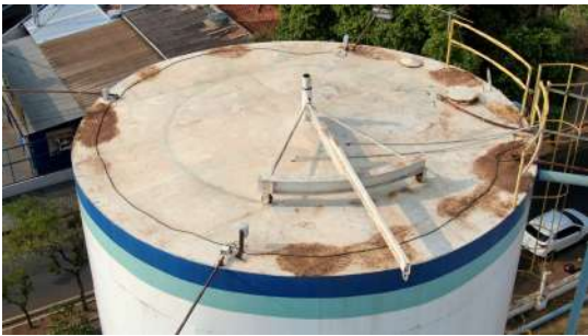
Foto 3 - Tampa de inspeção.
