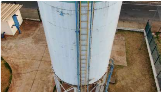
Foto 5 - Guarda-corpo da escada.
