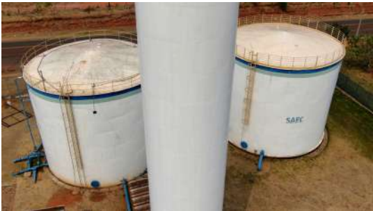
Foto 2 - Guarda-corpo do reservatório (esquerda).
