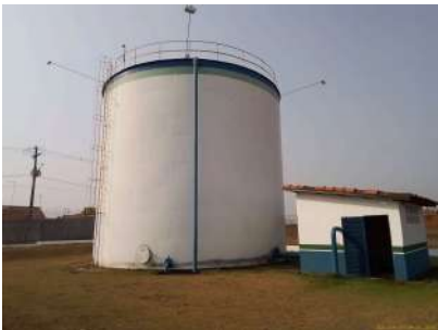
Foto 2 - Vista geral do reservatório.
