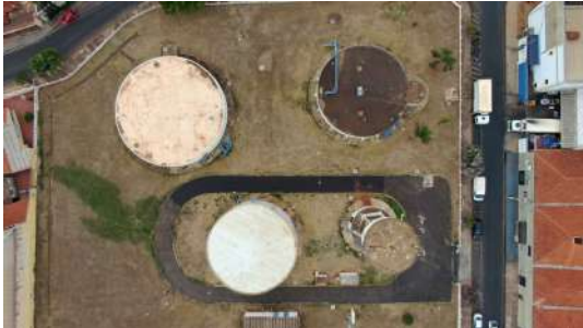
Foto 8 - Vista aérea dos reservatórios do local. Os reservatórios vasos comunicantes estão na parte superior da imagem.
