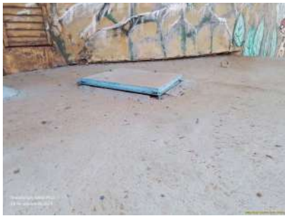
Foto 1 - Elevar e vedar laterais da tampa de inspeção da caixa de passagem.
