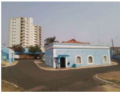
Foto 9 - Vista geral do edifício que abriga as elevatórias.
