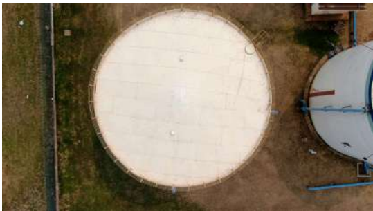
Foto 1 - Tampa de inspeção.
