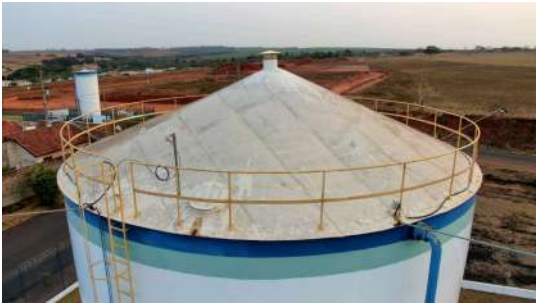
Foto 3 - Guarda-corpos no topo do reservatório.
