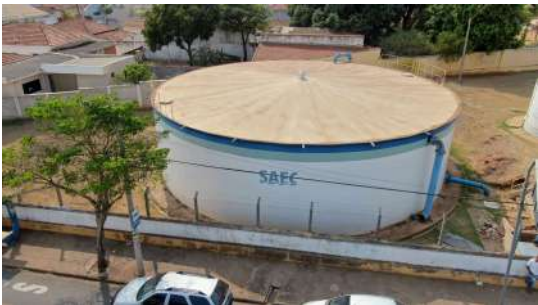
Foto 1 - Guarda-corpo do reservatório.
