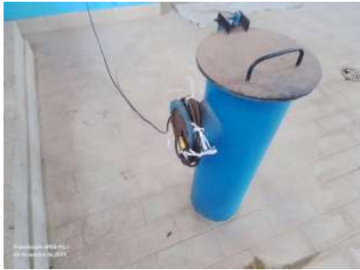
Foto 1 - Tubo de ventilação e extravasor do reservatório, segundo o prestador.
