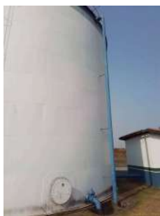
Foto 1 - Tubo extravasor do reservatório.
