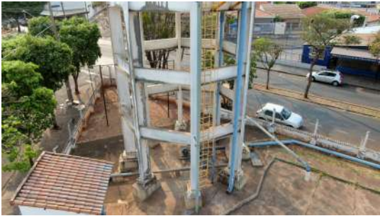
Foto 2 - Guarda-corpo do reservatório.
