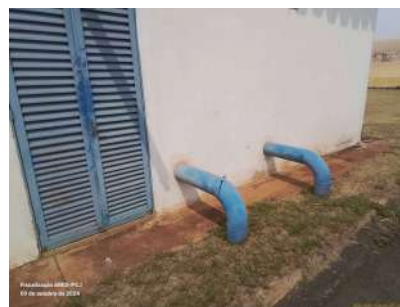
Foto 2 - Vista externa da tubulação de sucção.
