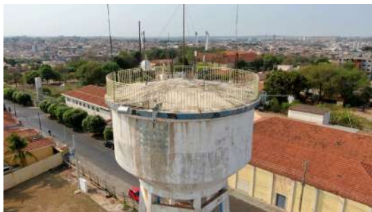
Foto 6 - Vista geral do reservatório.
