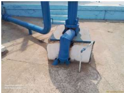
Foto 1 - Laje de proteção do poço.
