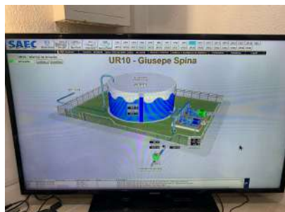
Foto 1 - Interface de monitoramento da unidade no CCO.
