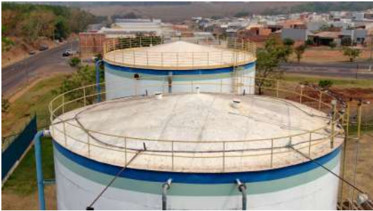
Foto 1 - Tubulações de ventilação no topo.
