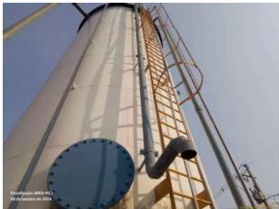
Foto 1 - Tubo extravasor do reservatório.
