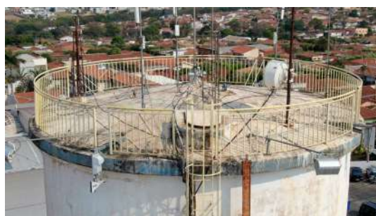
Foto 2 - Guarda-corpo do reservatório.
