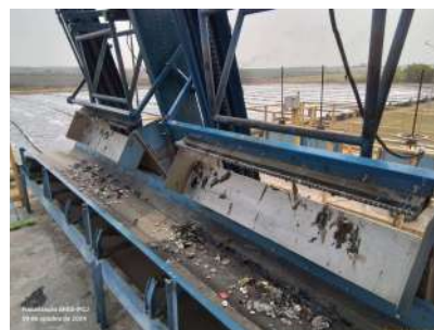
Foto 16 - Pá e esteira de retirada dos materiais do gradeamento fino.
