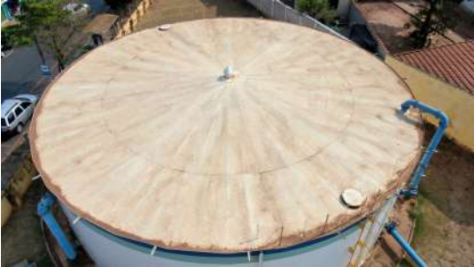
Foto 6 - Vista geral do reservatório apoiado metálico.
