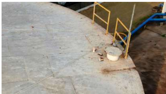
Foto 1 - Tampa de inspeção.
