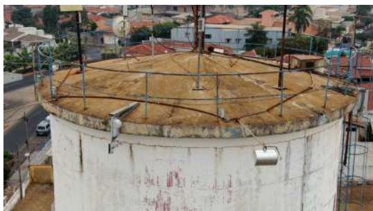
Foto 5 - Guarda-corpo no topo do reservatório.
