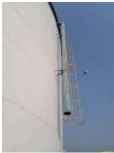
Foto 1 - Tubo extravasador do reservatório.
