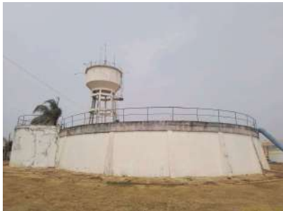
Foto 4 - Vista geral do reservatório R1 (primeiro plano).
