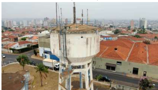
Foto 7 - Guarda-corpo no topo do reservatório.
