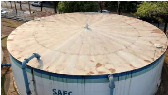
Foto 1 - Tubulação de respiro.
