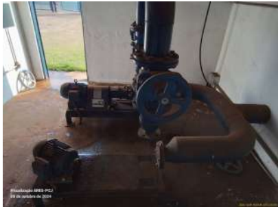
Foto 3 - Vista do interior da edificação da EEA.
