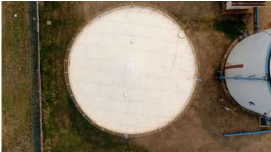
Foto 3 - Vista geral do topo reservatório apoiado 2.
